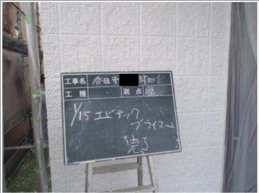
外壁エピテックプライマー施工完了
