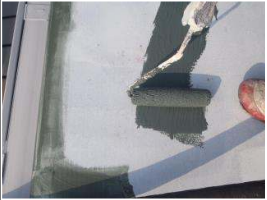
屋上防水塗装中塗り施工中
