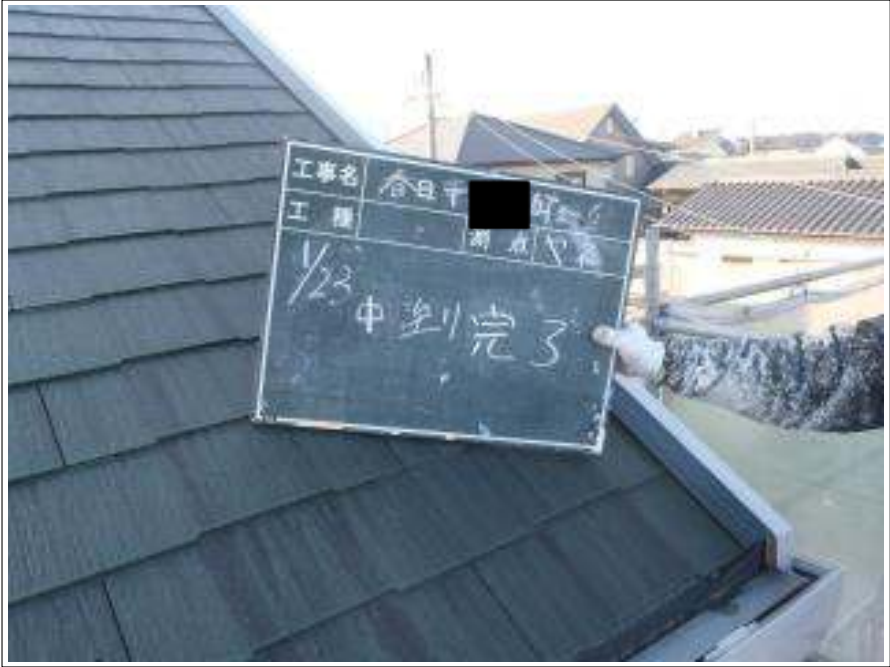
屋根塗装中塗り施工完了
