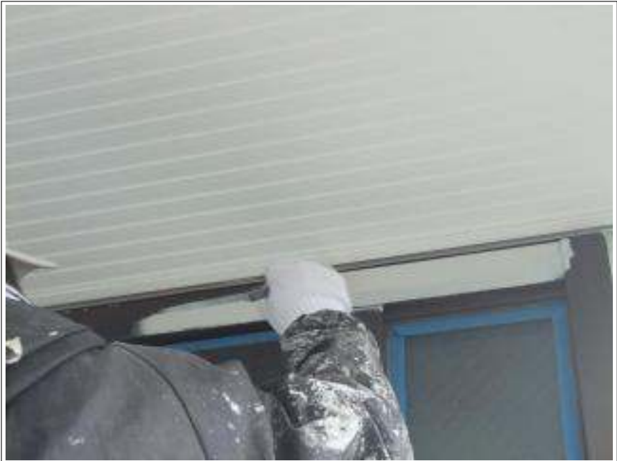
玄関塗装下塗り施工中
