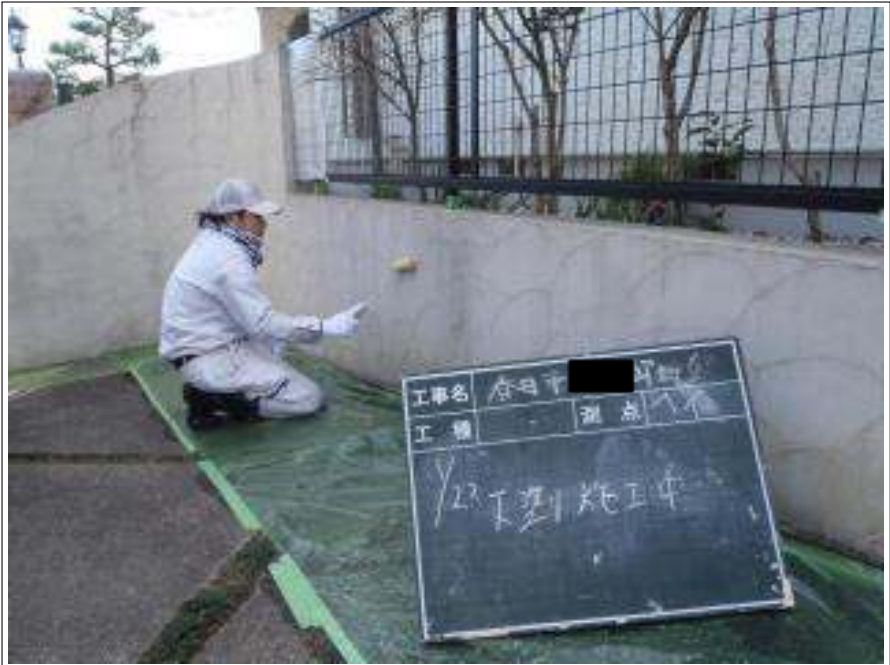
塀塗装下塗り施工中
