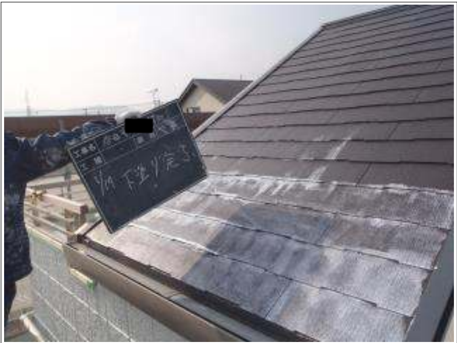
屋根塗装下塗り施工完了
