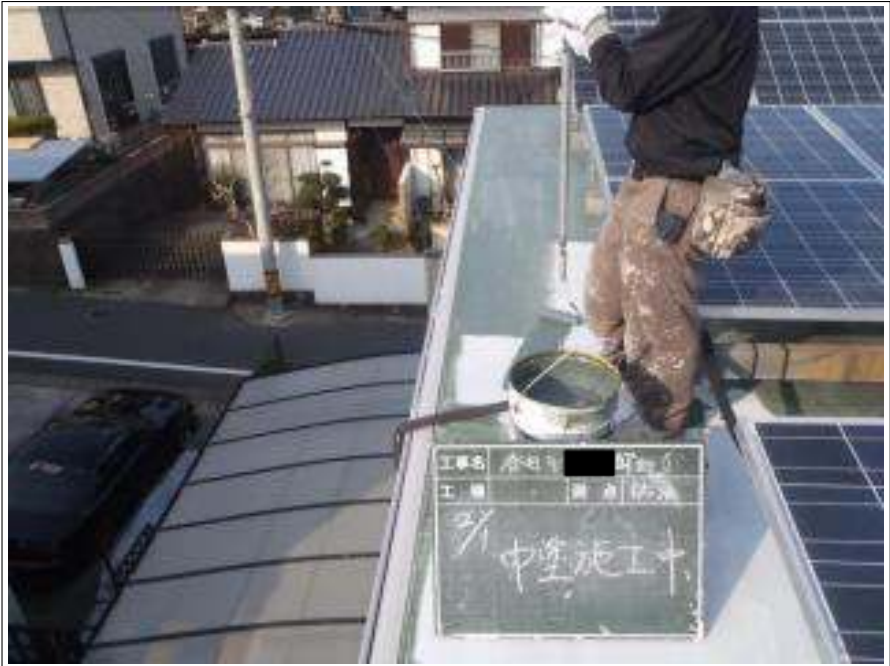
屋上防水塗装中塗り施工中
