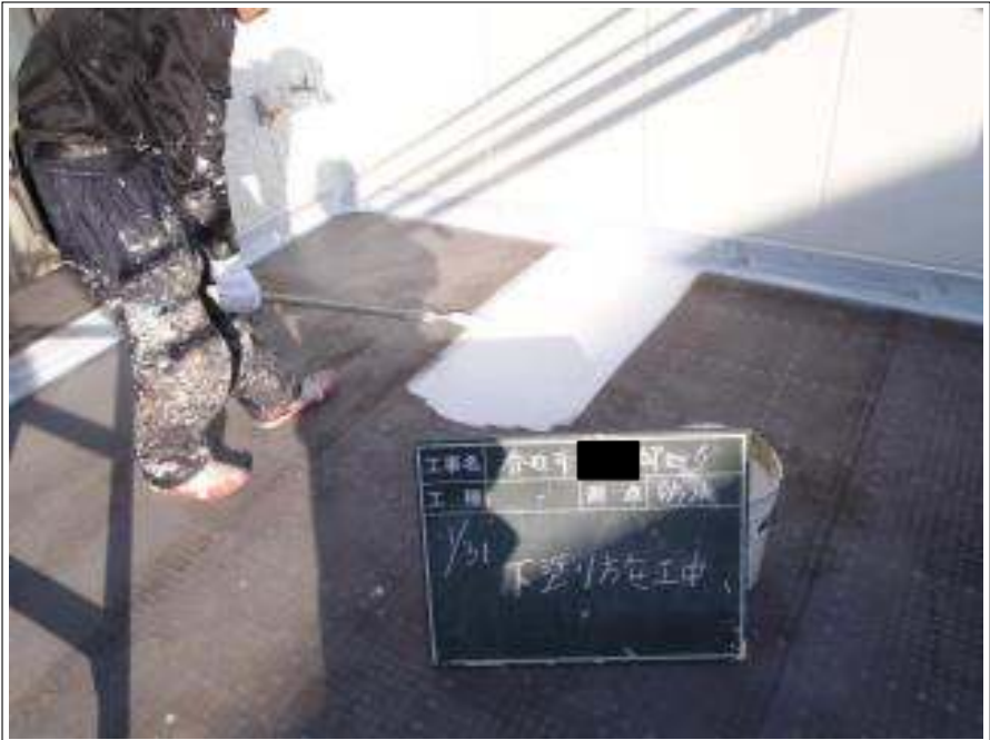
バルコニー防水塗装下塗り施工中
