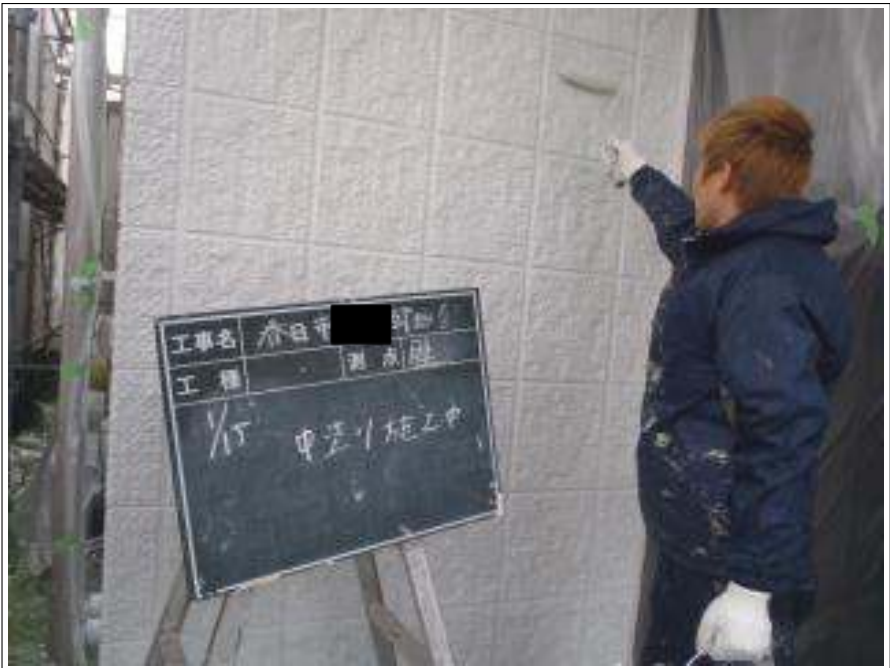
外壁塗装中塗り施工中
