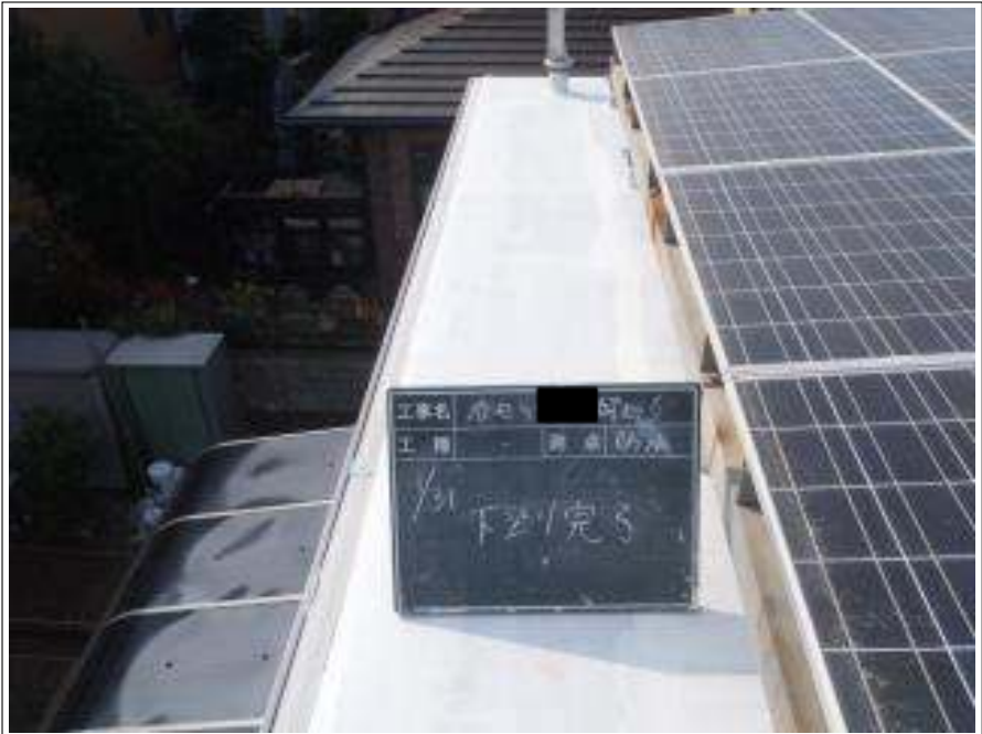
屋上防水塗装下塗り施工完了
