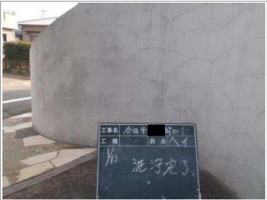
塀高圧洗浄施工完了
