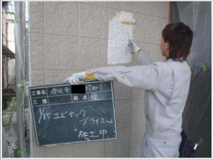
外壁エピテックプライマー施工中
