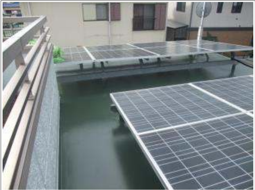
屋上防水塗装上塗り施工完了
