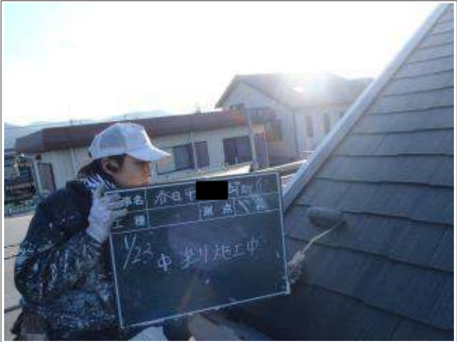
屋根塗装中塗り施工中
