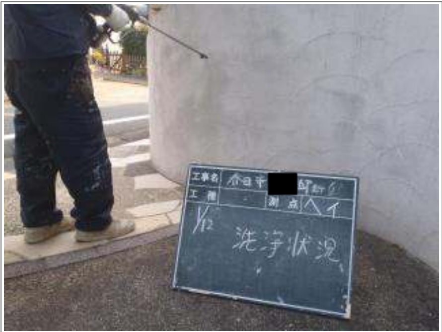
塀高圧洗浄施工中
