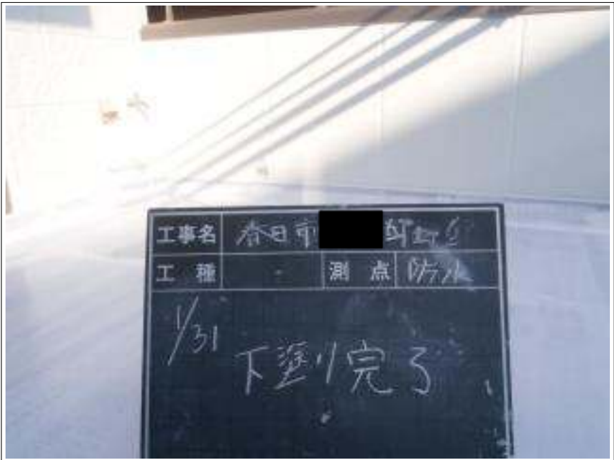
バルコニー防水塗装下塗り施工完了
