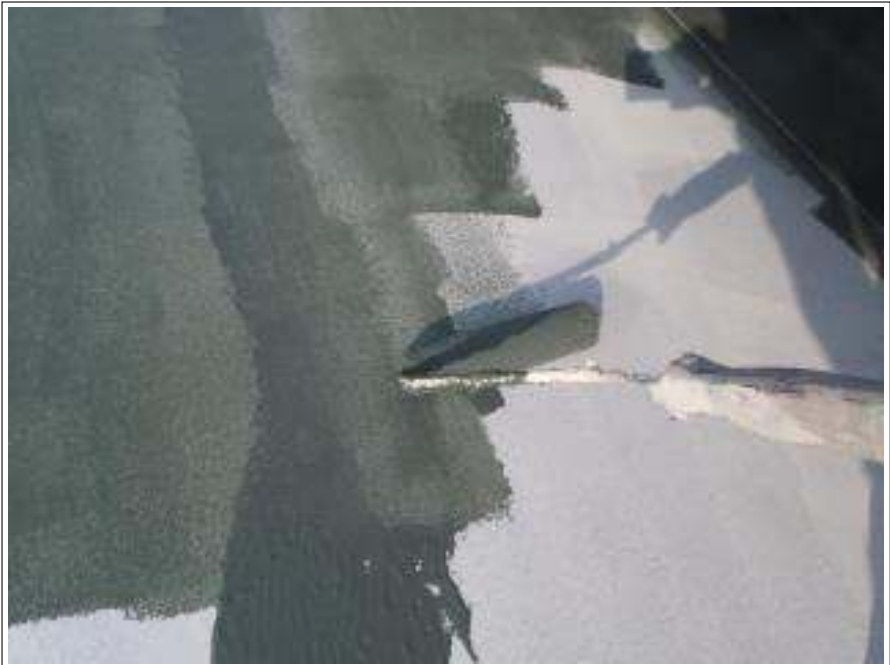
バルコニー防水塗装中塗り施工中
