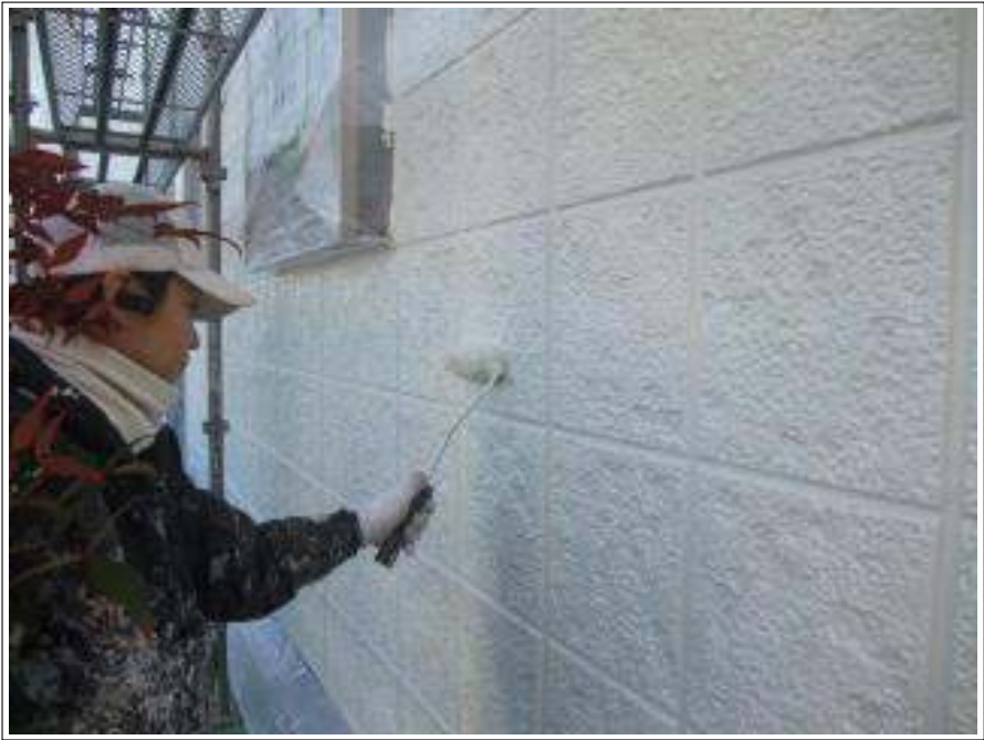
外壁塗装上塗り施工中
