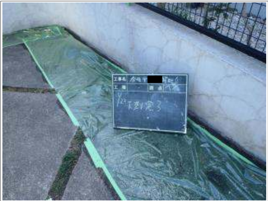
塀塗装下塗り施工完了
