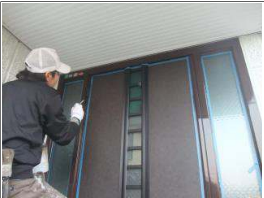
玄関塗装上塗り施工中
