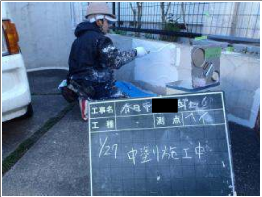
塀塗装中塗り施工中
