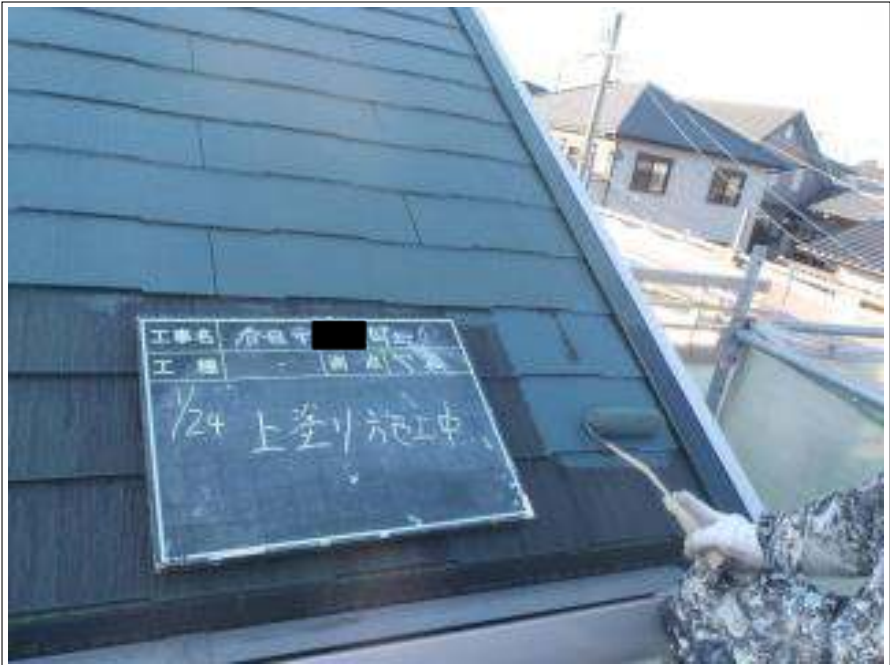
屋根上塗り塗装施工中
