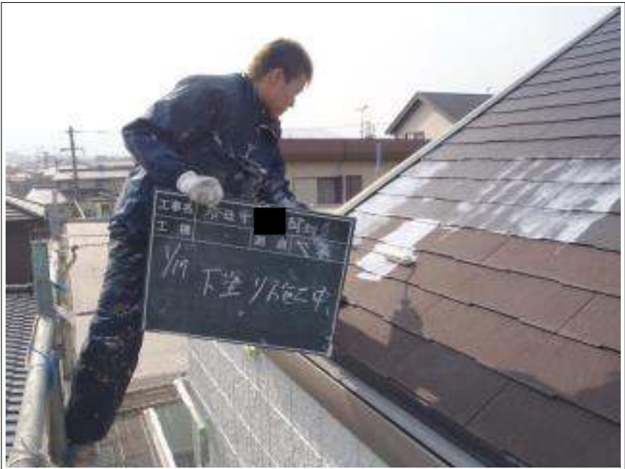
屋根塗装下塗り施工中
