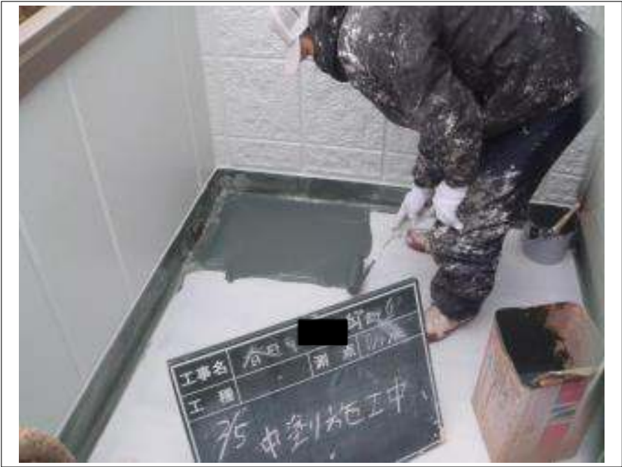
ベランダ防水塗装中塗り施工中
