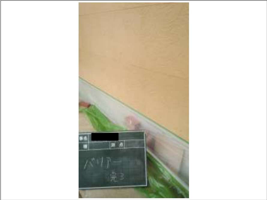
外壁バリアー施工完了
