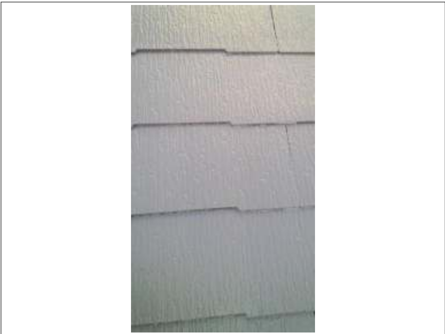
屋根塗装上塗り施工完了
