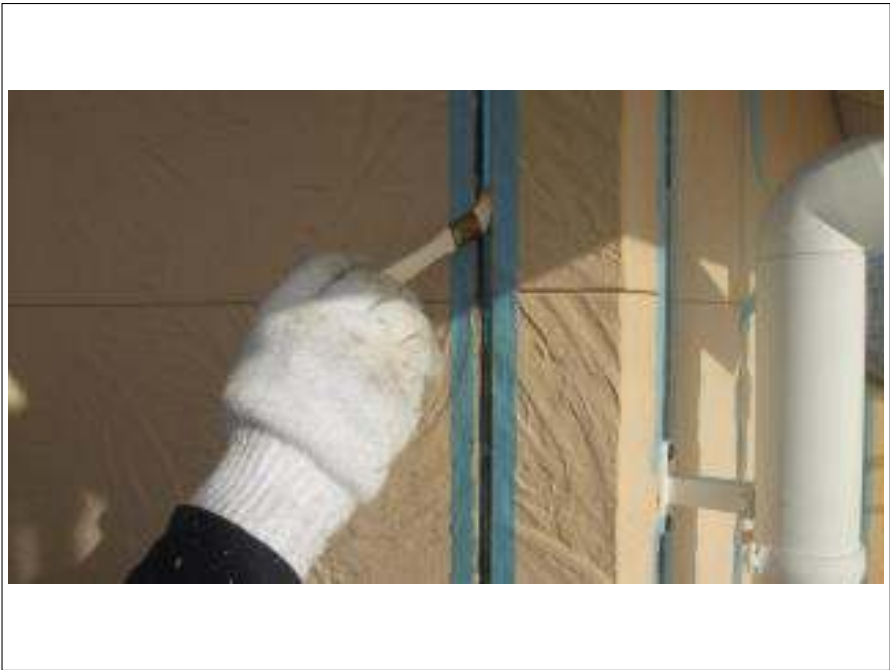
外壁コーキングプライマー施工中
