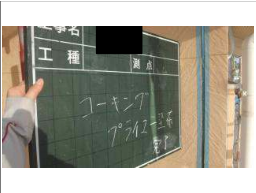
外壁コーキングプライマー施工完了
