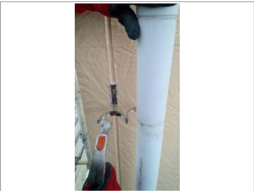
樋金具交換施工中
