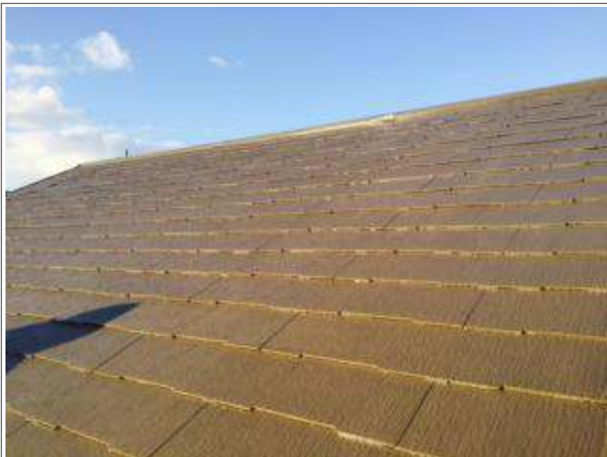
屋根塗装施工完了
