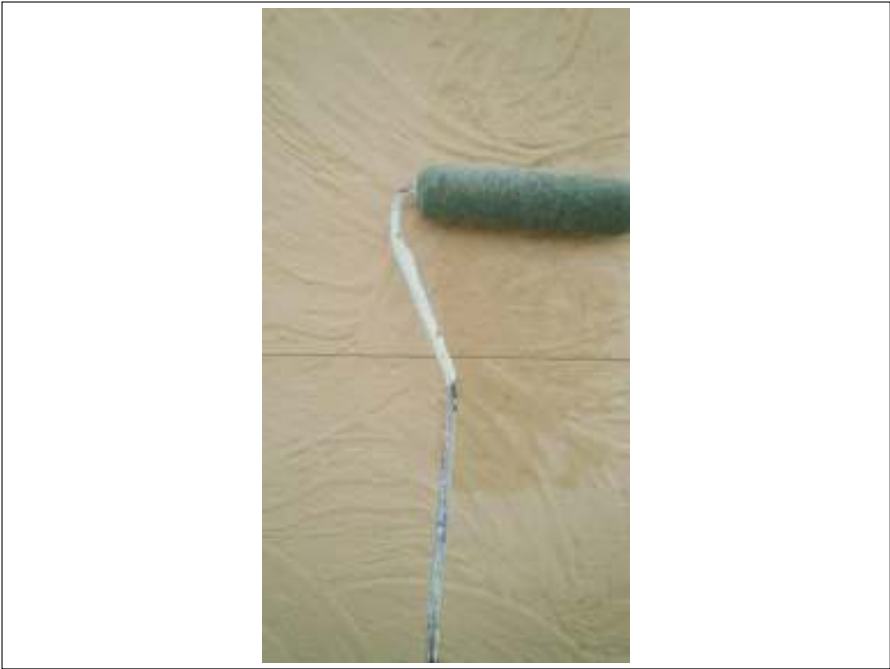
外壁バリアー施工中
