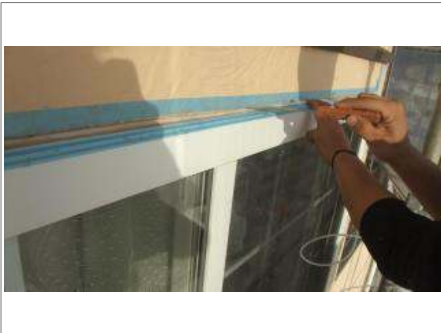
外壁コーキング撤去施工中
