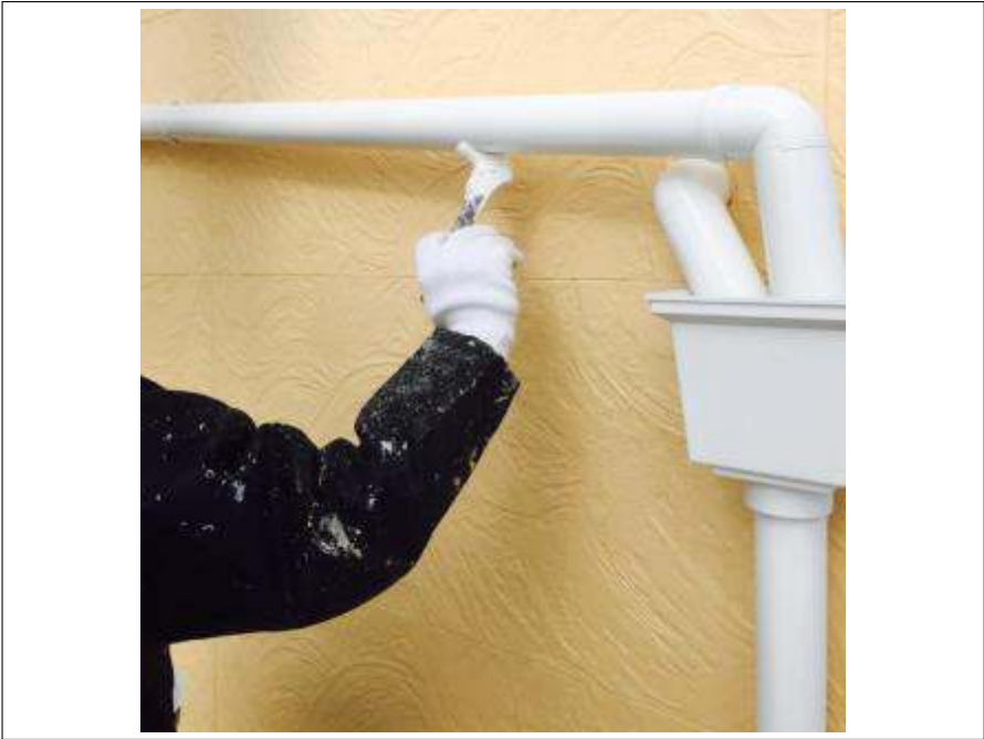
樋塗装施工中
