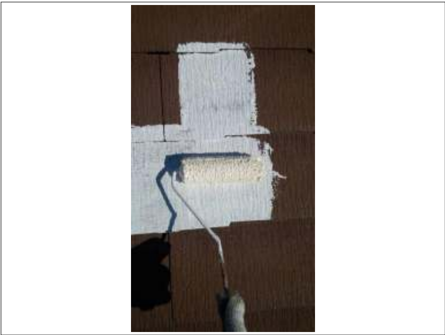
屋根塗装下塗り施工中
