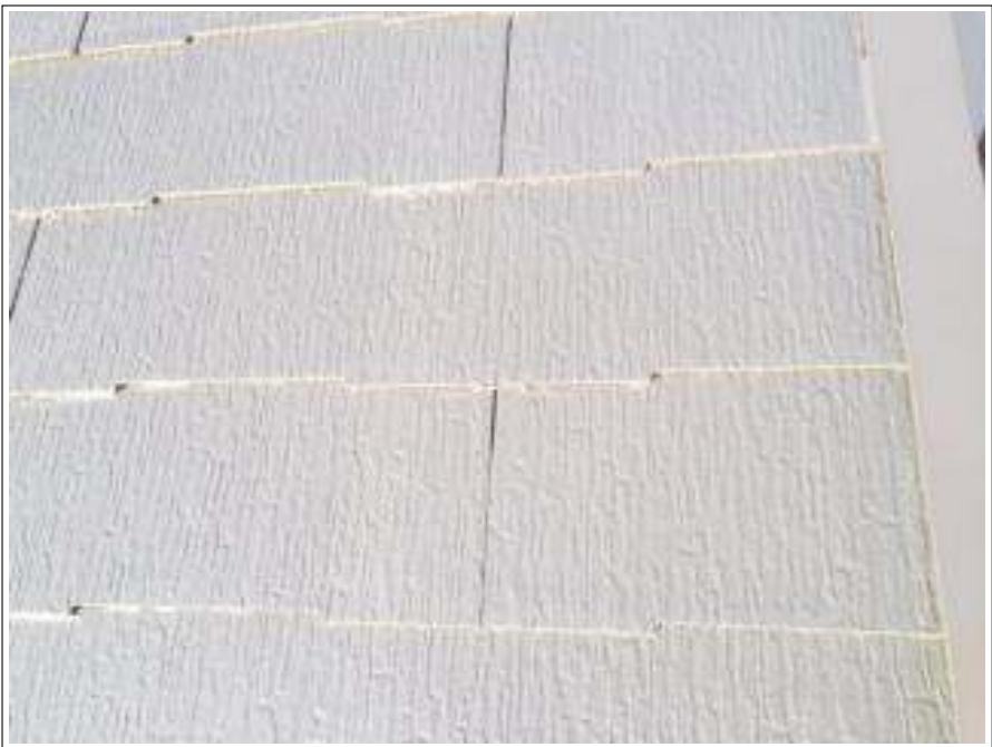
屋根塗装中塗り施工完了
