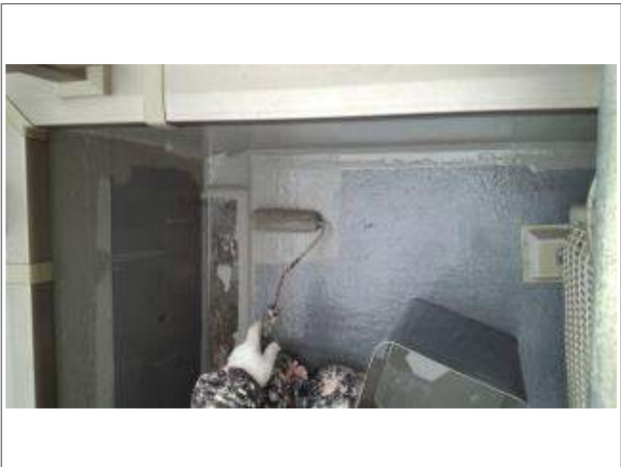
ベランダ床塗装施工中
