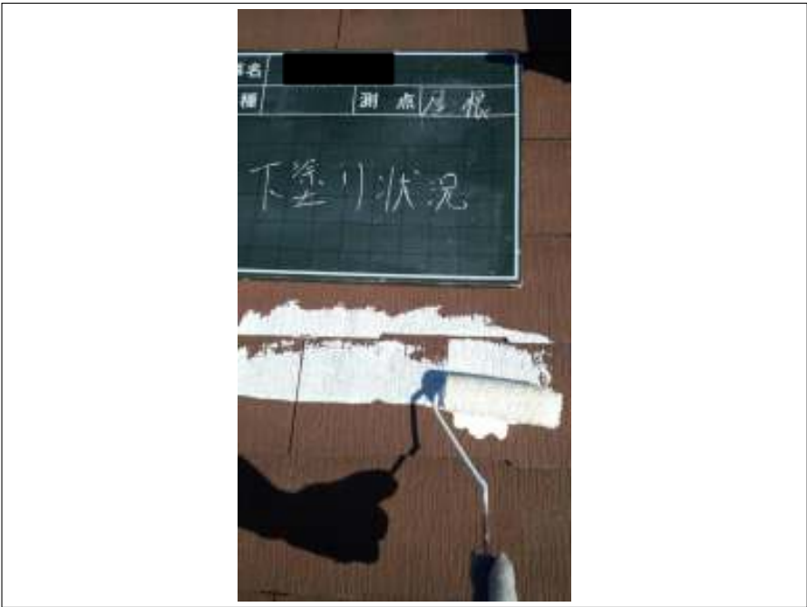
屋根塗装下塗り施工中
