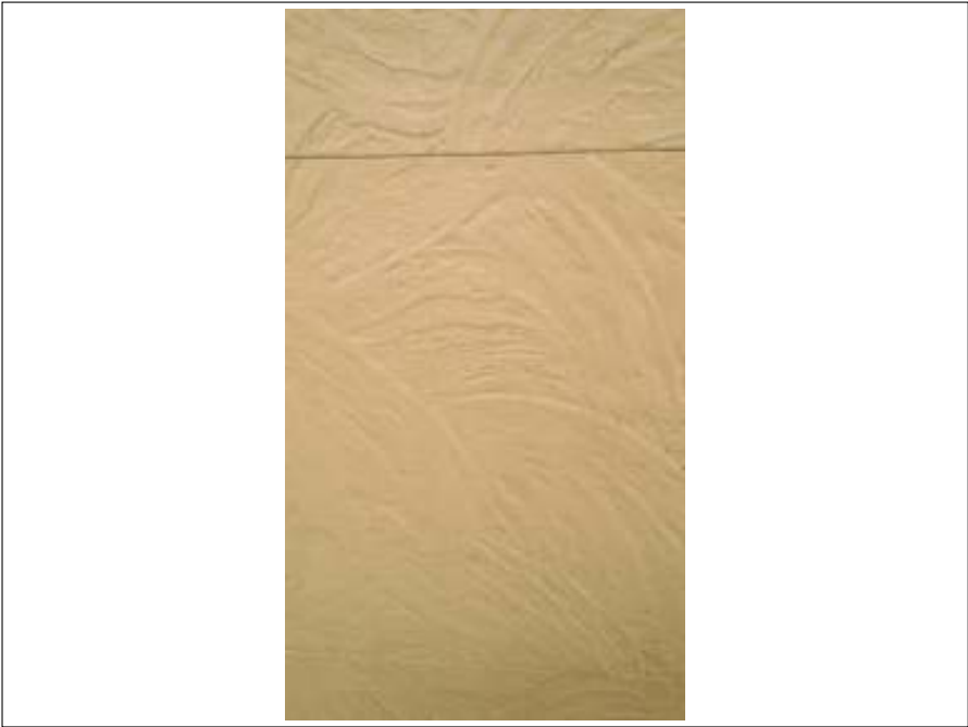
外壁バリアー施工完了
