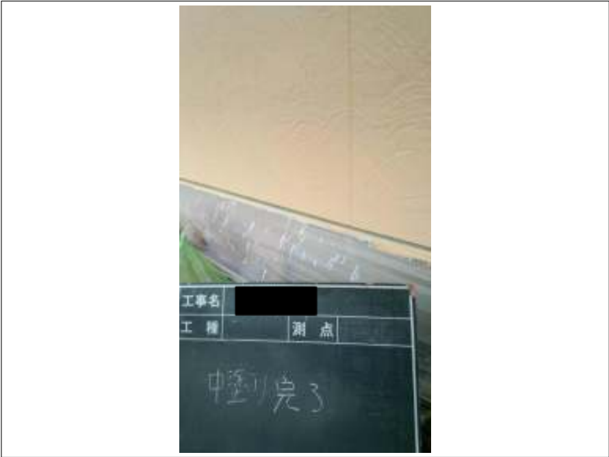
外壁塗装中塗り施工完了
