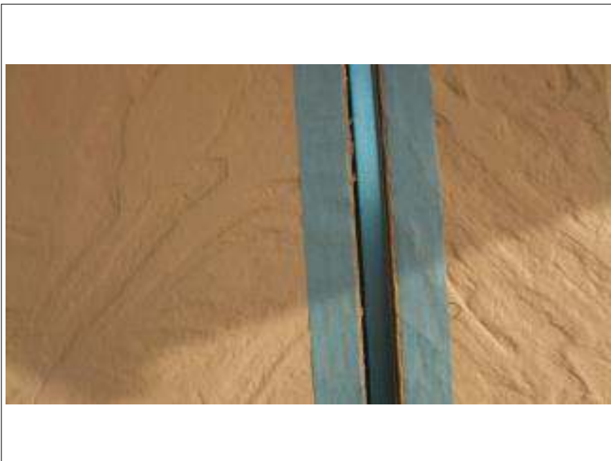
外壁コーキング撤去施工完了
