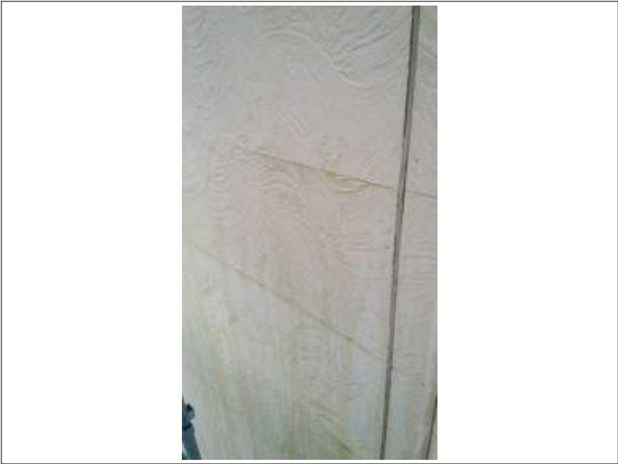
外壁高圧洗浄施工中
