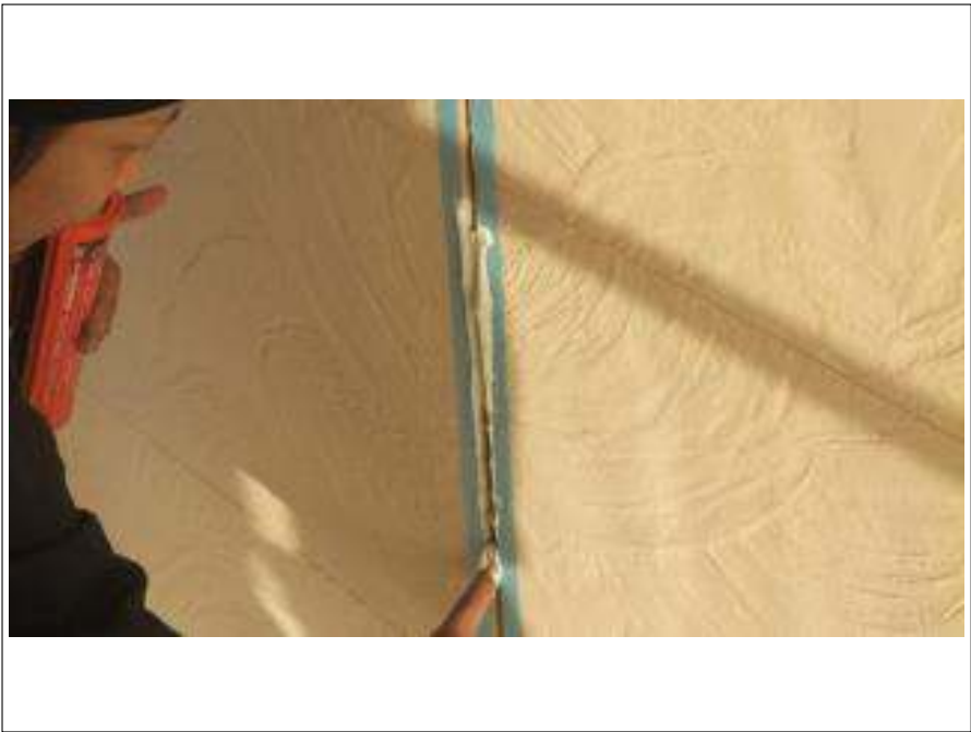
外壁コーキング打替施工中
