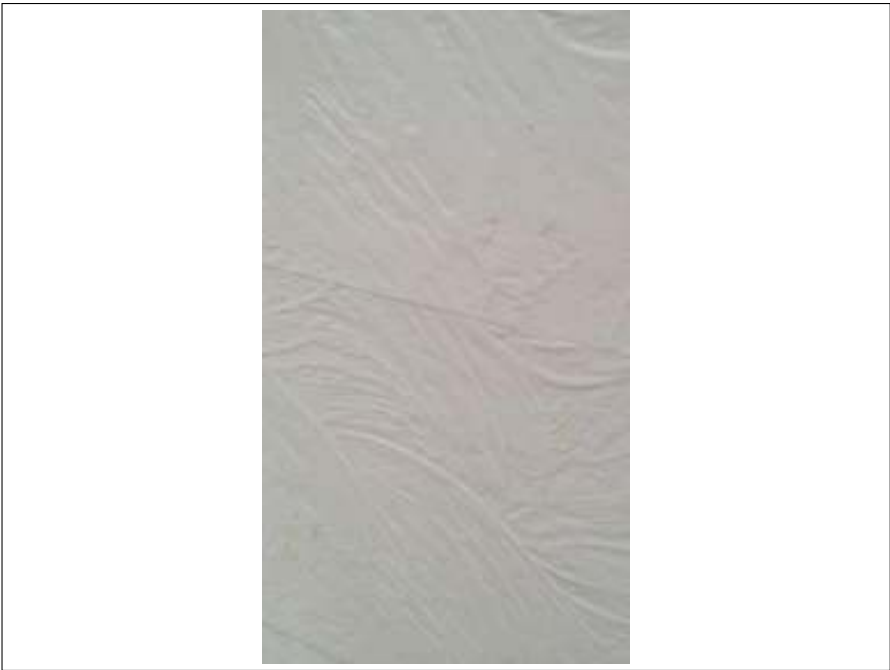
外壁高圧洗浄施工完了
