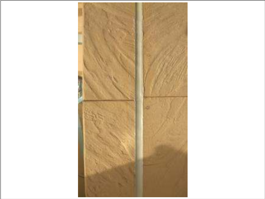
外壁コーキング打替施工完了
