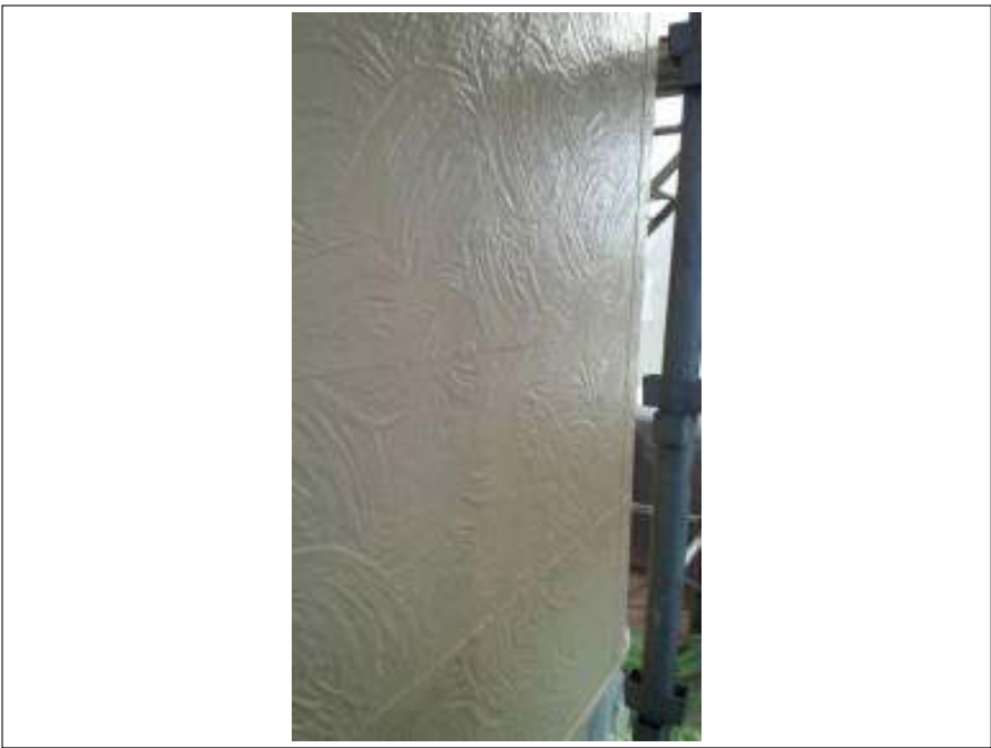
外壁塗装上塗り施工完了
