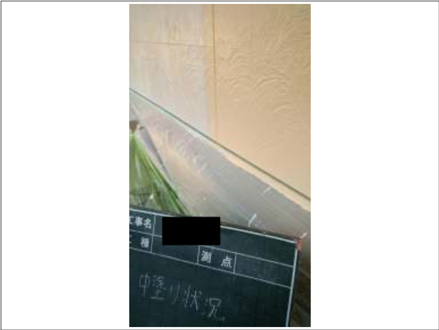
外壁塗装中塗り施工中
