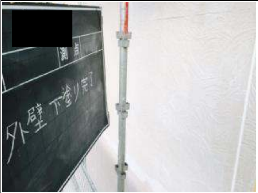
外壁塗装下塗り施工完了
