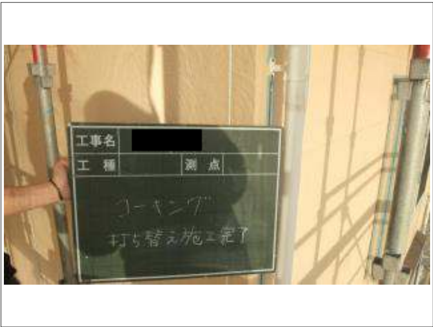
外壁コーキング打替施工完了
