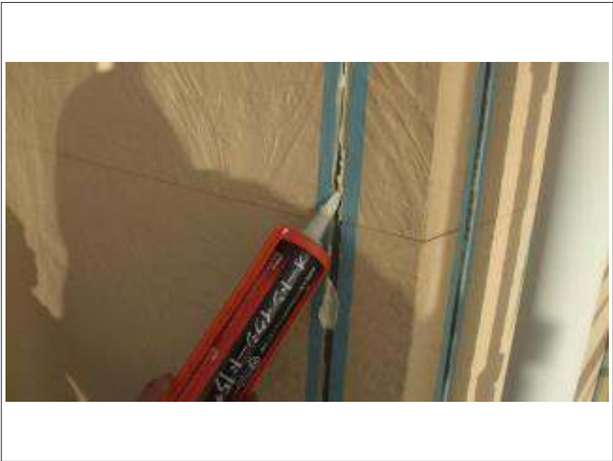
外壁コーキング打替施工中
