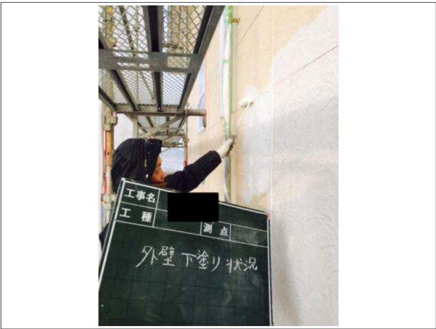
外壁塗装下塗り施工中
