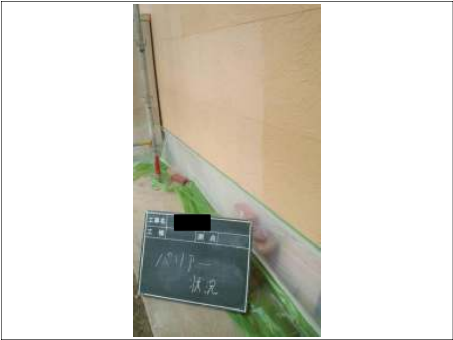
外壁バリアー施工中
