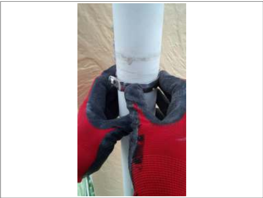
樋金具交換施工中
