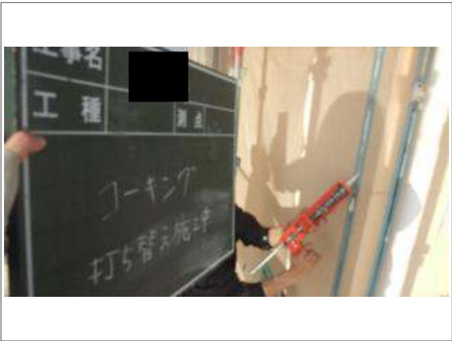
外壁コーキング打替施工中
