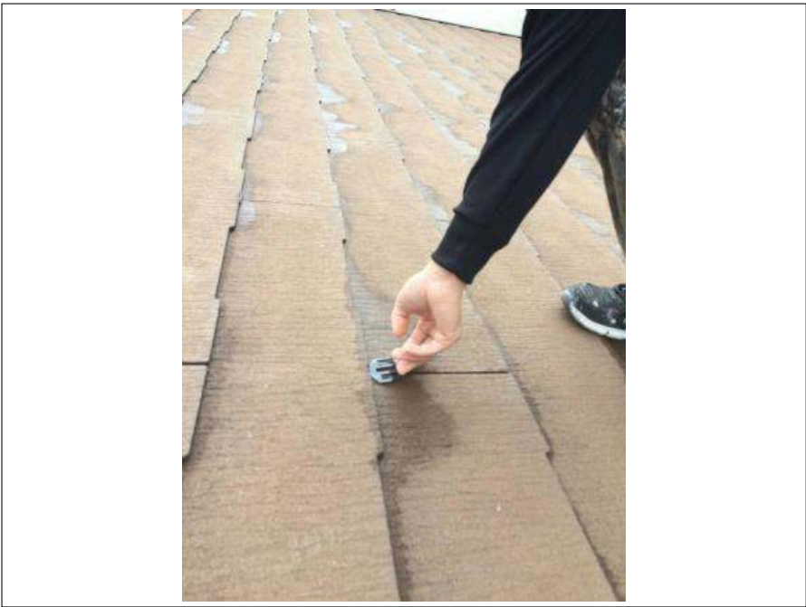
タスペーサー施工中
