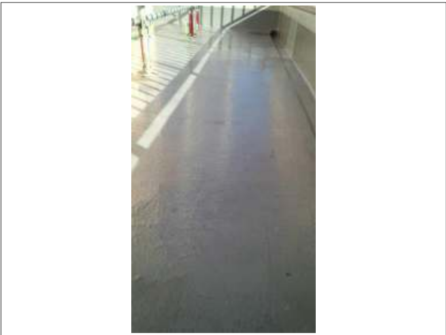
ベランダ床防水プライマー施工完了
