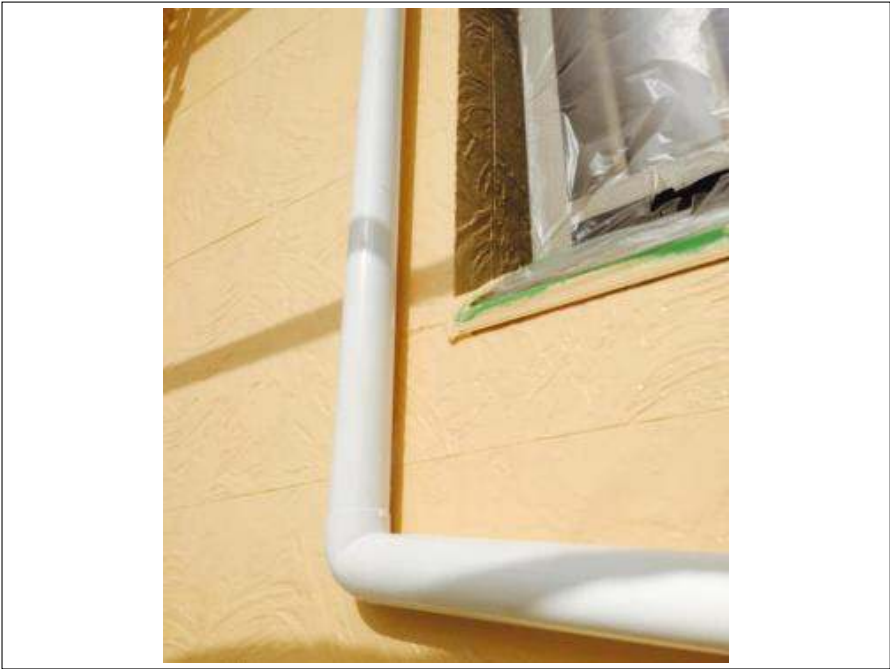
樋塗装施工完了
