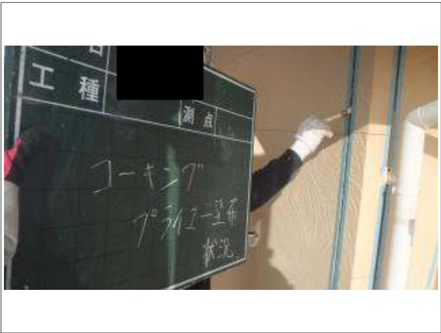
外壁コーキングプライマー施工中
