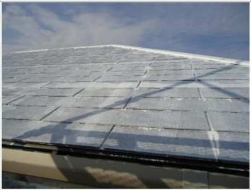
屋根塗装下塗り施工完了
