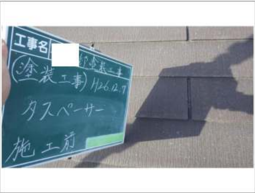
屋根タスペーサー施工前
