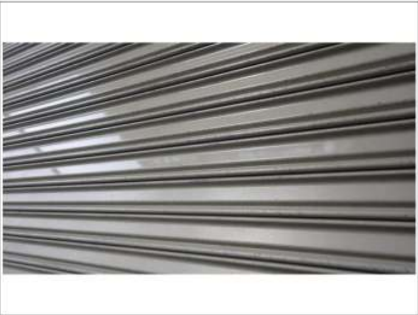
シャッター塗装下塗り施工中
