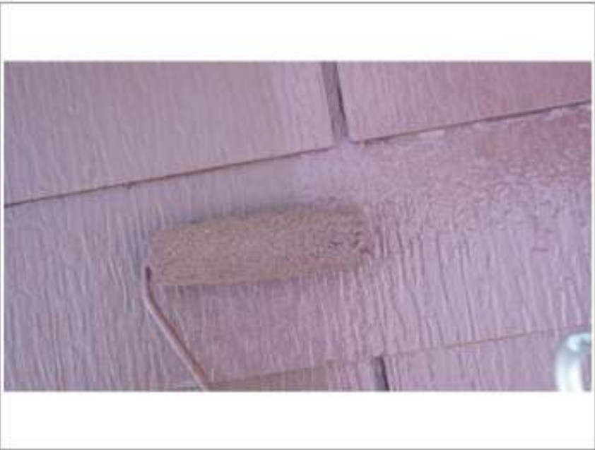
屋根塗装上塗り施工中
