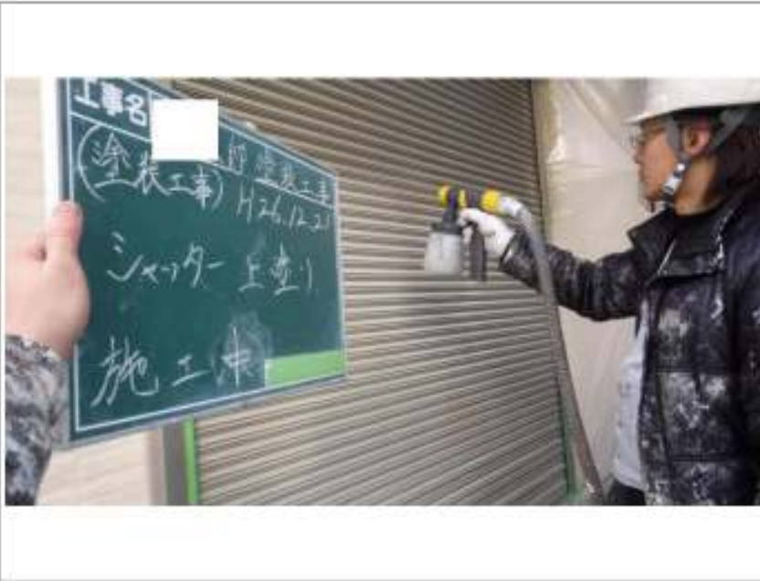
シャッター塗装上塗り施工中
