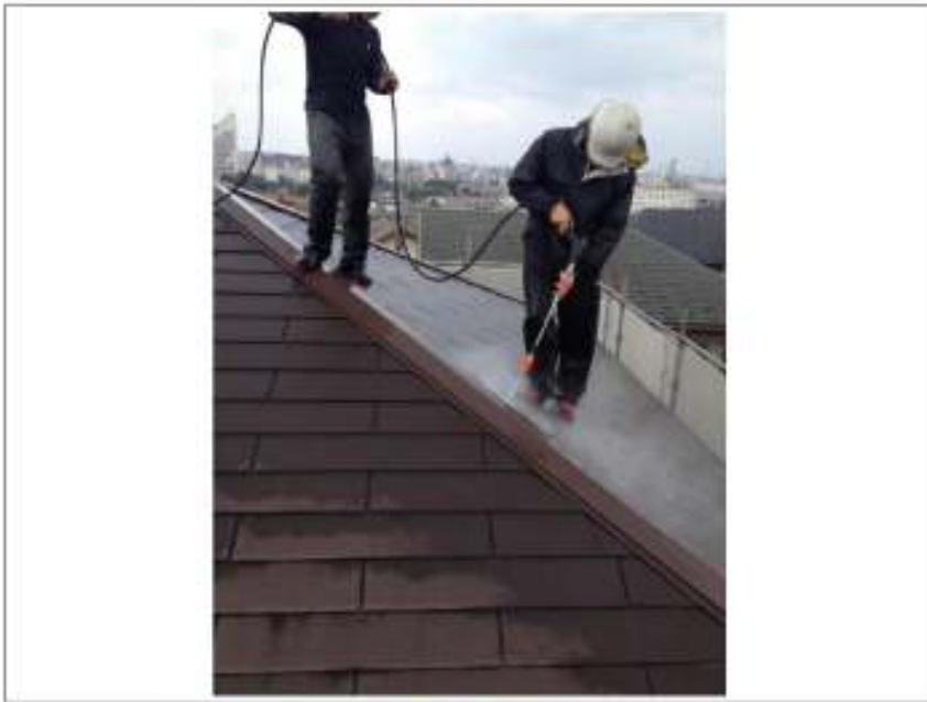
屋根高圧洗浄施工中
