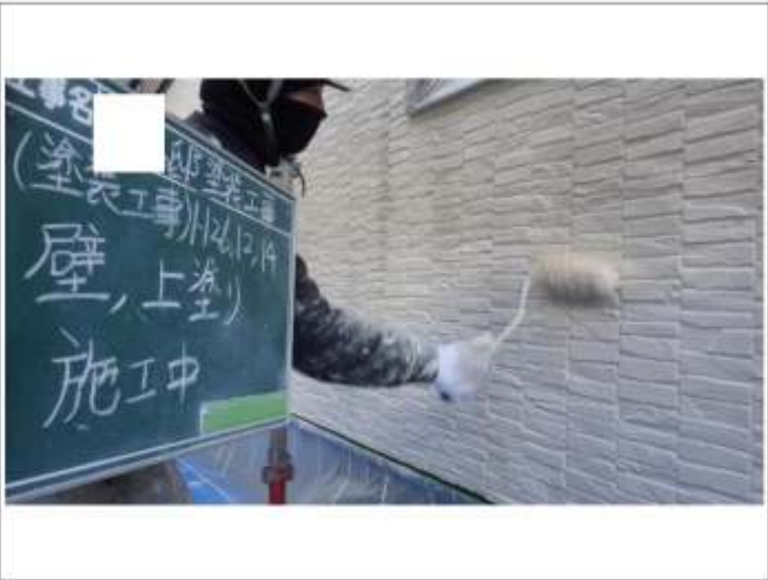
外壁塗装上塗り施工中
