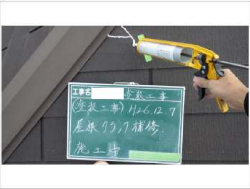
屋根クラック補修施工中
