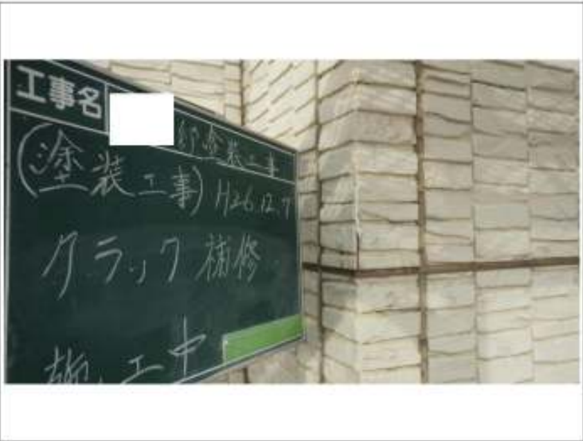
外壁クラック補修施工中
