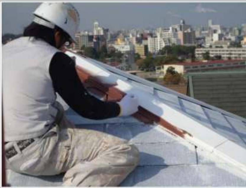
屋根塗装中塗り施工中
