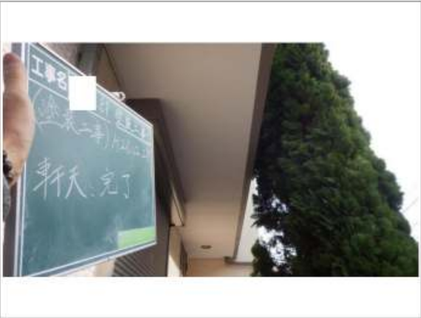
軒天塗装施工完了
