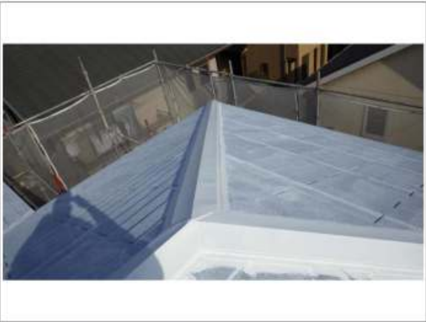
屋根塗装下塗り施工完了
