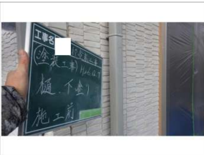
桶塗装施工前
