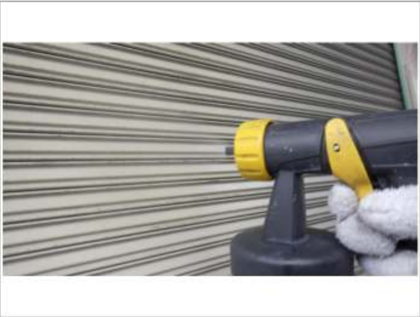
シャッター塗装下塗り施工中
