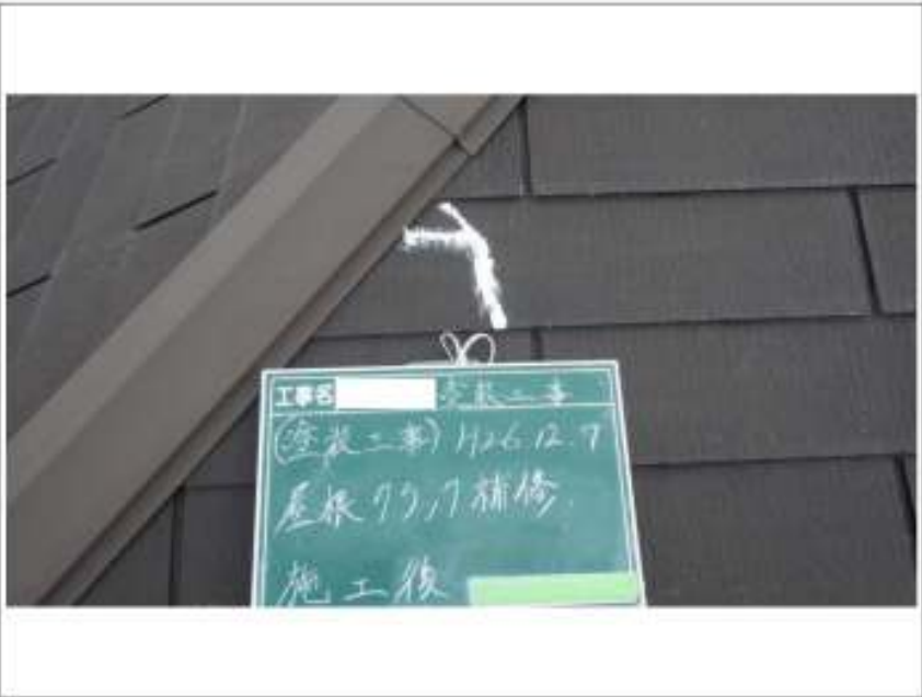
屋根クラック補修施工完了
