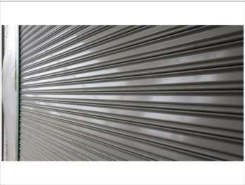
シャッター塗装下塗り施工完了
