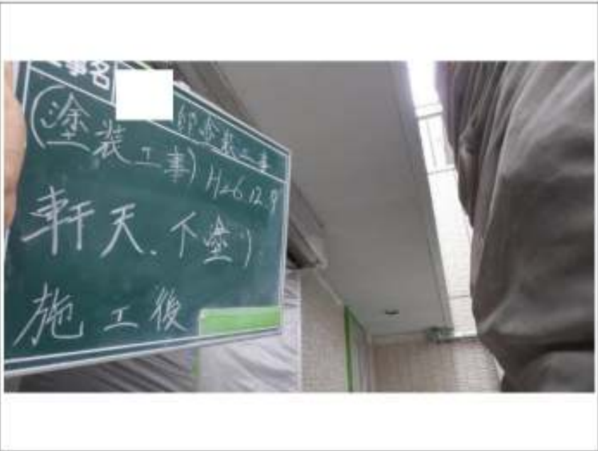
軒天塗装下塗り施工完了
