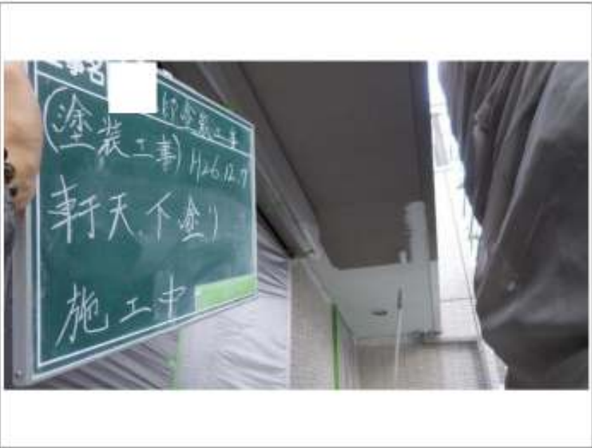
軒天塗装下塗り施工中
