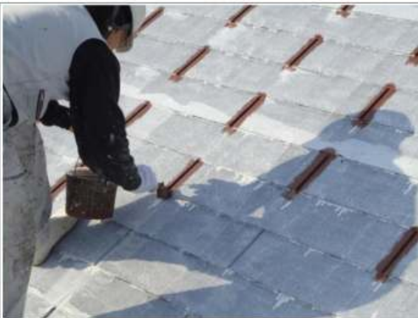
屋根塗装中塗り施工中
