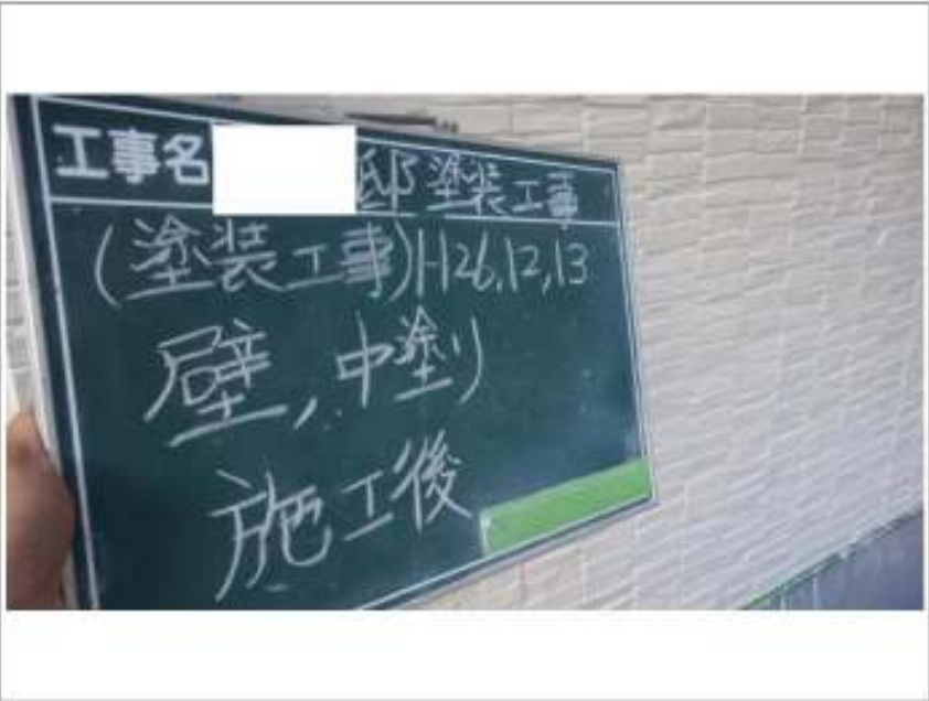
外壁塗装中塗り施工完了
