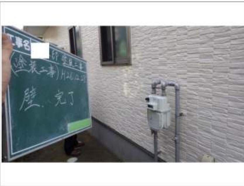
外壁塗装施工完了
