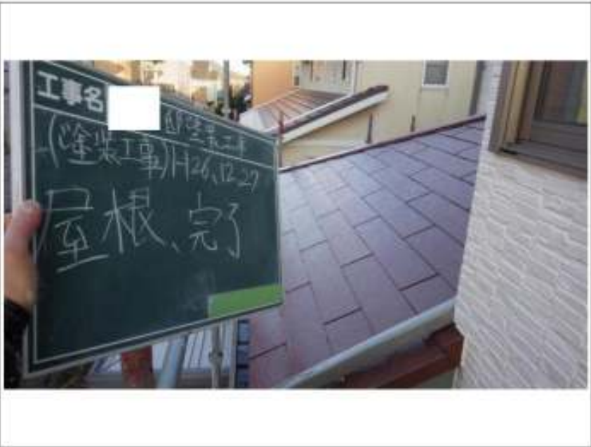
屋根塗装施工完了
