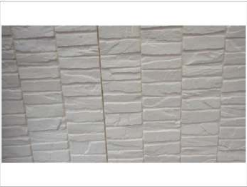
外壁塗装中塗り施工完了
