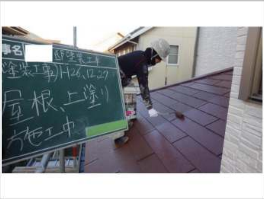
屋根塗装上塗り施工中
