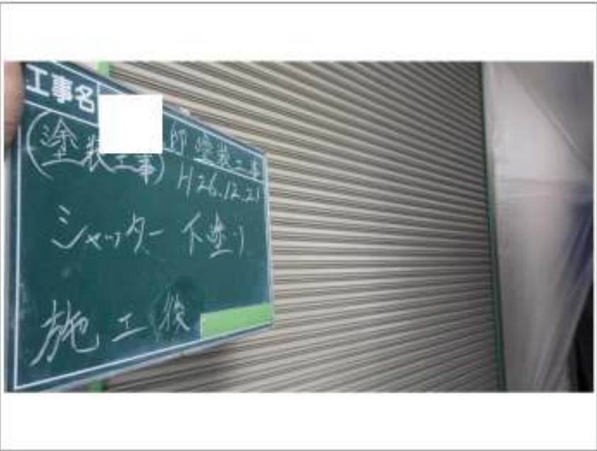
シャッター塗装下塗り施工完了
