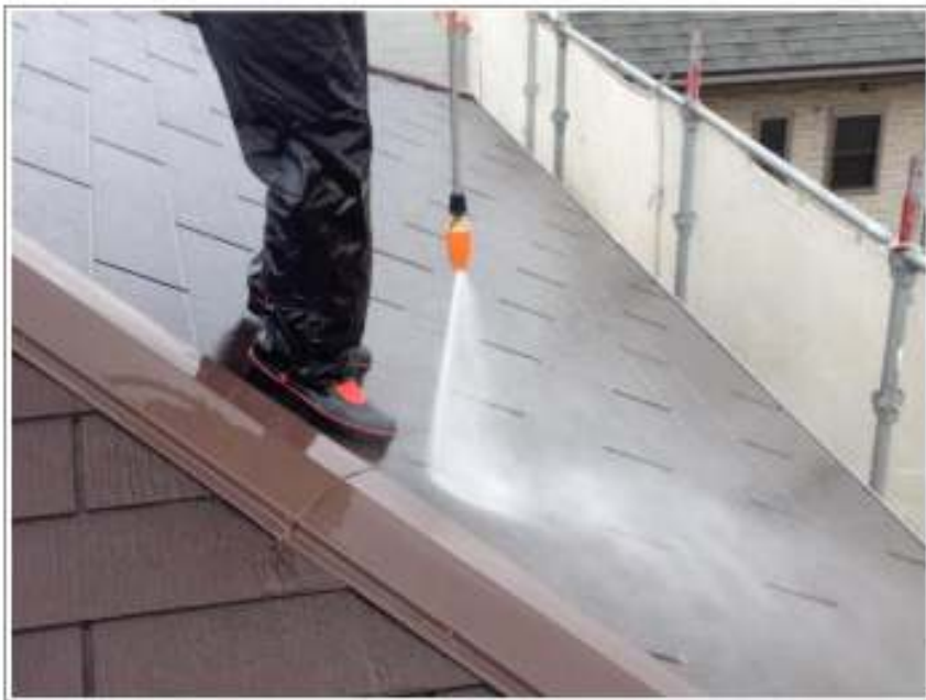
屋根高圧洗浄施工中
