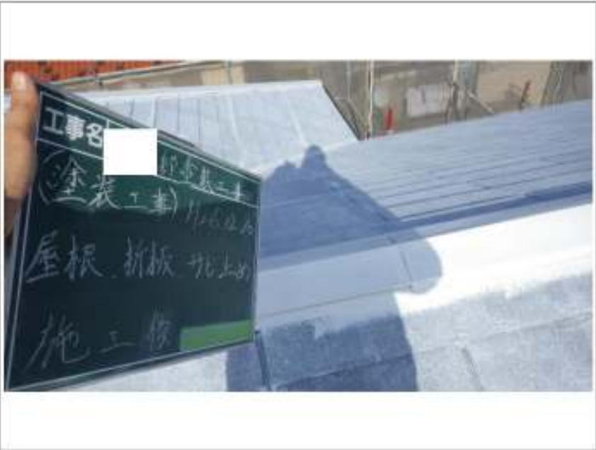
サビ止め施工完了
