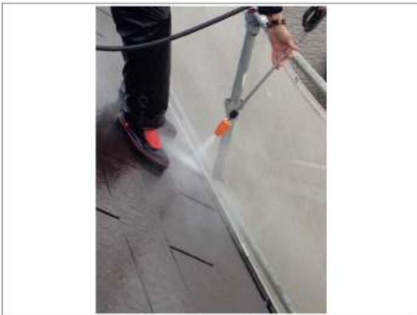
屋根高圧洗浄施工中
