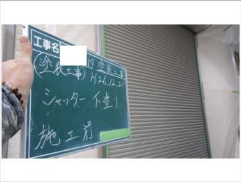
シャッター塗装施工前
