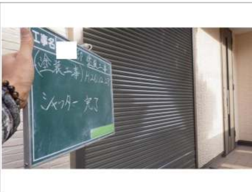
シャッター塗装施工完了
