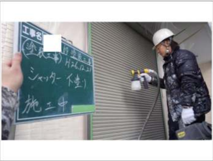
シャッター塗装下塗り施工中
