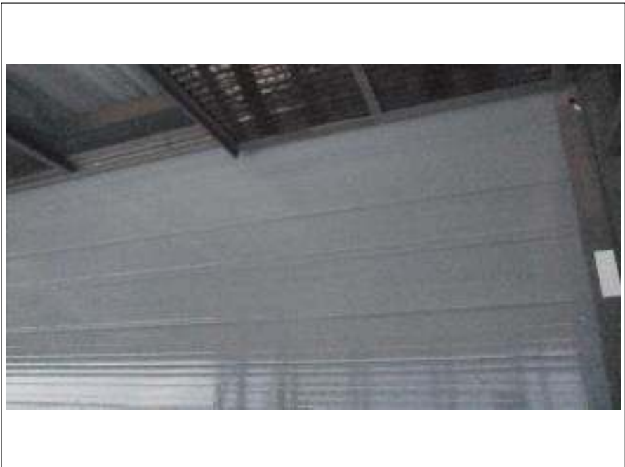
ベランダ床塗装施工完了
