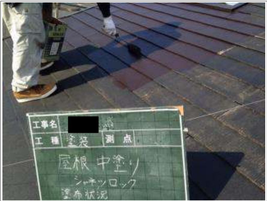
屋根塗装中塗り施工中
