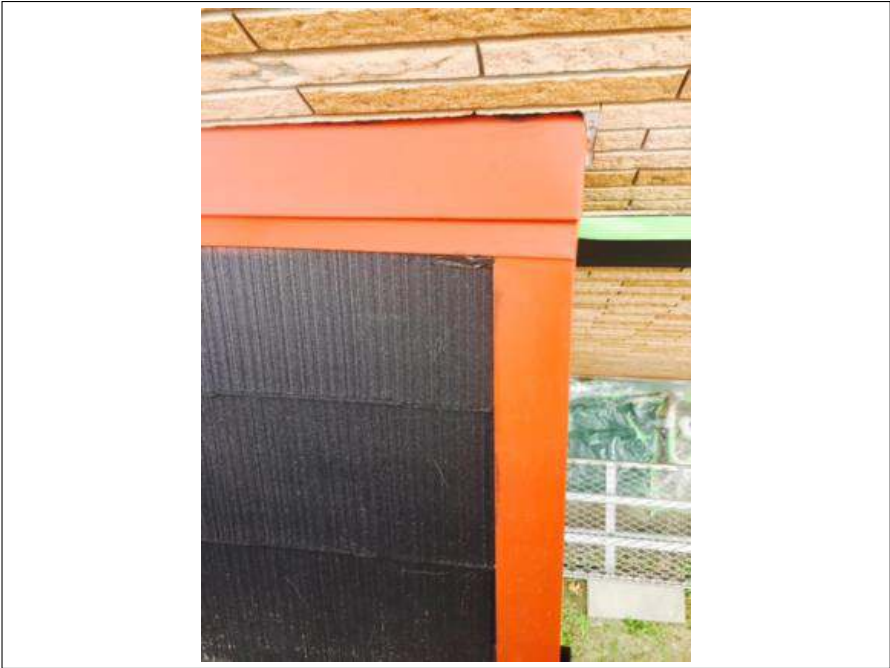
棟鉄板サビ止め施工完了
