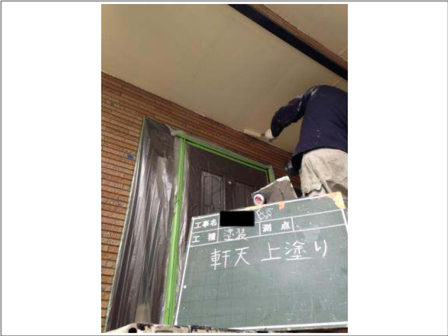
軒天塗装 2回目施工中
