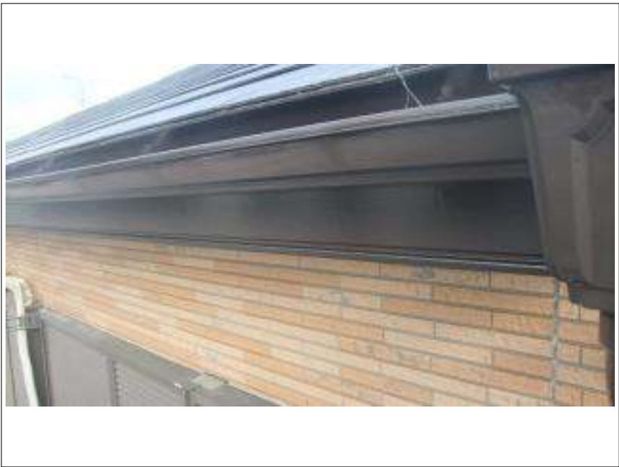
樋塗装施工完了
