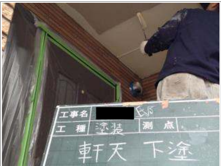
軒天塗装 1回目施工中
