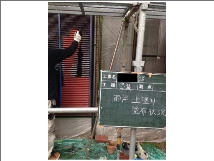
雨戸塗装 2回目施工中
