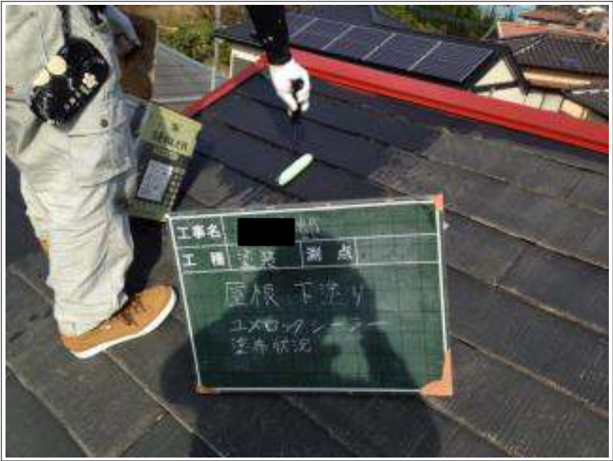
屋根塗装下塗り施工中
