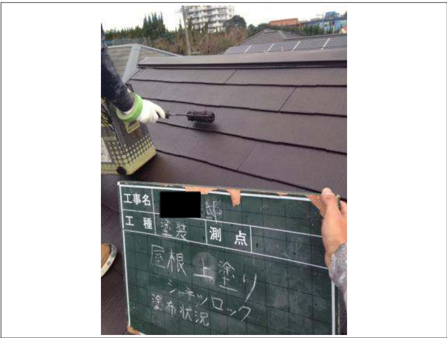
屋根塗装上塗り施工中
