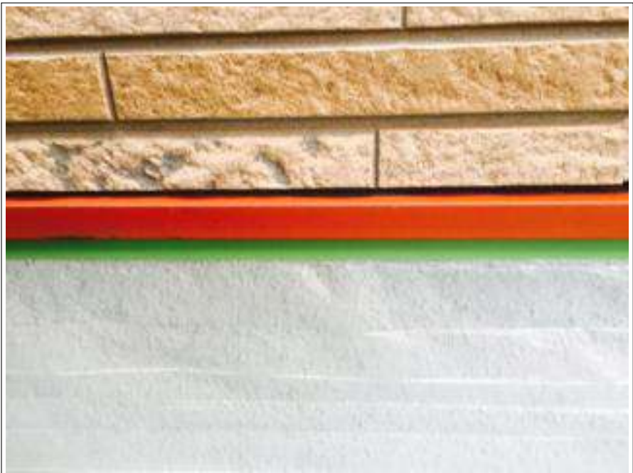
土台水切りサビ止め施工完了
