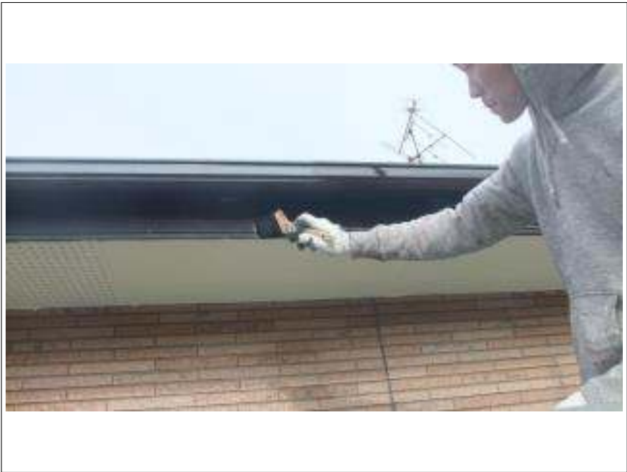
破風板塗装施工中
