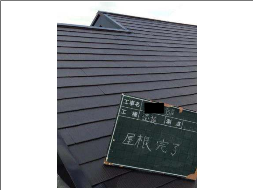
屋根塗装施工完了
