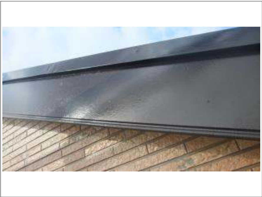
破風板塗装施工完了
