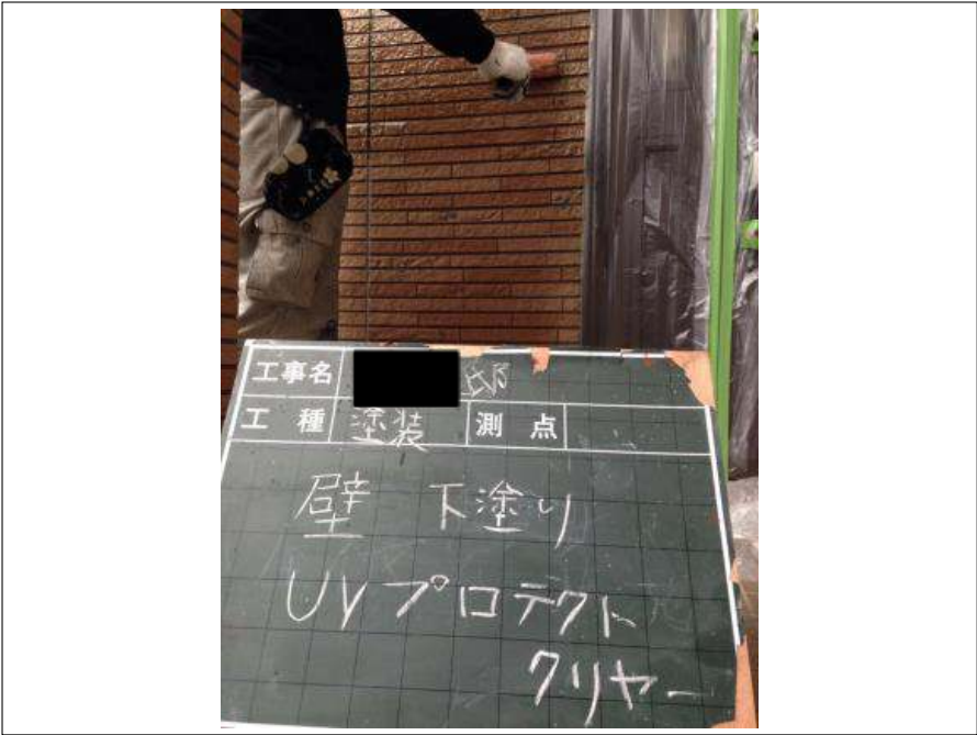
外壁塗装下塗り施工中
