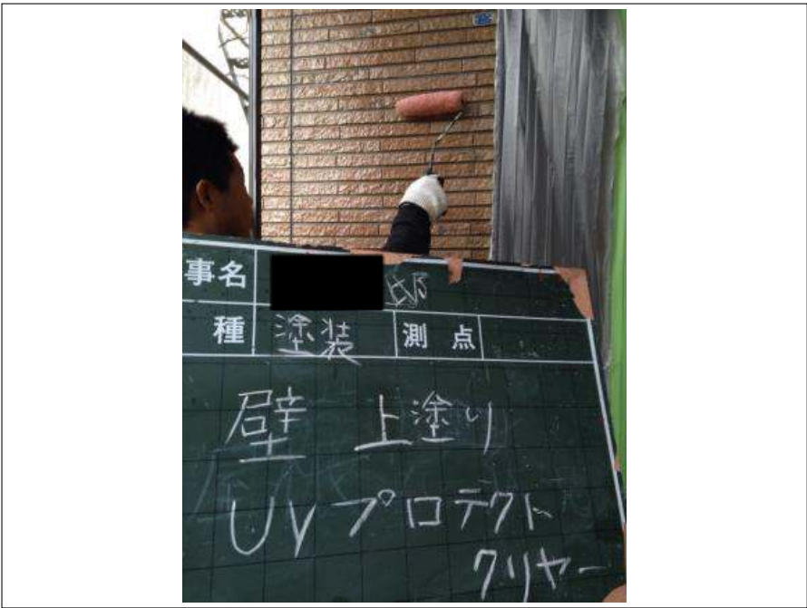
外壁塗装上塗り施工中
