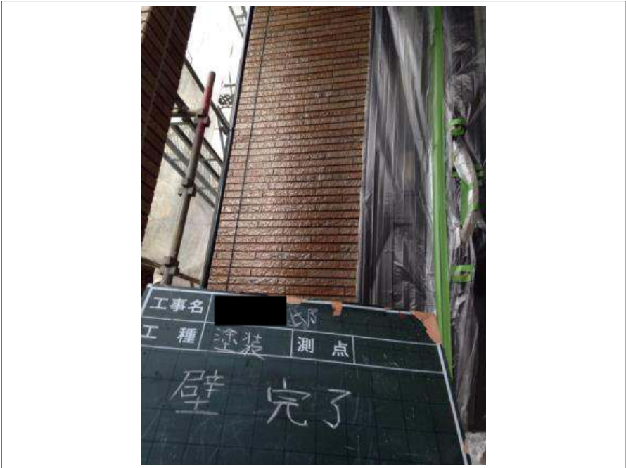
外壁塗装施工完了
