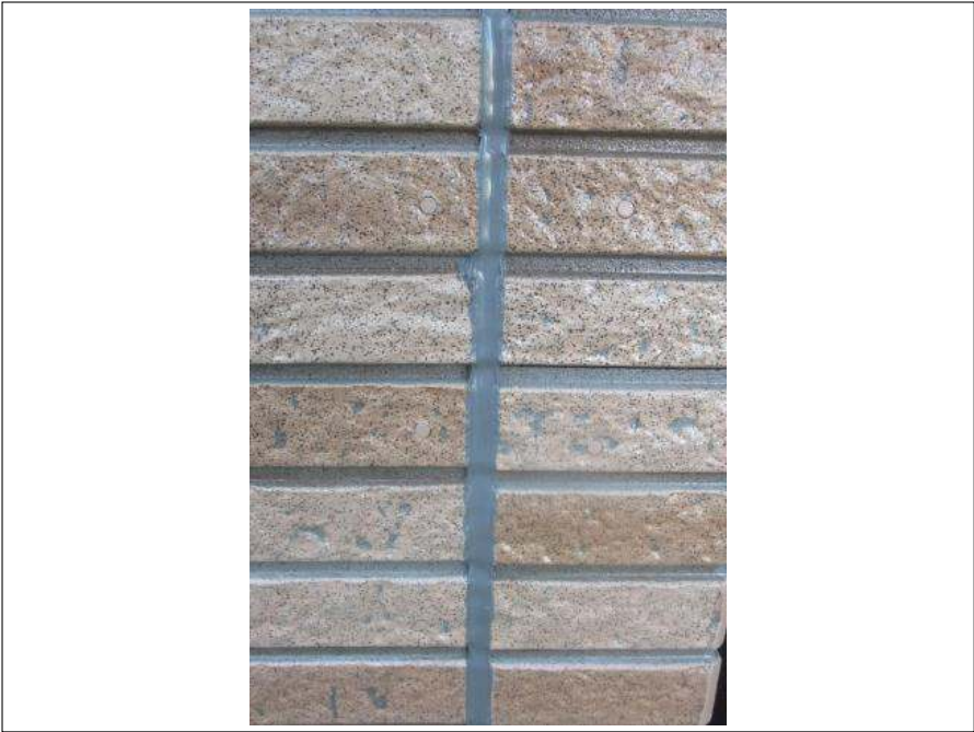
外壁コーキング打替施工完了
