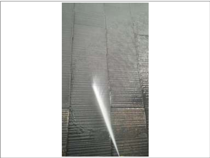
屋根高圧洗浄施工中
