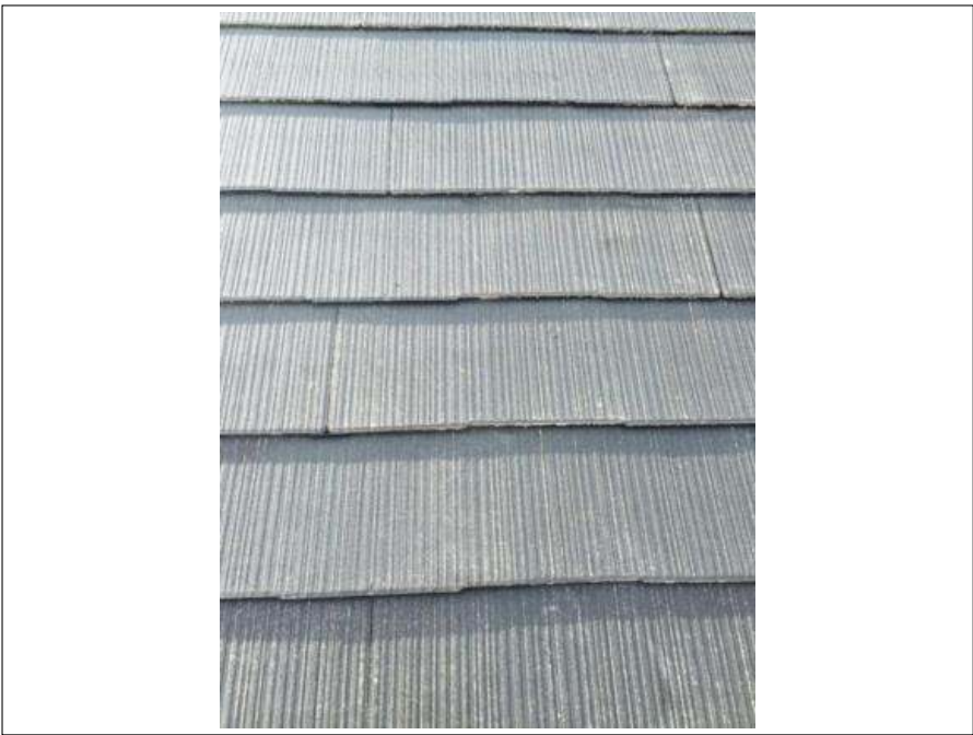
屋根塗装下塗り施工完了
