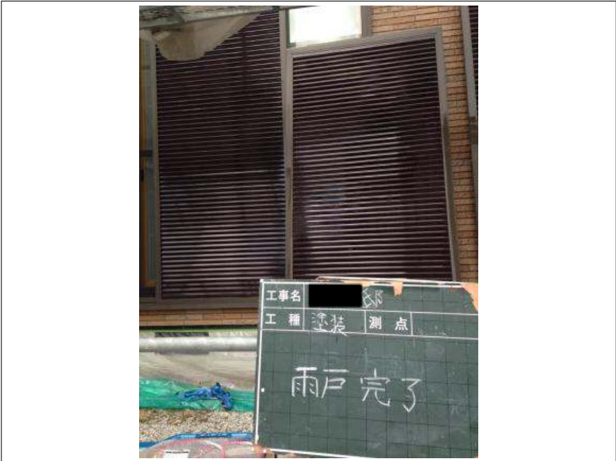
雨戸塗装施工完了
