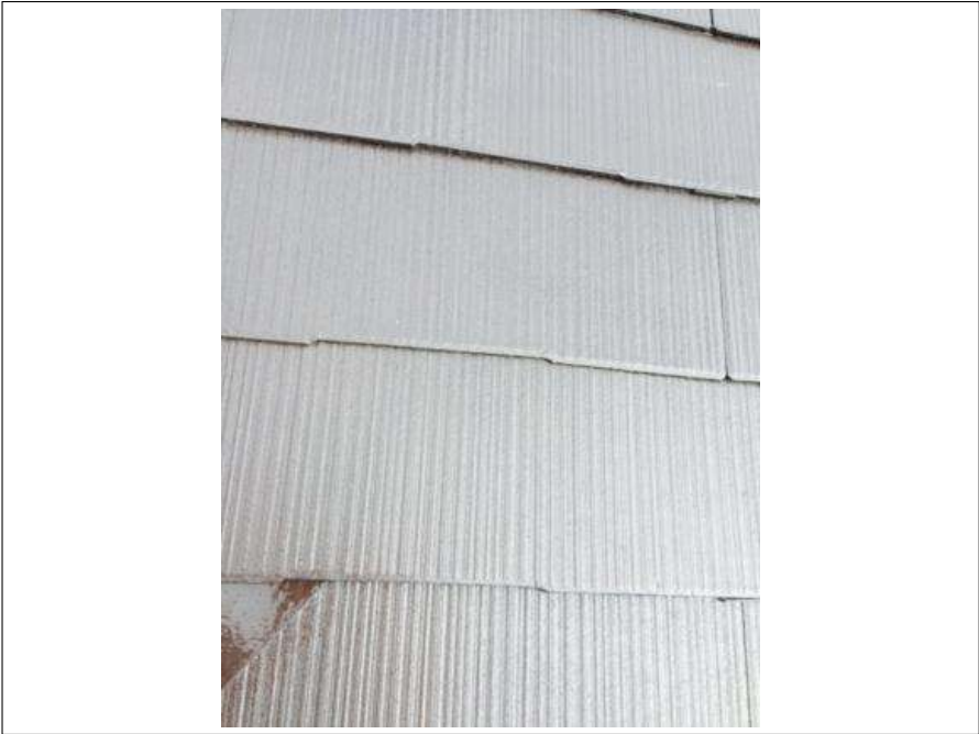
屋根塗装上塗り施工完了
