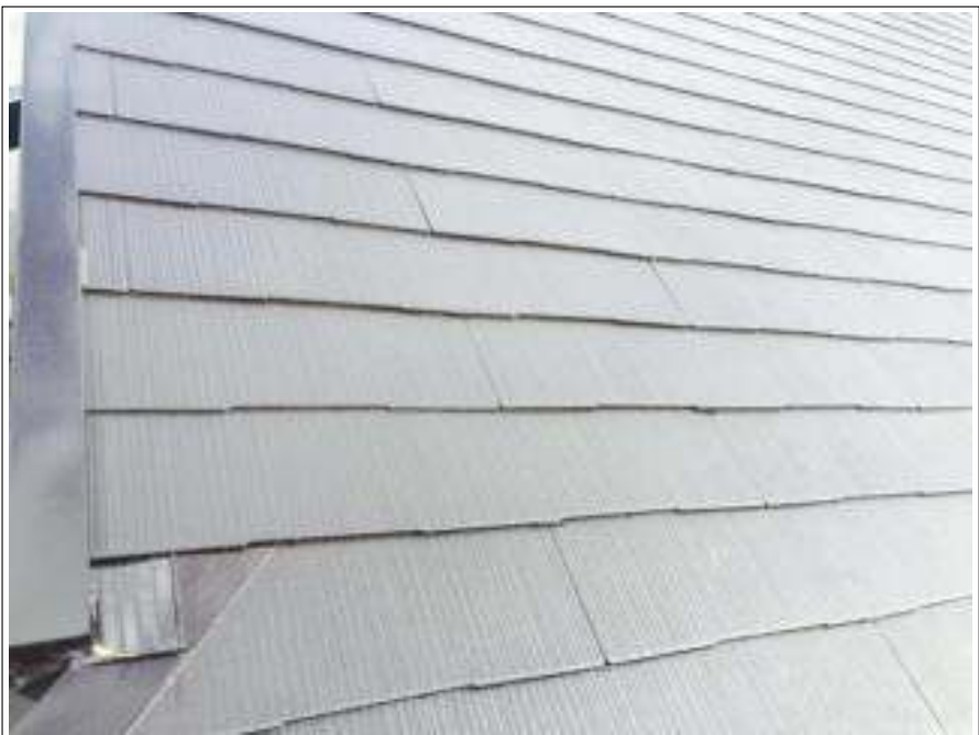
屋根塗装中塗り施工完了
