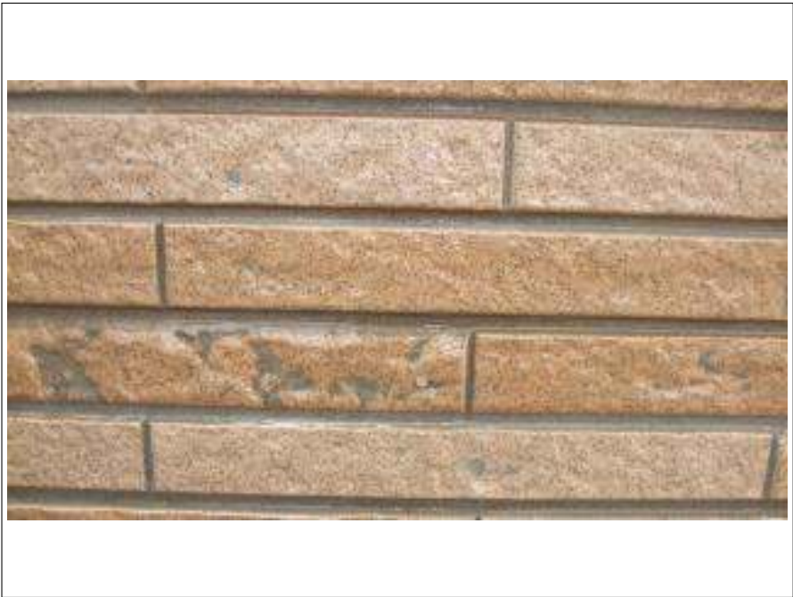
外壁塗装下塗り施工完了
