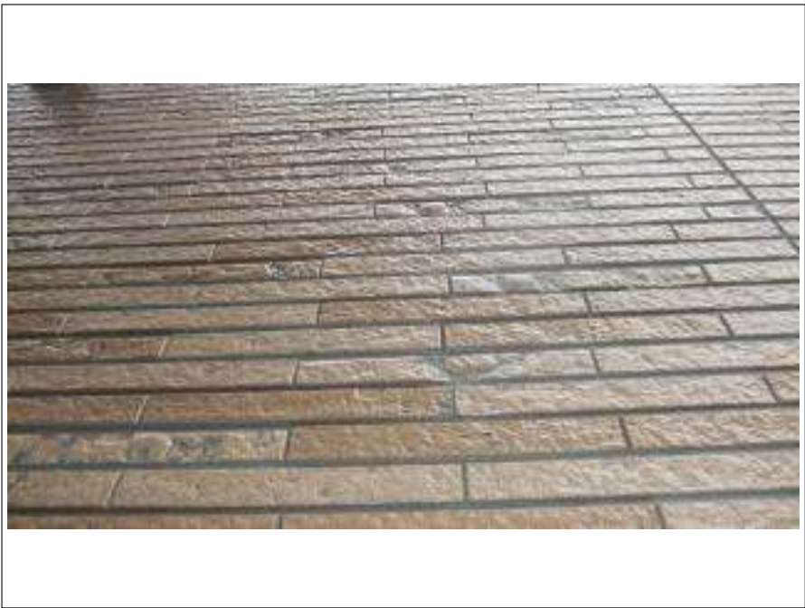
外壁塗装上塗り施工完了
