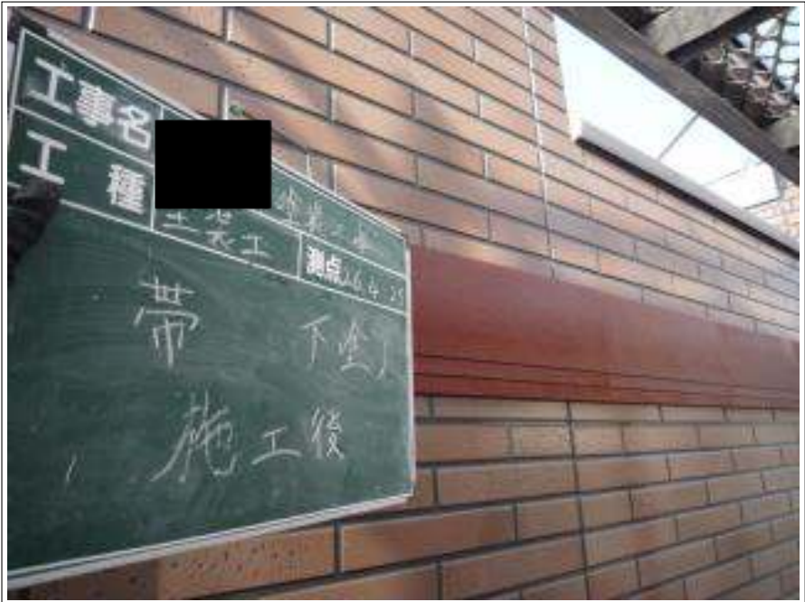
洞差し塗装下塗り施工完了
