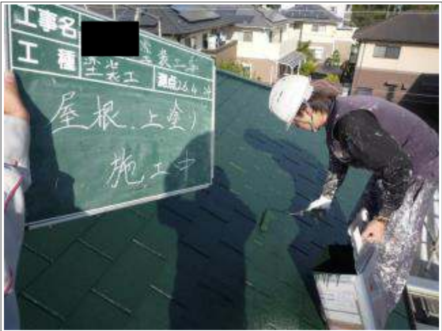
屋根塗装上塗り施工中
