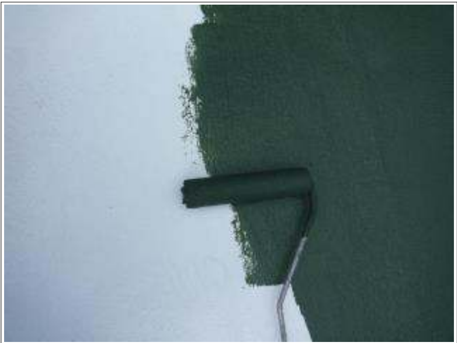
バルコニー防水塗装上塗り施工中
