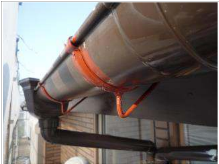
樋金具サビ止め施工完了
