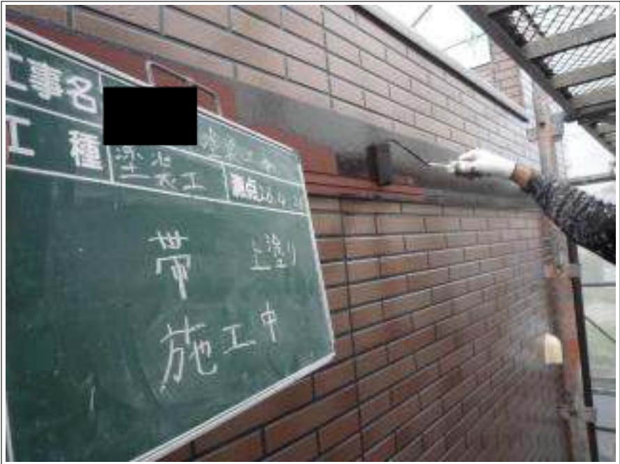
胴差し塗装上塗り施工中
