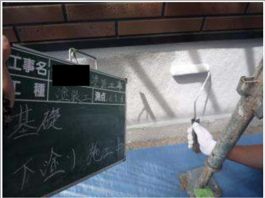
基礎塗装下塗り施工中
