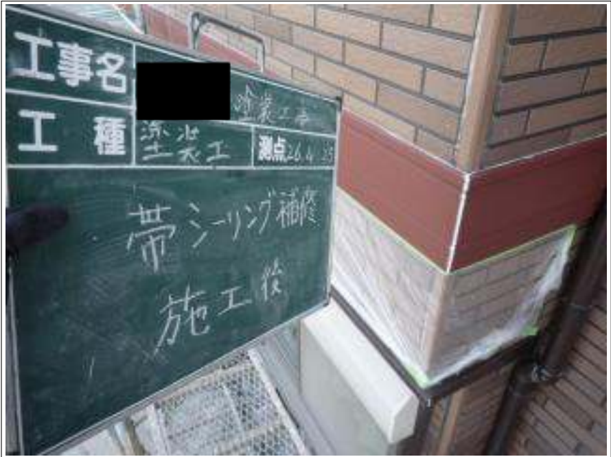
胴差しシーリング補修施工完了
