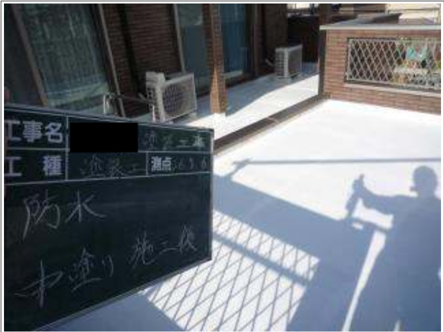
バルコニー防水塗装中塗り施工完了
