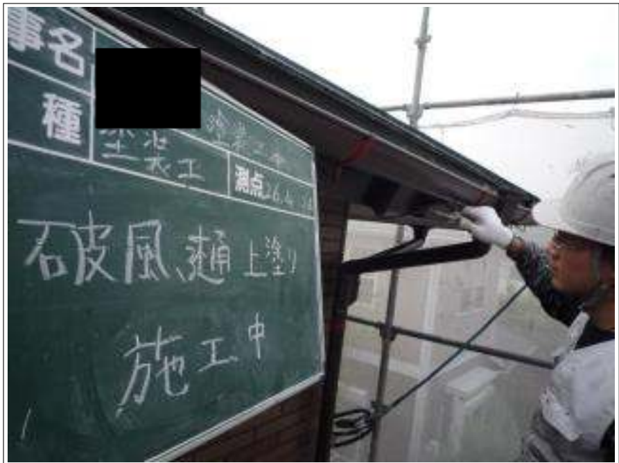
破風板塗装上塗り施工中
