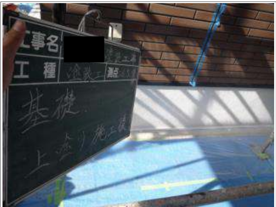
基礎塗装上塗り施工完了
