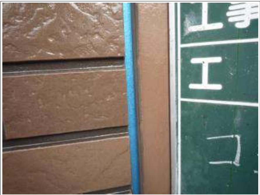
外壁コーキング撤去施工完了
