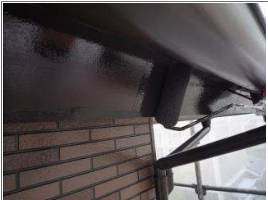
破風板塗装上塗り施工中
