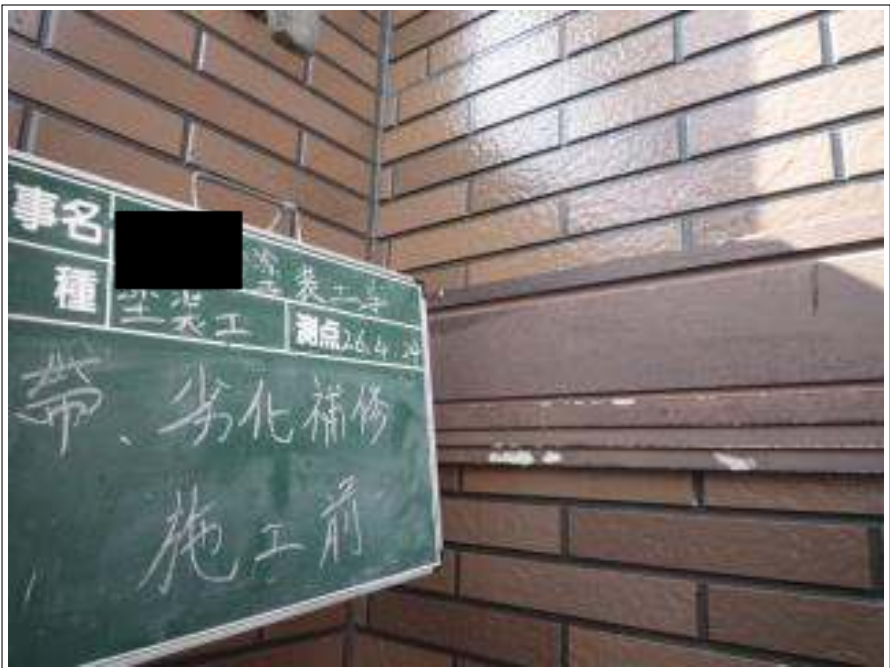
胴差し劣化補修施工前
