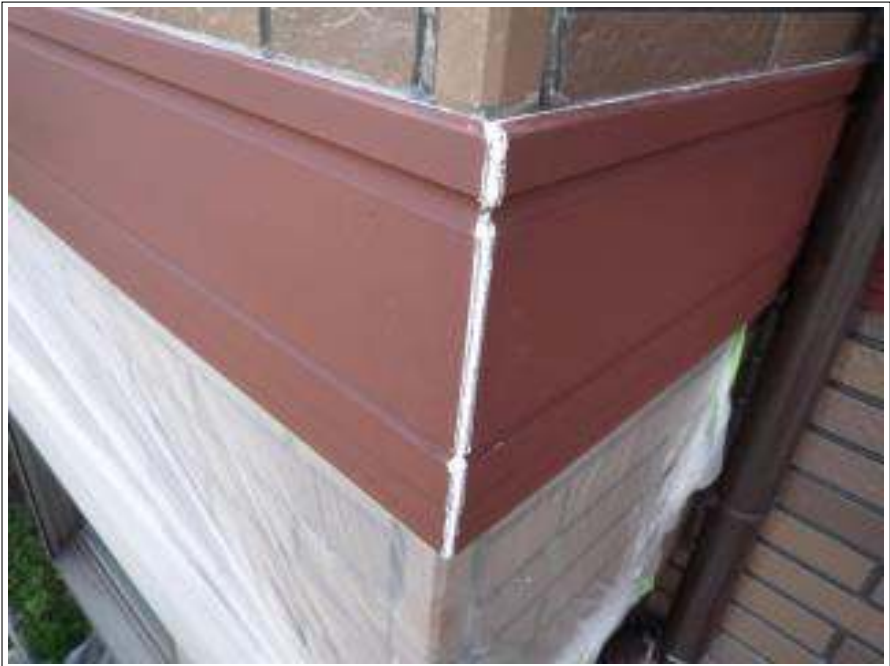
胴差しシーリング補修施工完了
