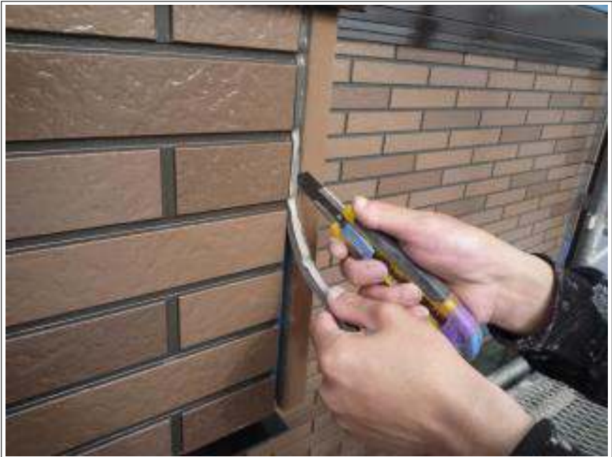
外壁コーキング撤去施工中
