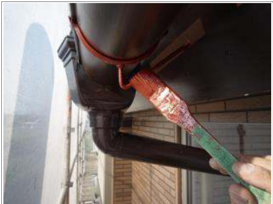
樋金具サビ止め施工中
