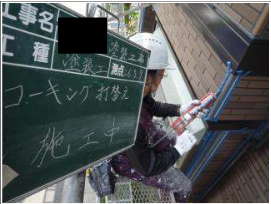
外壁コーキング打替え施工中
