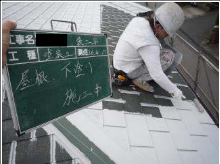
屋根塗装下塗り施工中
