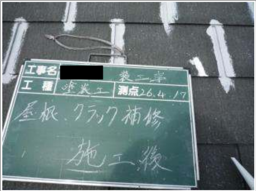
屋根クラック補修施工完了
