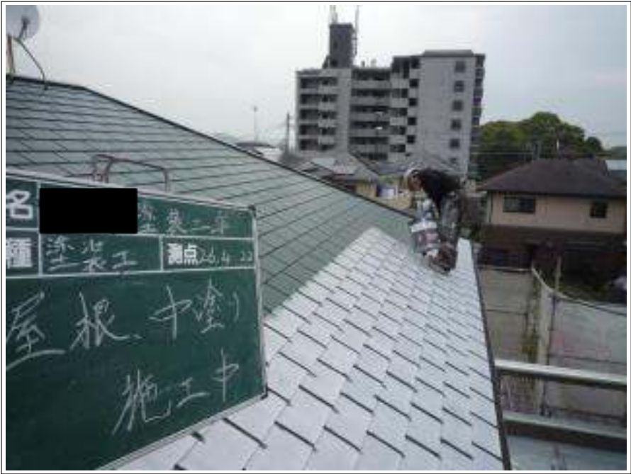
屋根塗装中塗り施工中
