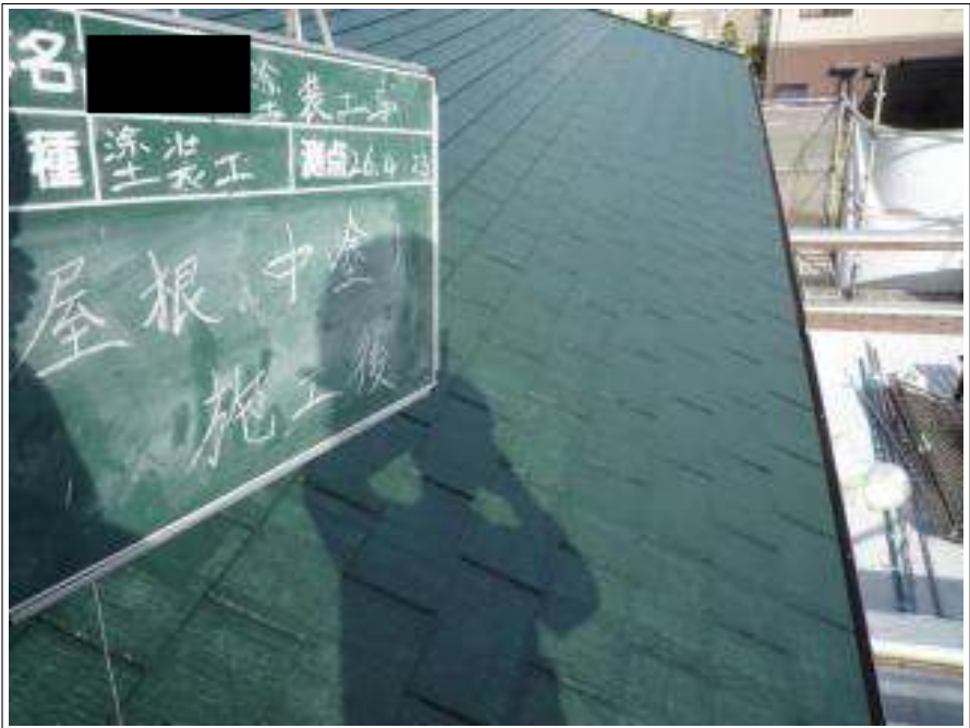
屋根塗装中塗り施工完了
