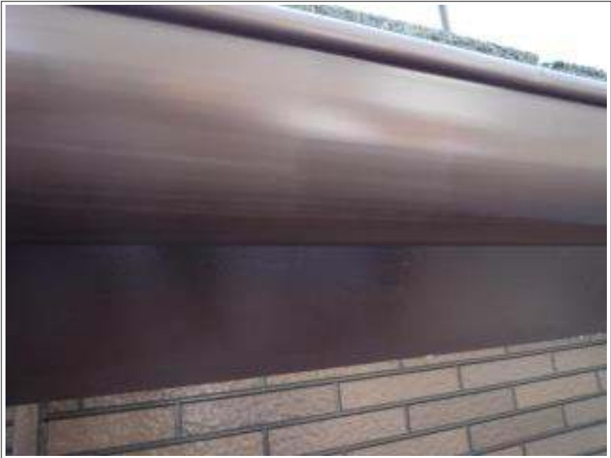
樋、破風板塗装下塗り施工完了
