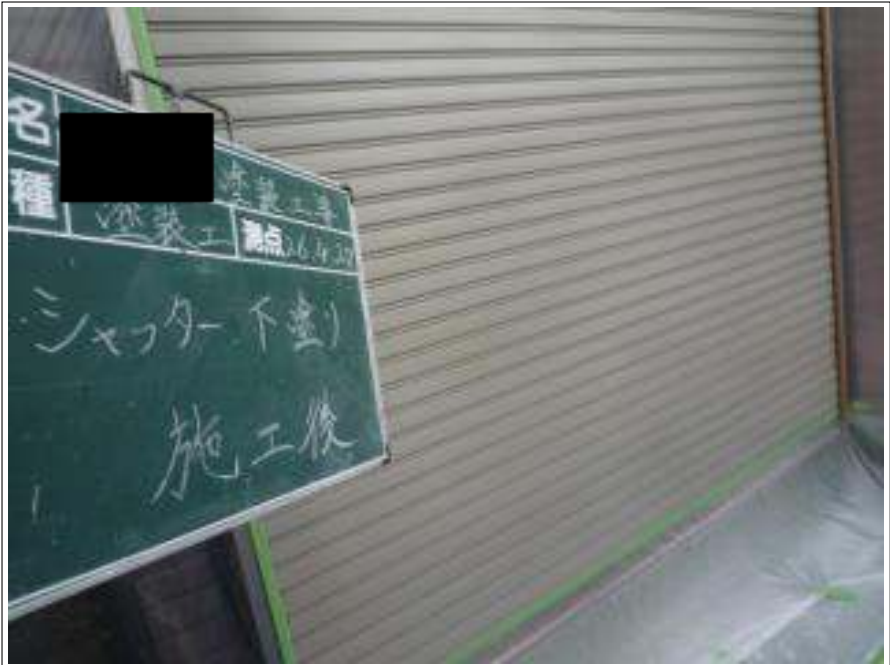
シャッター塗装下塗り施工完了
