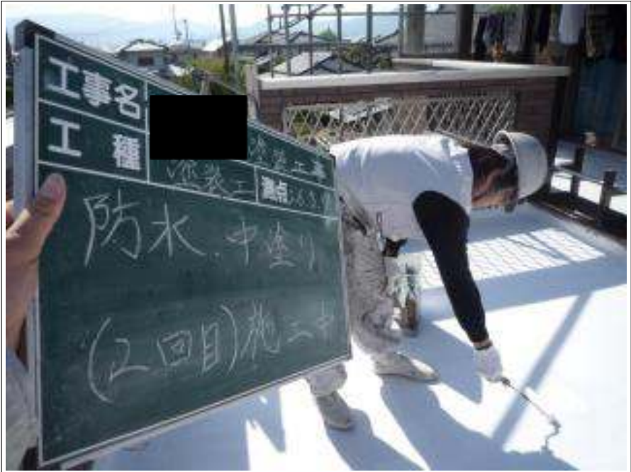
バルコニー防水塗装中塗り施工中
