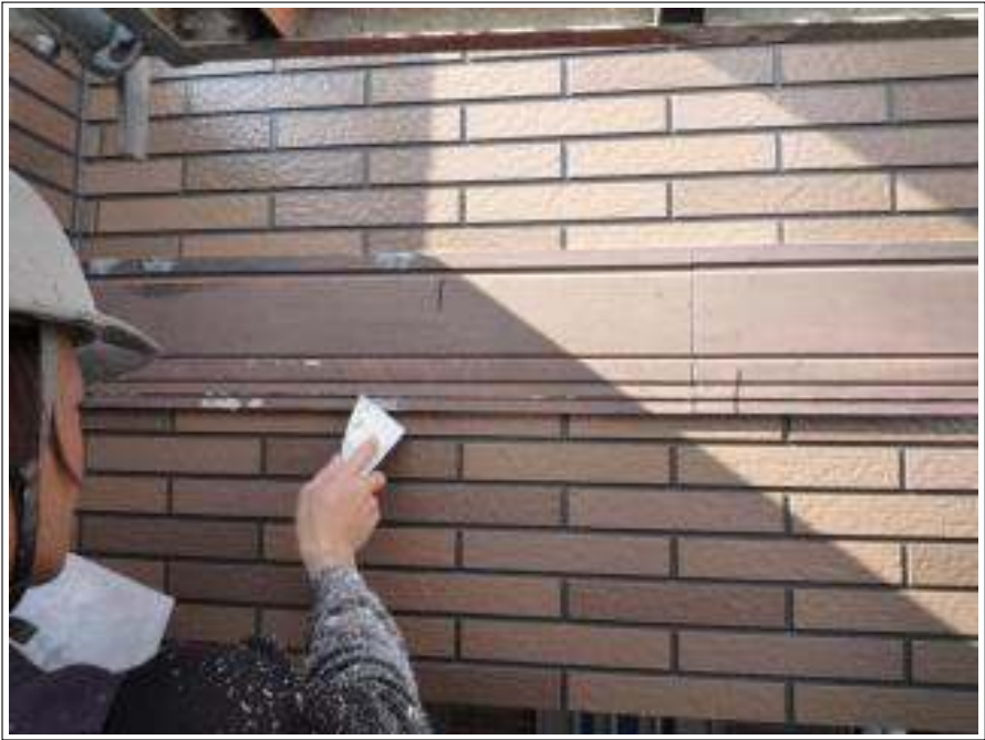
胴差し劣化補修施工中
