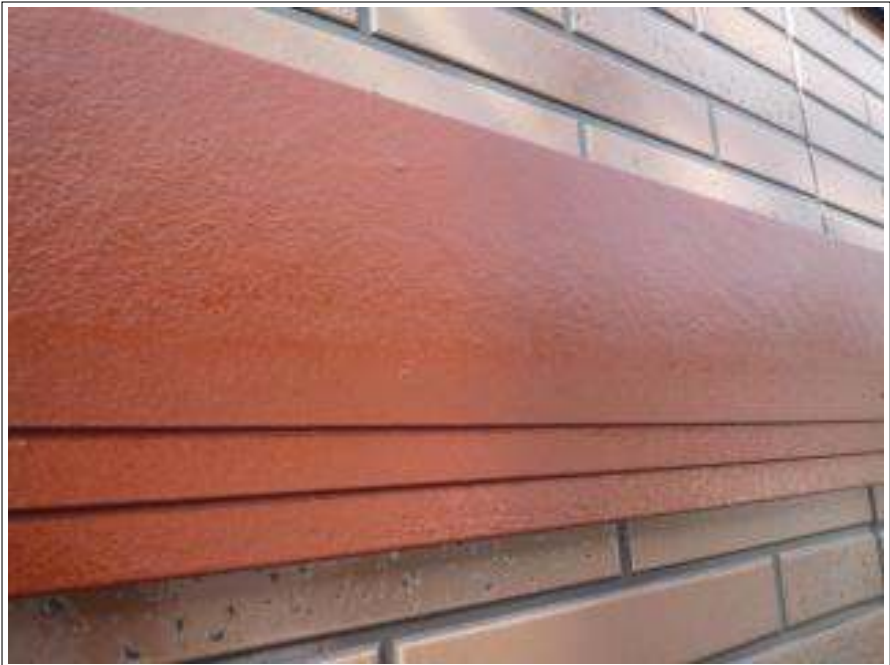
胴差し塗装下塗り施工完了
