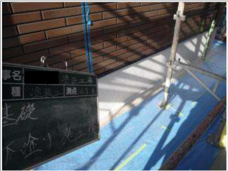
基礎塗装下塗り施工完了
