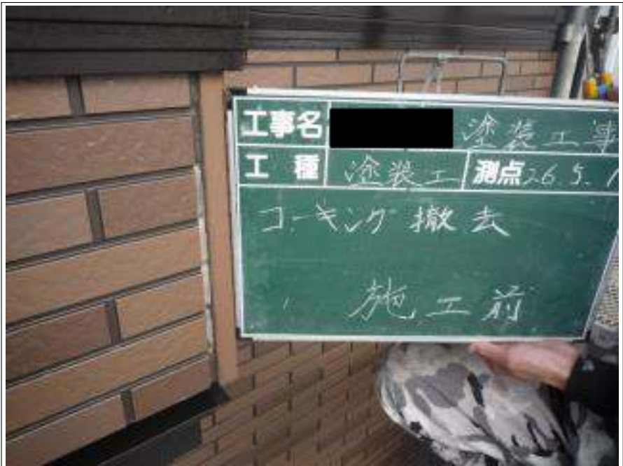
外壁コーキング撤去施工前
