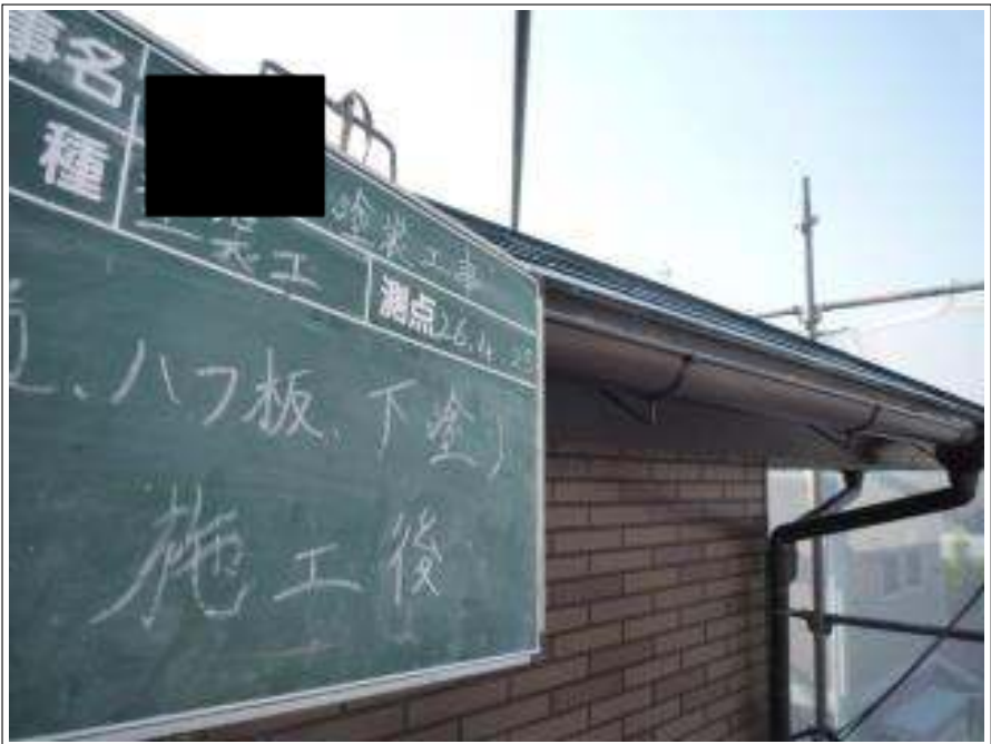
樋、破風板塗装下塗り施工完了
