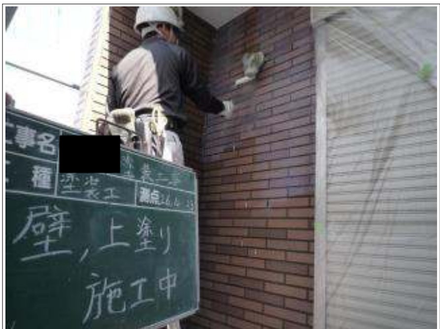
外壁塗装上塗り施工中
