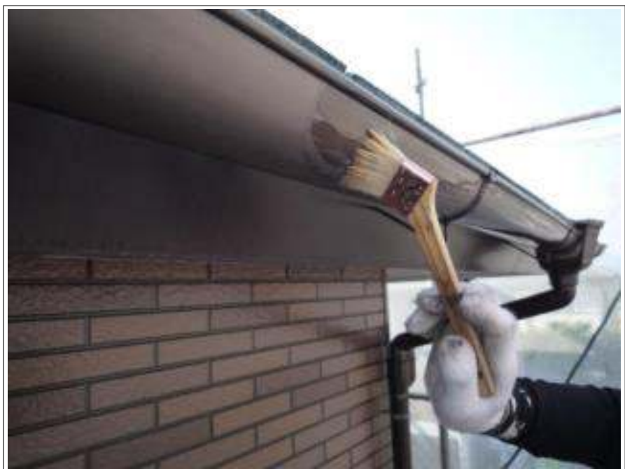
樋塗装下塗り施工中
