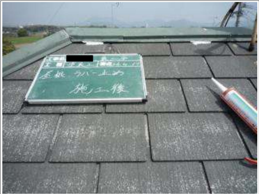
屋根ラバー止め施工完了
