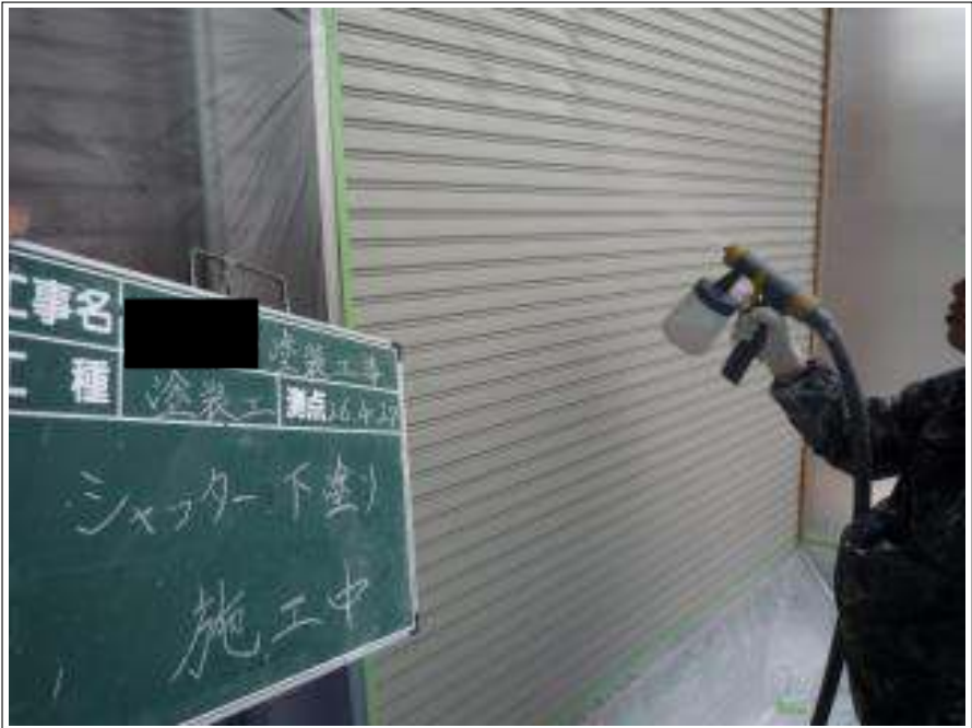
シャッター塗装下塗り施工中
