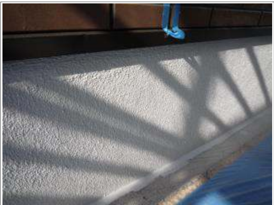
基礎塗装施工完了
