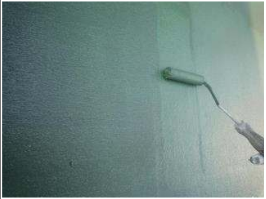
バルコニー防水塗装上塗り施工中
