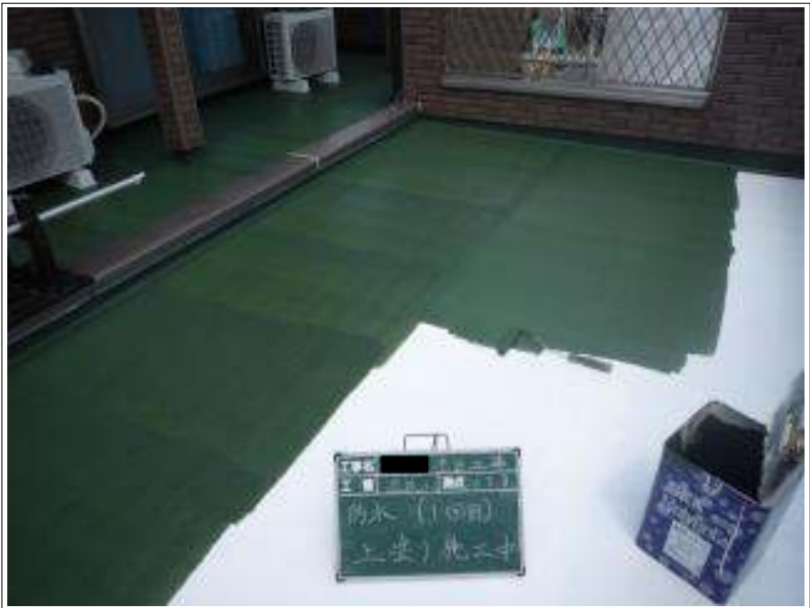
バルコニー防水塗装上塗り施工中
