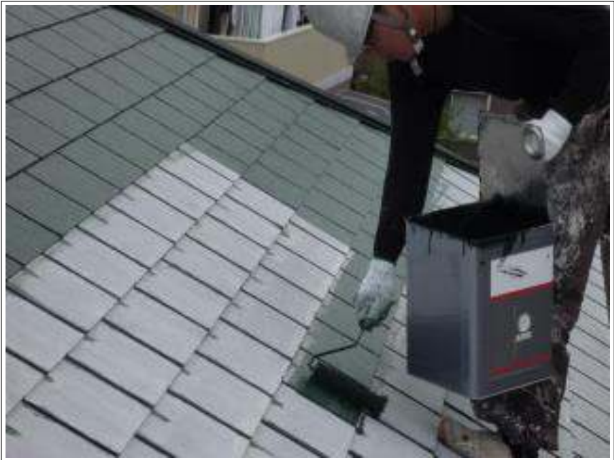
屋根塗装中塗り施工中
