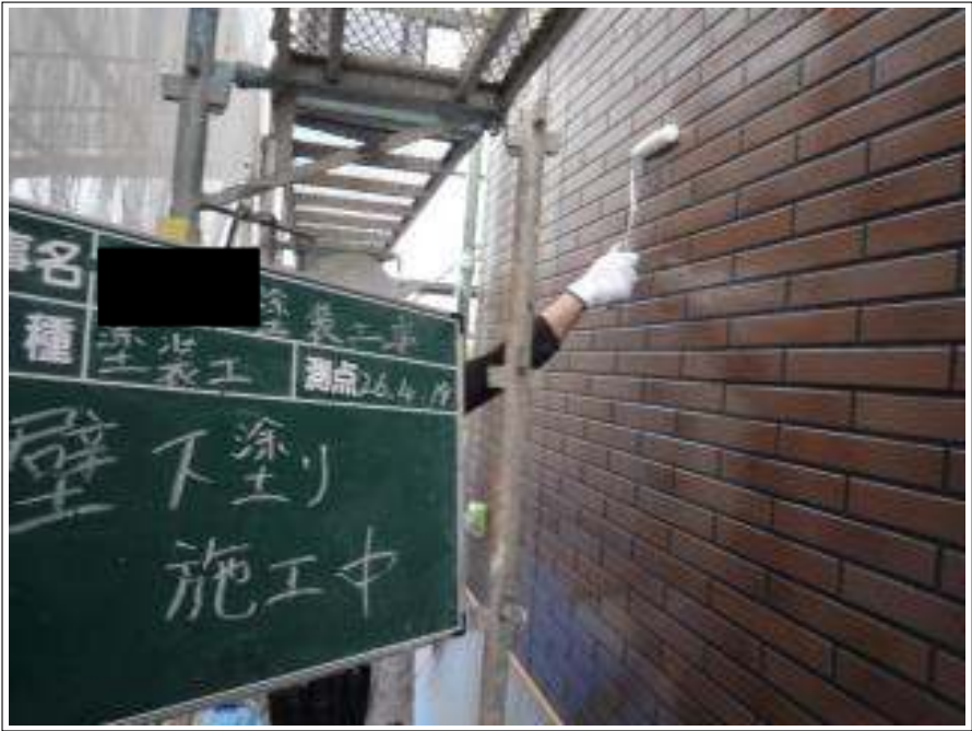
外壁塗装下塗り施工中
