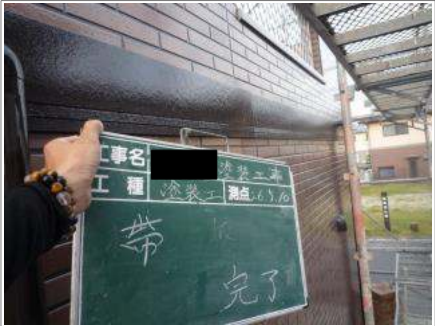
胴差し塗装施工完了
