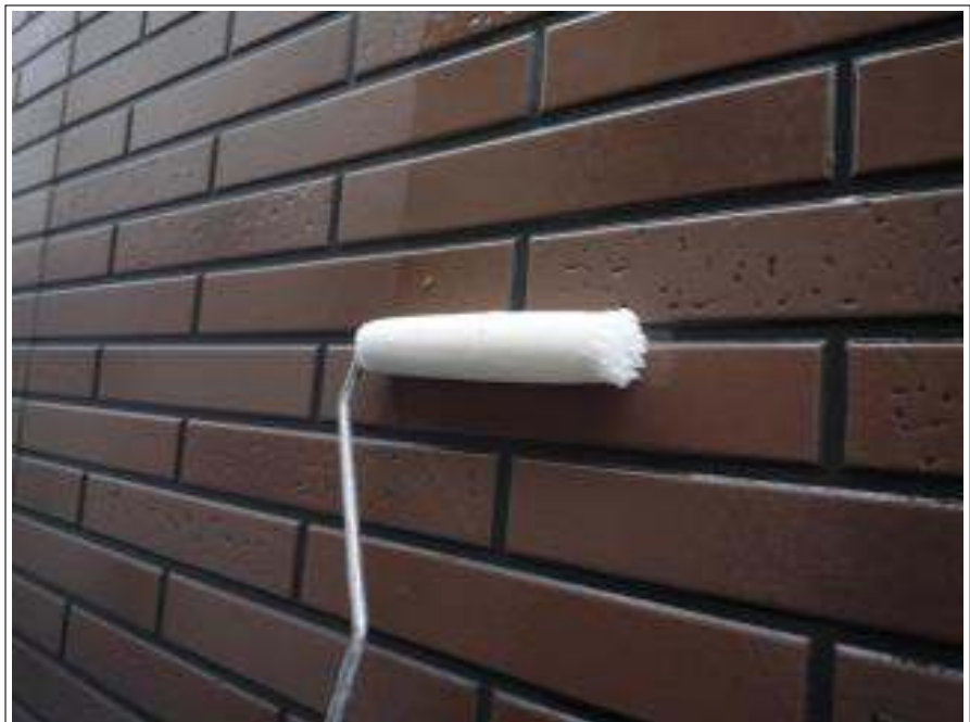
外壁塗装下塗り施工中
