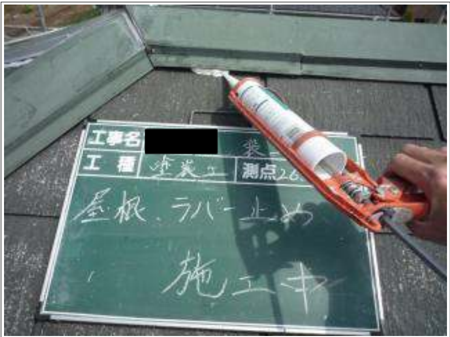
屋根ラバー止め施工中
