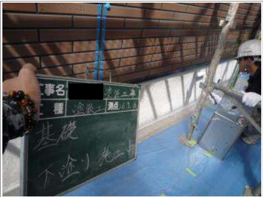
基礎塗装下塗り施工中
