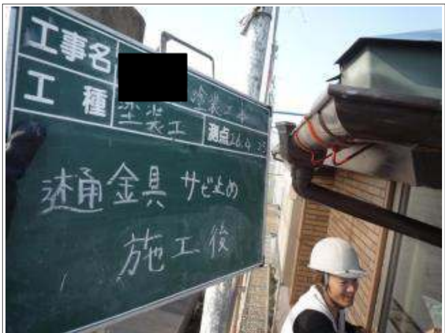
樋金具サビ止め施工完了
