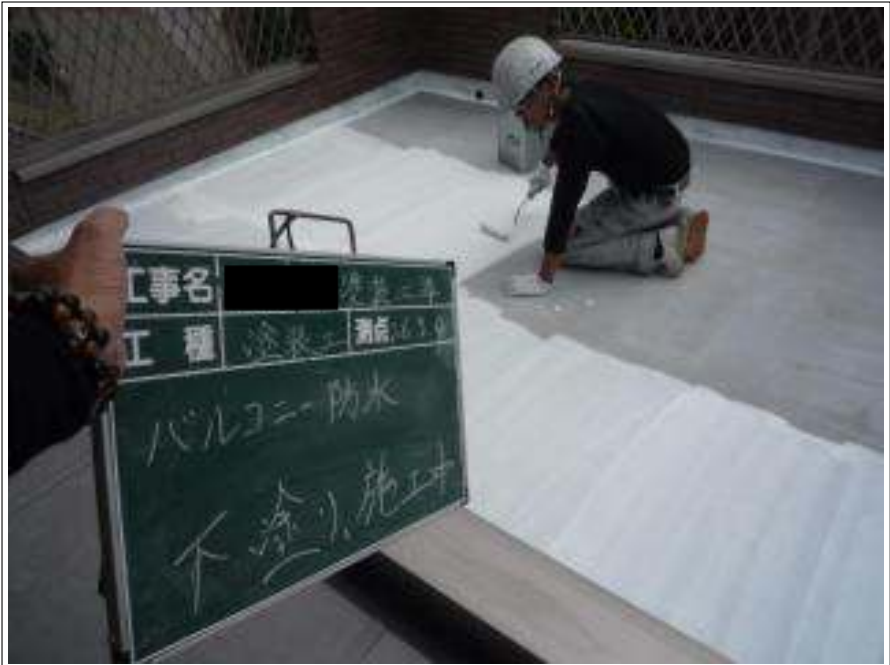
バルコニー防水塗装下塗り施工中
