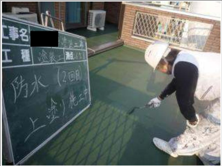
バルコニー防水塗装上塗り施工中
