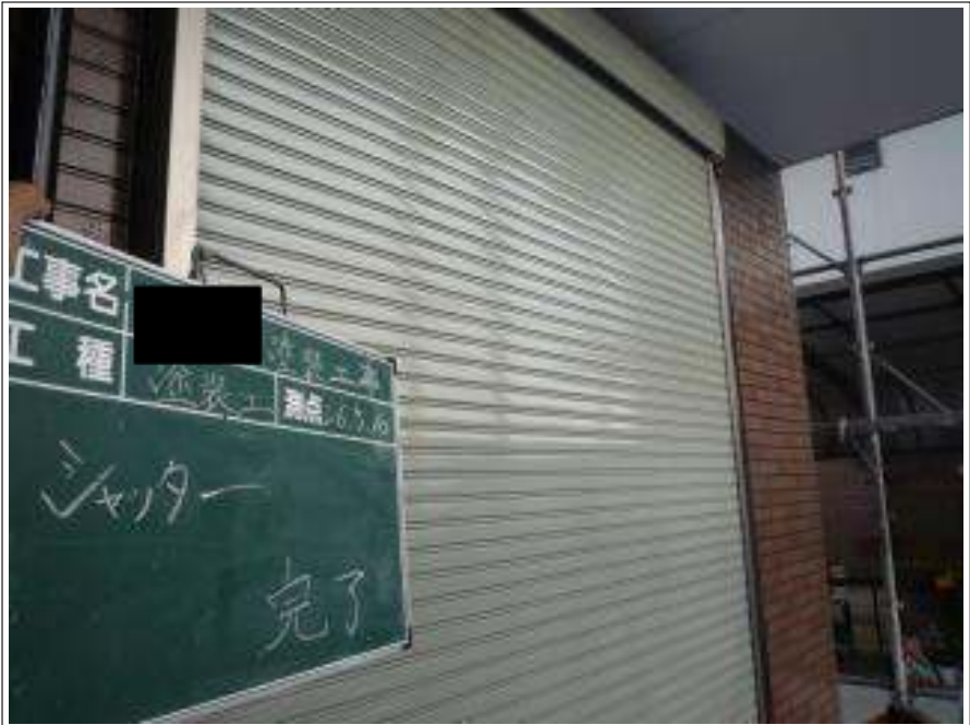
シャッター塗装施工完了
