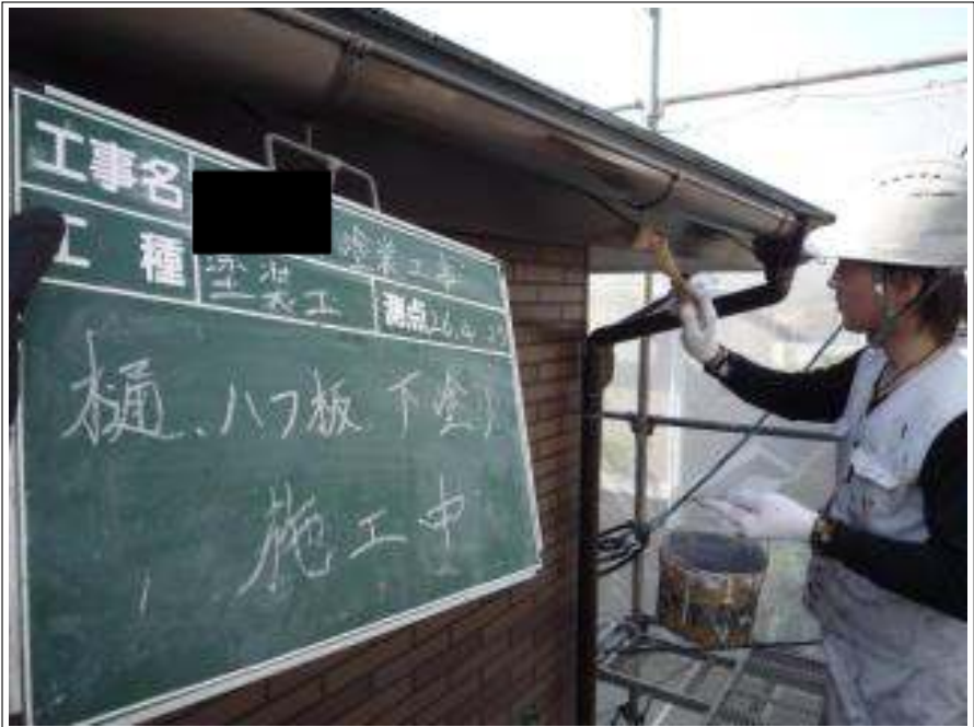
破風板塗装下塗り施工中
