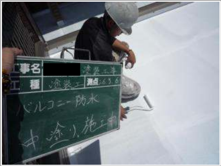
バルコニー防水塗装中塗り施工中
