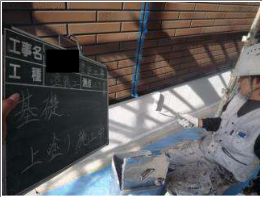
基礎塗装上塗り施工中
