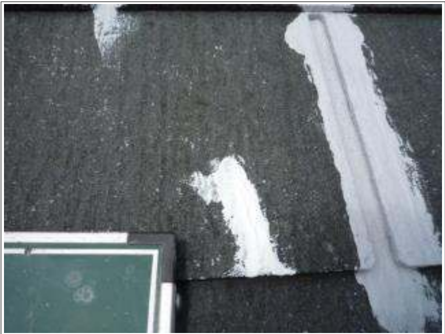
屋根クラック補修施工完了
