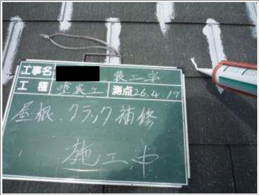
屋根クラック補修施工中
