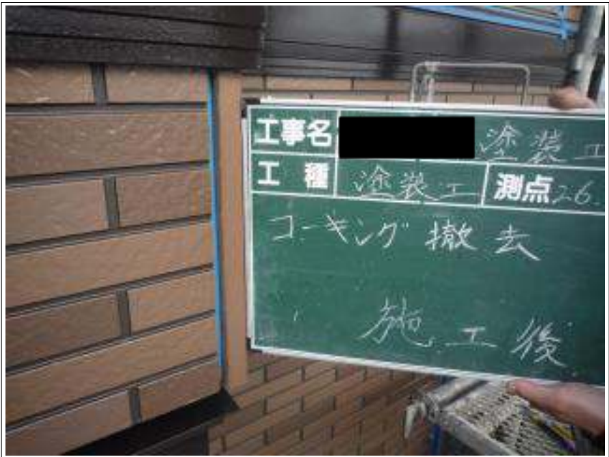
外壁コーキング撤去施工完了
