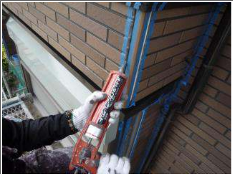
外壁コーキング打替え施工中
