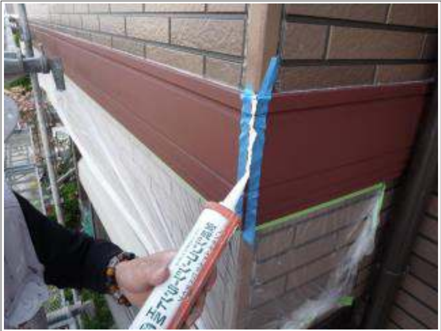
胴差しシーリング補修施工中
