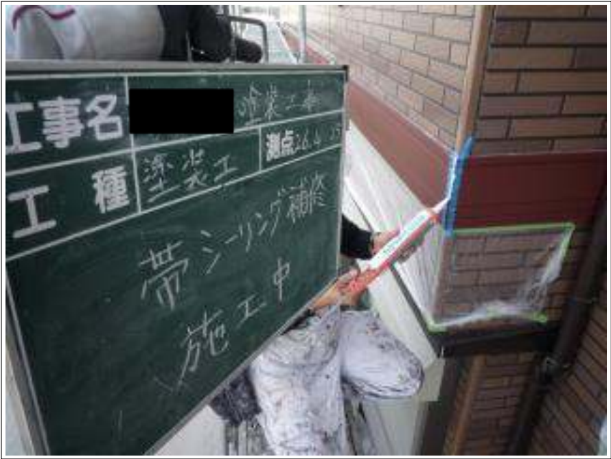
胴差しシーリング補修施工中
