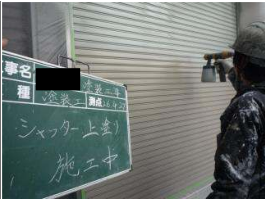
シャッター塗装上塗り施工中
