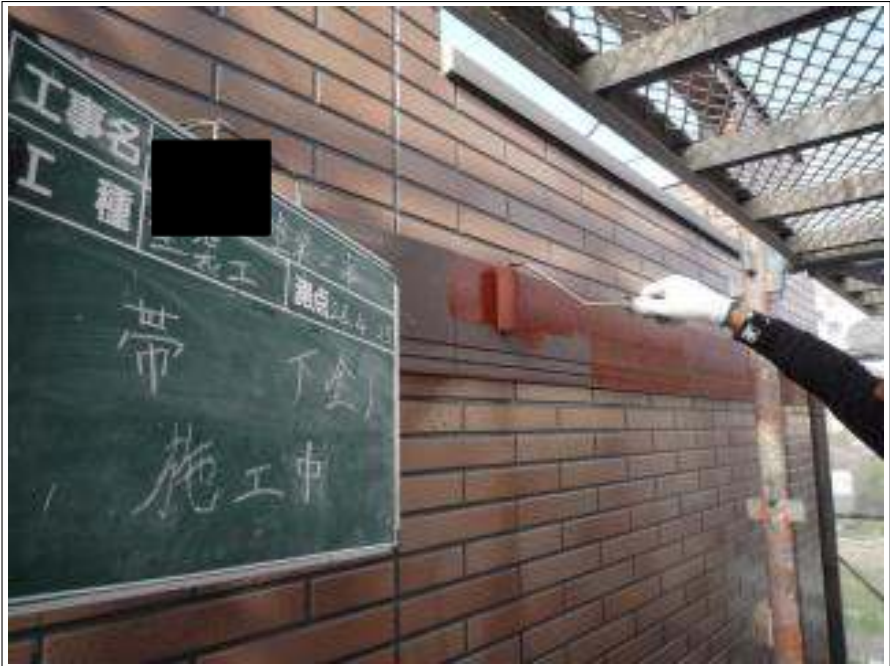
洞差し塗装下塗り施工中
