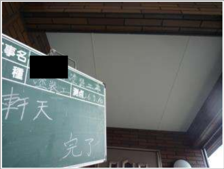
軒天塗装施工完了
