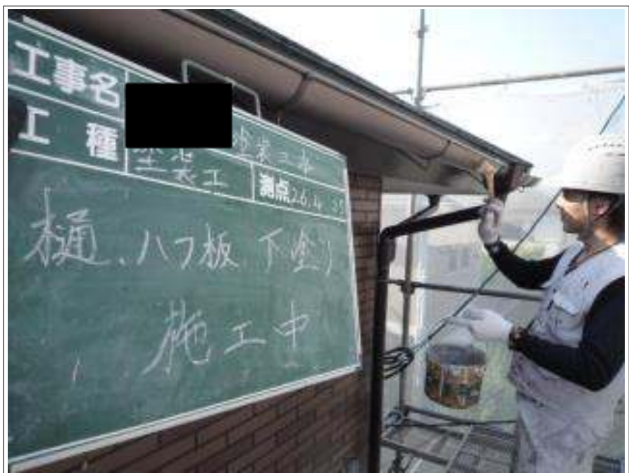
樋塗装下塗り施工中
