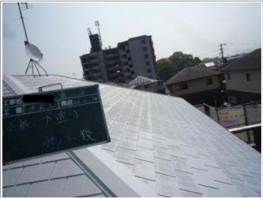
屋根塗装下塗り施工完了
