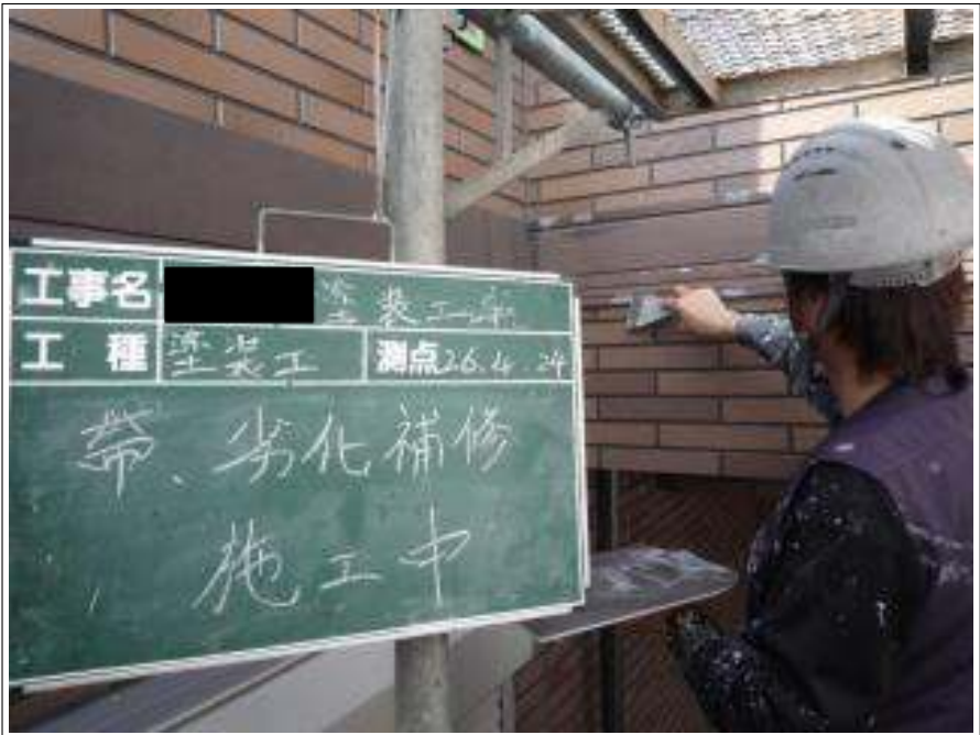
胴差し劣化補修施工中
