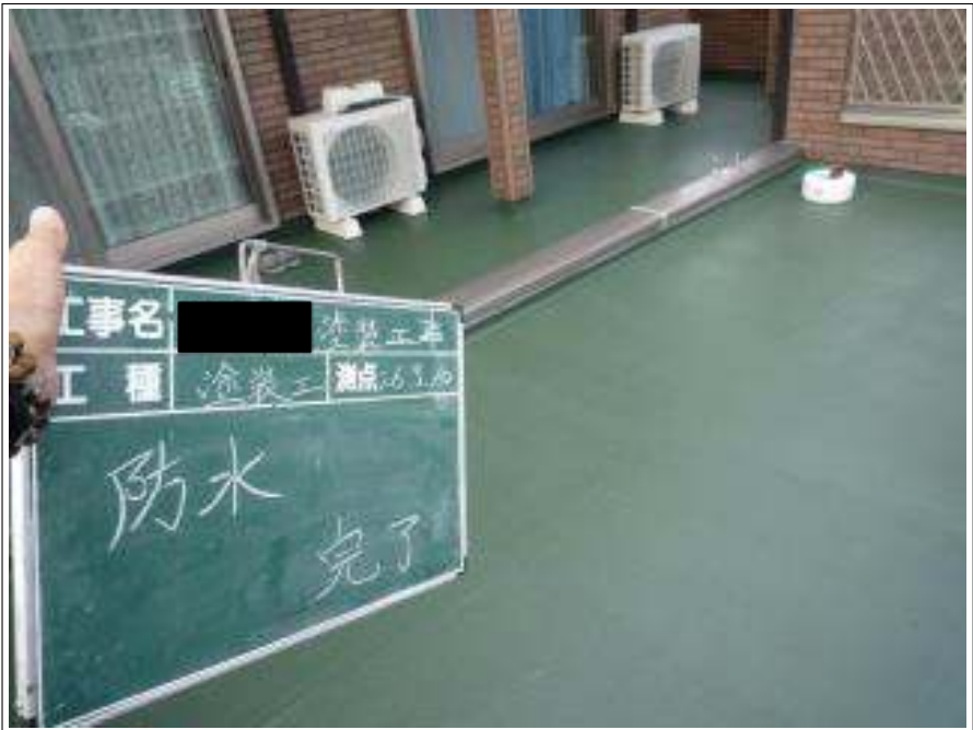
バルコニー防水塗装施工完了
