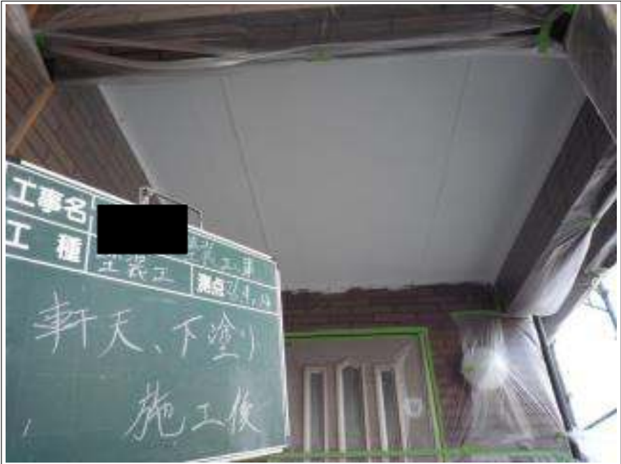
軒天塗装下塗り施工完了
