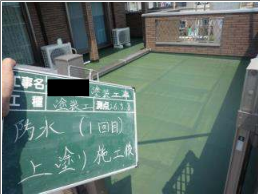
バルコニー防水塗装上塗り施工完了
