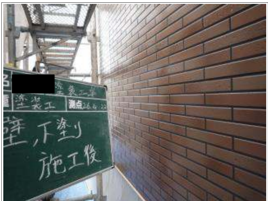
外壁塗装下塗り施工完了
