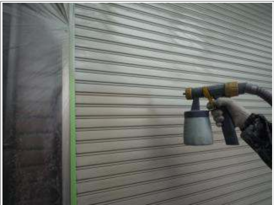
シャッター塗装上塗り施工中
