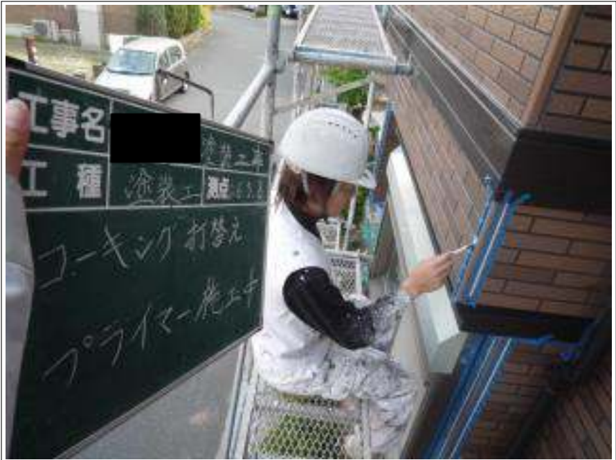
外壁コーキングプライマー施工中
