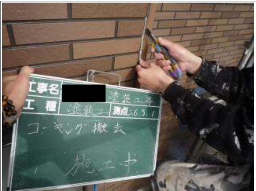
外壁コーキング撤去施工中
