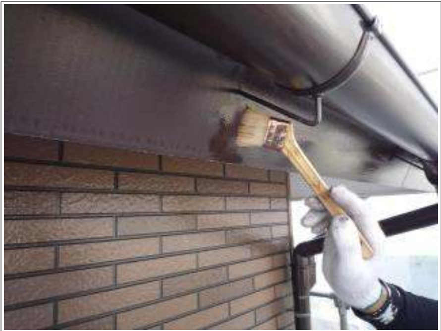
破風板塗装下塗り施工中
