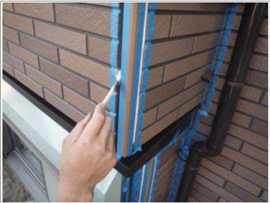
外壁コーキングプライマー施工中
