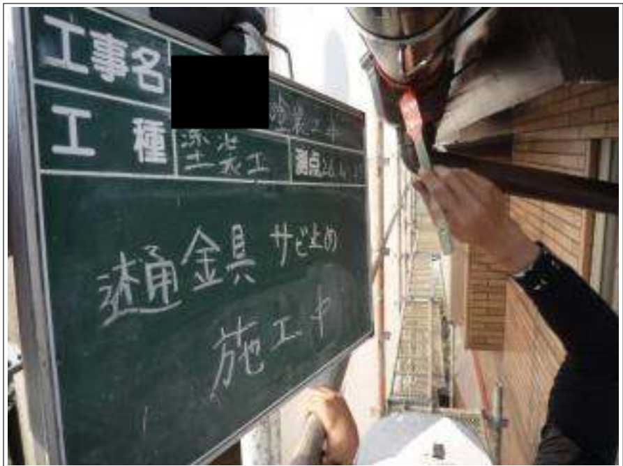
樋金具サビ止め施工中
