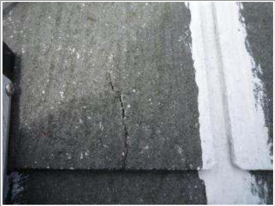
屋根クラック補修施工前
