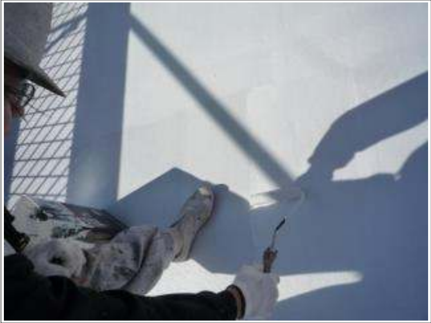
バルコニー防水塗装中塗り施工中
