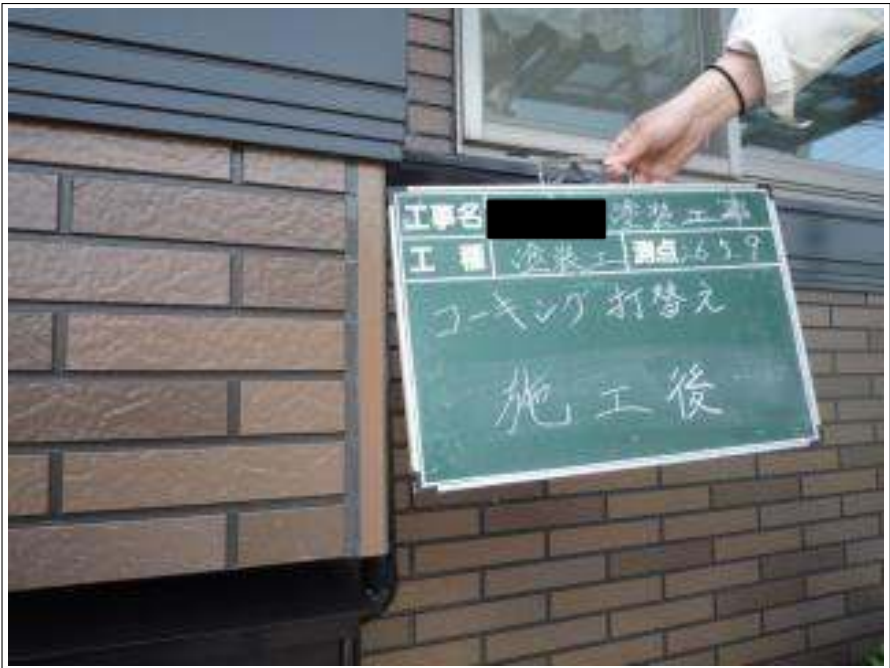
外壁コーキング打替え施工完了
