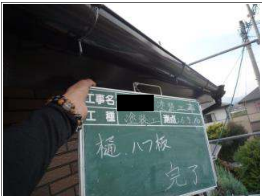
樋、破風板塗装施工完了
