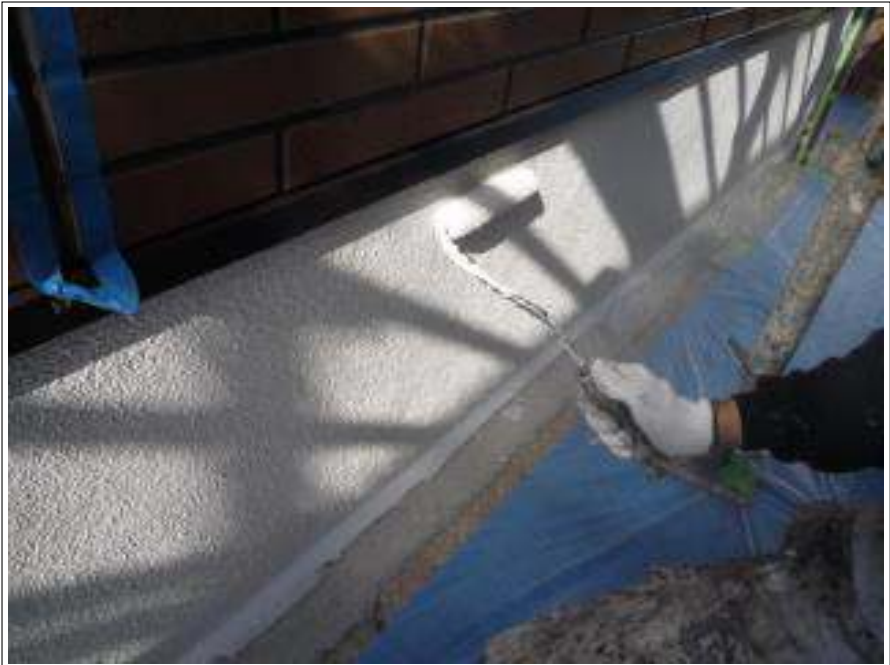
基礎塗装上塗り施工中
