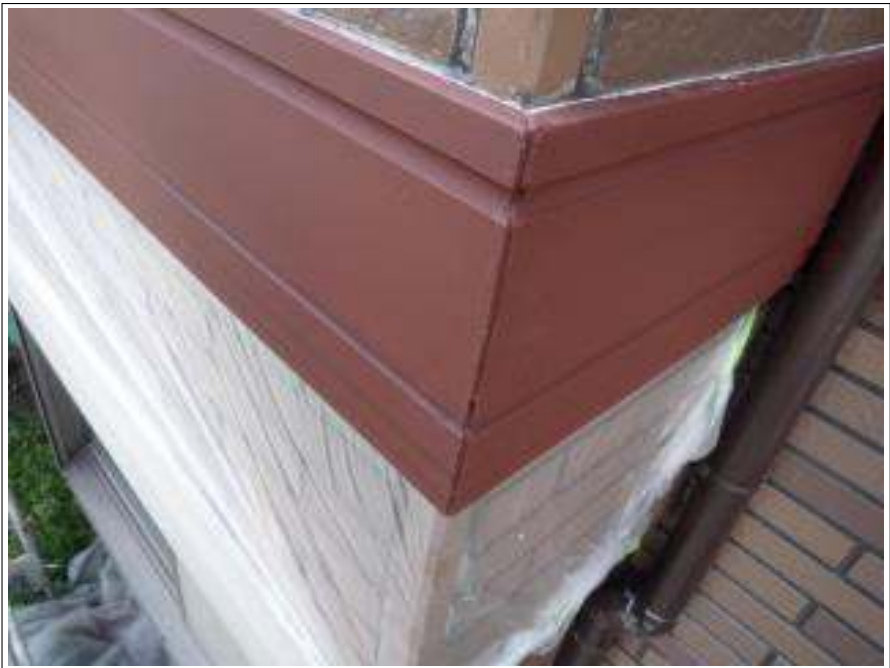
胴差しシーリング補修施工前
