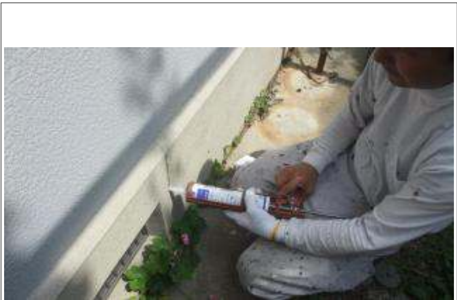
基礎クラック補修施工中
