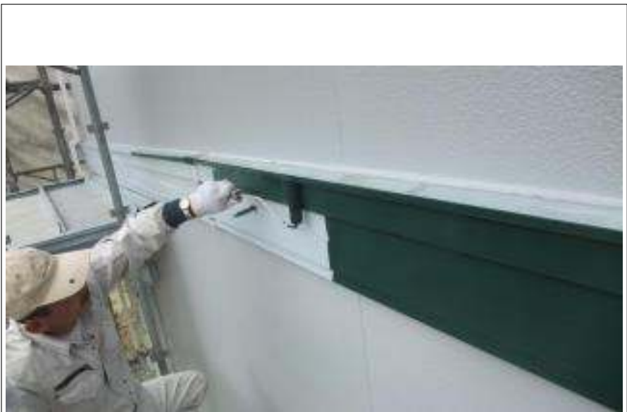
胴差し塗装下塗り施工中
