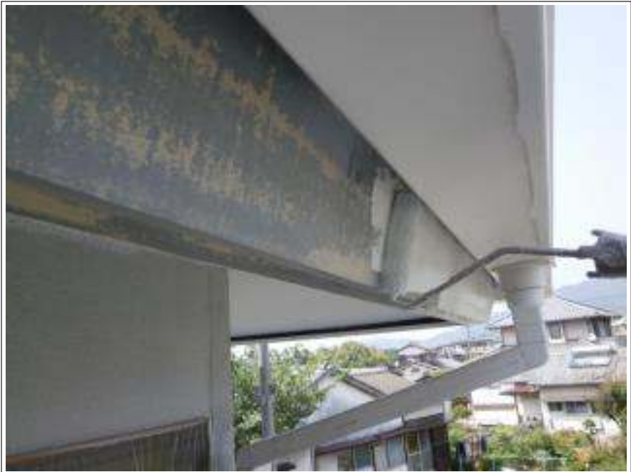
破風板塗装下塗り施工中
