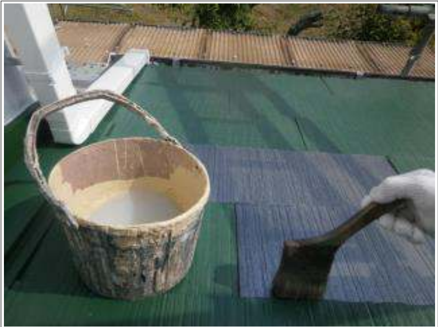
コロニアル差し替え部分塗装施工中
