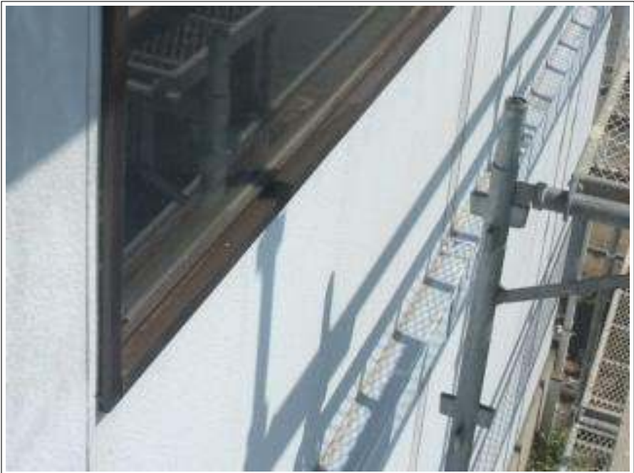
外壁高圧洗浄施工完了
