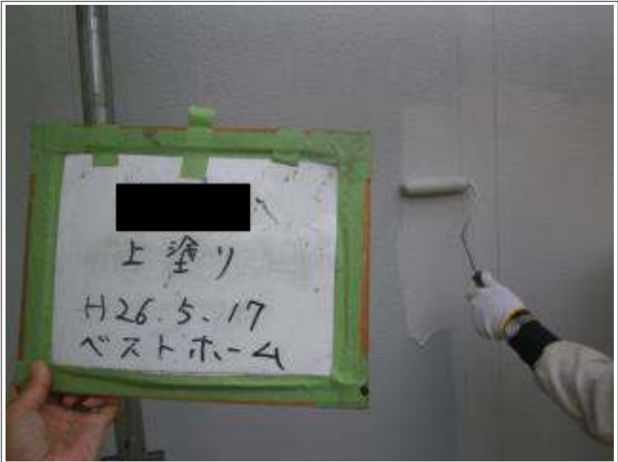
外壁塗装上塗り施工中
