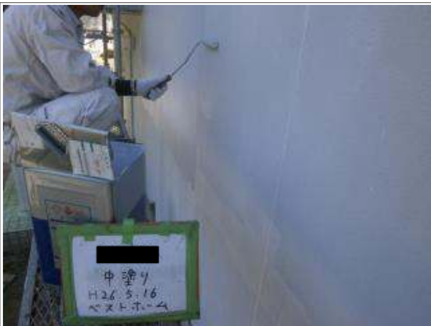
外壁塗装中塗り施工中
