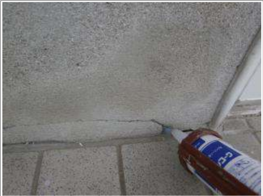
基礎クラック補修施工中
