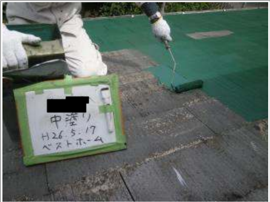
屋根塗装中塗り施工中
