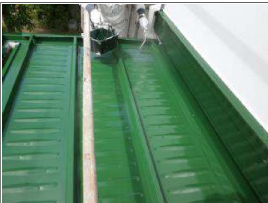
玄関屋根上塗り施工中
