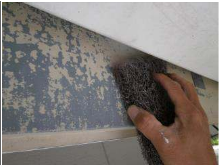
破風板ケレン施工中
