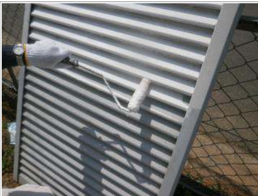
雨戸塗装下塗り施工中
