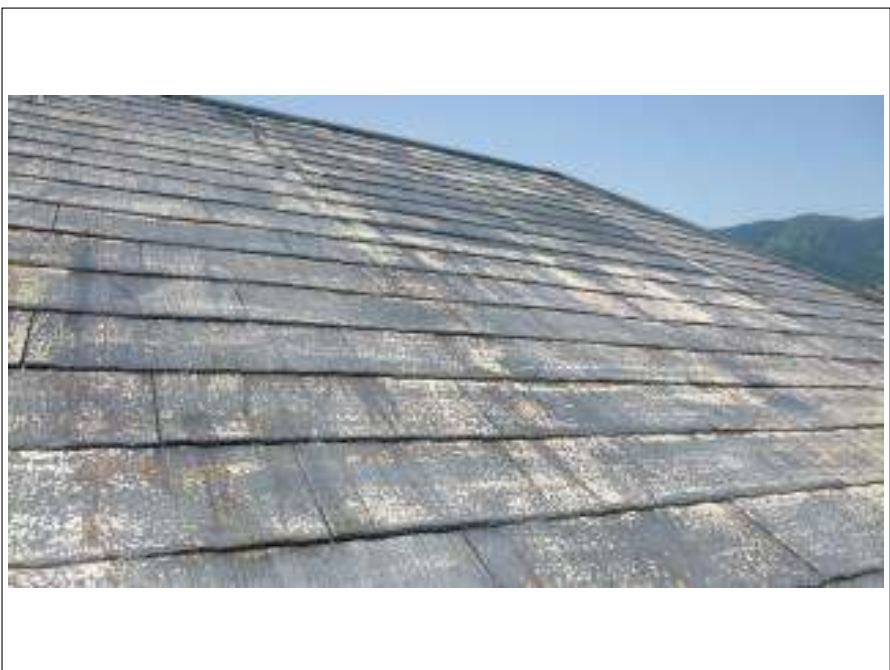
屋根塗装下塗り施工完了
