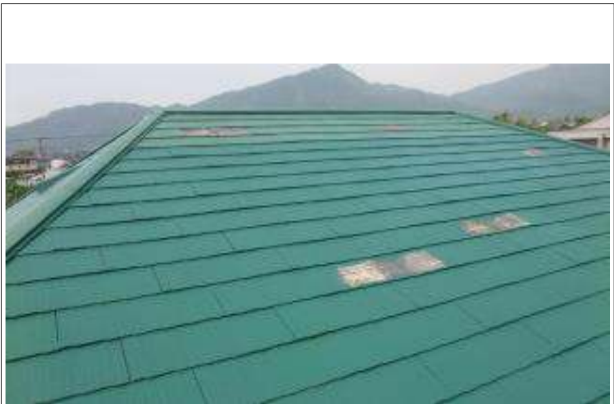
屋根塗装中塗り施工完了
