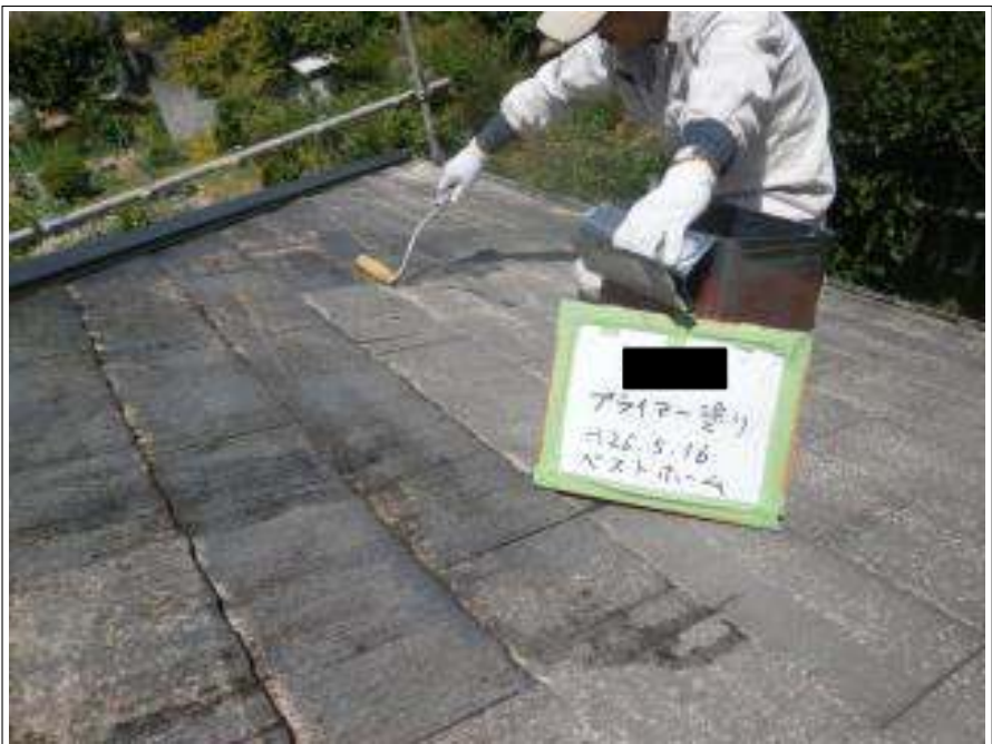
屋根塗装下塗り施工中
