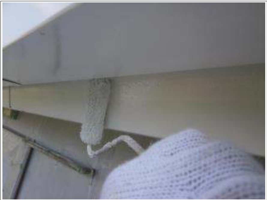
破風板塗装上塗り施工中
