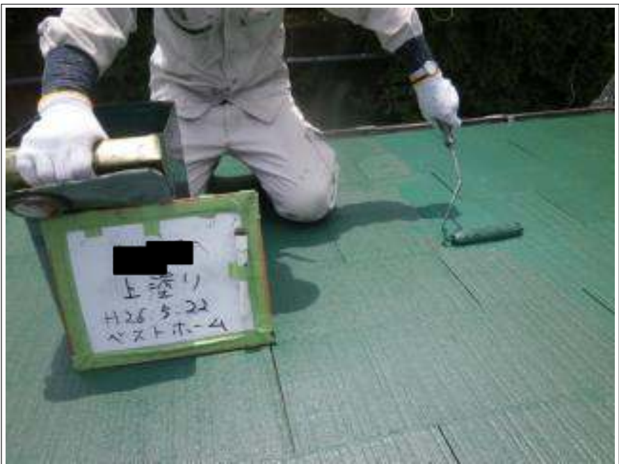
屋根塗装上塗り施工中
