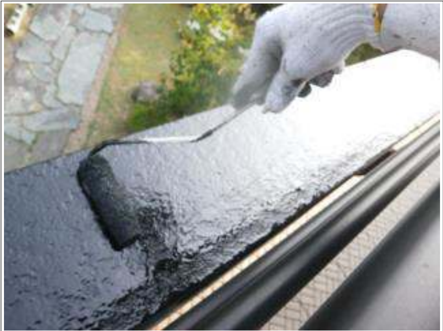
ベランダ笠置塗装上塗り施工中
