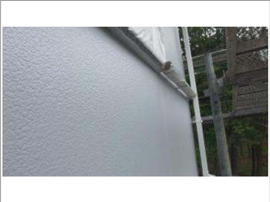
外壁塗装上塗り施工完了
