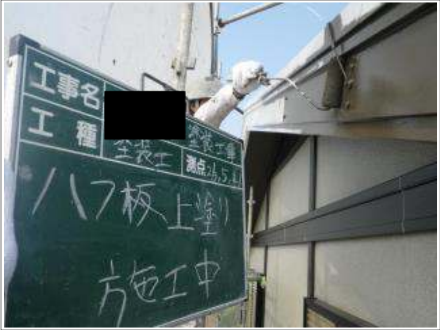
破風板塗装上塗り施工中
