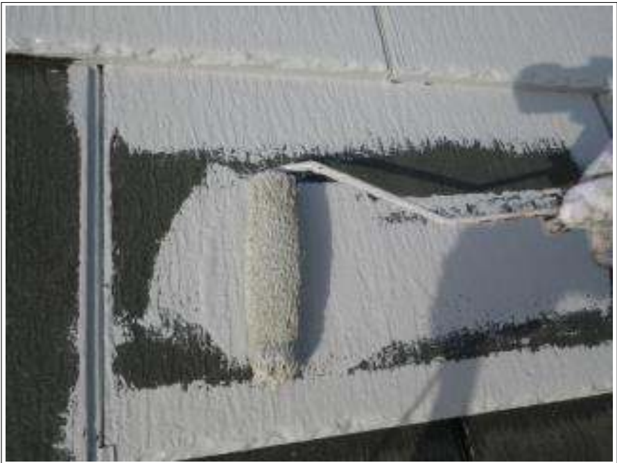
屋根塗装下塗り施工中
