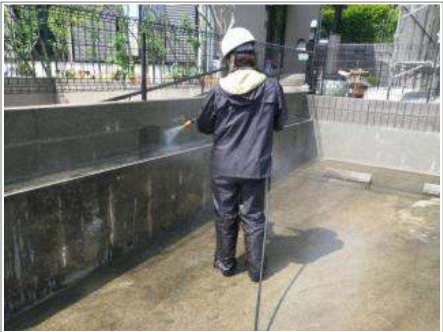
塀高圧洗浄施工中
