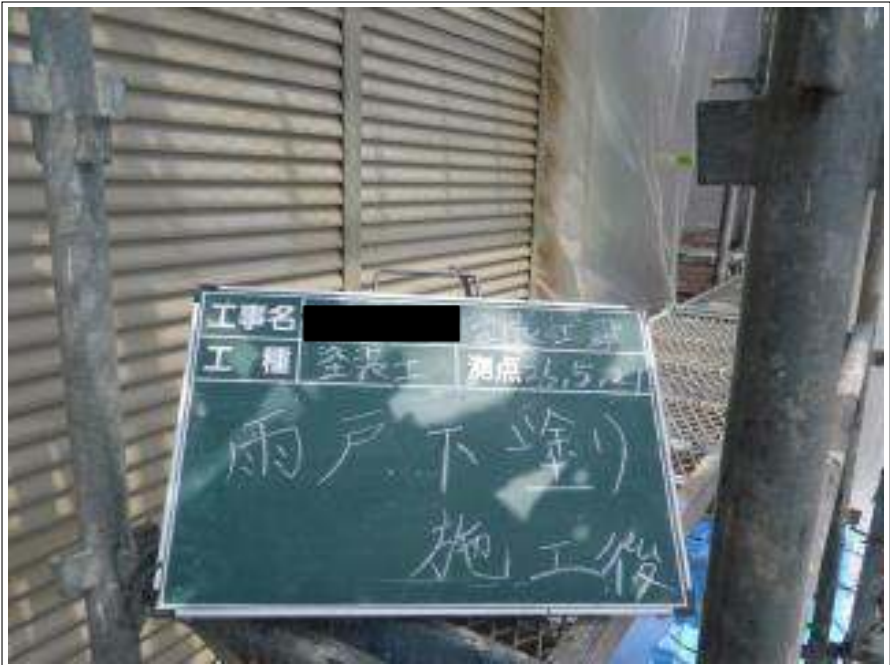
雨戸塗装下塗り施工完了
