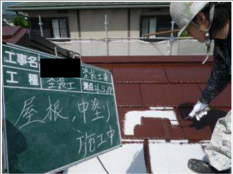
屋根塗装中塗り施工中
