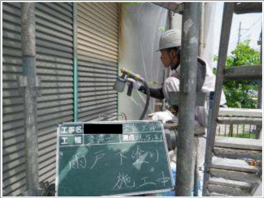
雨戸塗装下塗り施工中
