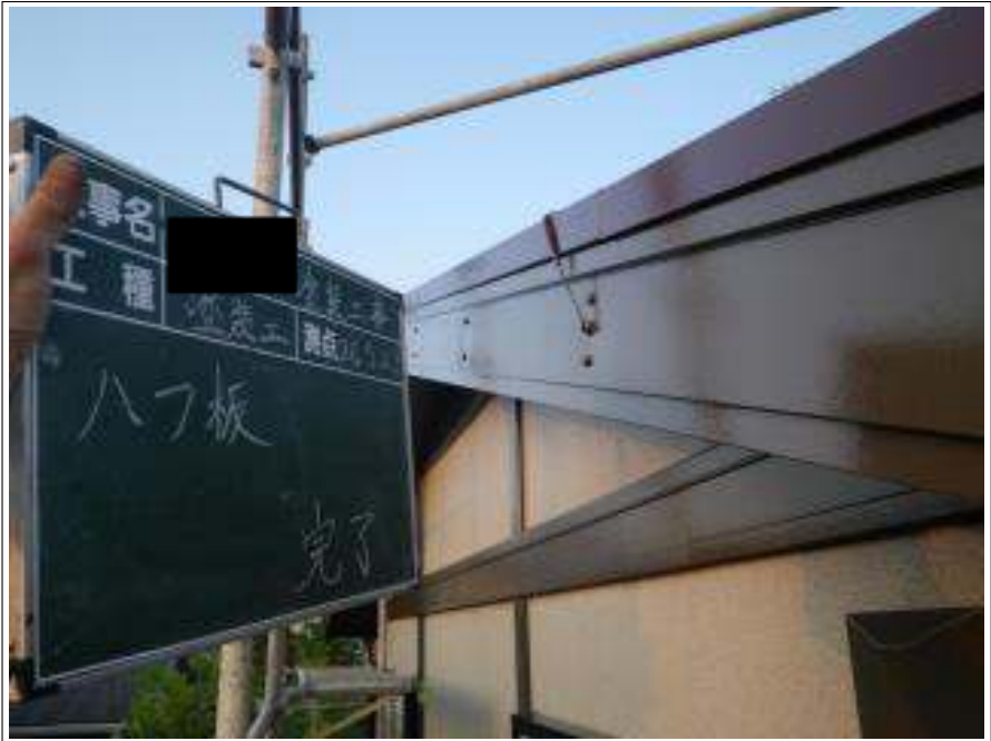
破風板塗装施工完了
