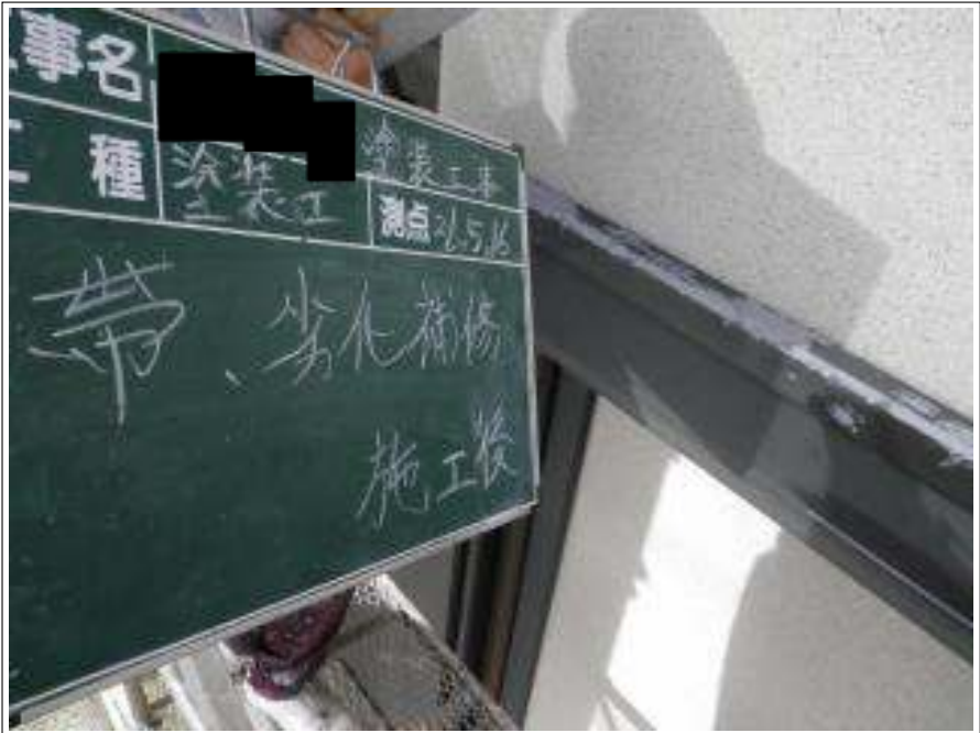
胴差し劣化補修施工完了
