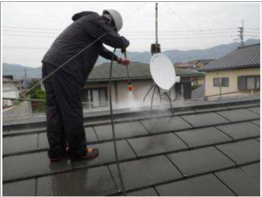
屋根高圧洗浄施工中
