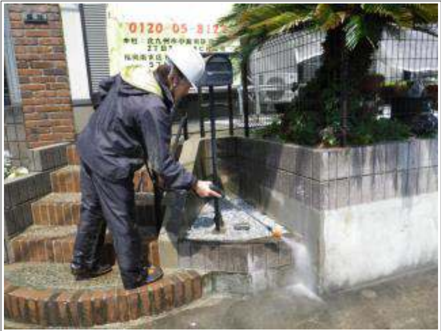
塀高圧洗浄施工中
