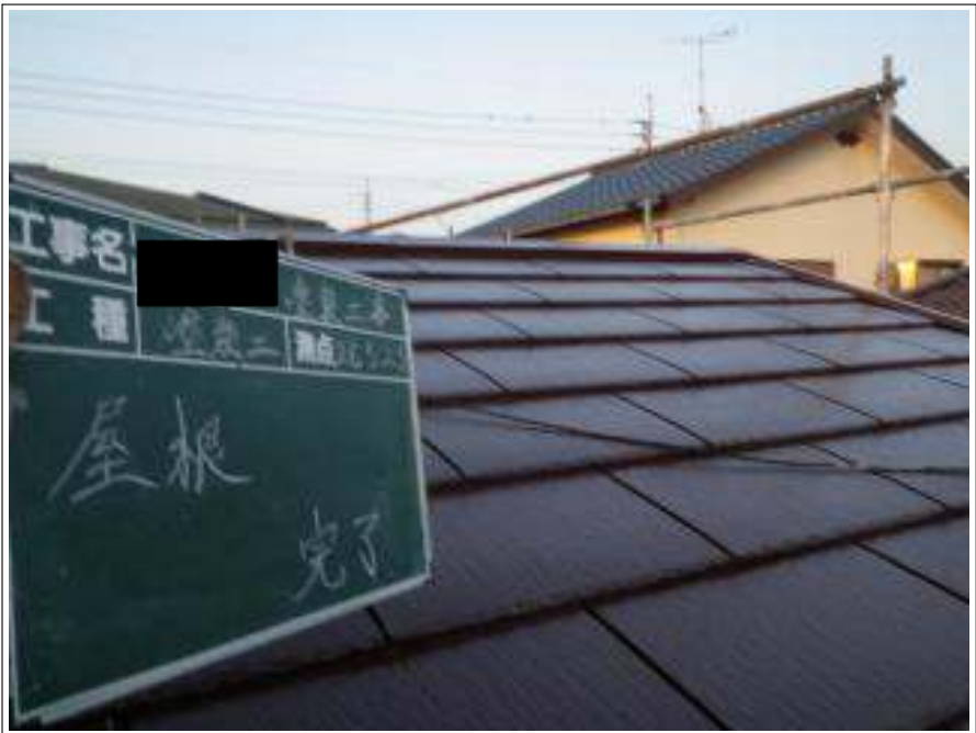
屋根塗装施工完了
