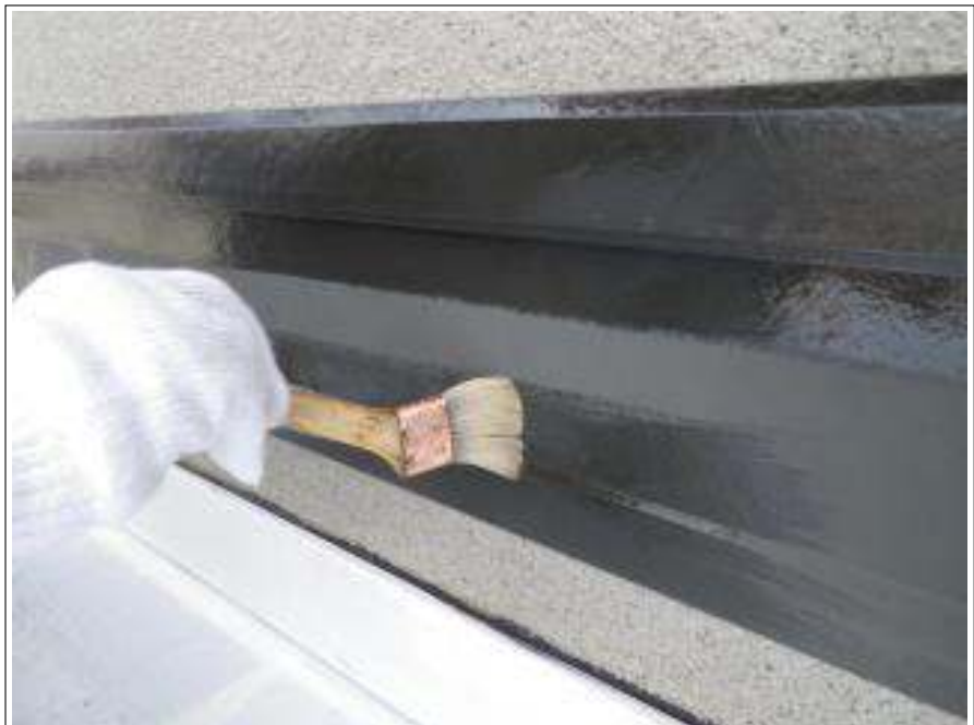
胴差し塗装下塗り施工中
