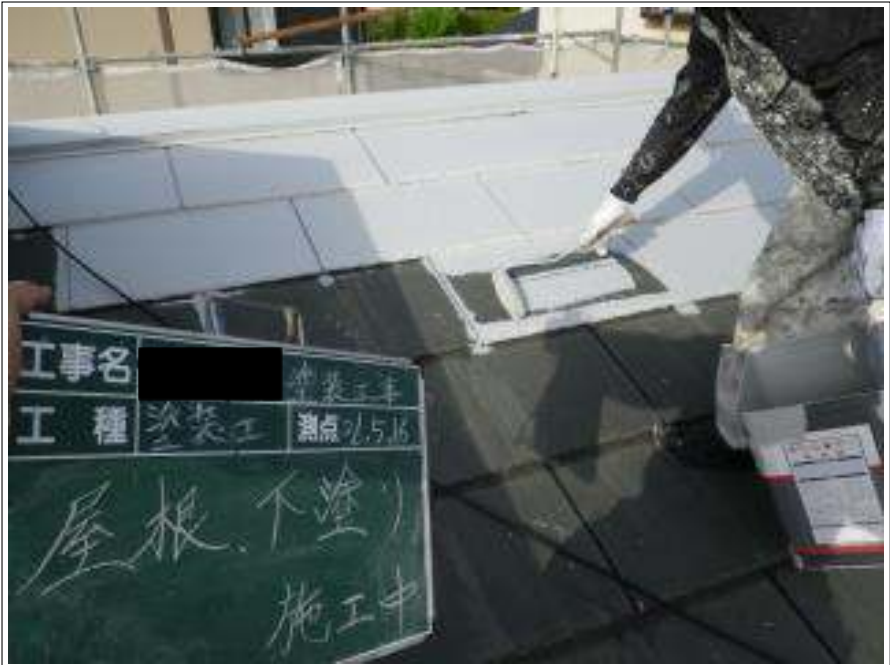
屋根塗装下塗り施工中
