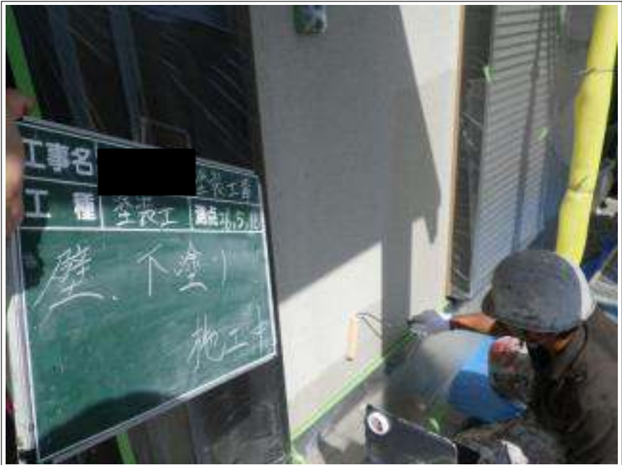
外壁塗装下塗り施工中
