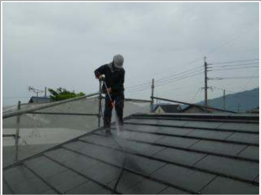
屋根高圧洗浄施工中
