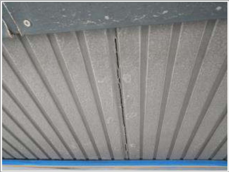
軒天クラック補修施工前
