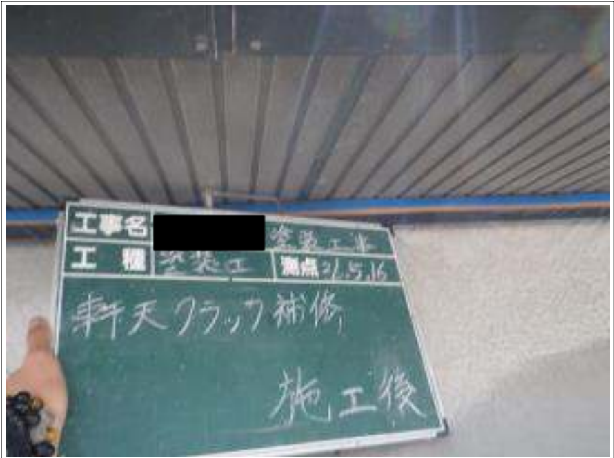
軒天クラック補修施工完了
