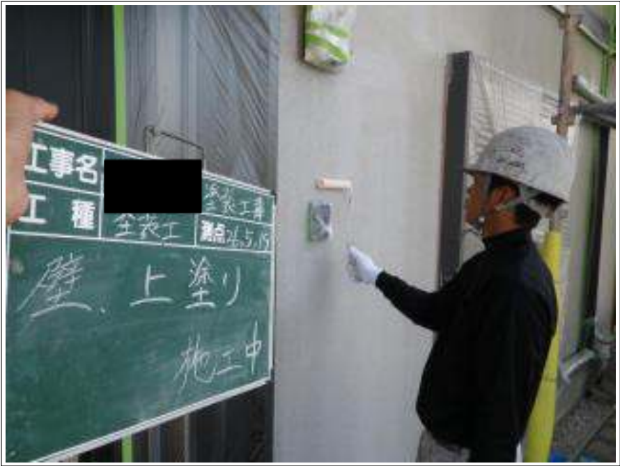
外壁塗装上塗り施工中
