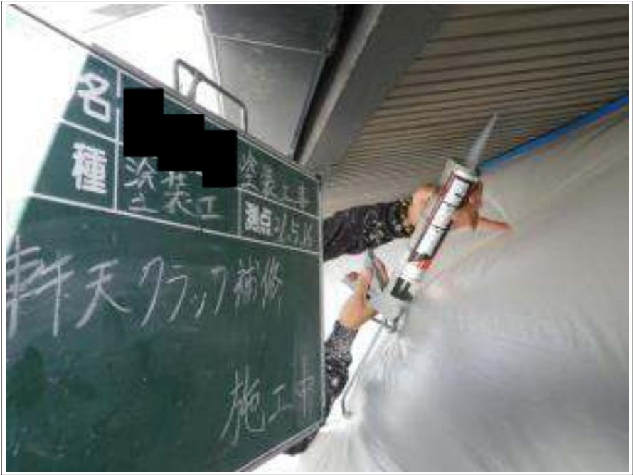
軒天クラック補修施工中
