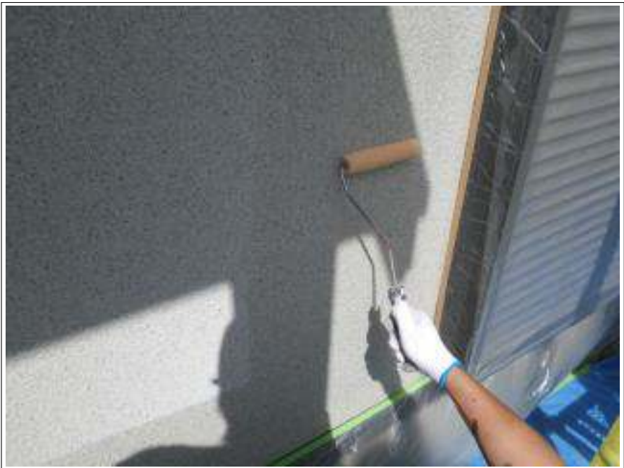
外壁塗装下塗り施工中
