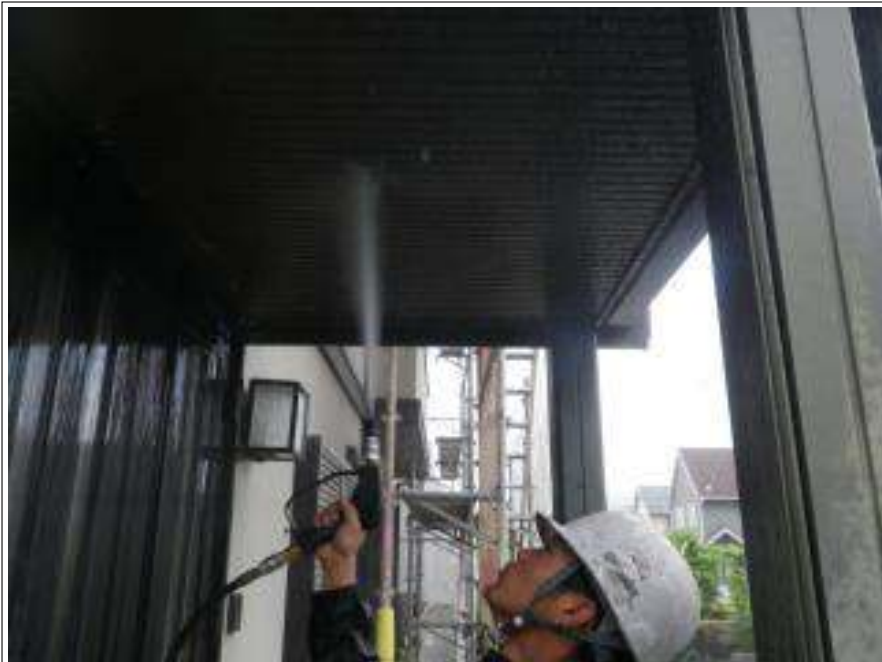
玄関軒高圧洗浄施工中
