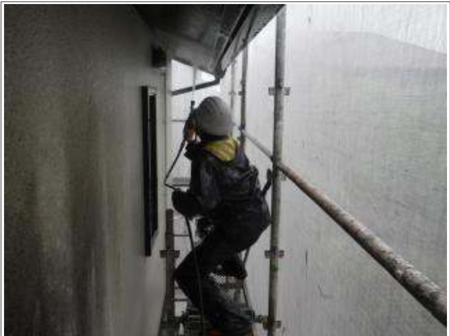
軒天高圧洗浄施工中
