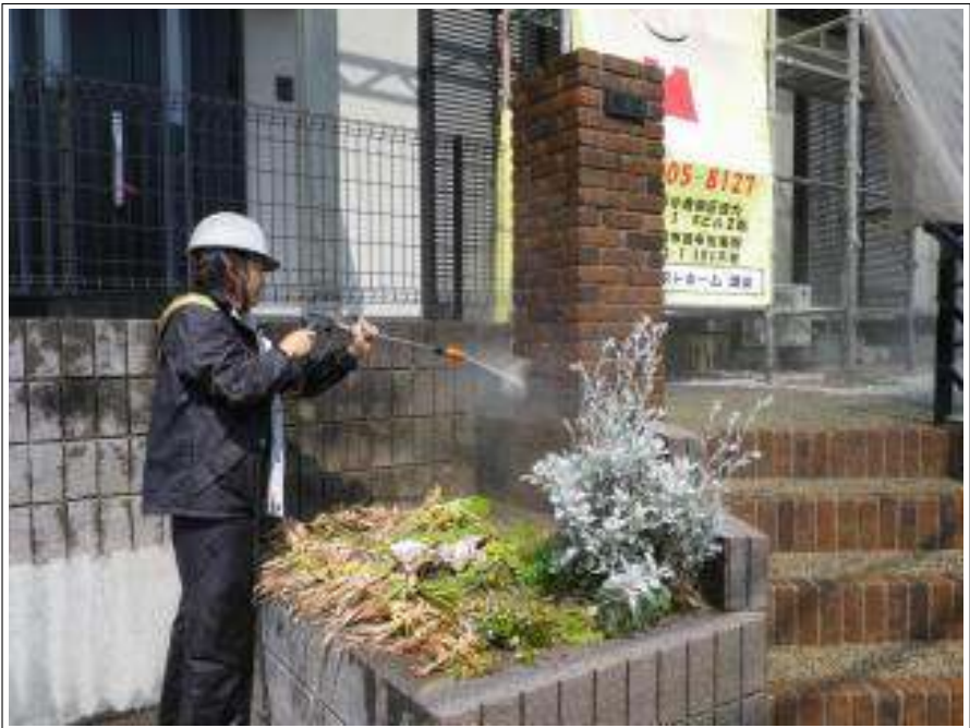
塀高圧洗浄施工中
