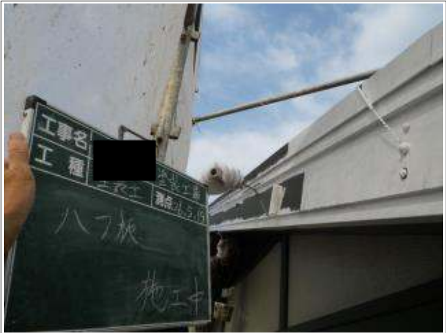
破風板塗装下塗り施工中
