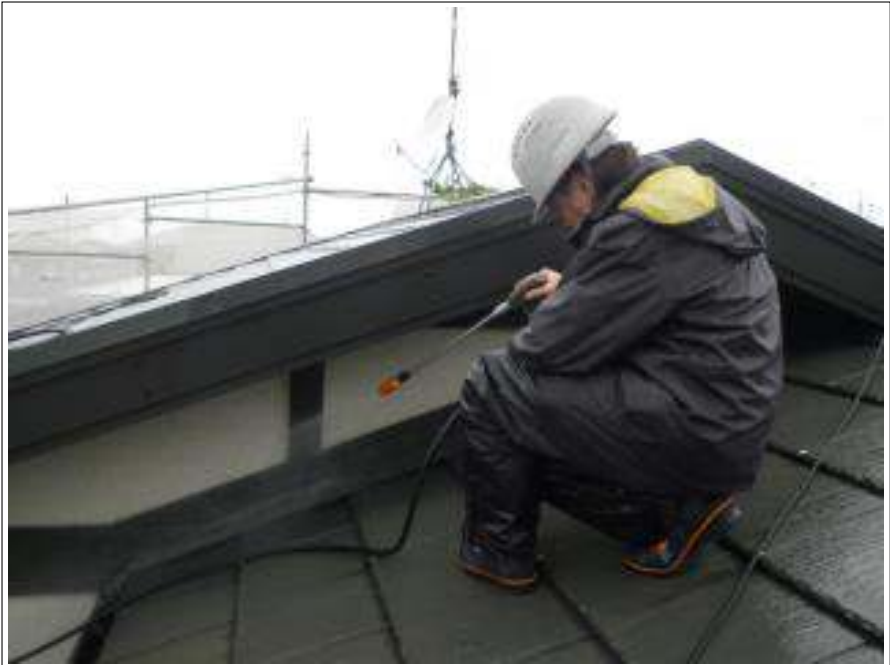
高圧洗浄施工中
