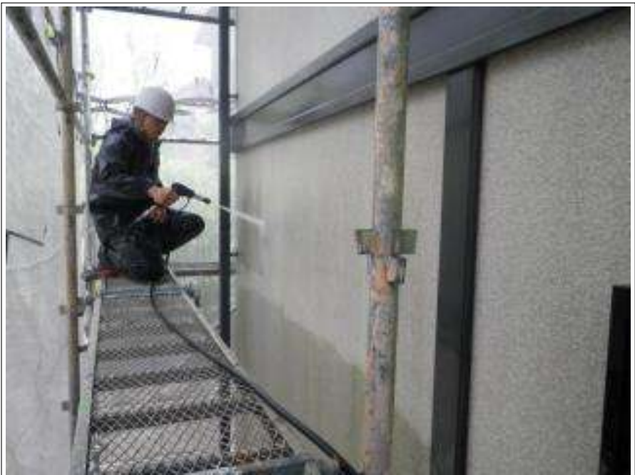
外壁高圧洗浄施工中
