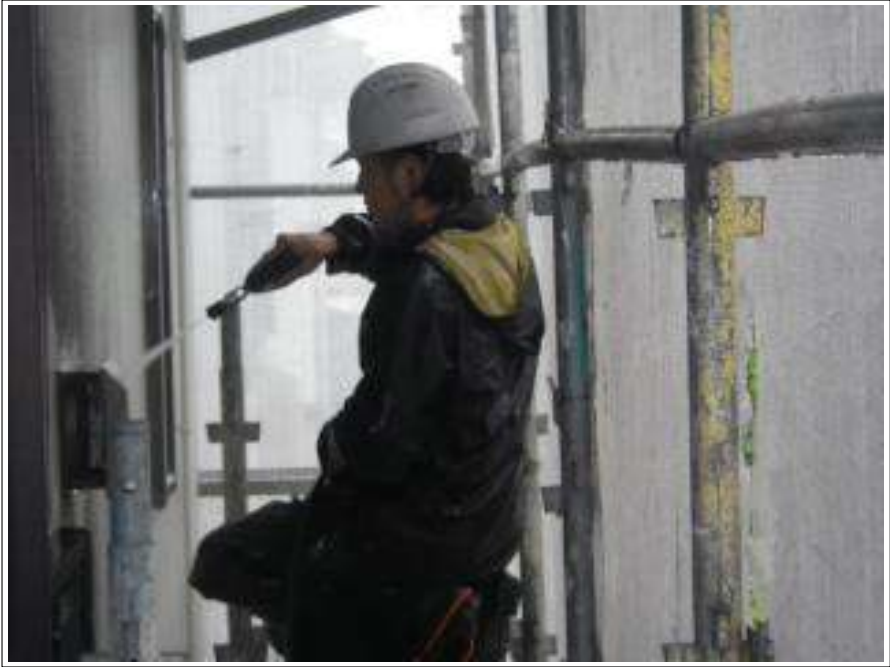
外壁高圧洗浄施工中
