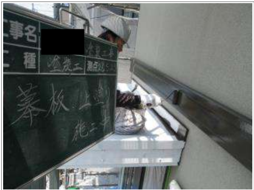
胴差し塗装上塗り施工中
