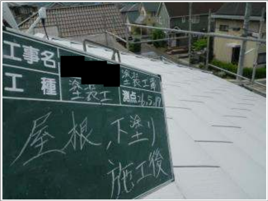
屋根塗装下塗り施工完了
