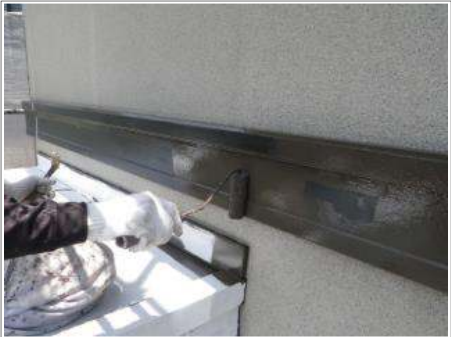
胴差し塗装上塗り施工中
