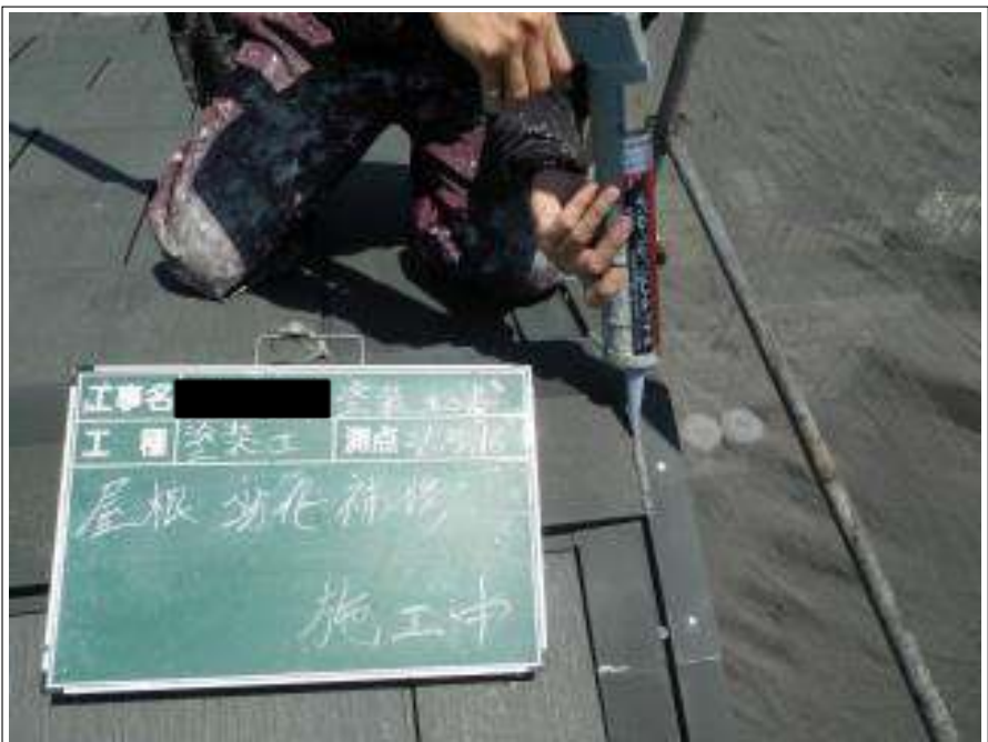
屋根劣化補修施工中
