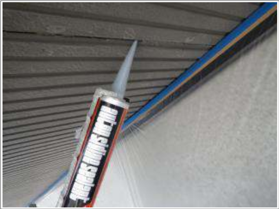
軒天クラック補修施工中
