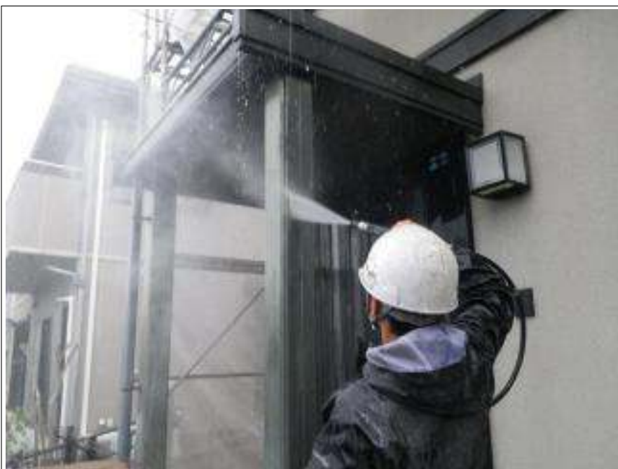
玄関柱高圧洗浄施工中
