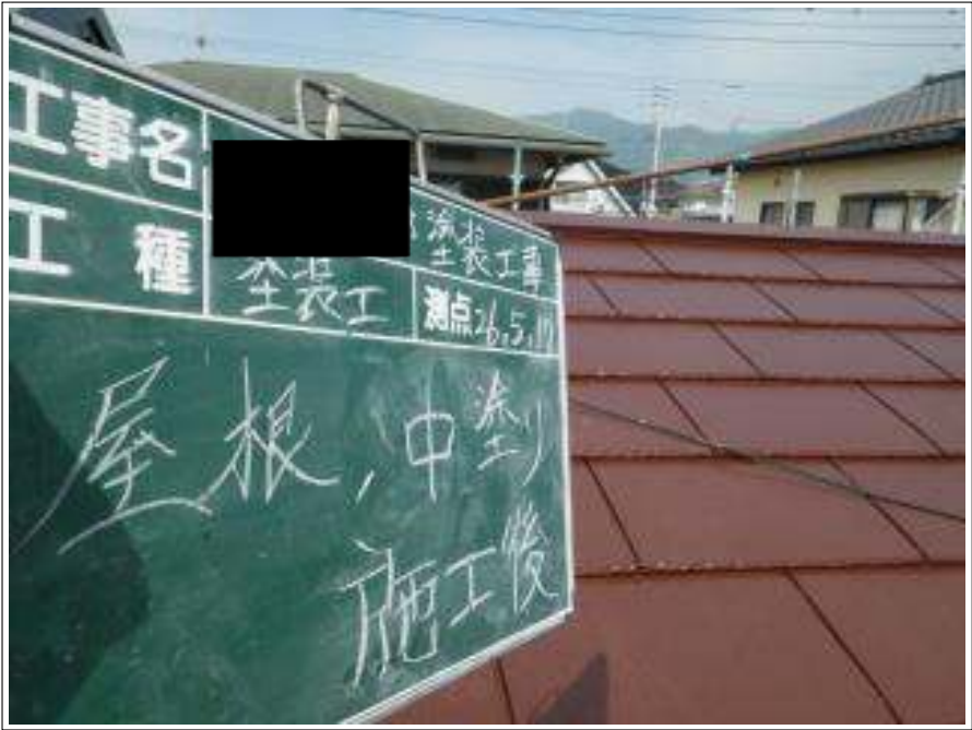
屋根塗装中塗り施工完了
