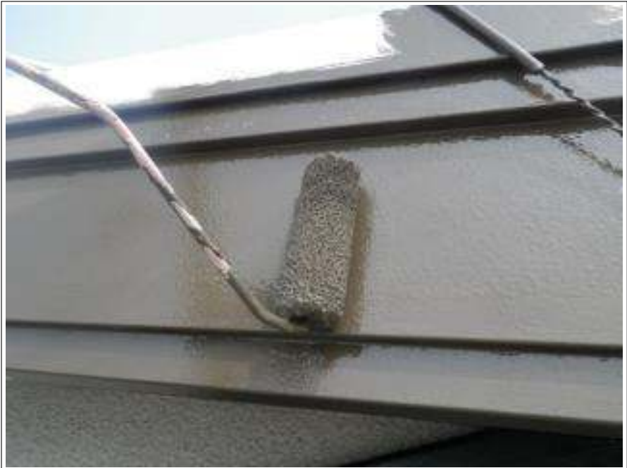
破風板塗装上塗り施工中
