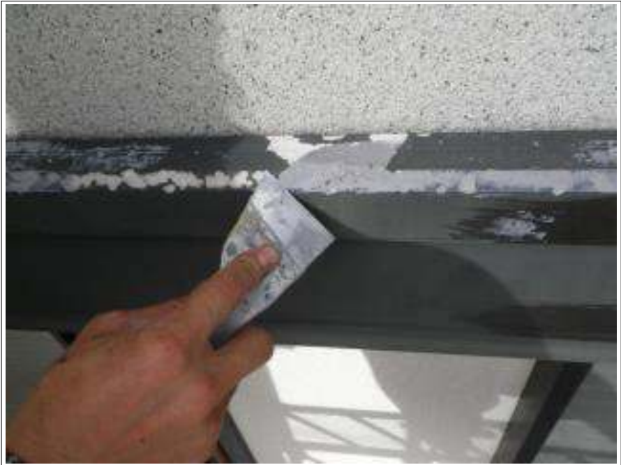
胴差し劣化補修施工中
