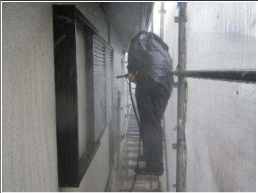
雨戸高圧洗浄施工中
