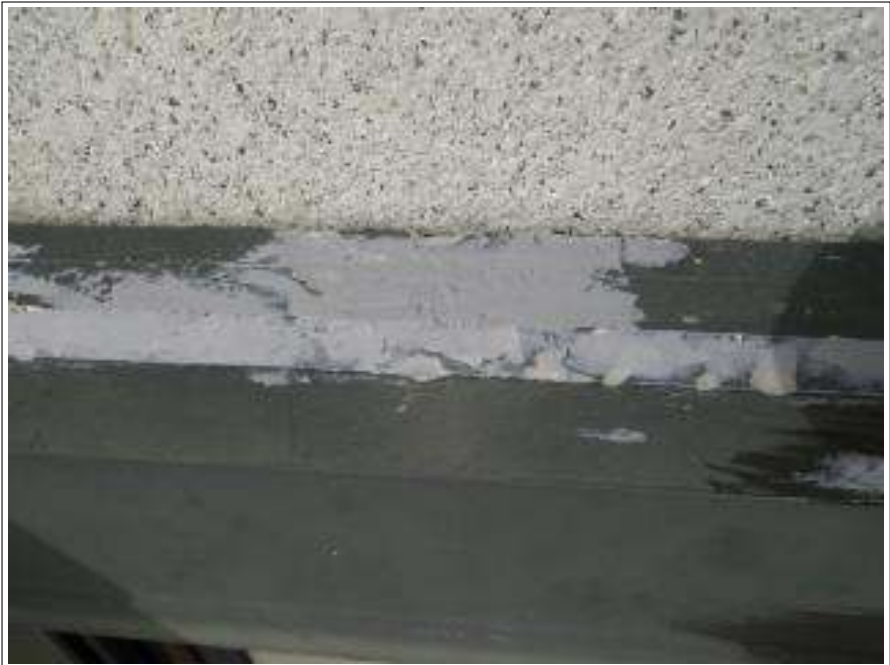
洞差し劣化補修施工完了
