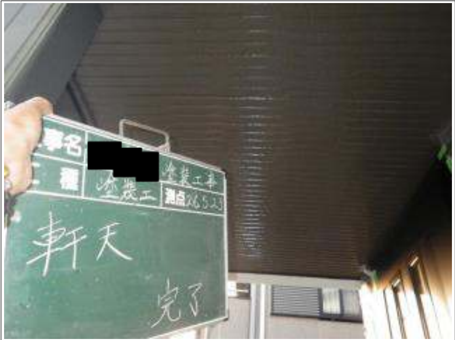
軒天塗装施工完了
