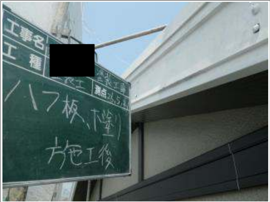
破風板塗装下塗り施工完了
