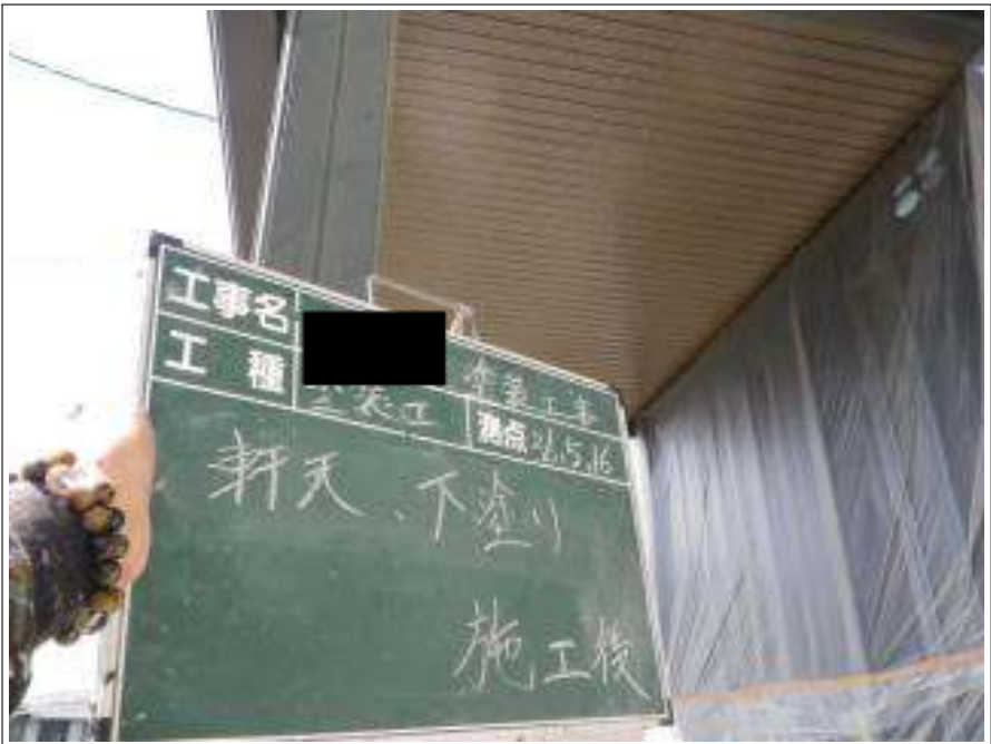
軒天塗装下塗り施工完了
