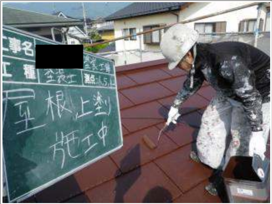
屋根塗装上塗り施工中
