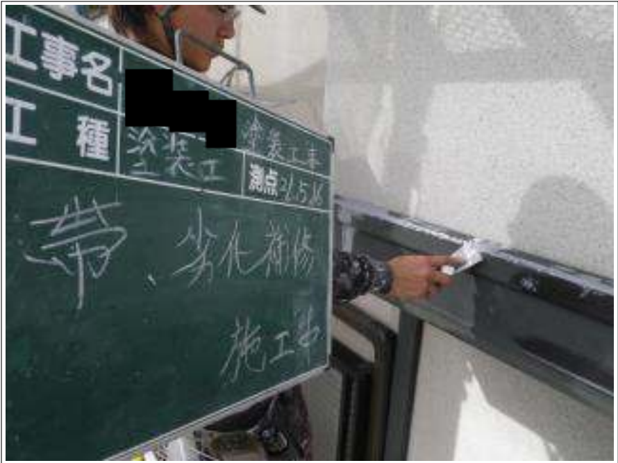
胴差し劣化補修施工中
