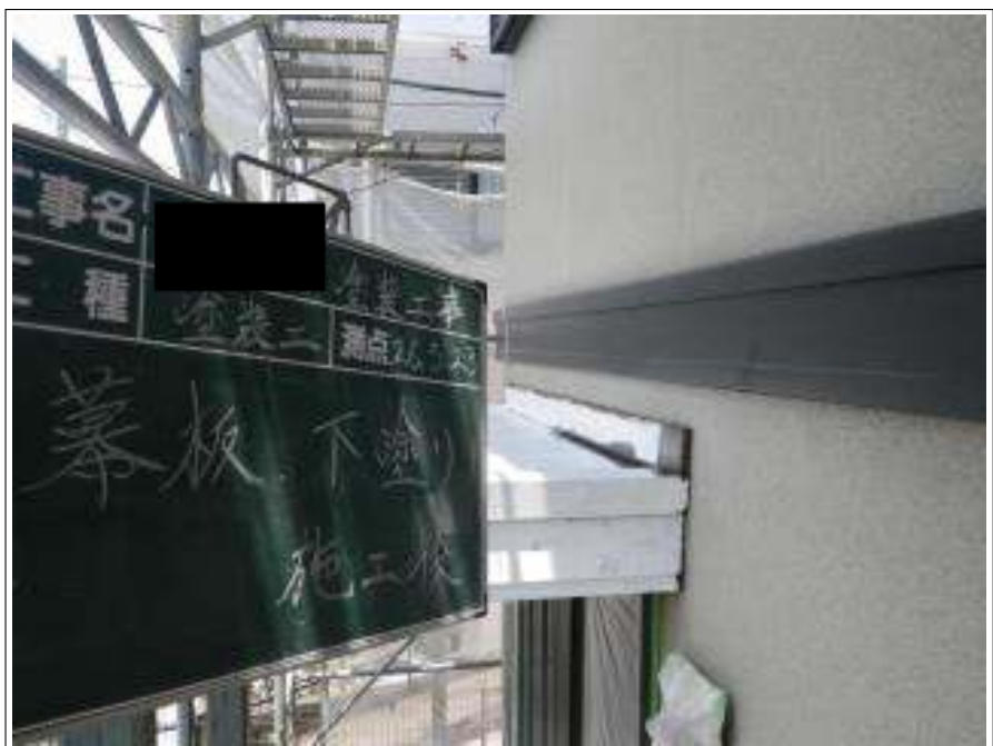
胴差し塗装下塗り施工完了
