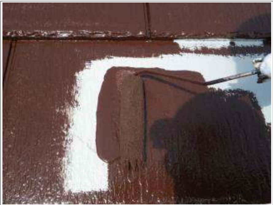
屋根塗装中塗り施工中
