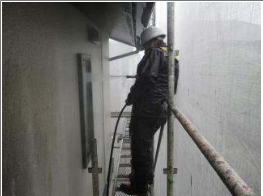
窓高圧洗浄施工中
