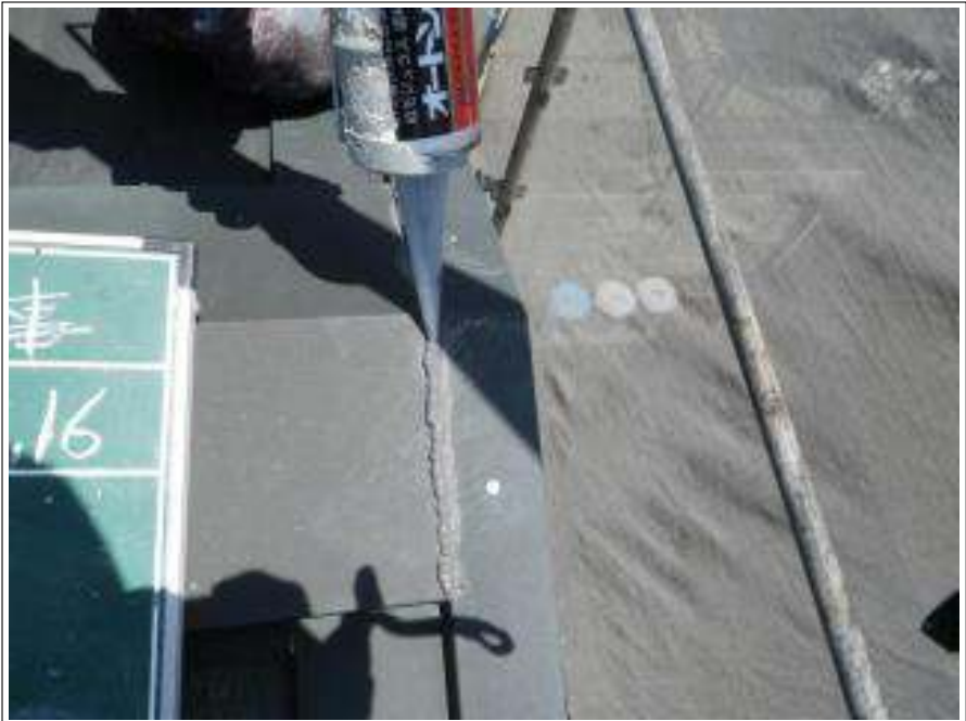
屋根劣化補修施工中
