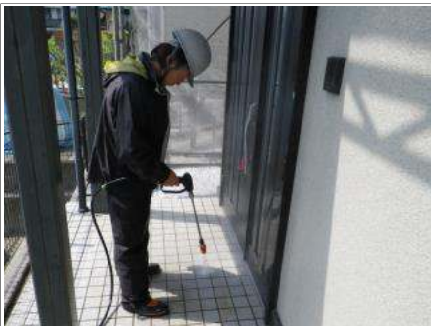
玄関土間タイル高圧洗浄施工中
