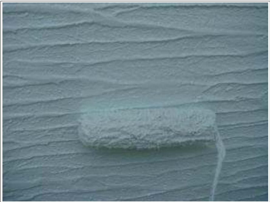
外壁塗装上塗り施工中
