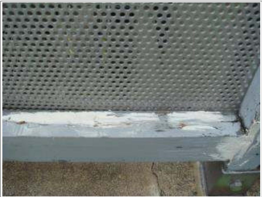
外壁シーリング補修施工完了
