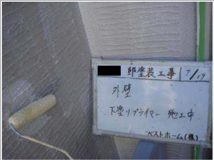
外壁塗装下塗り施工中
