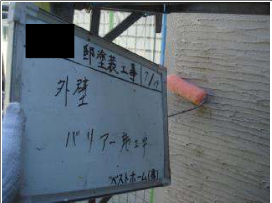
外壁塗装バリアー施工中
