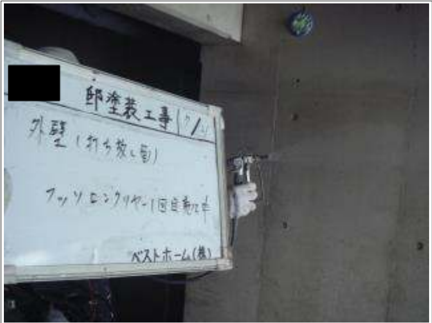
外壁コンクリート塗装上塗り施工中
