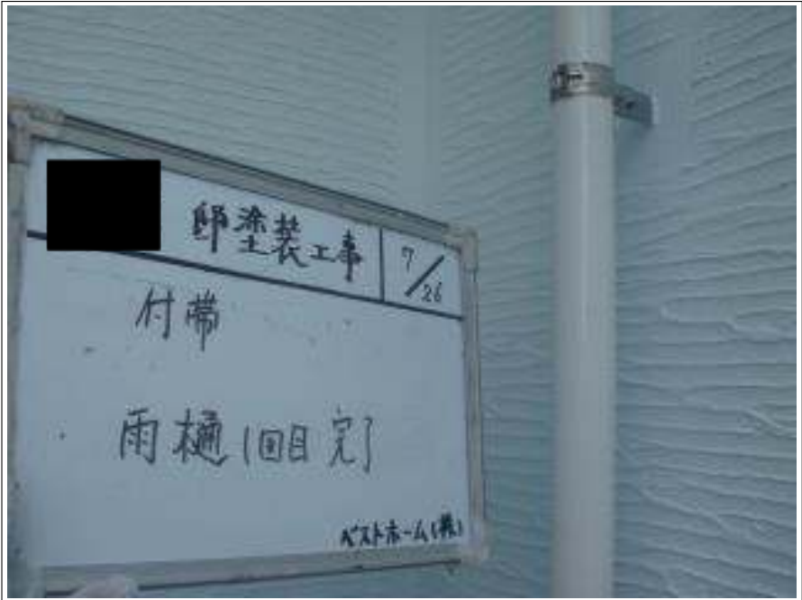
樋塗装 1 回目施工完了
