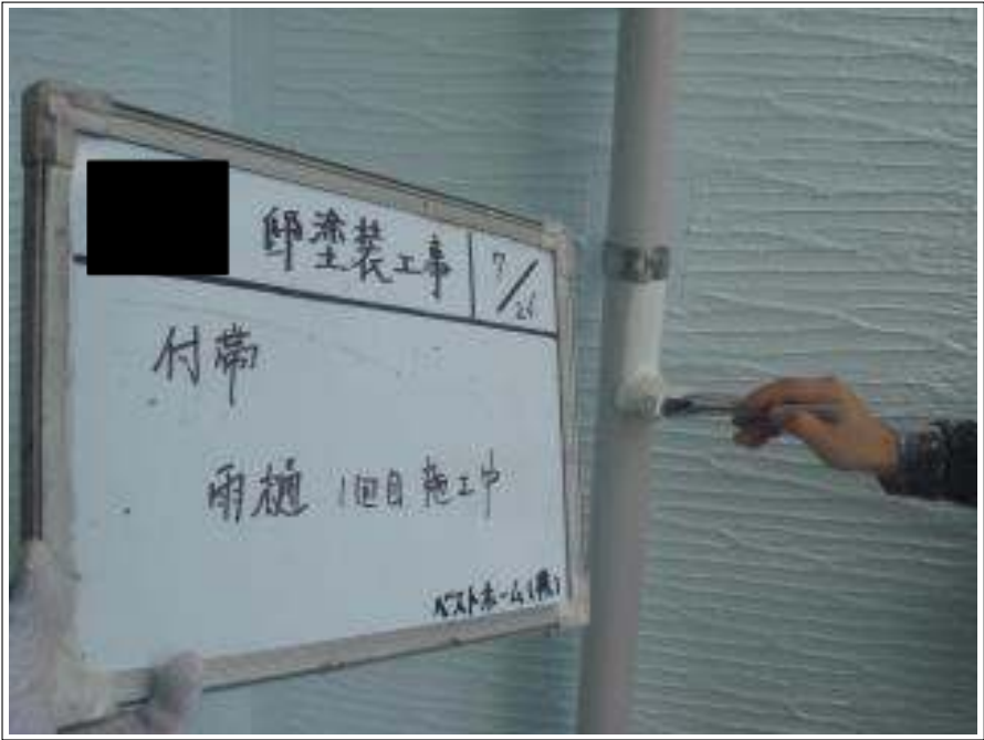
樋塗装 1 回目施工中
