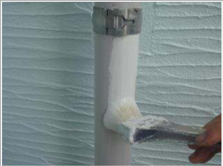
樋塗装 1 回目施工中
