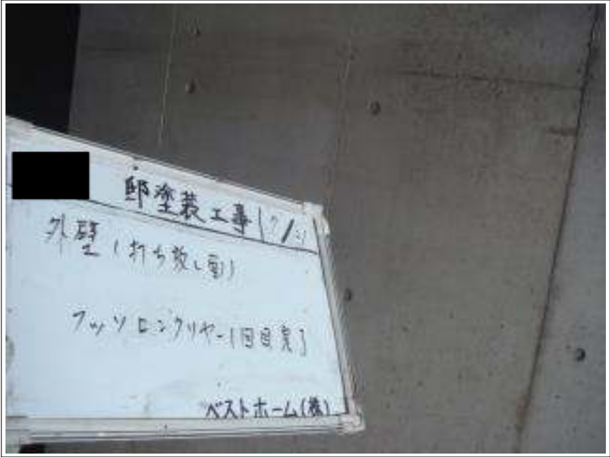
外壁コンクリート塗装上塗り施工完了
