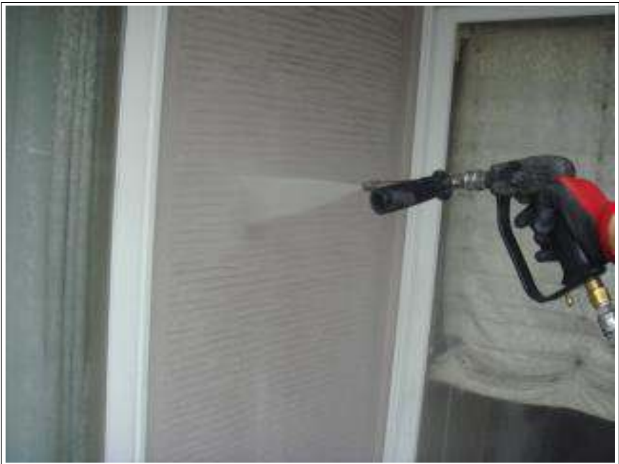
外壁高圧洗浄施工中
