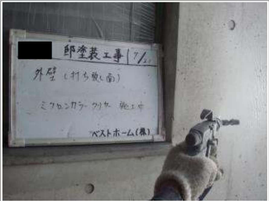
外壁コンクリート塗装中塗り施工中
