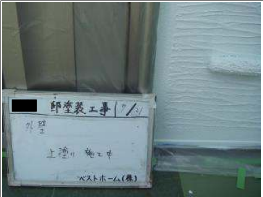
外壁塗装上塗り施工中
