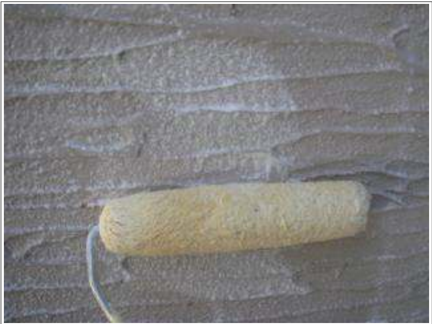
外壁塗装下塗り施工中
