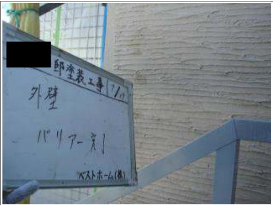
外壁塗装バリアー施工完了
