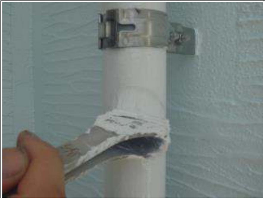
樋塗装 2 回目施工中
