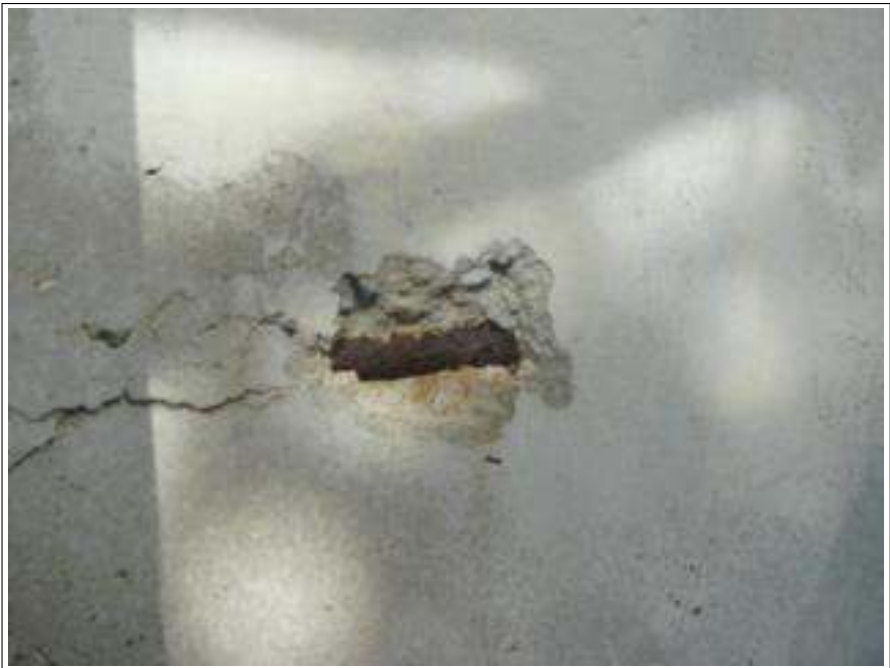
外壁下地補修施工前
