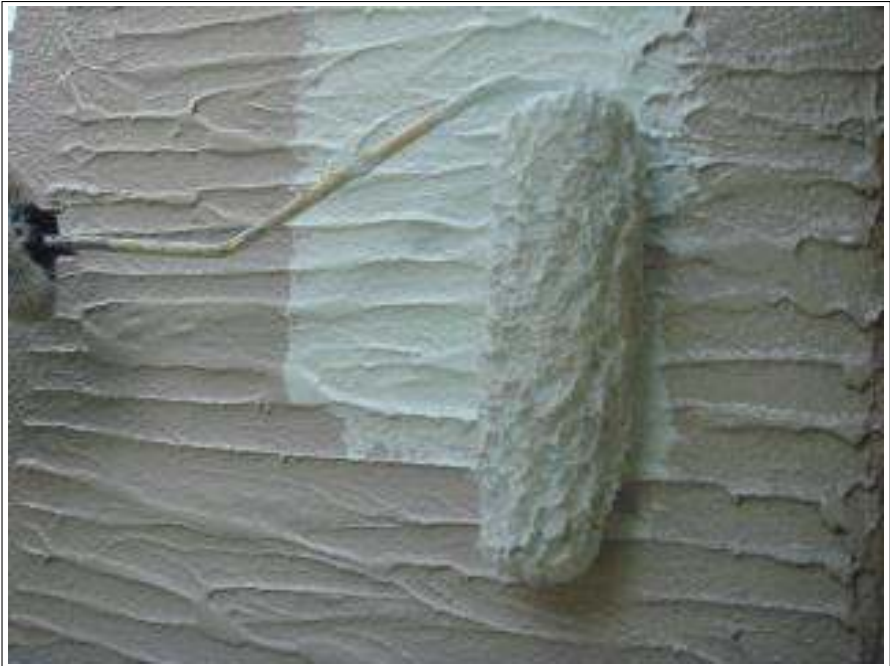
外壁塗装中塗り施工中
