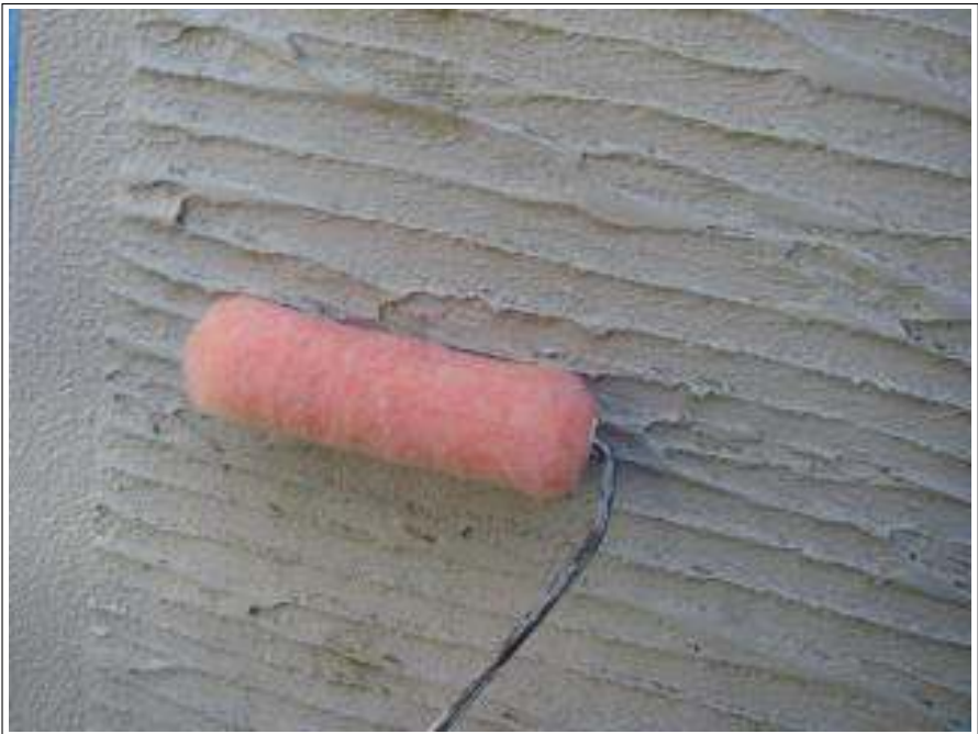
外壁塗装バリアー施工中
