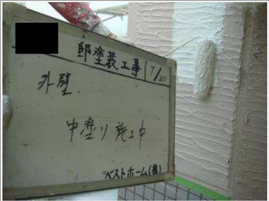
外壁塗装中塗り施工中
