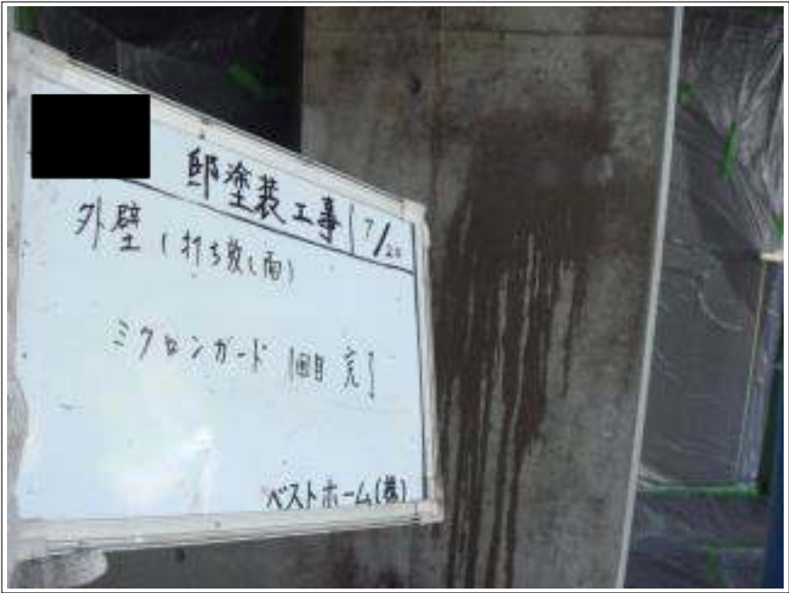
外壁コンクリート塗装下塗り施工完了
