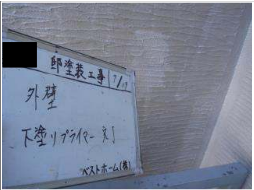
外壁塗装下塗り施工完了
