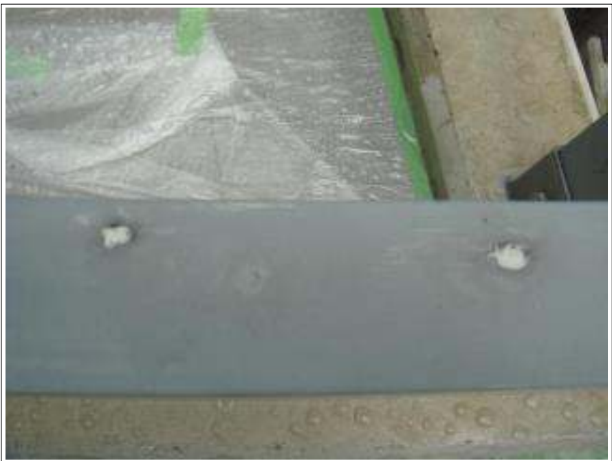
外壁シーリング補修施工完了
