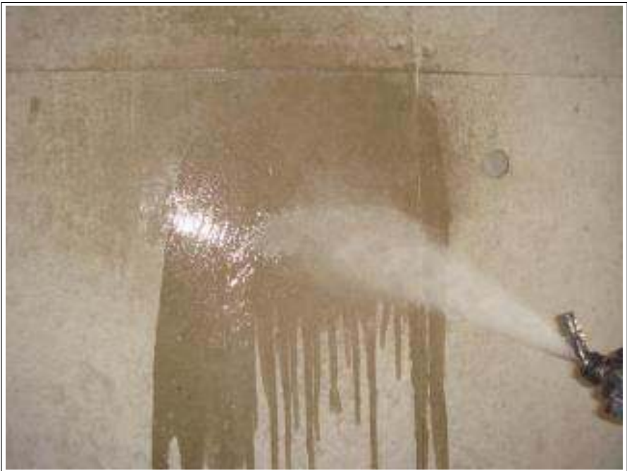
外壁コンクリート塗装下塗り施工中
