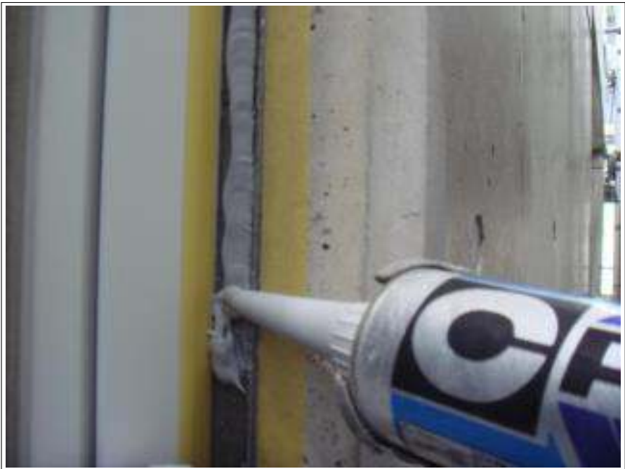
外壁シーリング補修施工中
