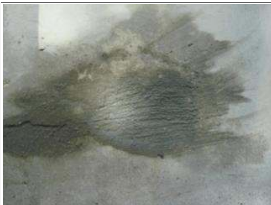
外壁下地補修施工完了
