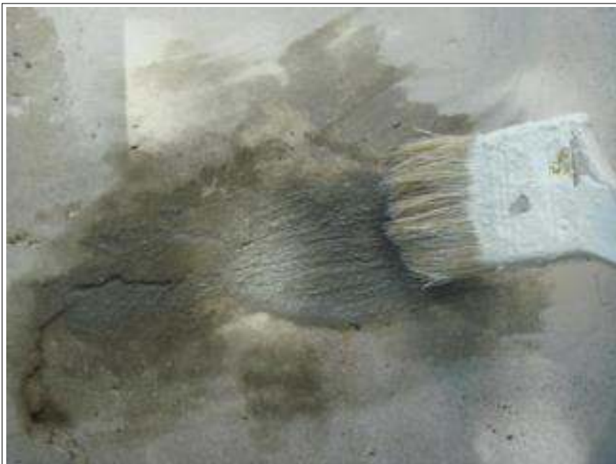
外壁下地補修施工中
