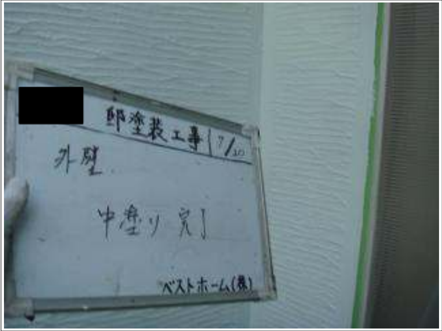
外壁塗装中塗り施工完了
