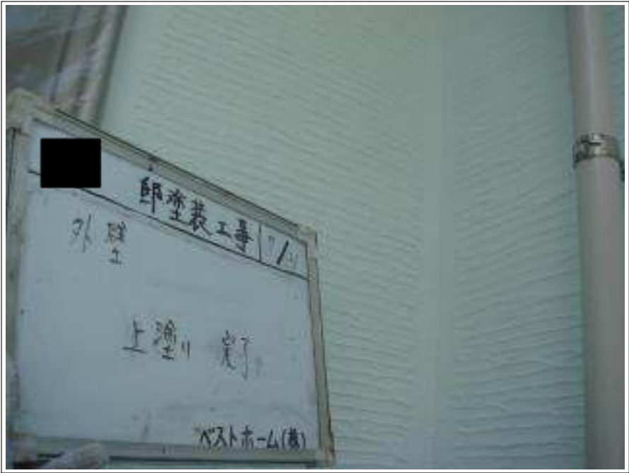
外壁塗装上塗り施工完了
