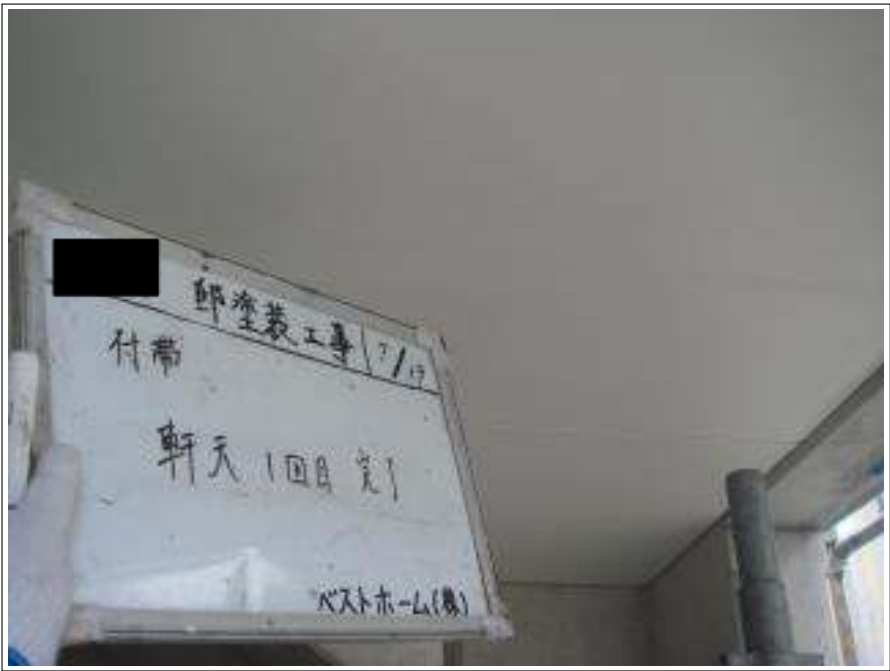
軒天塗装 1 回目施工完了
