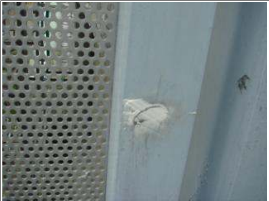
外壁シーリング補修施工完了
