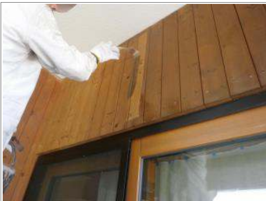
外壁木部塗装 1 回目施工中
