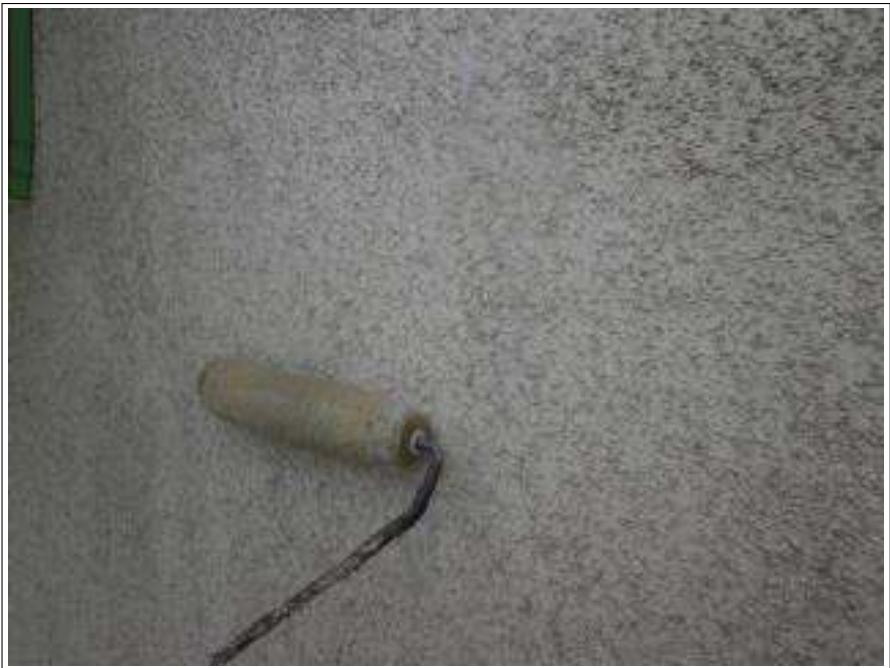
外壁塗装バリアー施工中
