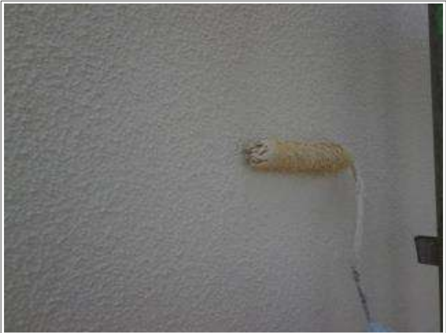
外壁塗装上塗り施工中
