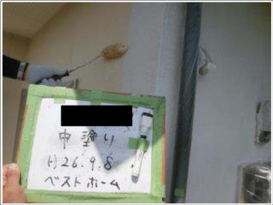
外壁塗装中塗り施工中
