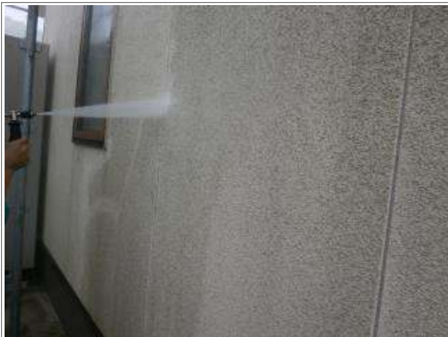
外壁高圧洗浄施工中
