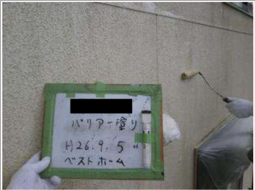
外壁塗装バリアー施工中
