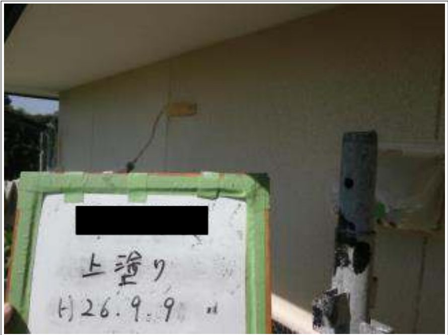
外壁塗装上塗り施工中
