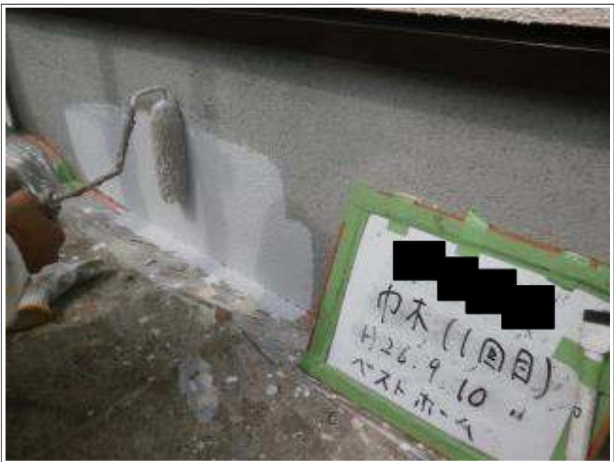
基礎塗装 1 回目施工中
