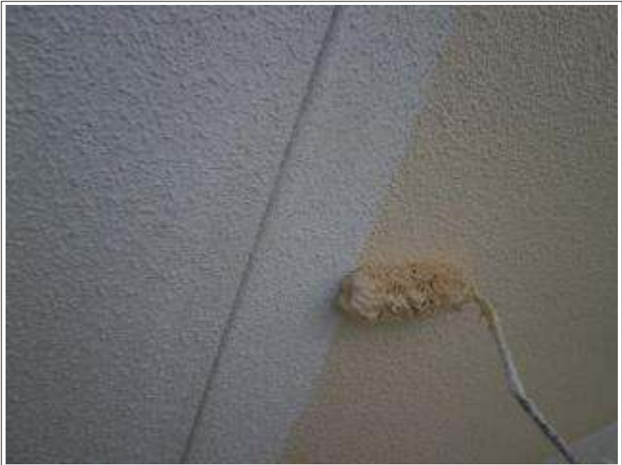
外壁塗装中塗り施工中
