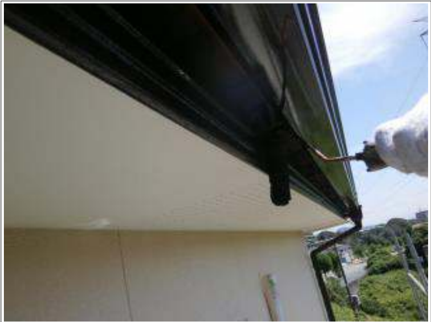
破風板塗装施工中
