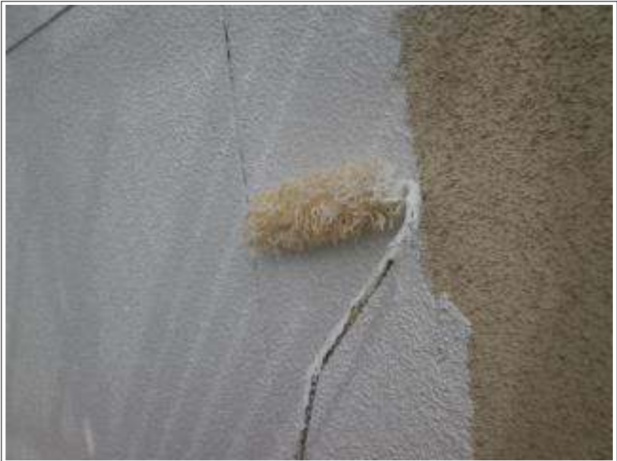
外壁塗装下塗り施工中
