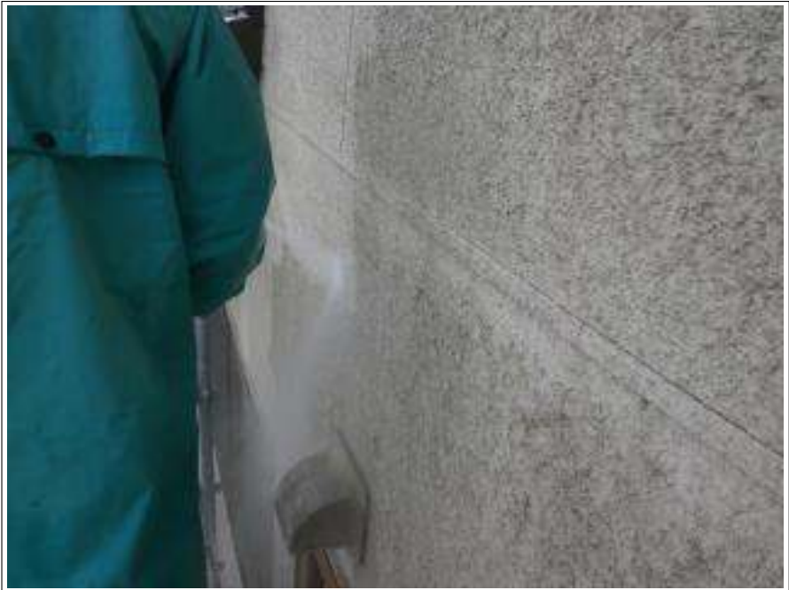
外壁高圧洗浄施工中
