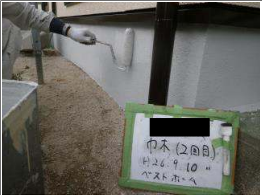
基礎塗装 2 回目施工中
