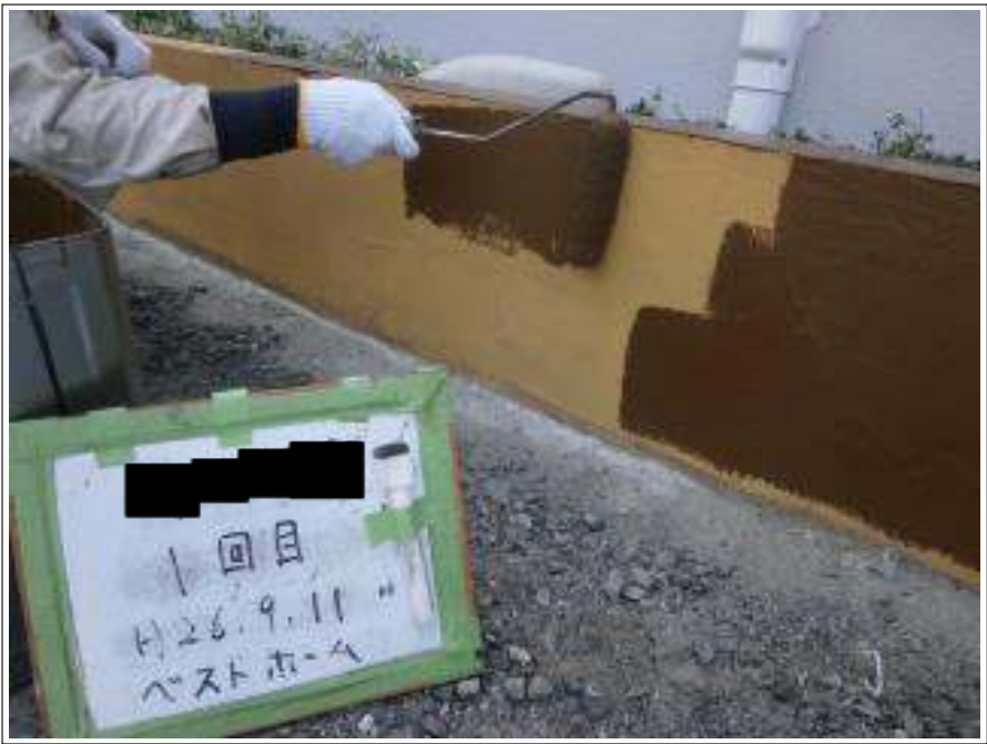
塀塗装 1 回目施工中
