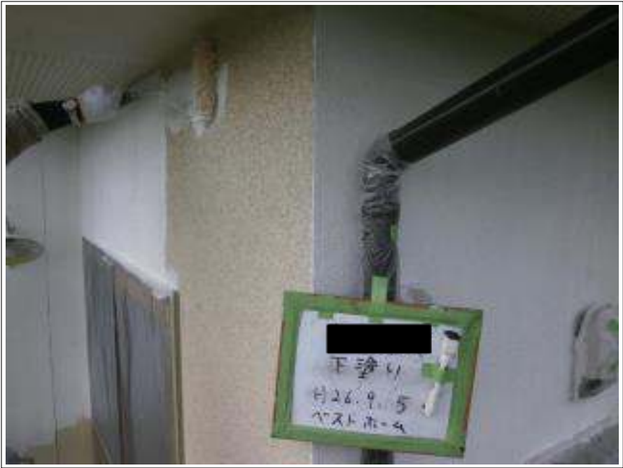
外壁塗装下塗り施工中
