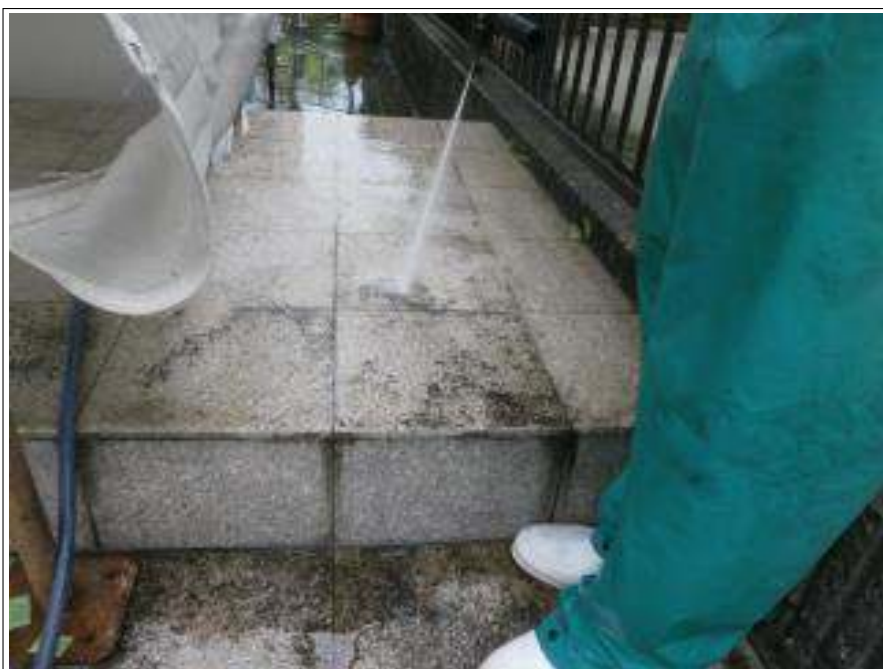
土間高圧洗浄施工中
