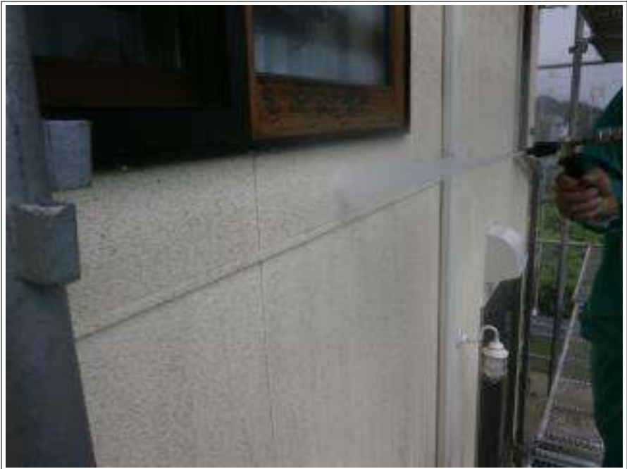
外壁高圧洗浄施工中
