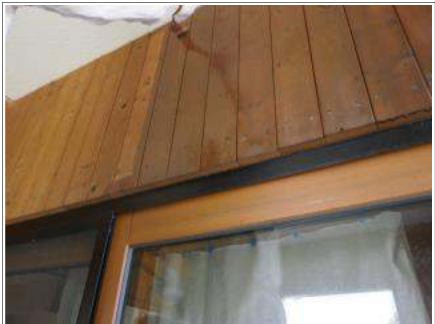
外壁木部塗装 1 回目施工中
