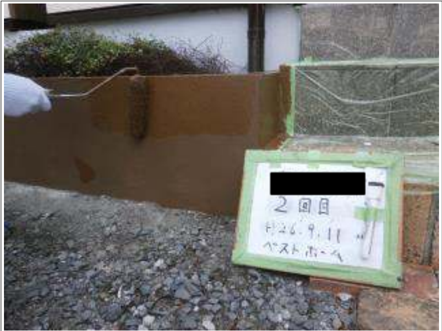
塀塗装 2 回目施工中
