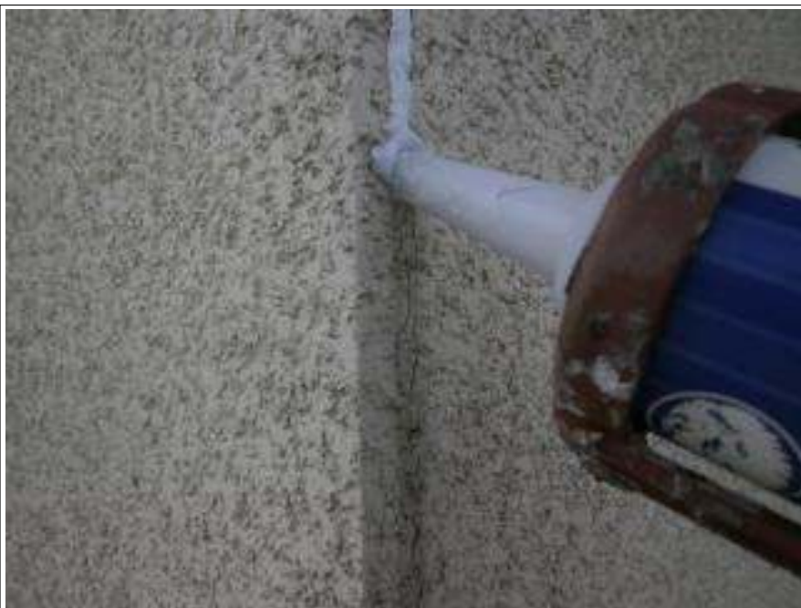
外壁コーキング補修施工中
