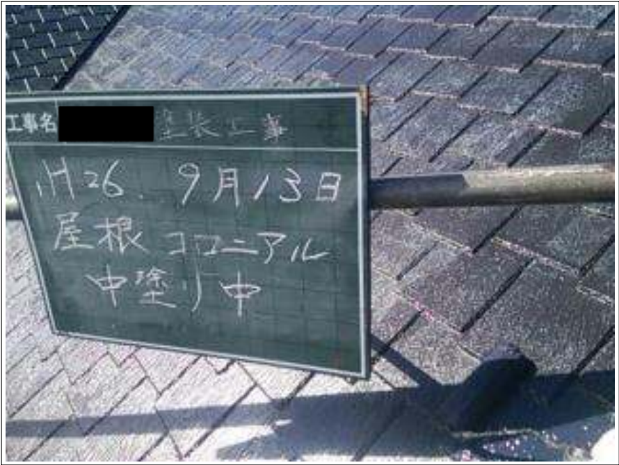
屋根塗装中塗り施工中
