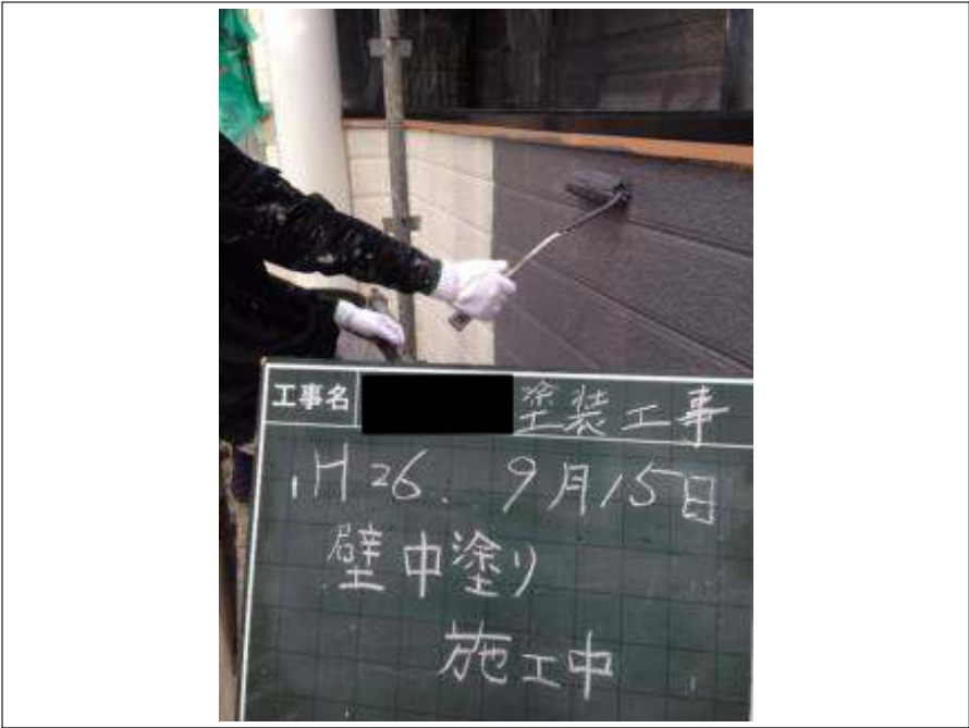
外壁塗装中塗り施工中
