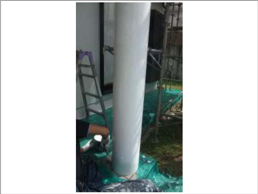
玄関柱塗装施工中
