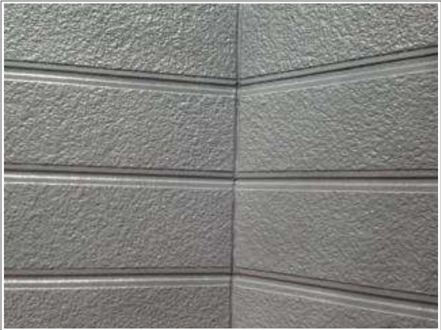
外壁塗装上塗り施工完了
