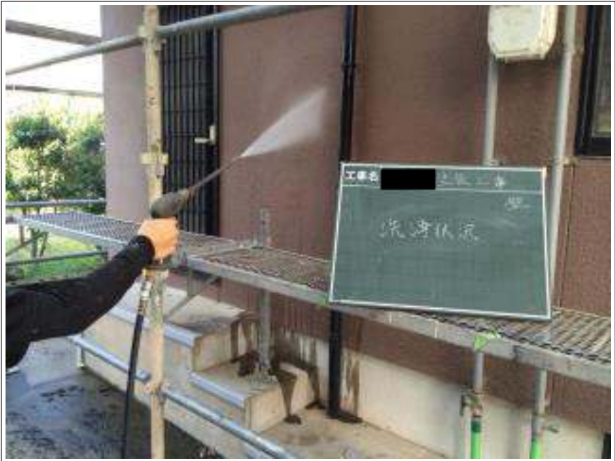
外壁高圧洗浄施工中
