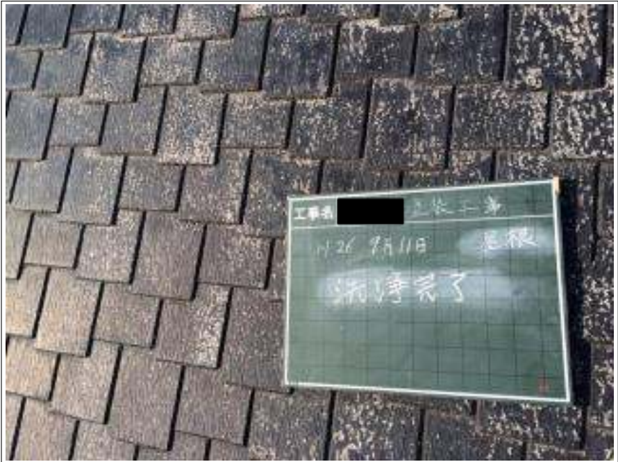
屋根高圧洗浄施工完了
