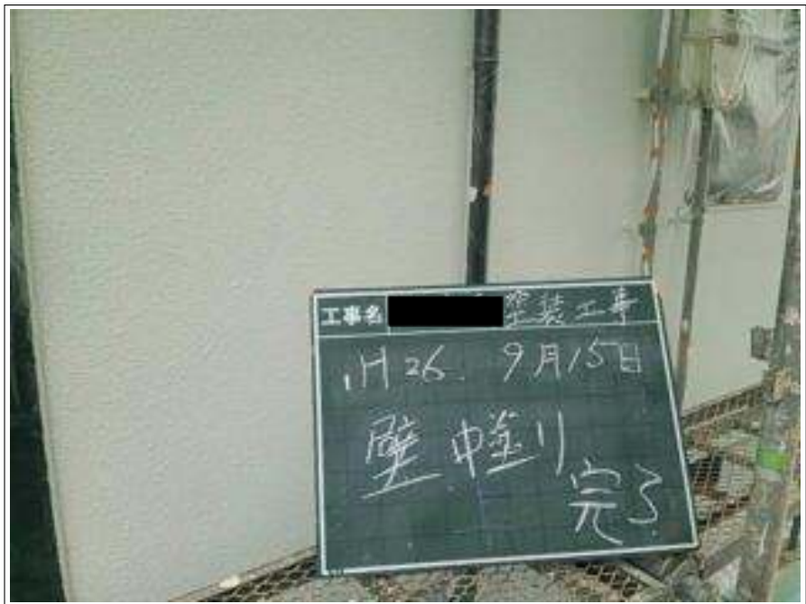
外壁塗装中塗り施工完了
