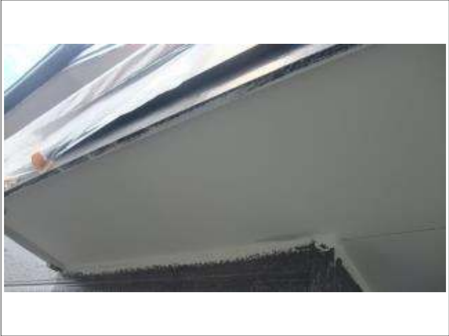
軒天塗装施工完了
