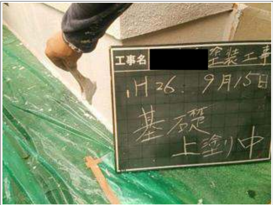
基礎塗装 2 回目施工中
