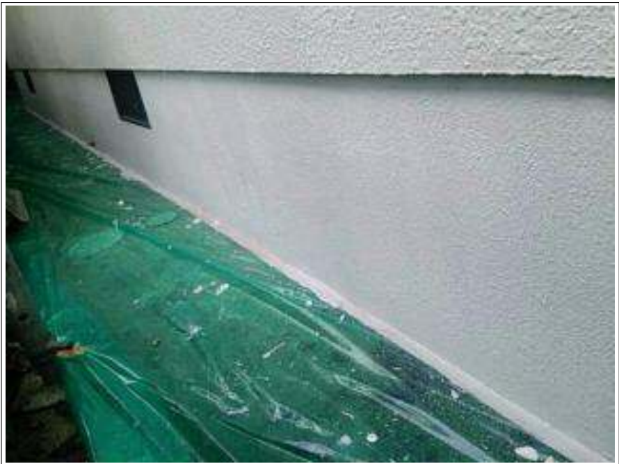
基礎塗装施工完了
