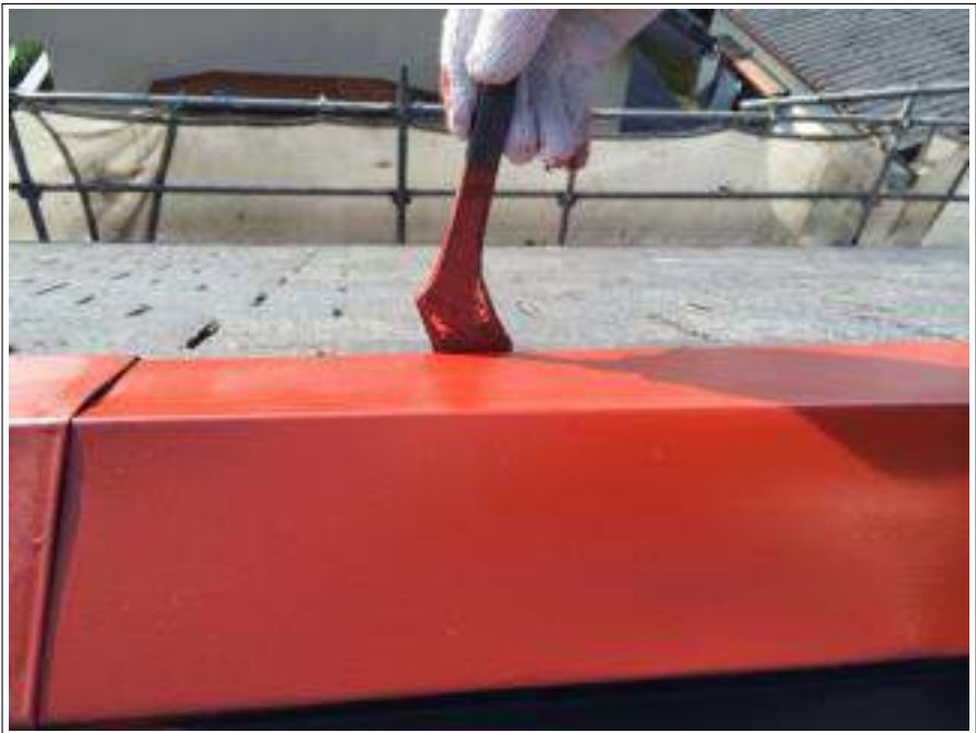
屋根トタン部サビ止め施工中
