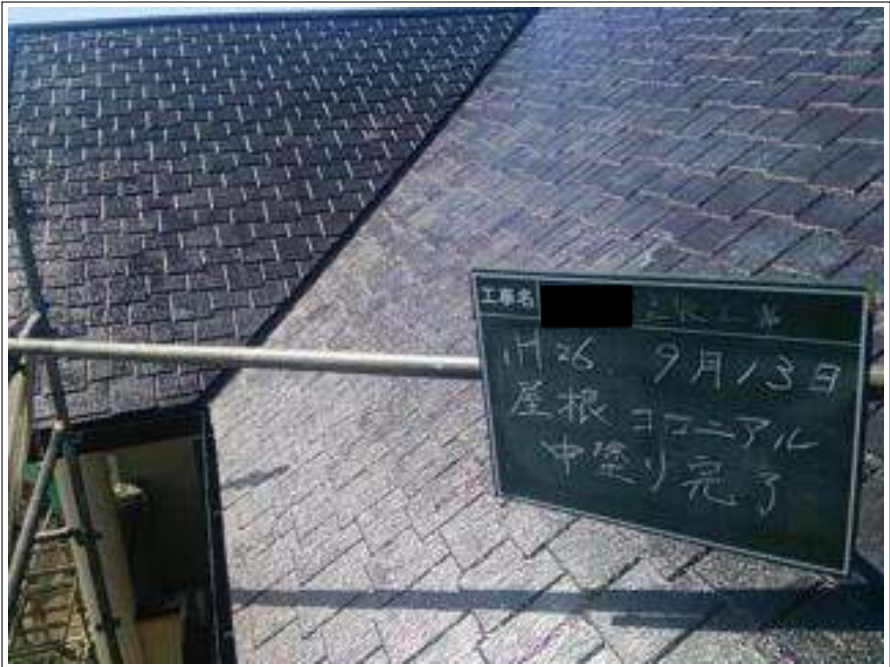
屋根塗装中塗り施工完了
