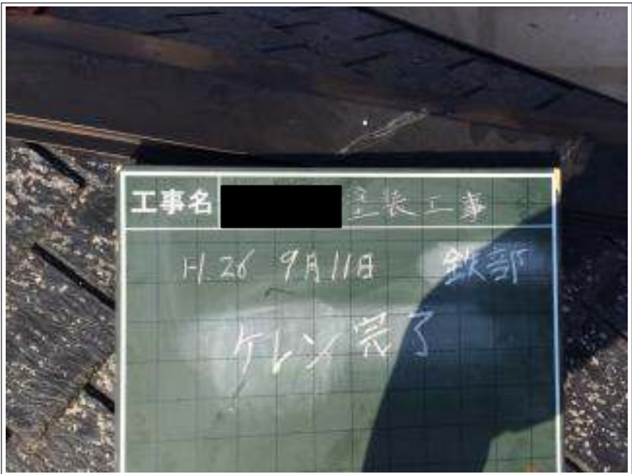
屋根ケレン施工完了
