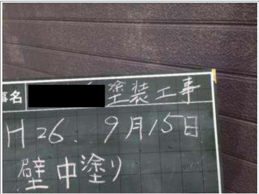
外壁塗装中塗り施工完了
