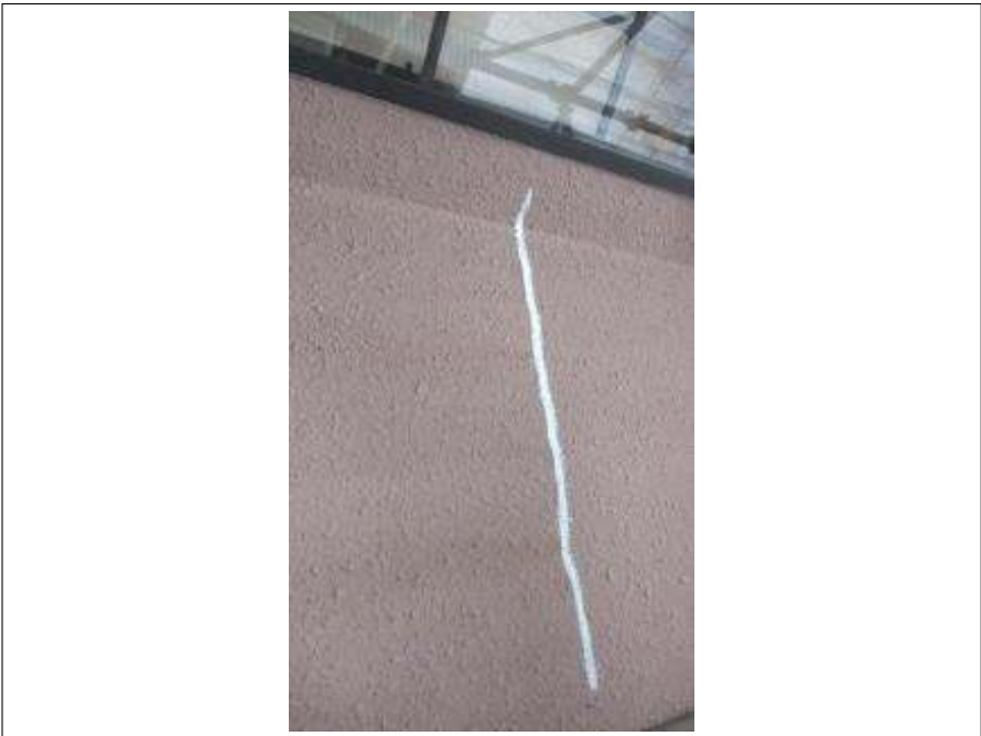
外壁コーキング補修施工完了
