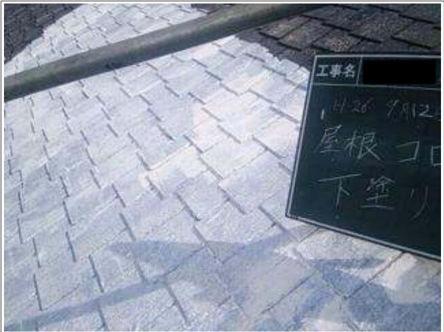
屋根塗装下塗り施工中
