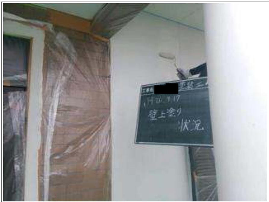
外壁塗装上塗り施工中
