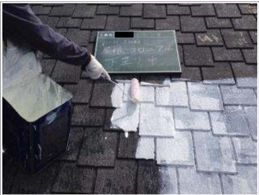
屋根塗装下塗り施工中
