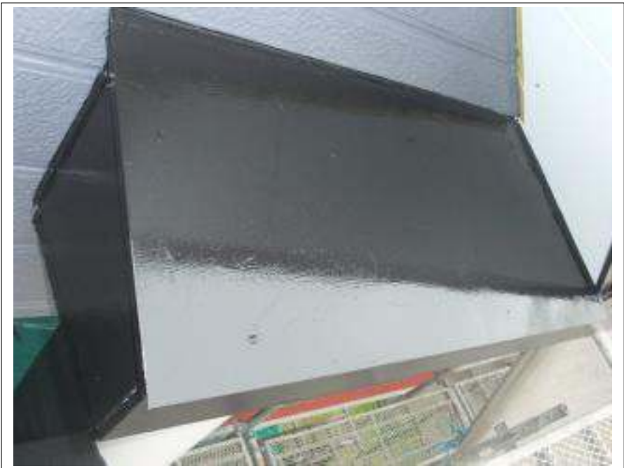
小庇塗装施工完了
