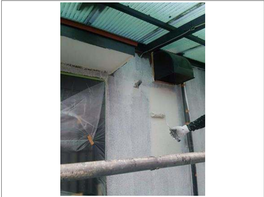
外壁塗装中塗り施工中
