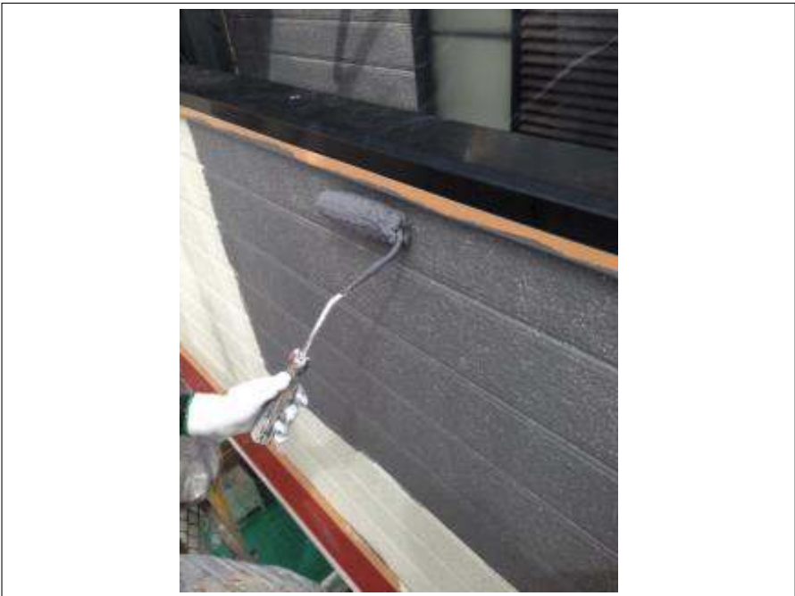
外壁塗装中塗り施工中
