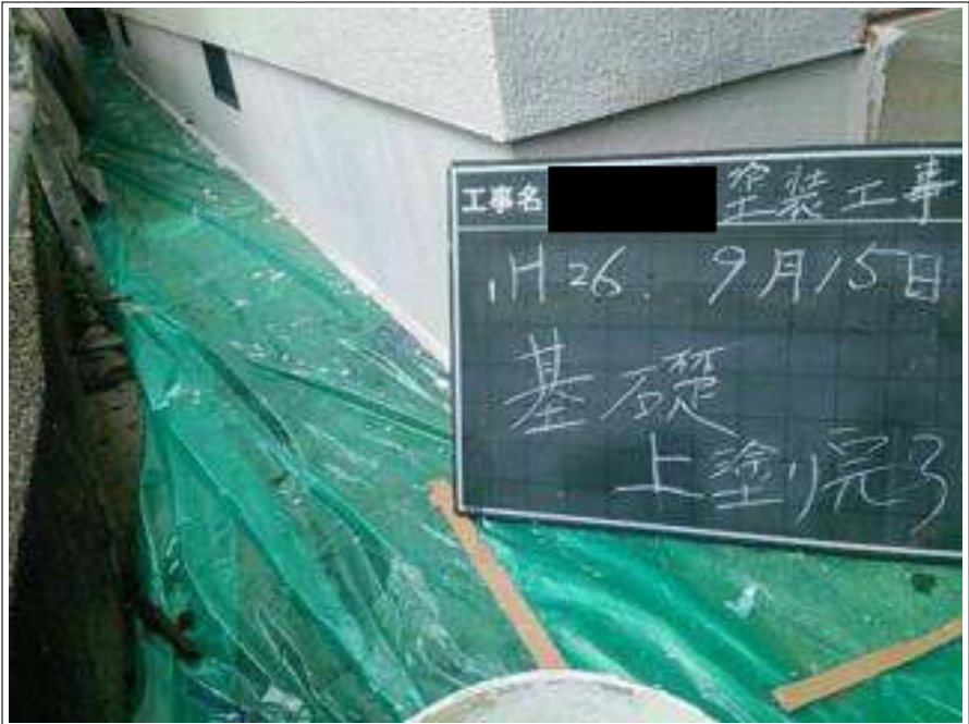
基礎塗装 2回目施工完了
