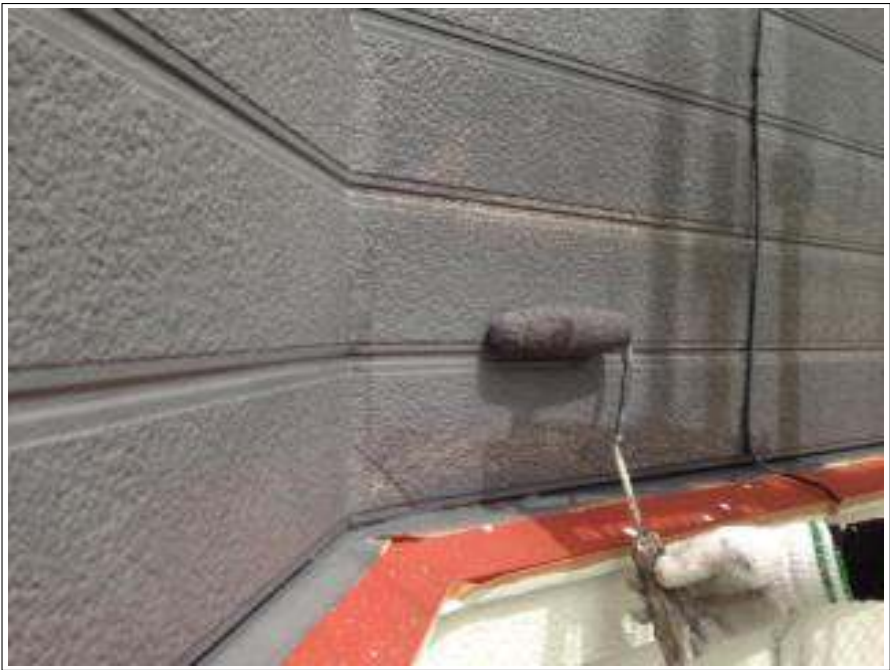
外壁塗装上塗り施工中
