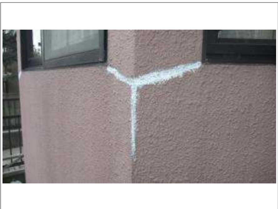
外壁コーキング補修施工完了
