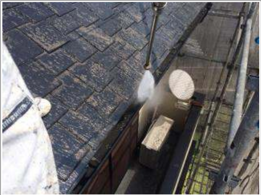
樋高圧洗浄施工中
