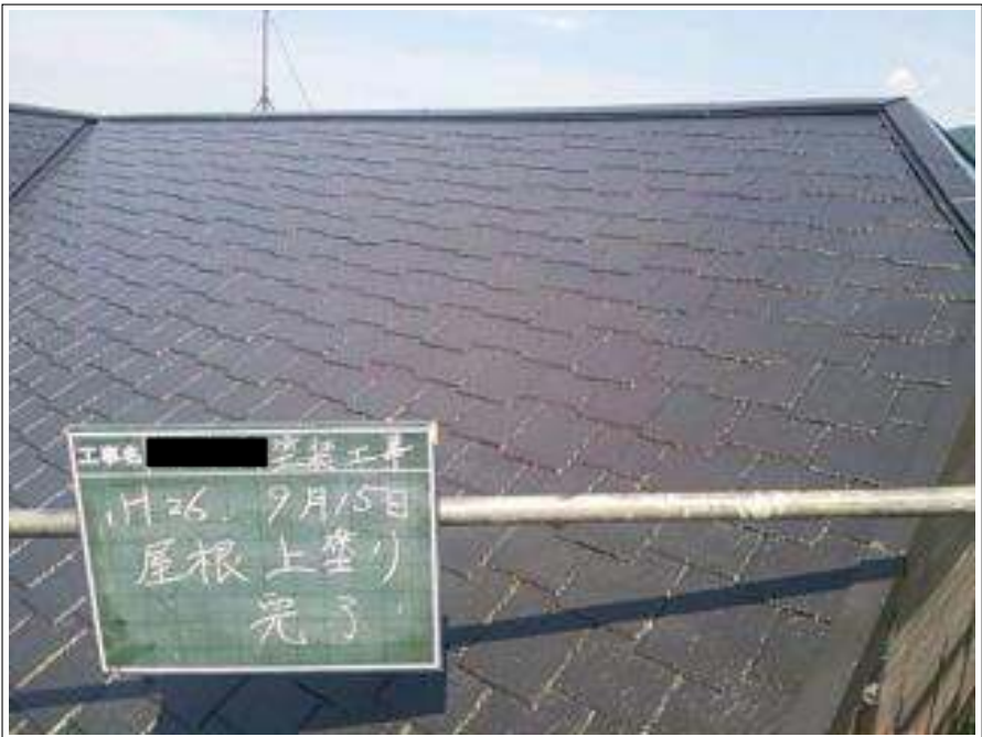
屋根塗装上塗り施工完了
