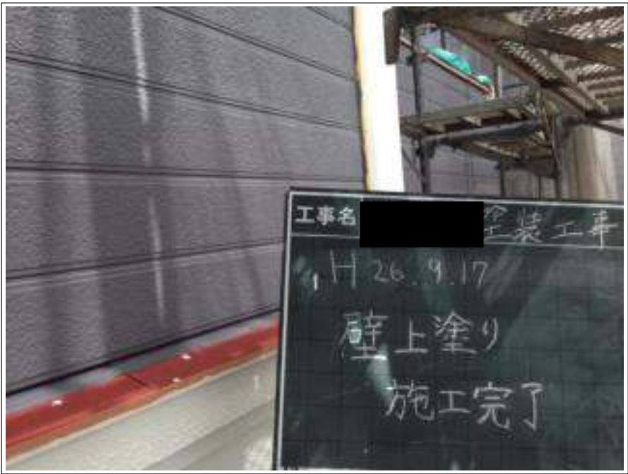
外壁塗装上塗り施工完了
