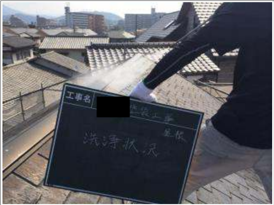
屋根高圧洗浄施工中
