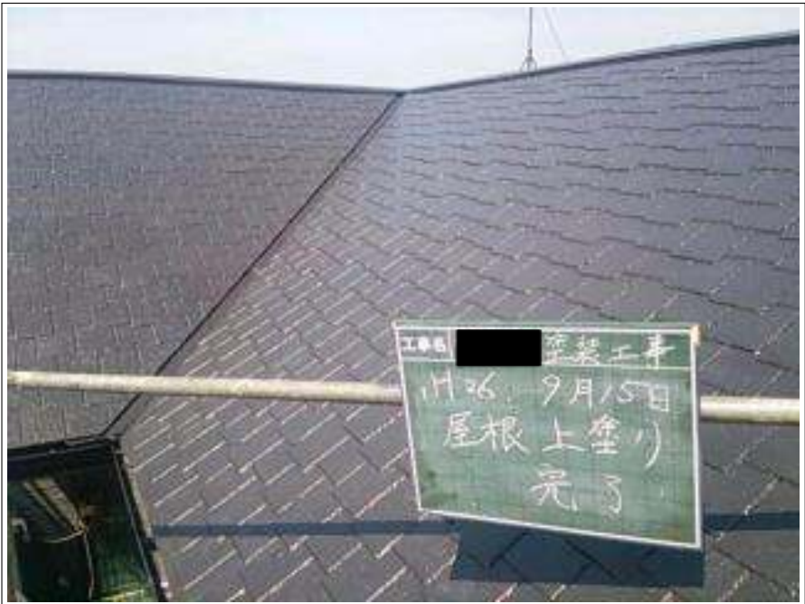
屋根塗装上塗り施工完了
