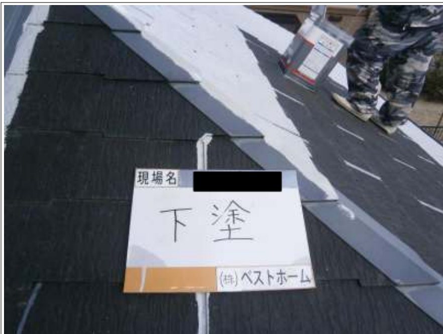
屋根下塗り施工中
