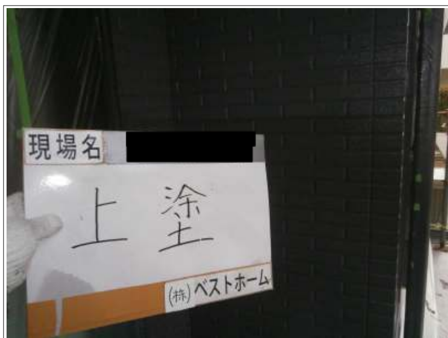
外壁上塗り施工中
