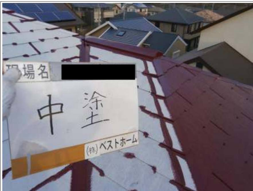
屋根中塗り施工中
