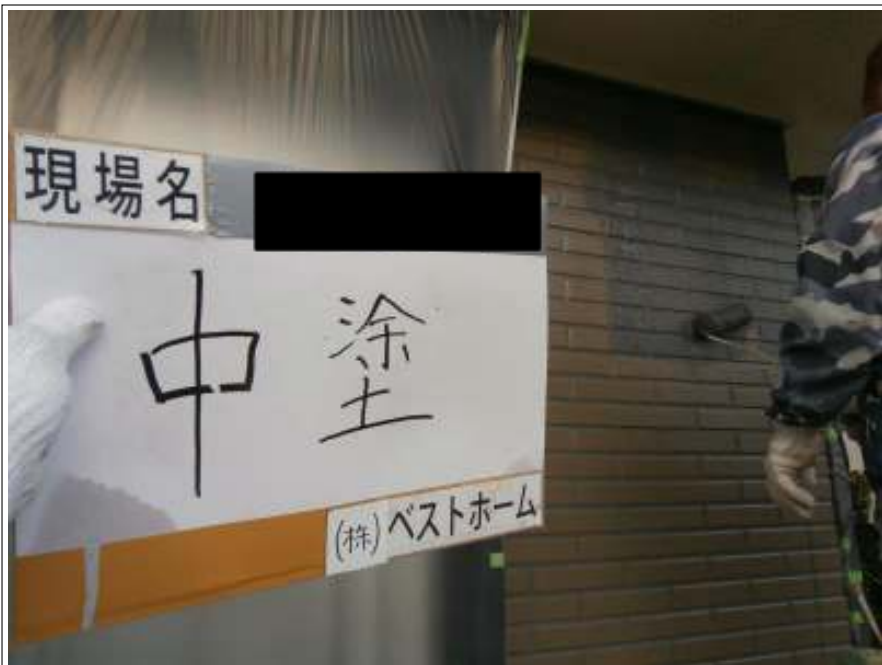
外壁中塗り施工中
