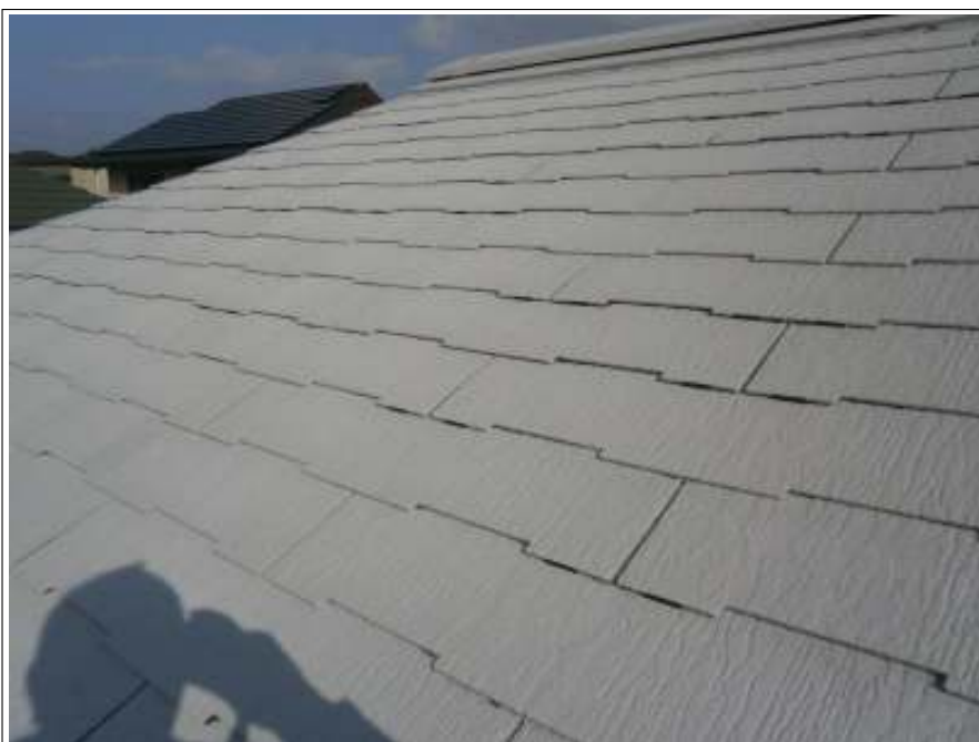
屋根下塗り施工中
