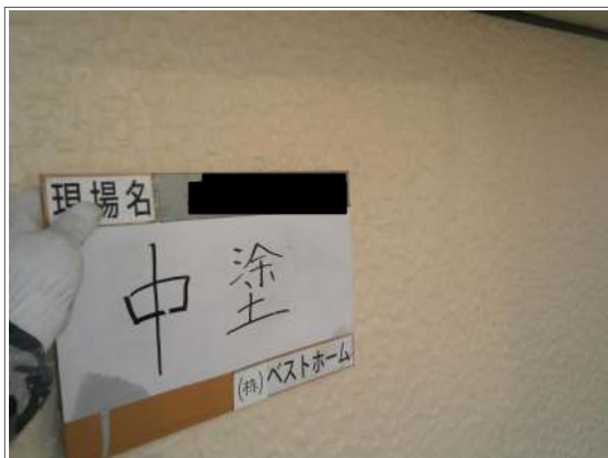
外壁中塗り施工中
