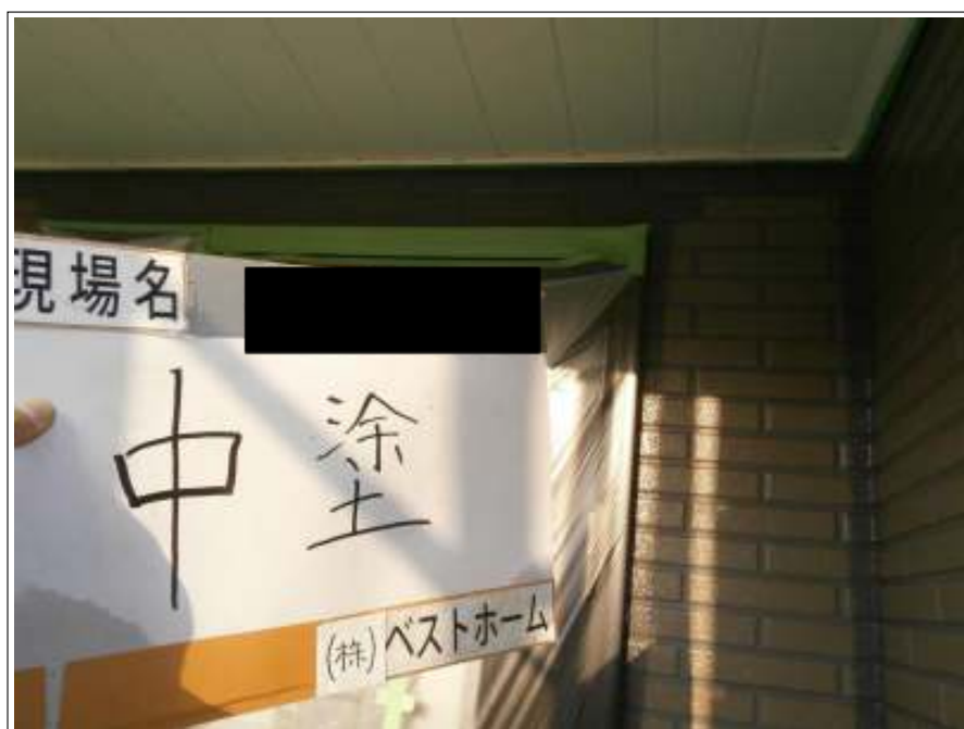
外壁中塗り施工中
