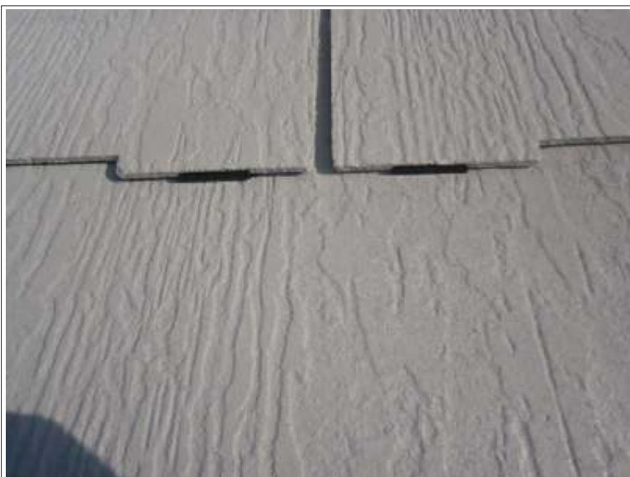
屋根下塗り施工中
