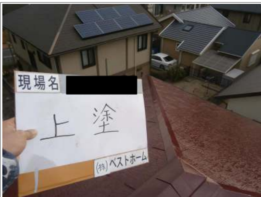
屋根上塗り施工中
