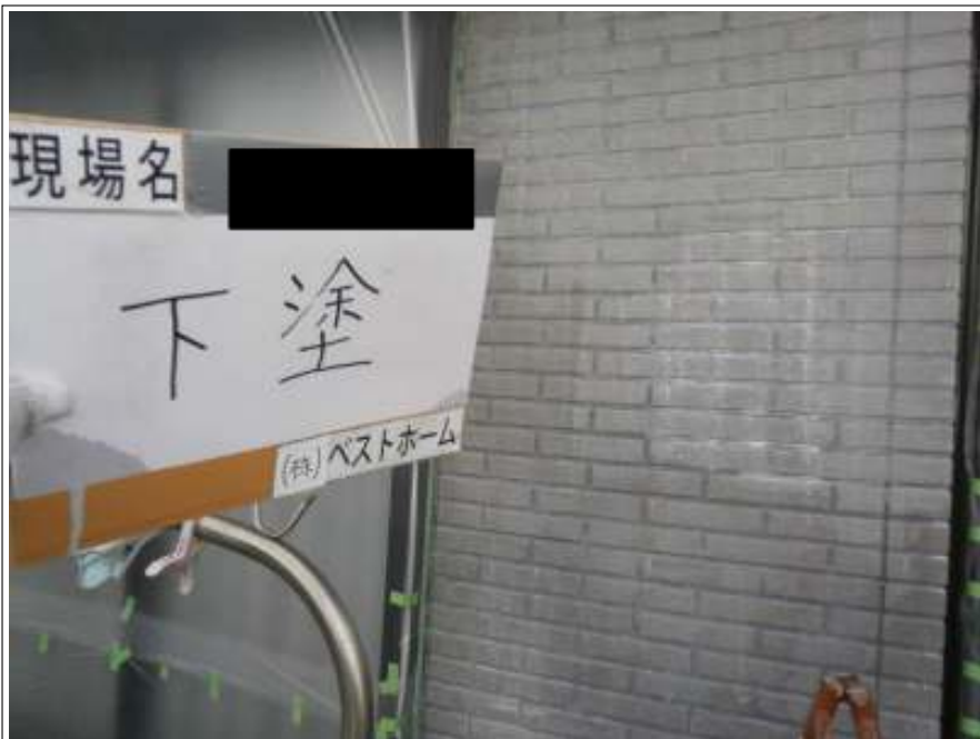
外壁下塗り施工中
