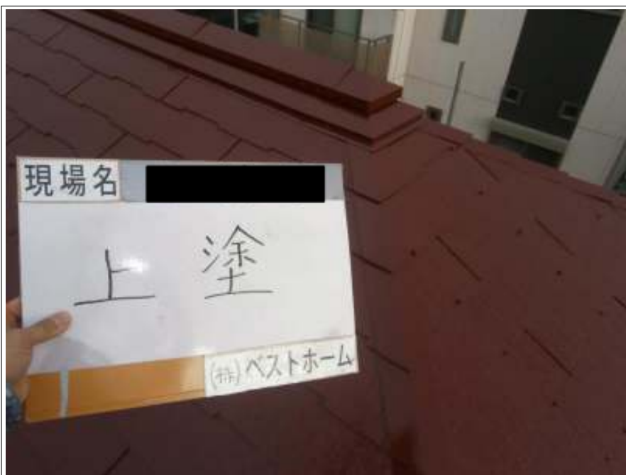
屋根上塗り施工中
