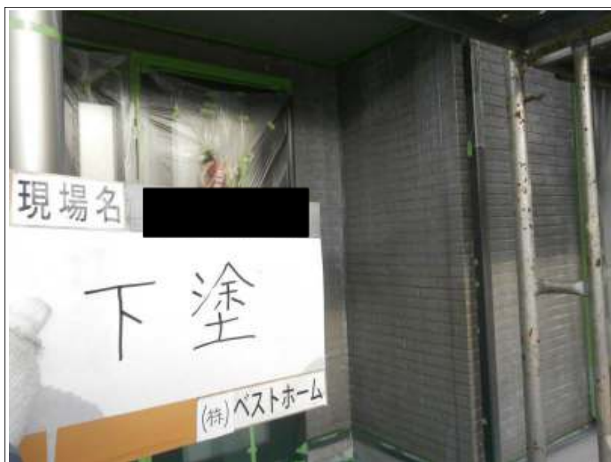
外壁下塗り施工中
