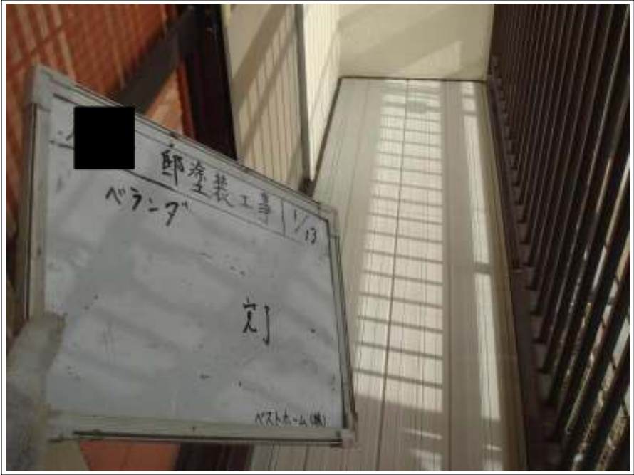
ベランダ上塗り施工完了
