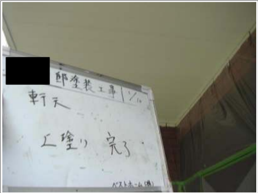
軒天上塗り2回目施工完了
