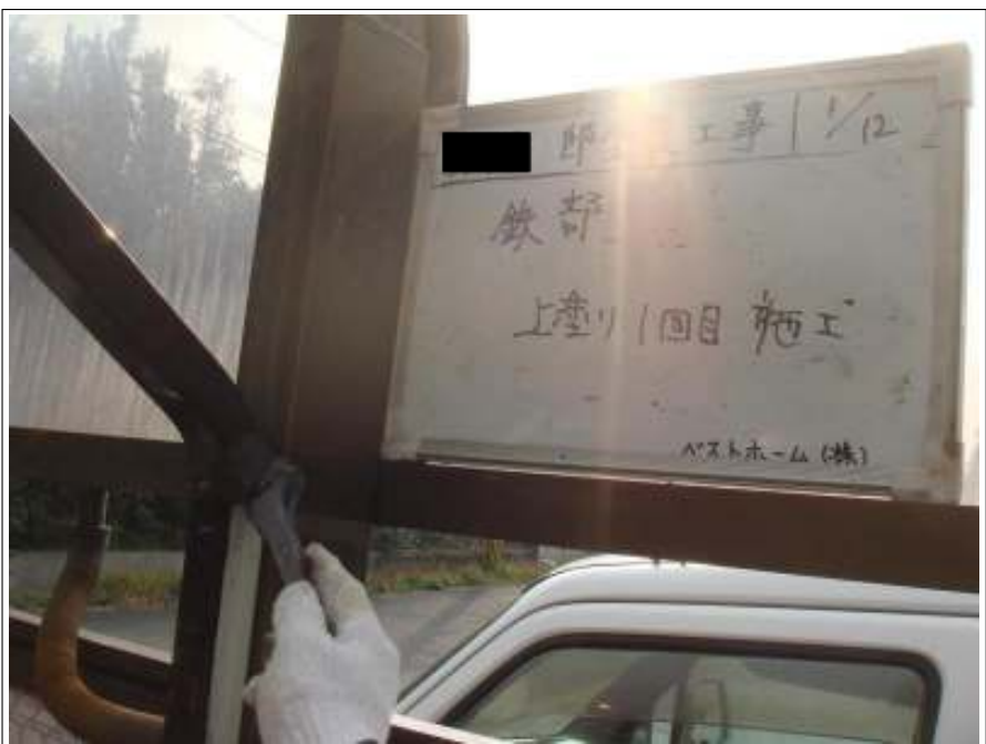
鉄部上塗り1回目施工中
