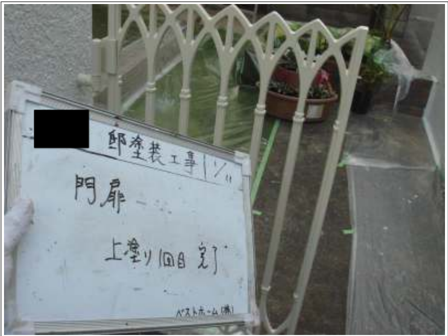
門扉上塗り1回目施工完了
