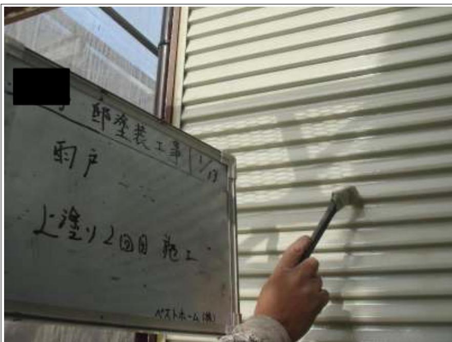
雨戸上塗り2回目施工中
