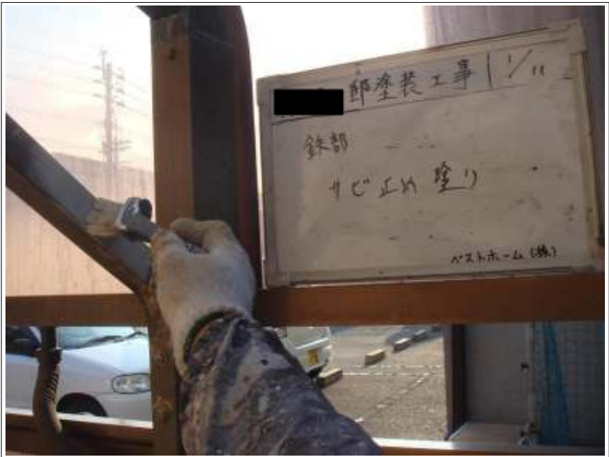
鉄部サビ止め塗り施工中
