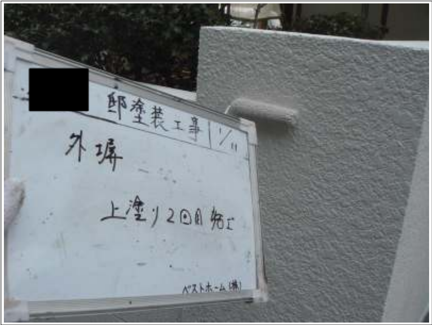
外塀上塗り2回目施工中
