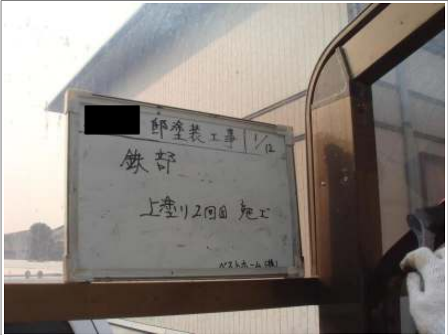
鉄部上塗り2回目施工中
