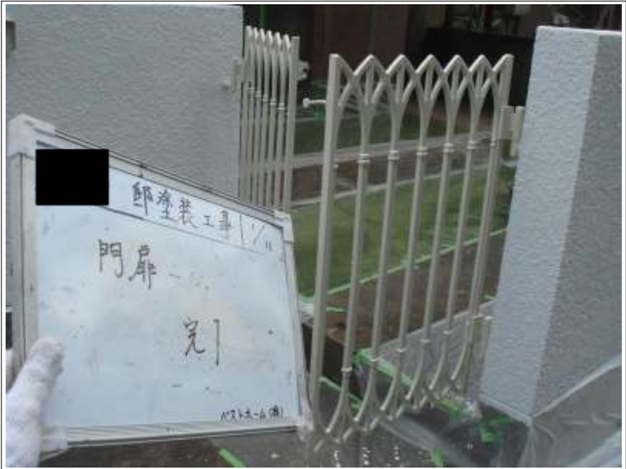
門扉上塗り2回目施工完了
