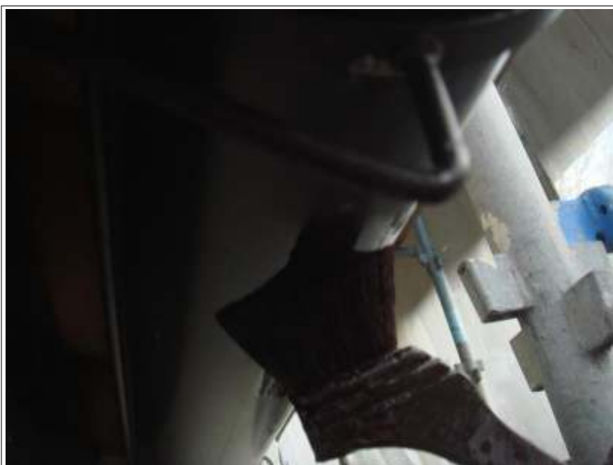
雨樋上塗り1回目施工中
