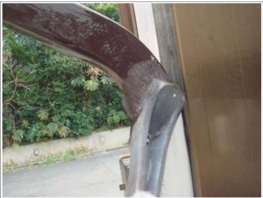
鉄部上塗り1回目施工中
