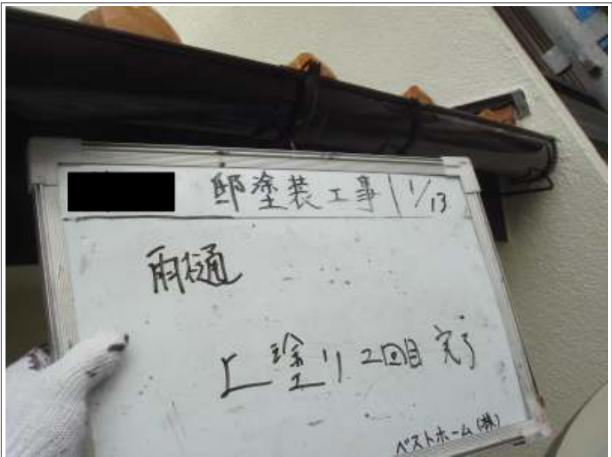
雨樋上塗り2回目施工完了
