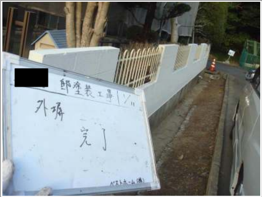
外塀上塗り2回目施工完了
