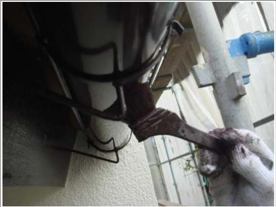
雨樋上塗り2回目施工中
