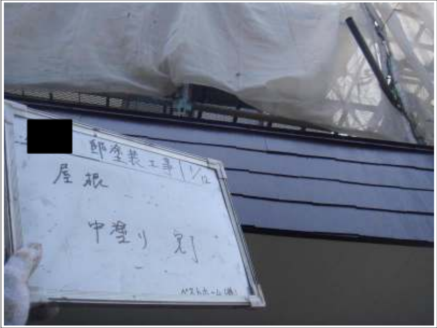
屋根中塗り施工完了
