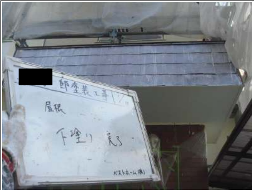
屋根下塗り施工完了
