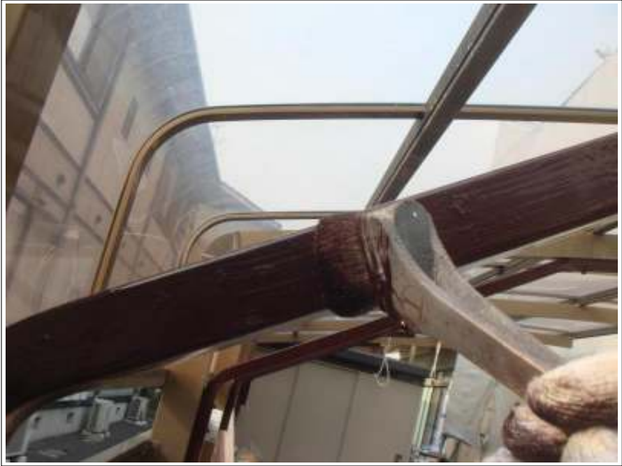
鉄部上塗り2回目施工中
