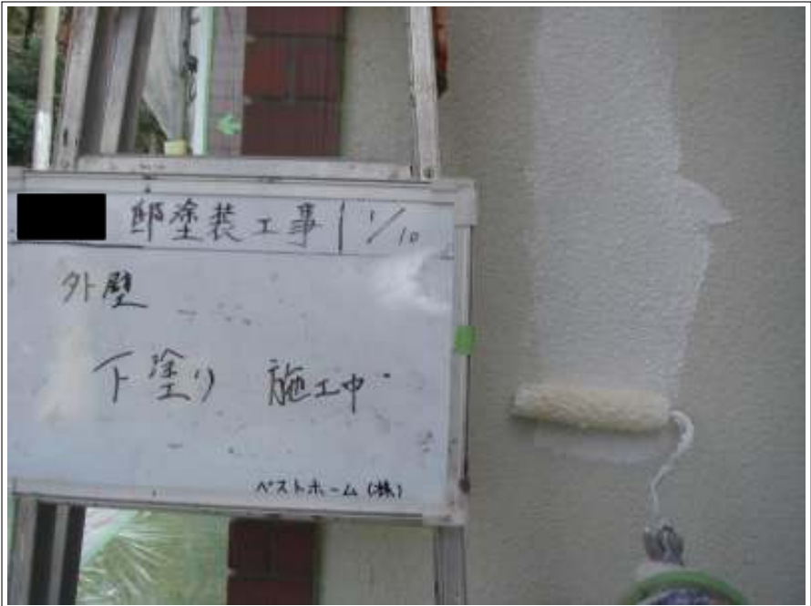
外壁下塗り施工中
