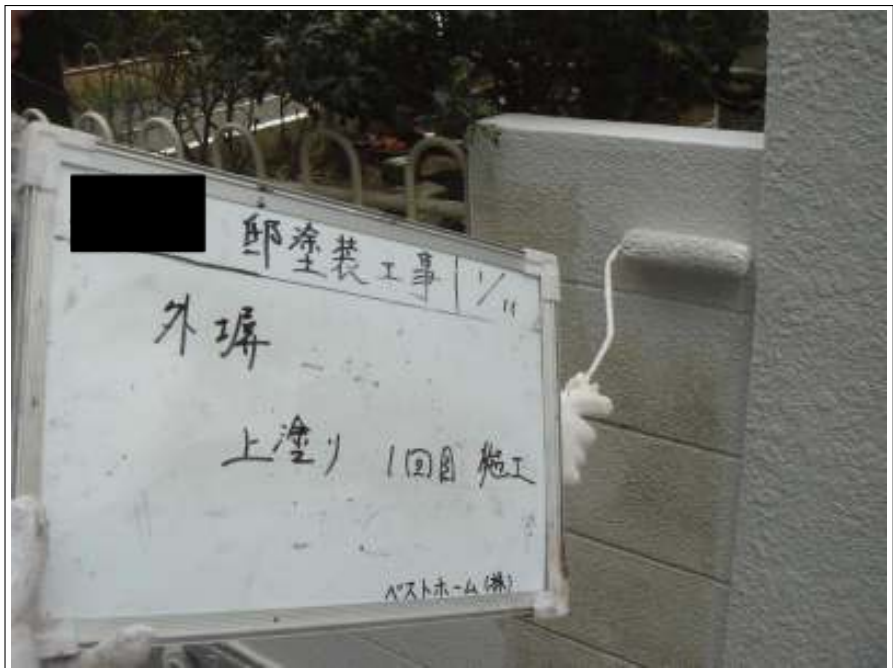
外塀上塗り1回目施工中
