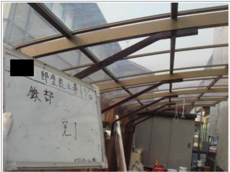
鉄部上塗り2回目施工完了
