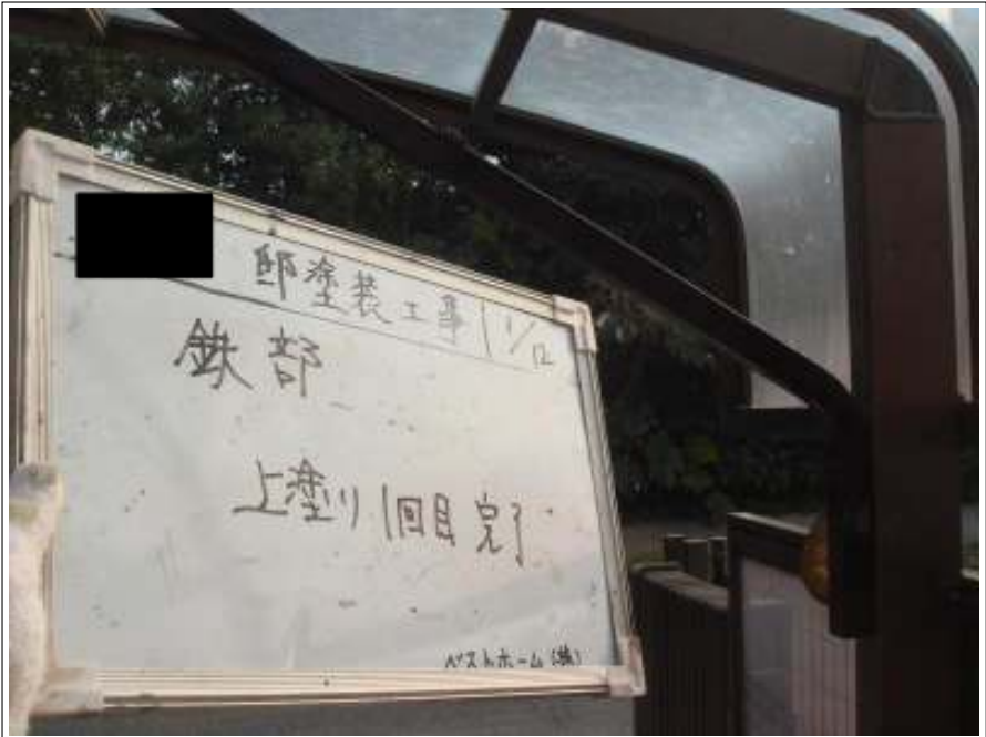
鉄部上塗り1回目施工完了
