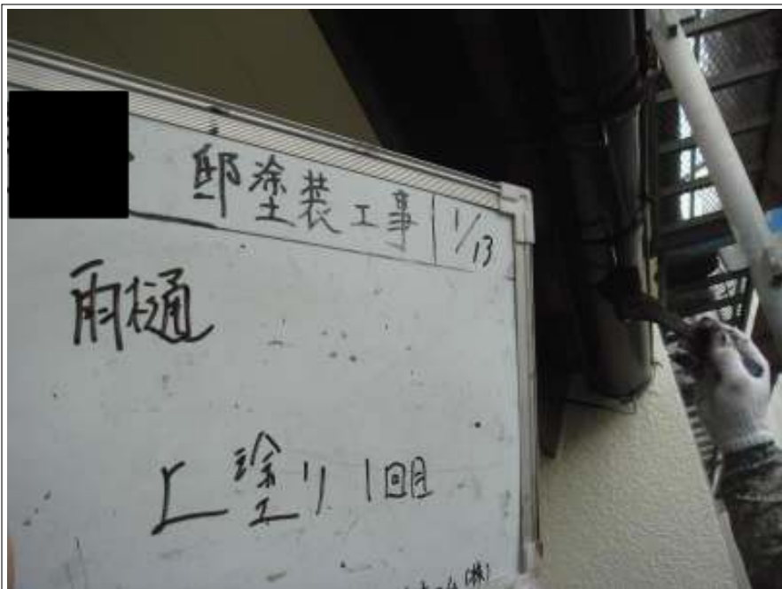
雨樋上塗り1回目施工中
