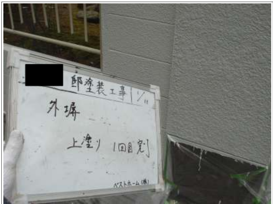
外塀上塗り1回目施工完了
