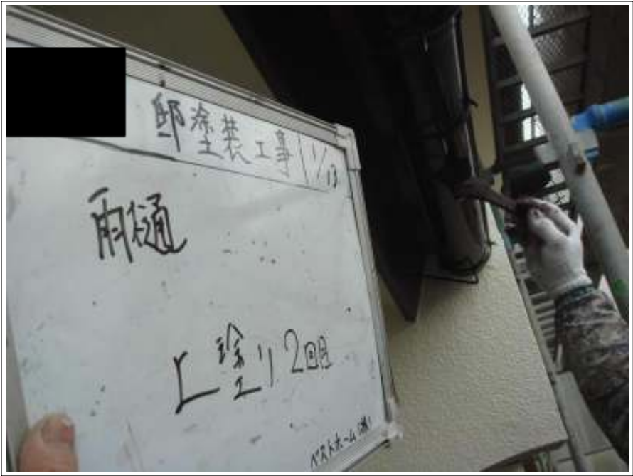
雨樋上塗り2回目施工中
