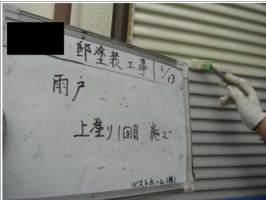
雨戸上塗り1回目施工中
