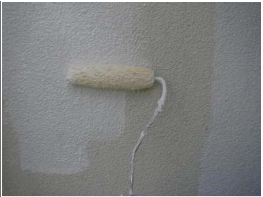
外壁下塗り施工中
