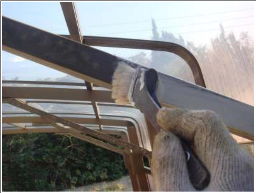
鉄部サビ止め塗り施工中
