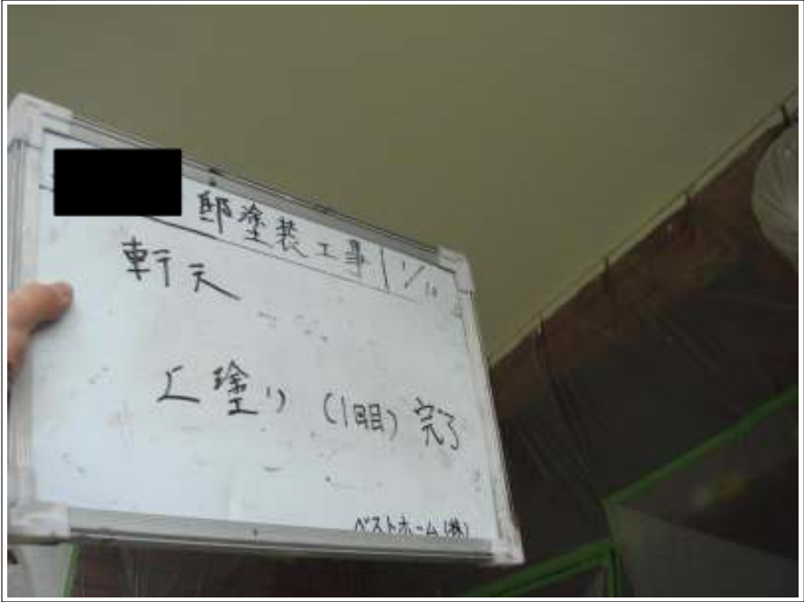
軒天上塗り1回目施工完了
