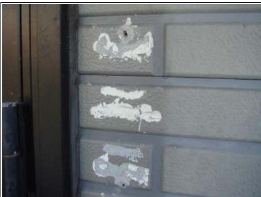
外壁補修施工前
