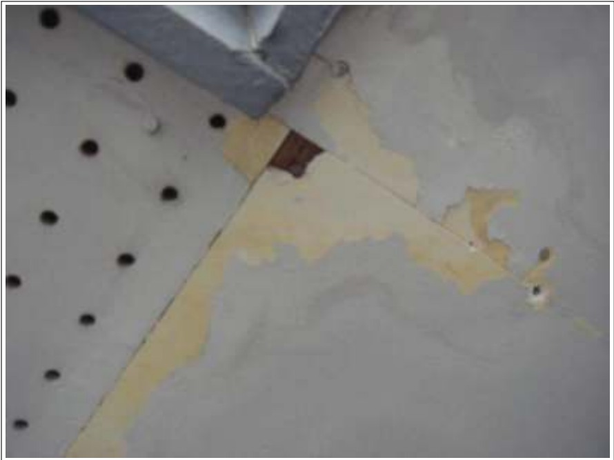
軒天補修施工前
