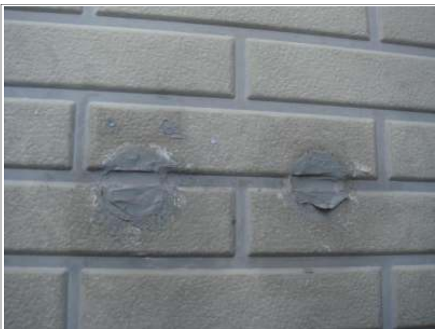
外壁補修施工前
