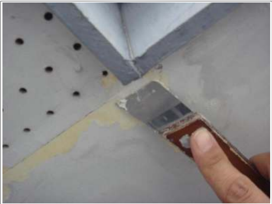
軒天補修施工中
