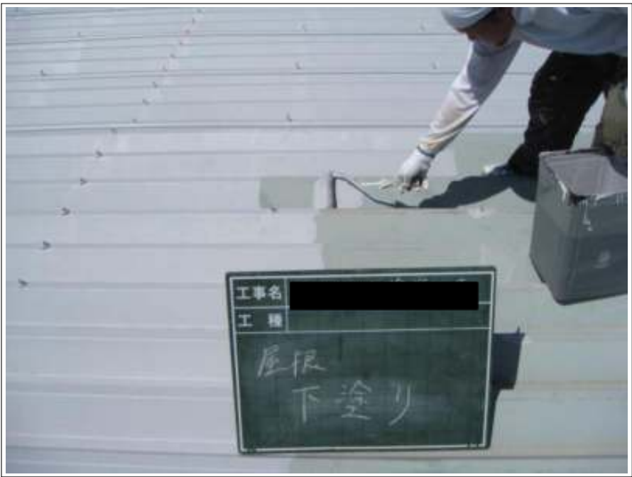
屋根塗装下塗り施工中
