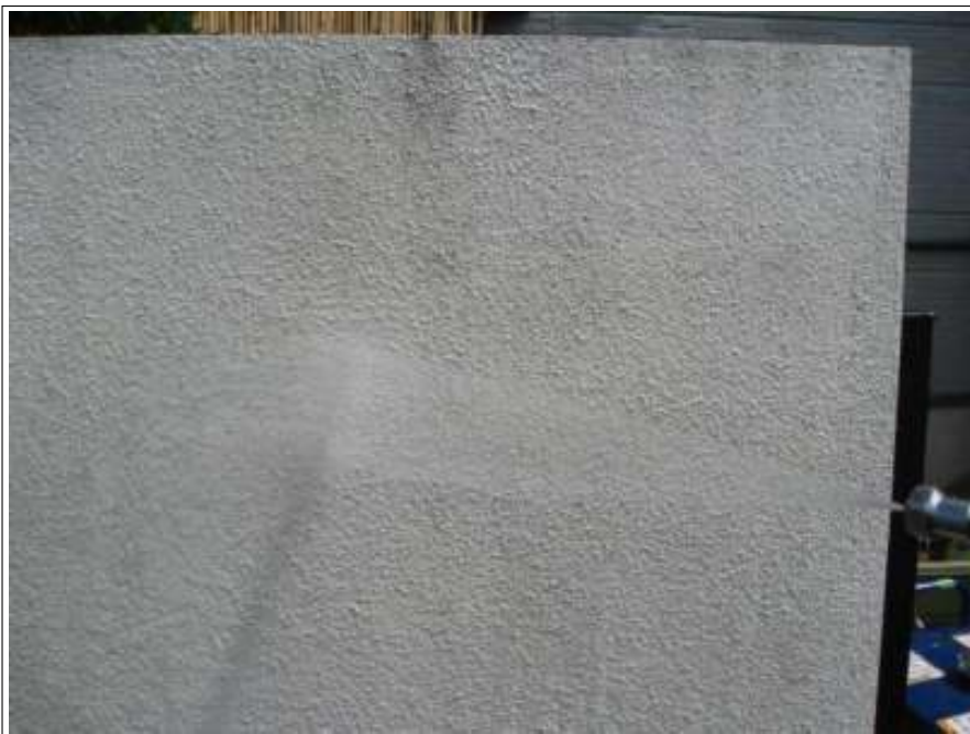
塀高圧洗浄施工中
