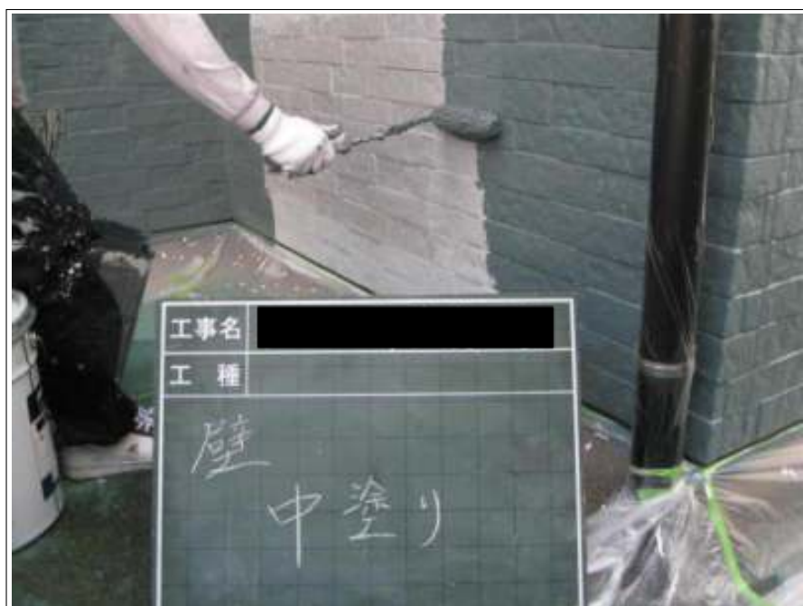
外壁塗装中塗り施工中
