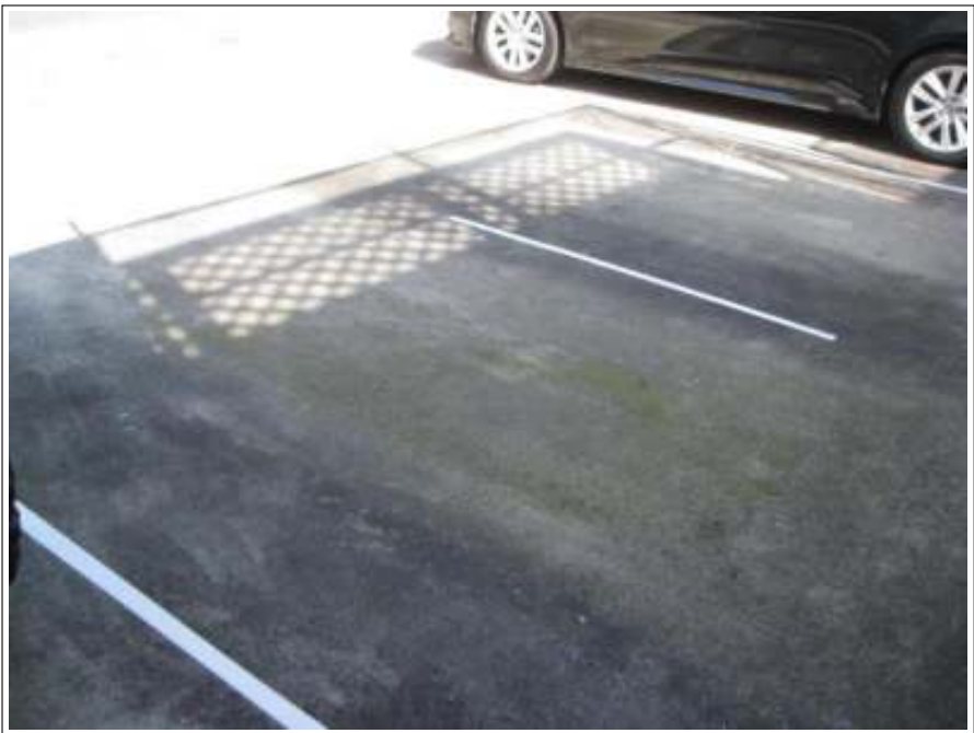
駐車場ライン塗装施工完了
