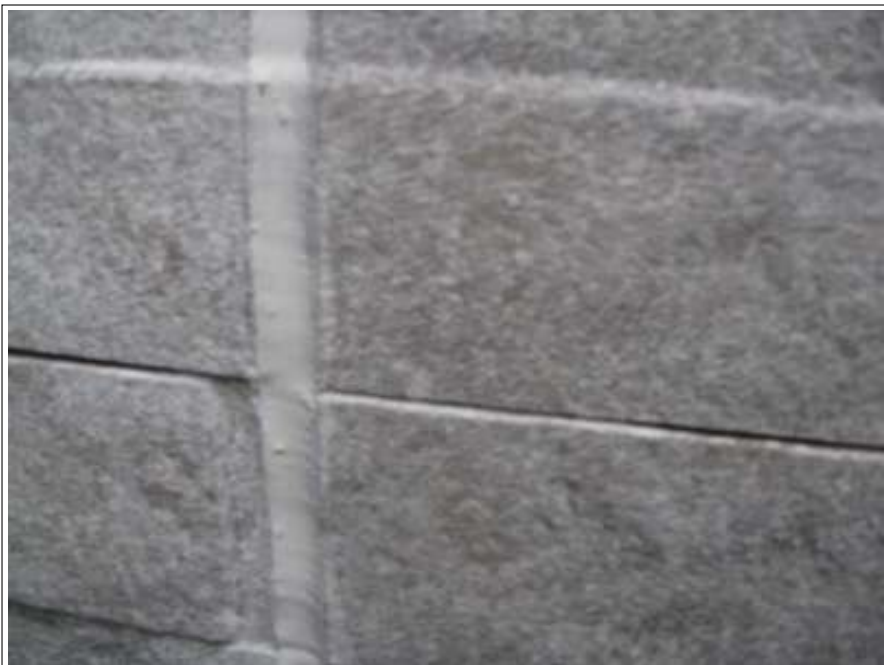
外壁シーリング補修施工完了
