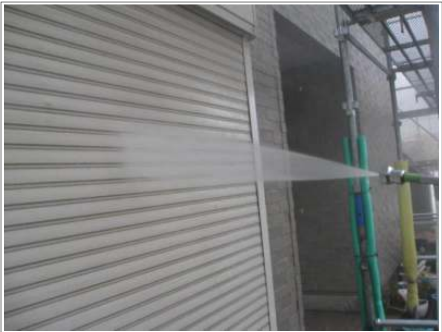
シャッター高压洗浄施工中
