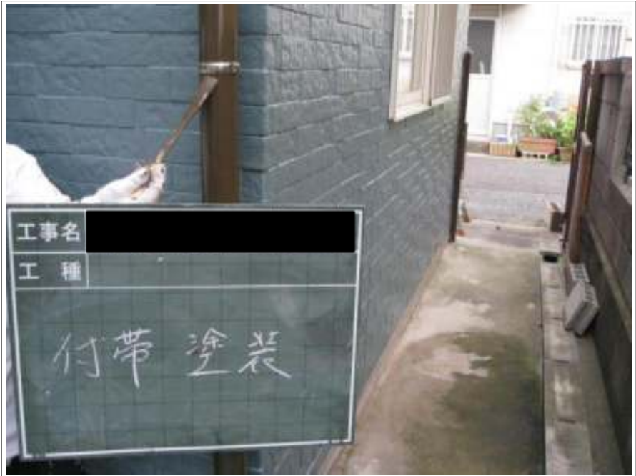
樋塗装施工中
