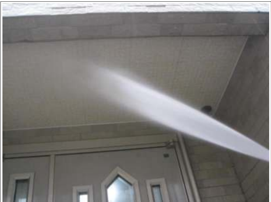
軒天高压洗浄施工中
