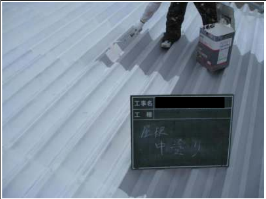
屋根塗装中塗り施工中
