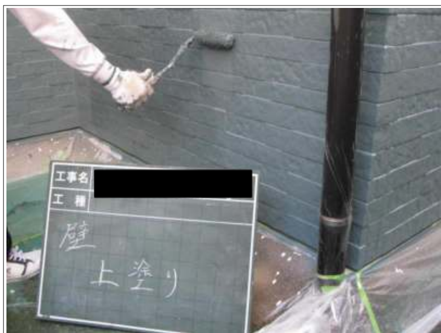
外壁塗装上塗り施工中
