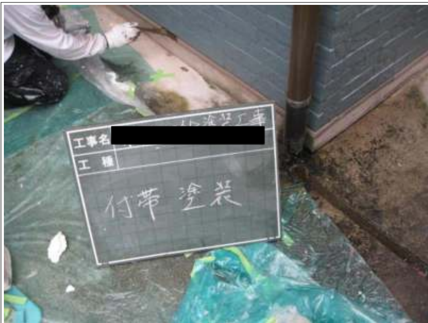
土台水切り塗装施工中
