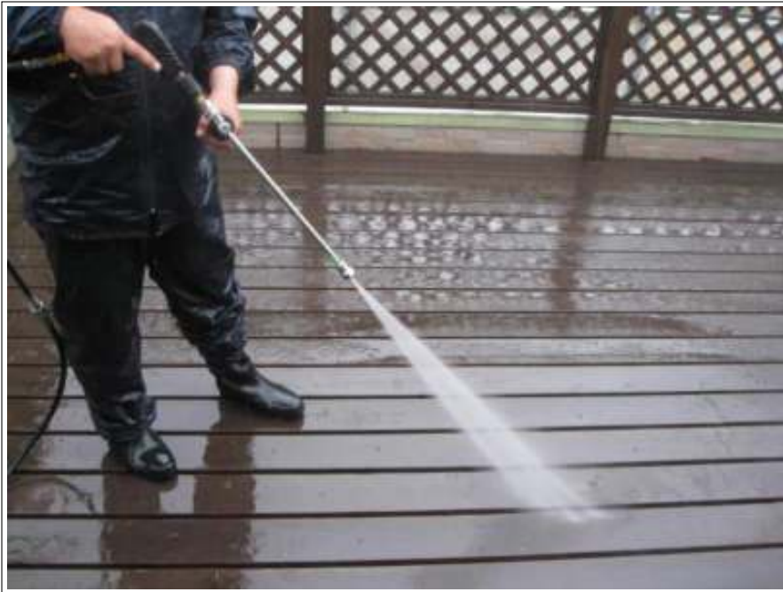
ウッドデッキ高圧洗浄施工中
