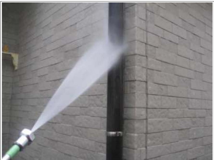
樋高压洗浄施工中
