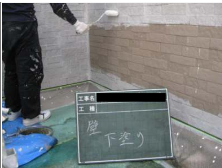
外壁塗装下塗り施工中
