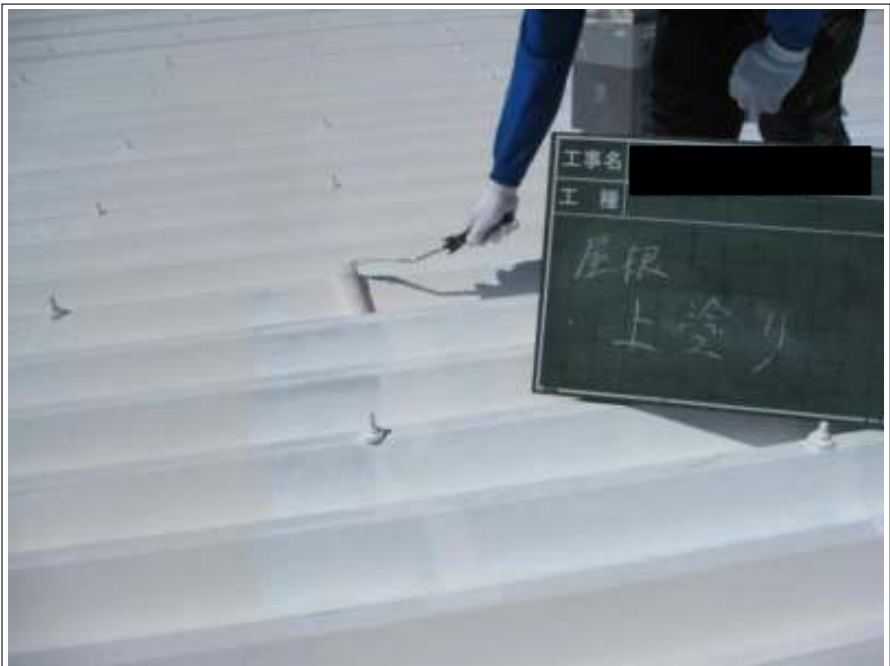
屋根塗装上塗り施工中
