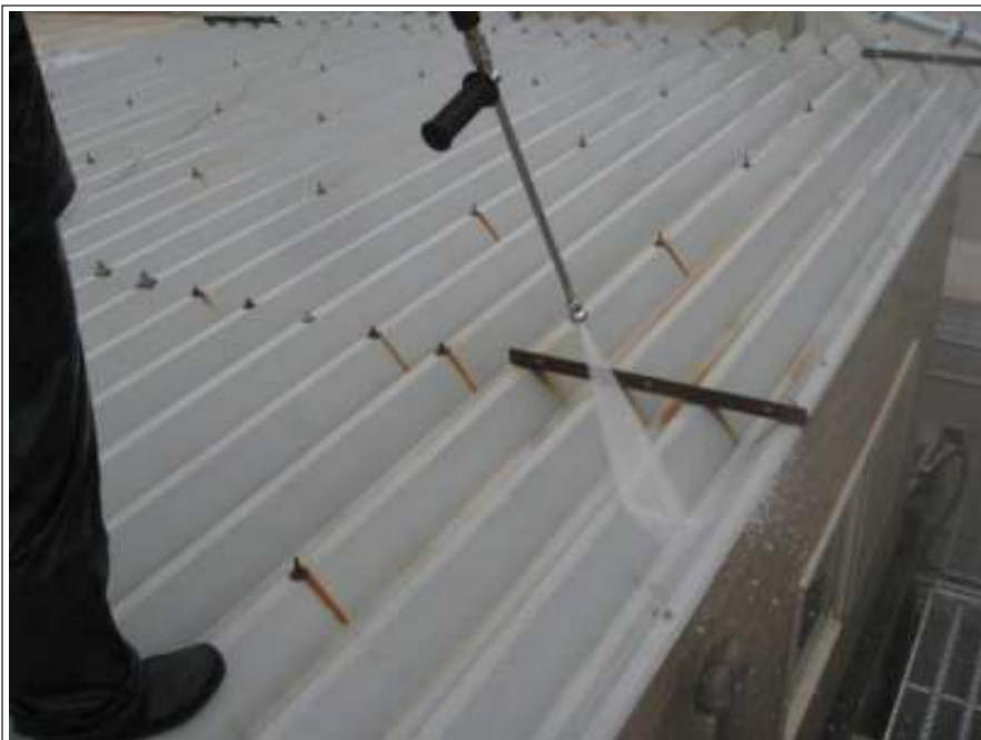
屋根高圧洗浄施工中
