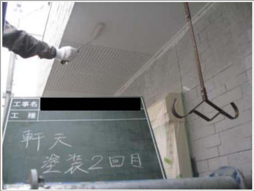
軒天塗装 2 回目施工中
