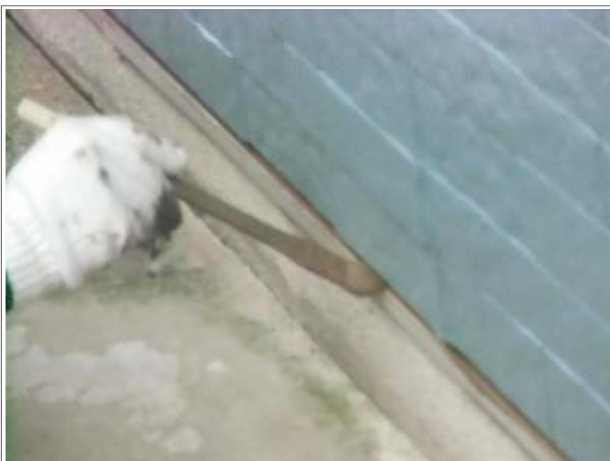
土台水切り塗装施工中
