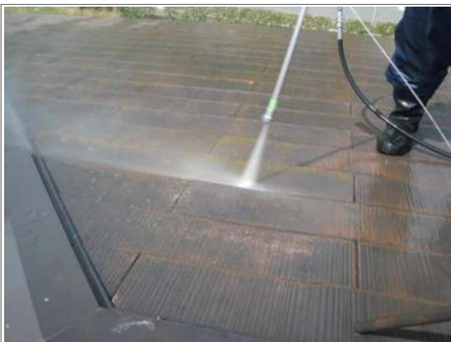
高圧洗浄施工中
