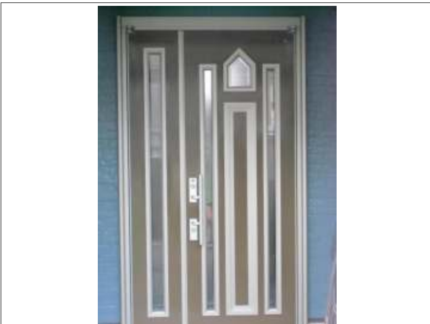
玄関塗装施工完了
