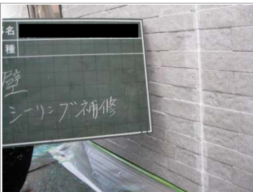
外壁シーリング補修施工完了
