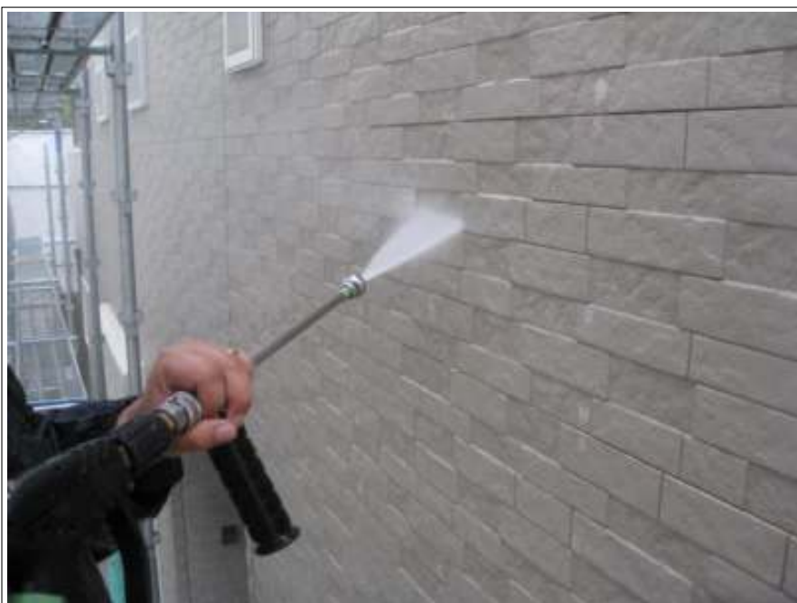
外壁高圧洗浄施工中
