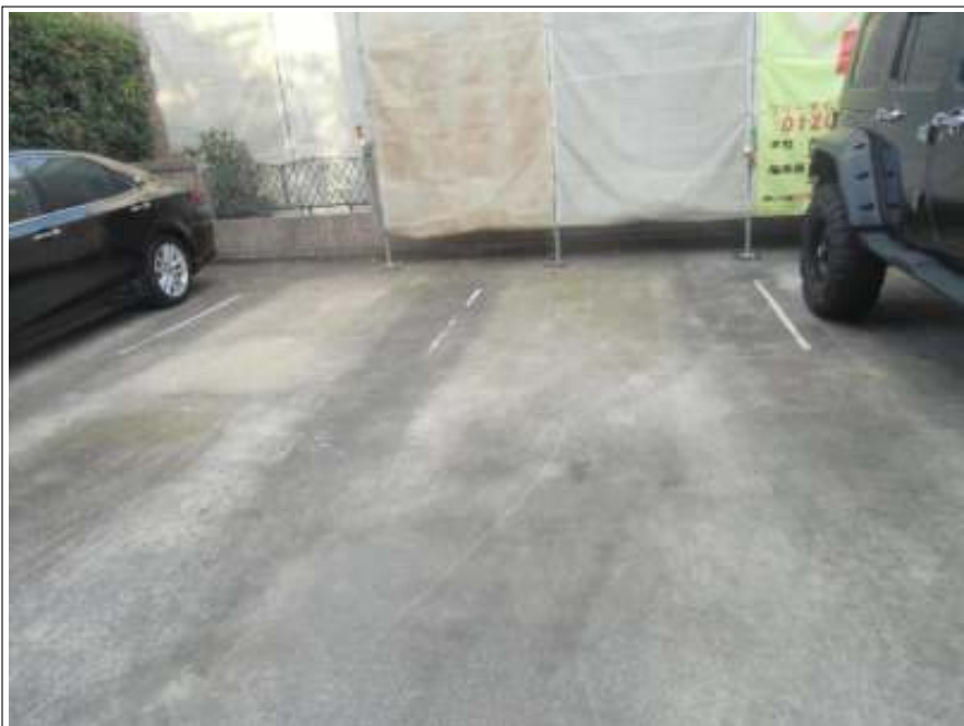
駐車場ライン塗装施工前
