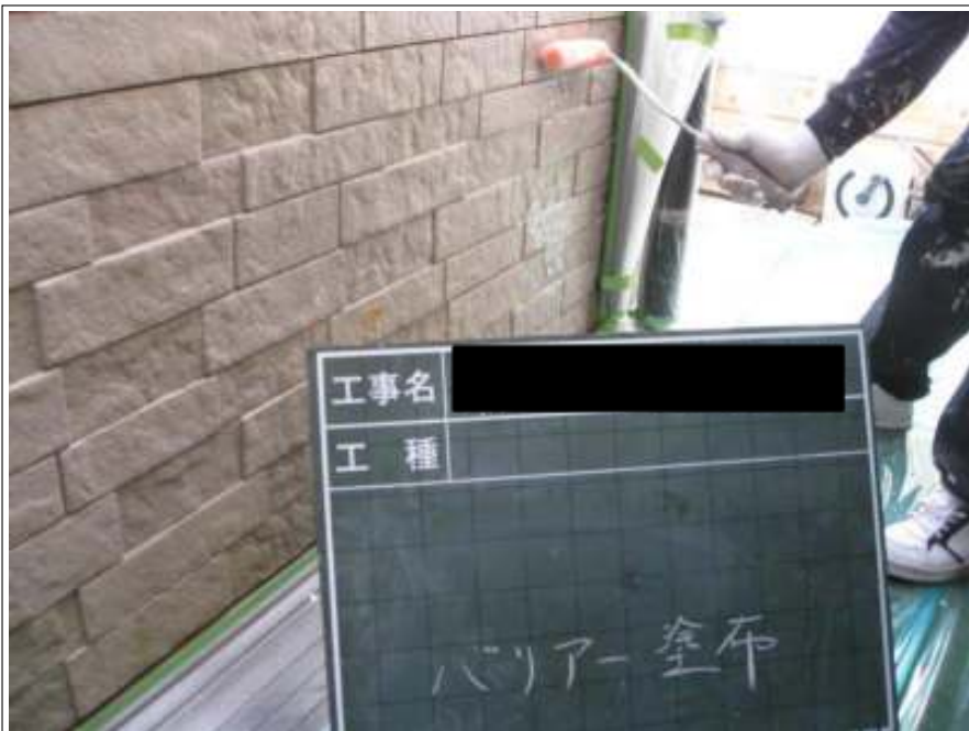
外壁塗装バリアー施工中
