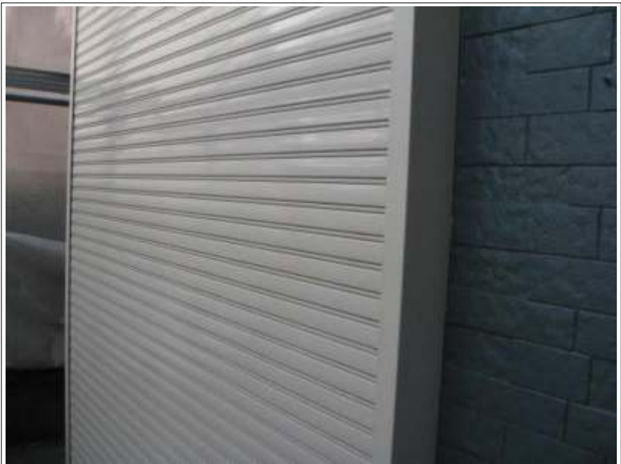
シャッター塗装施工完了
