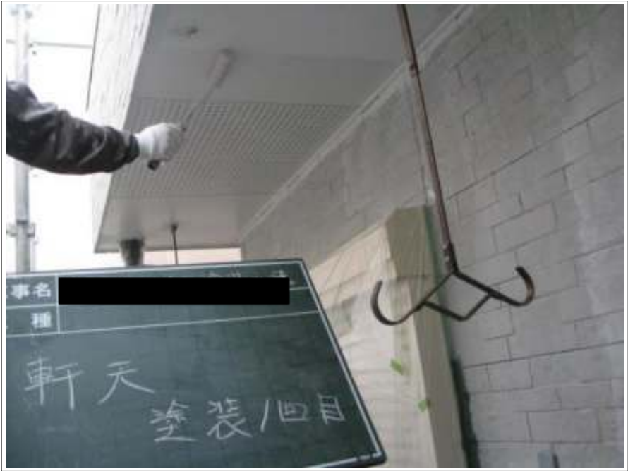
軒天塗装 1 回目施工中
