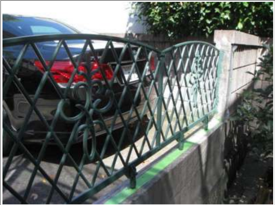
フェンス塗装施工完了
