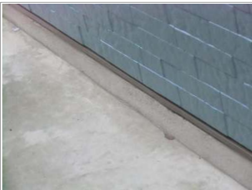
土台水切り塗装施工完了
