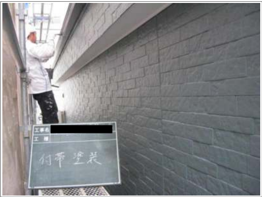
破風板塗装施工中
