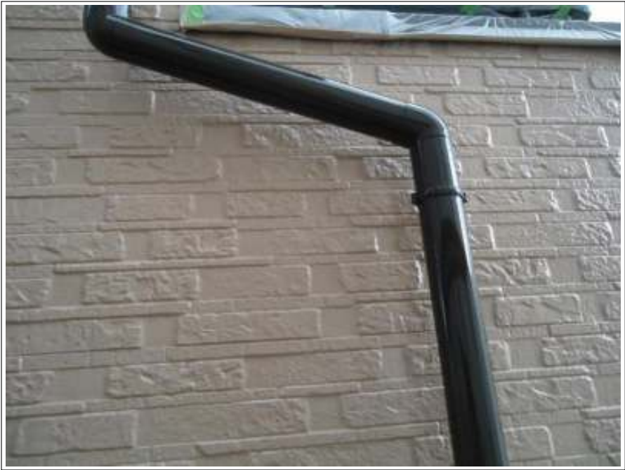
樋塗装施工完了
