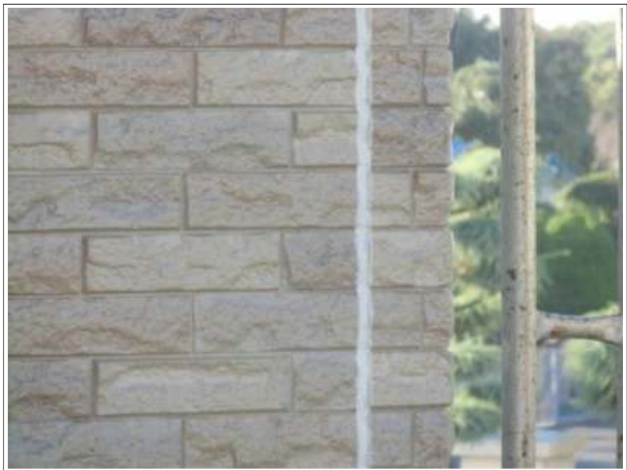
外壁シーリング補修施工完了
