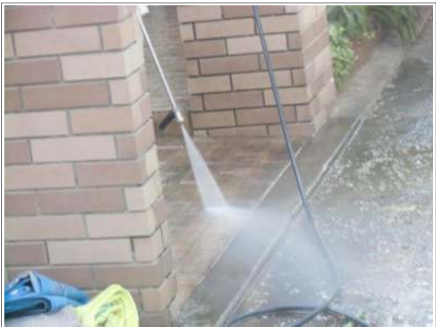
土間高圧洗浄施工中
