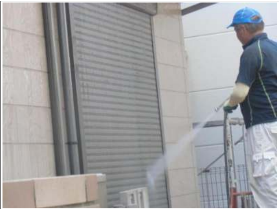
雨戸高圧洗浄施工中
