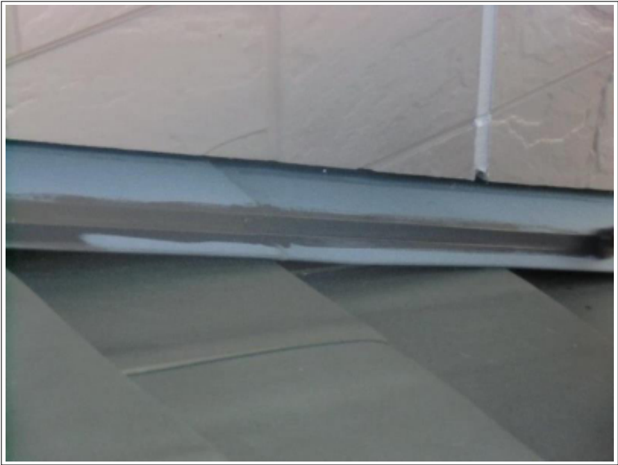
棟鉄板塗装施工中
