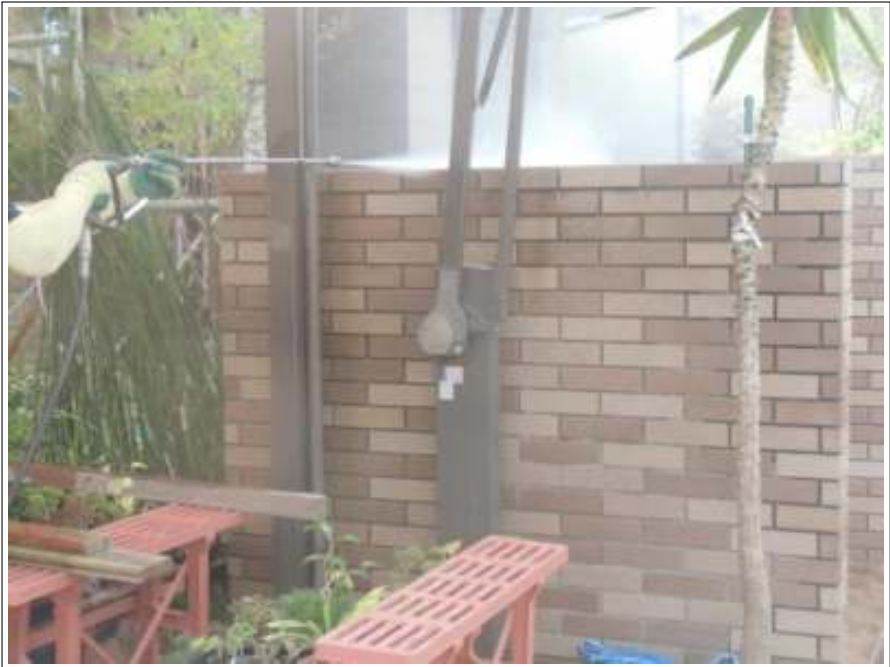
塀高圧洗浄施工中
