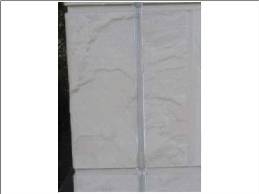
外壁シーリング補修施工前
