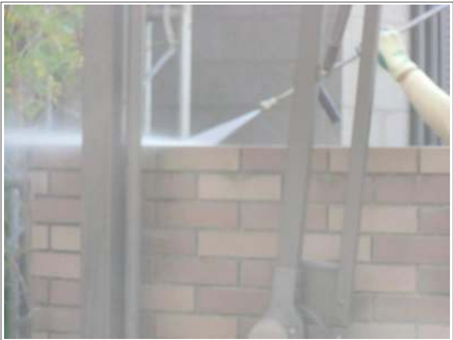
塀高圧洗浄施工中
