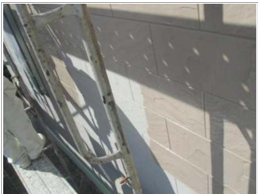
外壁塗装下塗り施工中
