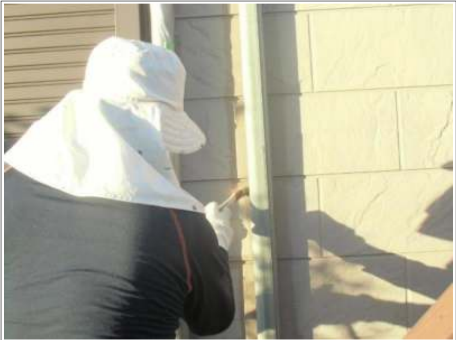
外壁塗装下塗り施工中
