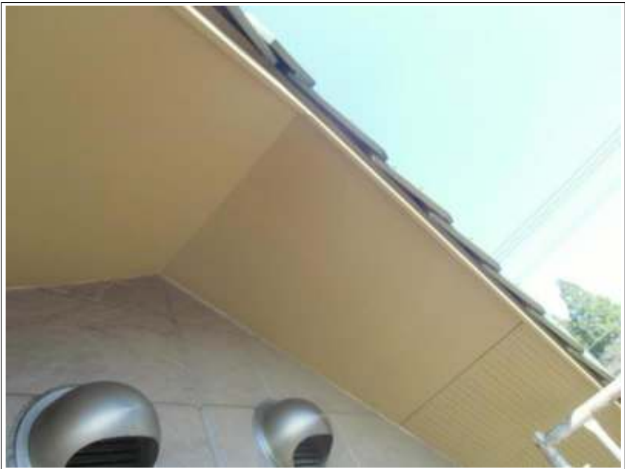
軒天塗装施工完了
