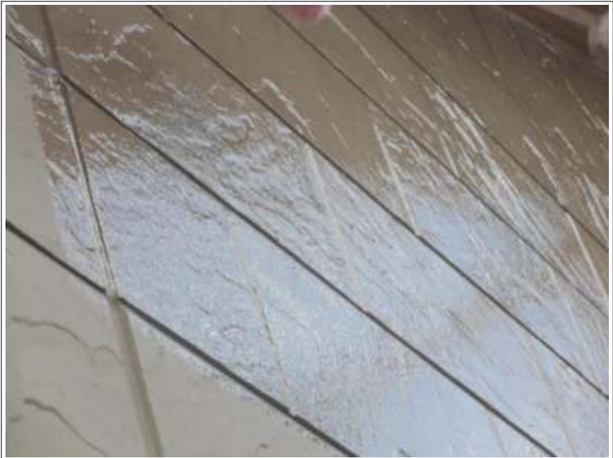
外壁塗装下塗り施工中
