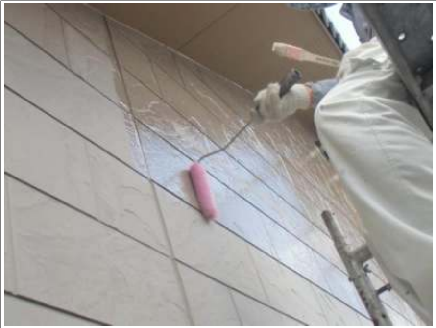
外壁塗装下塗り施工中
