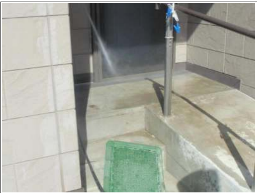
土間高圧洗浄施工中
