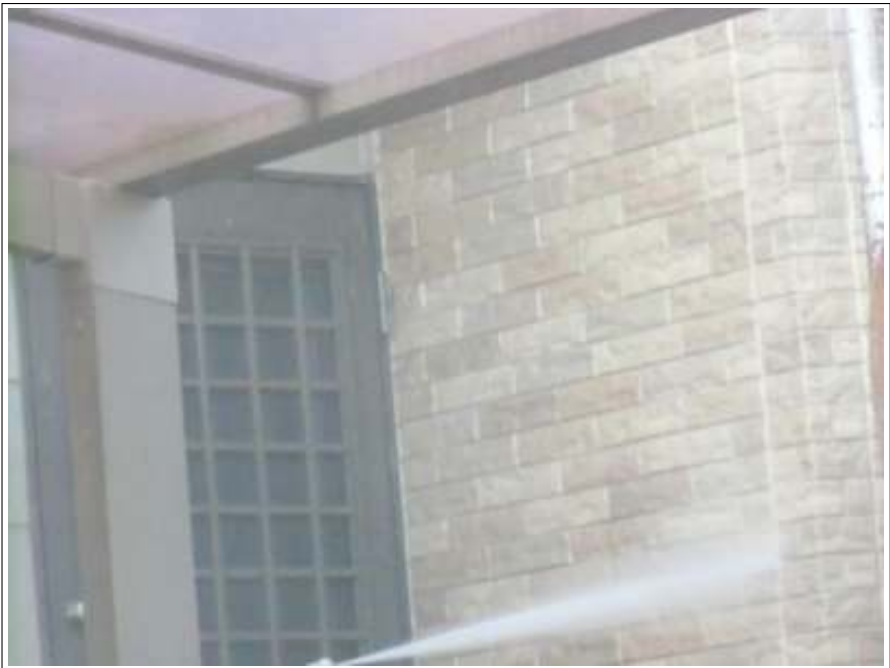
外壁高圧洗浄施工中
