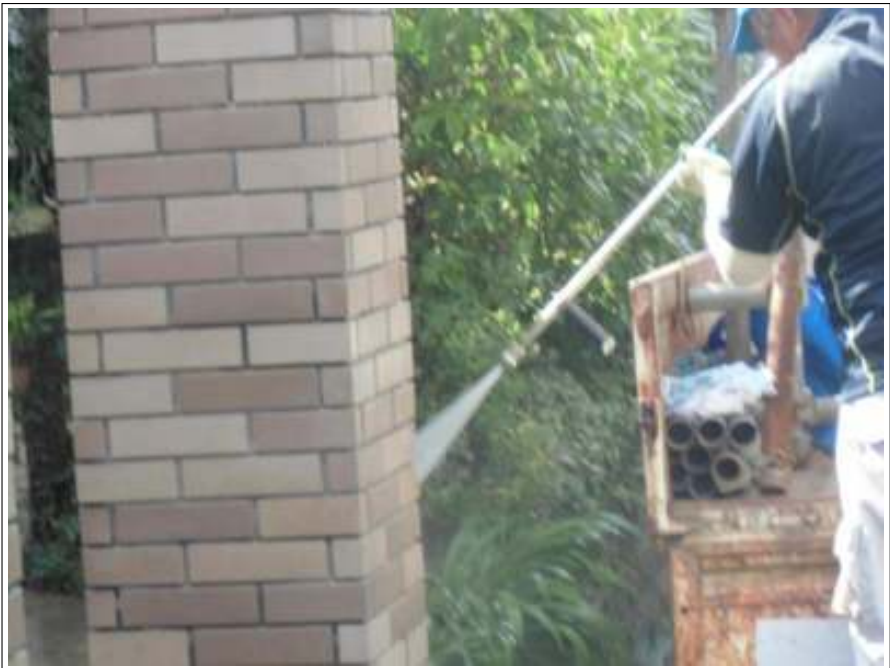
塀高圧洗浄施工中
