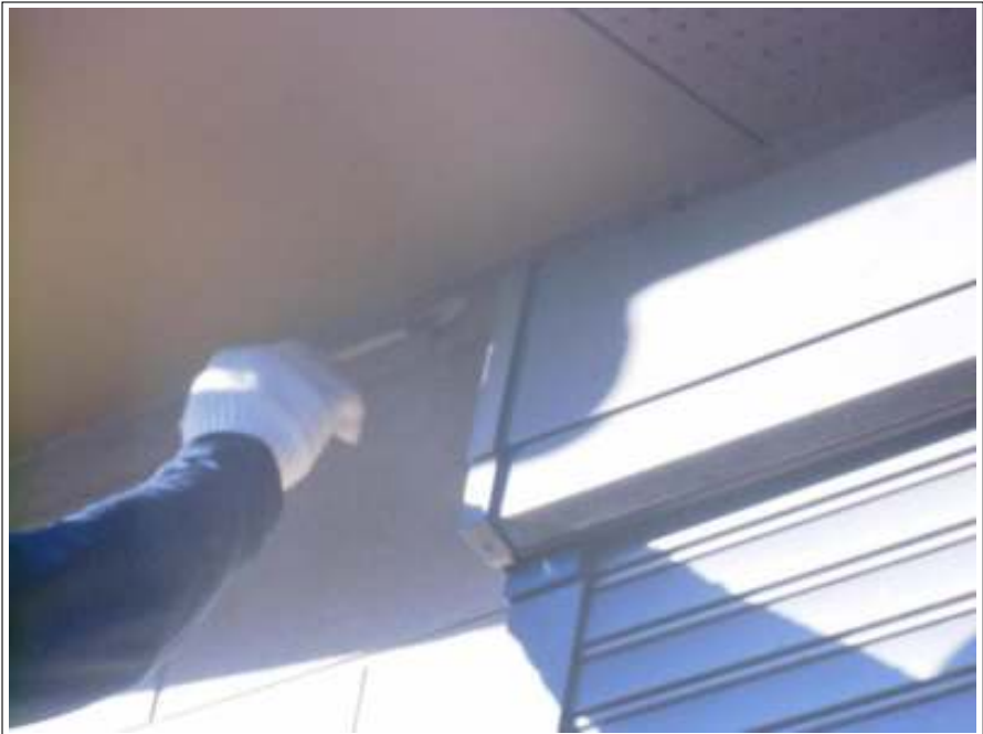
外壁塗装下塗り施工中
