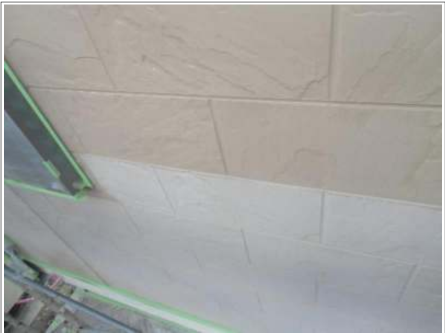
外壁塗装下塗り施工中
