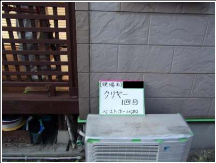
外壁塗装下塗り施工完了
