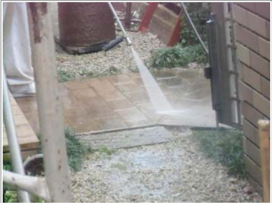
土間高圧洗浄施工中
