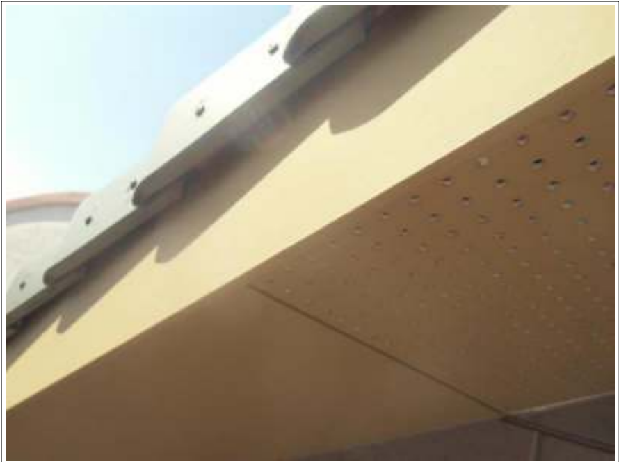
破風板塗装施工完了
