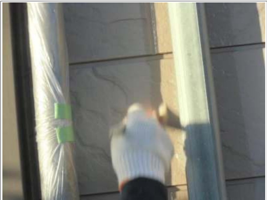
外壁塗装下塗り施工中
