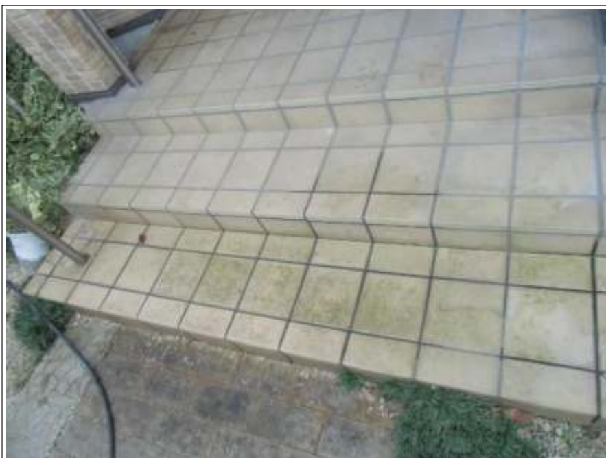
玄関土間高圧洗浄施工中
