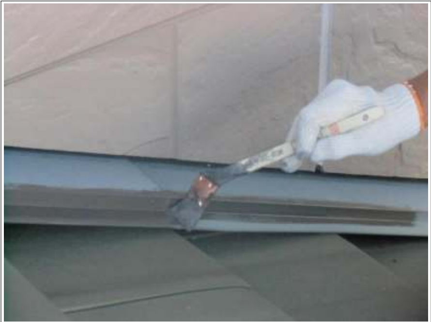
棟鉄板塗装施工中
