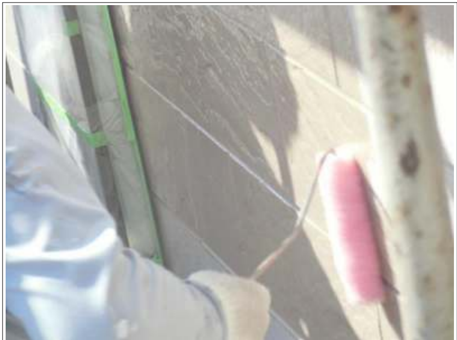
外壁塗装下塗り施工中
