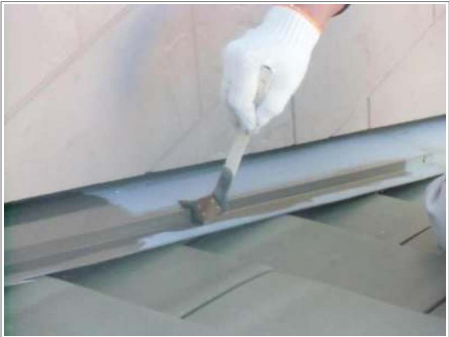
棟鉄板塗装施工中
