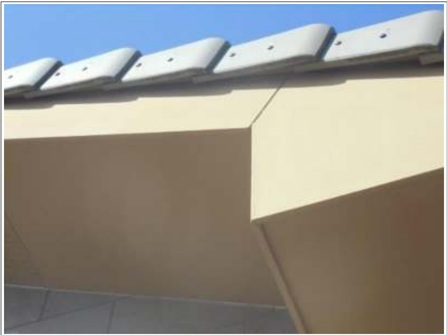
破風板塗装施工完了
