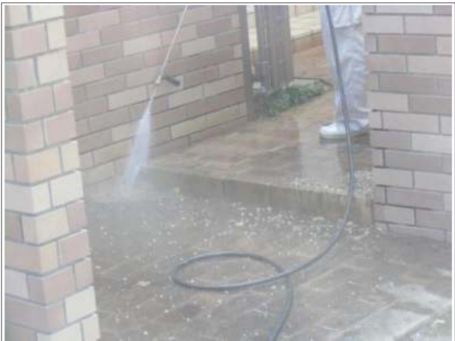
土間高圧洗浄施工中
