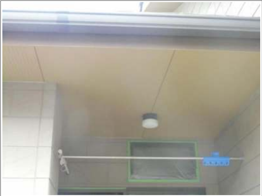
軒天塗装施工完了
