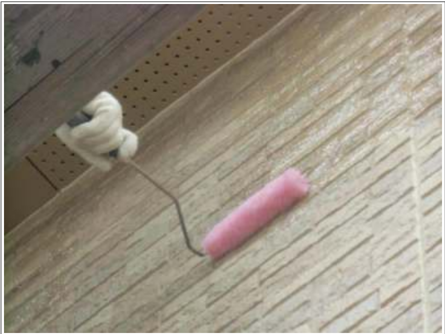
外壁塗装上塗り施工中
