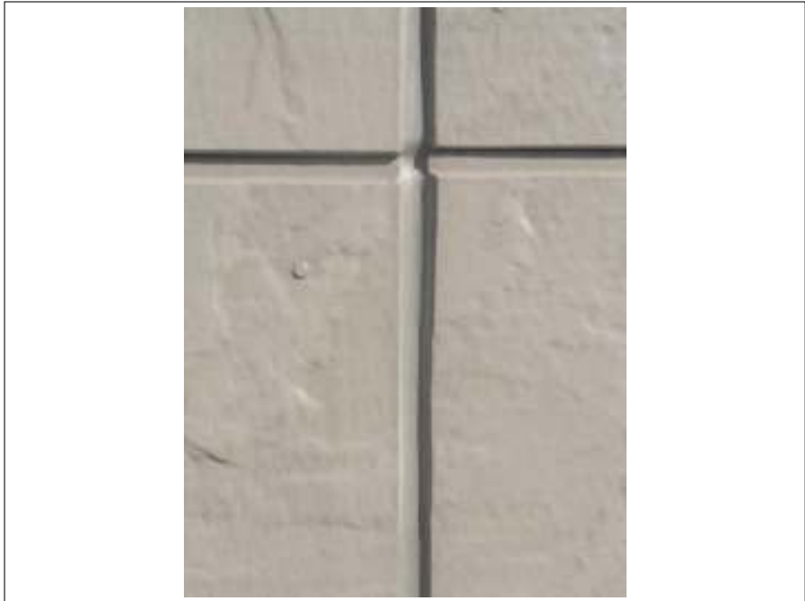
外壁シーリング補修施工中
