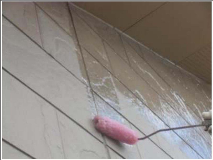
外壁塗装下塗り施工中
