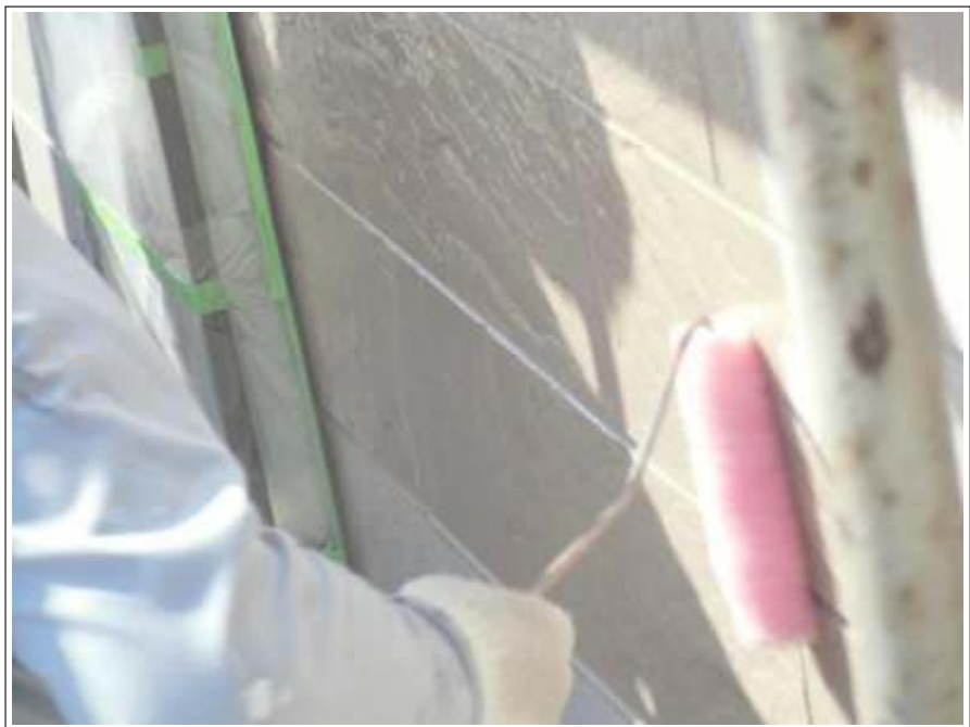
外壁塗装下塗り施工中
