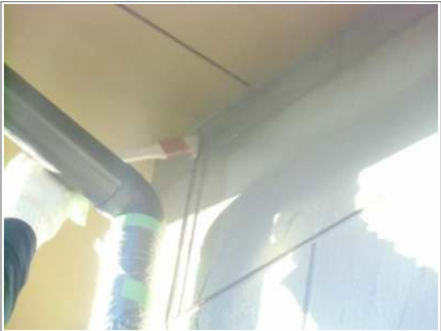
外壁塗装下塗り施工中
