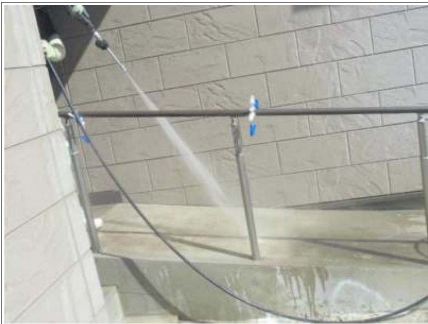
土間高圧洗浄施工中
