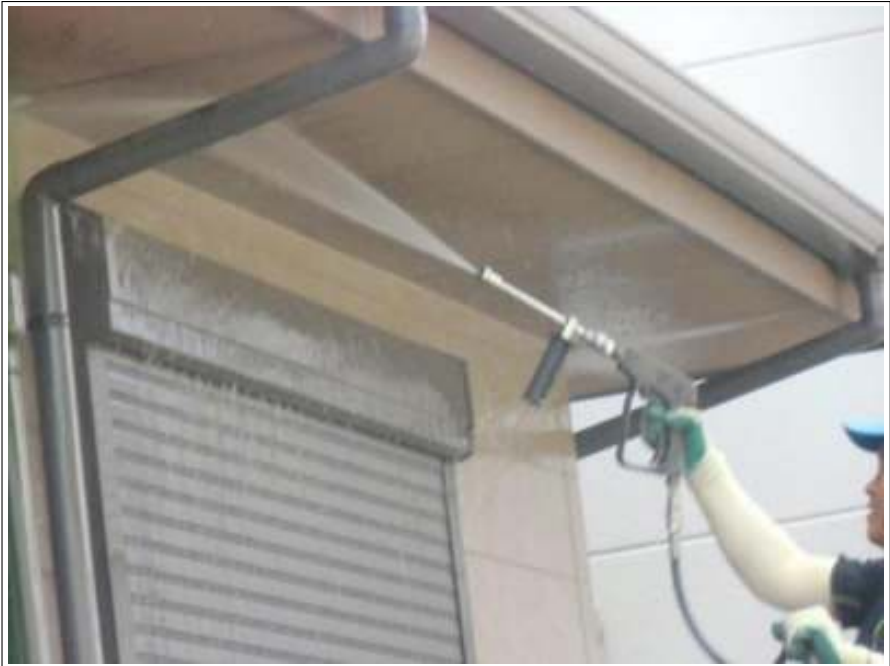
軒天高压洗浄施工中
