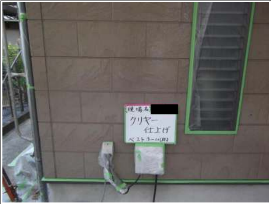
外壁塗装施工完了
