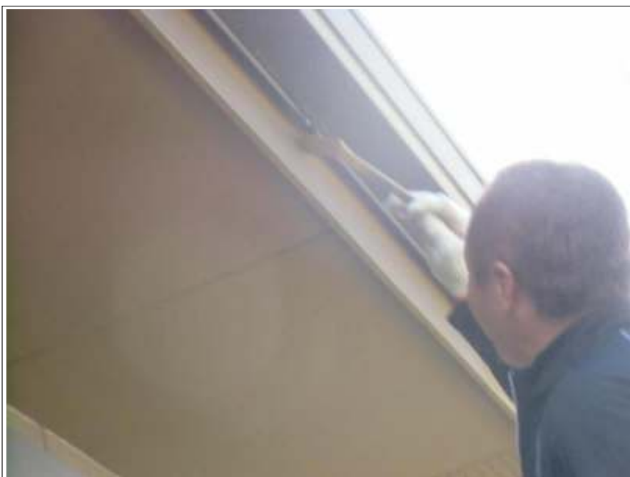
破風板塗装施工中
