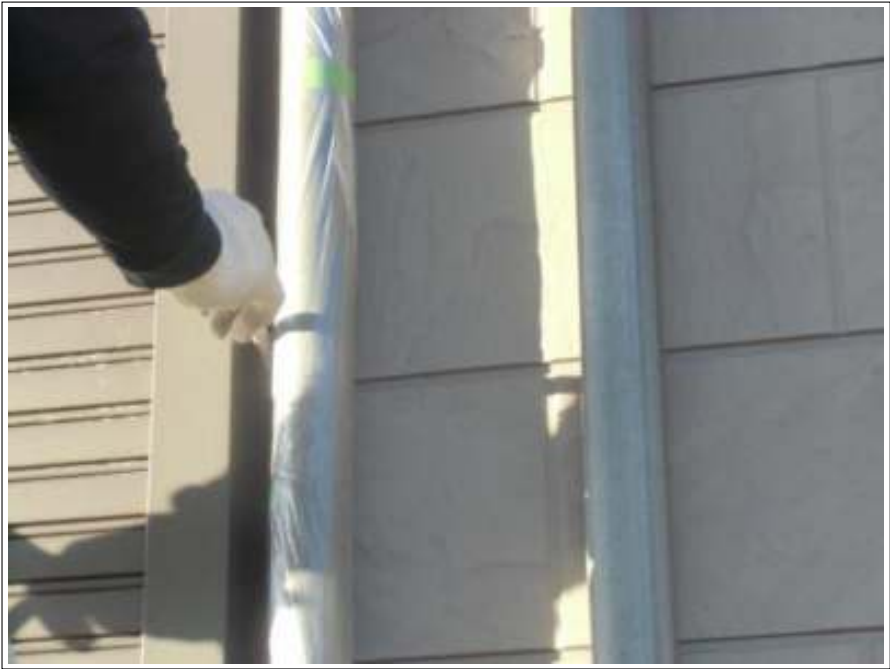
外壁塗装下塗り施工中
