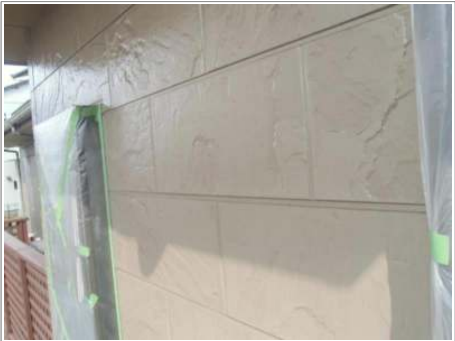
外壁塗装施工完了
