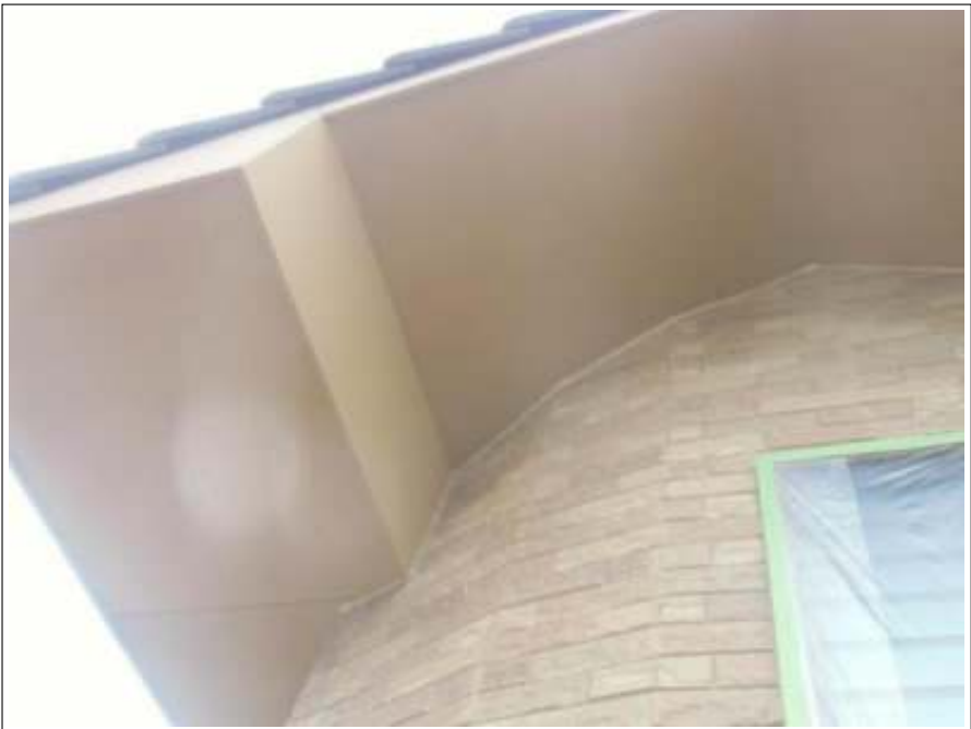
軒天塗装施工完了
