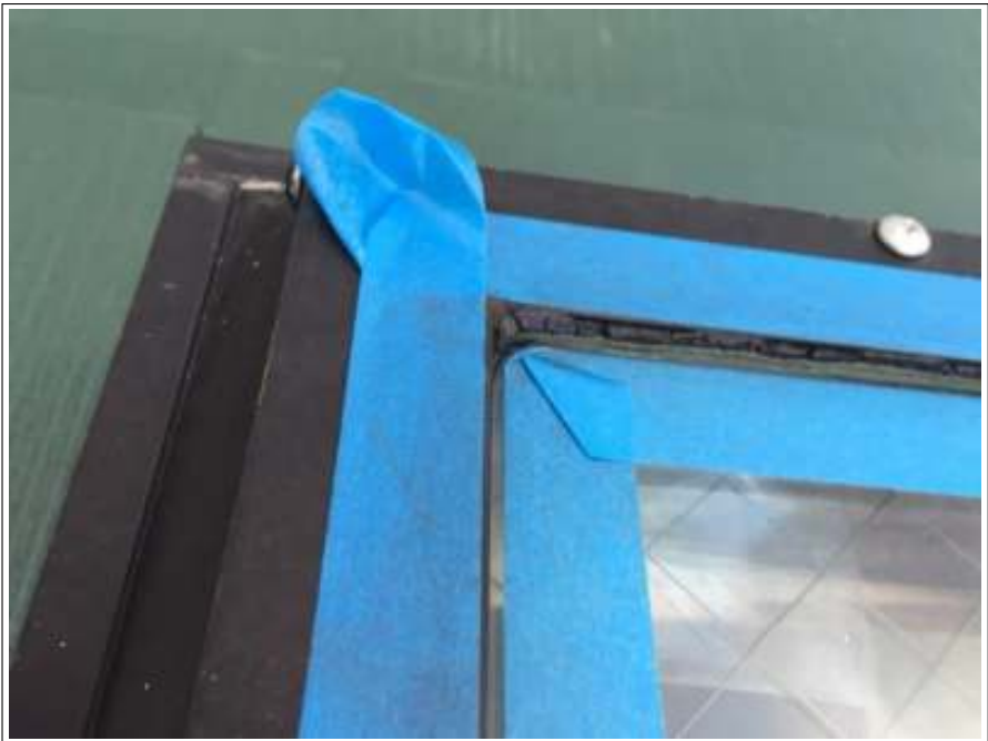
天窓シーリング補修施工中
