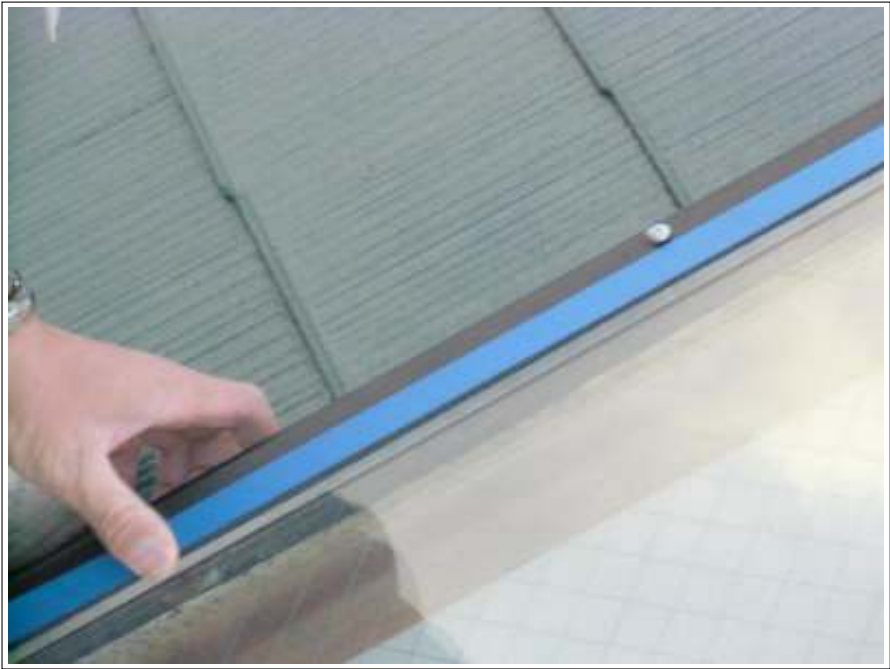
天窓シーリング補修施工中
