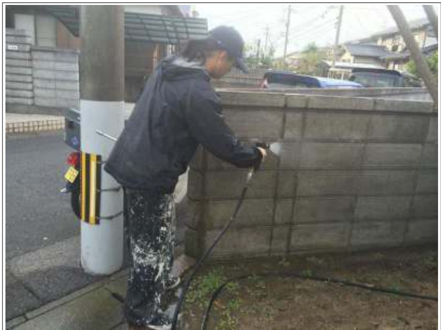
塀高圧洗浄施工中
