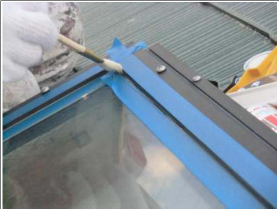
天窓シーリング補修施工中
