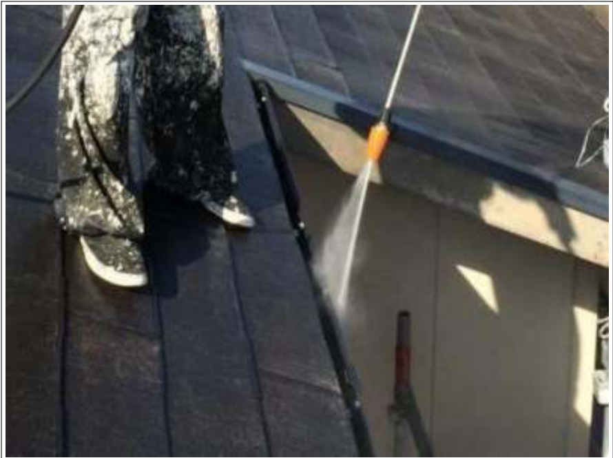
樋高圧洗浄施工中
