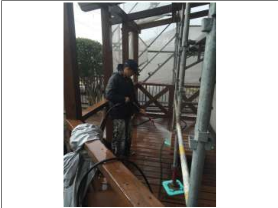
ウッドデッキ高圧洗浄施工中
