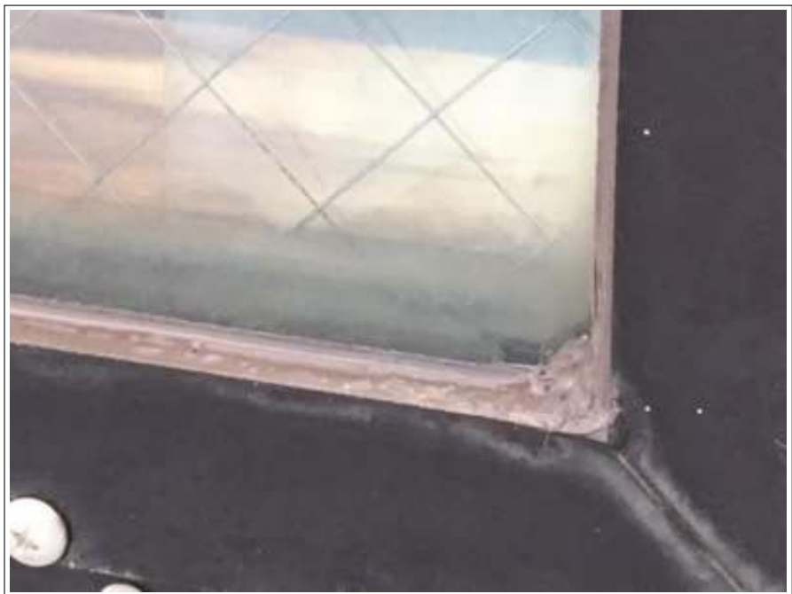
天窓シーリング補修施工完了
