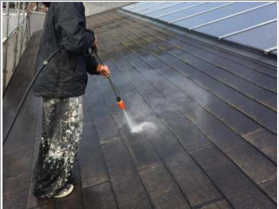
屋根高圧洗浄施工中
