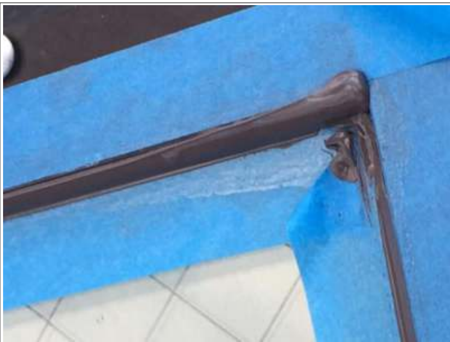
天窓シーリング補修施工中
