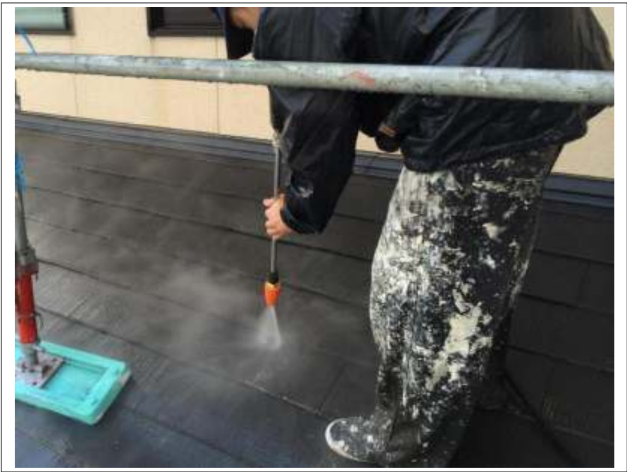
下屋根高圧洗浄施工中
