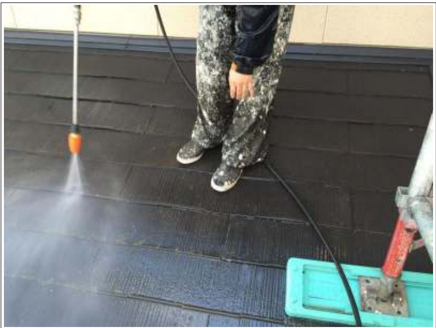
下屋根高圧洗浄施工中
