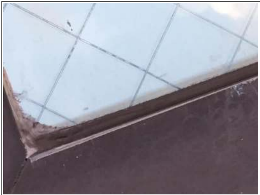
天窓シーリング補修施工完了
