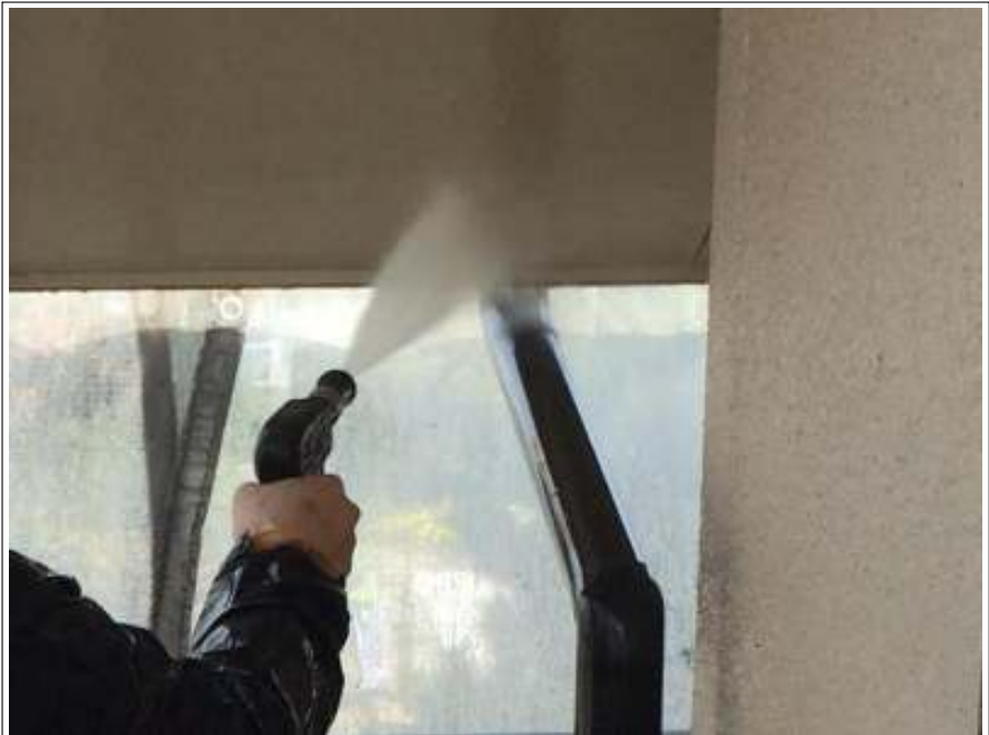
軒天高圧洗浄施工中
