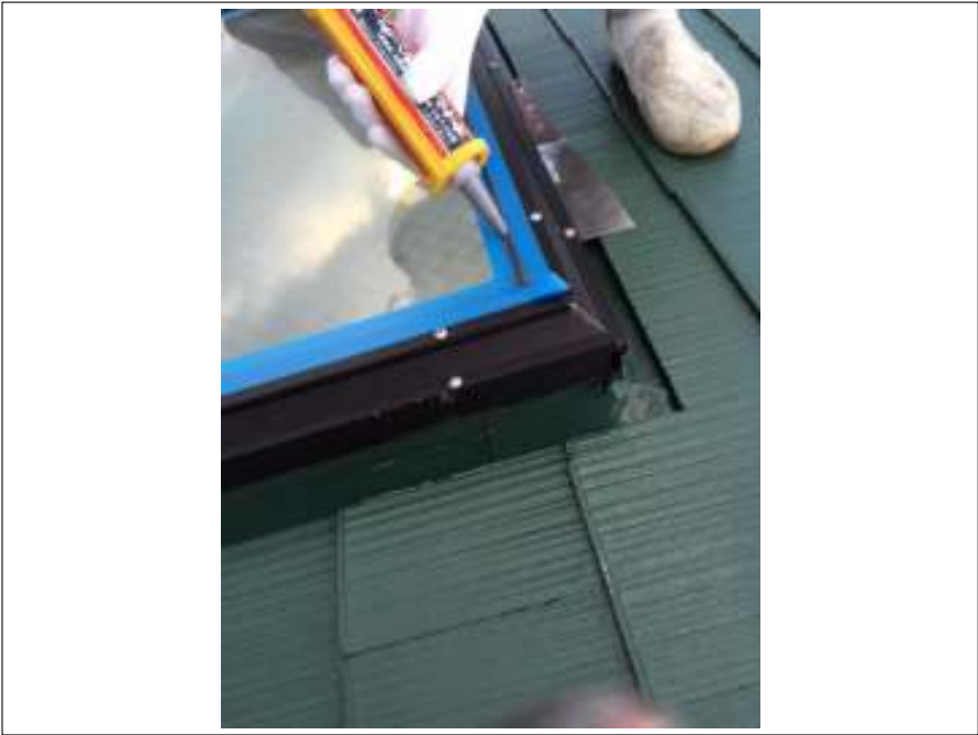
天窓シーリング補修施工中
