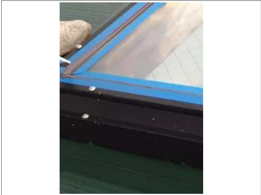
天窓シーリング補修施工中
