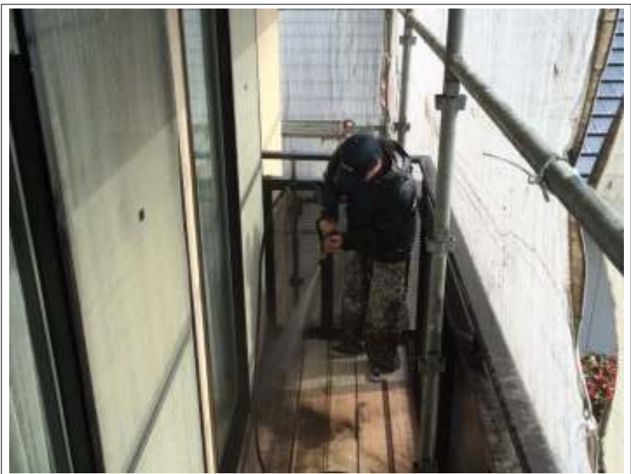
ベランダ高圧洗浄施工中
