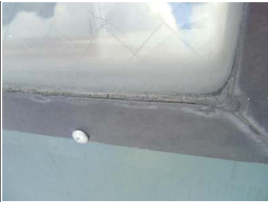
天窓シーリング補修施工前
