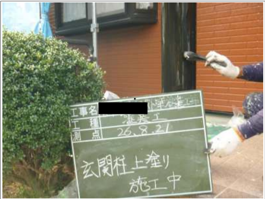
玄関柱塗装施工中
