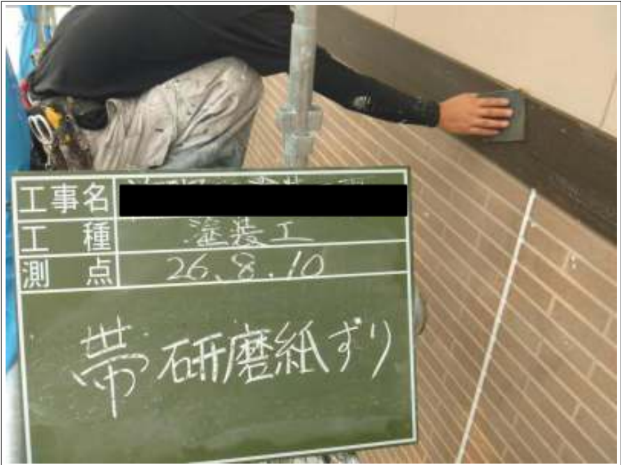
胴差し研磨施工中
