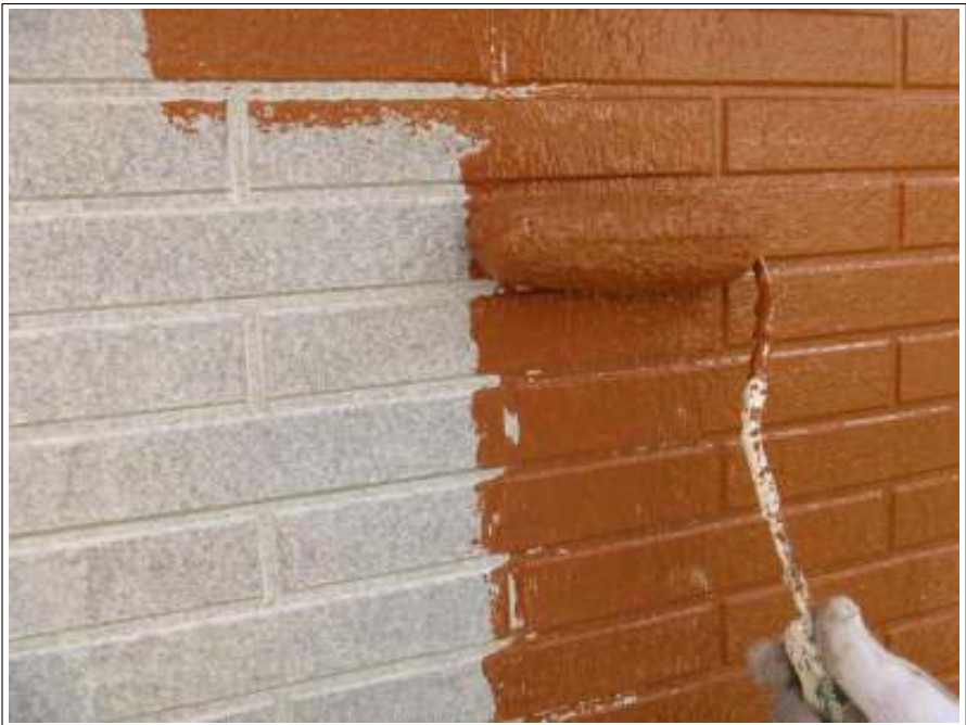
外壁塗装中塗り施工中
