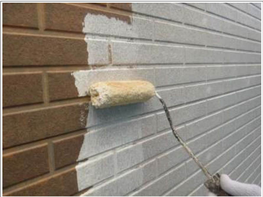
外壁塗装下塗り施工中
