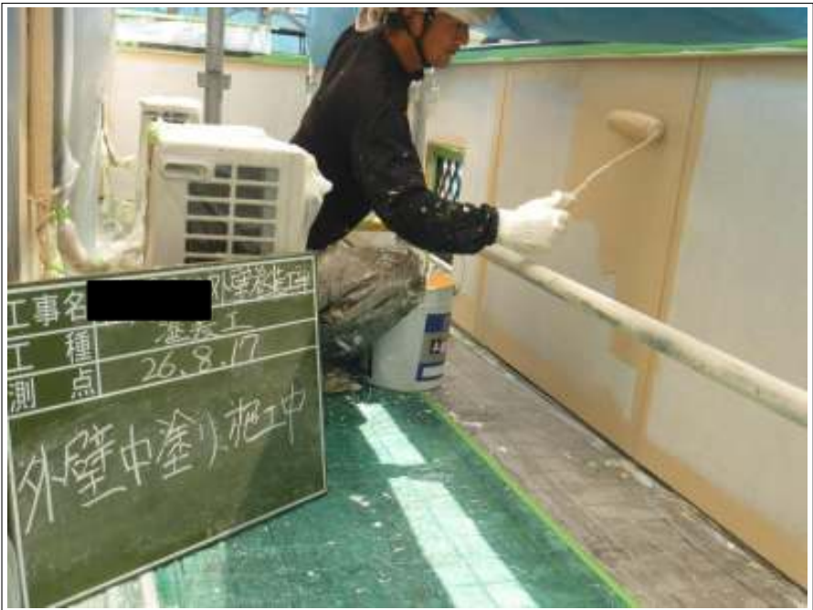
外壁塗装中塗り施工中
