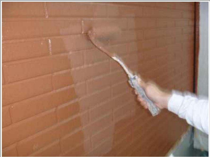
外壁塗装上塗り施工中
