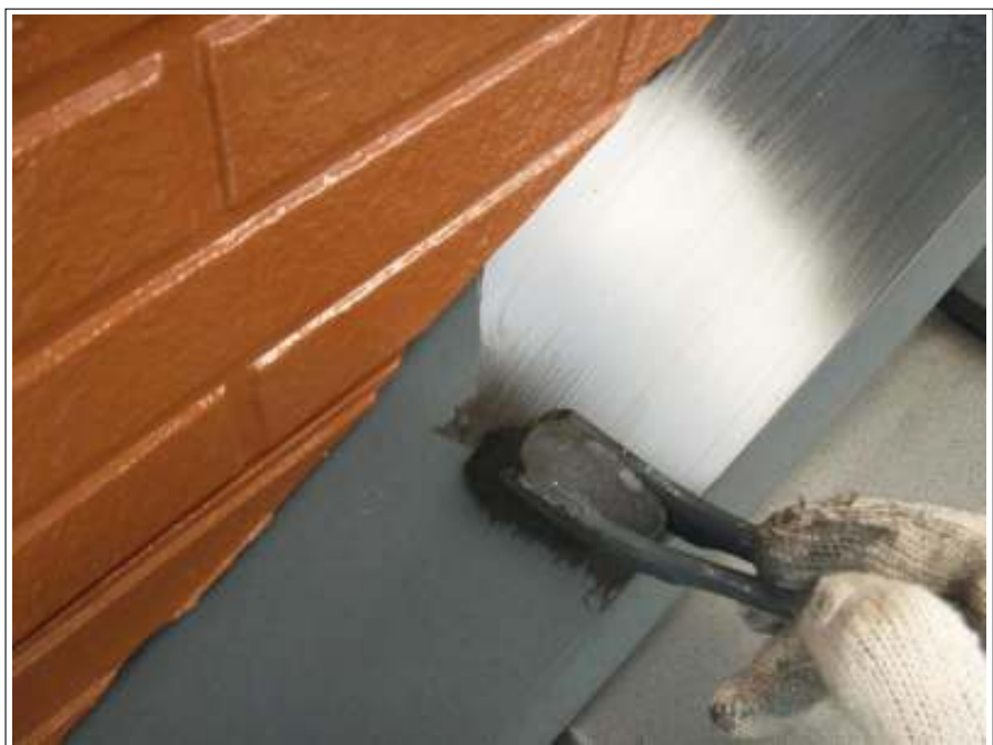
土台水切り塗装上塗り施工中
