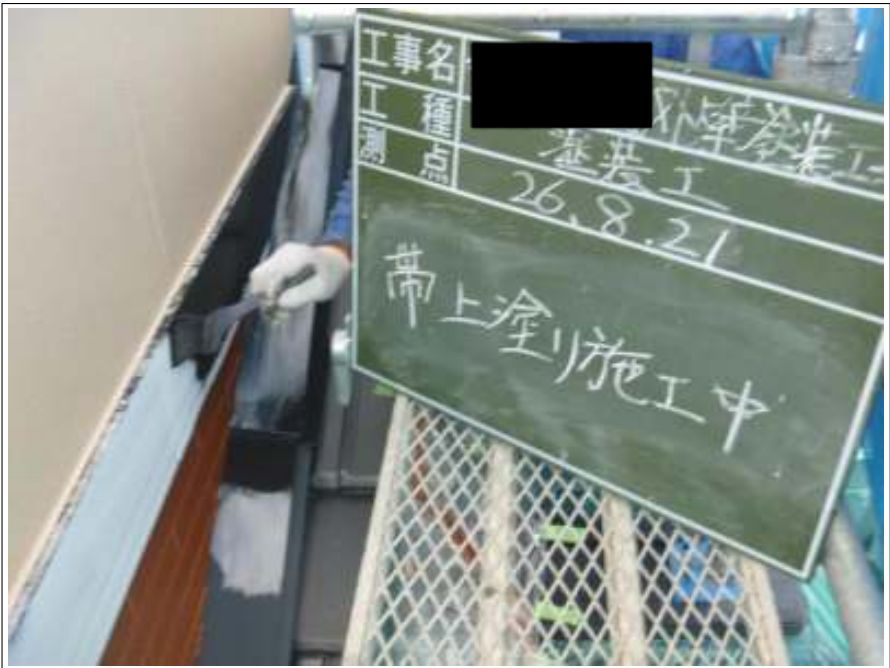
胴差し塗装上塗り施工中
