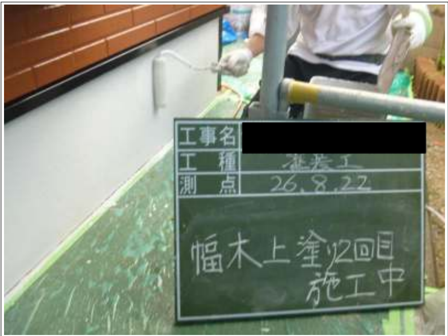
基礎塗装 2 回目施工中
