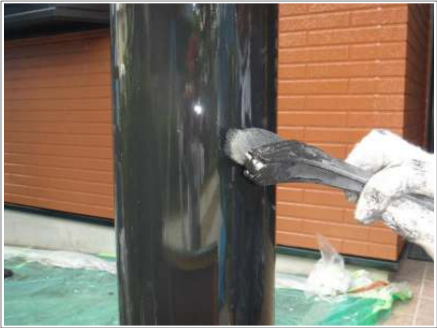
玄関柱塗装施工中
