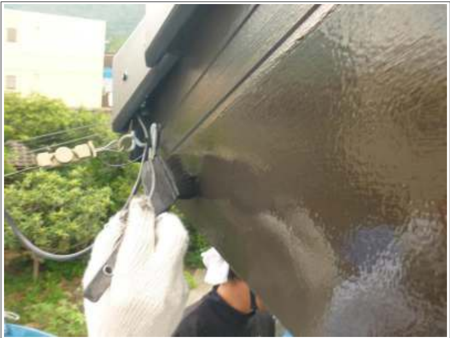
破風板塗装上塗り施工中
