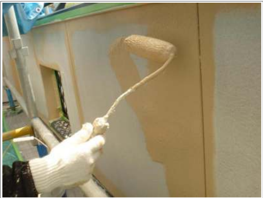
外壁塗装中塗り施工中
