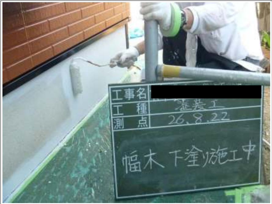
基礎塗装 1 回目施工中
