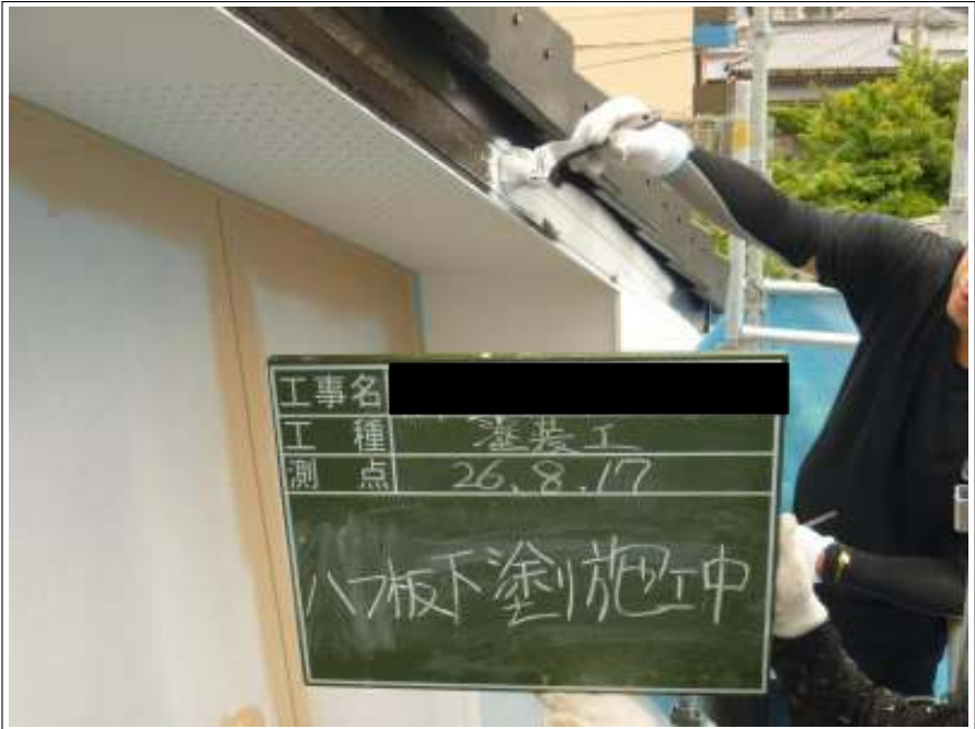
破風板塗装下塗り施工中
