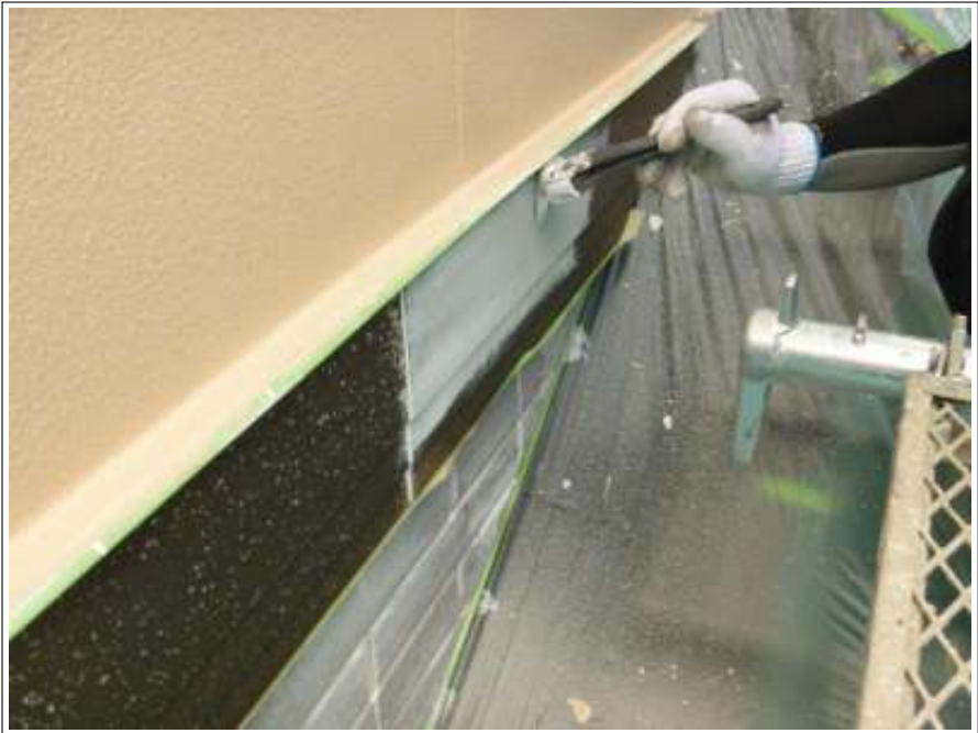
胴差し塗装下塗り施工中
