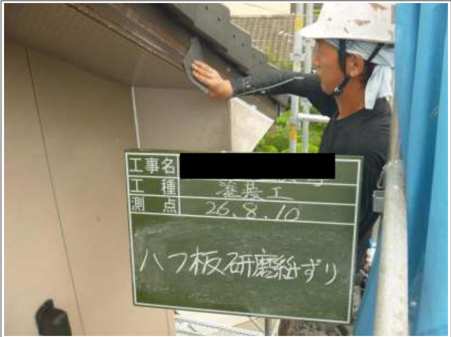
破風板研磨施工中
