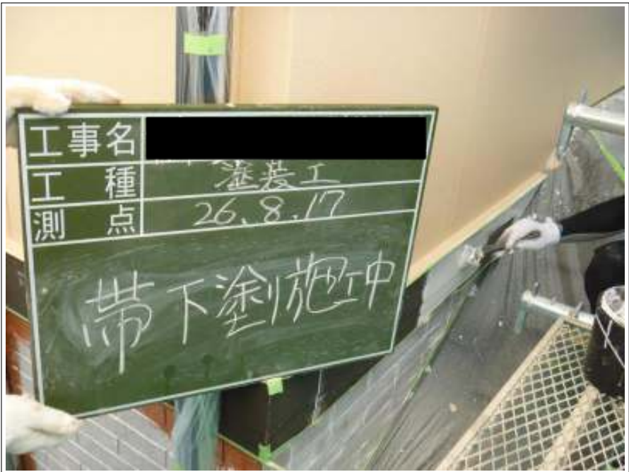
胴差し塗装下塗り施工中
