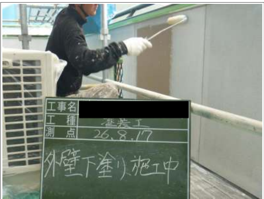
外壁塗装下塗り施工中
