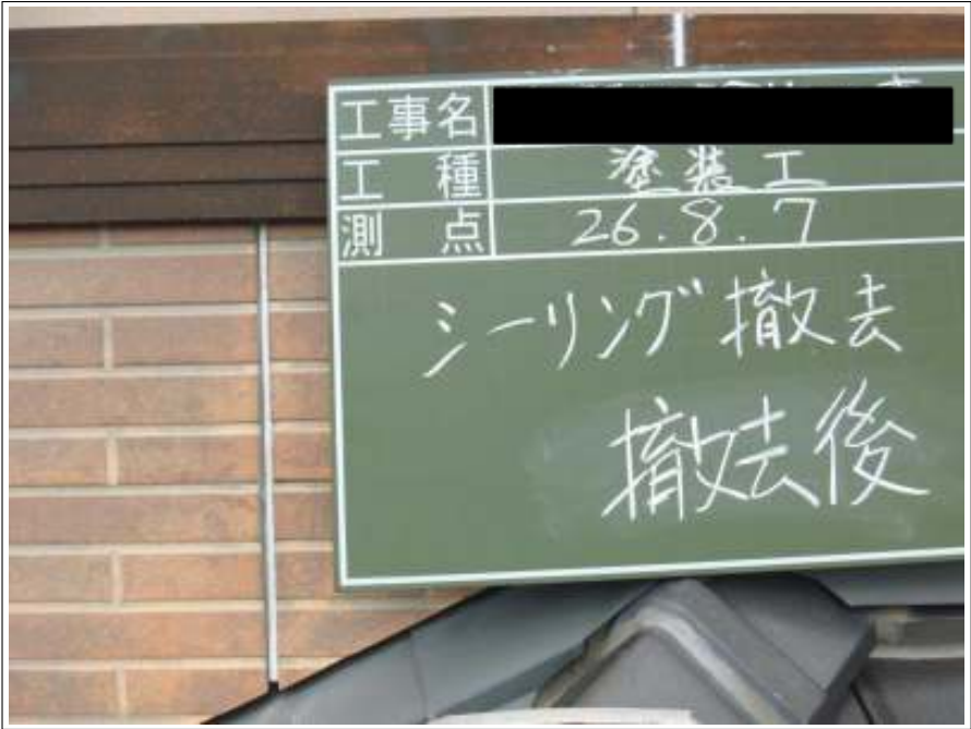
外壁シーリング撤去施工完了
