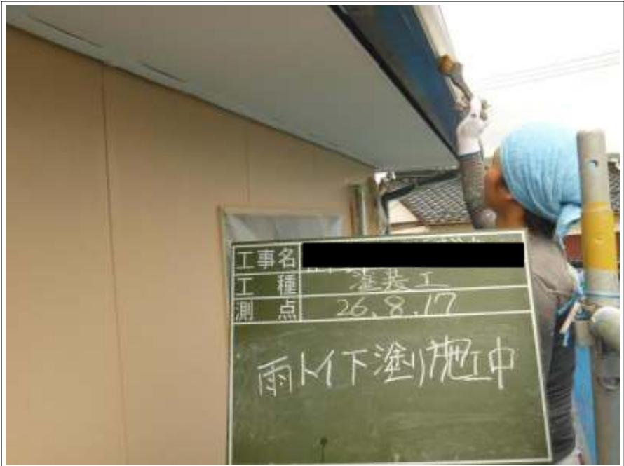
樋塗装下塗り施工中
