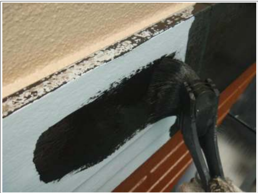
胴差し塗装上塗り施工中
