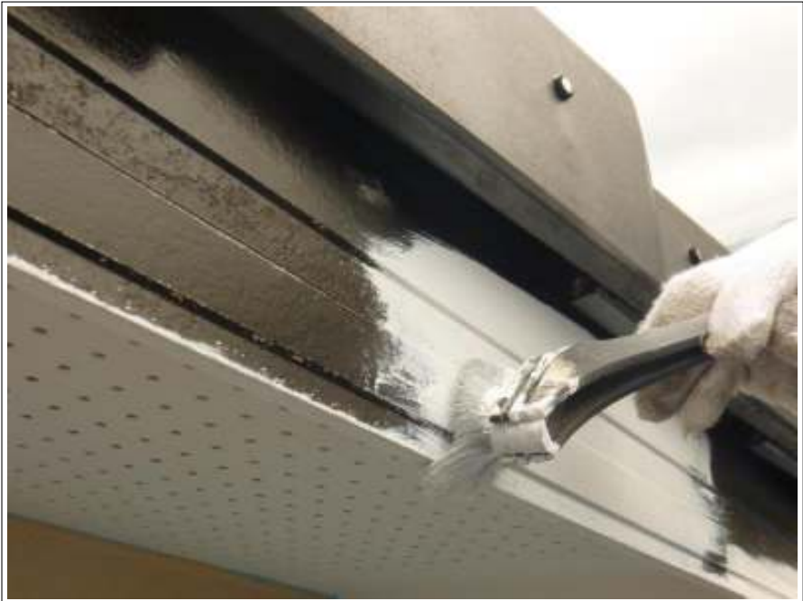
破風板塗装下塗り施工中
