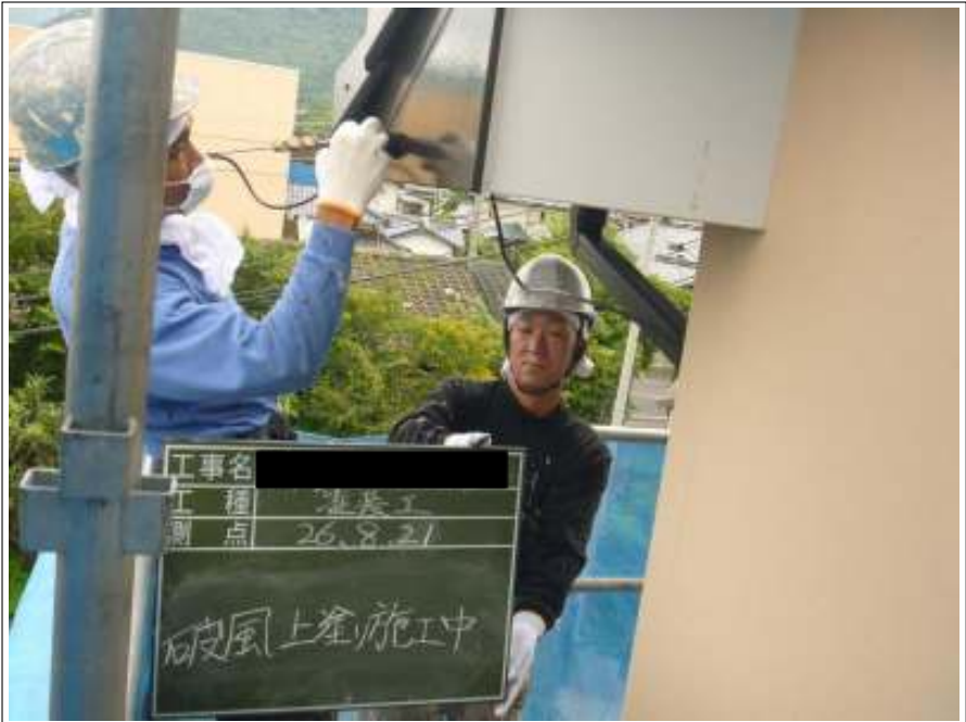
破風板塗装上塗り施工中
