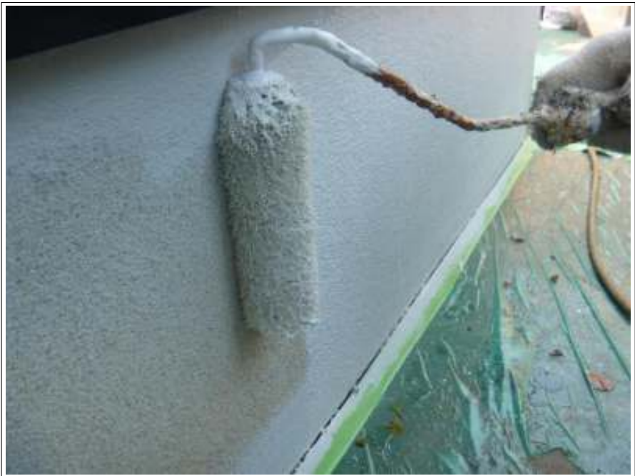
基礎塗装 1 回目施工中
