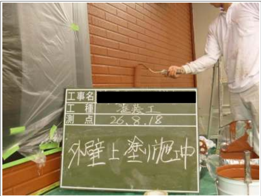
外壁塗装上塗り施工中
