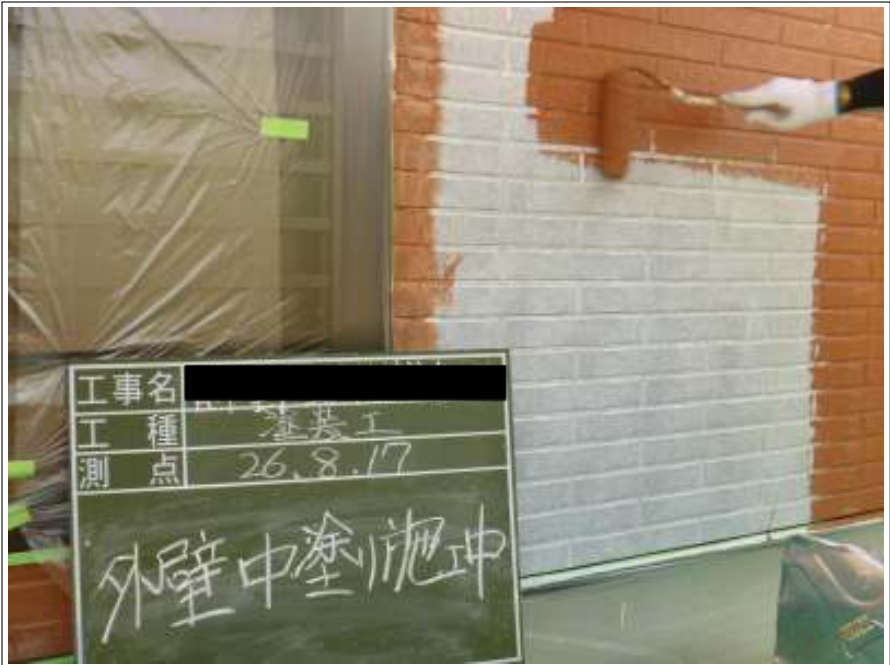
外壁塗装中塗り施工中
