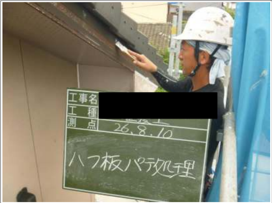
破風板パテ処理施工中
