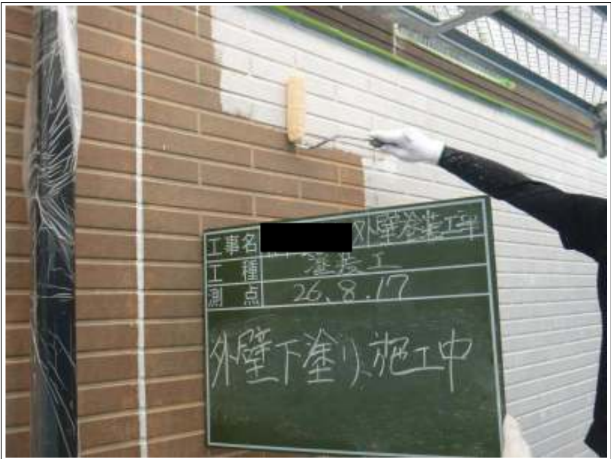
外壁塗装下塗り施工中
