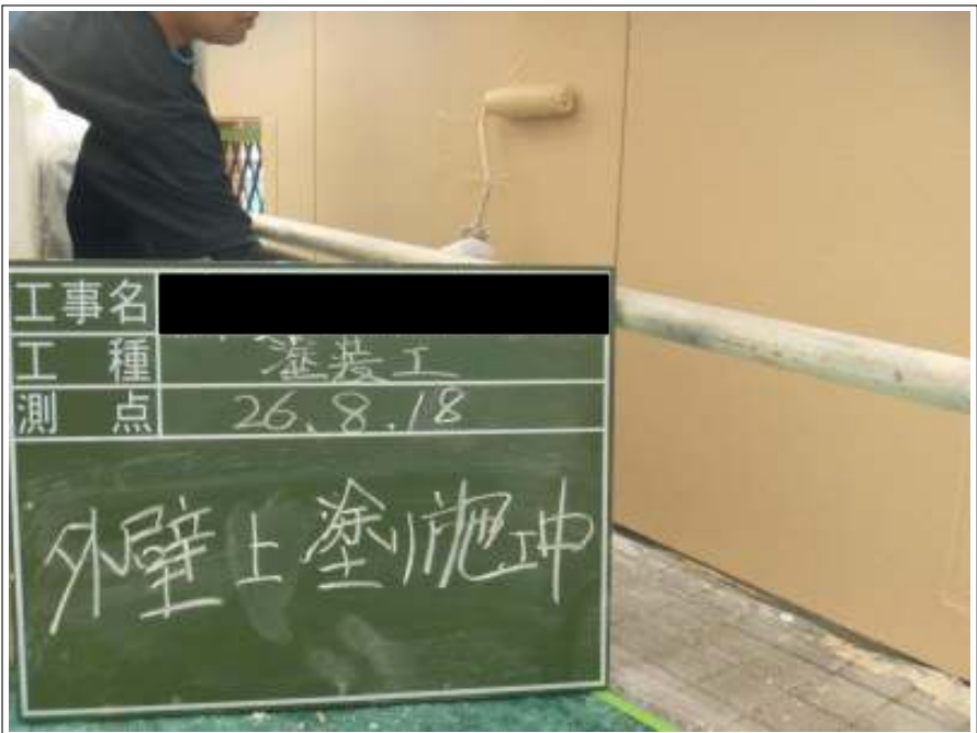
外壁塗装上塗り施工中
