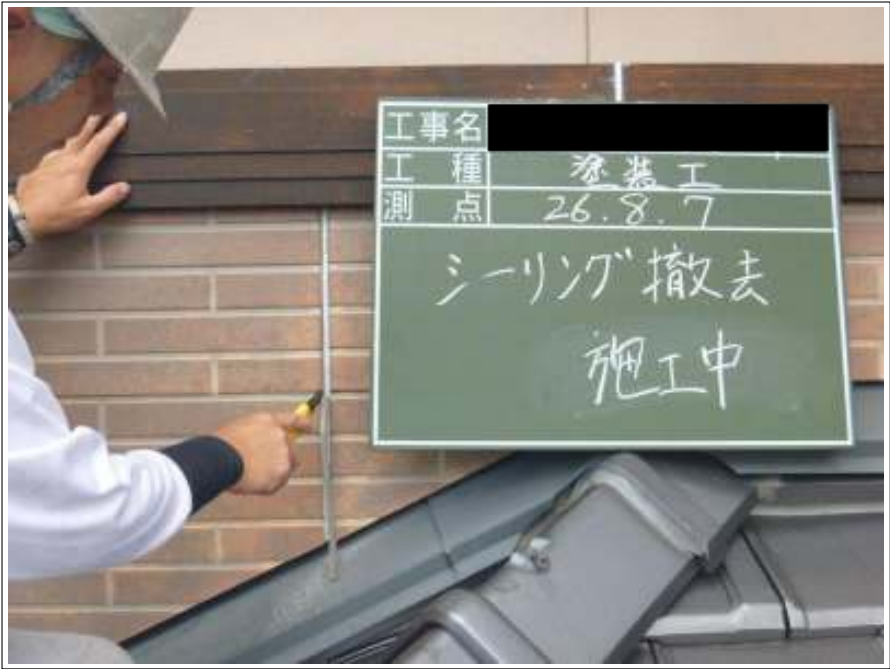
外壁シーリング撤去施工中
