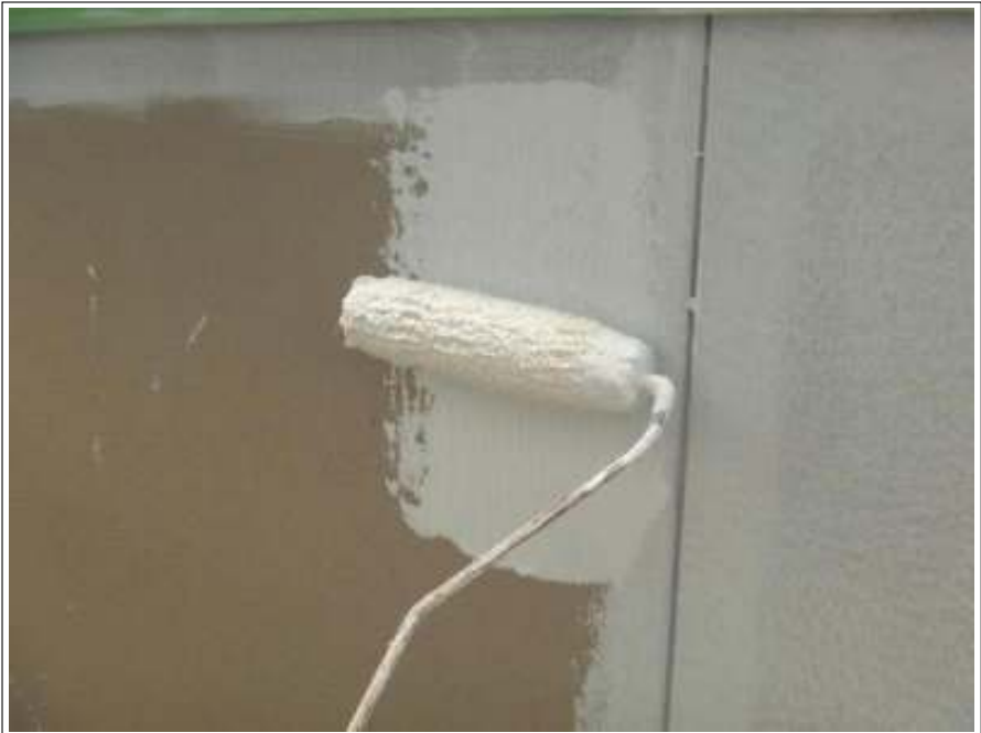
外壁塗装下塗り施工中
