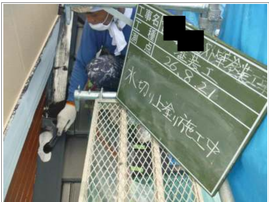
土台水切り塗装上塗り施工中
