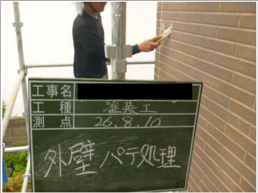
外壁パテ処理施工中
