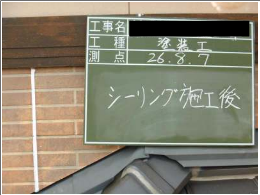
外壁シーリング補修施工完了
