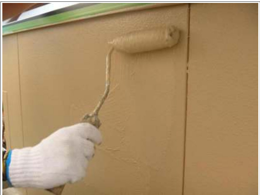
外壁塗装上塗り施工中
