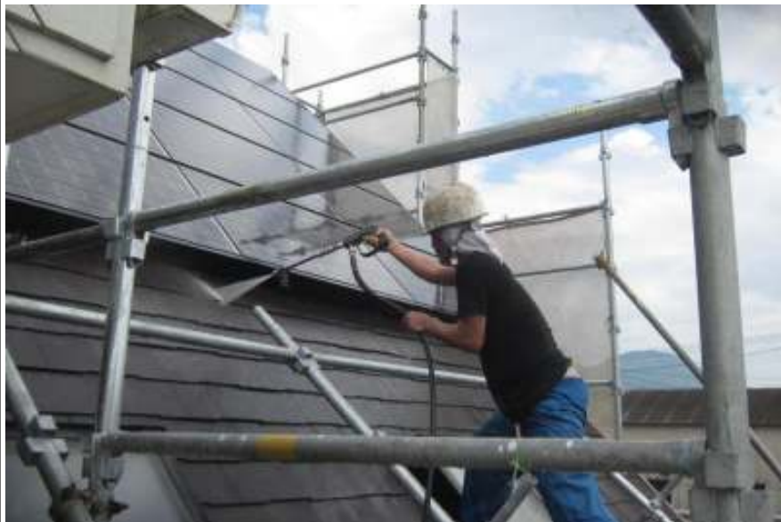
屋根高圧洗浄施工中
