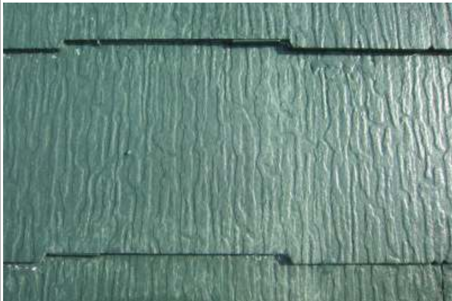
屋根塗装中塗り施工完了
