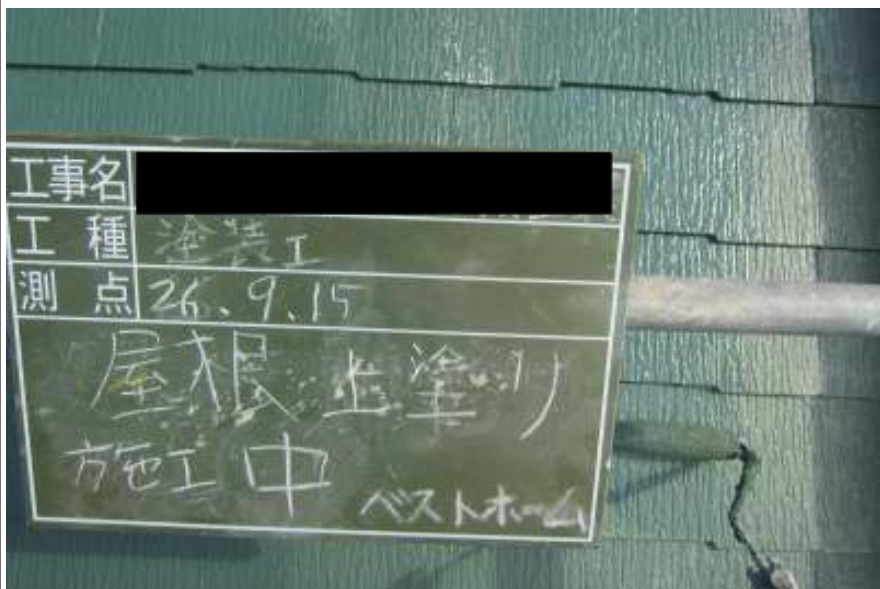
屋根塗装上塗り施工中
