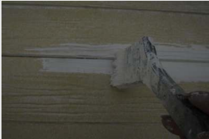
外壁塗装中塗り施工中
