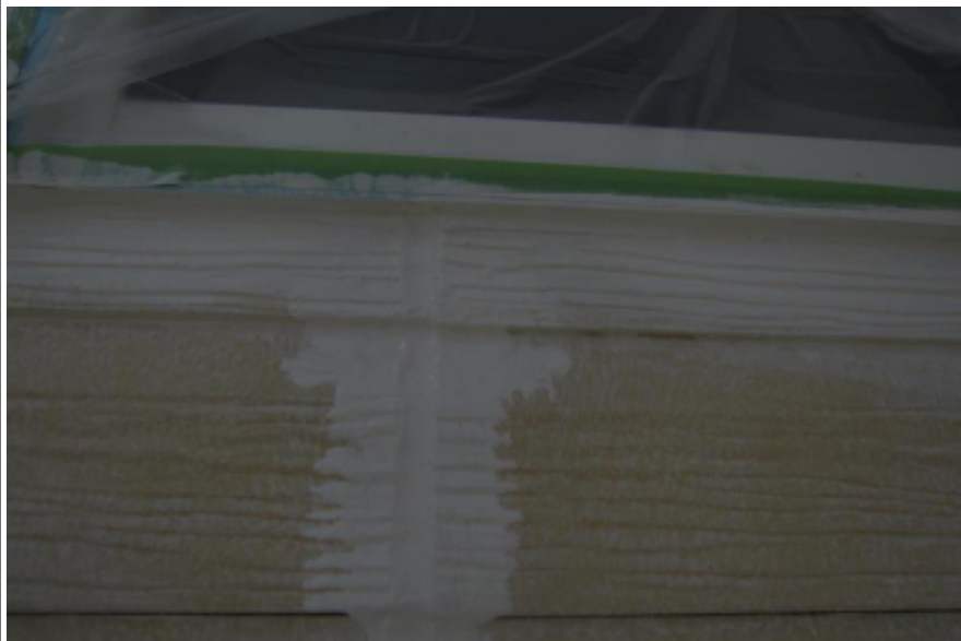
外壁塗装中塗り施工中
