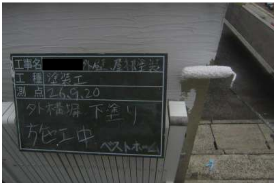
塀塗装下塗り施工中
