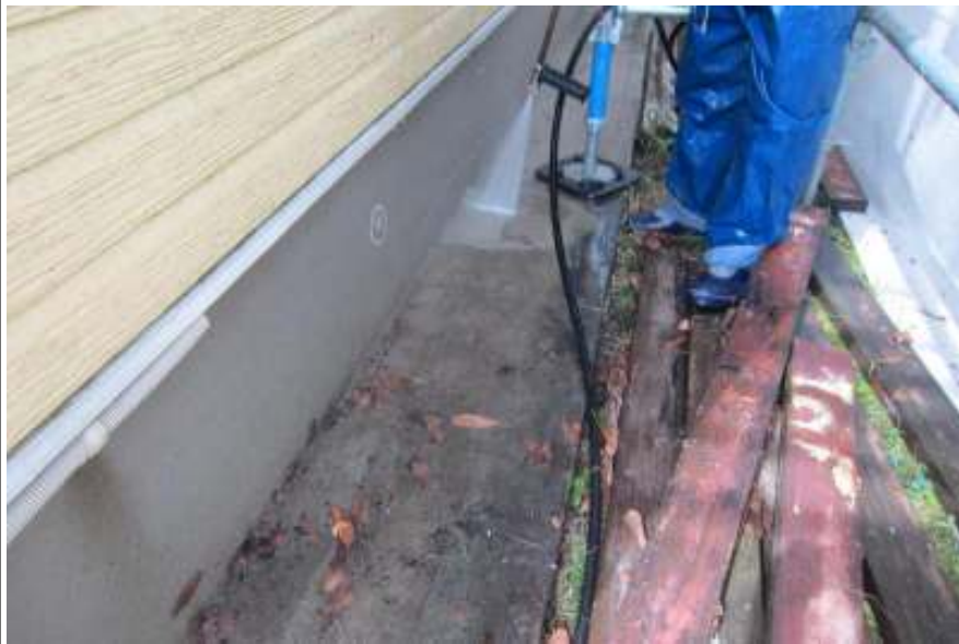
土間高圧洗浄施工中
