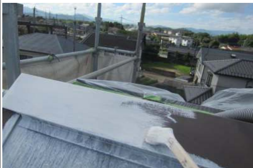
棟鉄板サビ止め施工中
