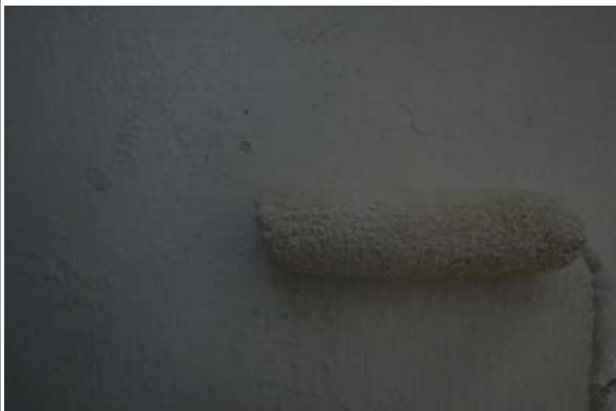
ベランダ塗装中塗り 2回目施工中
