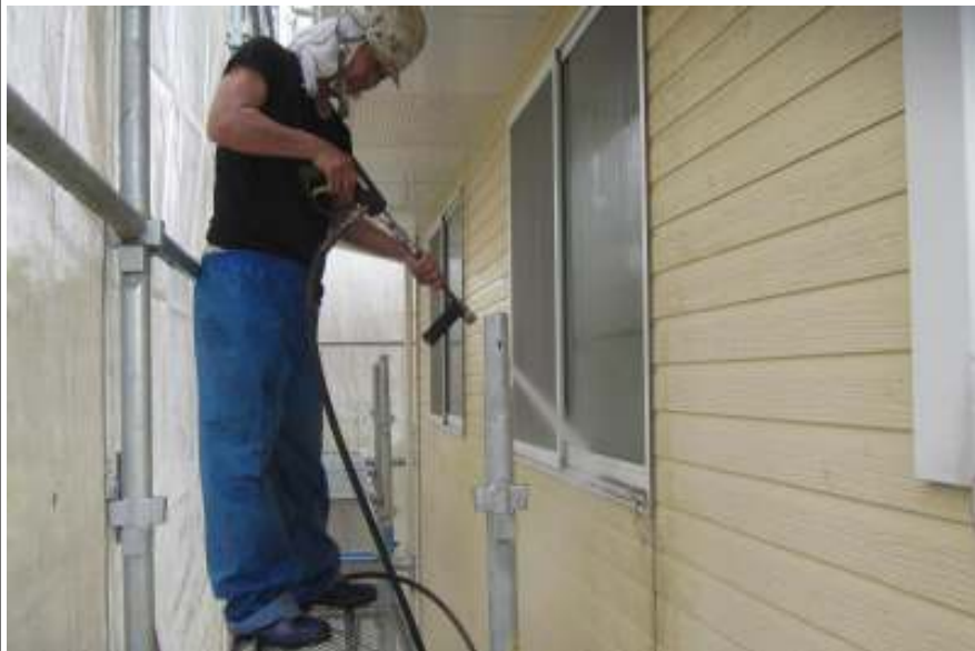
窓高圧洗浄施工中
