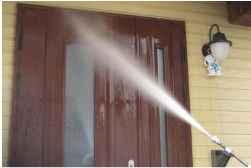
玄関高圧洗浄施工中
