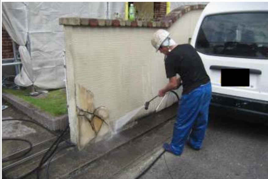
塀高圧洗浄施工中
