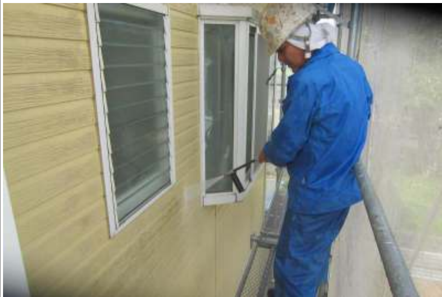
外壁高压洗净施工中
