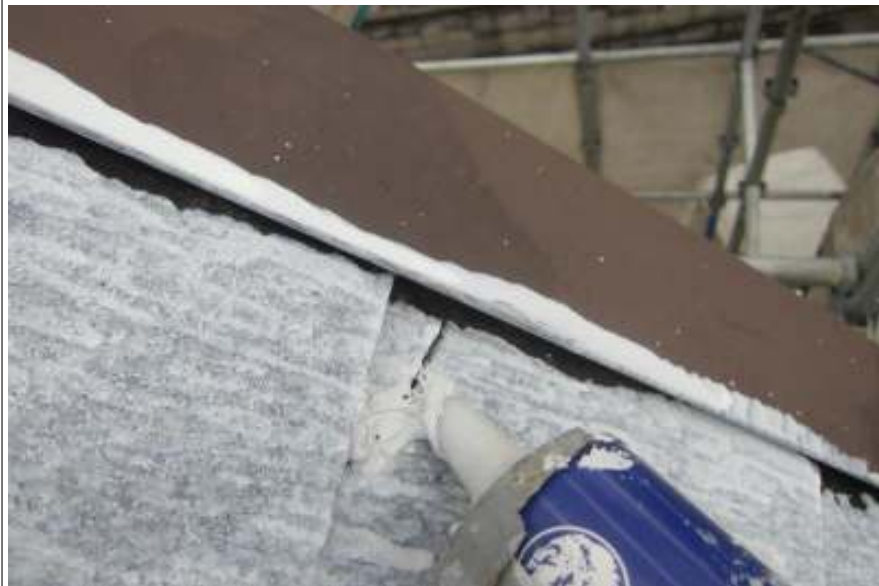
屋根クラック補修施工中
