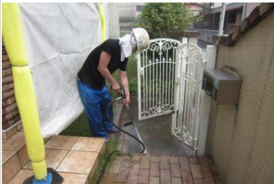
土間高圧洗浄施工中
