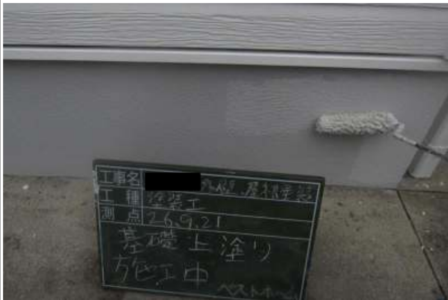
基礎塗装上塗り施工中
