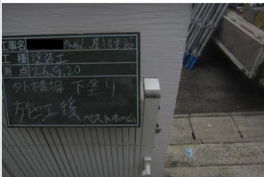
塀塗装下塗り施工完了
