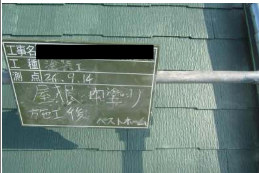
屋根塗装中塗り施工完了
