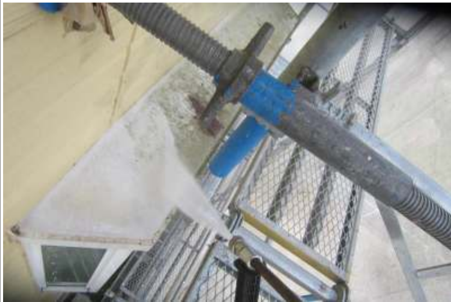
小庇高压洗净施工中
