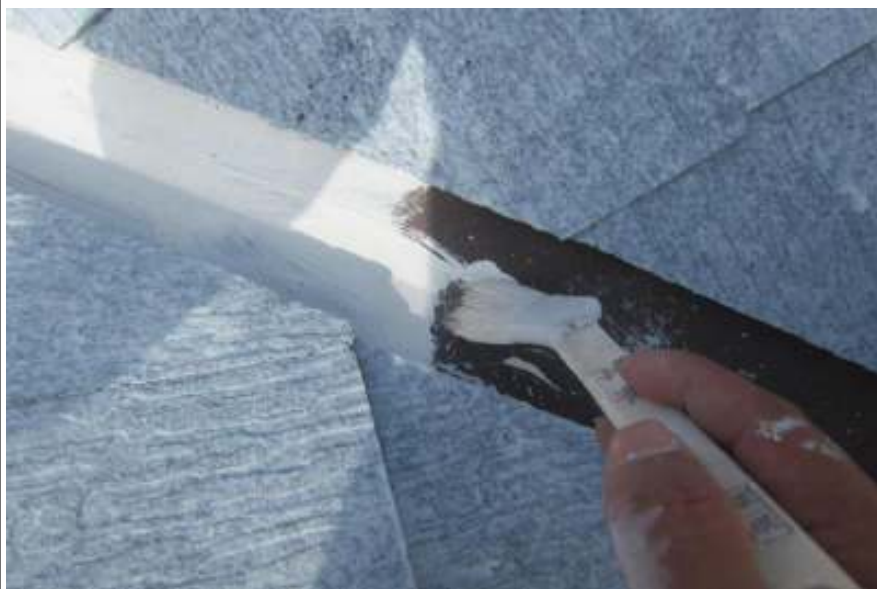
棟鉄板サビ止め施工中
