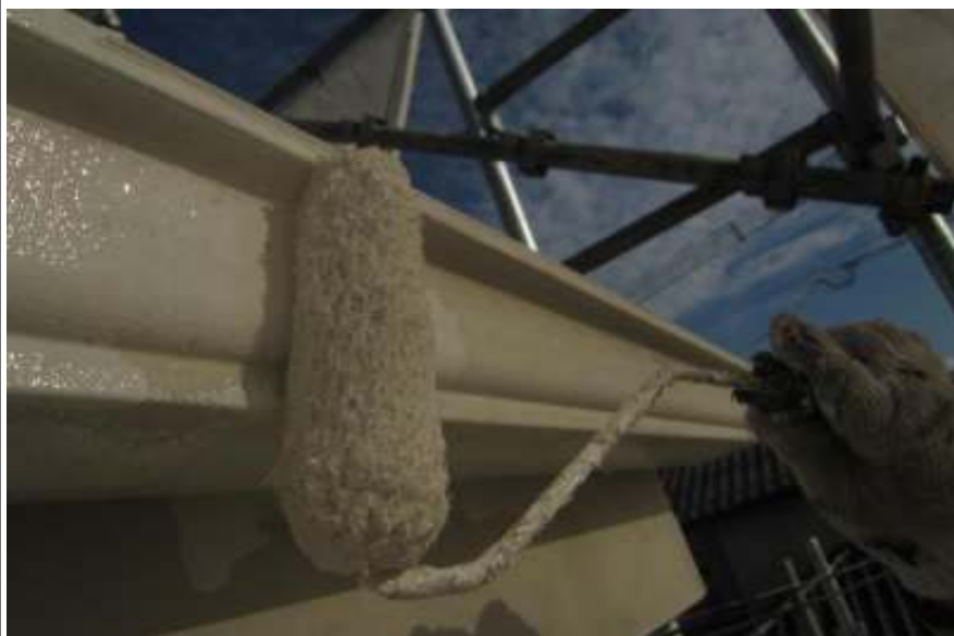
樋塗装下塗り施工中
