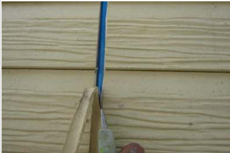
外壁シーリング撤去施工中
