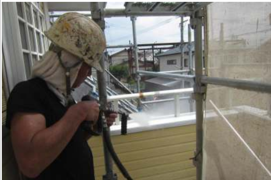
ベランダ高圧洗浄施工中
