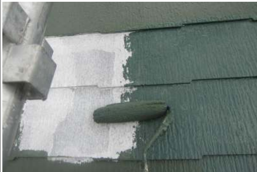
屋根塗装中塗り施工中
