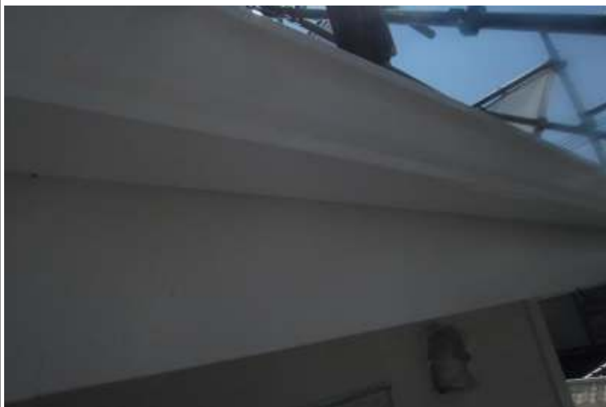
樋塗装施工完了
