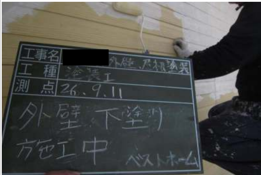
外壁塗装下塗り施工中
