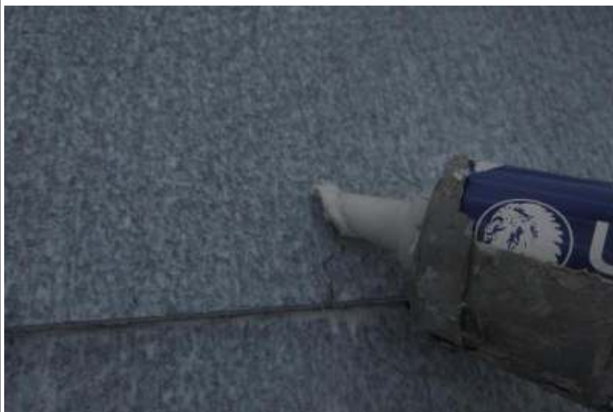
屋根クラック補修施工中
