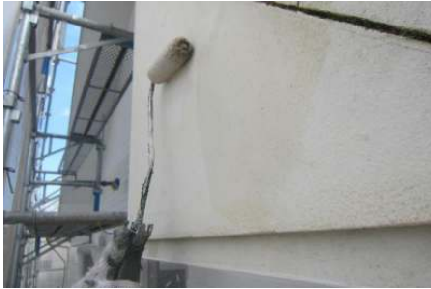
破風板塗装バリアー施工中
