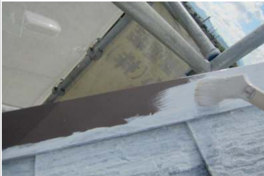
棟鉄板サビ止め施工中
