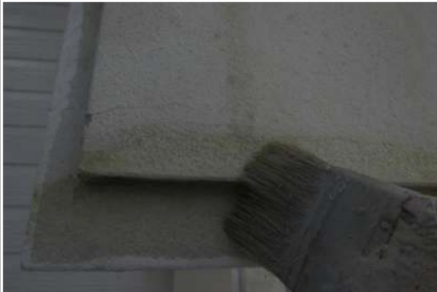
破風板塗装バリアー施工中
