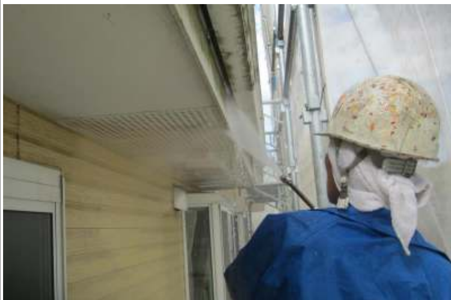
破風板高圧洗浄施工中
