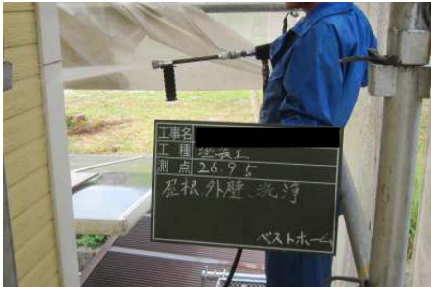
外壁高圧洗浄施工中
