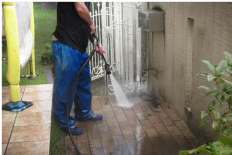
土間高圧洗浄施工中
