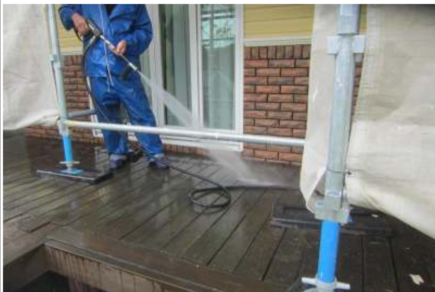
ウッドデッキ高圧洗浄施工中
