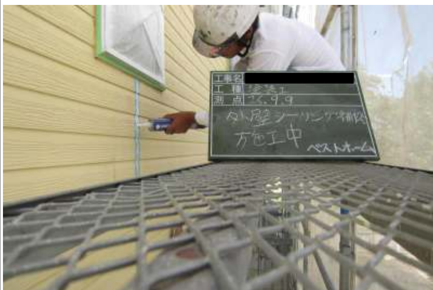
外壁シーリング補修施工中
