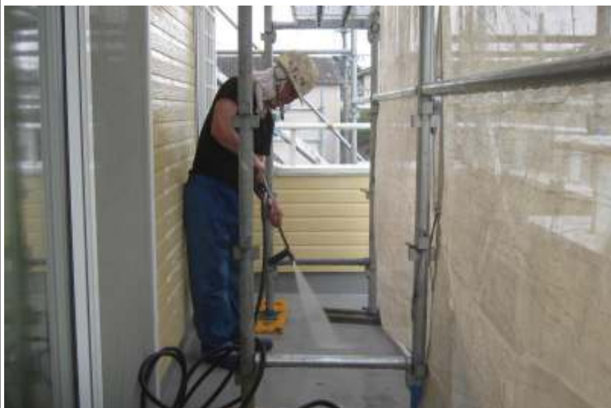
ベランダ高圧洗浄施工中
