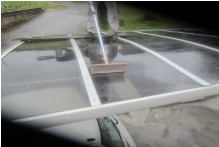
カーポート洗浄施工中
