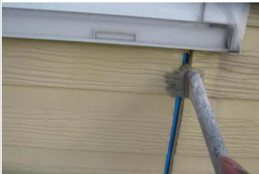
外壁シーリング補修施工中
