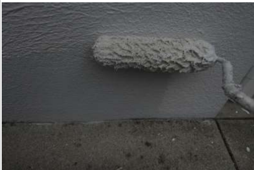
基礎塗装上塗り施工中
