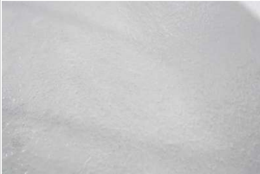
ベランダ塗装中塗り 1回目施工完了
