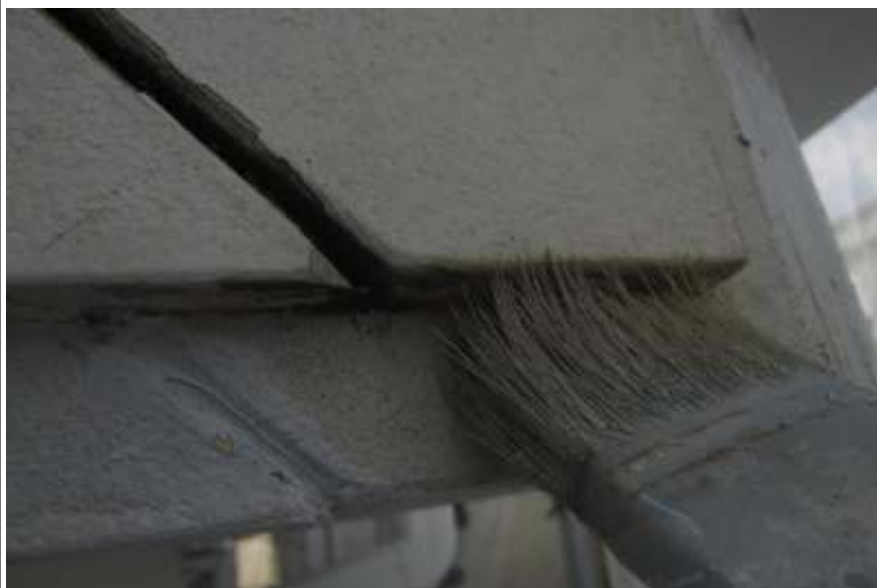
破風板塗装バリアー施工中
