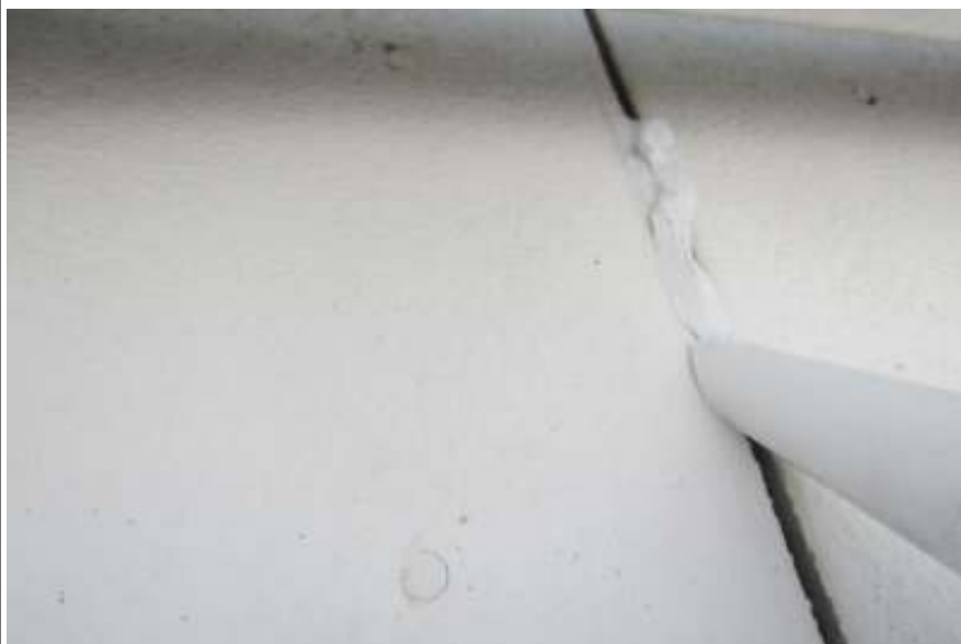
破風板補修施工中
