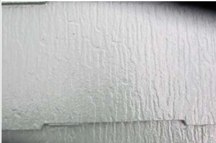
屋根塗装下塗り施工完了
