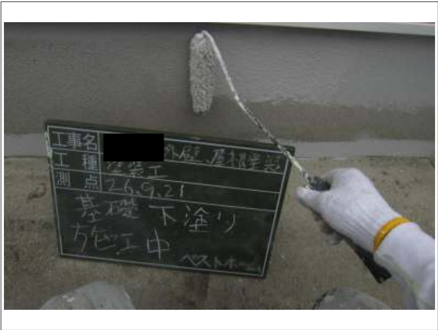
基礎塗装下塗り施工中
