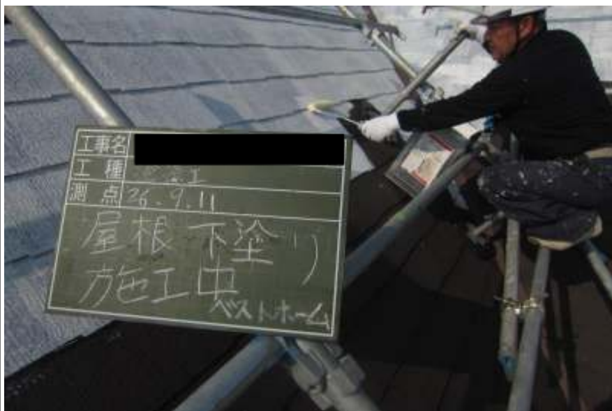
屋根塗装下塗り施工中
