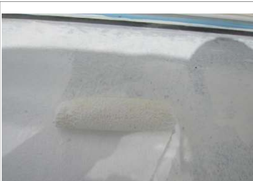
ベランダ塗装中塗り 1 回目施工中
