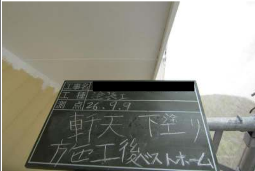
軒天塗装下塗り施工完了
