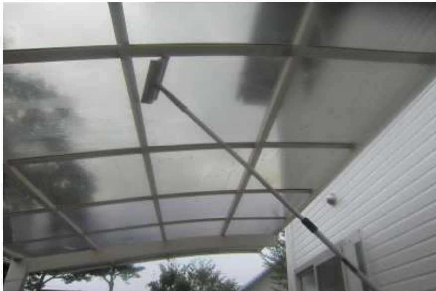
カーポート洗浄施工中
