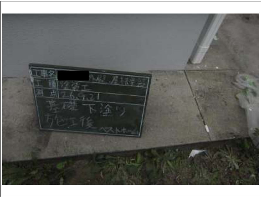
基礎塗装下塗り施工完了
