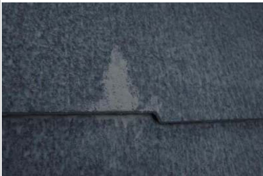
屋根クラック補修施工完了
