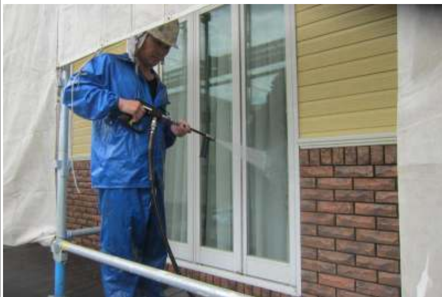
窓高圧洗浄施工中
