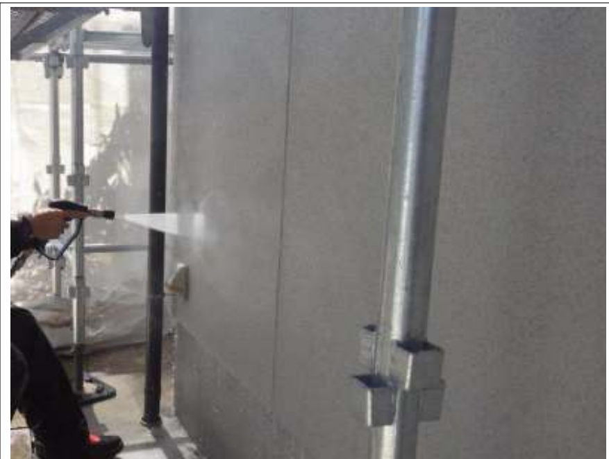
外壁高圧洗浄施工中
