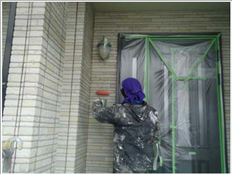
外壁塗装下塗り施工中
