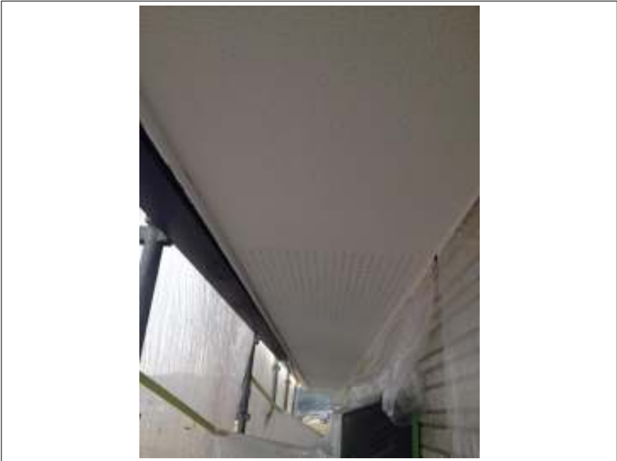
軒天塗装施工完了
