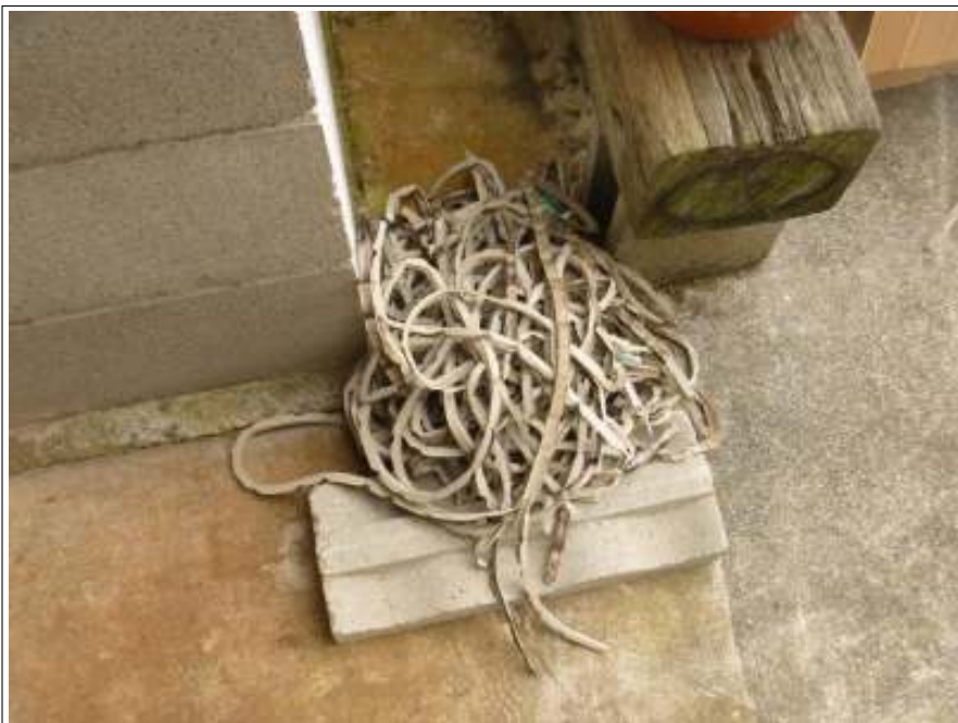
外壁シーリング撤去後
