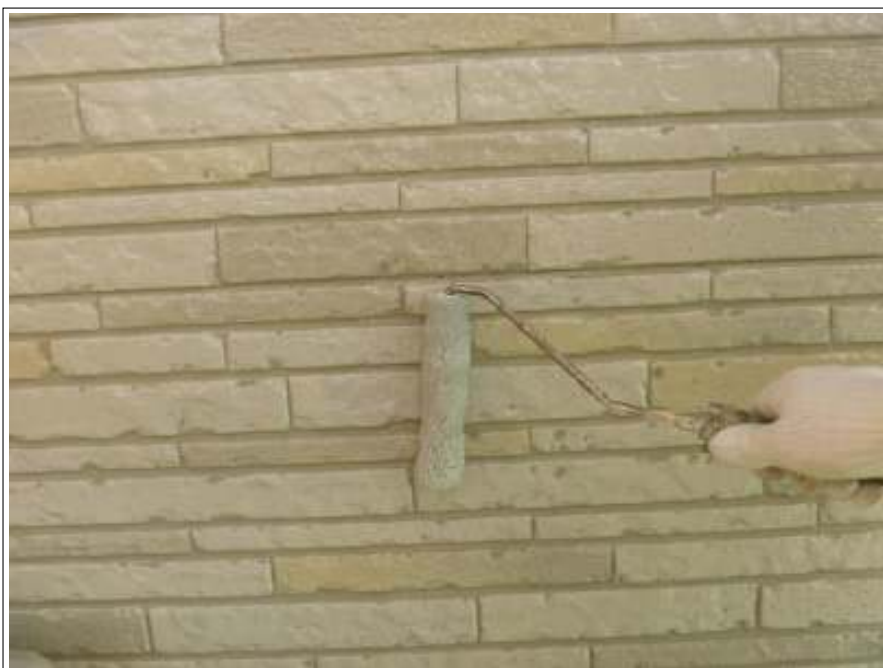
外壁塗装上塗り施工中
