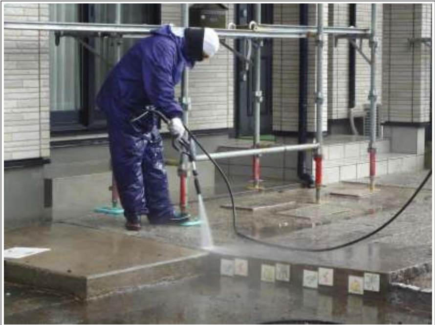
土間高圧洗浄施工中
