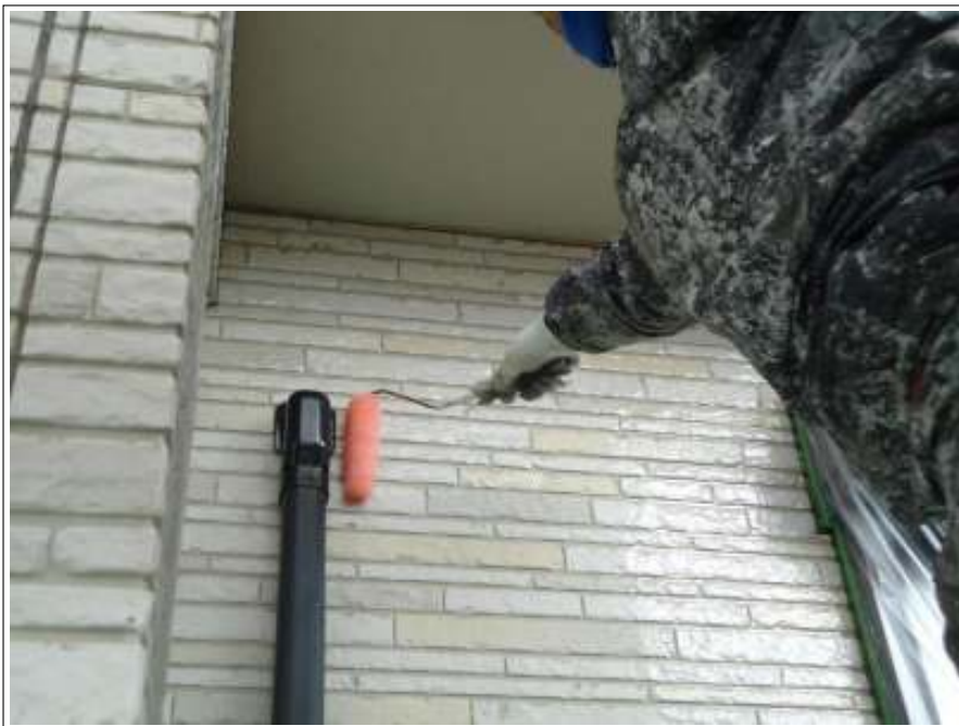
外壁塗装下塗り施工中
