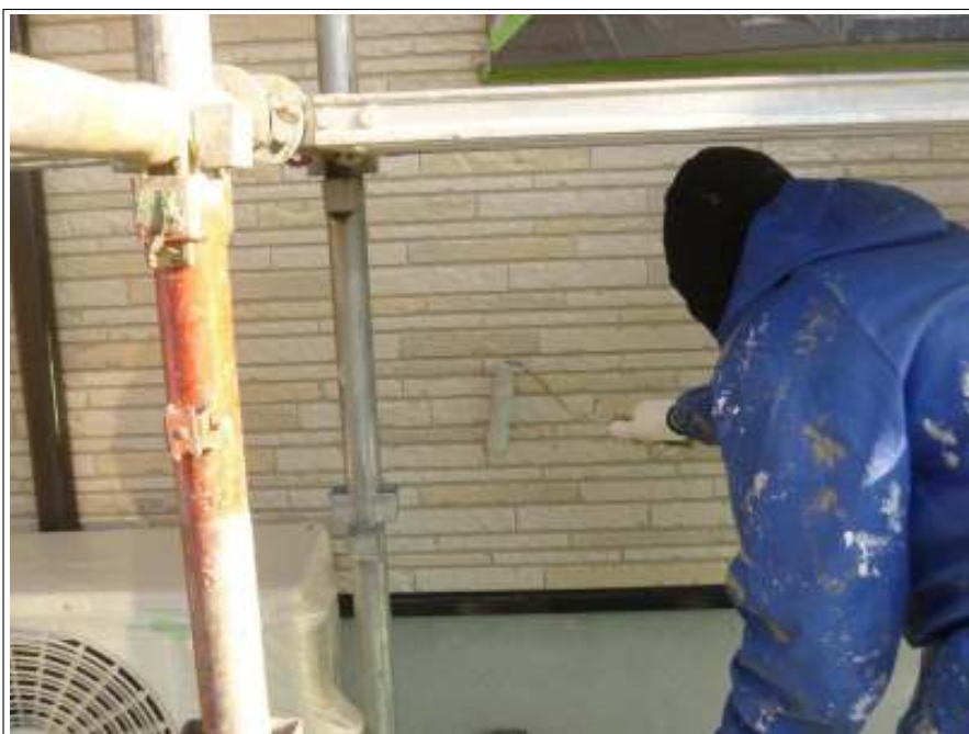
外壁塗装上塗り施工中
