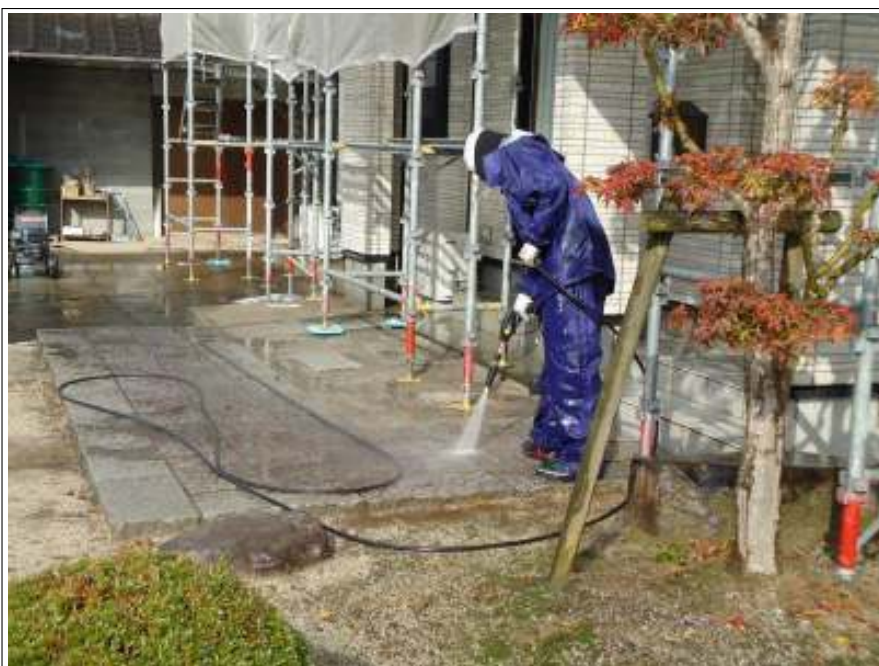
土間高圧洗浄施工中
