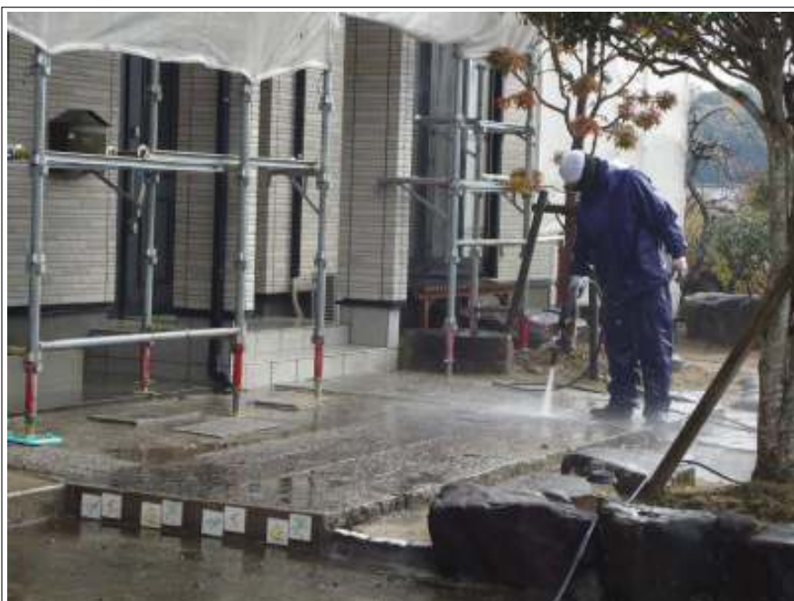
土間高圧洗浄施工中
