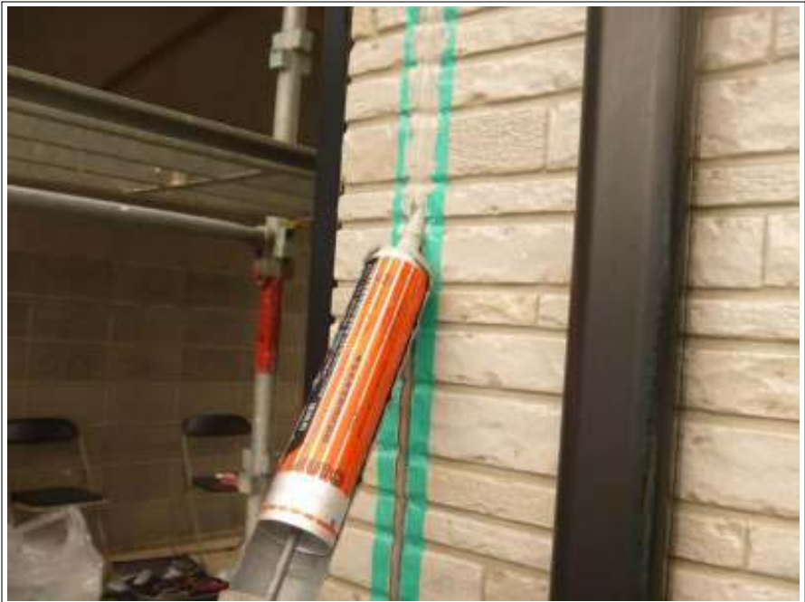
外壁シーリング打替え施工中
