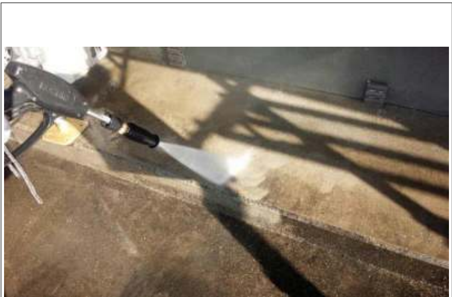
土間高圧洗浄施工中
