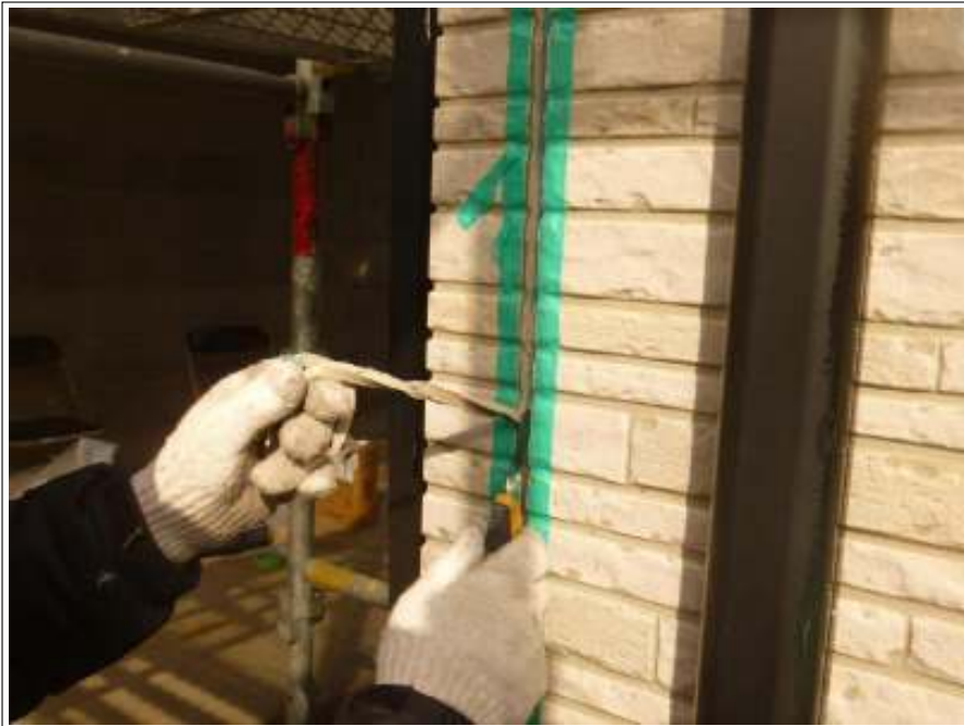
外壁シーリング撤去施工中
