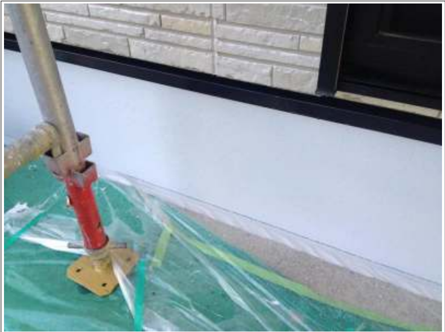
基礎塗装施工完了
