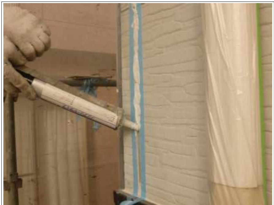
外壁シーリング打替え施工中
