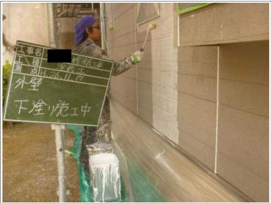
外壁塗装下塗り施工中
