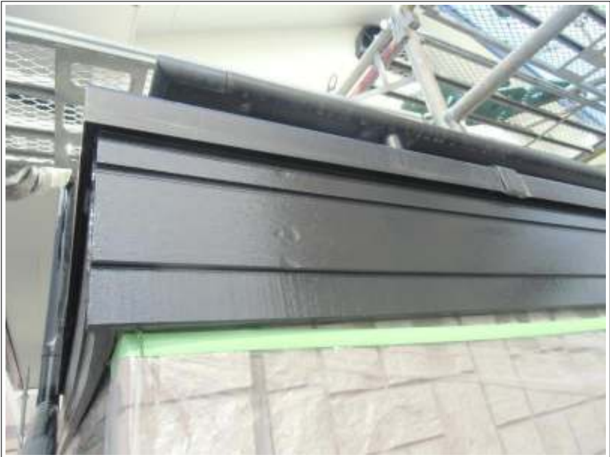
帯塗装施工完了
