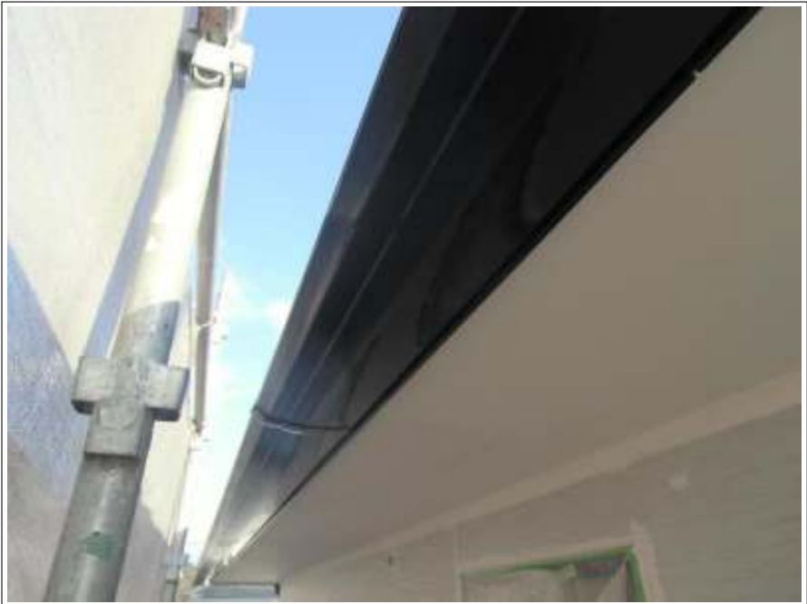
横樋塗装施工完了
