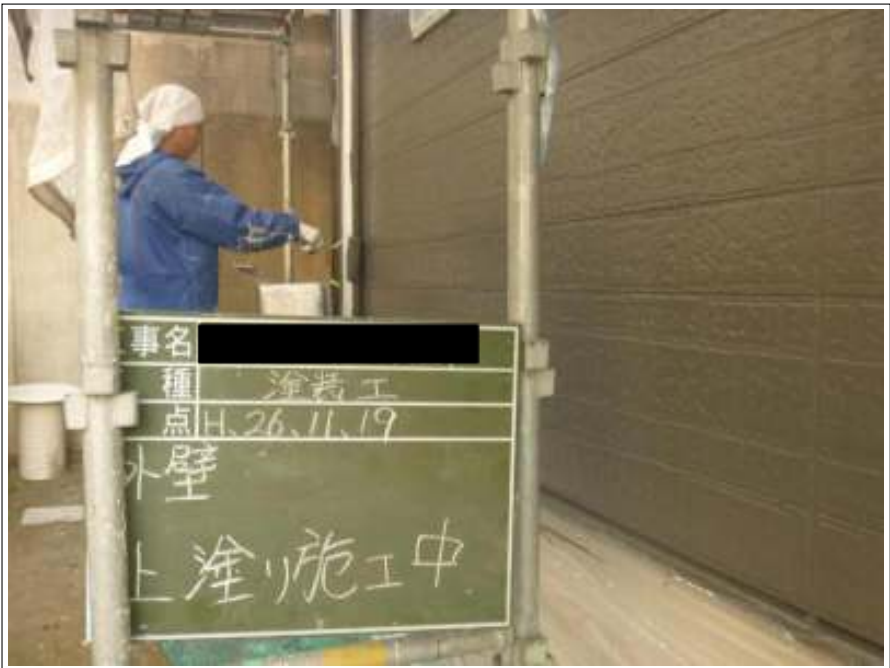
外壁塗装上塗り施工中
