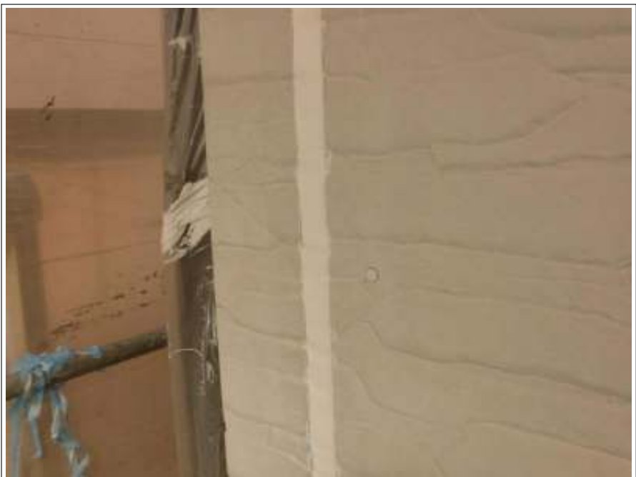
外壁シーリング打替え施工完了
