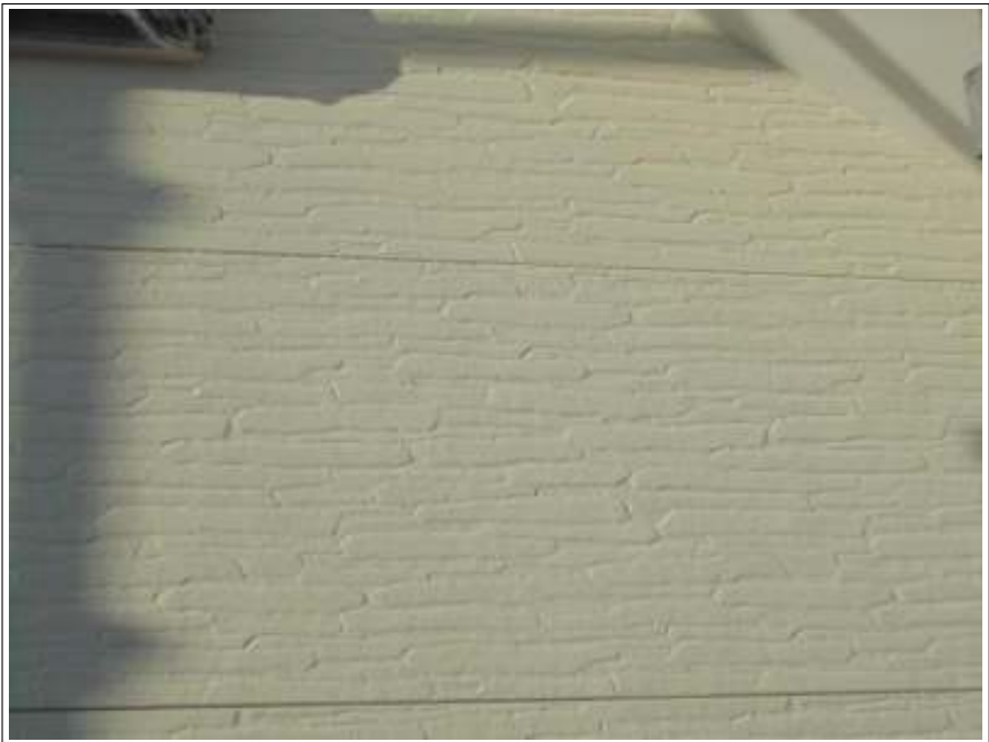
外壁塗装上塗り施工完了
