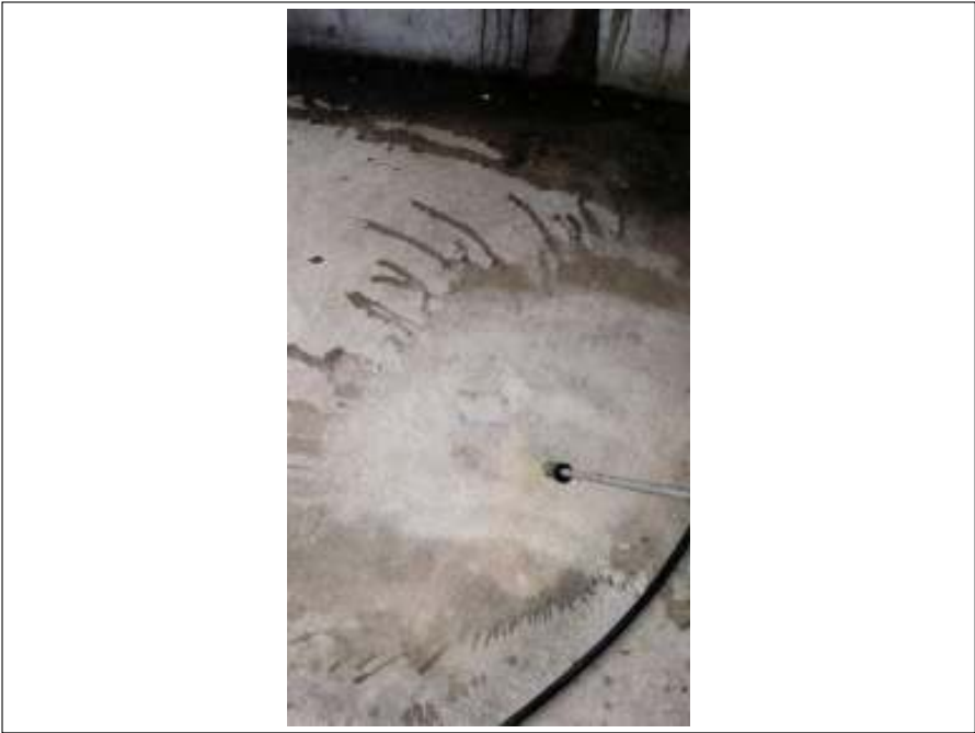
土間高圧洗浄施工中
