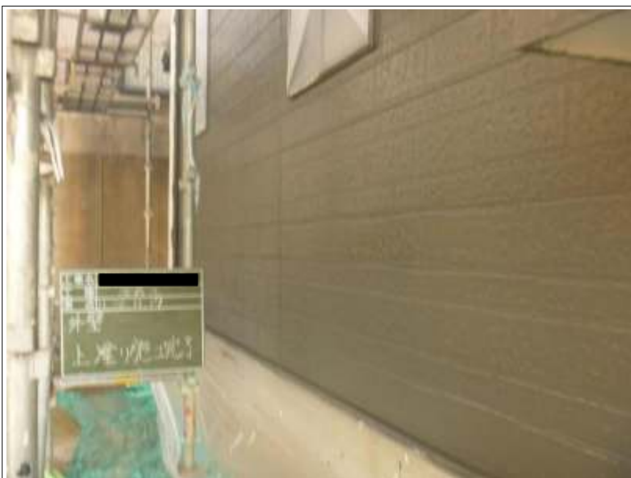
外壁塗装上塗り施工完了
