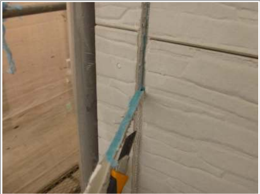
外壁シーリング撤去施工中
