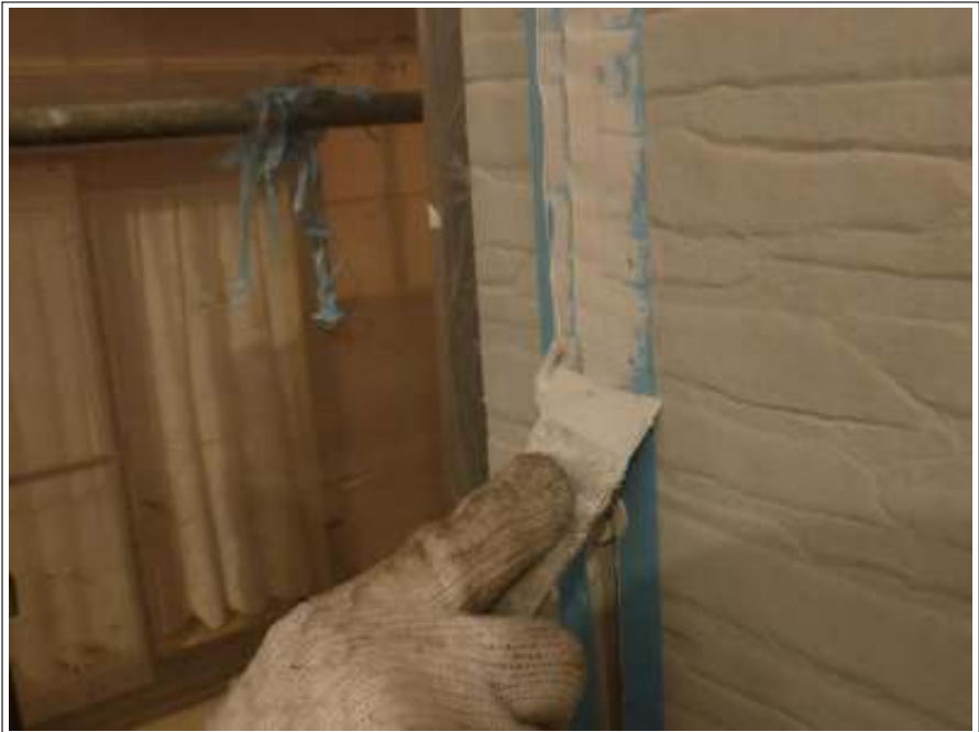
外壁シーリング打替え施工中
