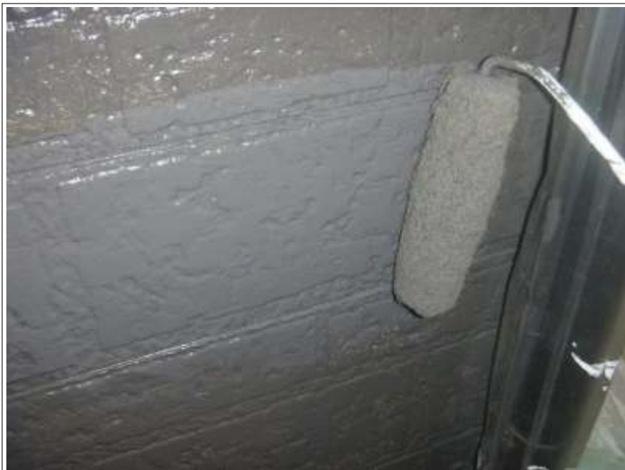
外壁塗装上塗り施工中
