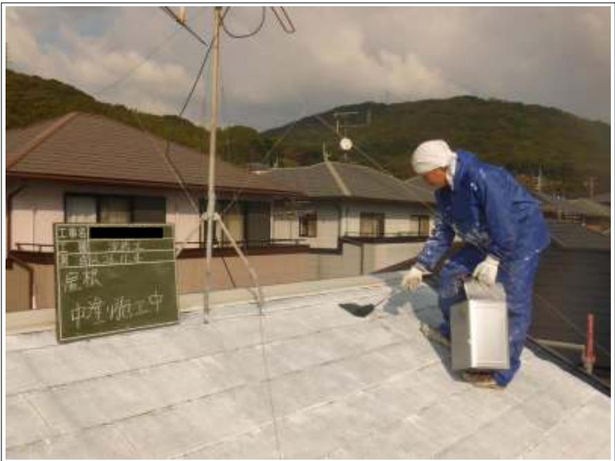
屋根塗装中塗り施工中
