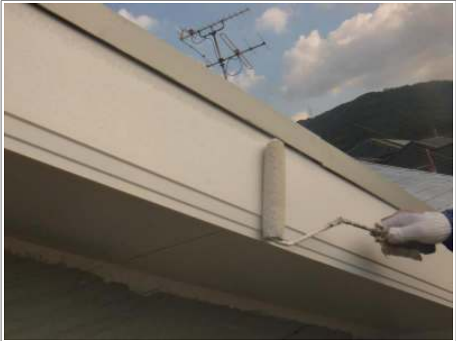
破風板塗装下塗り施工中
