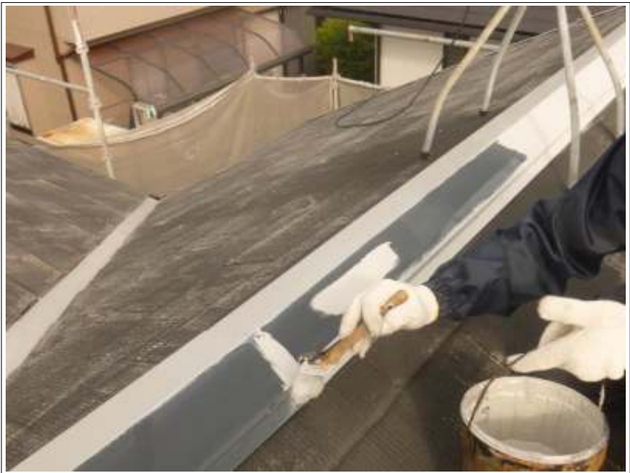
棟鉄板塗装下塗り施工中
