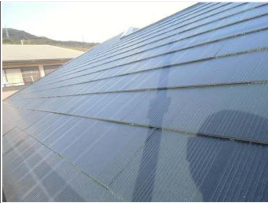
屋根塗装上塗り施工完了
