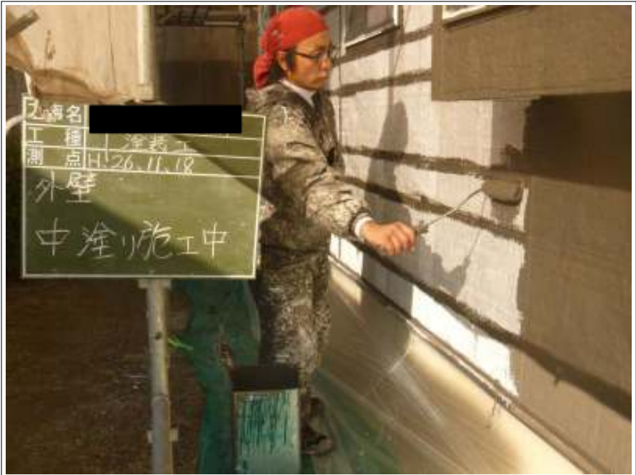
外壁塗装中塗り施工中
