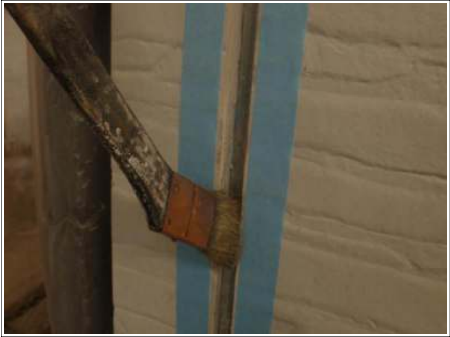
外壁シーリングプライマー施工中
