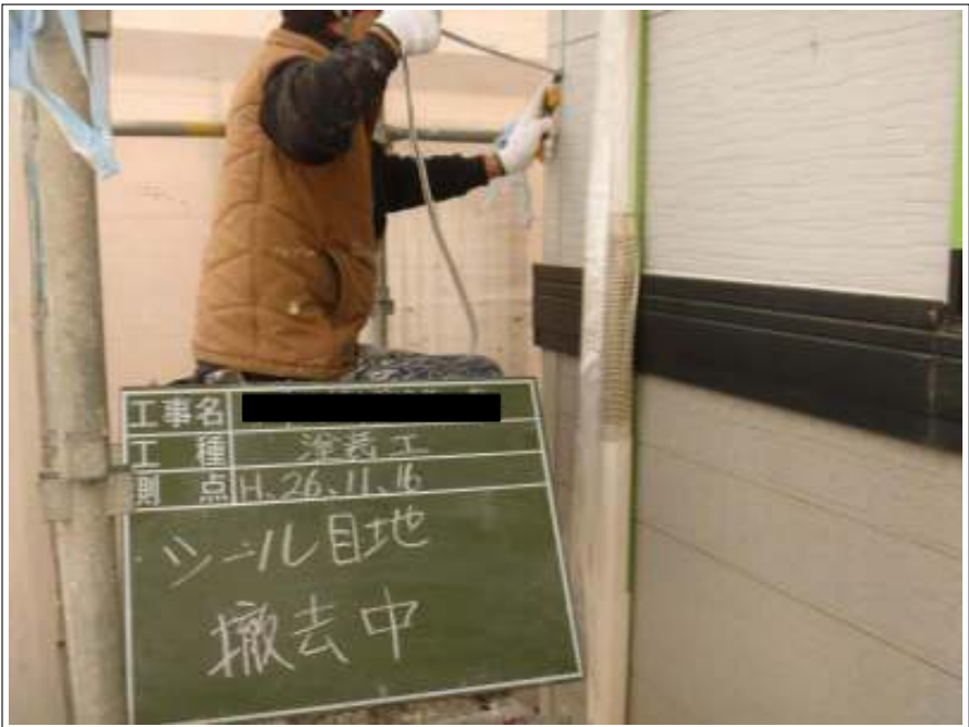
外壁シーリング撤去施工中
