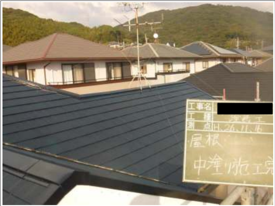
屋根塗装中塗り施工完了
