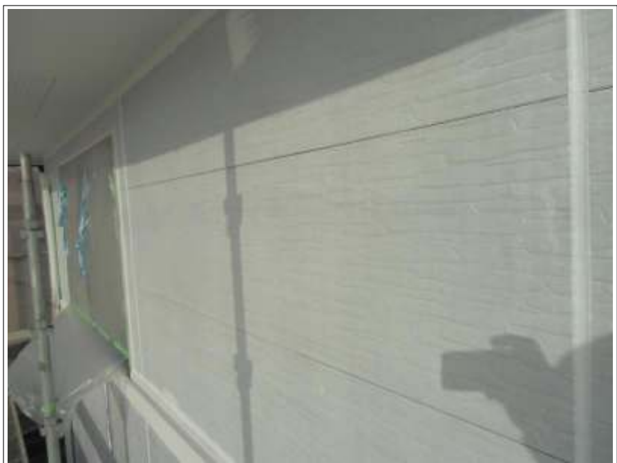
外壁塗装下塗り施工完了
