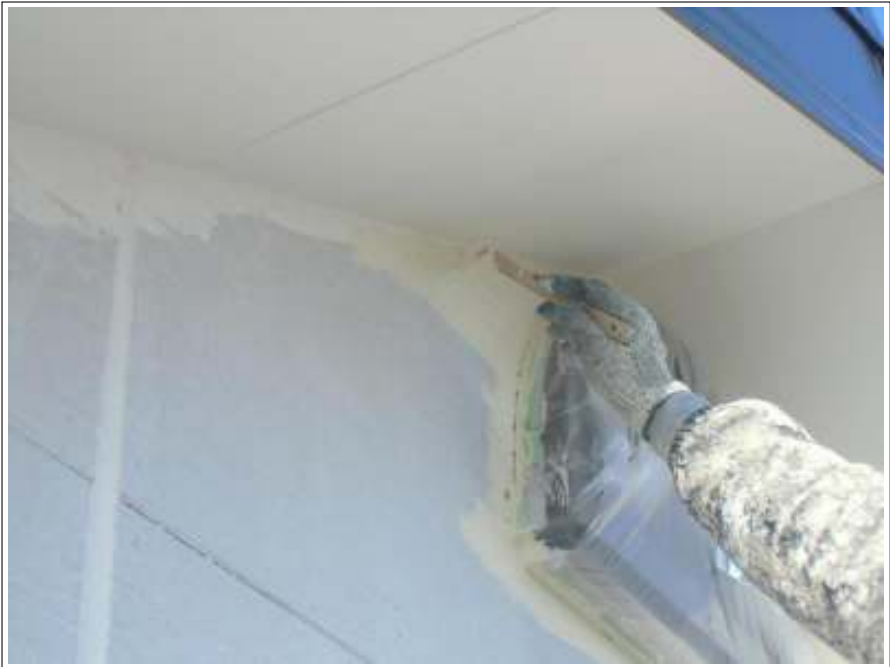
外壁塗装中塗り施工中
