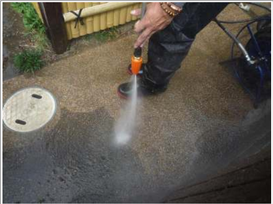
土間高圧洗浄施工中
