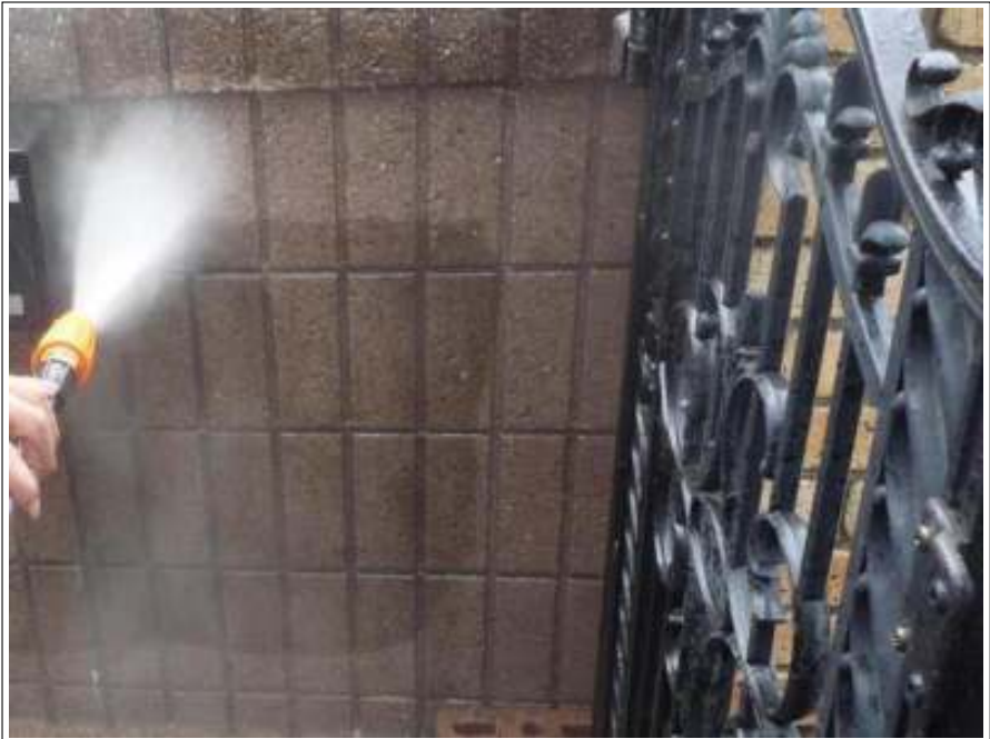
塀高圧洗浄施工中
