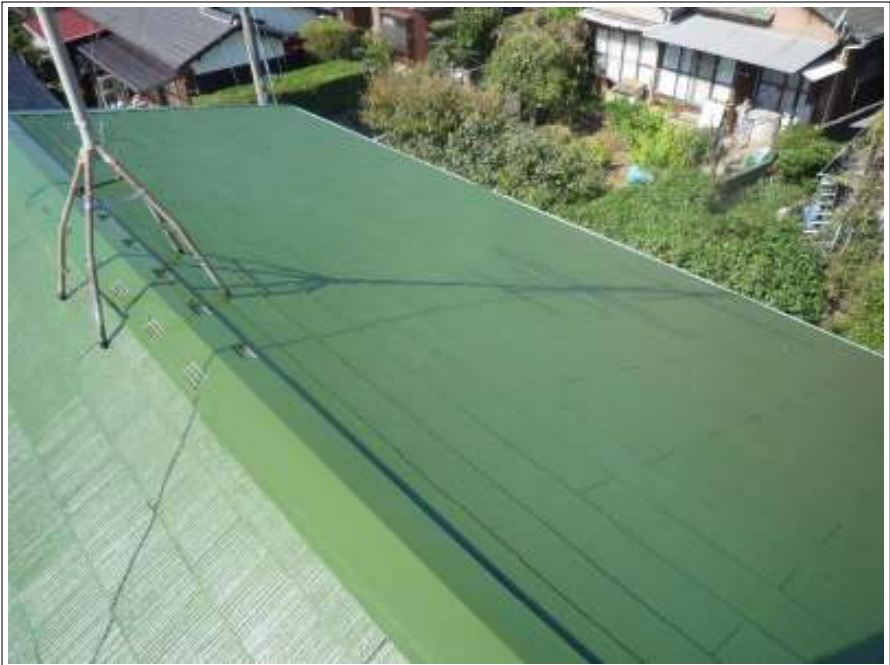
屋根塗装中塗り施工完了
