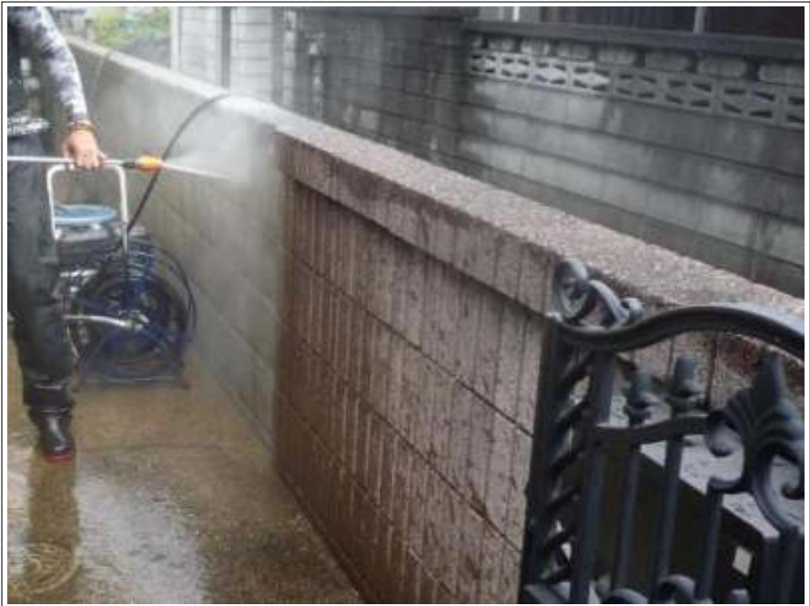
塀高圧洗浄施工中
