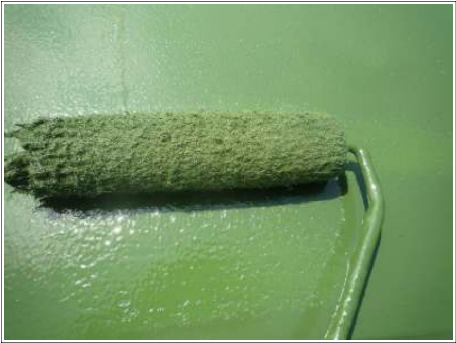
棟鉄板塗装上塗り施工中
