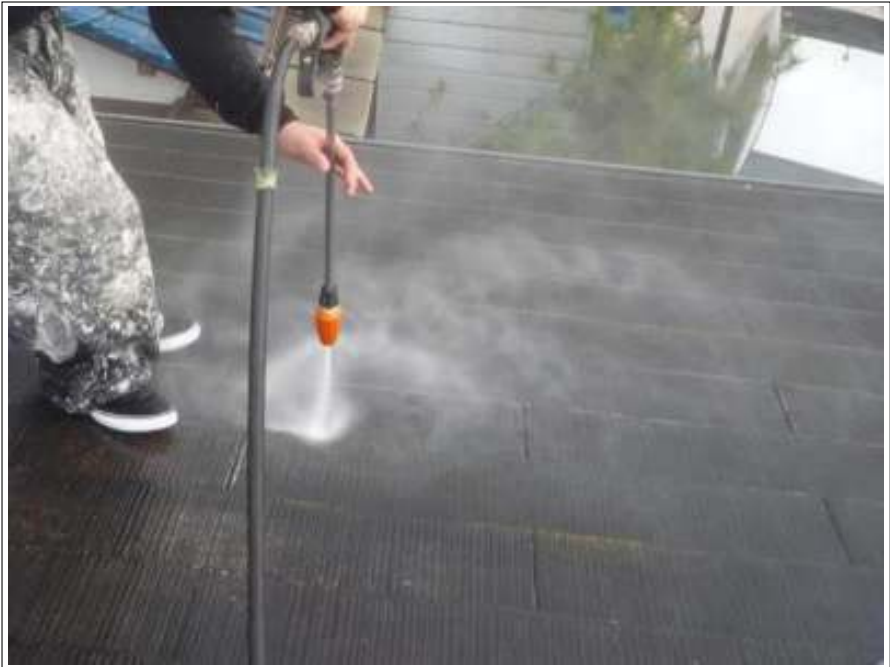
屋根高圧洗浄施工中
