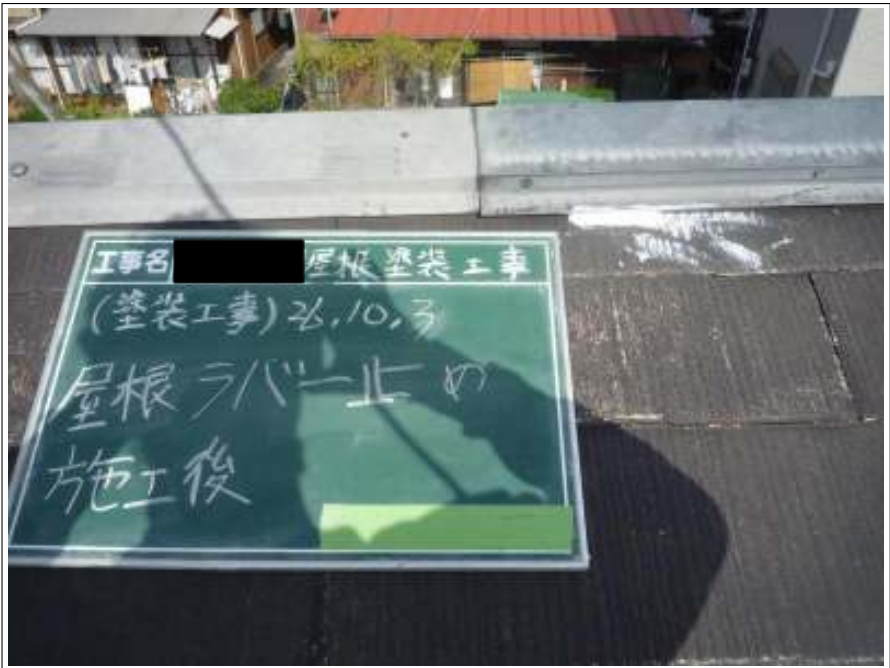
棟鉄板ラバー止め施工完了
