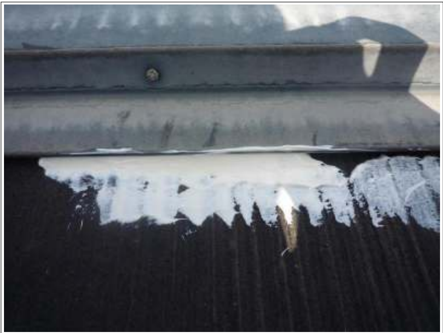
棟鉄板ラバー止め施工完了
