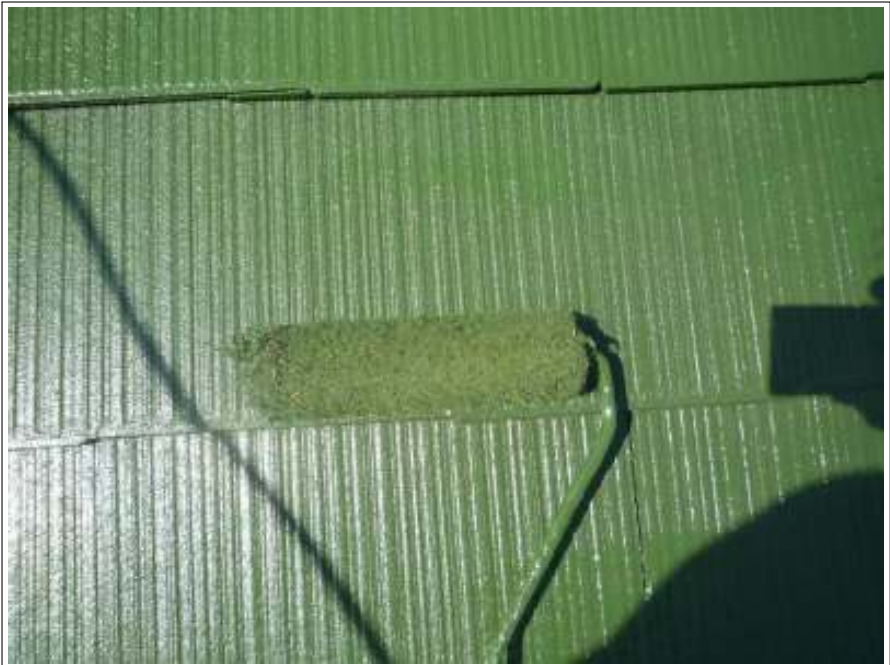
屋根塗装上塗り施工中
