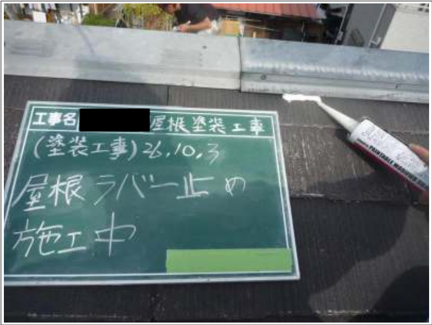
棟鉄板ラバー止め施工中
