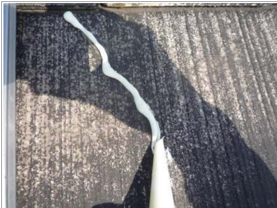
屋根クラック補修施工中
