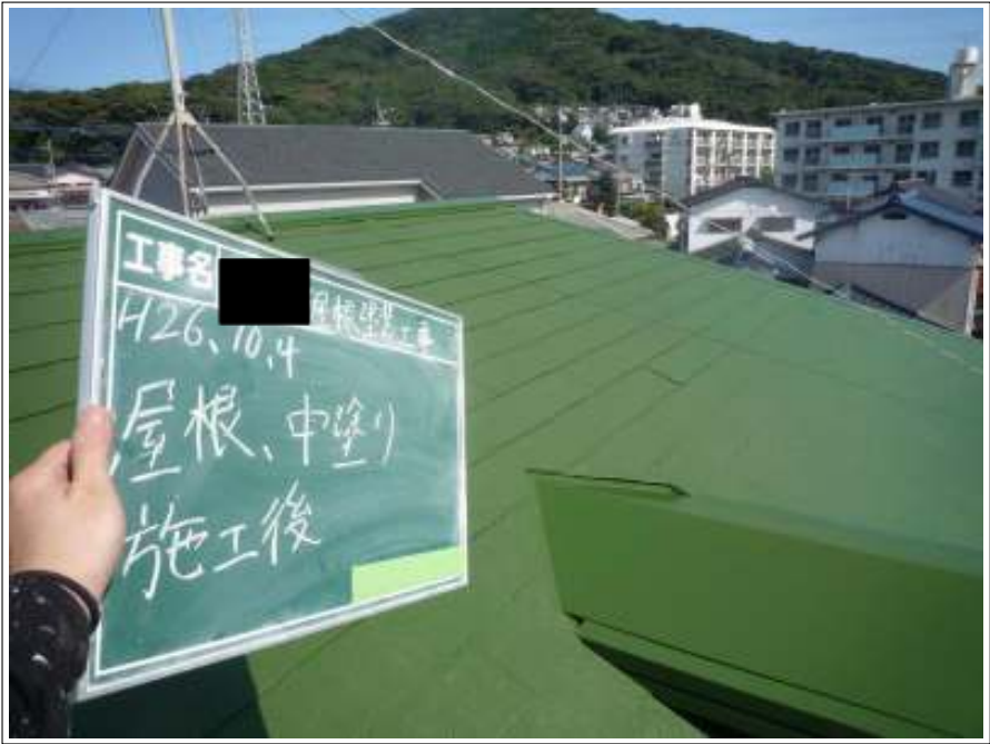
屋根塗装中塗り施工完了
