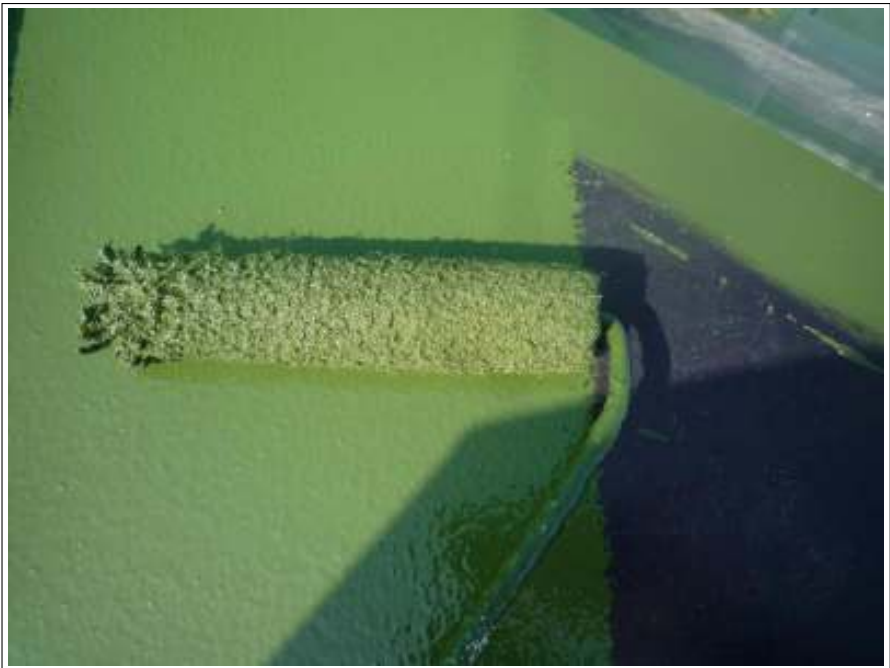
棟鉄板塗装中塗り施工中
