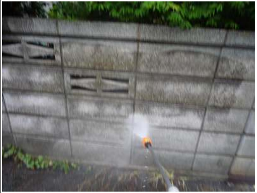
塀高圧洗浄施工中
