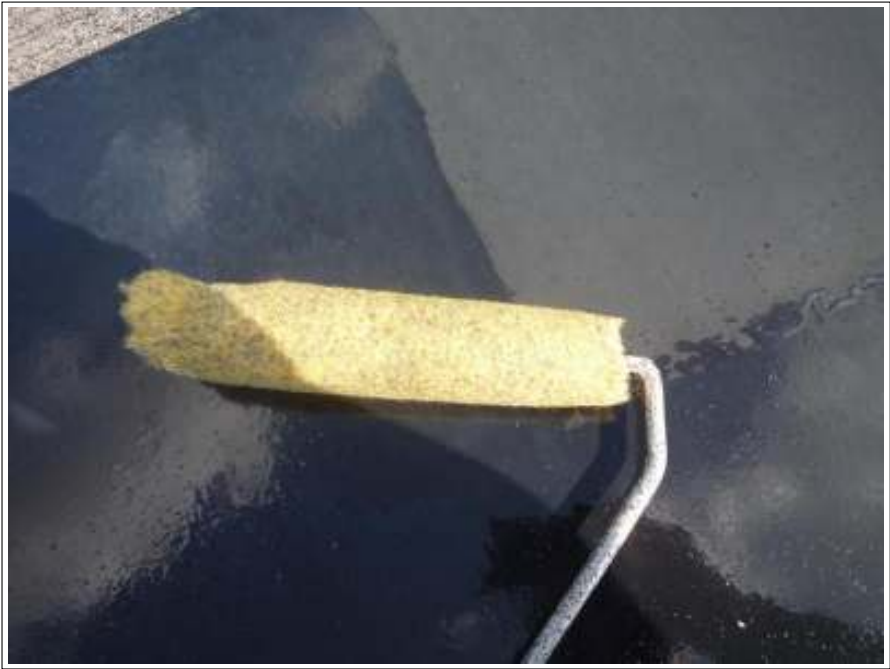
棟鉄板塗装下塗り施工中
