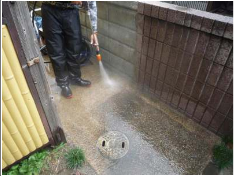
土間高圧洗浄施工中
