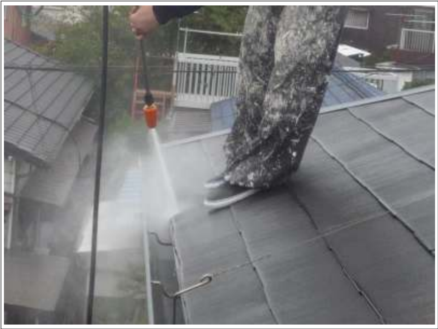
樋高圧洗浄施工中
