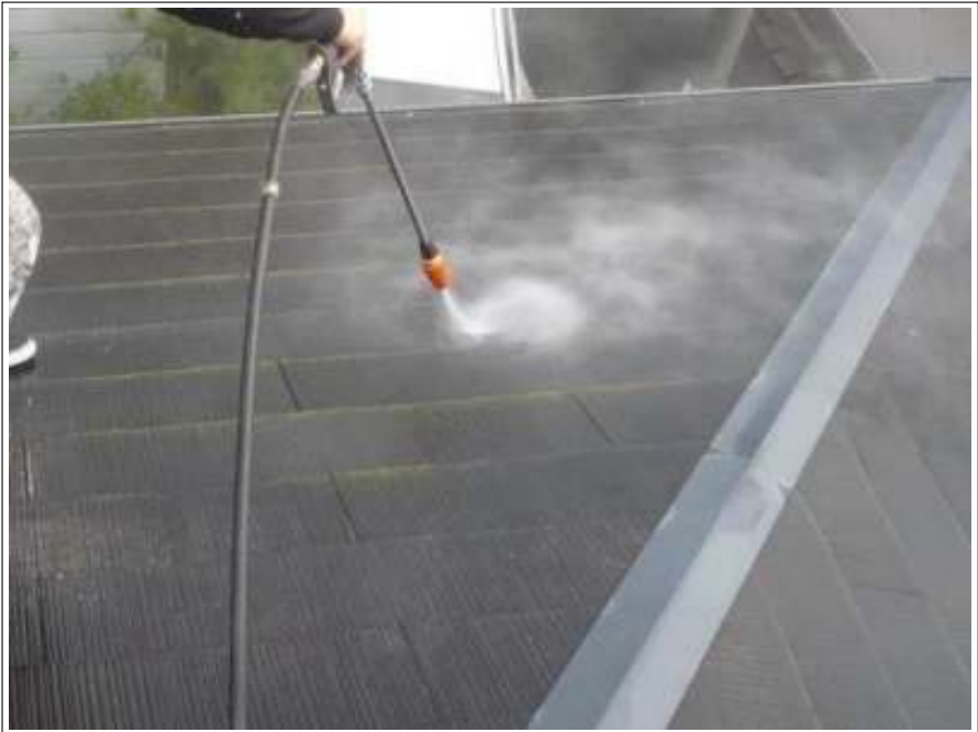
屋根高圧洗浄施工中
