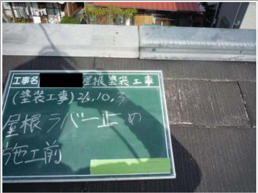
棟鉄板ラバー止め施工前
