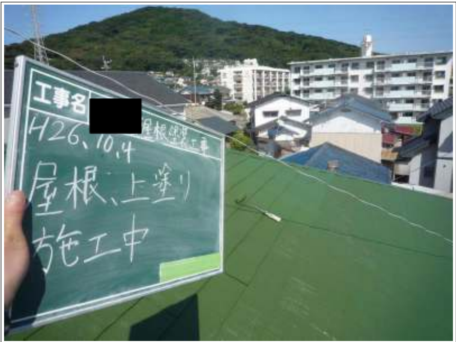
屋根塗装上塗り施工中
