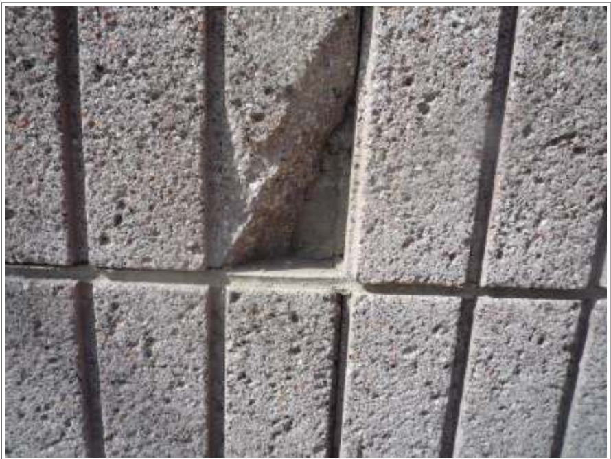
塀石タイル部補修施工前
