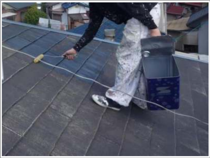
屋根塗装下塗り施工中
