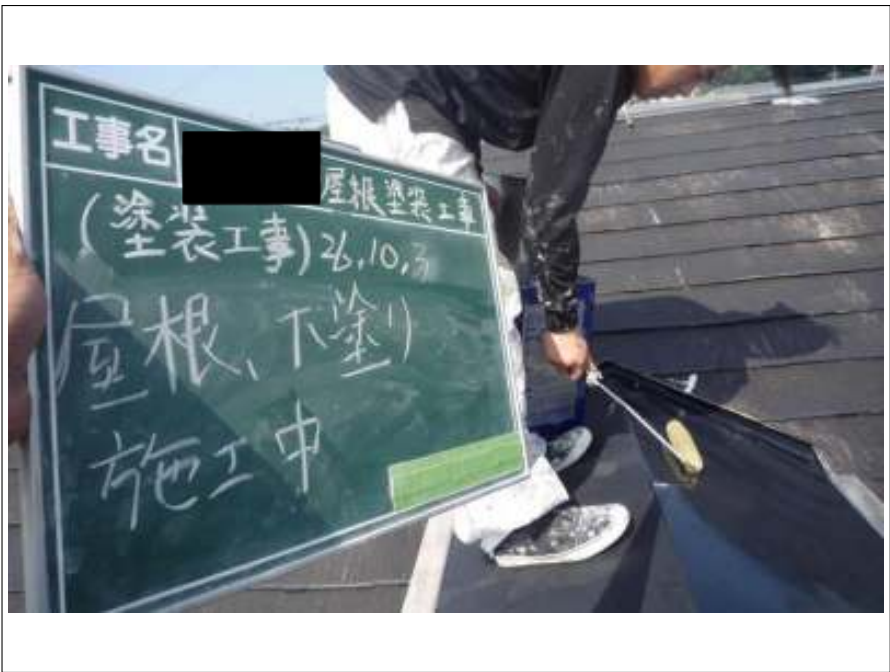
棟鉄板塗装下塗り施工中
