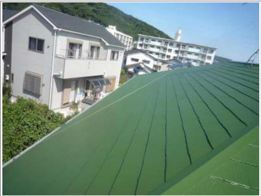
屋根塗装中塗り施工完了
