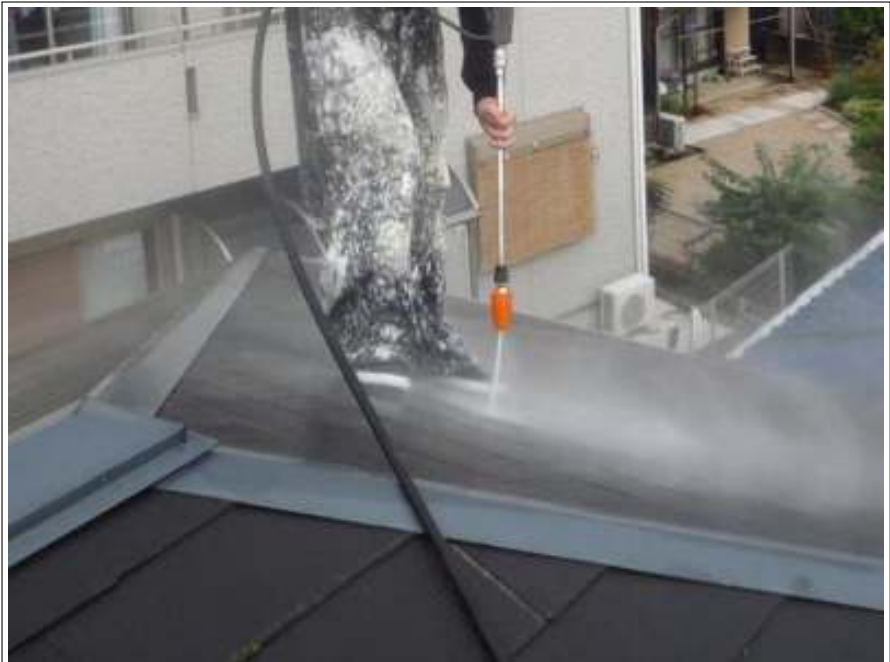
屋根高圧洗浄施工中
