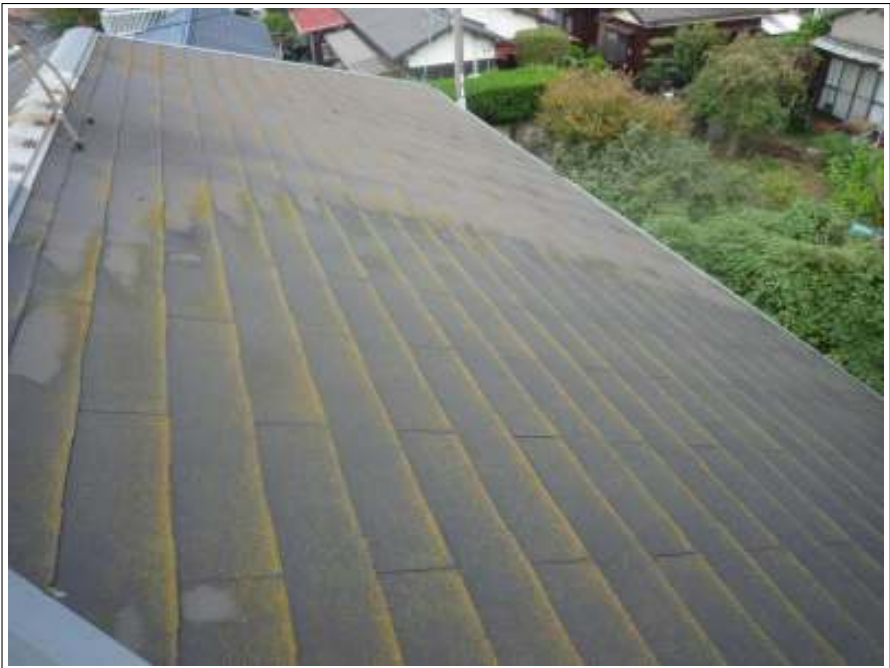
屋根高圧洗浄施工中
