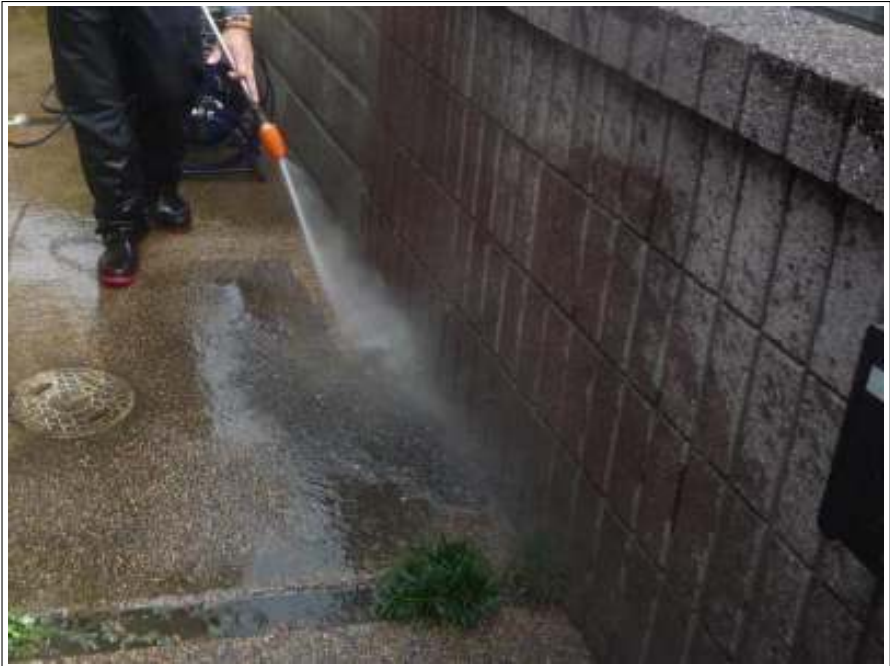
土間高圧洗浄施工中
