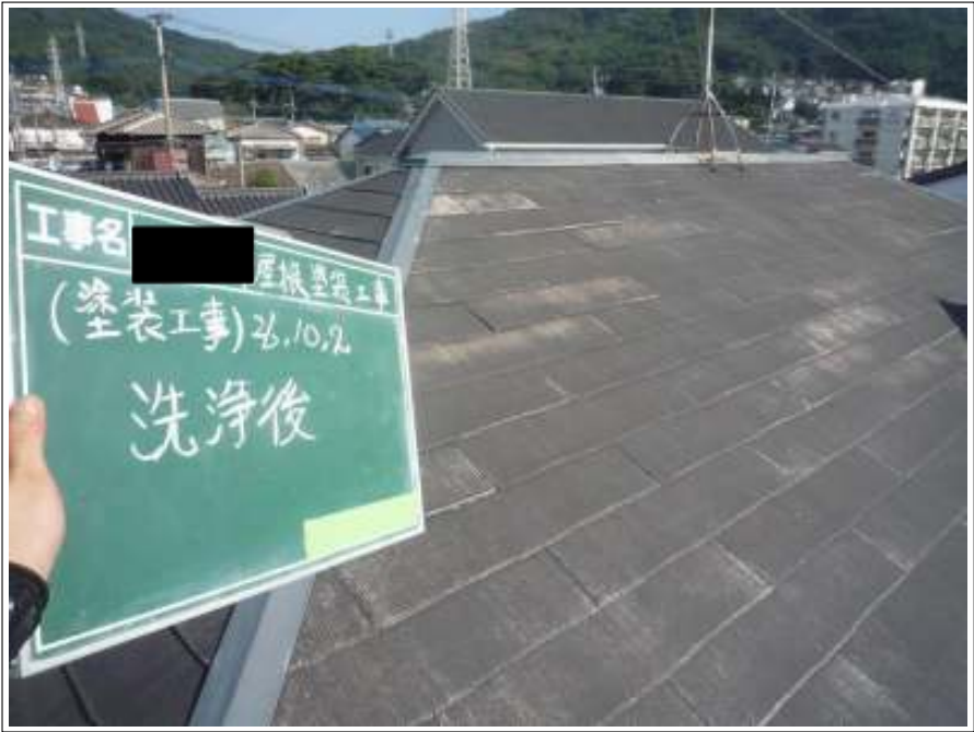
屋根高圧洗浄施工完了
