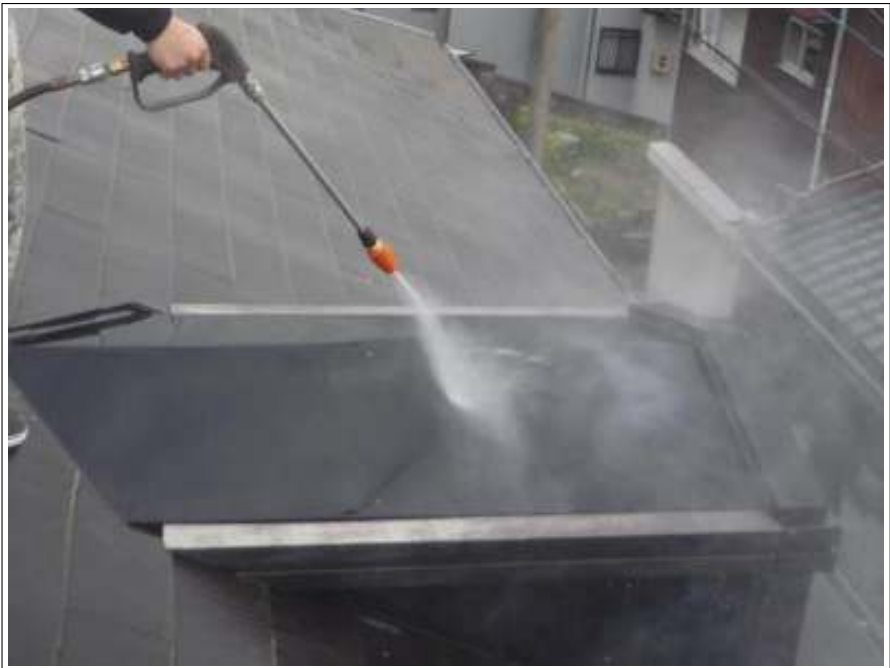
棟鉄板高圧洗浄施工中
