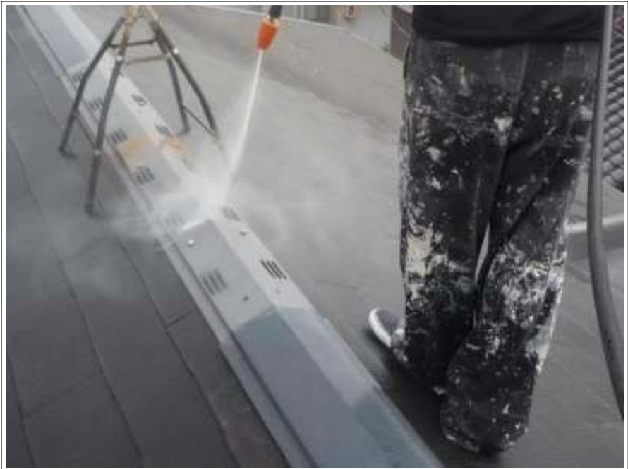
棟鉄板高圧洗浄施工中
