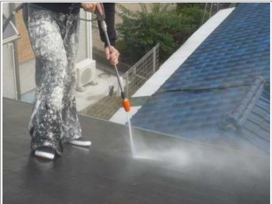
屋根高圧洗浄施工中
