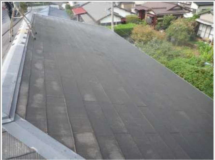
屋根高圧洗浄施工完了
