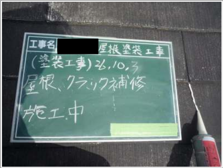
屋根クラック補修施工中
