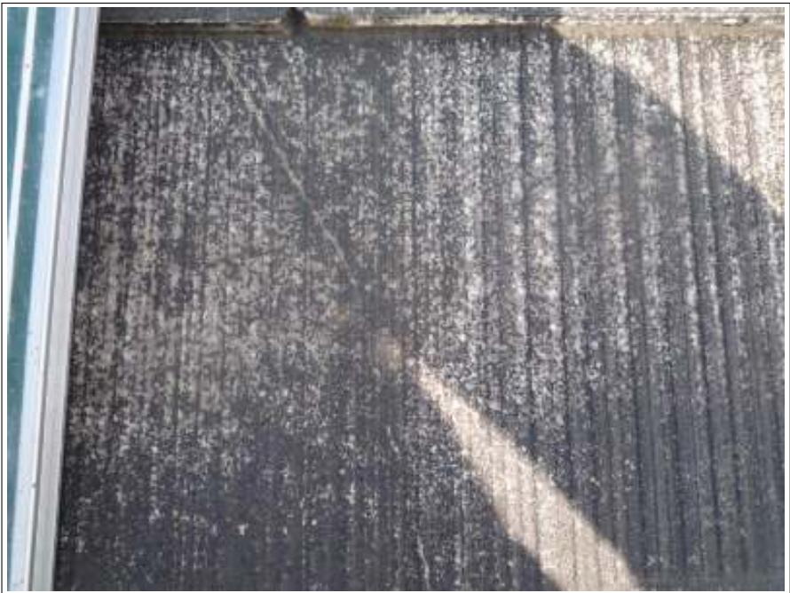
屋根クラック補修施工前
