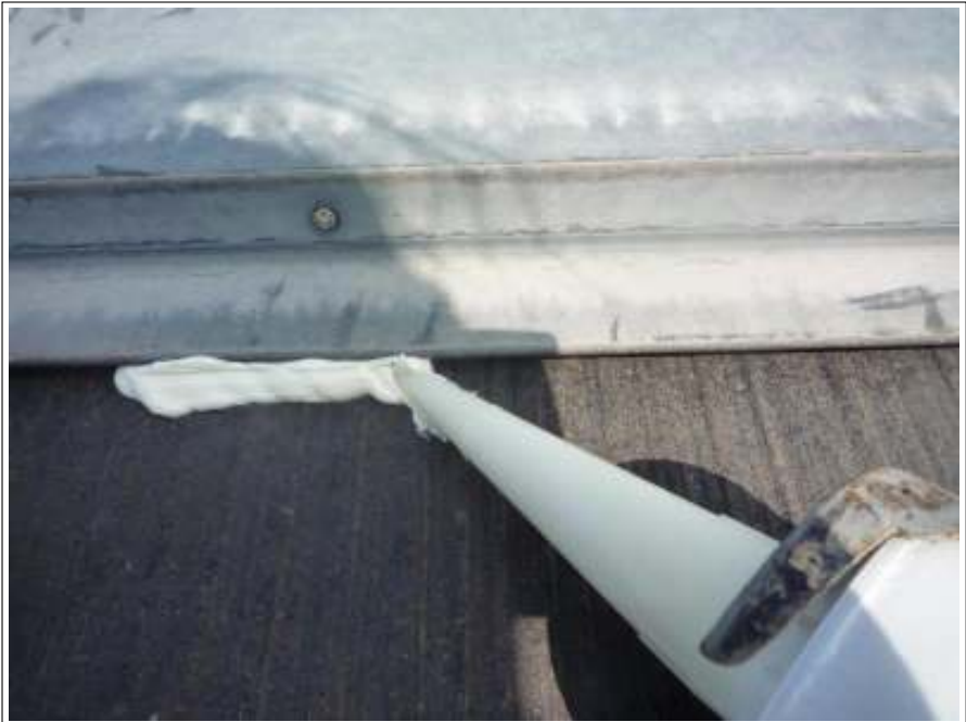
棟鉄板ラバー止め施工中
