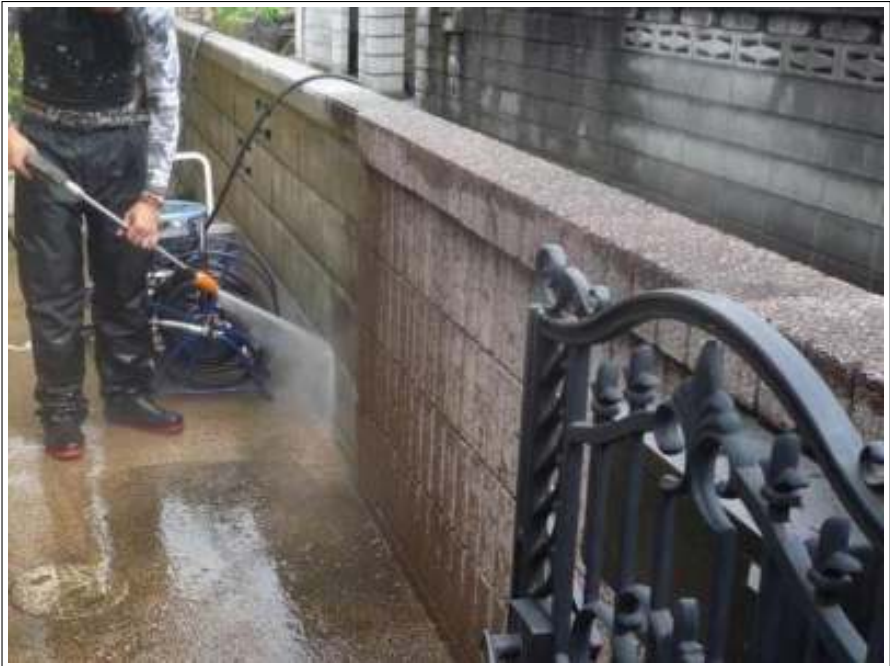
塀高圧洗浄施工中
