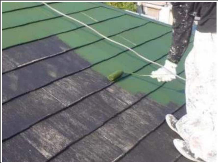
屋根塗装中塗り施工中
