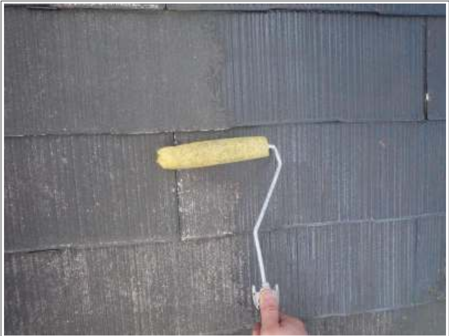
屋根塗装下塗り施工中
