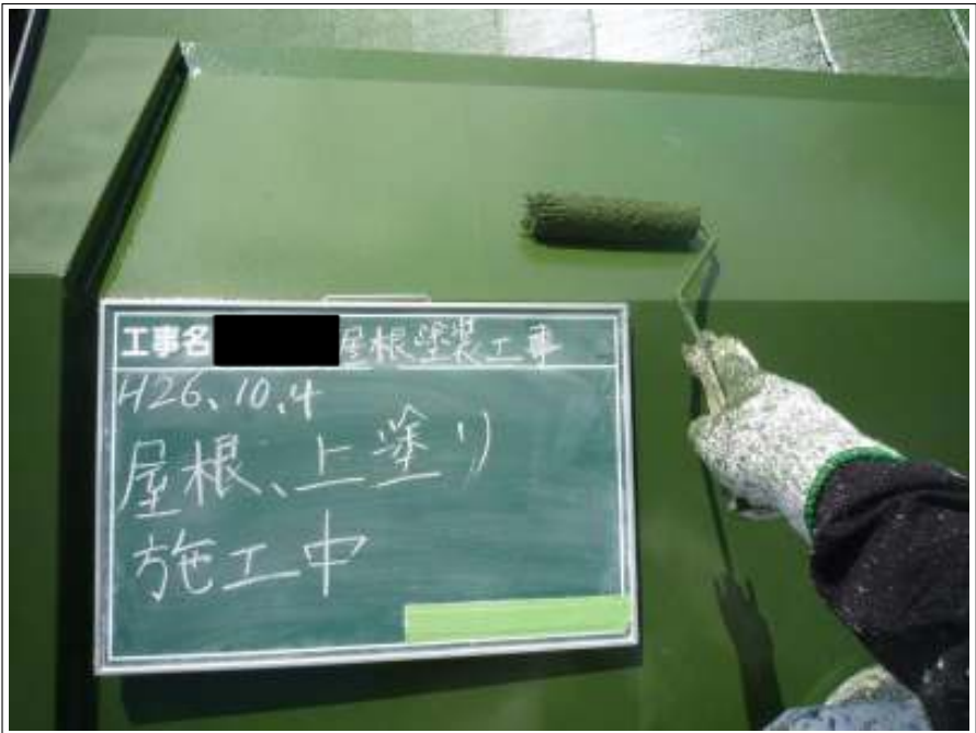
棟鉄板塗装上塗り施工中
