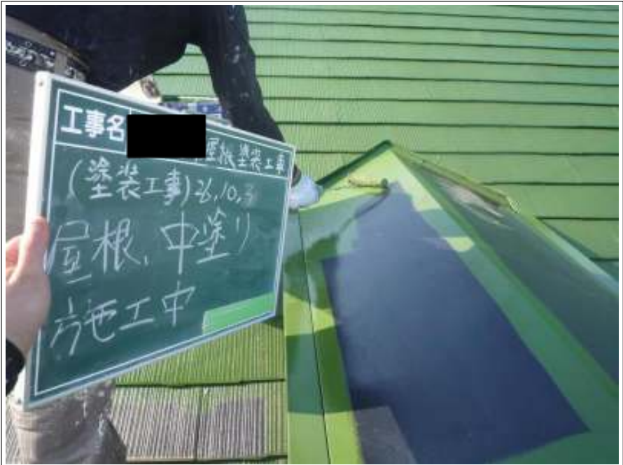
棟鉄板塗装中塗り施工中
