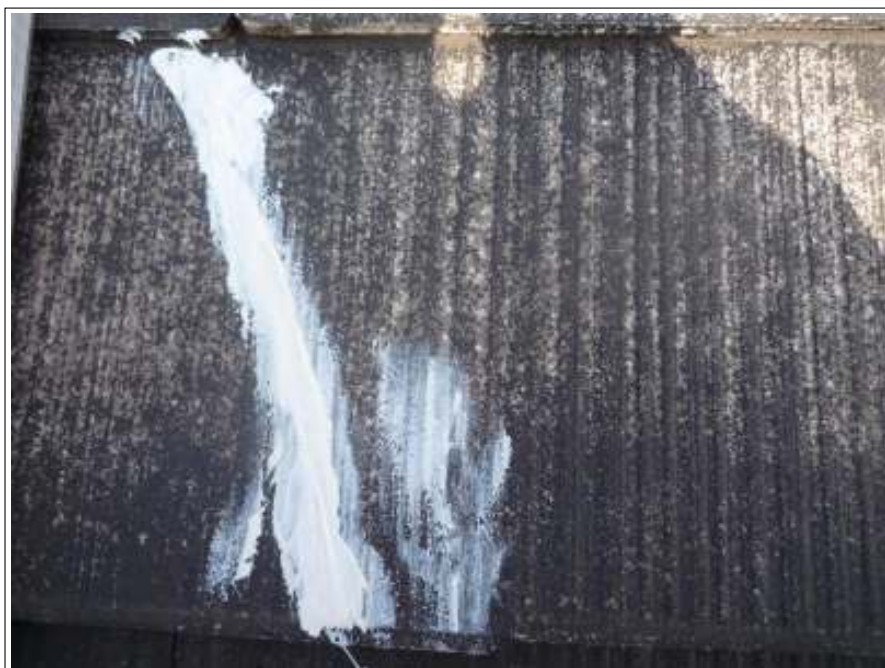
屋根クラック補修施工完了
