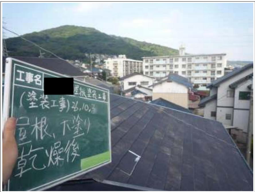
屋根塗装下塗り施工完了
