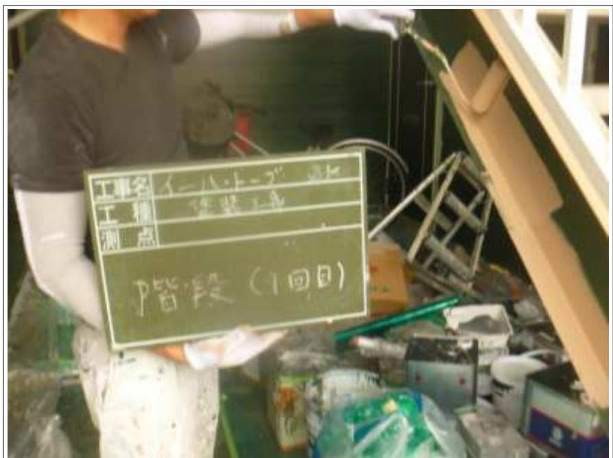
階段 上塗り施工中 (1回目)
