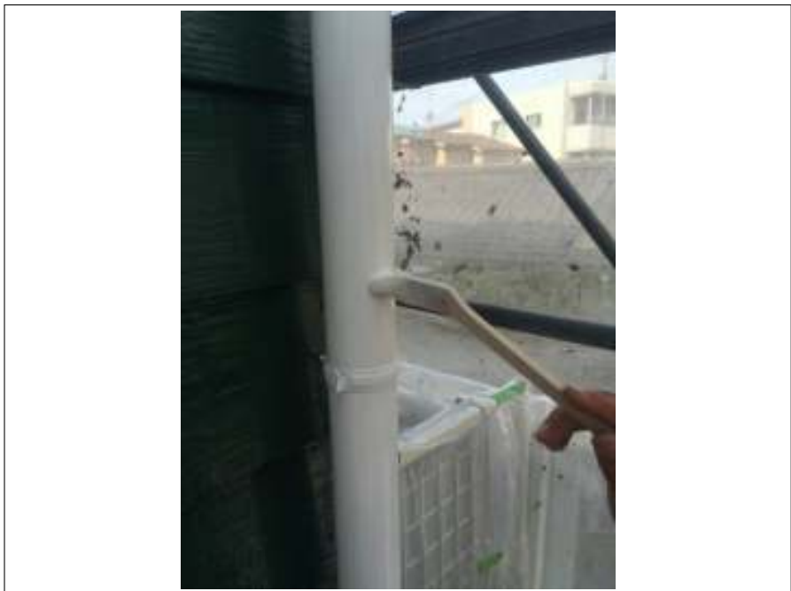
樋 上塗り施工中 (2回目)
