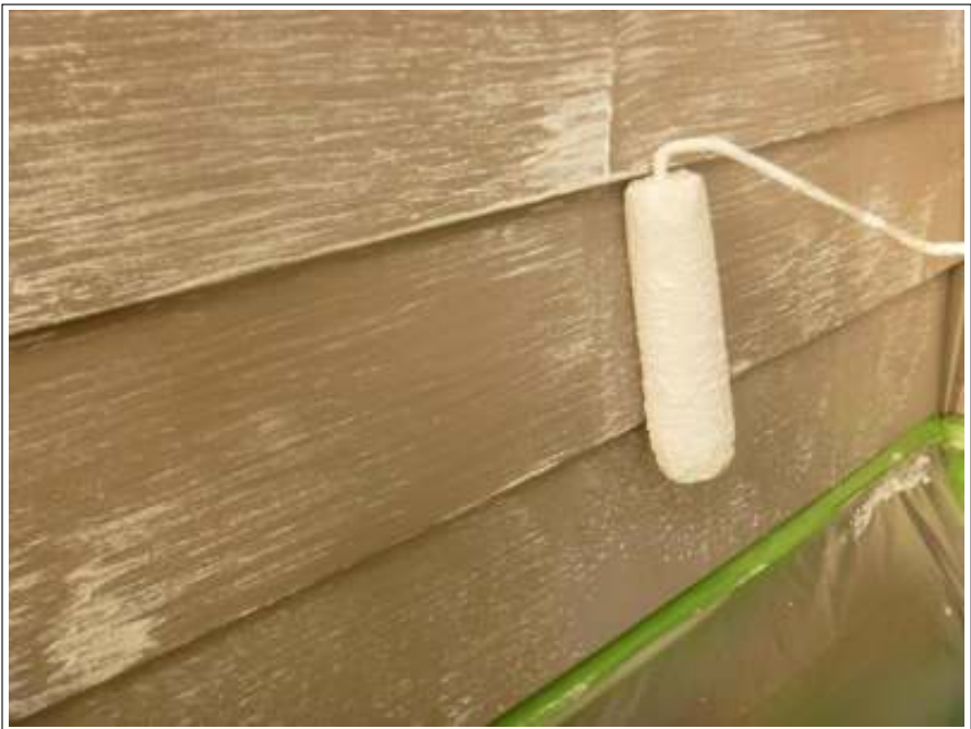
外壁 下塗り施工中
