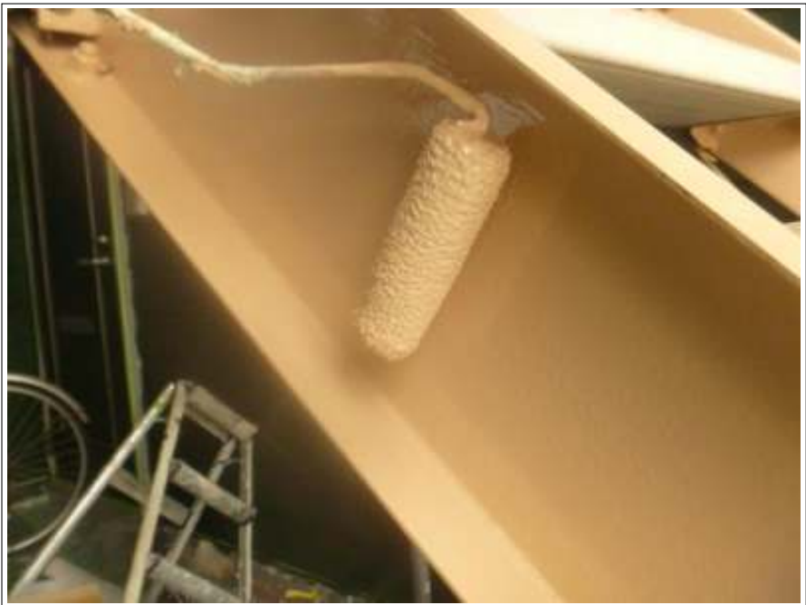
階段 上塗り施工中（2回目）
