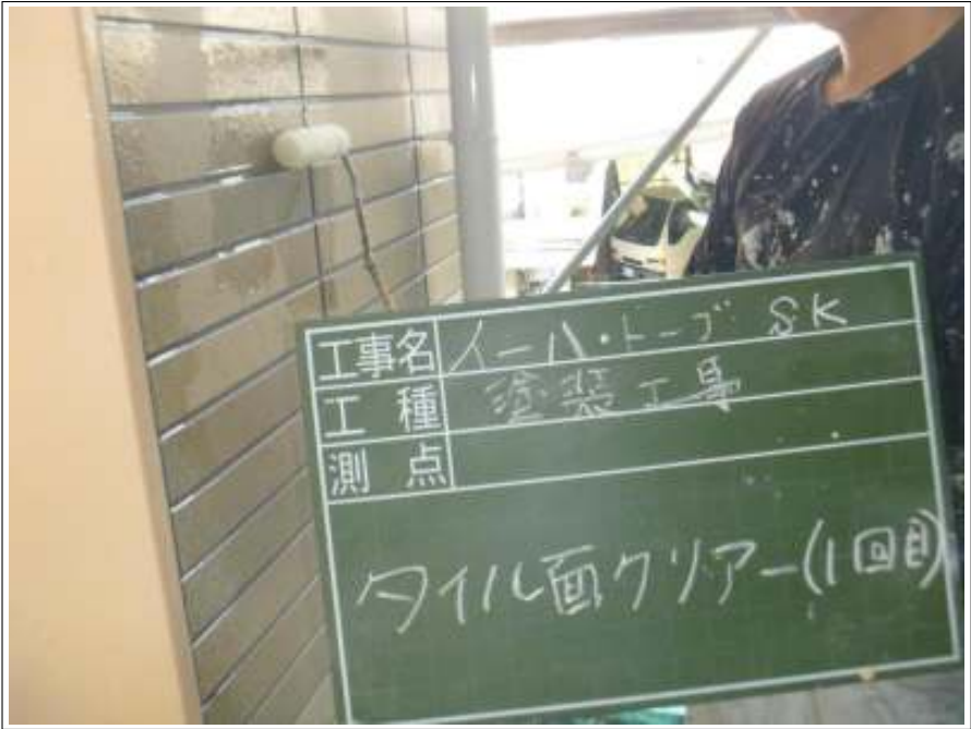
外壁 クリアー塗布施工中（1回目）
