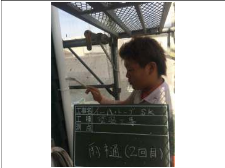
樋 上塗り施工中 (2回目)
