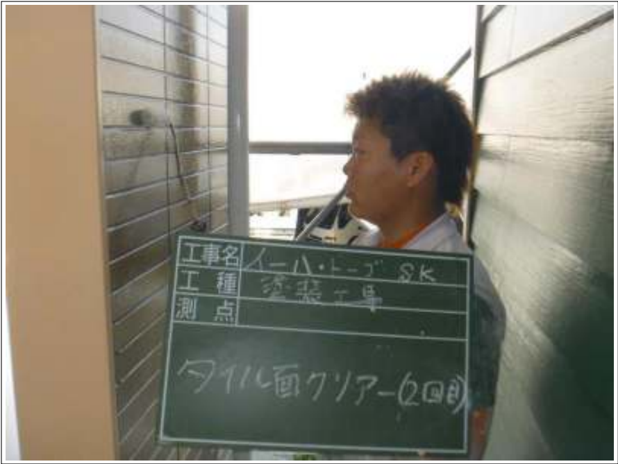
外壁 クリアー塗布施工中（2回目）
