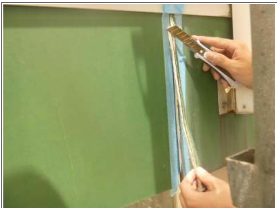
外壁 コーキング撤去施工中
