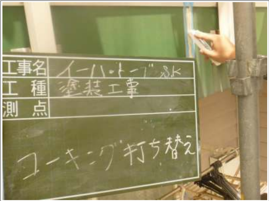
外壁 コーキング打ち替え施工中
