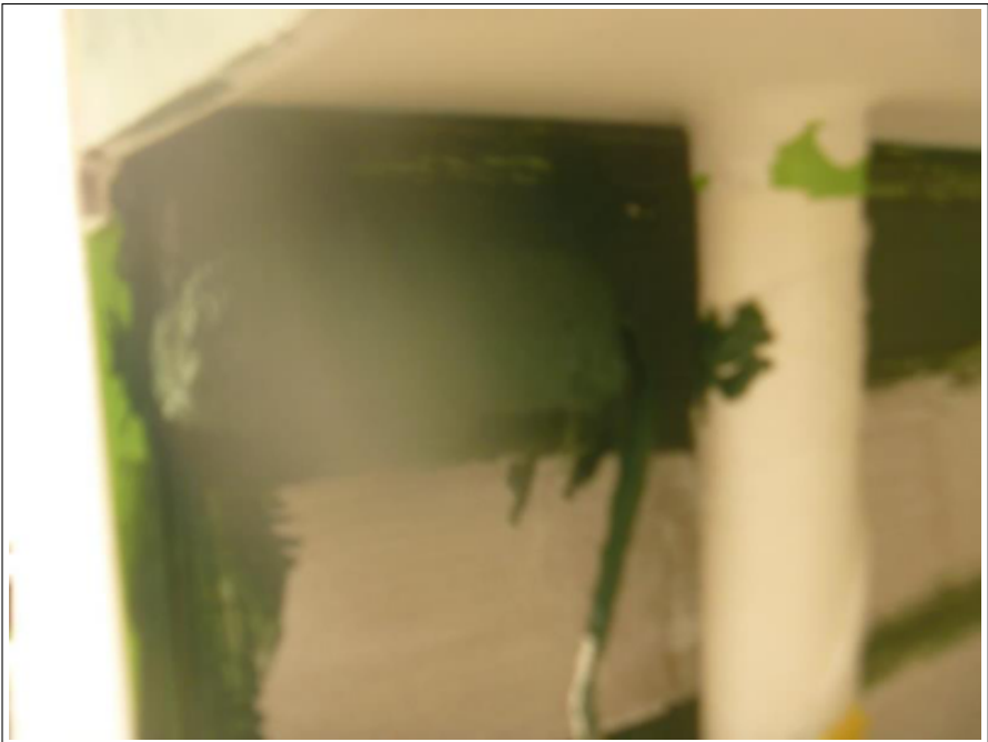
外壁 中塗り施工中
