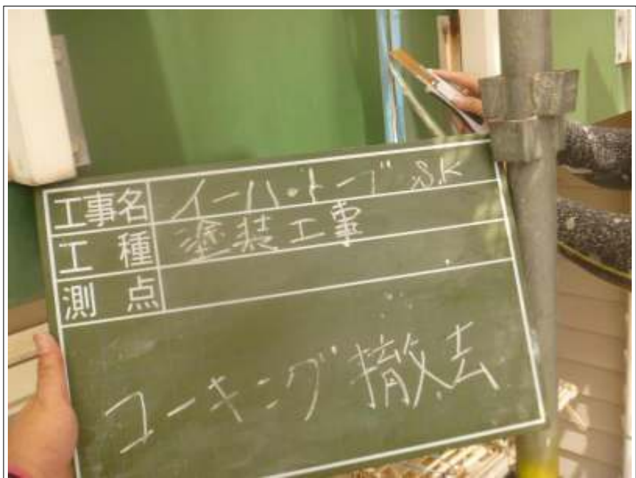
外壁 コーキング撤去施工中
