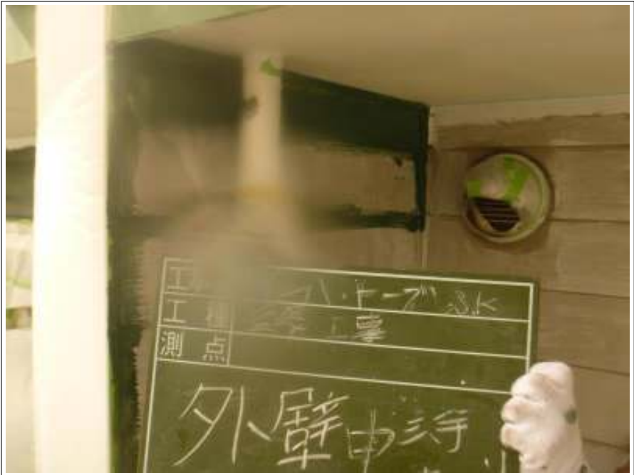
外壁 中塗り施工中
