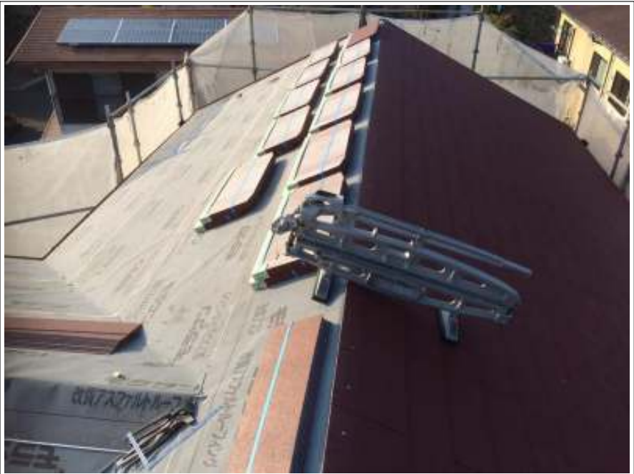
屋根 コロニアルクアット施工中
