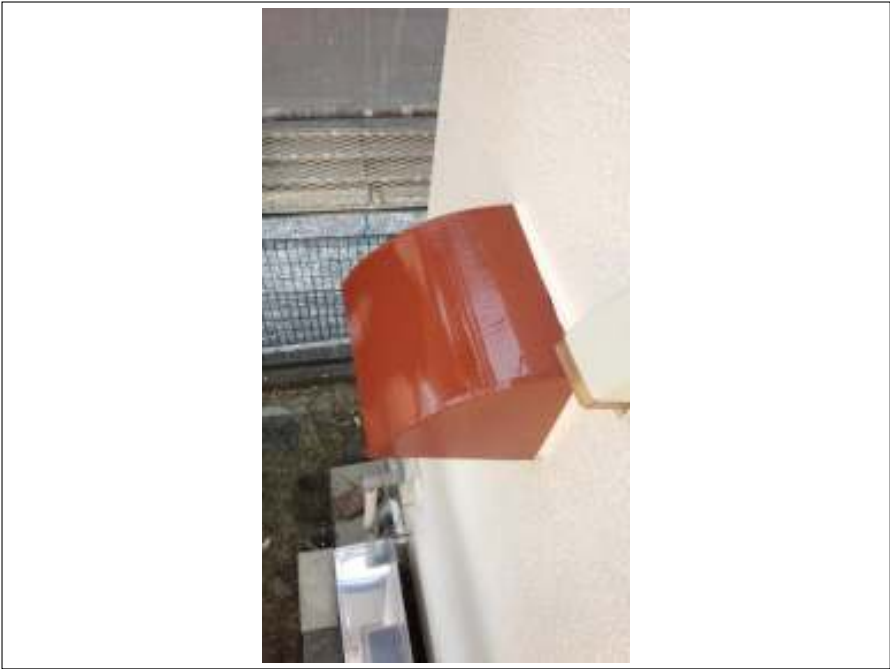
換気フード 施工完了
