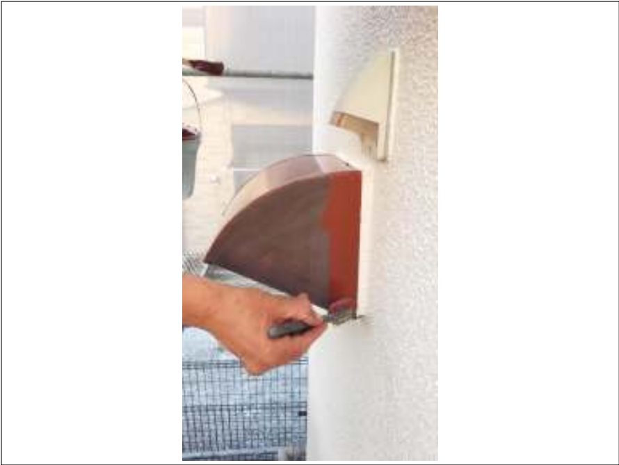
換気フード 中塗り施工中
