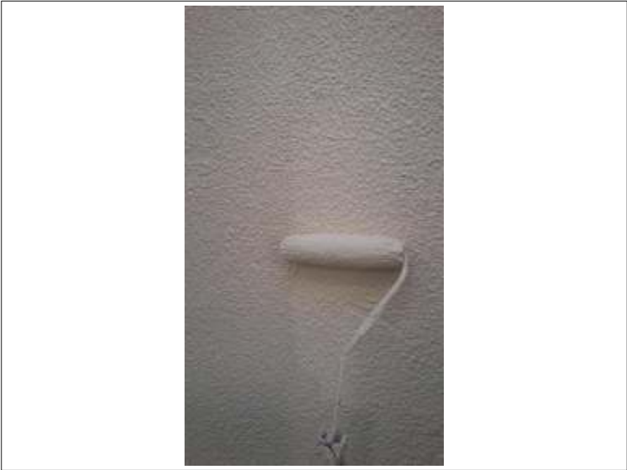
外壁 下地処理施工中
