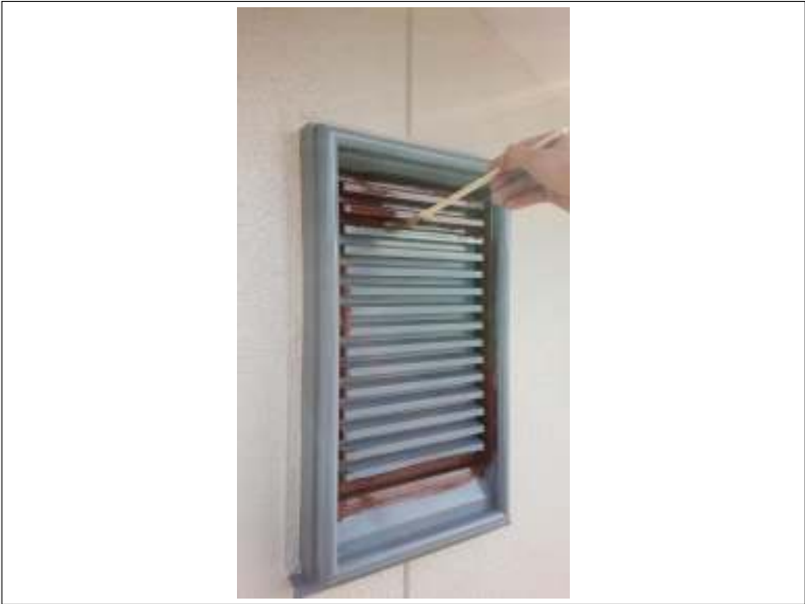
鉄部 中塗り施工中
