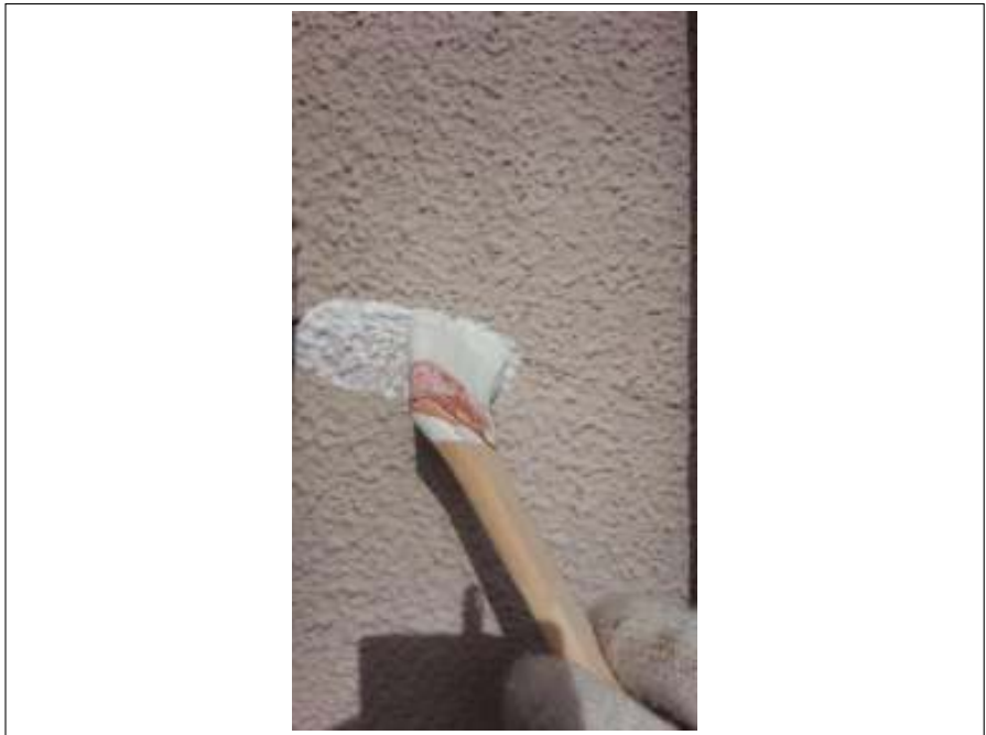
外壁 クラック補修施工中
