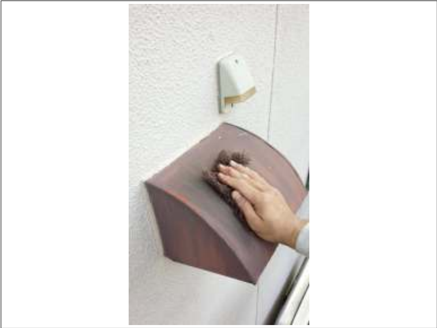
換気フード 下地処理施工中
