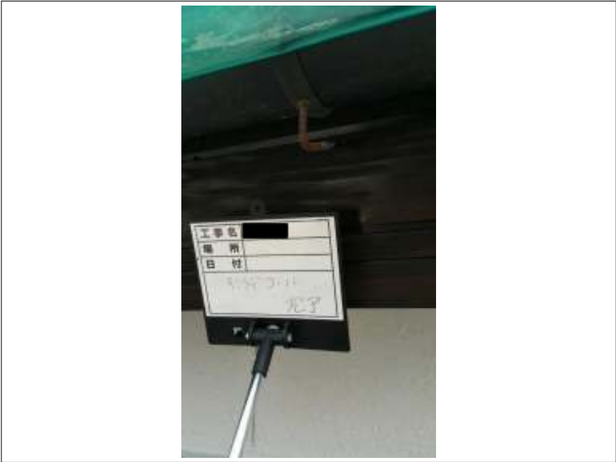
破風 上塗り施工完了
