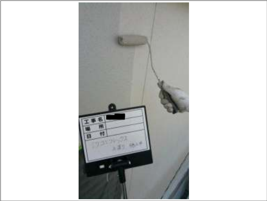
外壁 上塗り施工中
