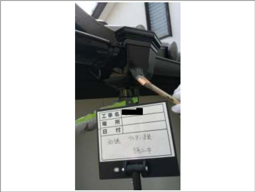
雨樋 上塗り施工中
