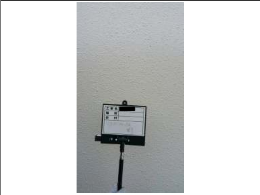
外壁 上塗り施工完了
