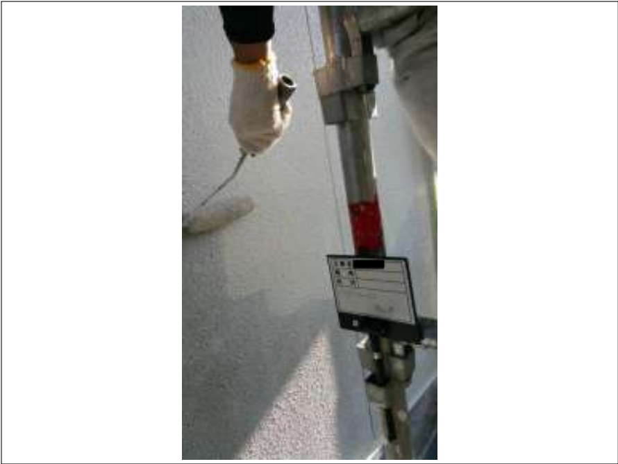
外壁 中塗り施工中
