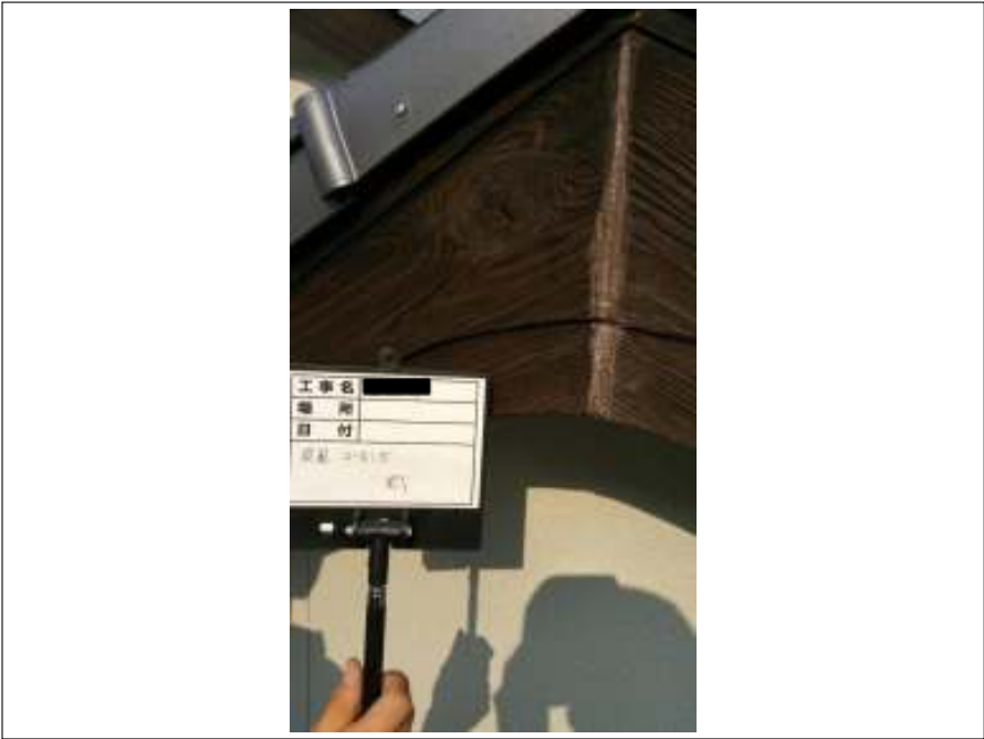
破風 補修施工完了
