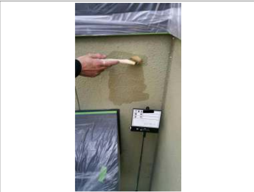
外壁 バリアー塗布施工中
