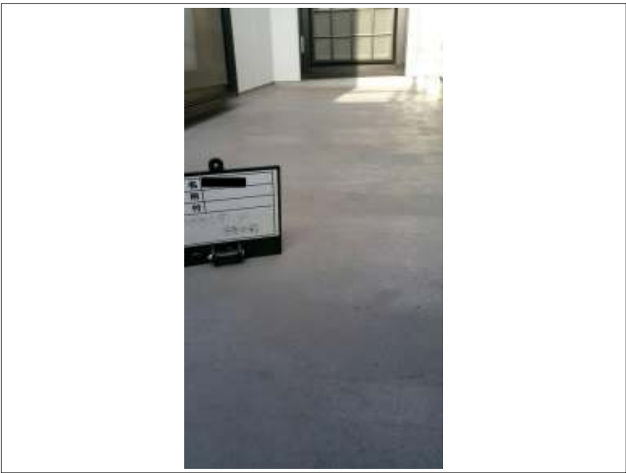
ベランダ 施工前
