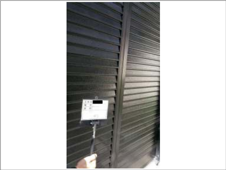
雨戸 施工完了
