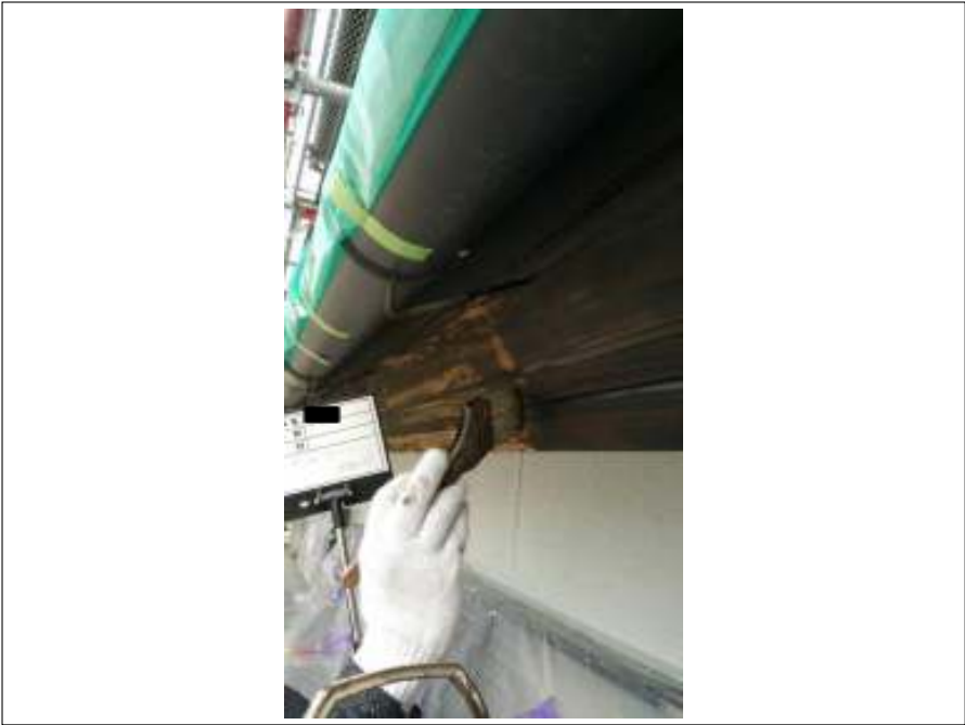
破風 上塗り施工中
