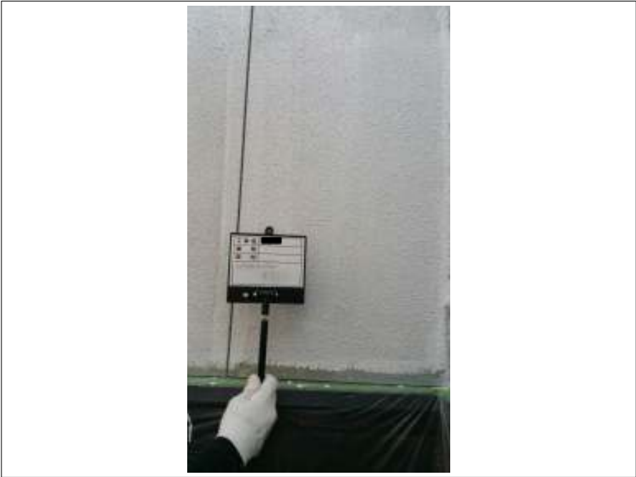
外壁 下塗り施工完了
