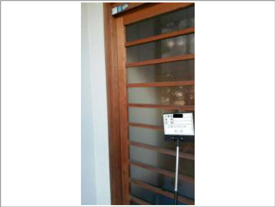
玄関部 施工前
