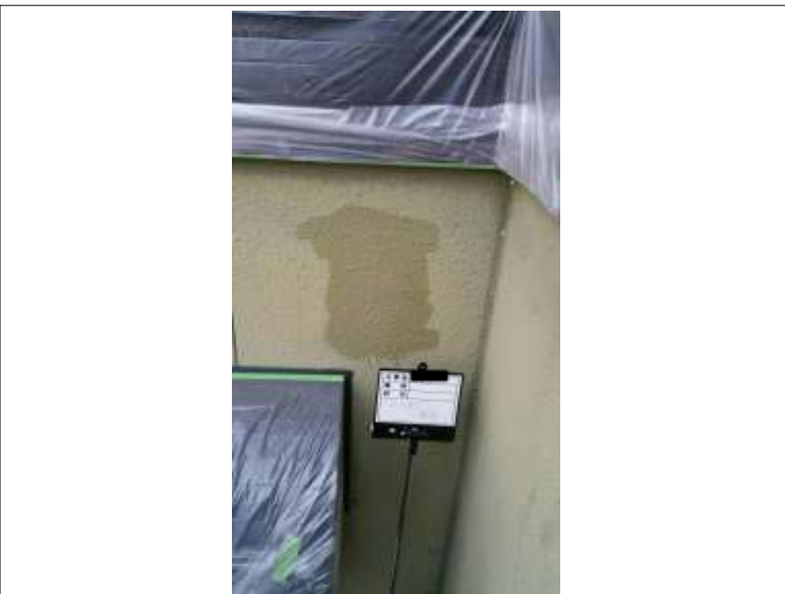
外壁 バリアー塗布施工完了
