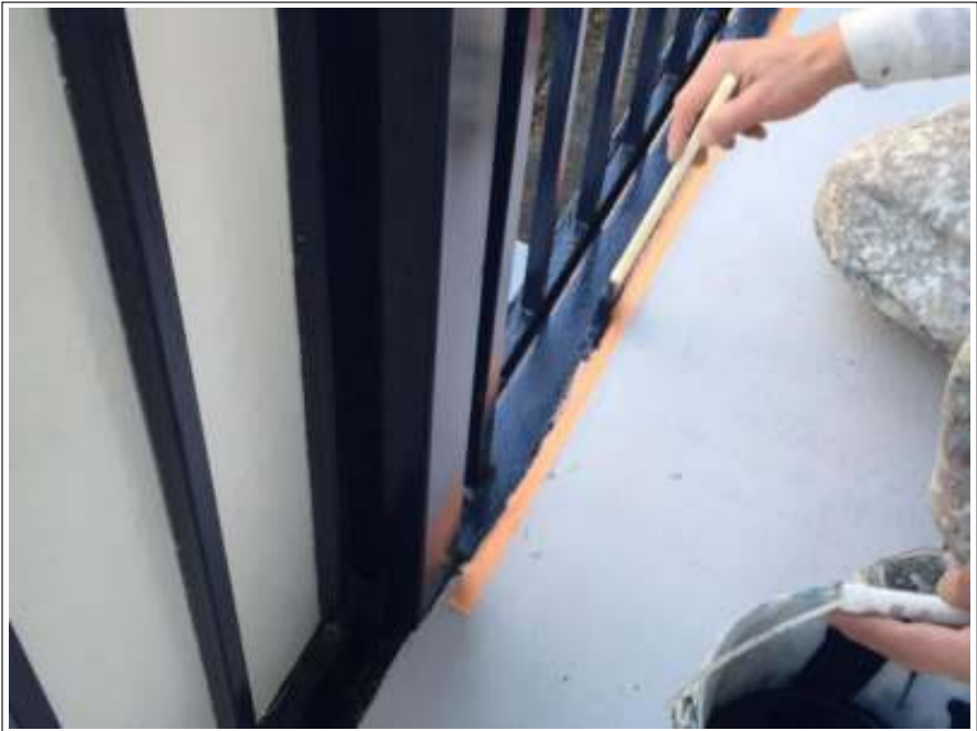
鉄部 上塗り施工中
