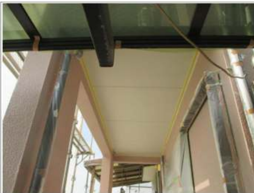
軒天塗装施工完了
