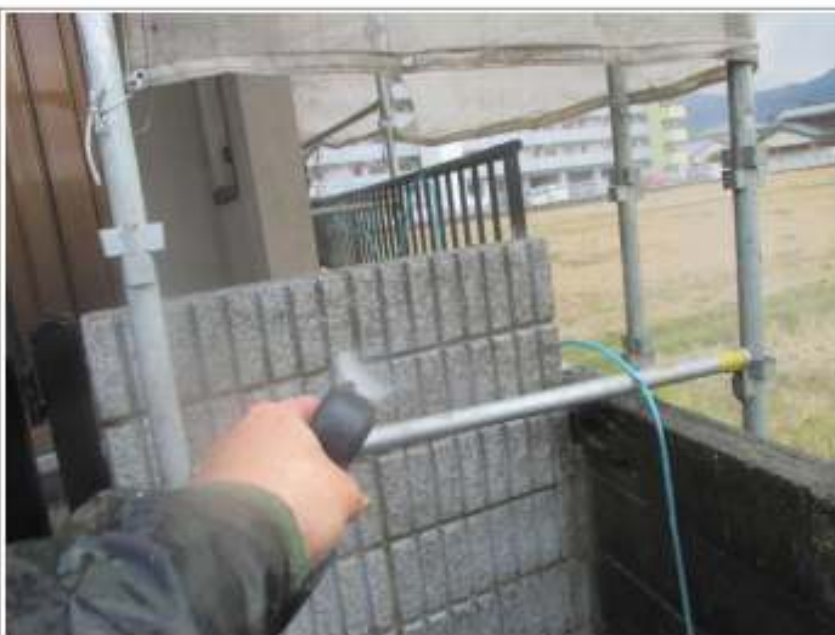
塀高压洗浄施工中
