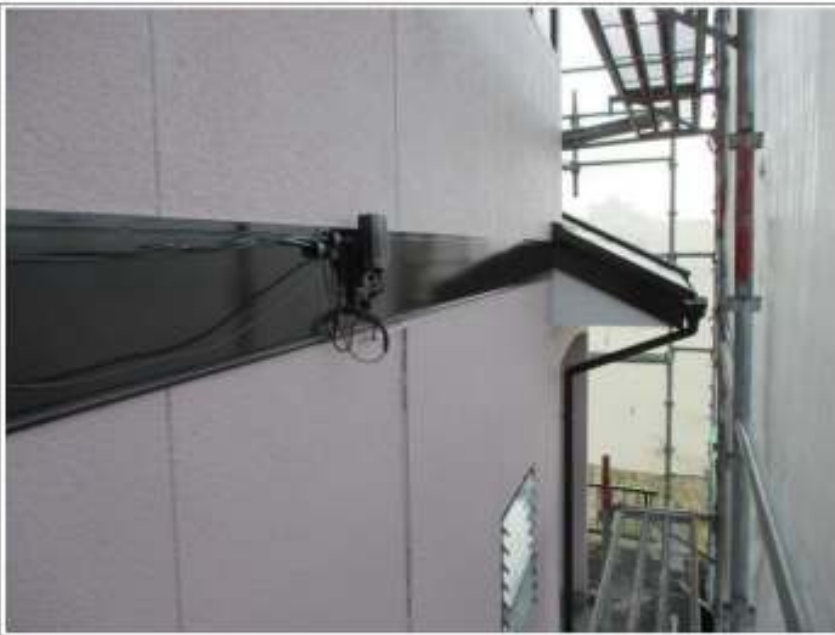
外壁・付帯塗装施工完了
