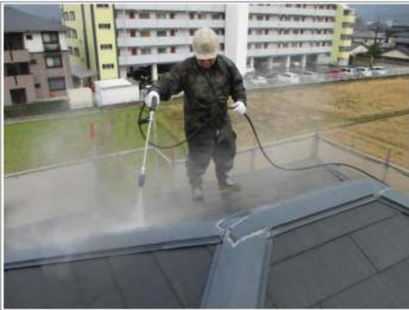
屋根高圧洗浄施工中
