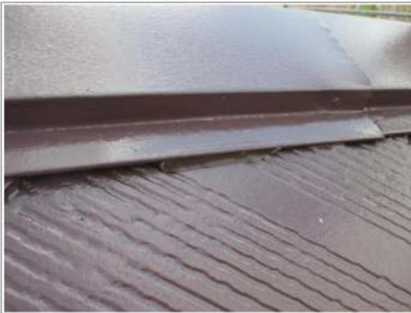
ラバー止め施工完了
