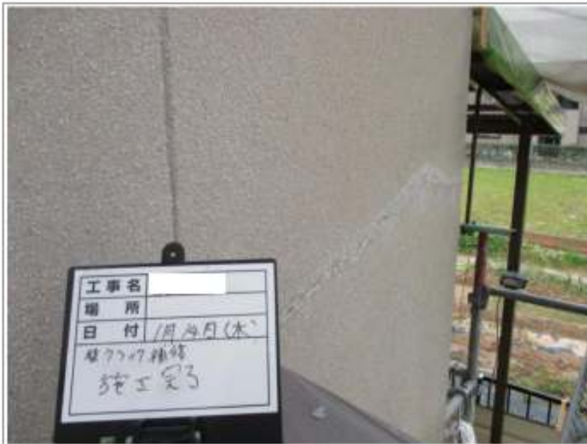
外壁クラック補修施工完了
