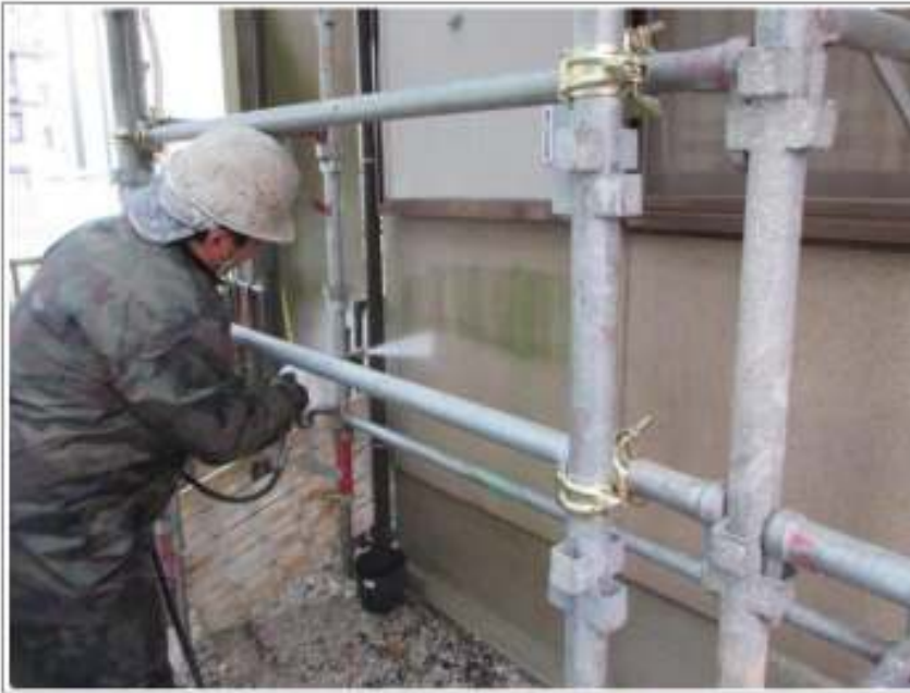
外壁高圧洗浄施工中
