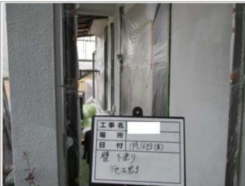
外壁塗装下塗り施工完了
