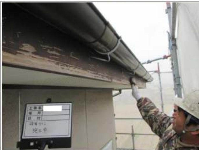
破風板ケレン施工中
