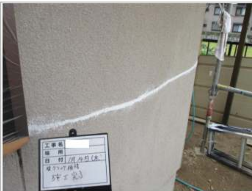
外壁クラック補修施工完了
