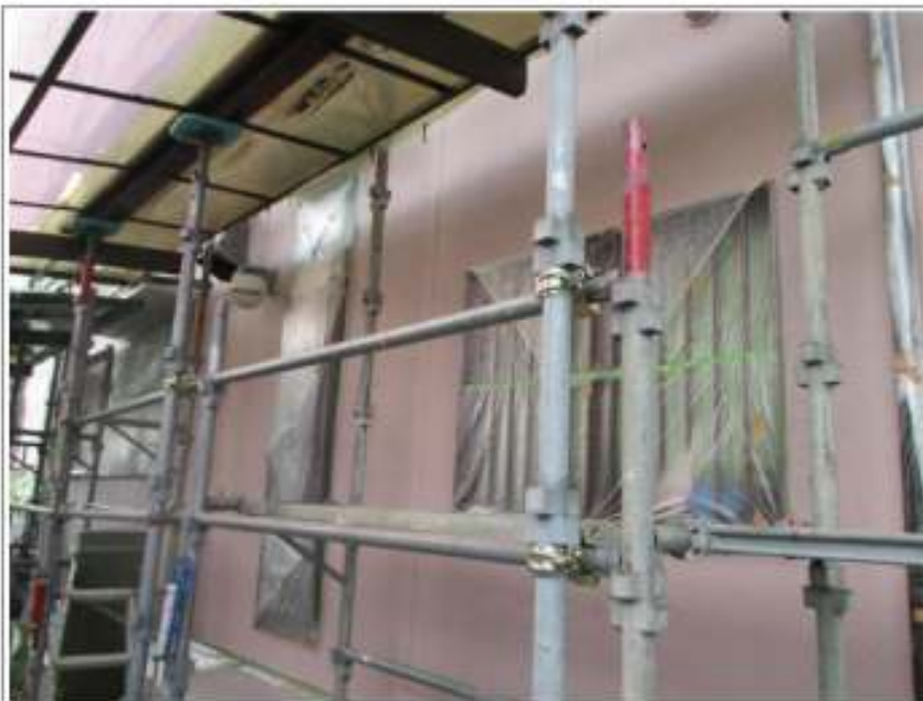
外壁塗装中塗り施工完了
