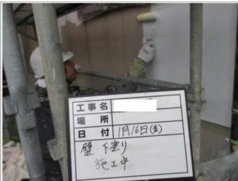
外壁塗装下塗り施工中
