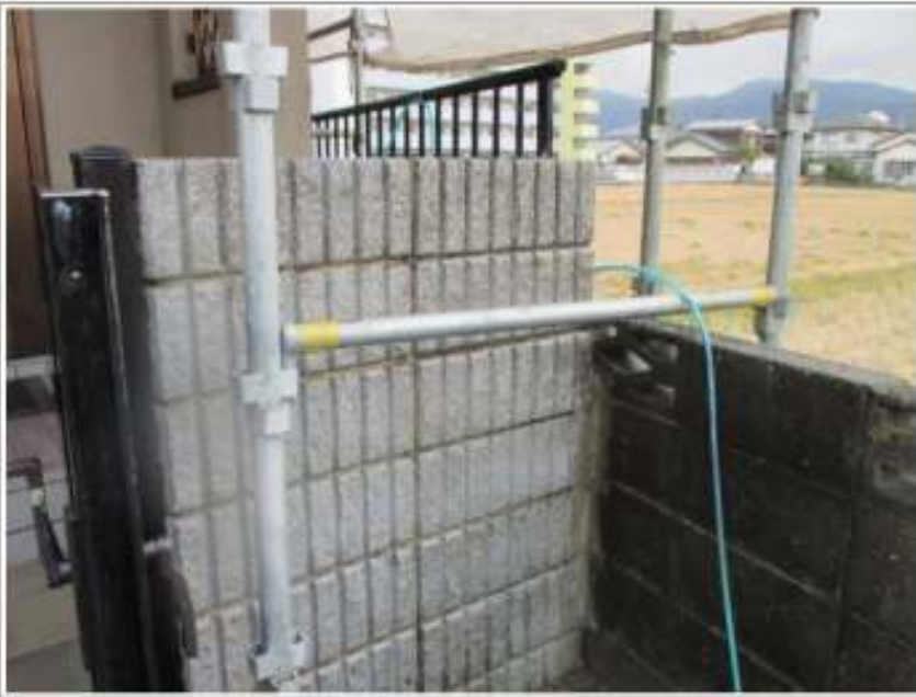
塀高圧洗浄施工完了
