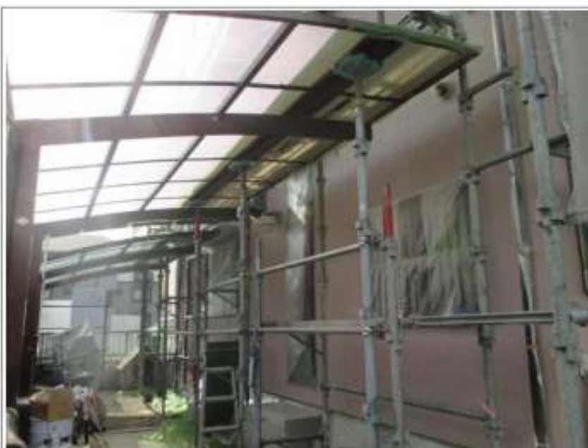
外壁塗装上塗り施工完了
