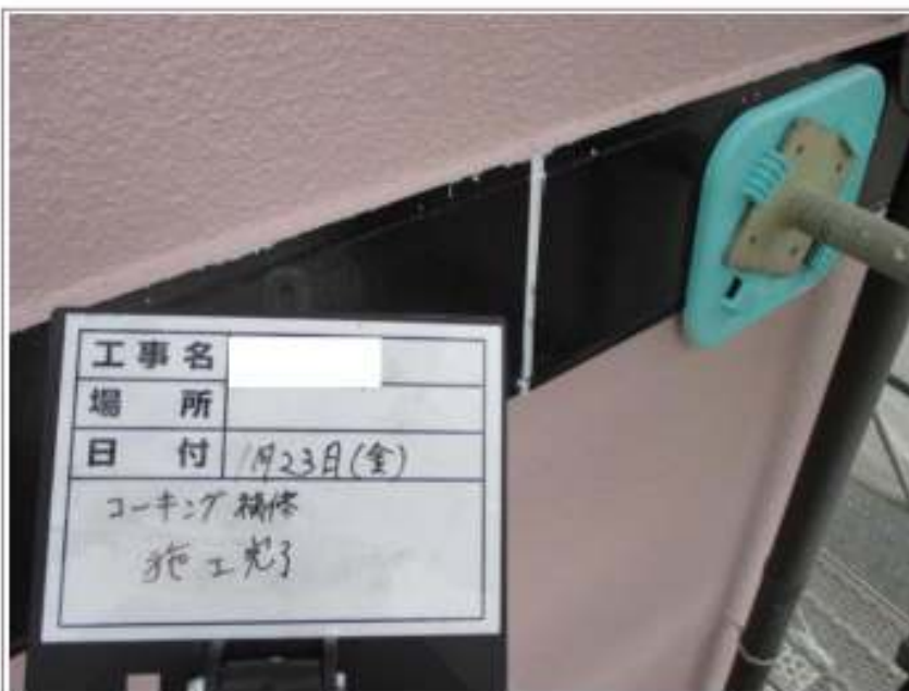
胴差しコーキング補修施工完了
