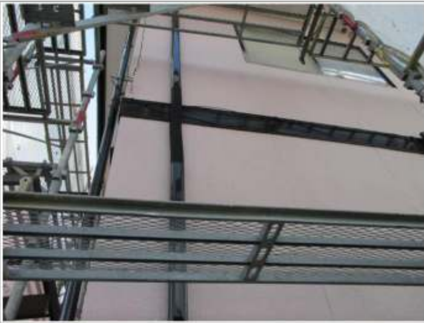
外壁・付帯塗装施工完了
