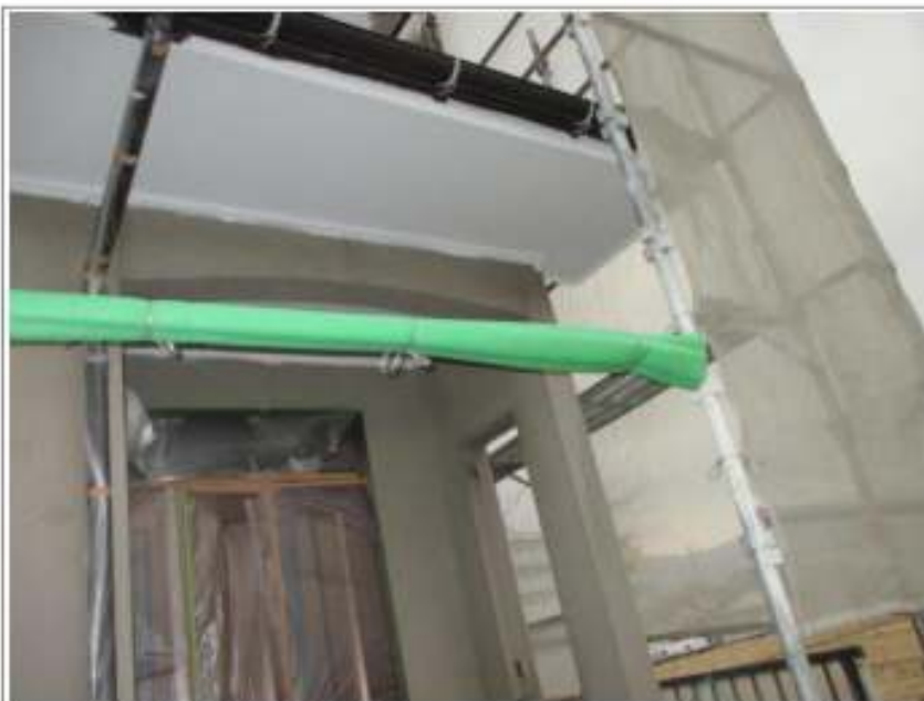
軒天塗装 1 回目施工完了
