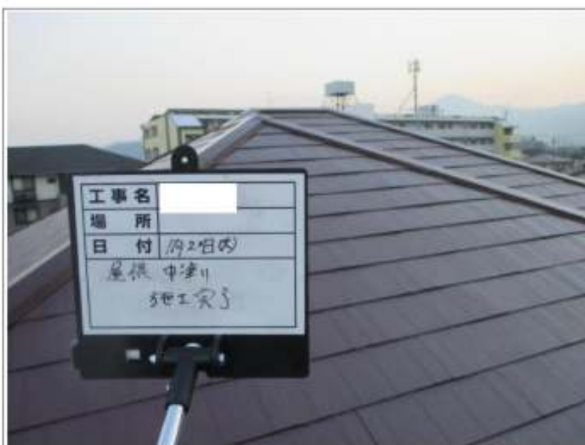
屋根塗装中塗り施工完了
