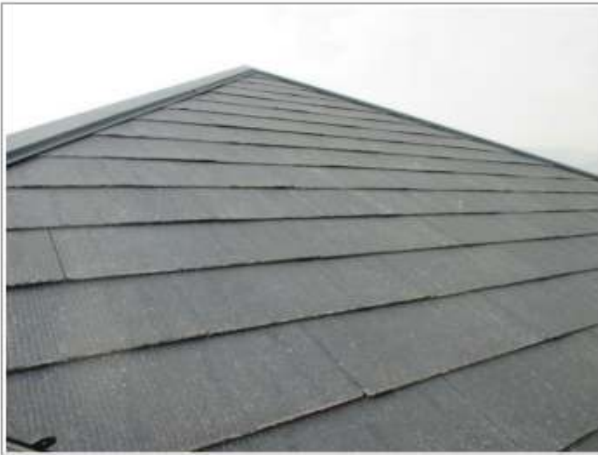
タスペーサー施工完了
