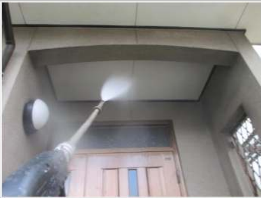
軒天高压洗浄施工中
