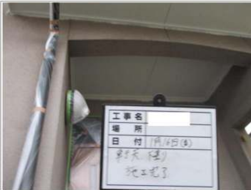
軒天塗装 1 回目施工完了
