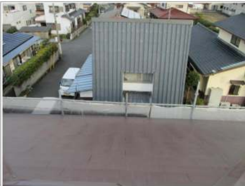
屋根塗装施工完了
