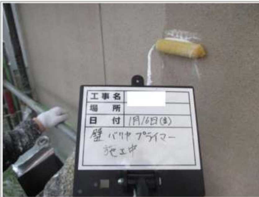
外壁バリアー施工中
