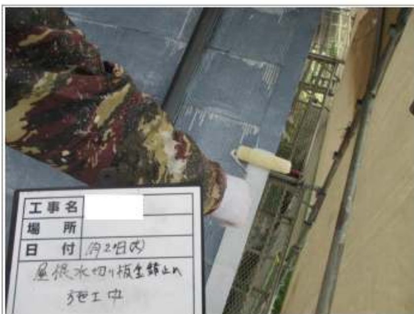
屋根水切り板金サビ止め施工中
