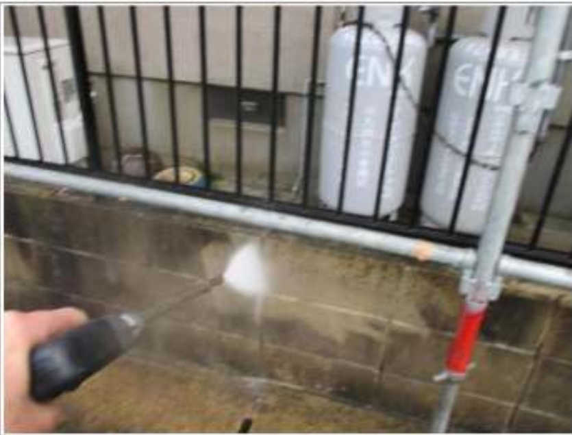
塀高圧洗浄施工中
