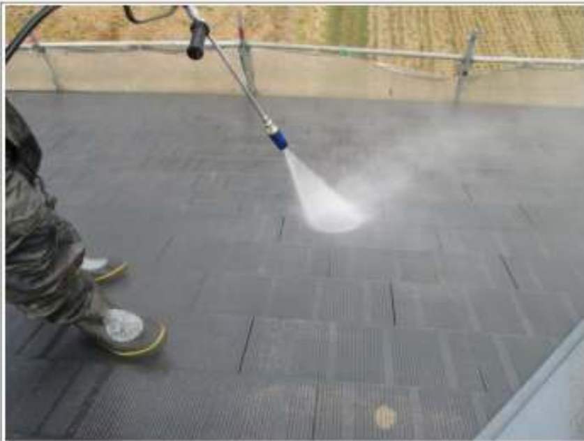
屋根高圧洗浄施工中
