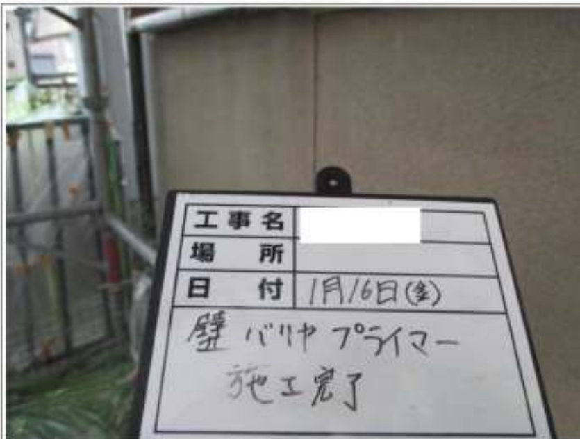
外壁バリアー施工完了
