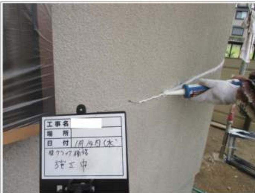
外壁クラック補修施工中
