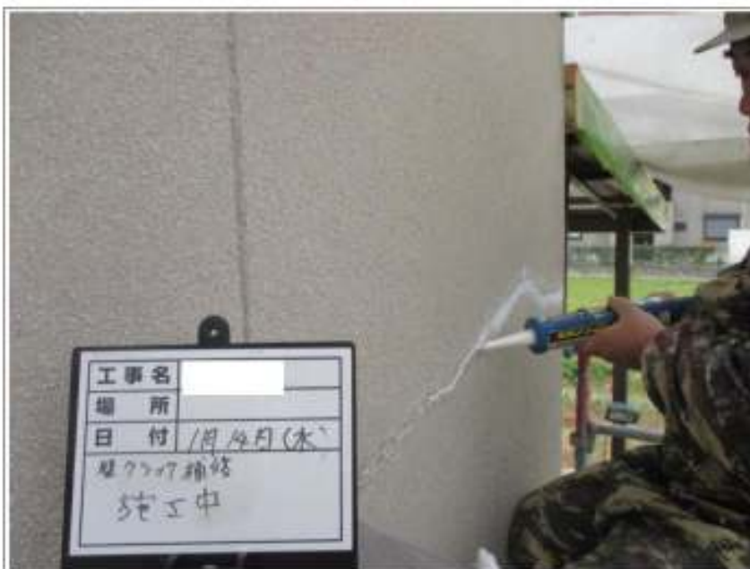
外壁クラック補修施工中
