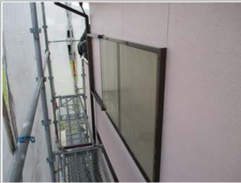
外壁・付帯塗装施工完了
