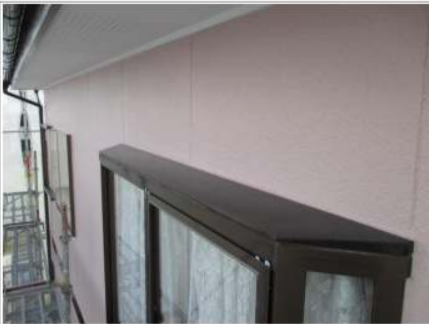
外壁・付帯塗装施工完了
