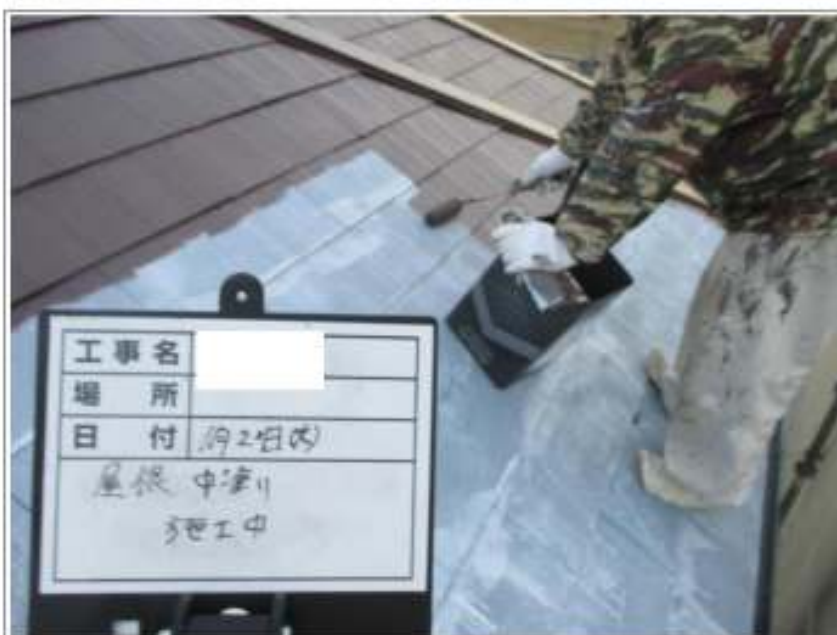
屋根塗装中塗り施工中
