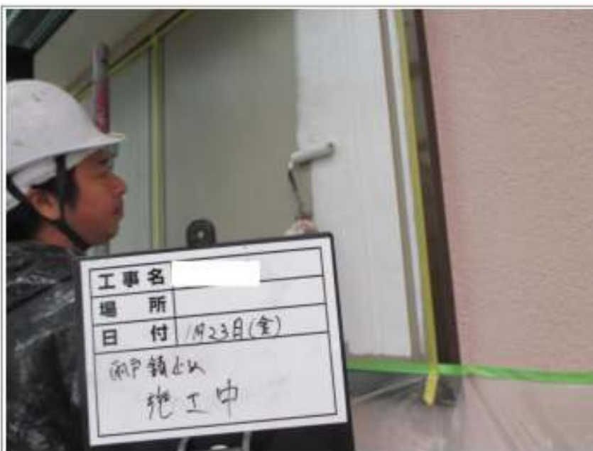
雨戸錆止め施工中
