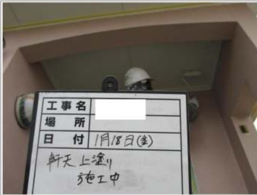
軒天塗装2回目施工中
