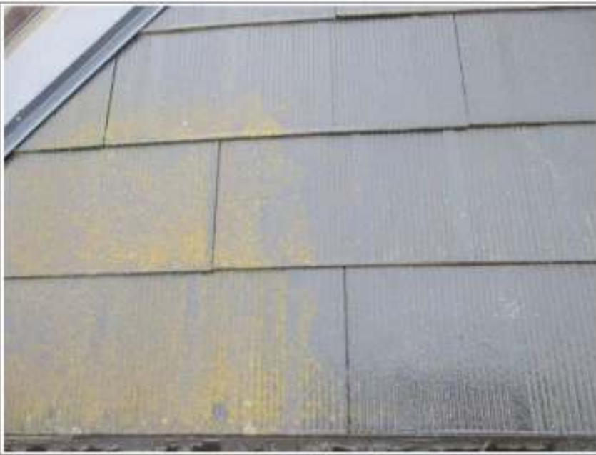
屋根高圧洗浄施工中
