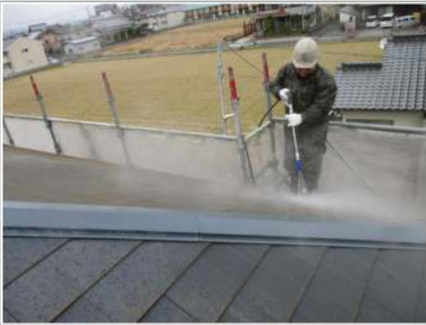
屋根高圧洗浄施工中
