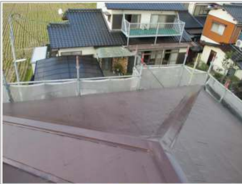
屋根塗装施工完了
