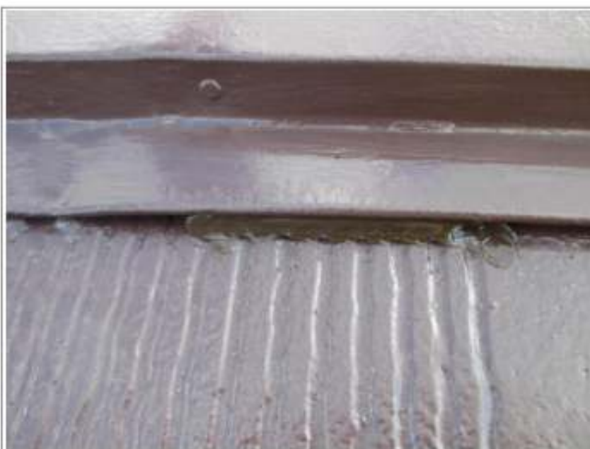
ラバー止め施工完了
