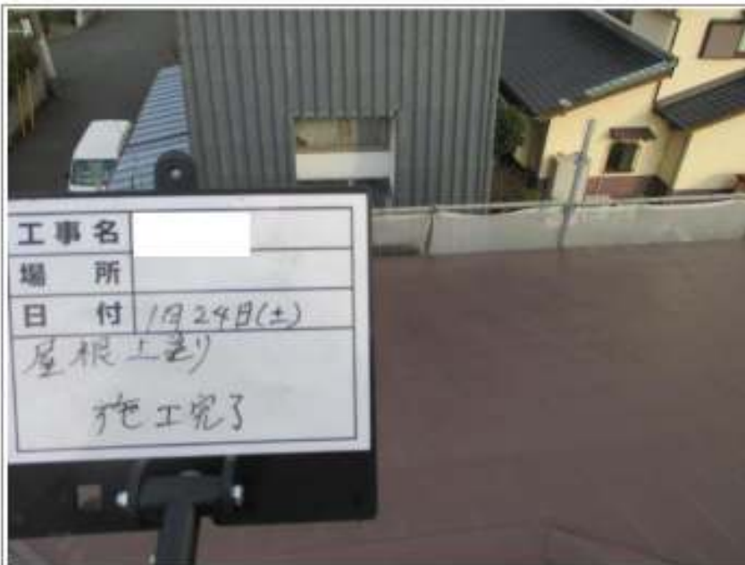
屋根塗装上塗り施工完了
