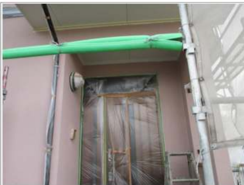
外壁塗装中塗り施工完了
