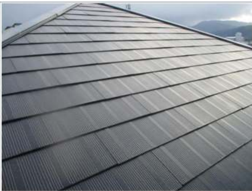
屋根高压洗净施工完了
