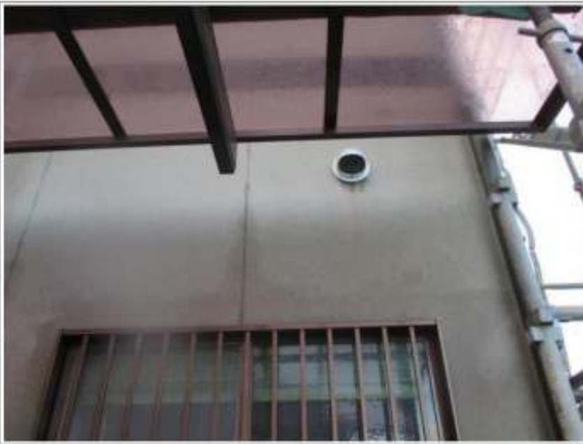
外壁高圧洗浄施工完了
