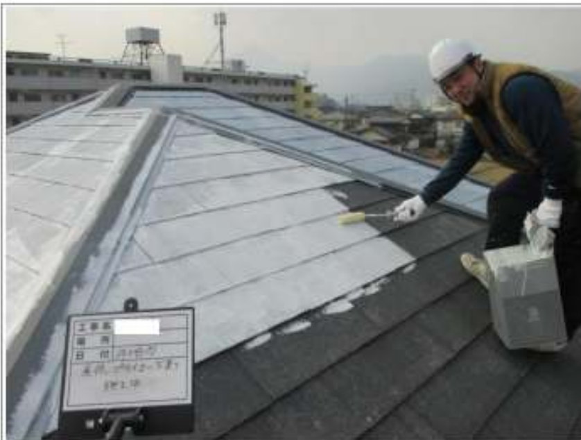
屋根塗装下塗り施工中
