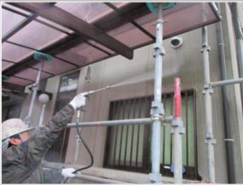
外壁高压洗净施工中
