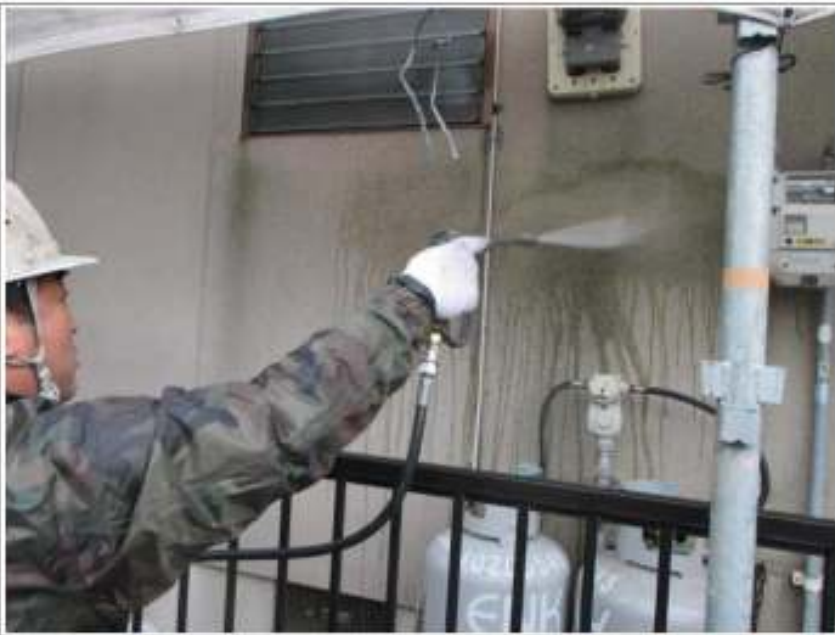
外壁高压洗净施工中
