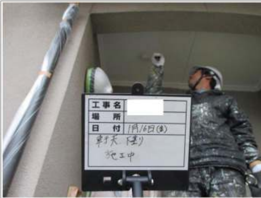
軒天塗装 1 回目施工中
