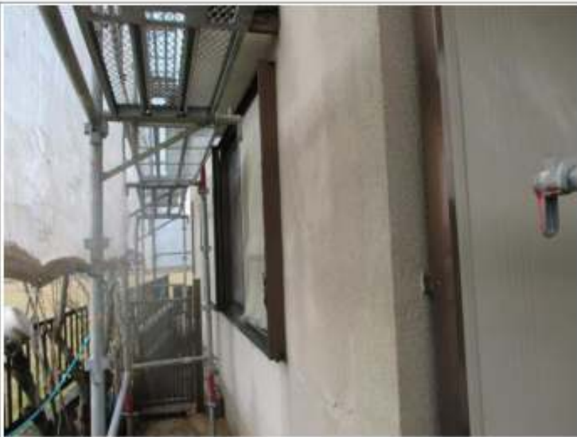
外壁高圧洗浄施工完了
