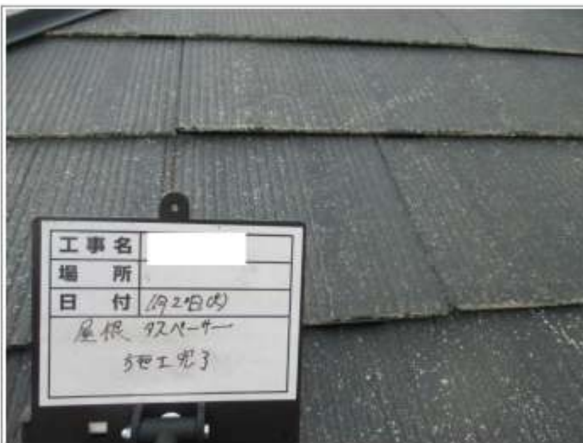
タスペーサー施工完了
