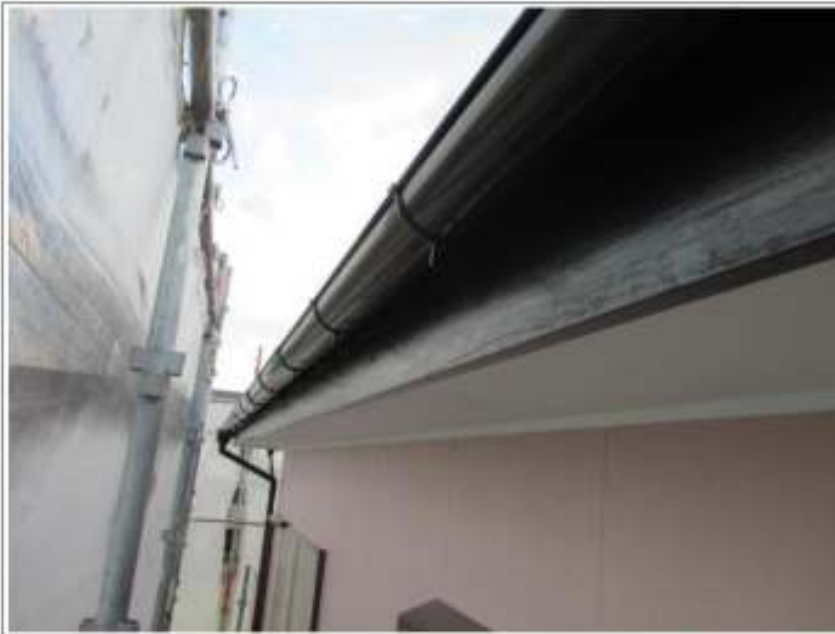
破風板塗装施工完了
