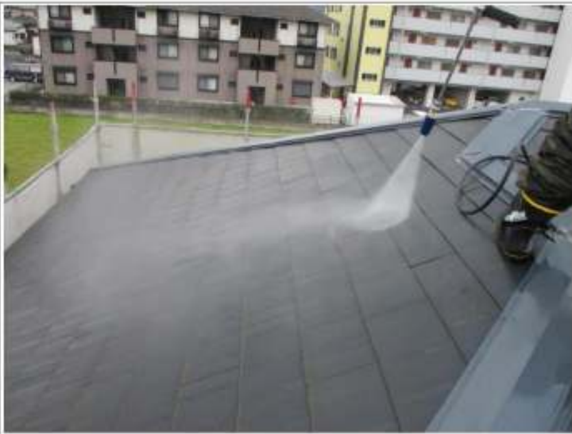
屋根高圧洗浄施工中
