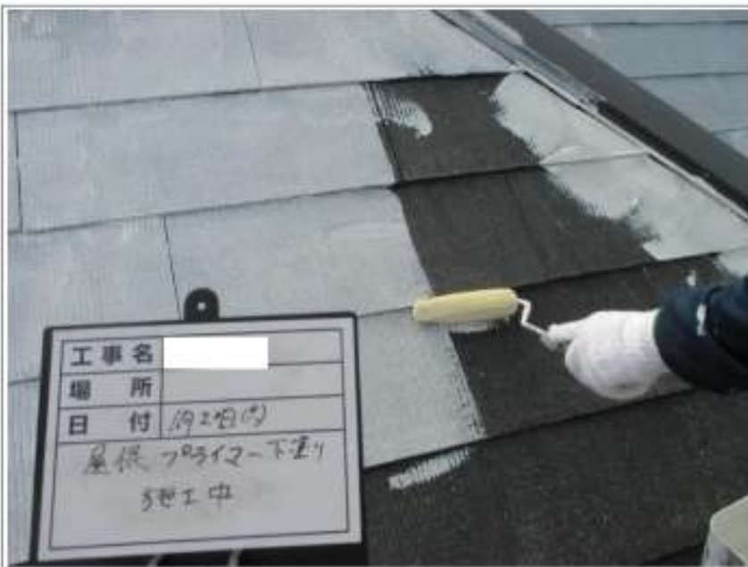
屋根塗装下塗り施工中
