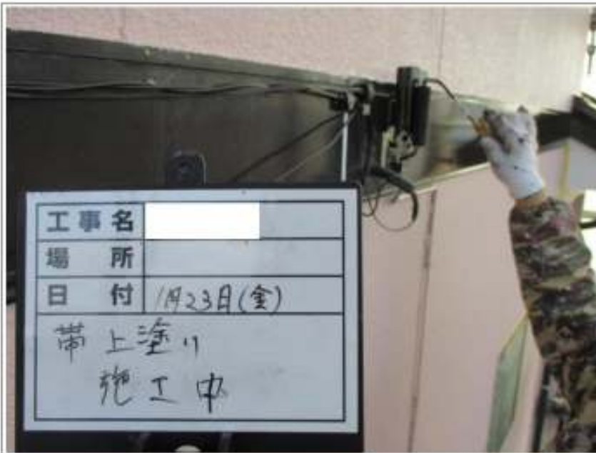
胴差し塗装施工中
