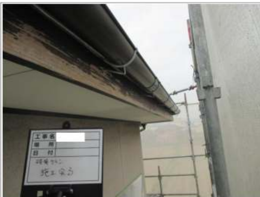
破風板ケレン施工完了
