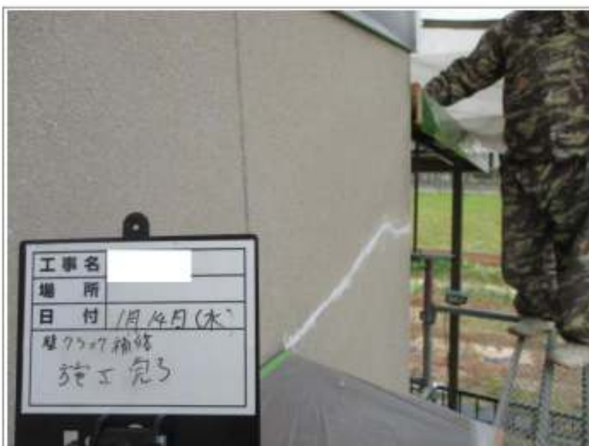
外壁クラック補修施工完了
