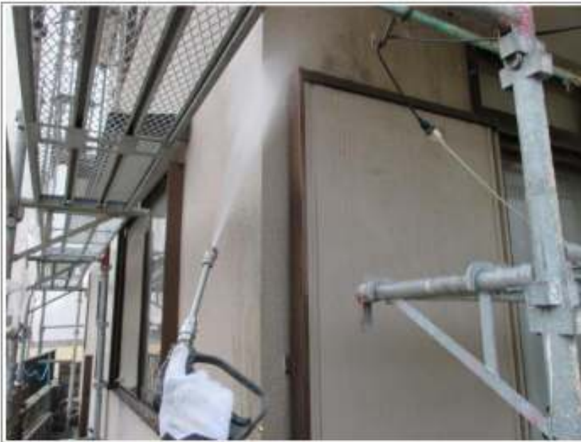
外壁高圧洗浄施工中
