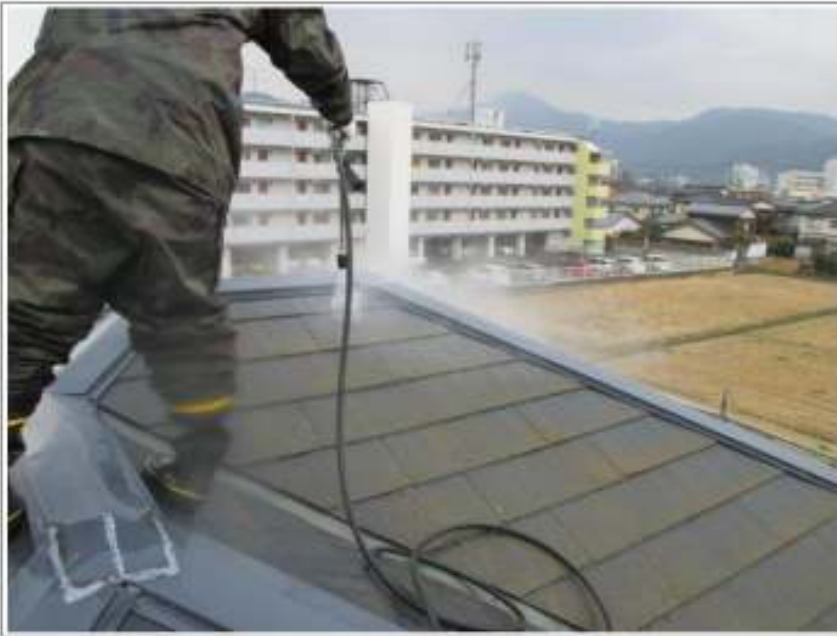
屋根高圧洗浄施工中
