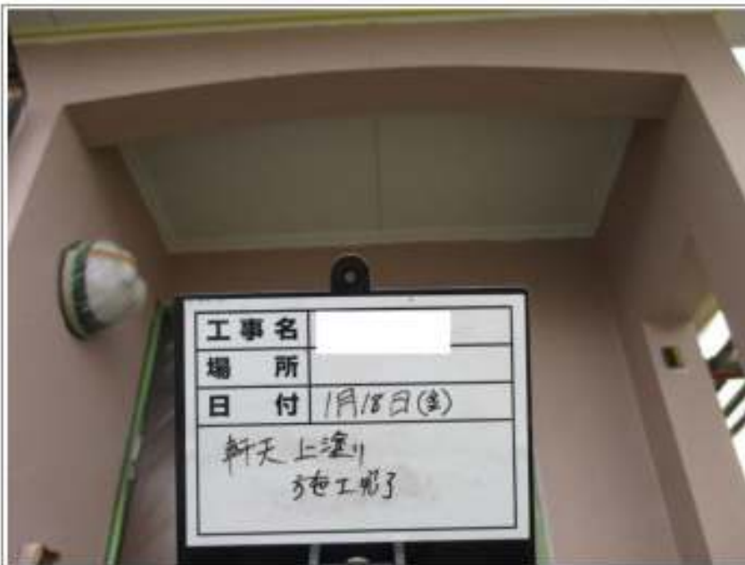
軒天塗装施工完了
