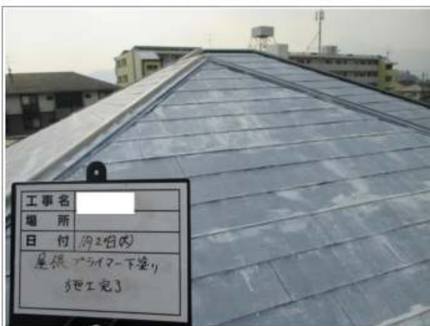
屋根塗装下塗り施工完了
