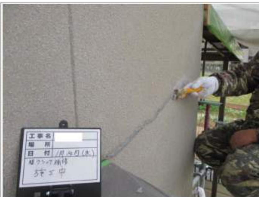
外壁クラック補修施工中
