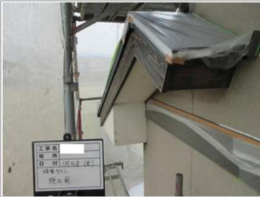
破風板ケレン施工前
