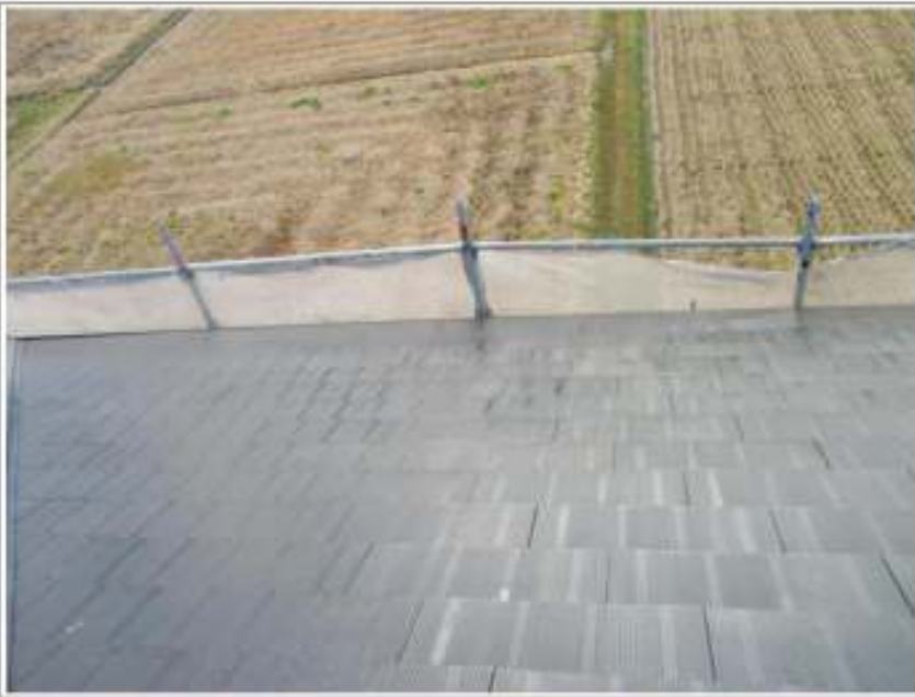
屋根高压洗净施工完了
