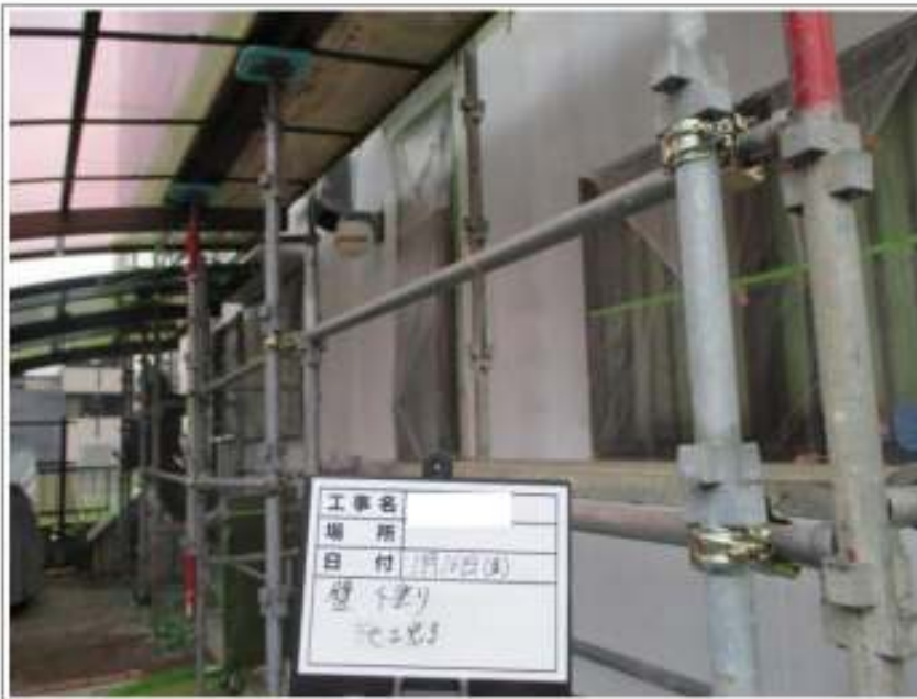
外壁塗装下塗り施工完了
