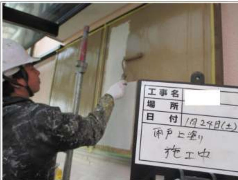
雨戸塗装施工中
