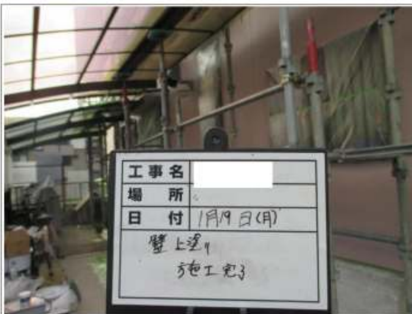
外壁塗装上塗り施工完了
