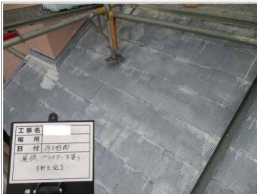
屋根塗装下塗り施工完了
