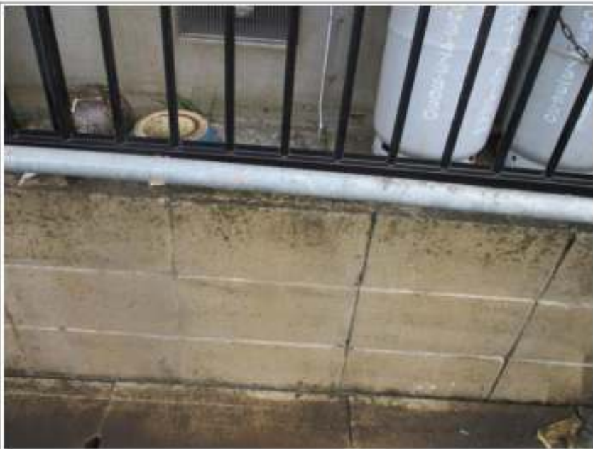
塀高圧洗浄施工完了
