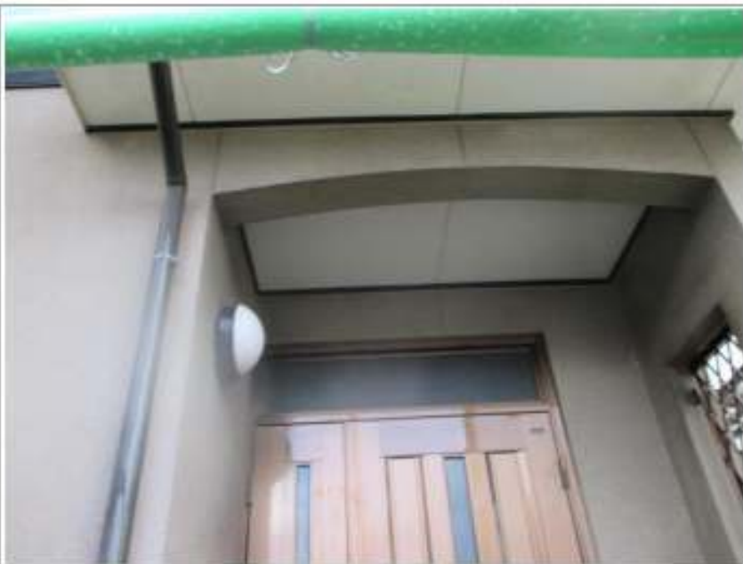
軒天高压洗浄施工完了
