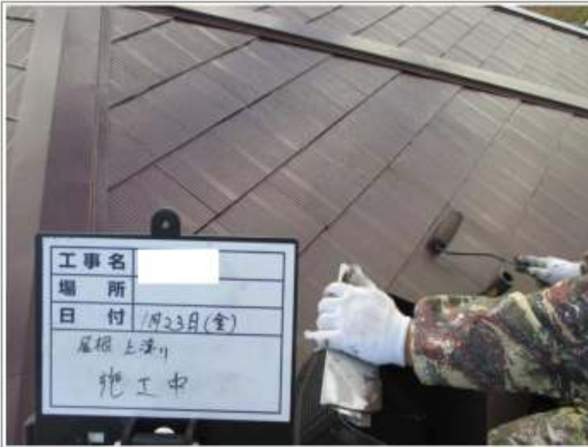
屋根塗装上塗り施工中
