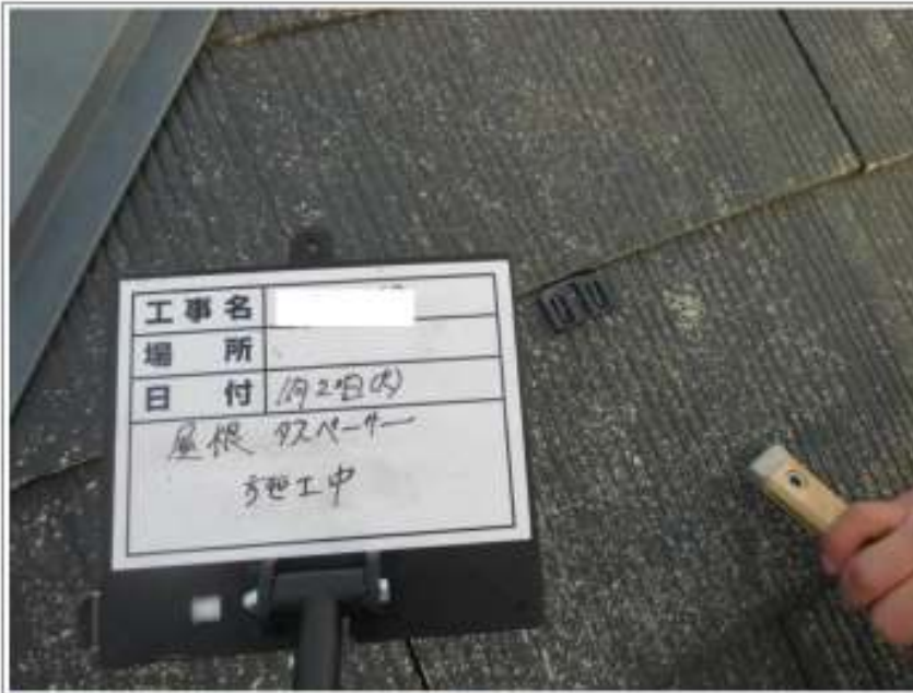
タスペーサー施工中
