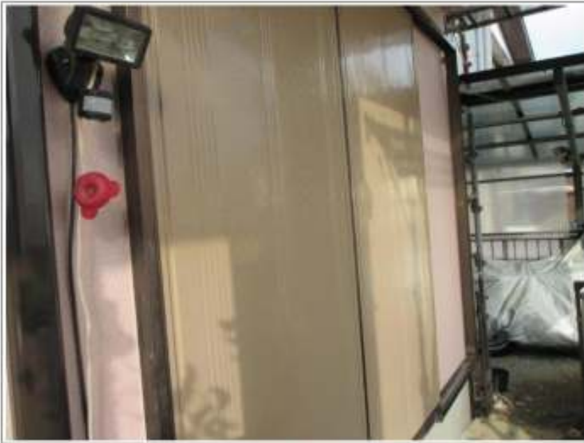
雨戸塗装施工完了
