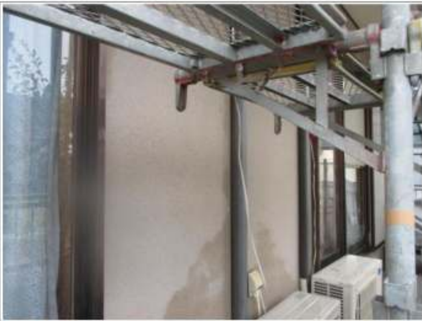
外壁高圧洗浄施工完了
