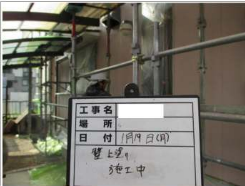
外壁塗装上塗り施工中
