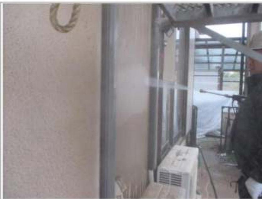
外壁高圧洗浄施工中
