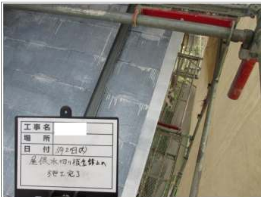
屋根水切り板金サビ止め施工完了
