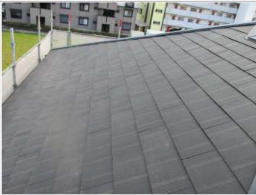
屋根高压洗净施工完了
