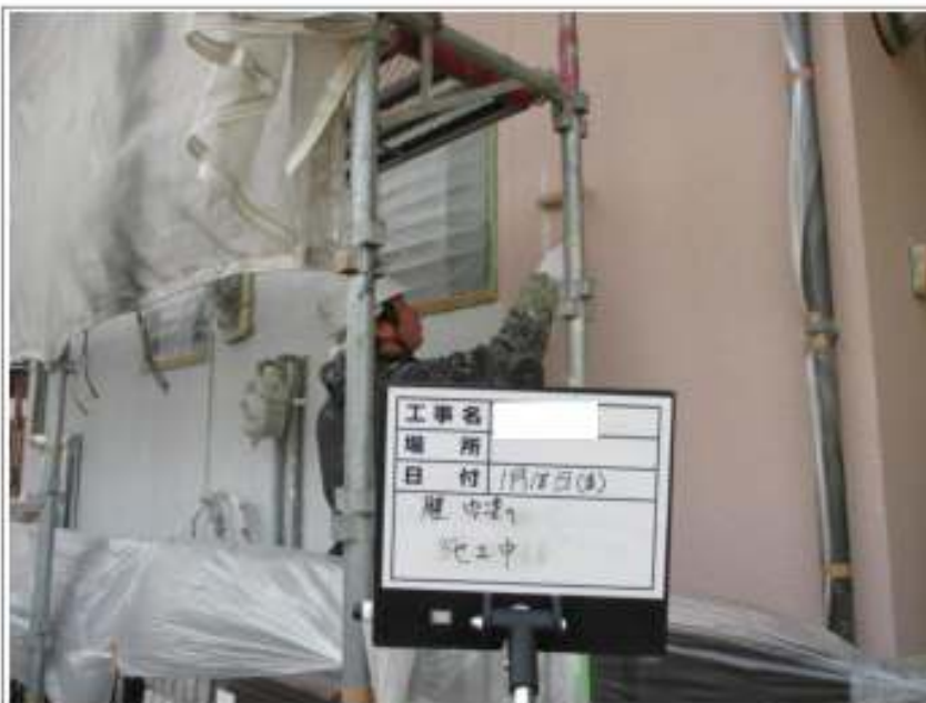
外壁塗装中塗り施工中
