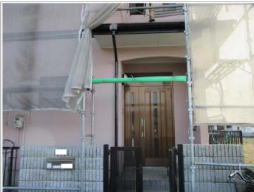
外壁・付帯塗装施工完了
