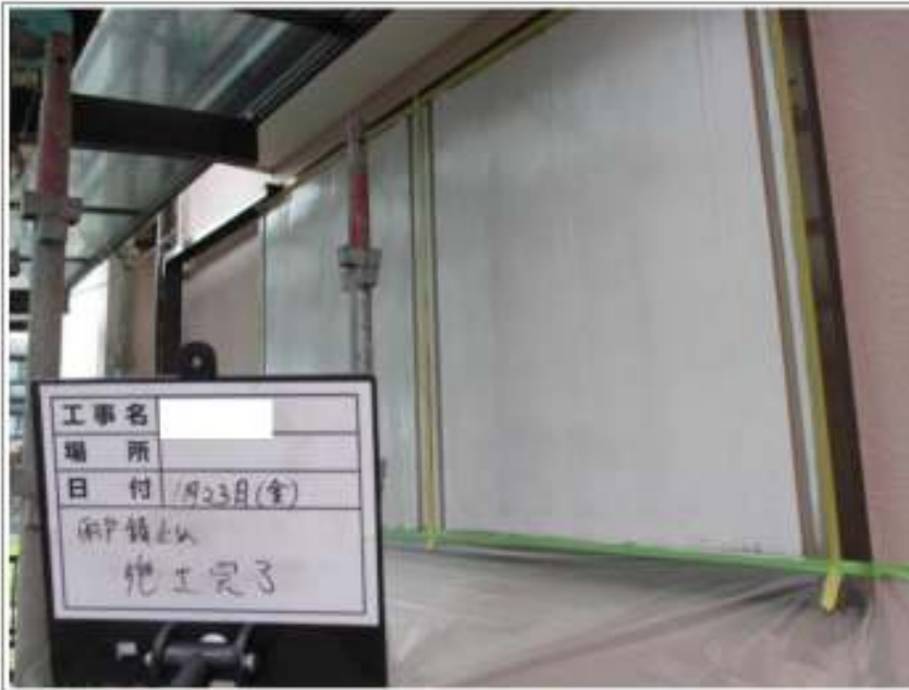
雨戸サビ止め施工完了
