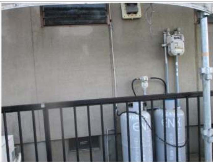
外壁高压洗净施工完了
