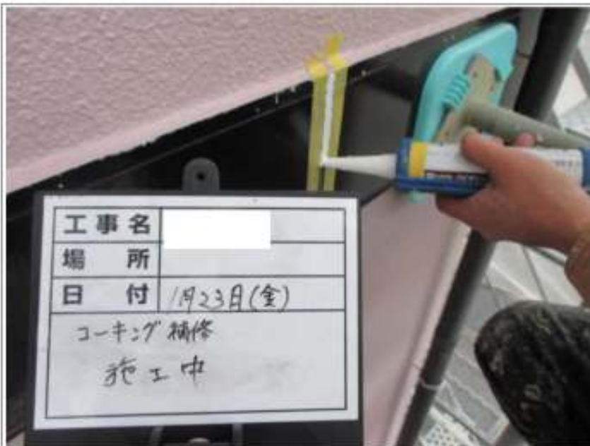
胴差しコーキング補修施工中
