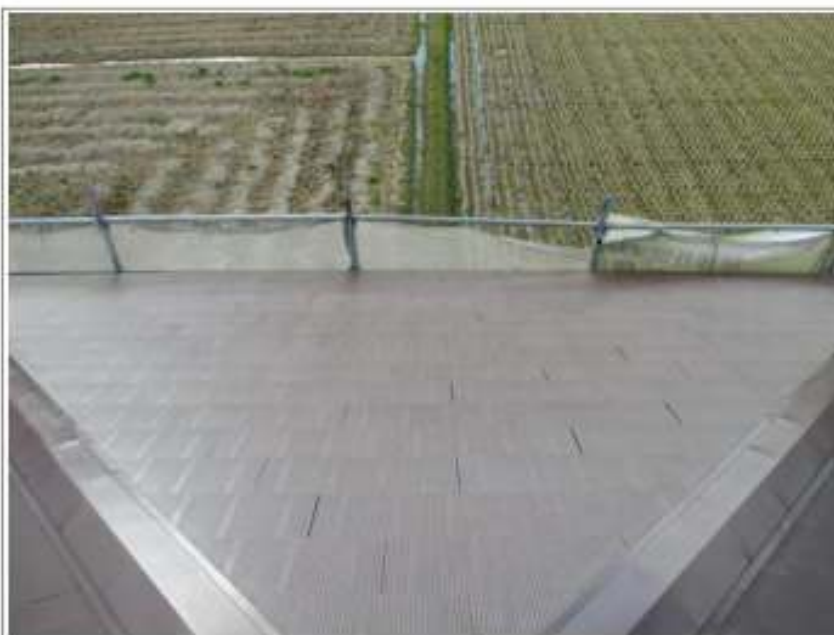
屋根塗装施工完了
