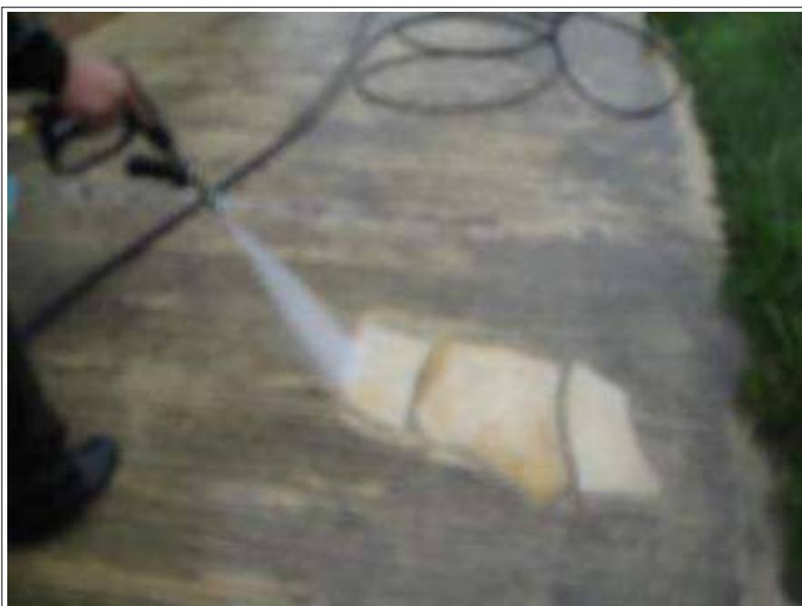
土間 高圧洗浄中
