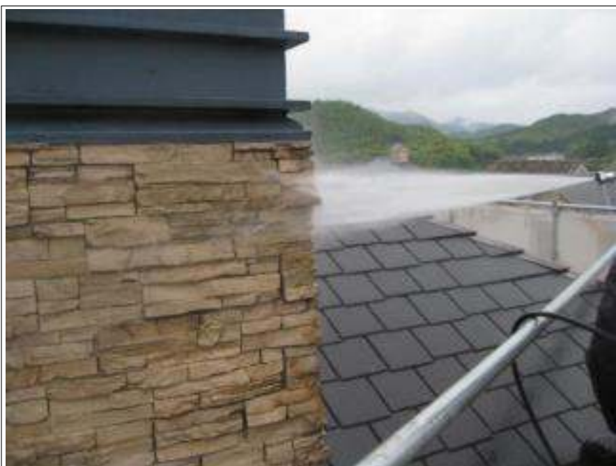
煙突 高圧洗浄中
