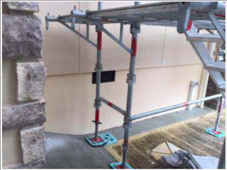
基礎 施工完了
