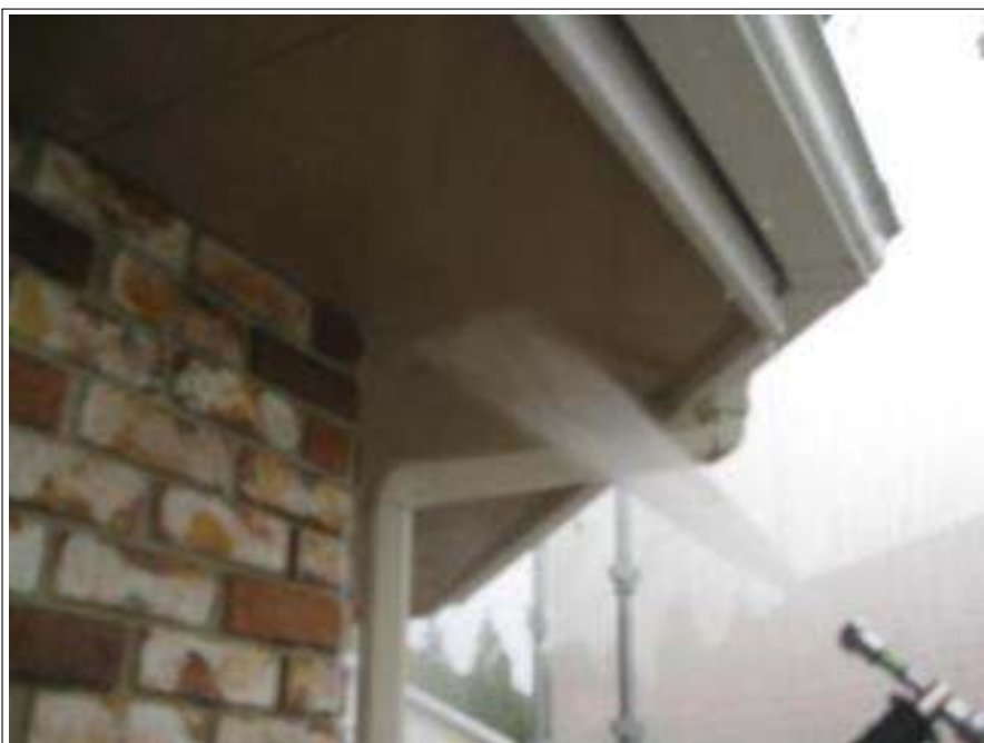
軒天 高圧洗浄中
