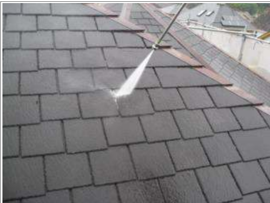
屋根 高圧洗浄中
