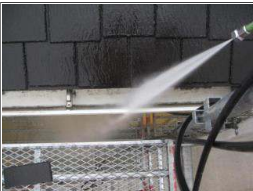
樋 高圧洗浄中
