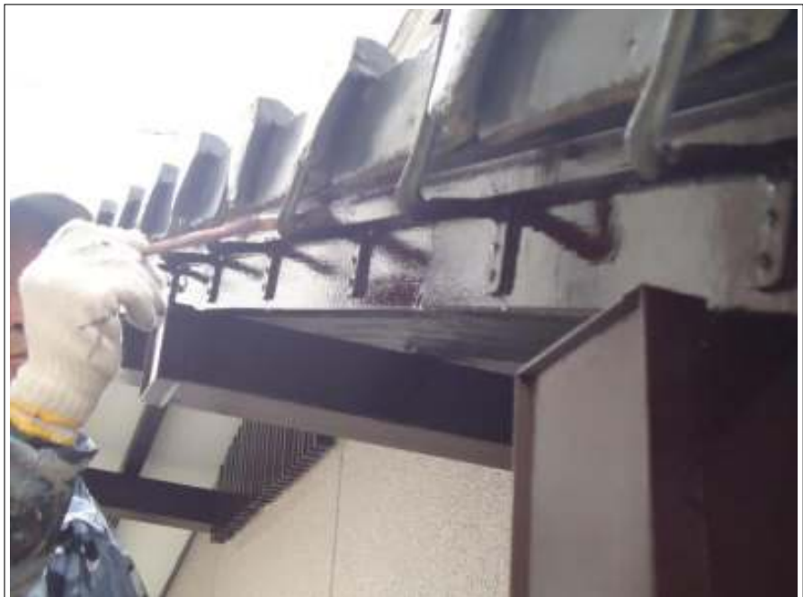
破風板 施工中
