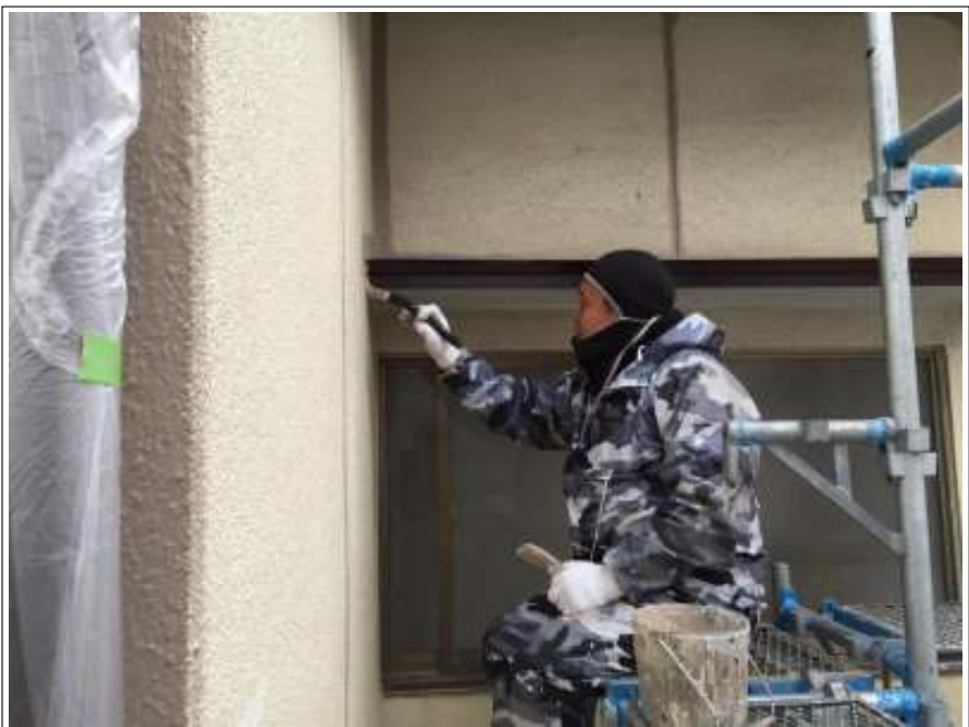
外壁 中塗り施工中
