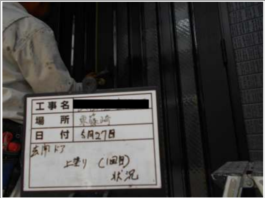
玄関ドア 上塗り（1回目）施工中
