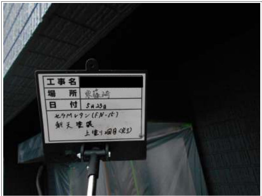
軒天 上塗り（2回目）施工完了
