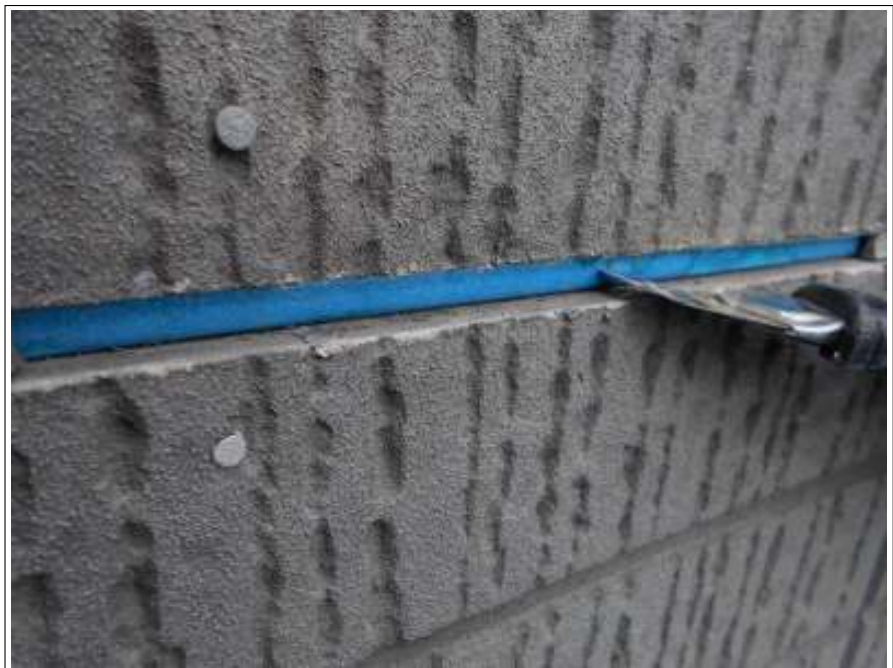
外壁 シーリング撤去施工中
