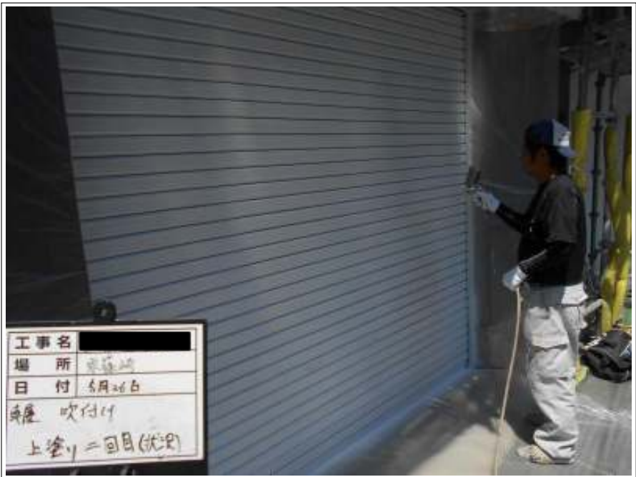
車庫 上塗り（2回目）施工中
