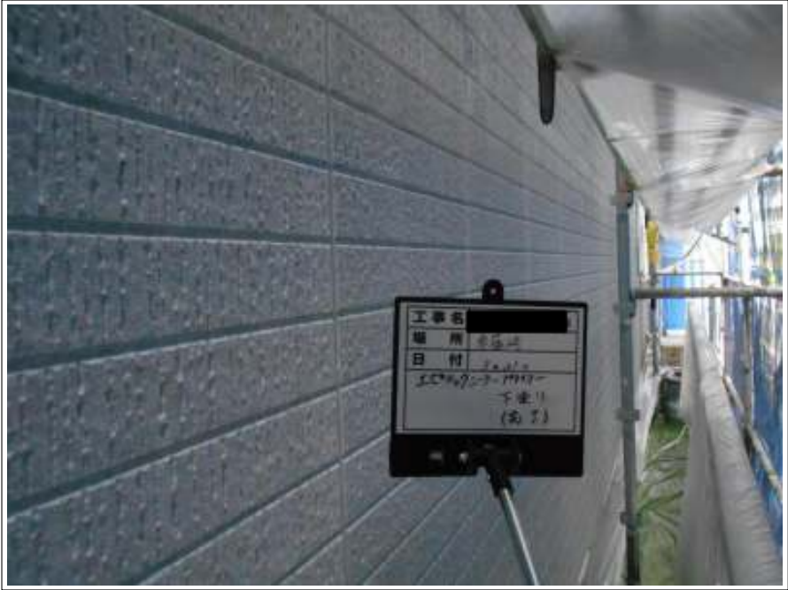
外壁 下塗り施工完了
