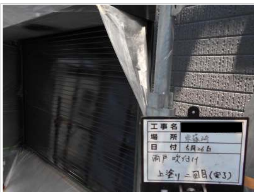
雨戸 上塗り（2回目）施工完了
