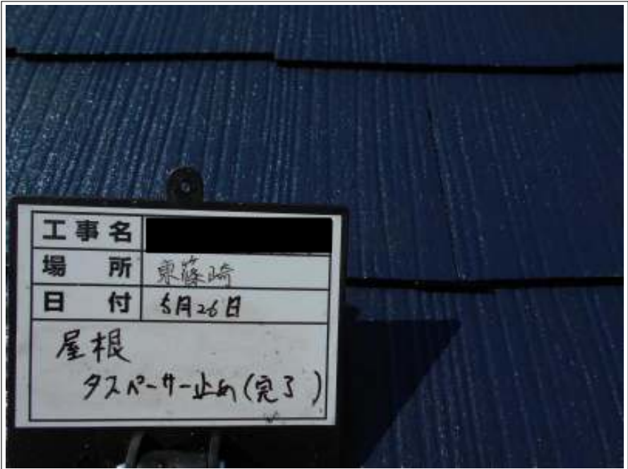
屋根 タスペーサー施工完了
