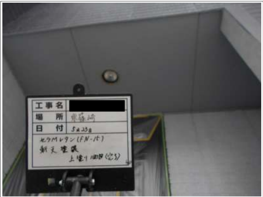
軒天 上塗り（1回目）施工完了
