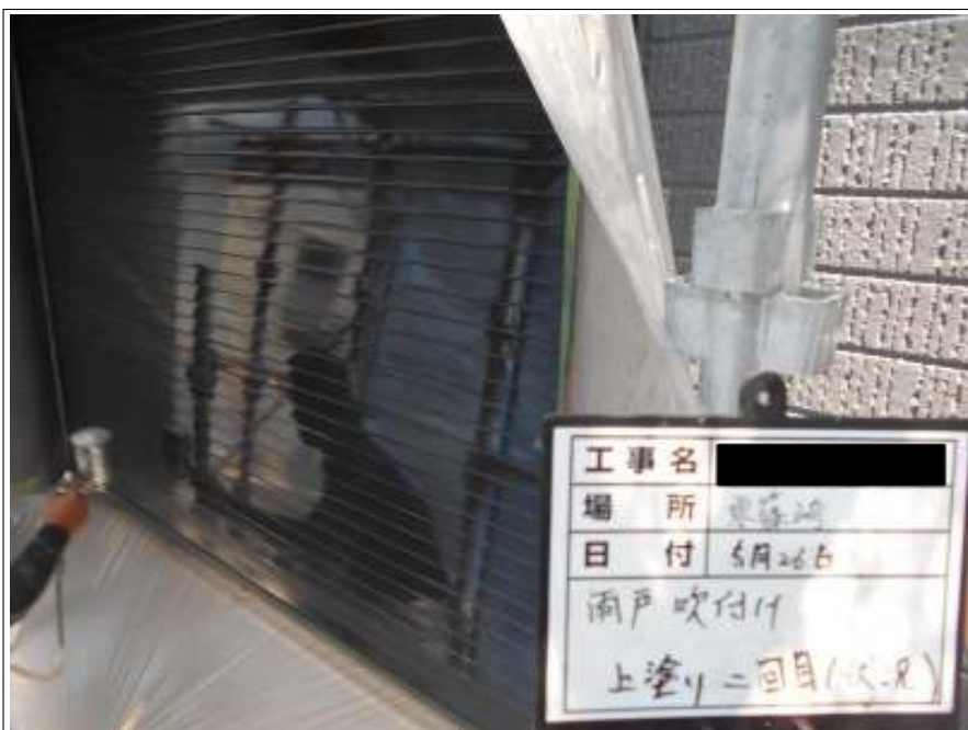
雨戸 上塗り（2回目）施工中
