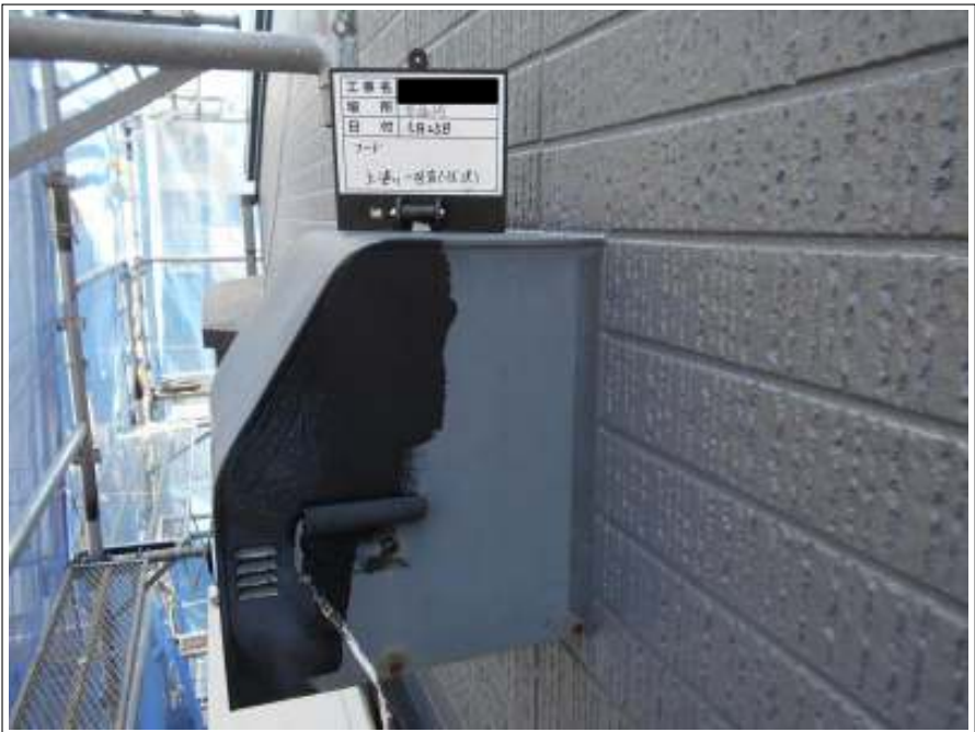
換気フード 上塗り施工中
