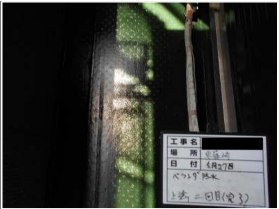
ベランダ防水 上塗り（2回目）施工完了
