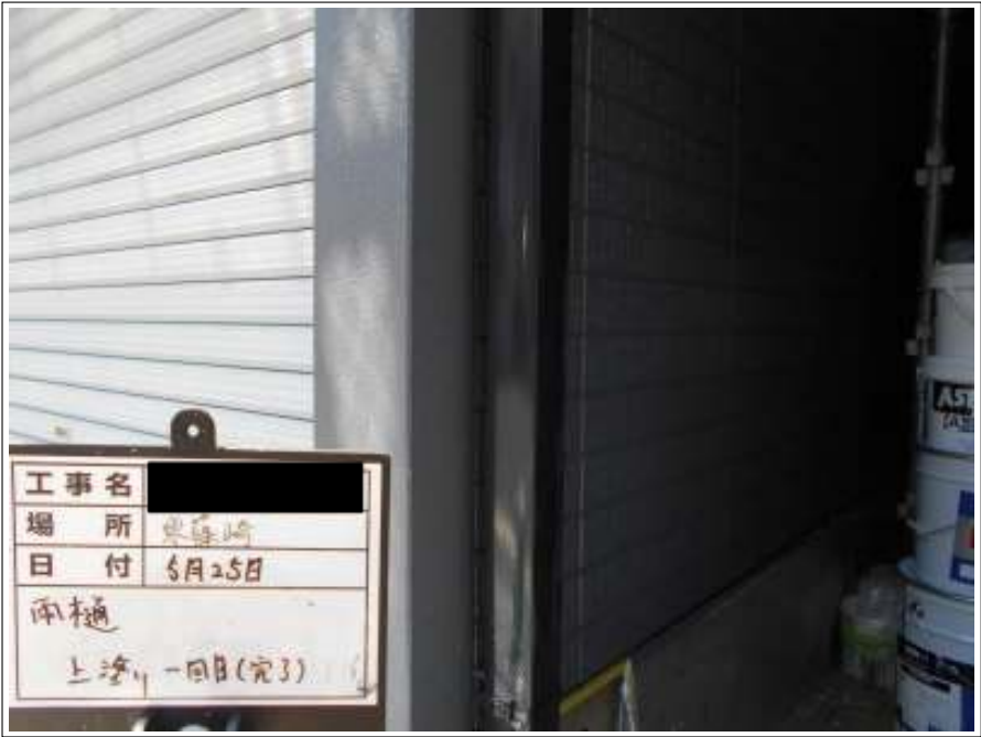
樋 上塗り（1回目）施工完了
