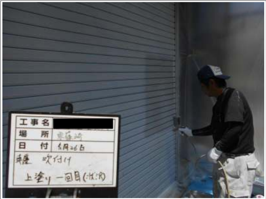
車庫 上塗り（1回目）施工中
