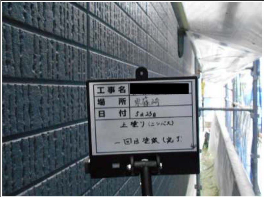
外壁 中塗り施工完了
