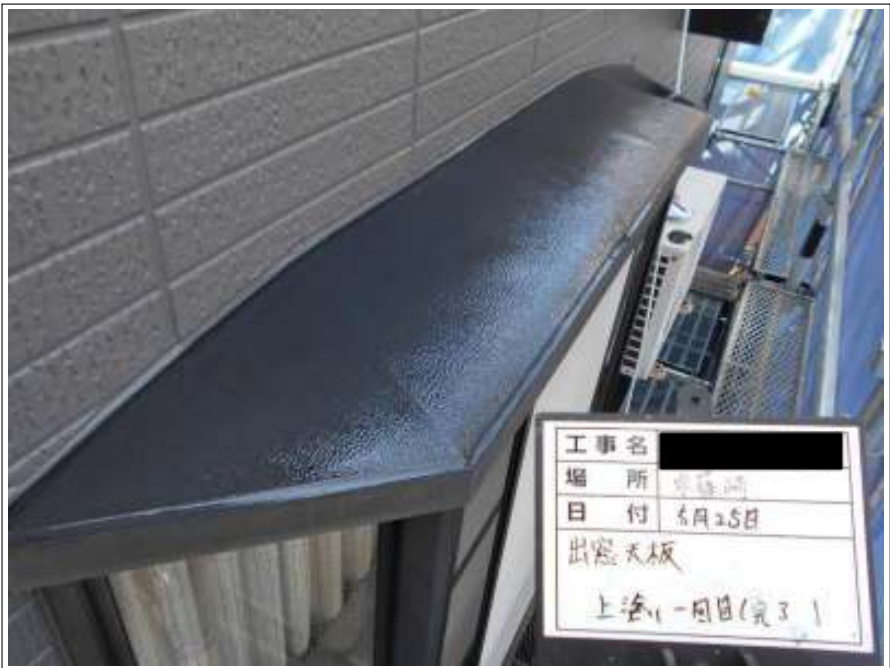
出窓天板 上塗り（1回目）施工完了
