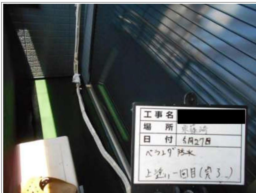
ベランダ防水 上塗り（1回目）施工完了
