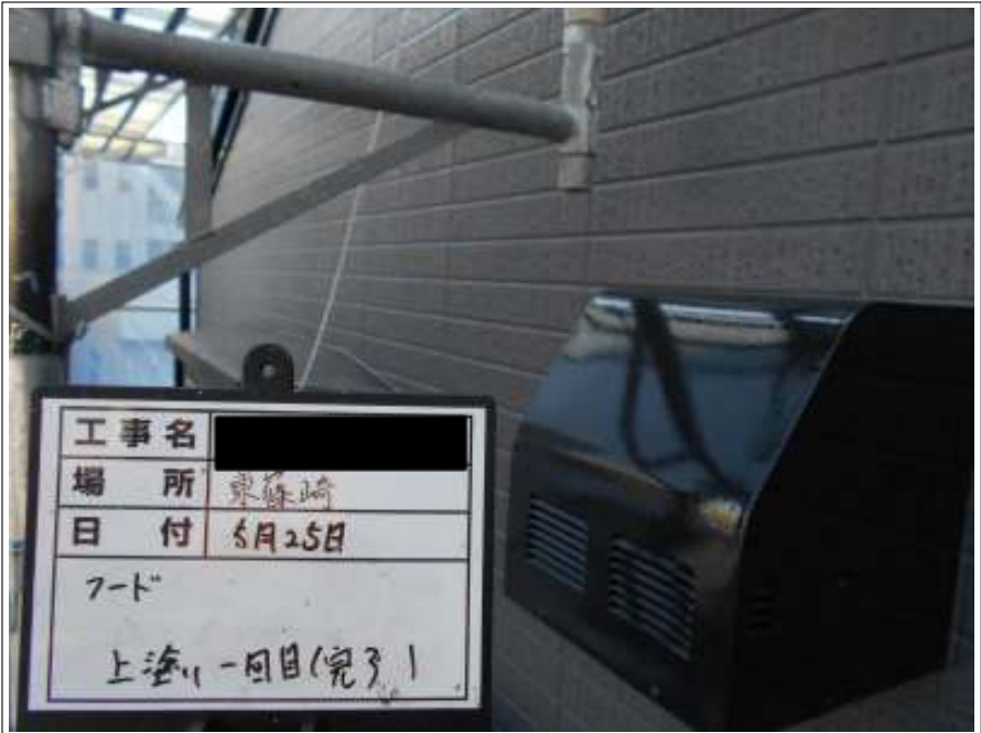
換気フード 上塗り施工完了
