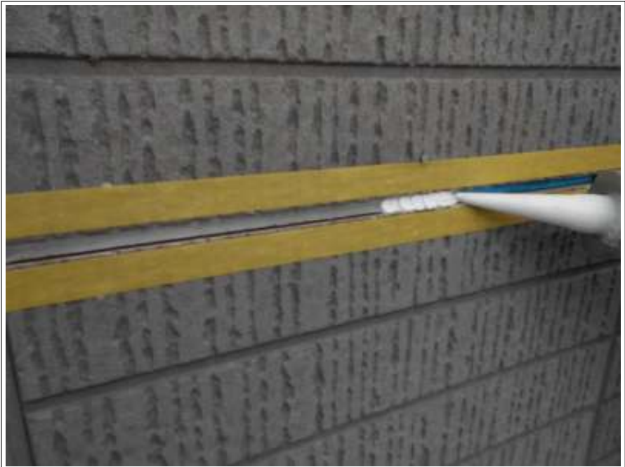
外壁 シーリング打ち替え施工中
