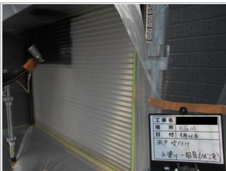
雨戸 上塗り（1回目）施工中
