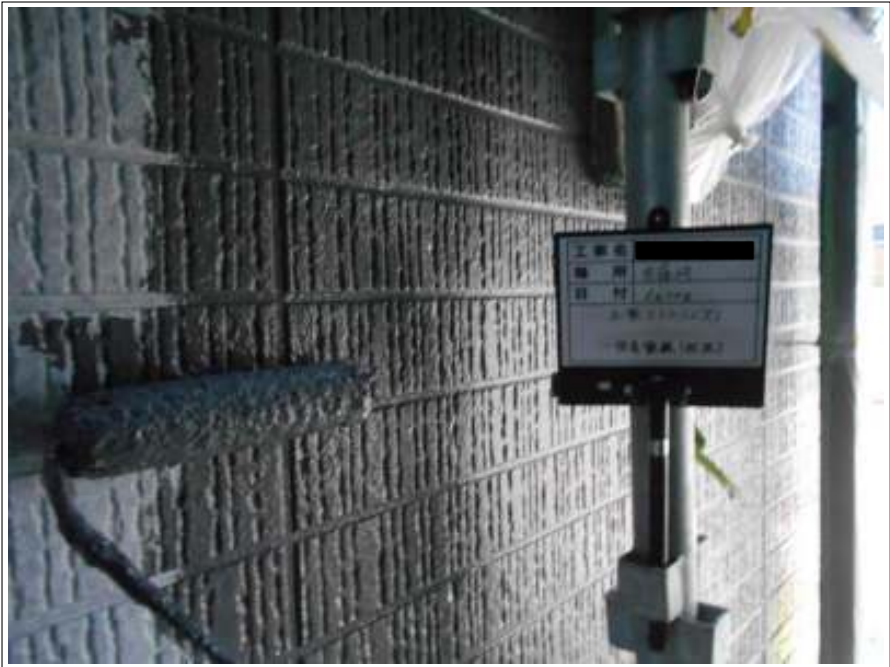
外壁 中塗り施工中
