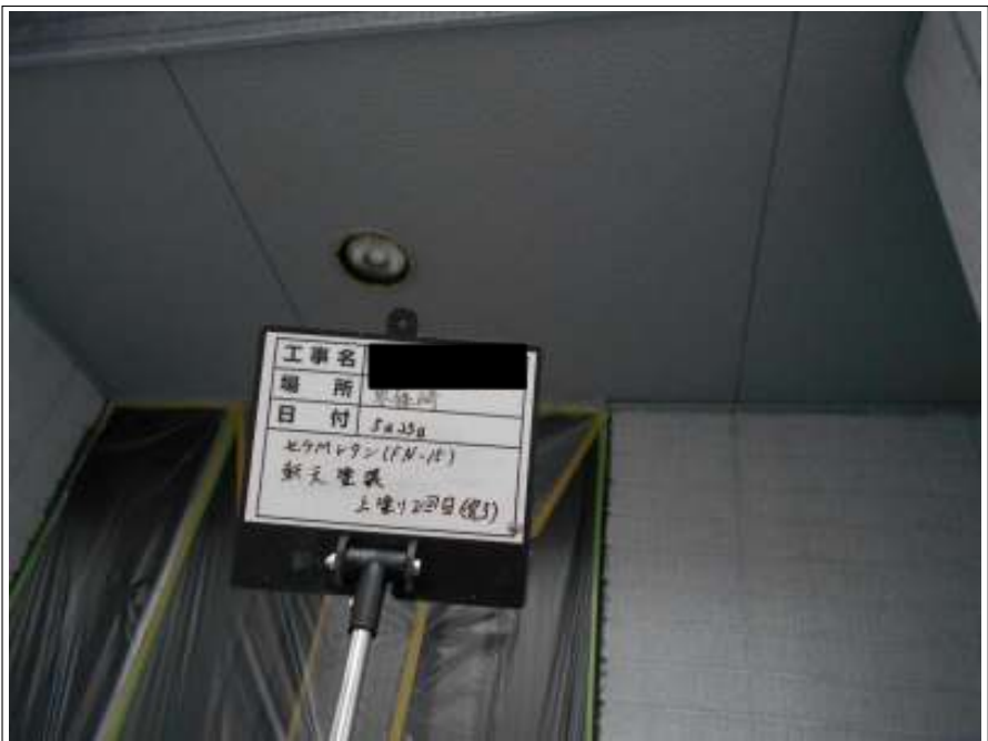
軒天 上塗り（2回目）施工完了
