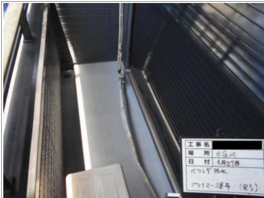
ベランダ防水 下塗り施工完了
