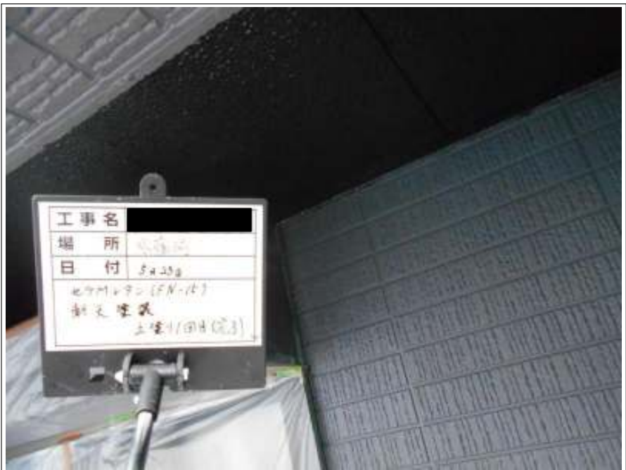
軒天 上塗り（1回目）施工完了
