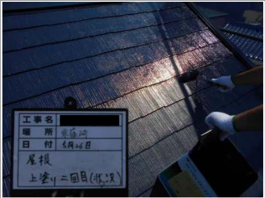
屋根 上塗り（2回目）施工中
