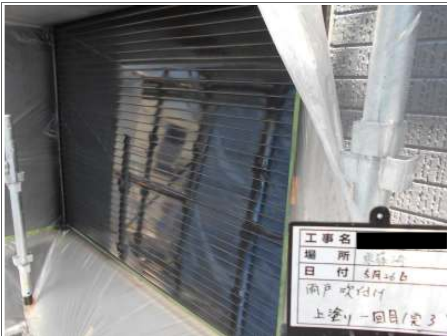
雨戸 上塗り（1回目）施工完了
