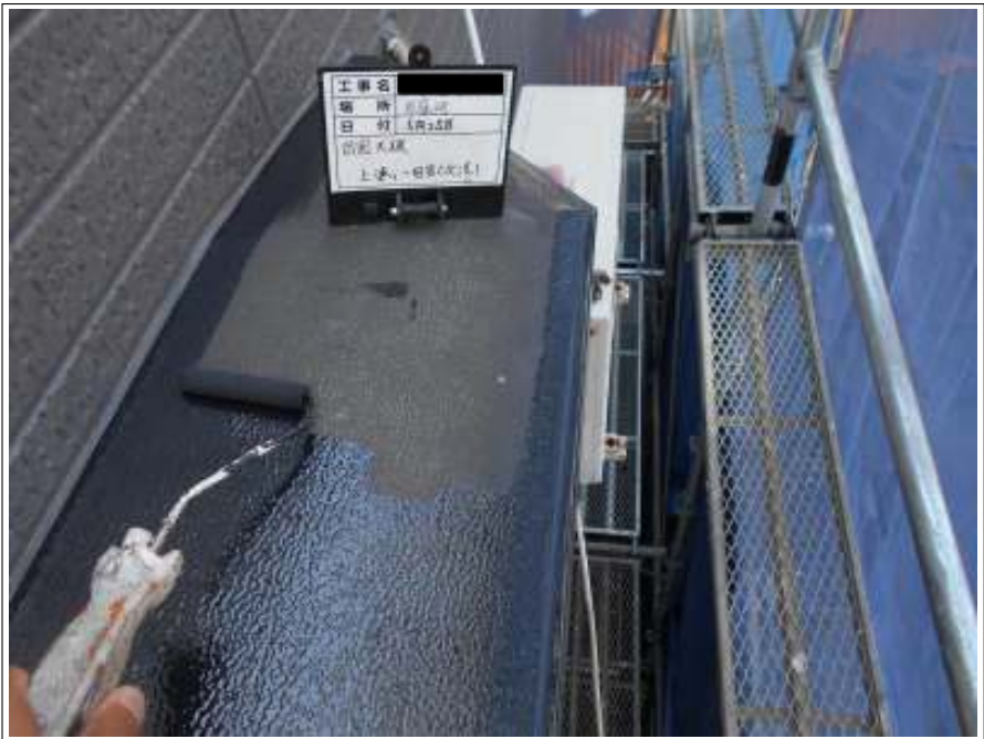
出窓天板 上塗り（1回目）施工中
