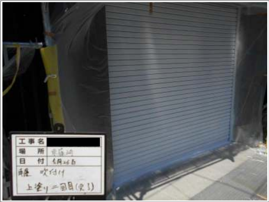
車庫 上塗り（2回目）施工完了
