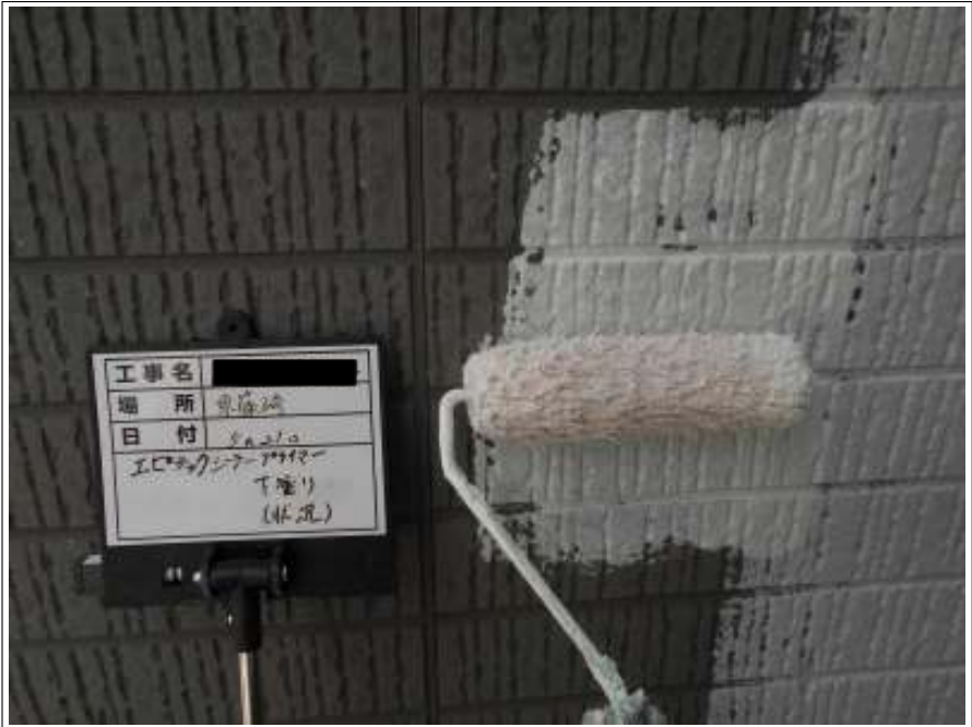
外壁 下塗り施工中
