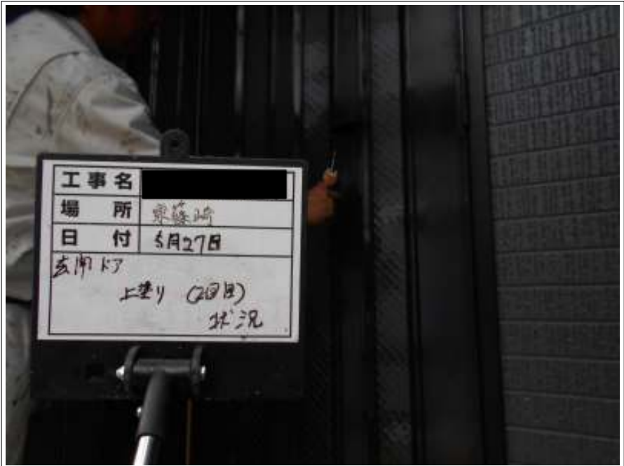
玄関ドア 上塗り（2回目）施工中
