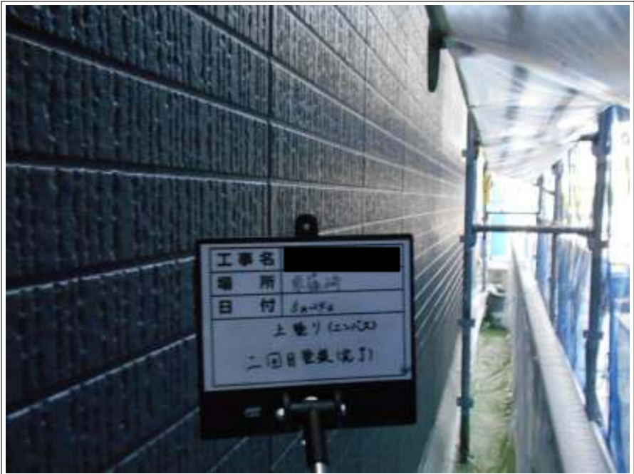
外壁 上塗り施工完了
