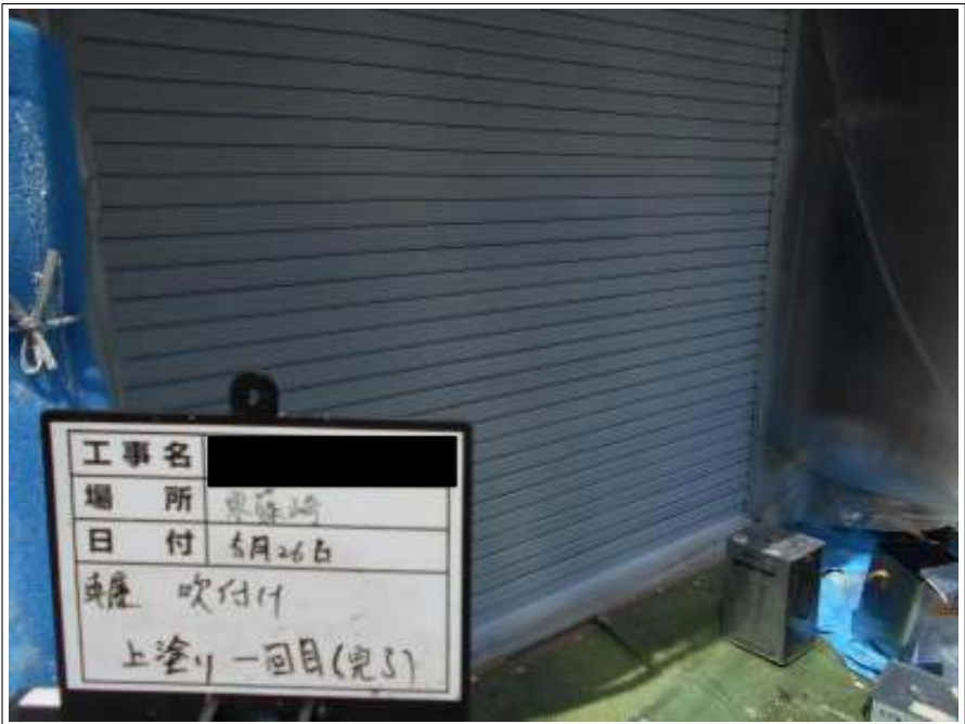
車庫 上塗り（1回目）施工完了
