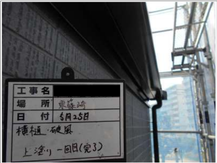
破風 上塗り（1回目）施工完了
