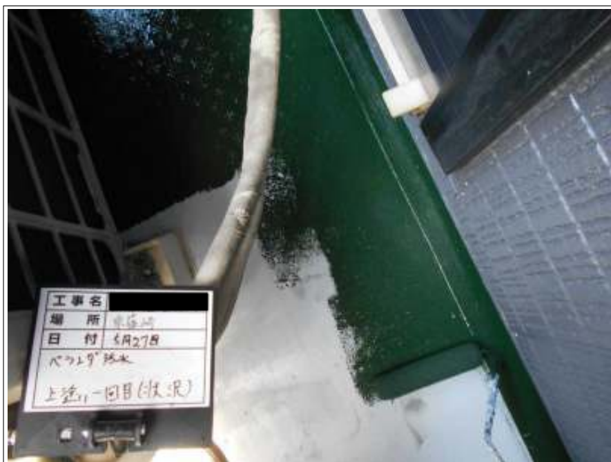
ベランダ防水 上塗り（1回目）施工中
