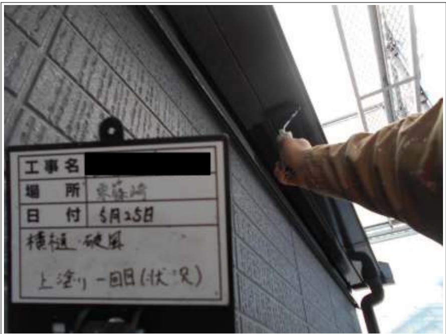
破風 上塗り（1回目）施工中
