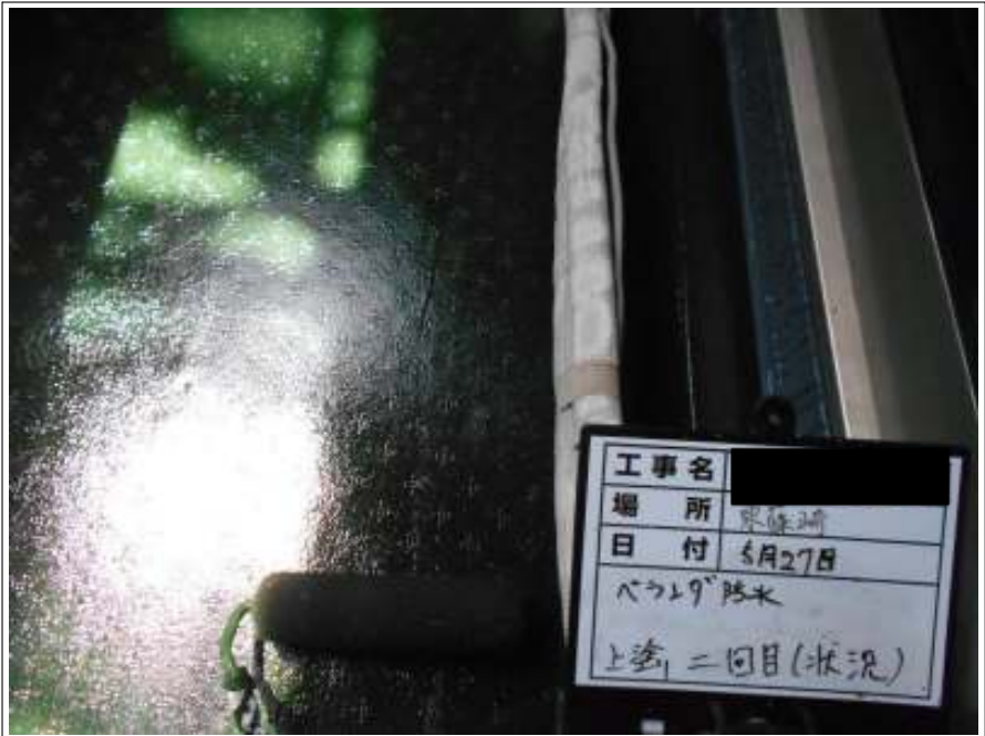
ベランダ防水 上塗り（2回目）施工中
