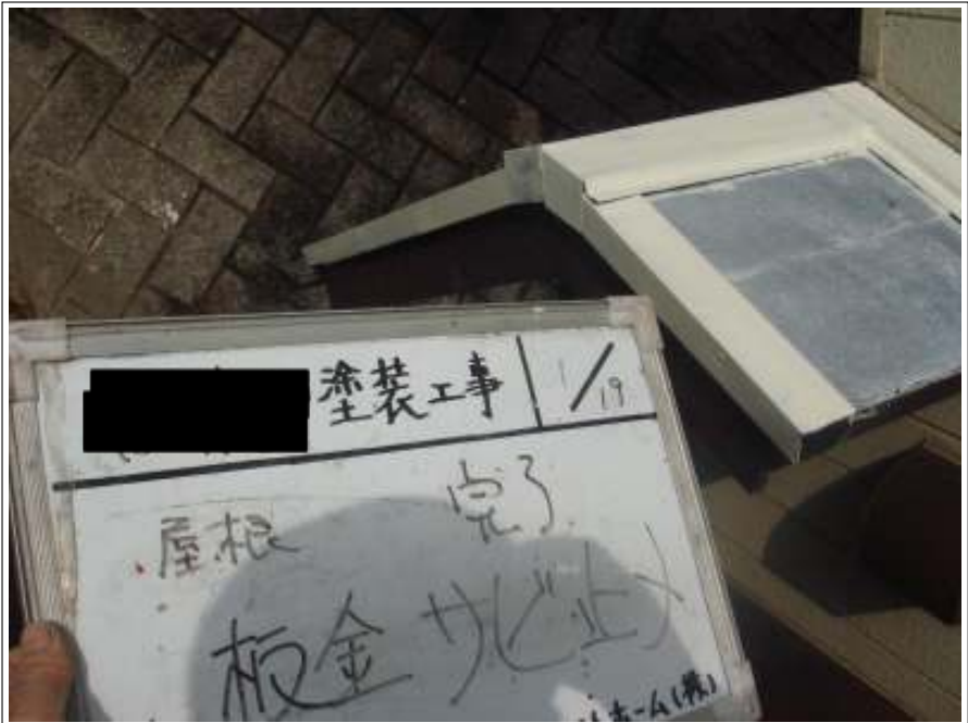
棟鉄板サビ止め施工完了
