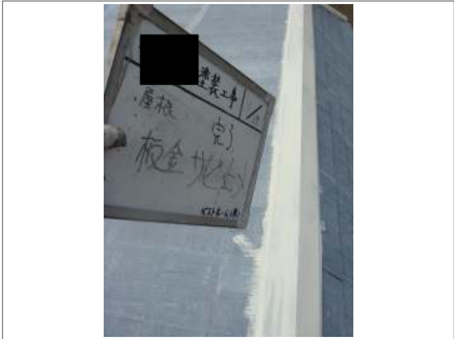
棟鉄板サビ止め施工完了
