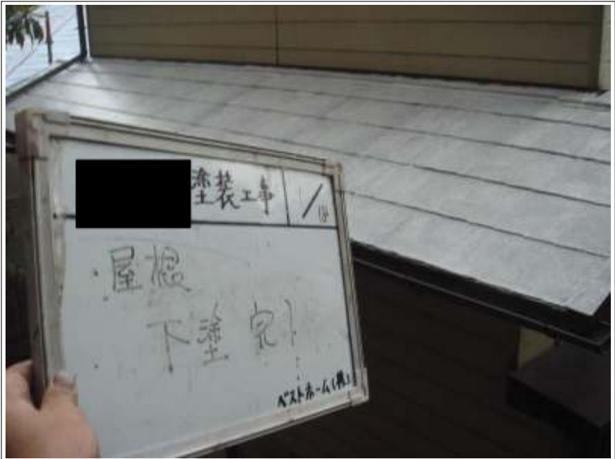
屋根塗装下塗り施工完了
