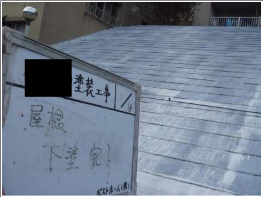
屋根塗装下塗り施工完了
