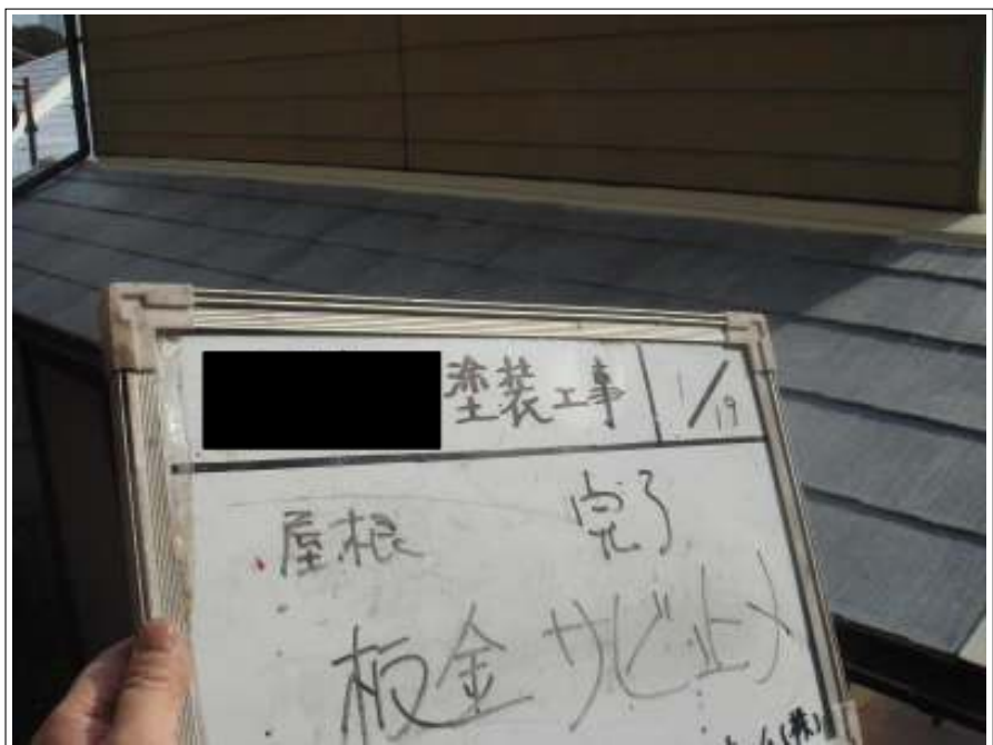
棟鉄板サビ止め施工完了
