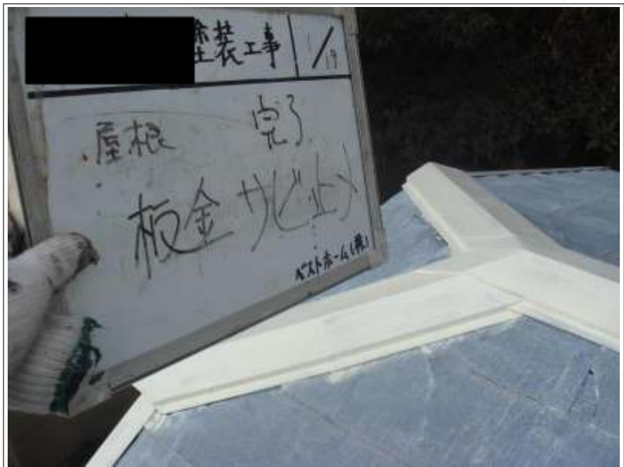
棟鉄板サビ止め施工完了
