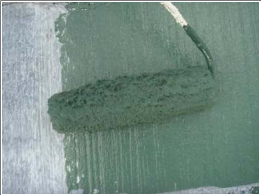
屋根塗装中塗り施工中
