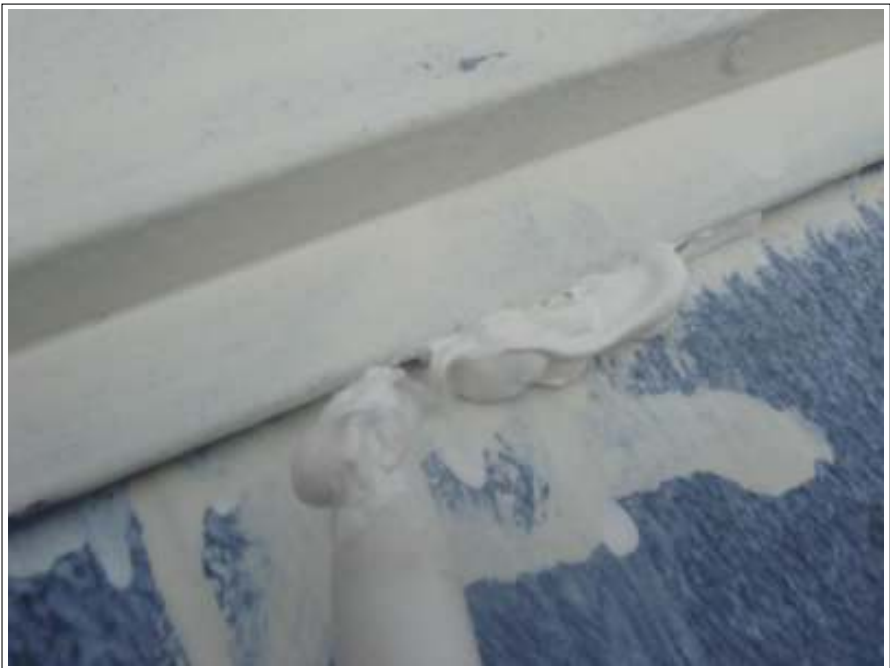
棟鉄板ラバー止め施工中
