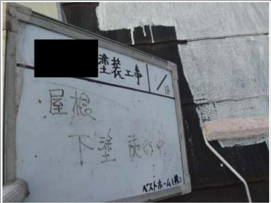
屋根塗装下塗り施工中
