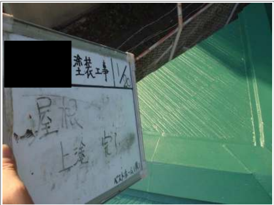
屋根塗装上塗り施工完了
