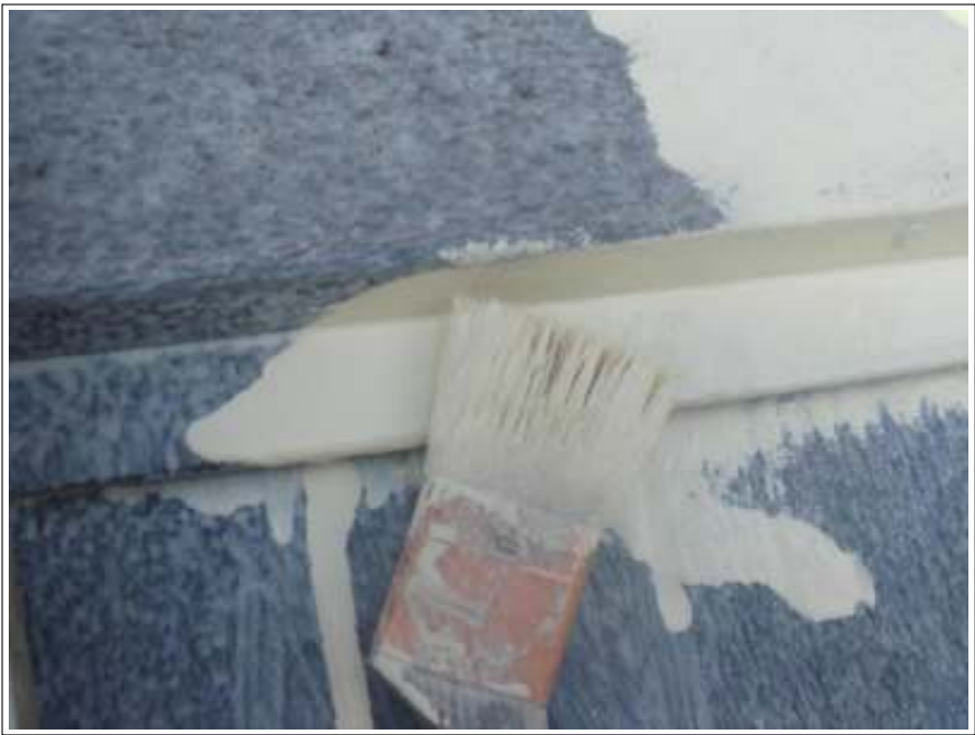
棟鉄板サビ止め施工中
