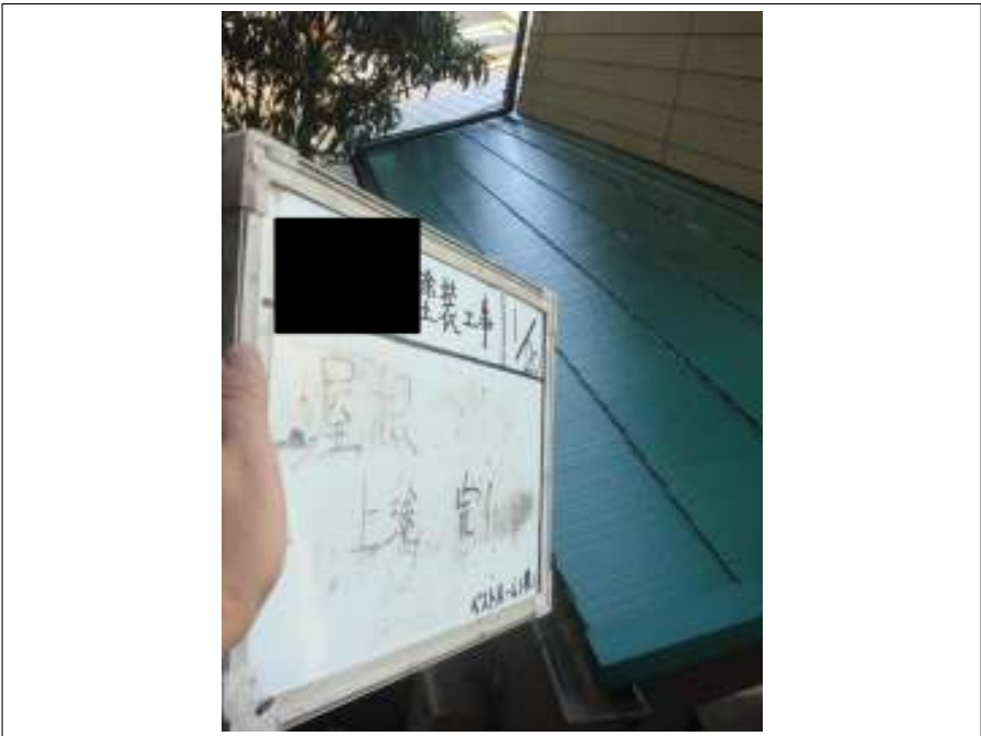
屋根塗装上塗り施工完了
