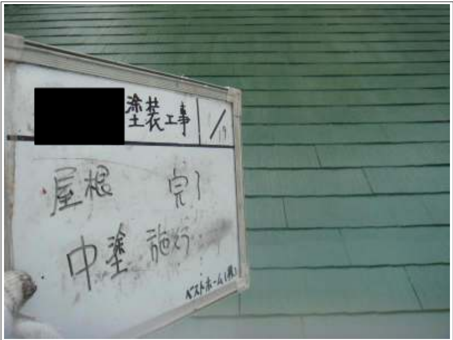
屋根塗装中塗り施工完了
