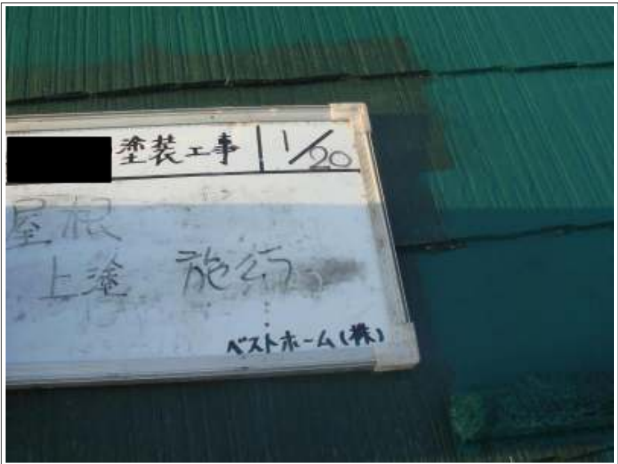
屋根塗装上塗り施工中
