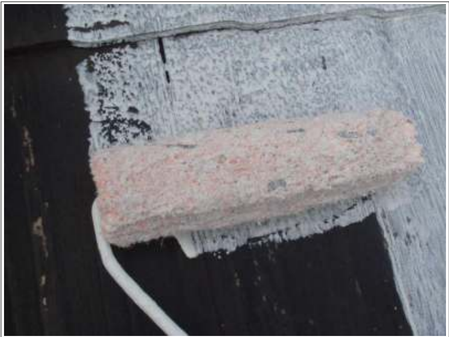
屋根塗装下塗り施工中
