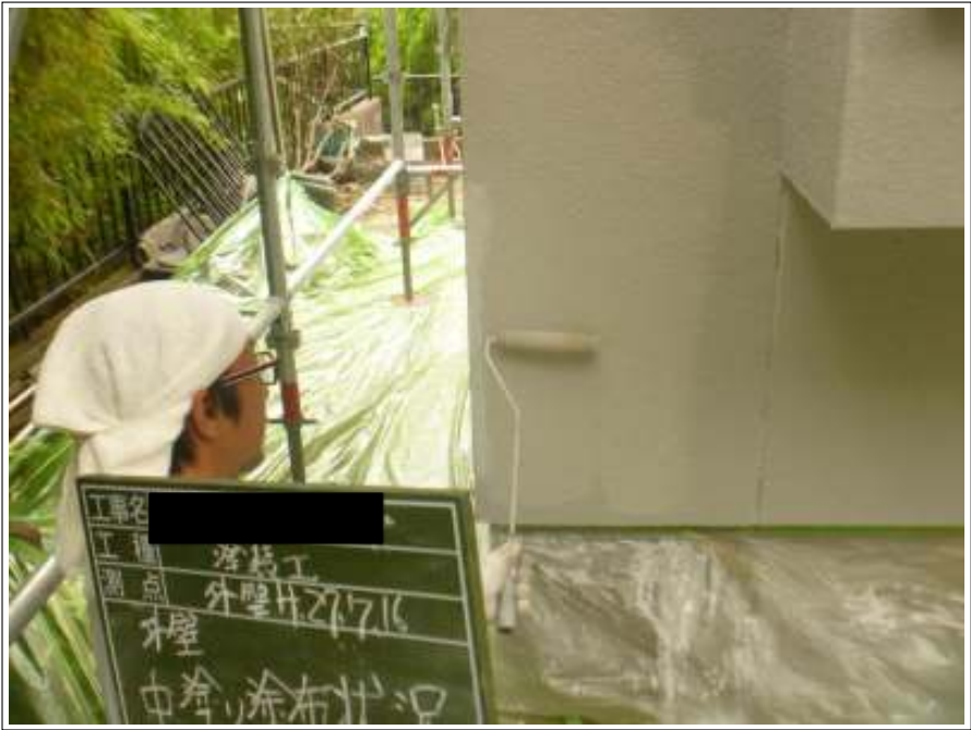
外壁 中塗り施工中
