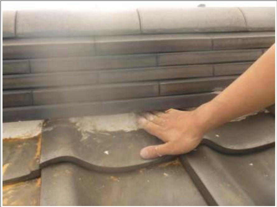
漆喰補修 施工中
