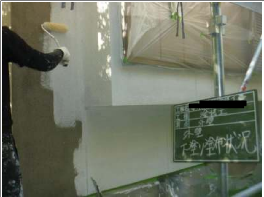
外壁 下塗り施工中
