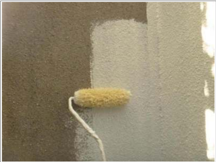
外壁 下塗り施工中
