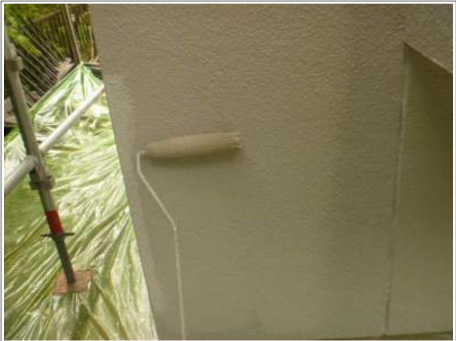
外壁 中塗り施工中
