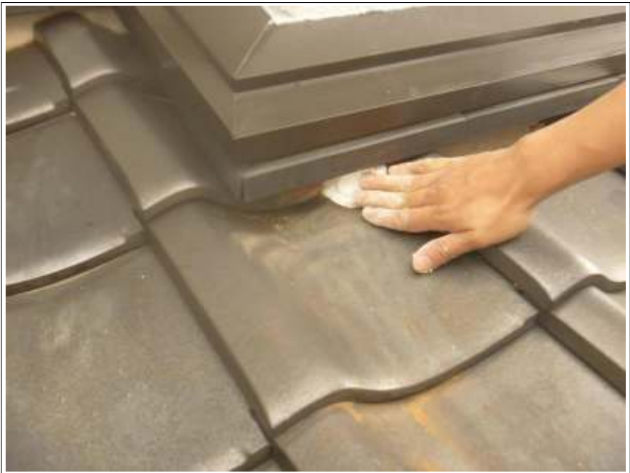
漆喰補修 施工中
