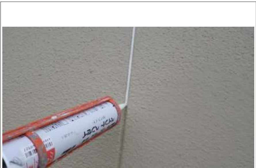
外壁クラック補修施工中
