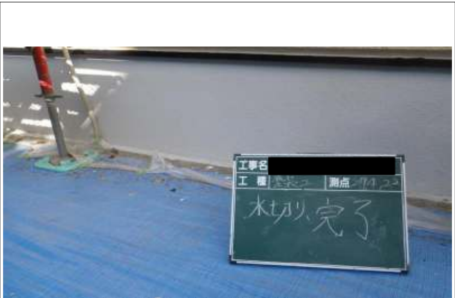
土台水切り施工完了
