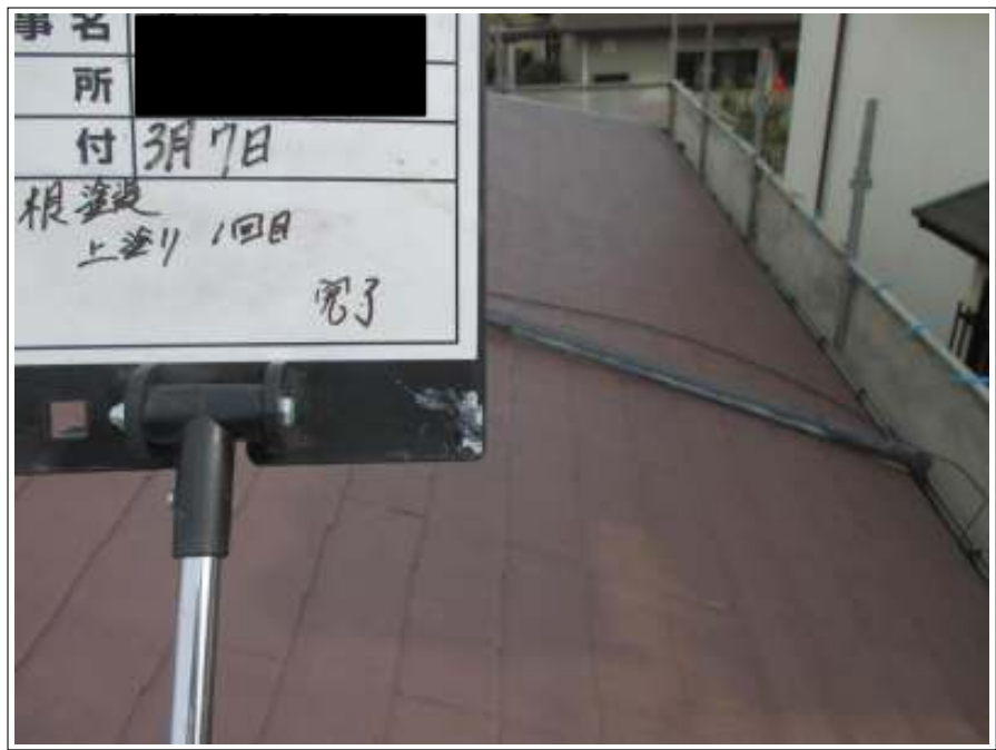
屋根塗装中塗り施工完了
