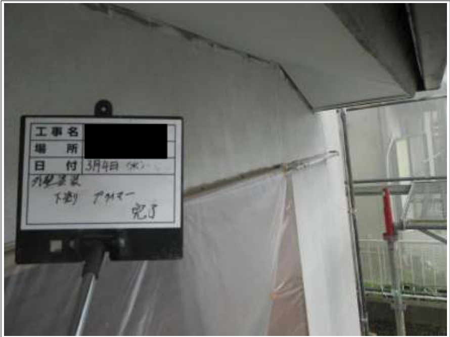
外壁塗装下塗り施工完了
