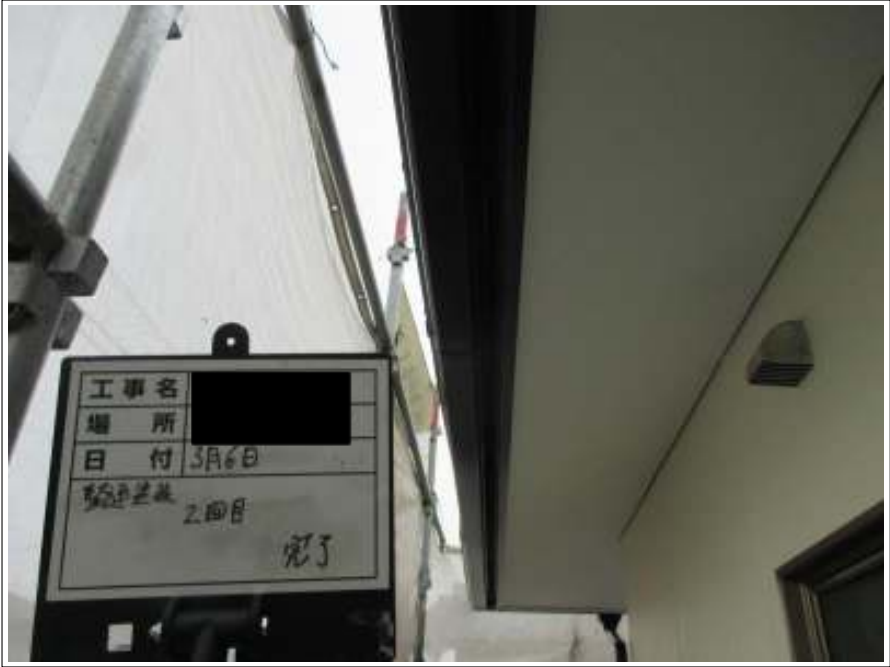
縦樋塗装 2 回目施工完了
