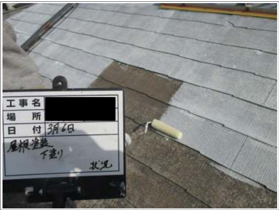
屋根塗装下塗り施工中
