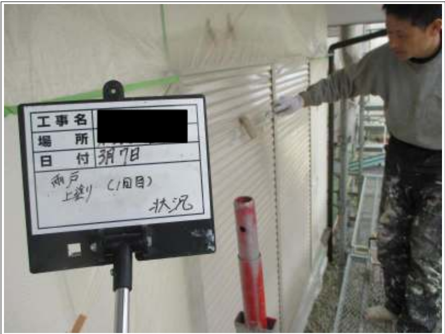
雨戸塗装上塗り 1 回目施工中
