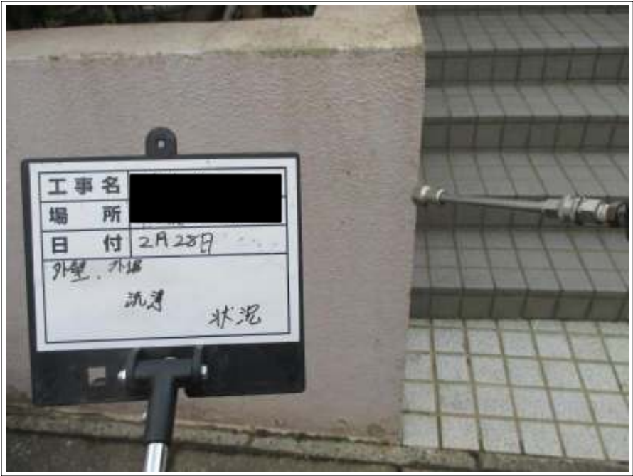
塀高圧洗浄施工中
