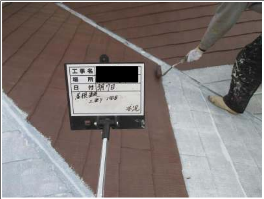
屋根塗装中塗り施工中
