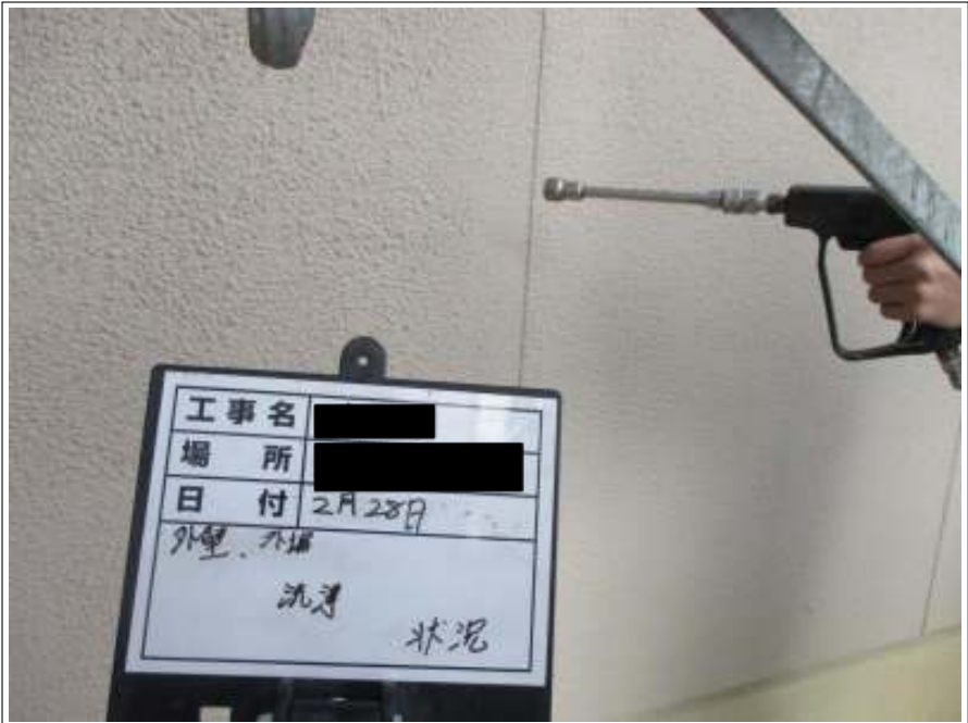
外壁高圧洗浄施工中
