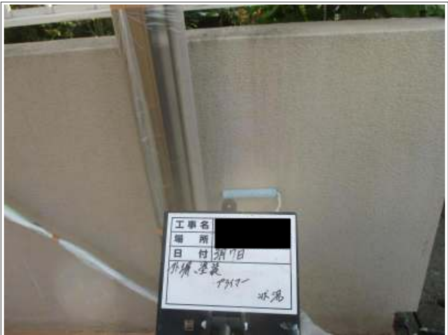
塀塗装下塗り施工中
