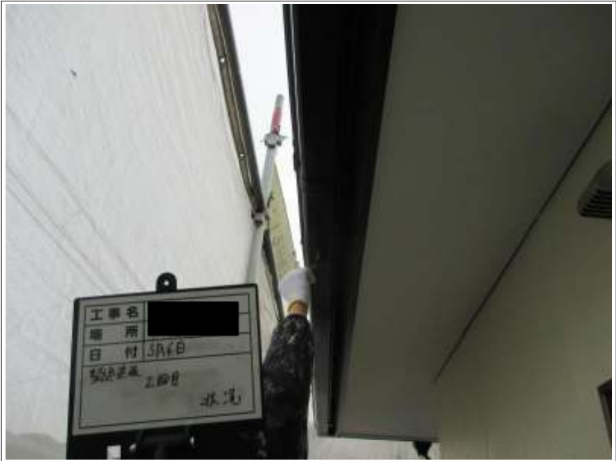
縦樋塗装 2 回目施工中
