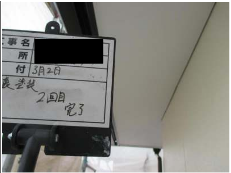
軒天塗装 2 回目施工完了
