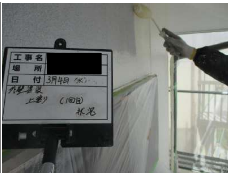
外壁塗装中塗り施工中
