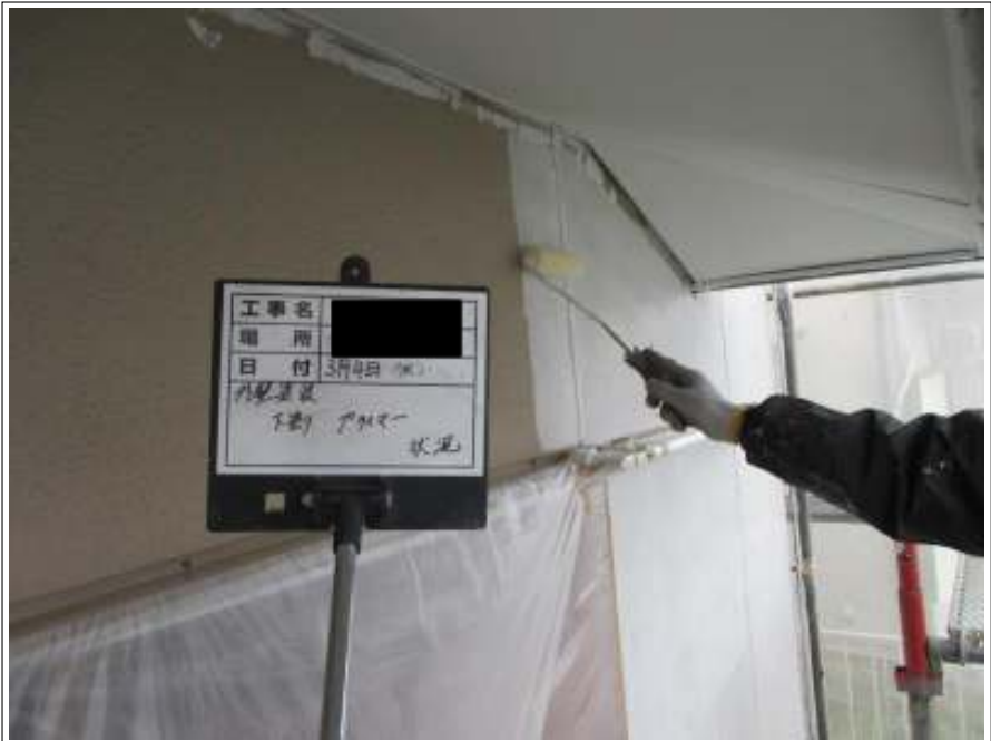
外壁塗装下塗り施工中
