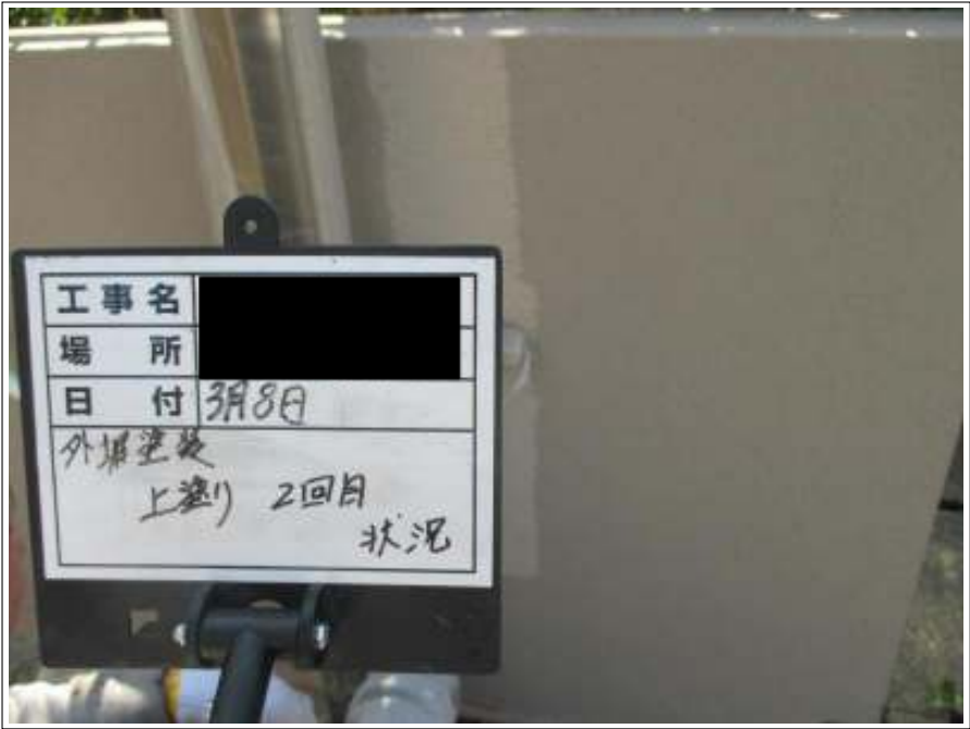
塀塗装上塗り 2回目施工中
