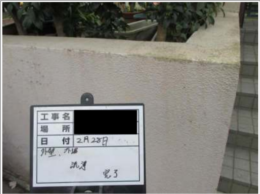
塀高圧洗浄施工完了
