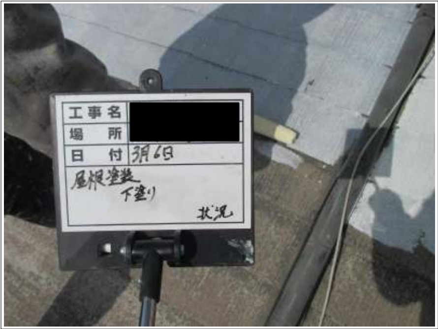
屋根塗装下塗り施工中
