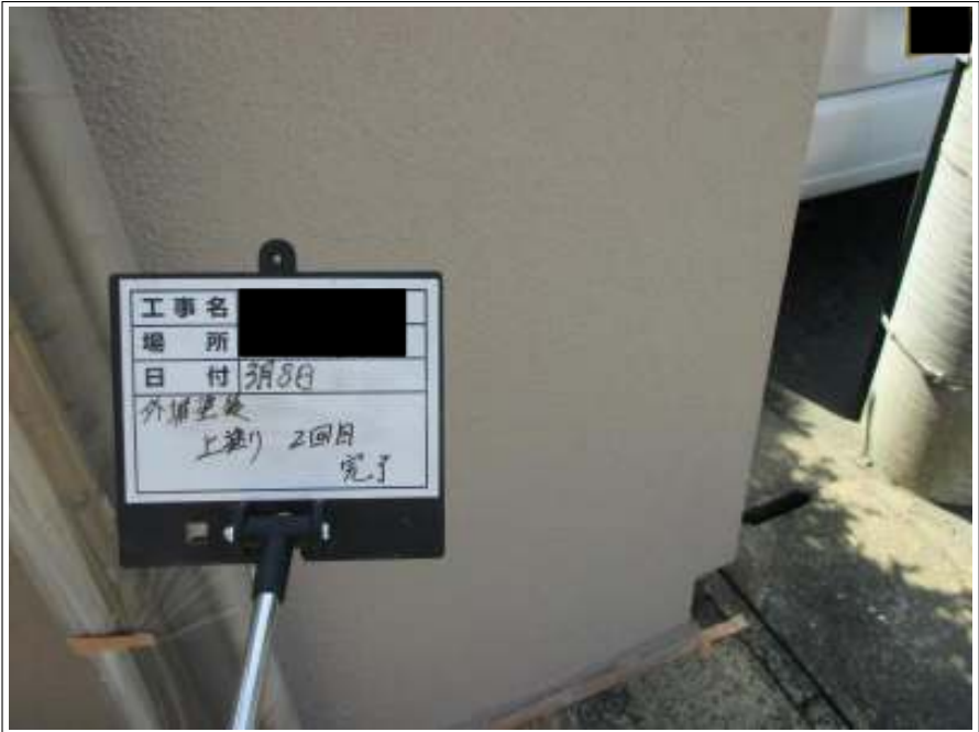
塀塗装上塗り 2回目施工完了
