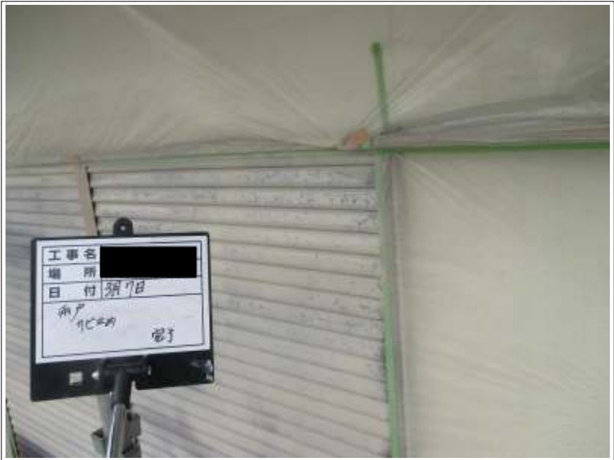
雨戸サビ止め施工完了
