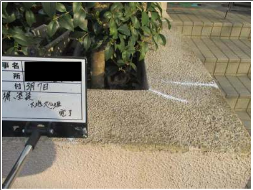
塀クラック補修施工完了
