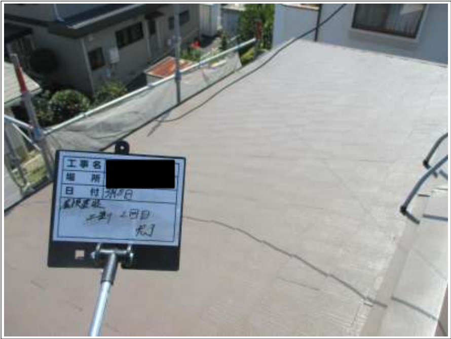
屋根塗装上塗り 2 回目施工完了
