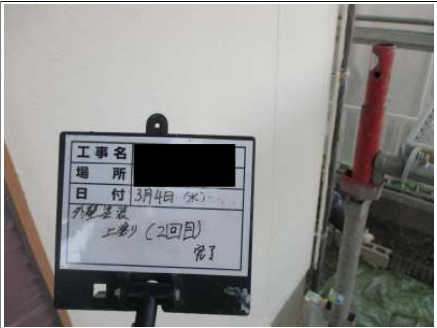
外壁塗装上塗り施工完了
