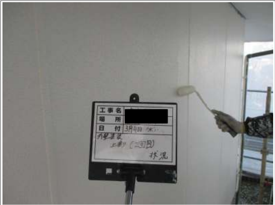
外壁塗装上塗り施工中
