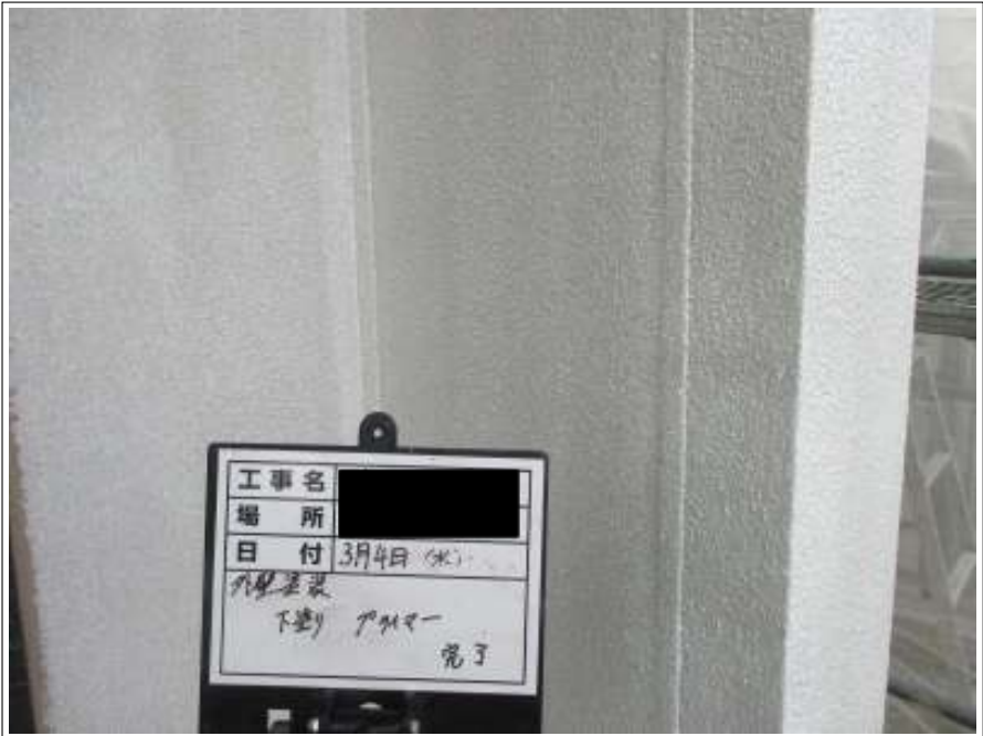
外壁塗装下塗り施工完了
