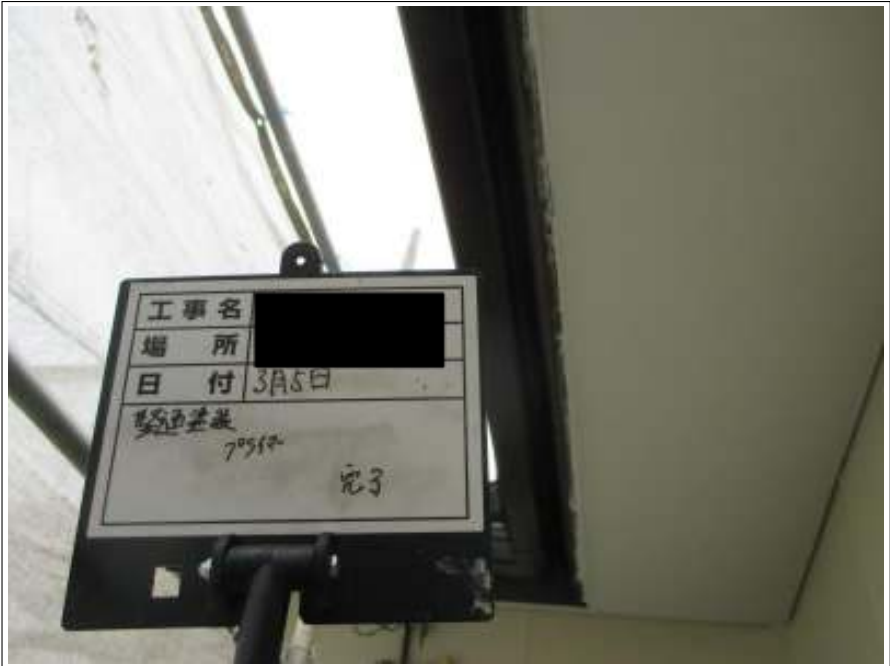
壁面塗装下塗り施工完了
