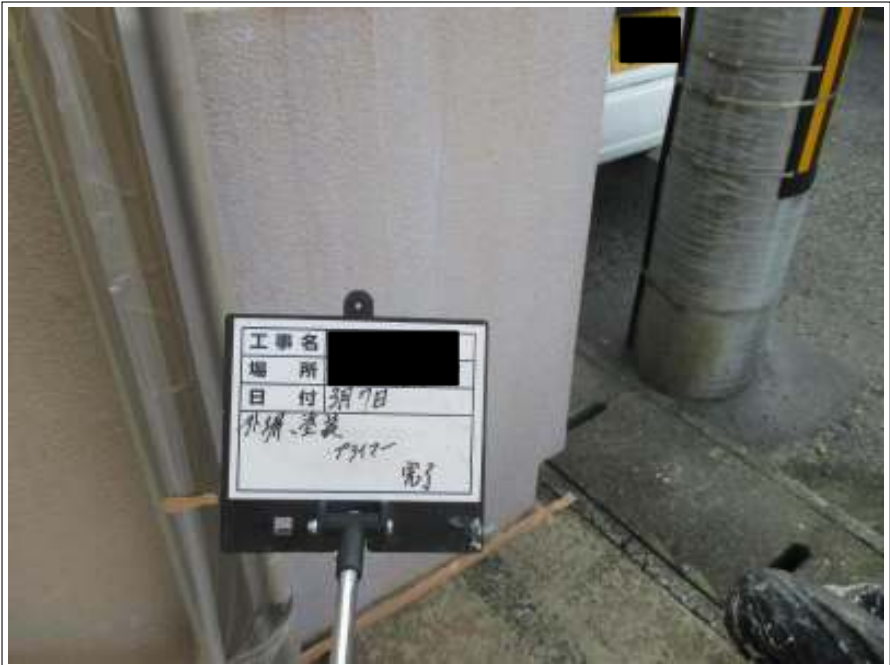
塀塗装下塗り施工完了
