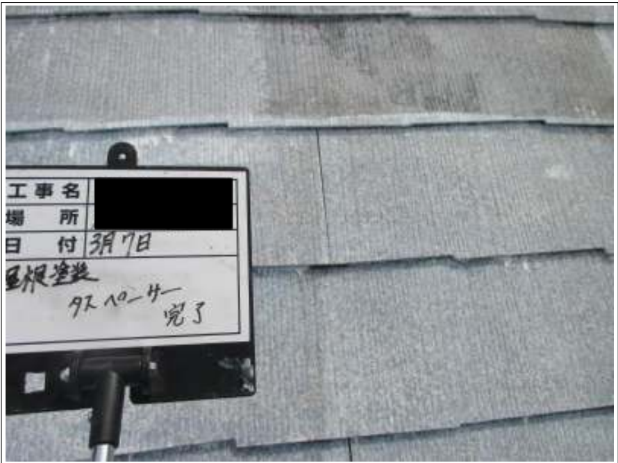
タスペーサー取付施工完了
