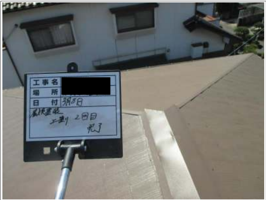
屋根塗装上塗り 2 回目施工完了
