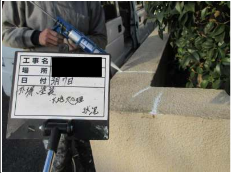
塀クラック補修施工中
