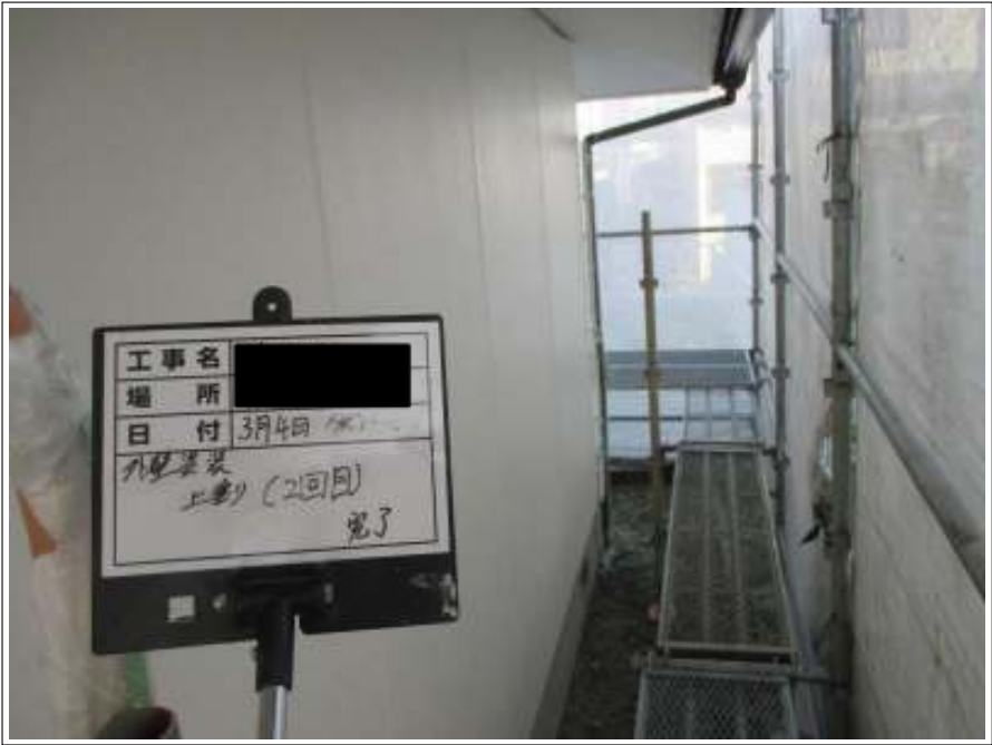
外壁塗装上塗り施工完了
