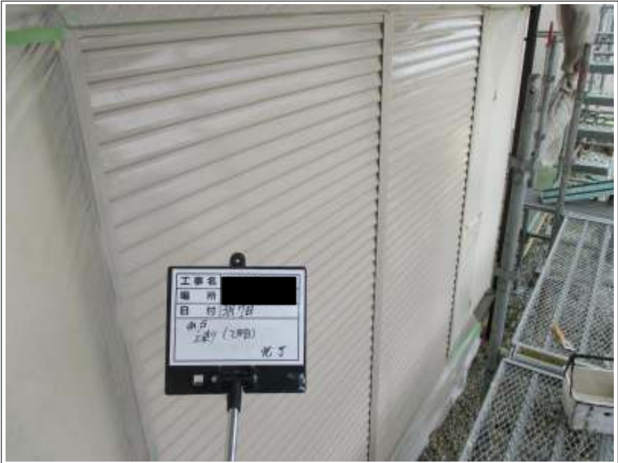
雨戸塗装上塗り 2 回目施工完了
