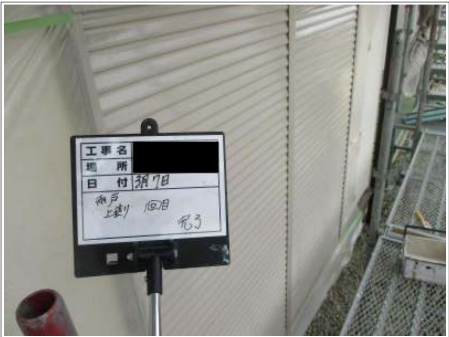
雨戸塗装上塗り 1 回目施工完了
