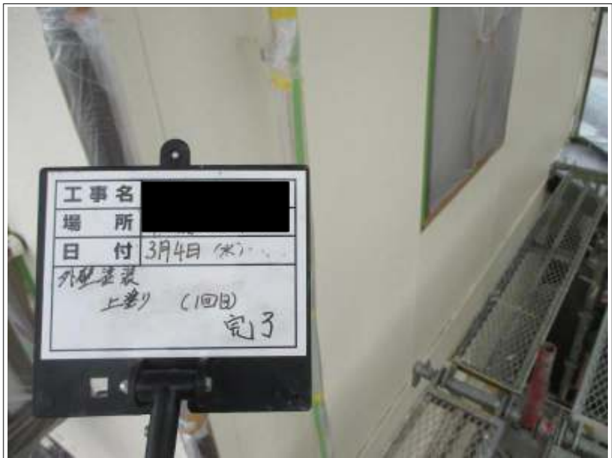
外壁塗装中塗り施工完了
