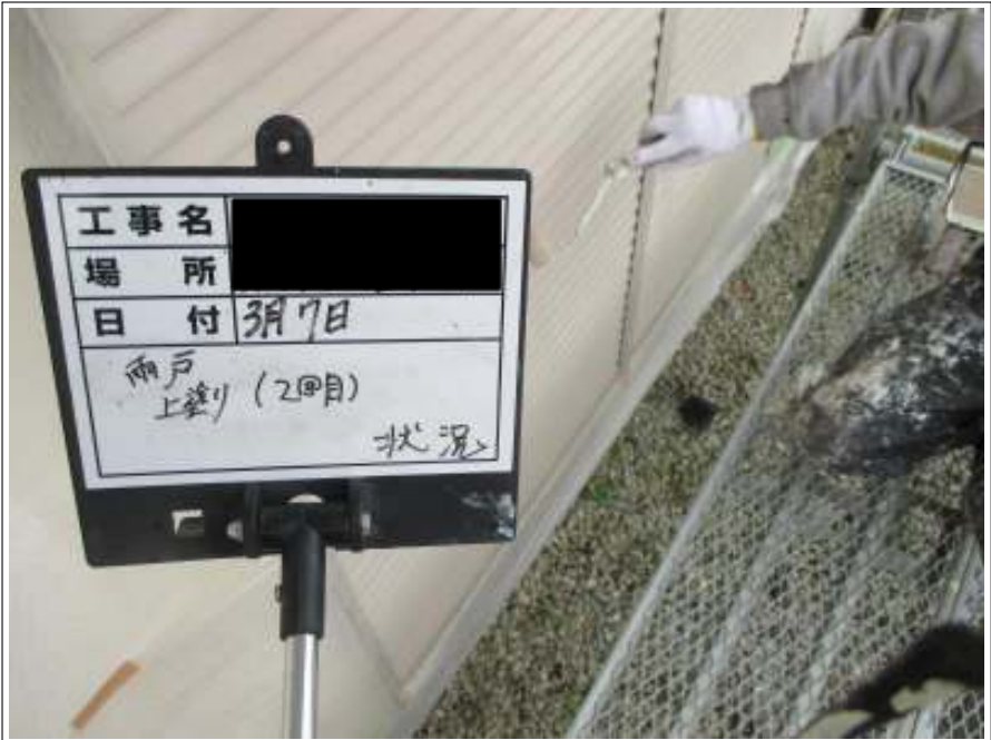
雨戸塗装上塗り 2 回目施工中
