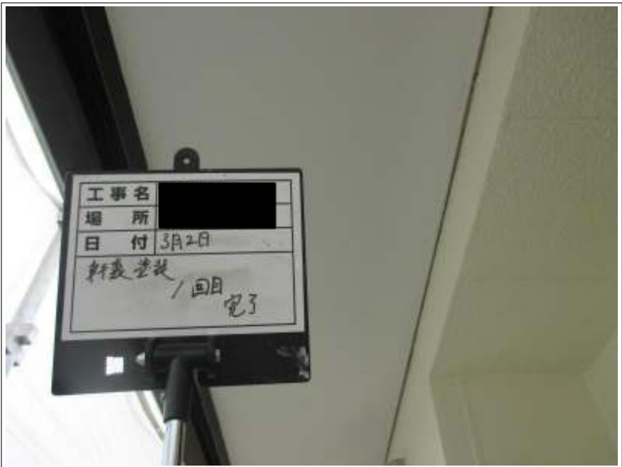
軒天塗装 1 回目施工完了
