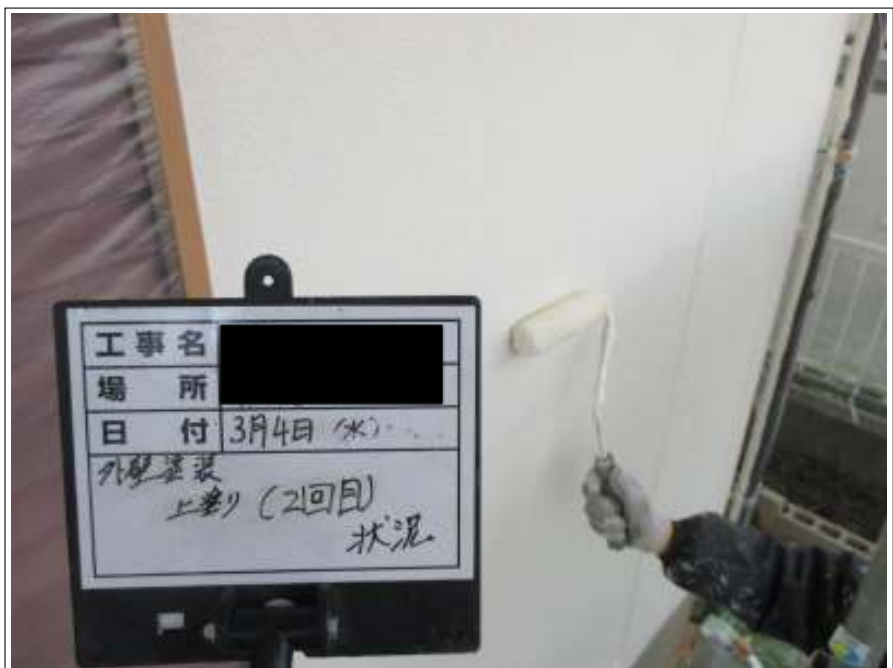
外壁塗装上塗り施工中
