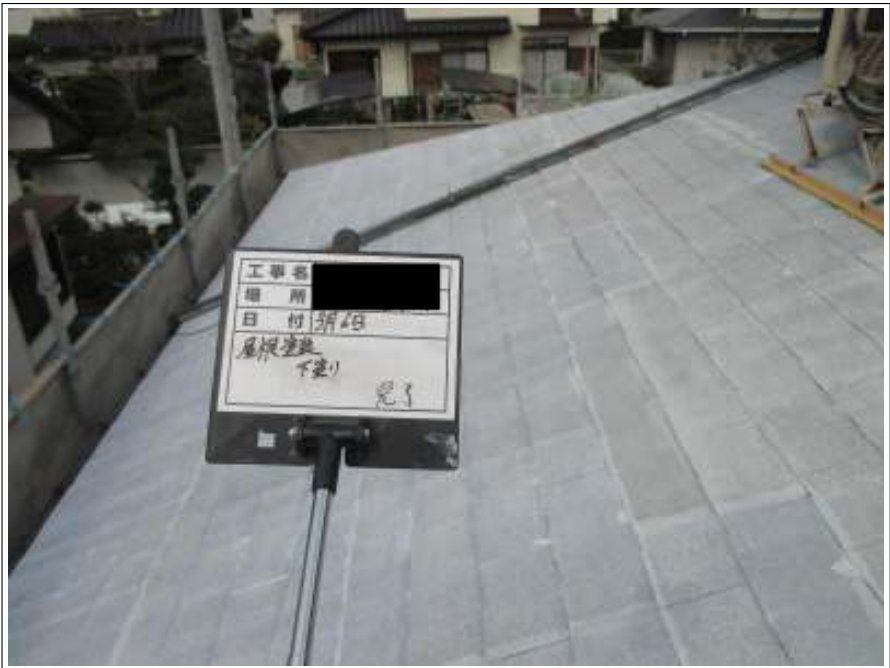
屋根塗装下塗り施工完了
