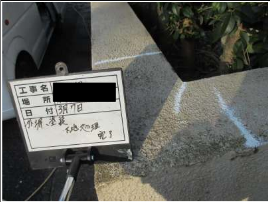
塀クラック補修施工完了
