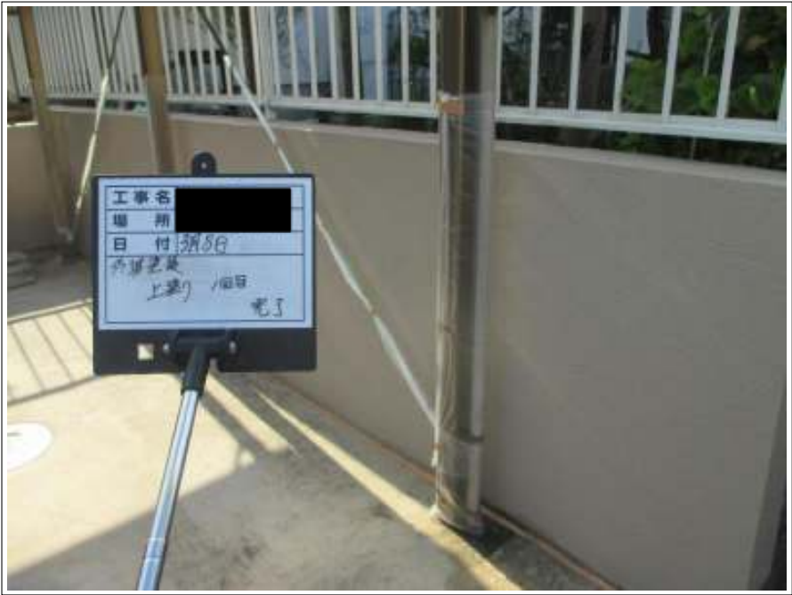
塀塗装上塗り 1 回目施工完了
