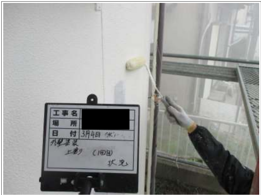
外壁塗装中塗り施工中
