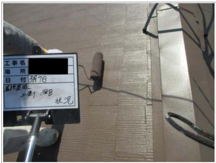
屋根塗装上塗り施工中
