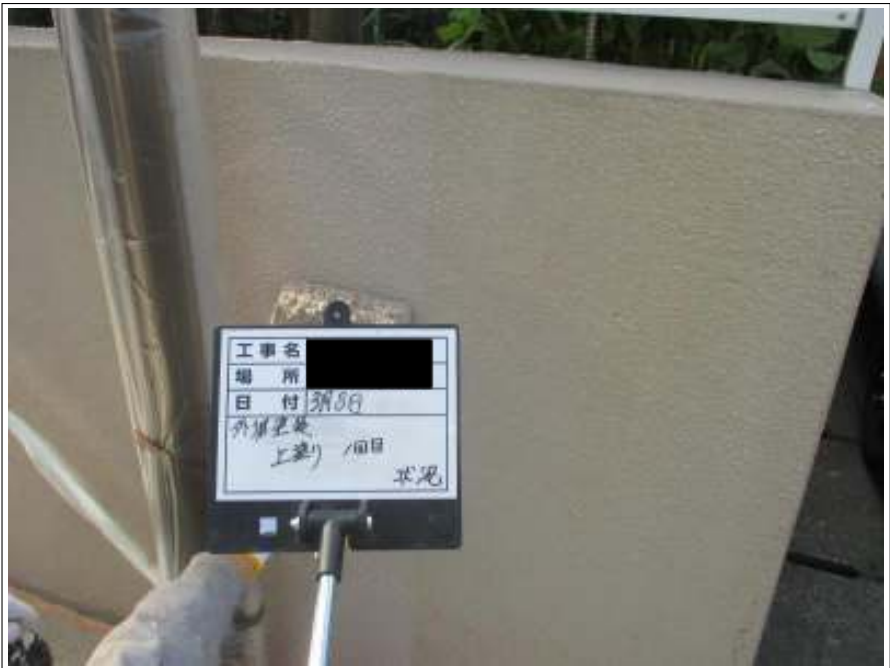
塀塗装上塗り 1 回目施工中
