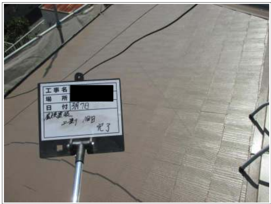
屋根塗装上塗り施工完了
