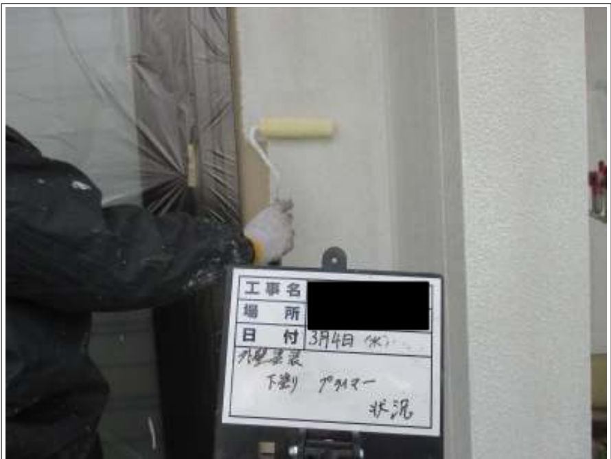
外壁塗装下塗り施工中
