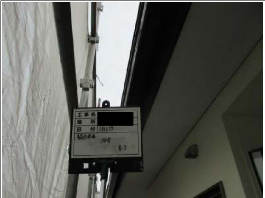
縦樋塗装 1 回目施工完了
