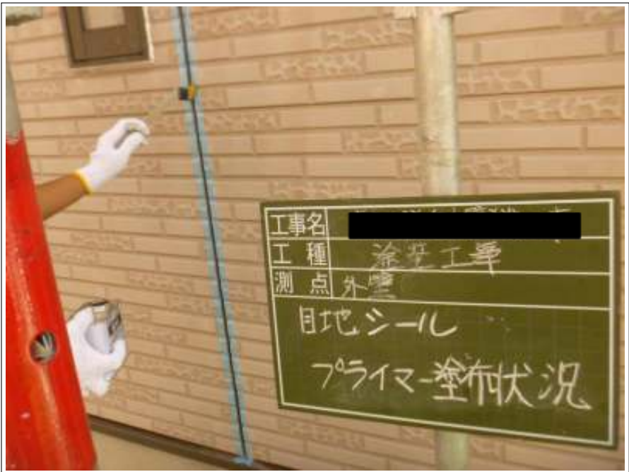
外壁 プライマー塗布施工中
