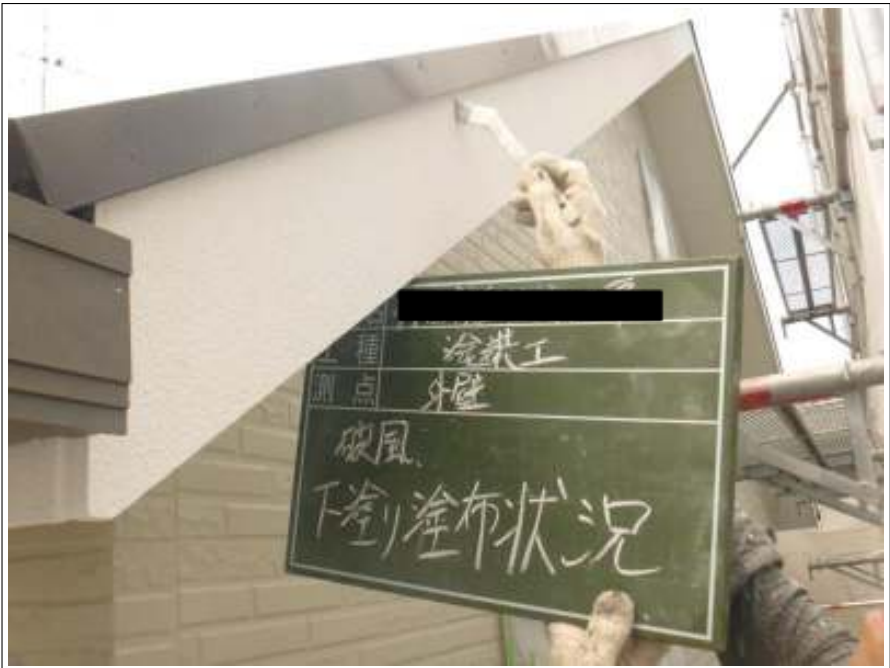
破風板 下塗り施工中
