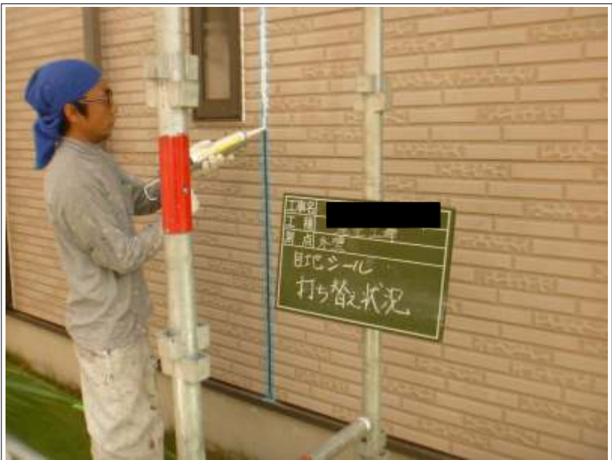
外壁 シーリング打ち替え施工中
