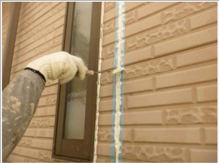
外壁 シーリング打ち替え施工中
