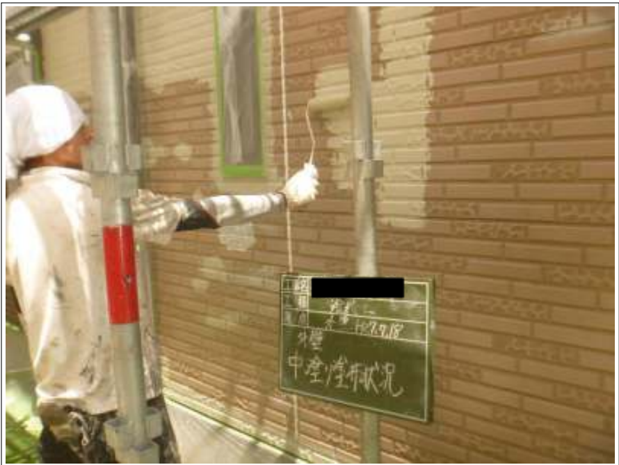
外壁 中塗り施工中
