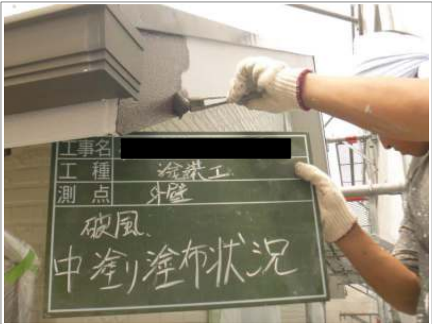
破風板 中塗り施工中
