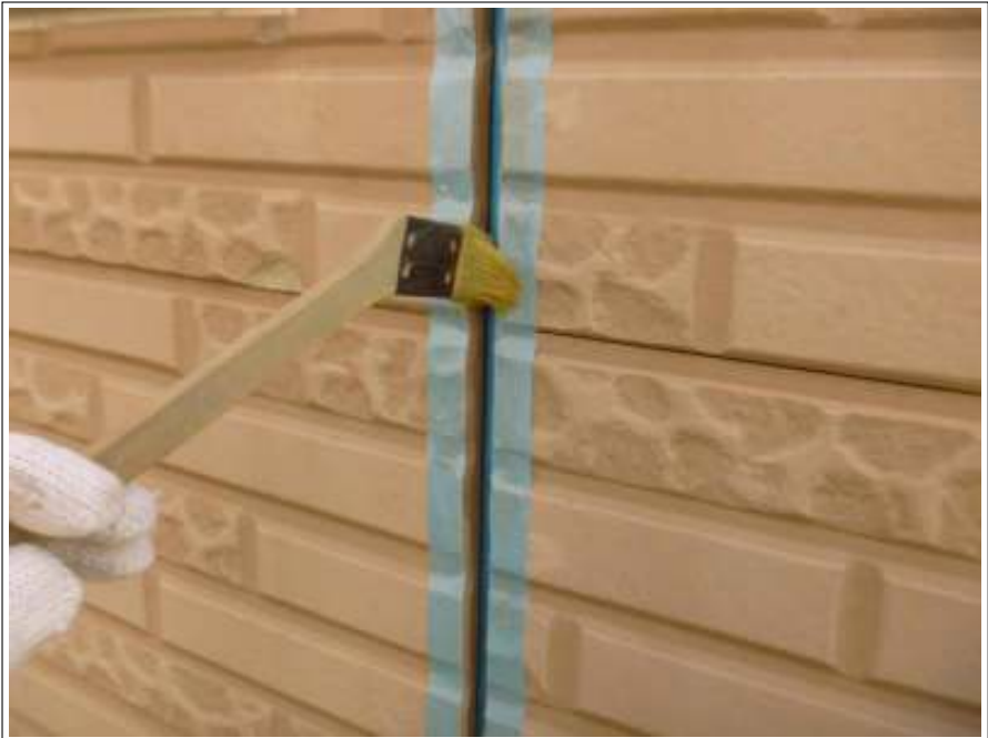
外壁 プライマー塗布施工中
