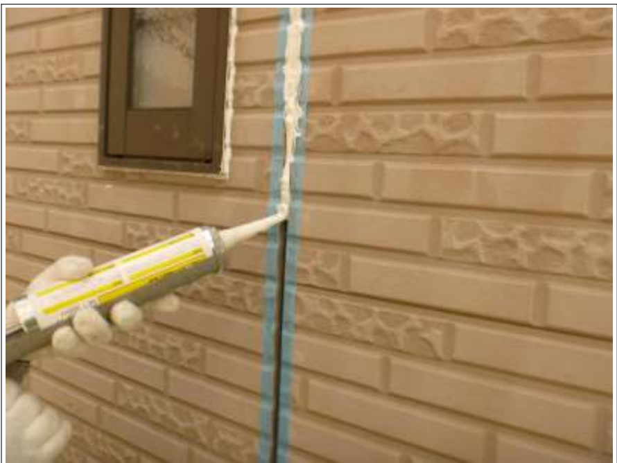
外壁 シーリング打ち替え施工中
