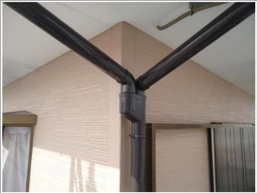
樋塗装施工完了
