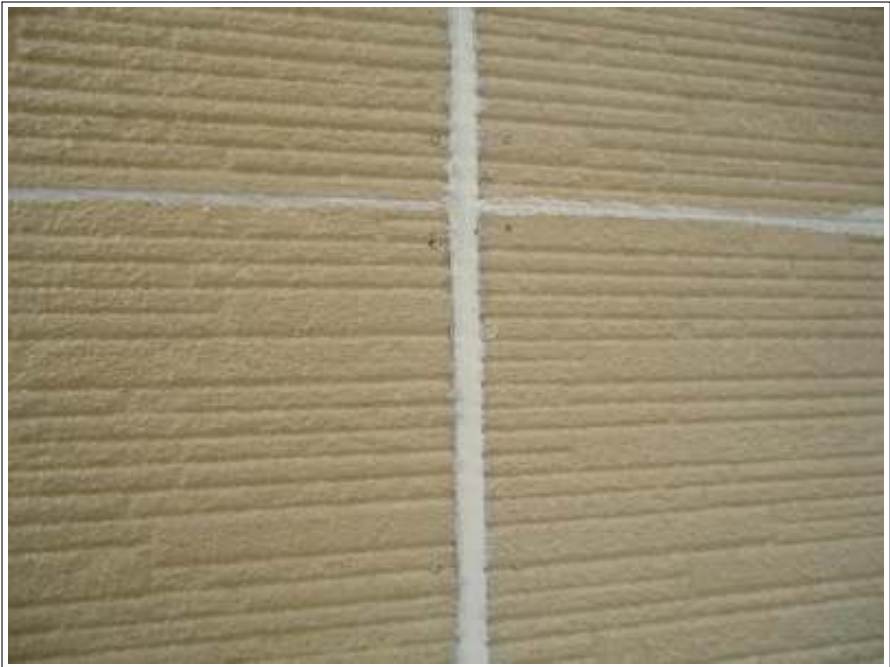
コーキング補修施工完了
