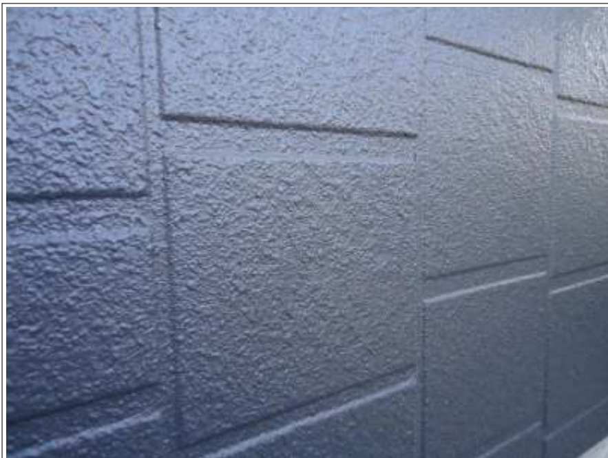
外壁（1階）上塗り施工完了
