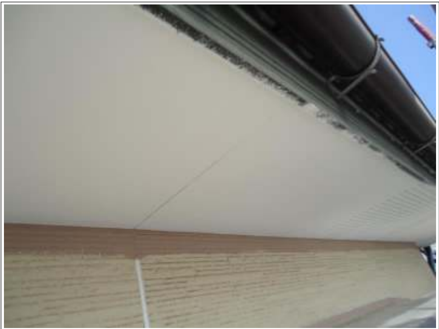
軒天塗装施工完了
