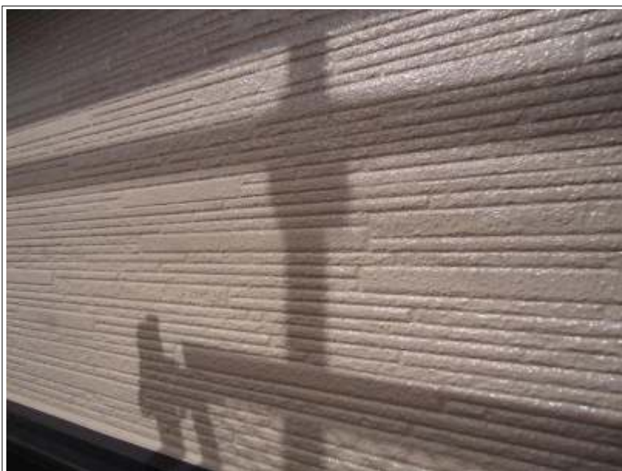
外壁（2階）中塗り施工完了
