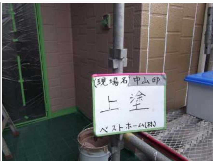
外壁（玄関部）上塗り施工中
