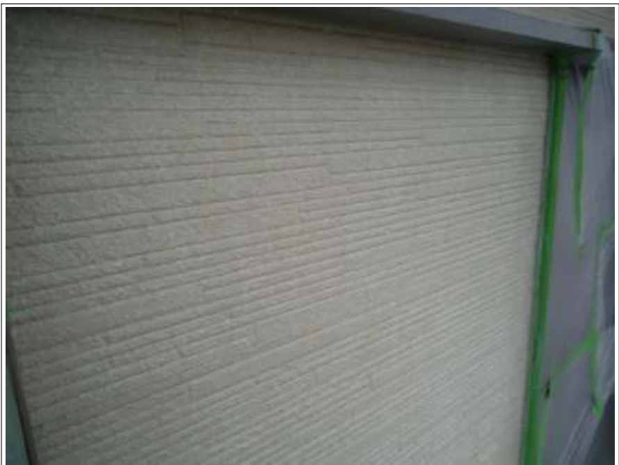
外壁下塗り施工完了
