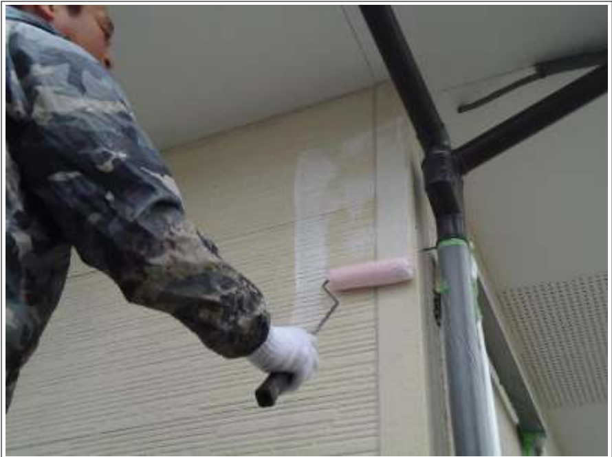
外壁（2階）下塗り施工中
