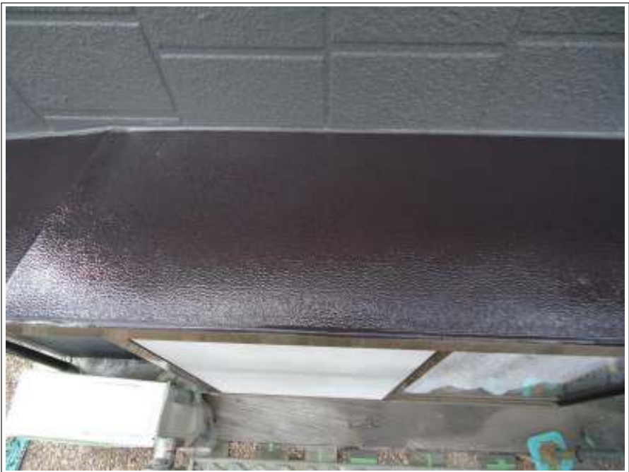
小庇塗装施工完了
