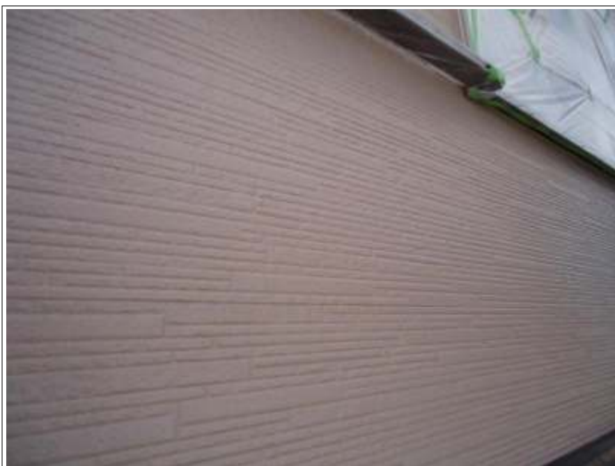
外壁（2階）上塗り施工完了
