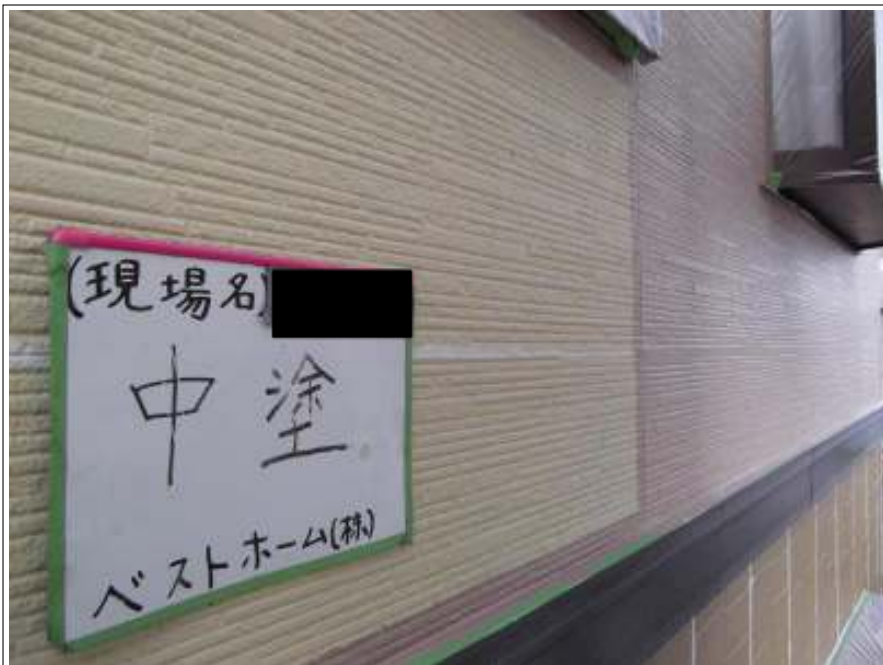
外壁（2階）中塗り施工中
