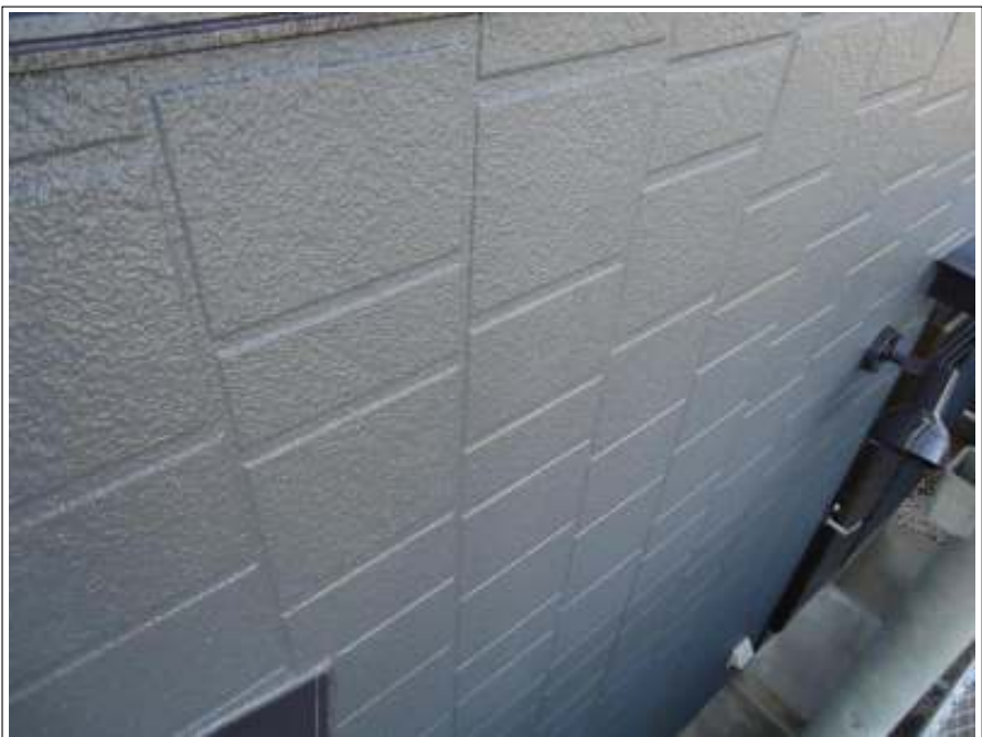
外壁（1階）中塗り施工完了
