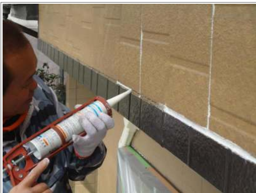
コーキング補修施工中
