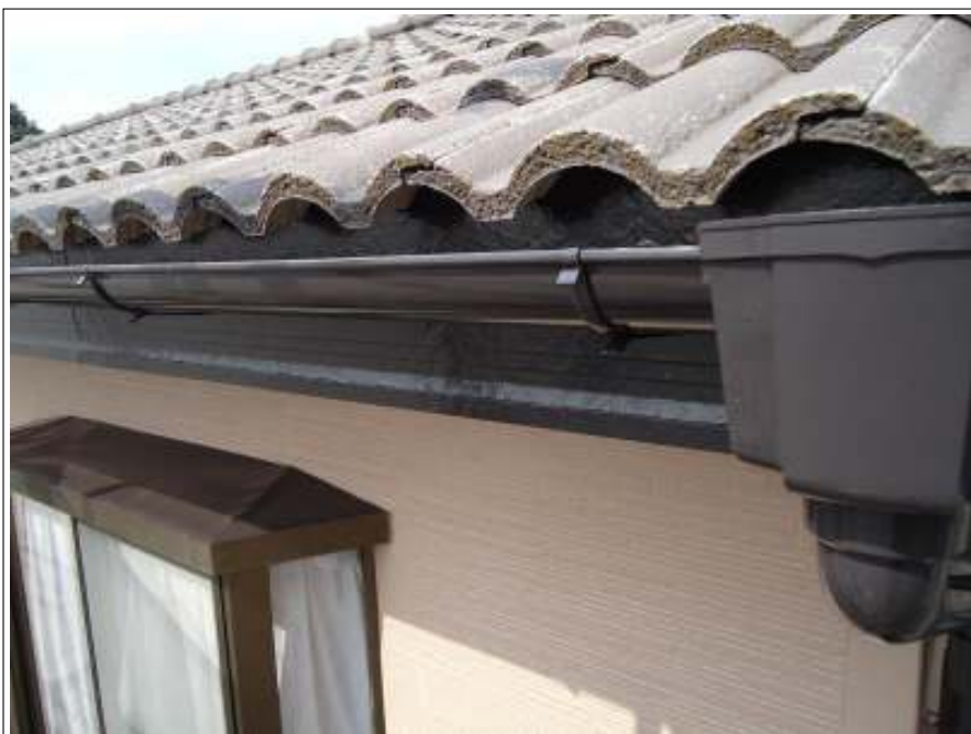
樋塗装施工完了
