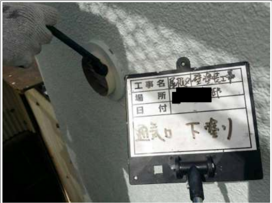
通気口 下塗り施工中
