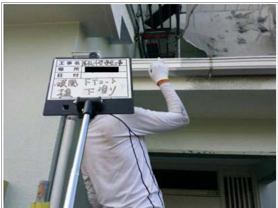
破風・樋 下塗り施工中
