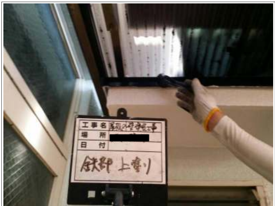
鉄部 上塗り施工中
