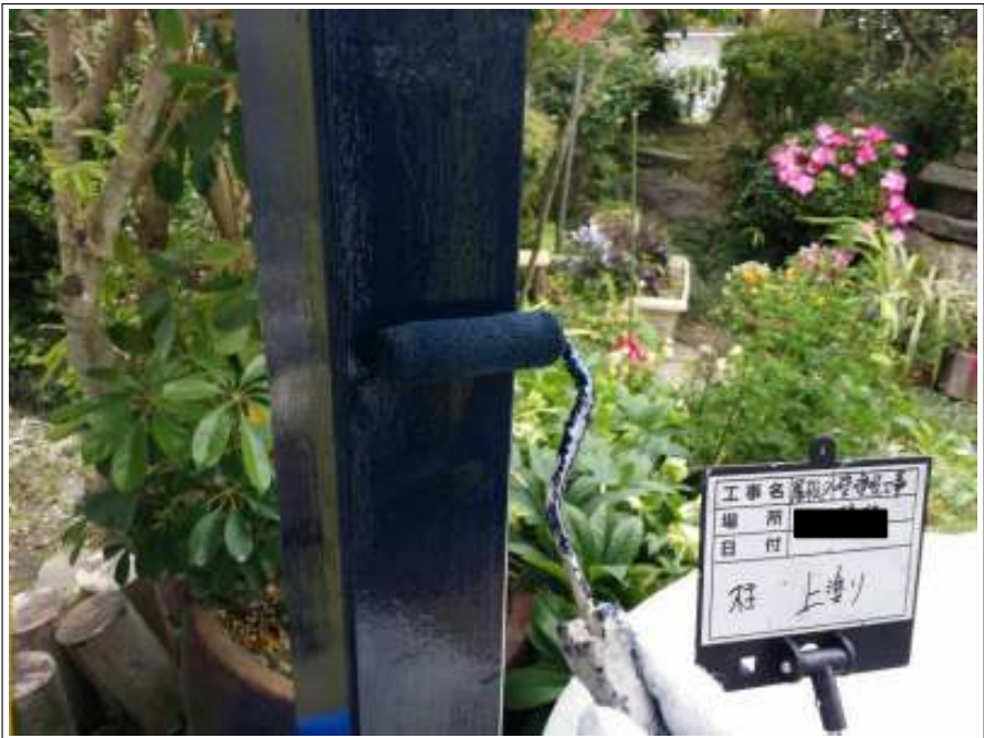
玄関柱 上塗り施工中
