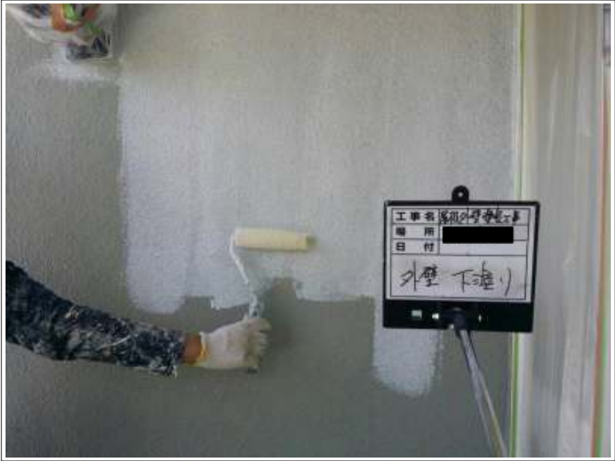
外壁 下塗り施工中
