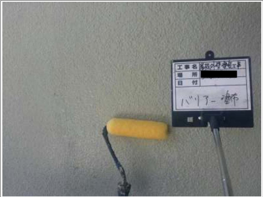
外壁 バリヤー施工中
