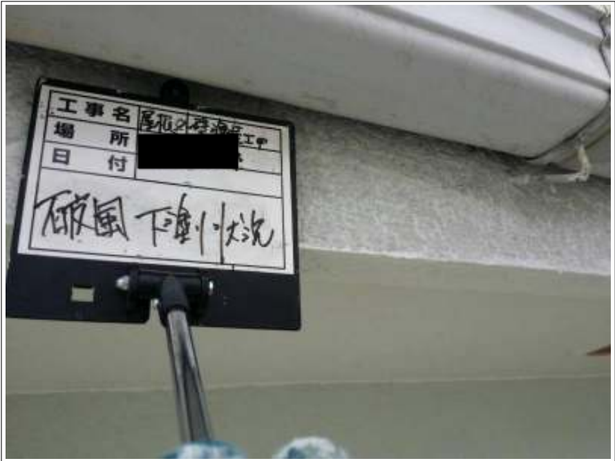
破風 下塗り施工中
