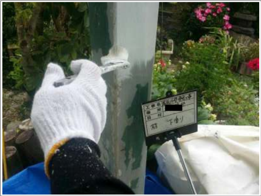
玄関柱 下塗り施工中
