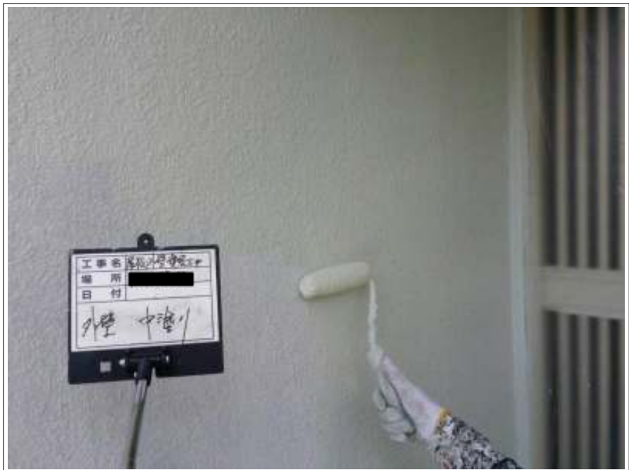
外壁 中塗り施工中
