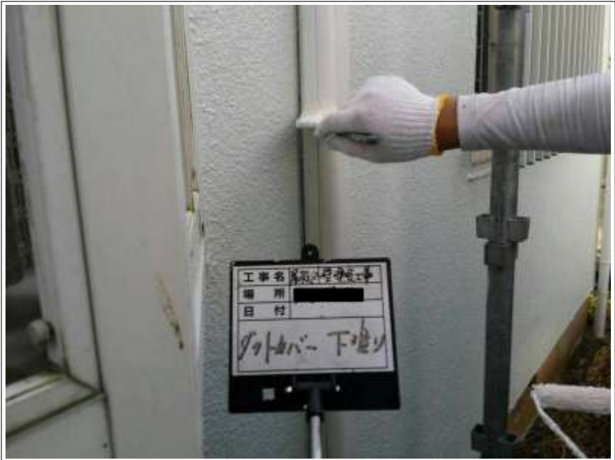
ダクトカバー 下塗り施工中
