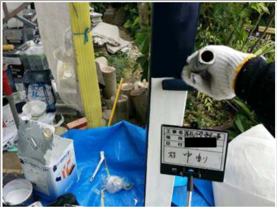
玄関柱 中塗り施工中
