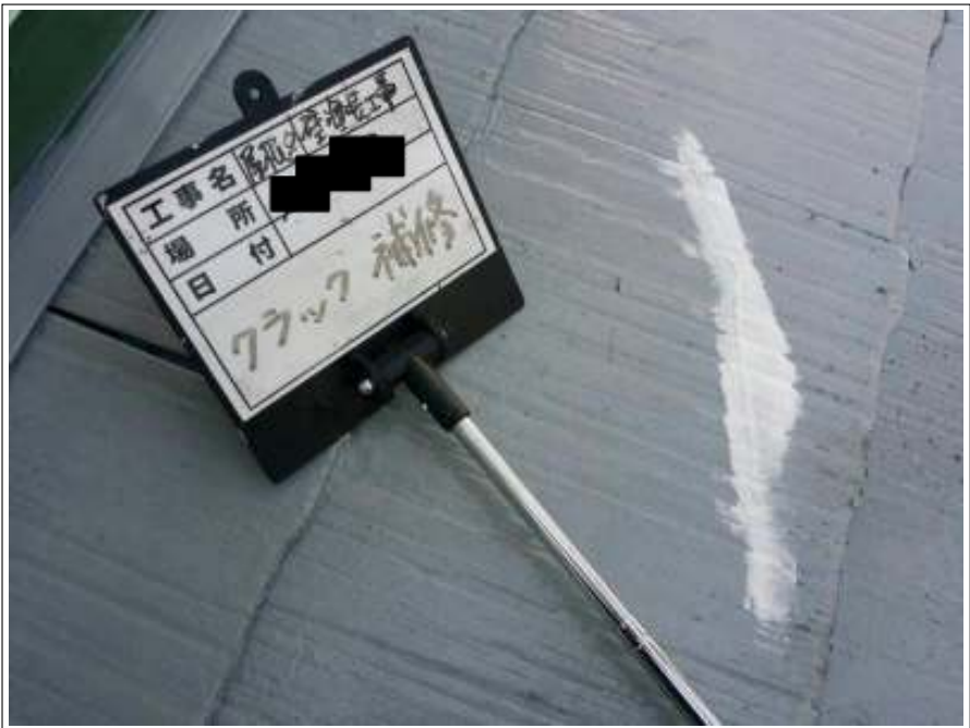
屋根 クラック補修施工完了
