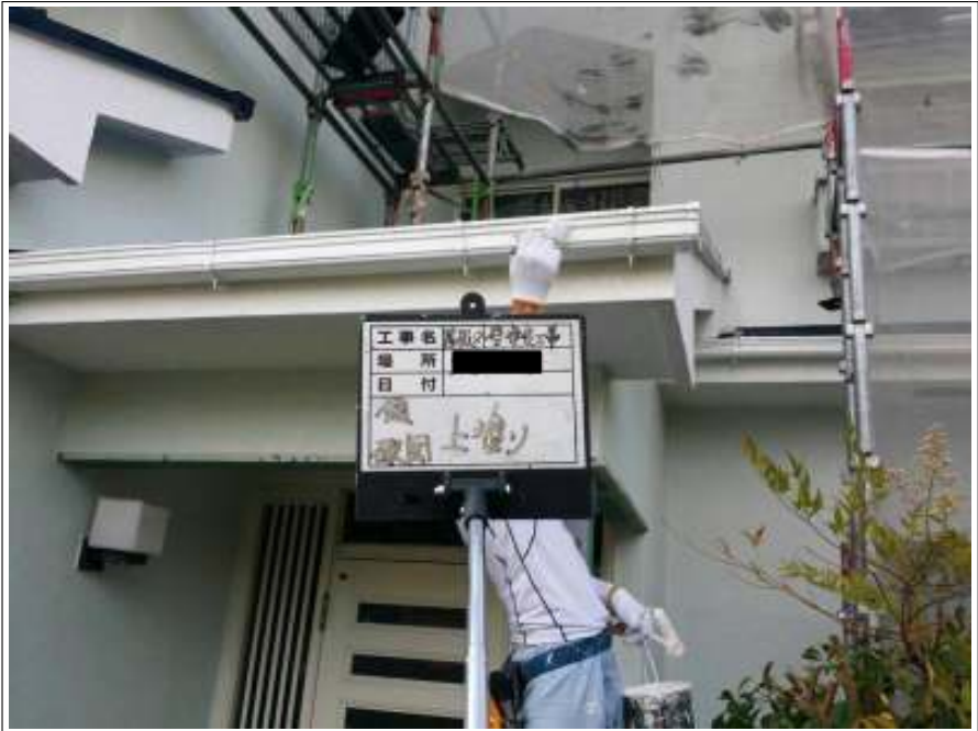
破風・樋 上塗り施工中
