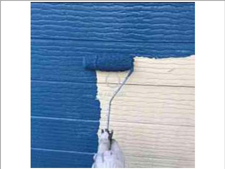
外壁 中塗り施工中
