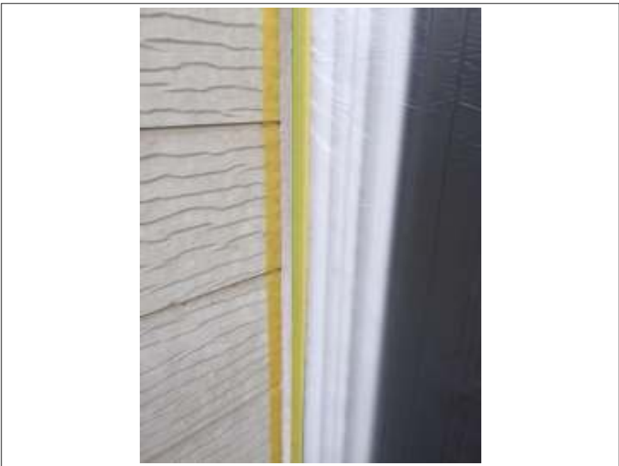
サッシ廻り シーリング打ち増し施工前
