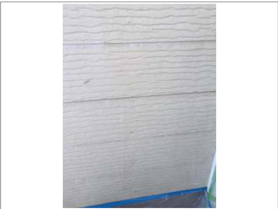
外壁 下塗り施工完了
