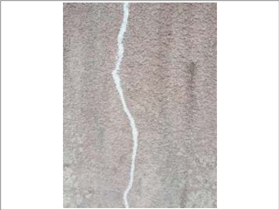
外壁 クラック補修施工完了
