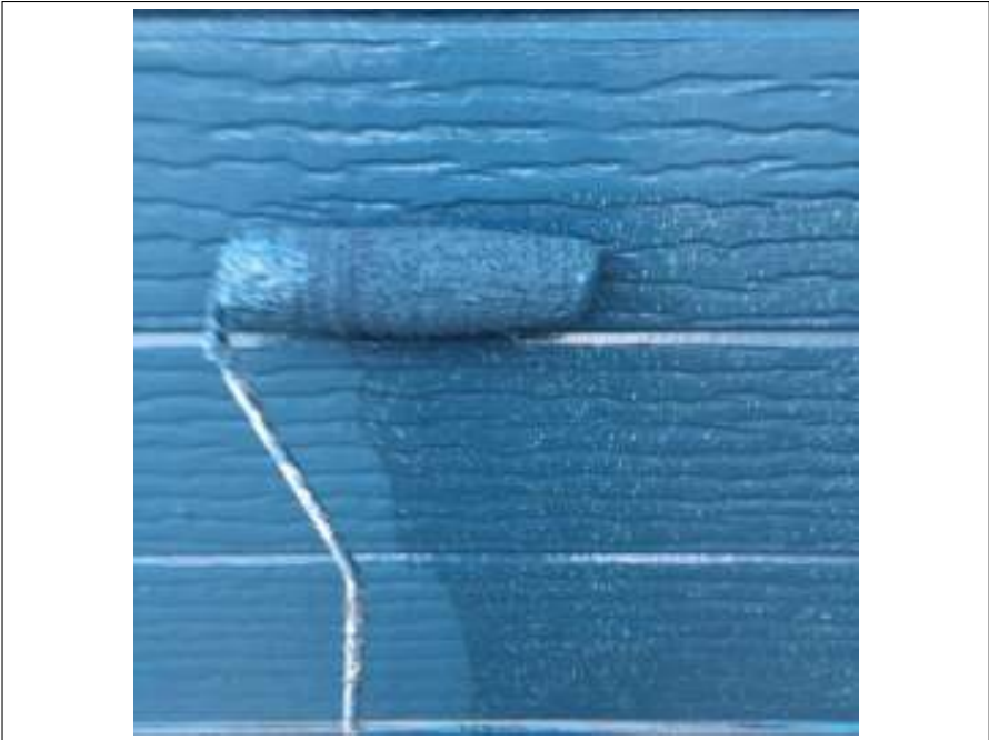
外壁 上塗り施工中
