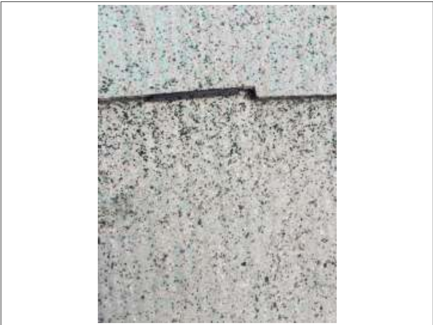
屋根 タスペーサー取付 施工完了
