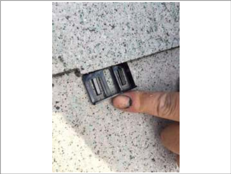
屋根 タスペーサー取付 施工中
