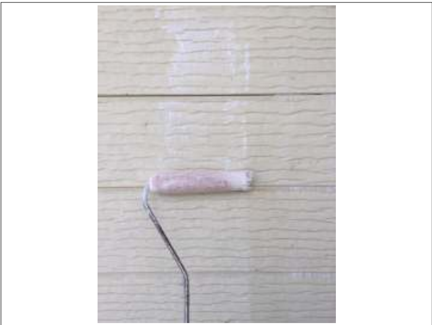
外壁 下塗り施工中
