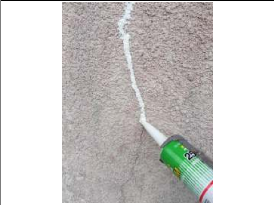
外壁 クラック補修施工中
