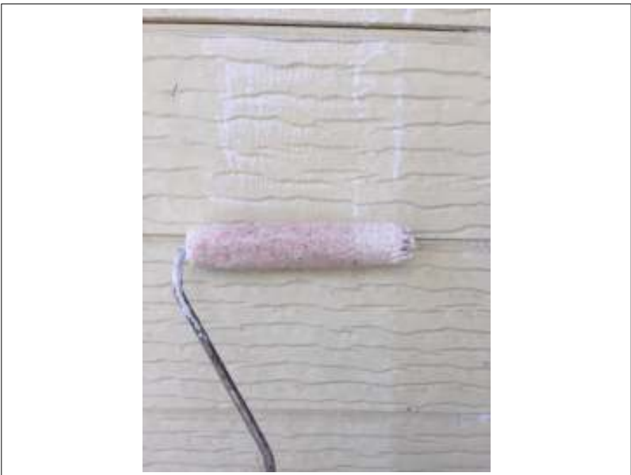
外壁 下塗り施工中
