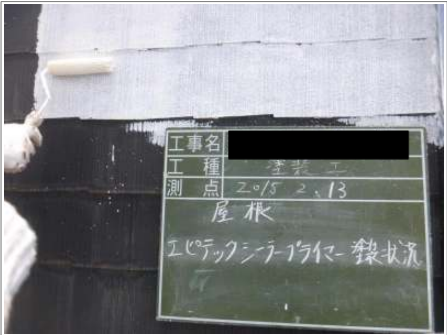
屋根塗装下塗り施工中
