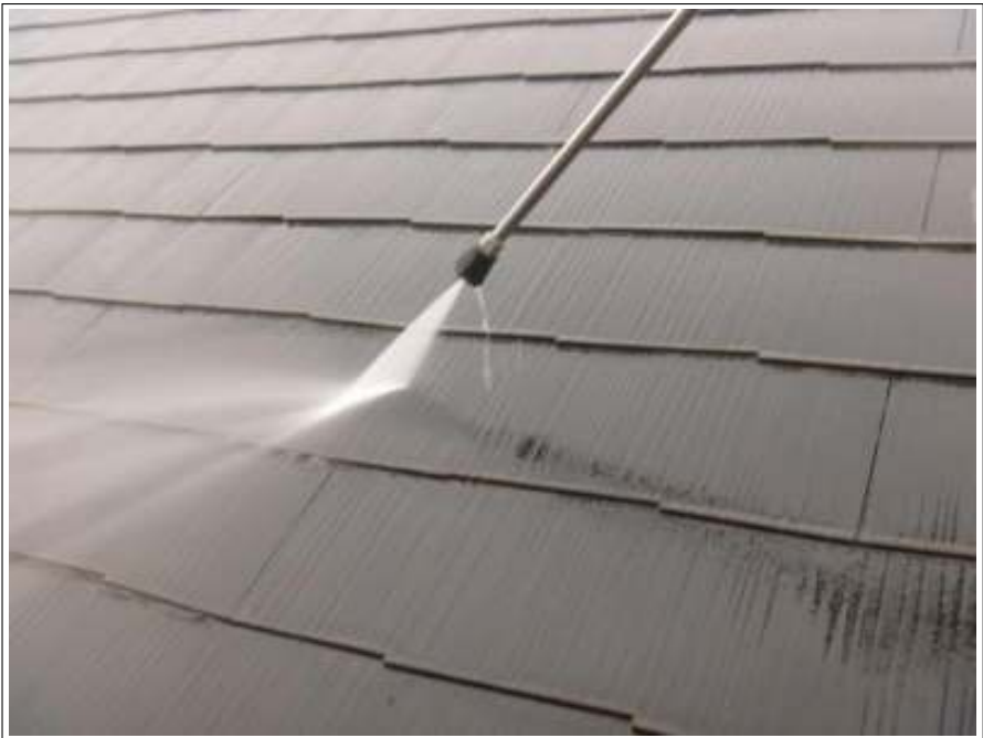
屋根高圧洗浄施工中
