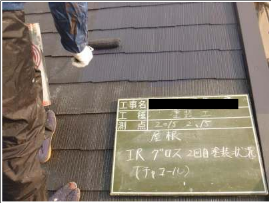
屋根塗装上塗り施工中
