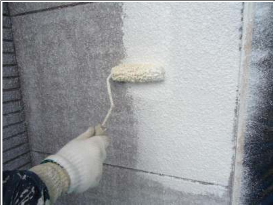
外壁塗装下塗り 2 回目施工中
