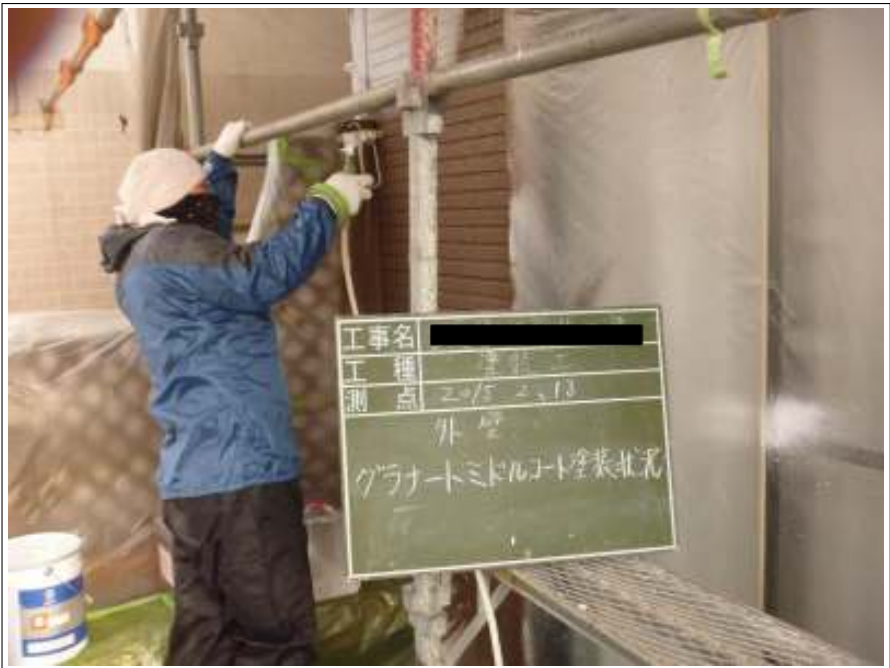
外壁塗装中塗り施工中
