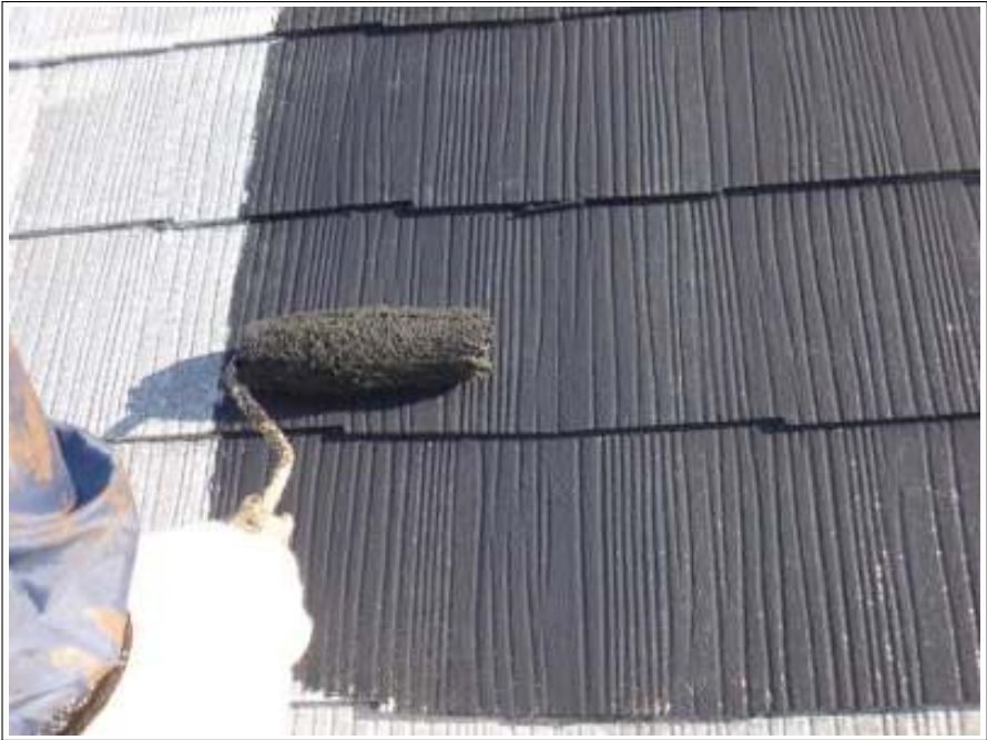
屋根塗装中塗り施工中
