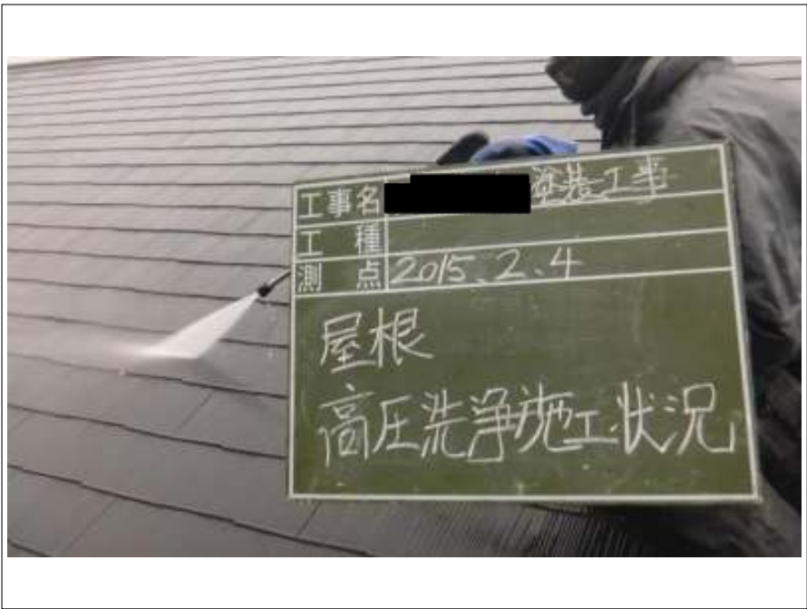
屋根高圧洗浄施工中
