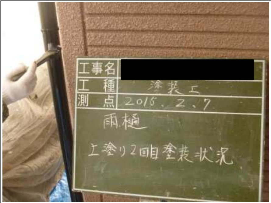
樋塗装2回目施工中
