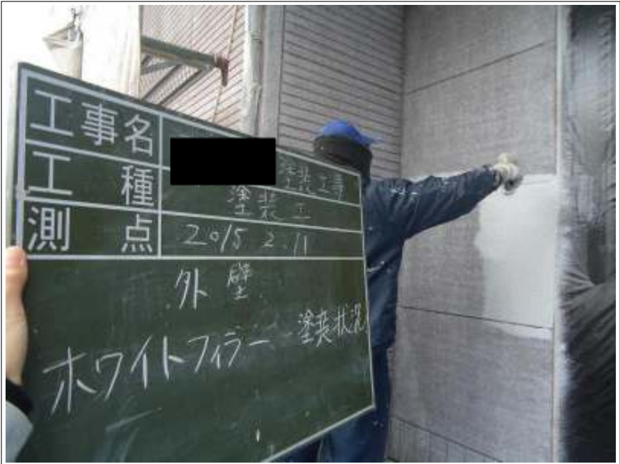
外壁塗装下塗り 2 回目施工中
