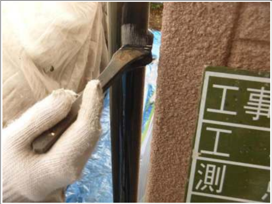
樋塗装2回目施工中
