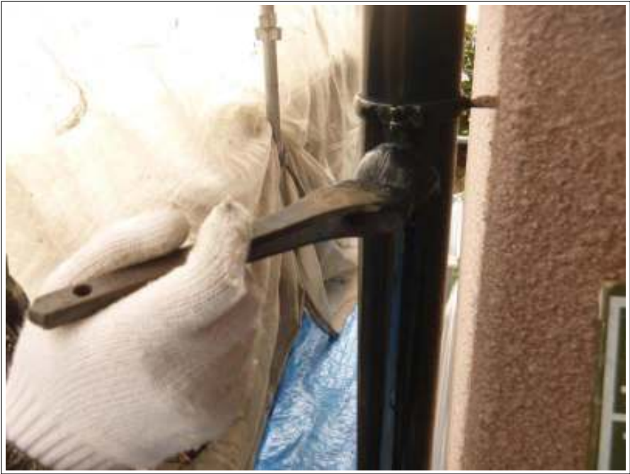
樋塗装 1 回目施工中
