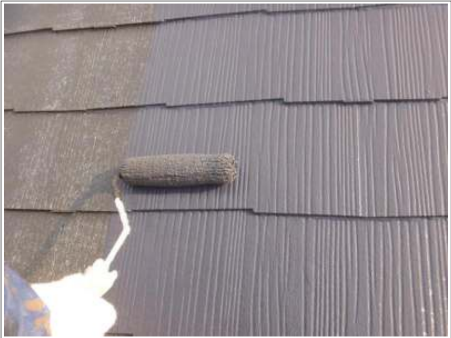
屋根塗装上塗り施工中
