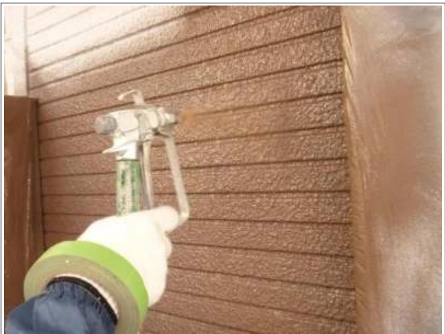
外壁塗装中塗り施工中
