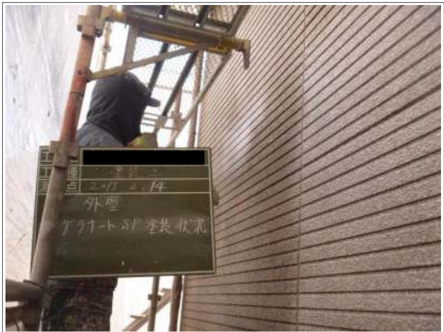
外壁塗装上塗り施工中
