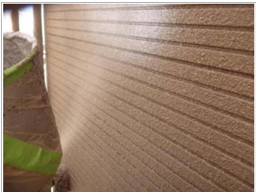
外壁塗装上塗り施工中
