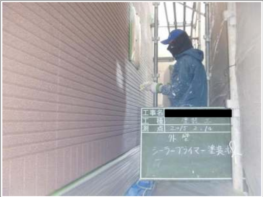
外壁塗装下塗り 1 回目施工中
