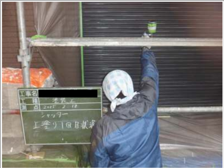
シャッター塗装 1 回目施工中
