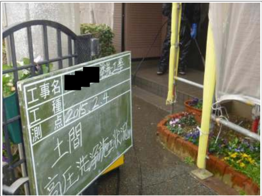
土間高圧洗浄施工中
