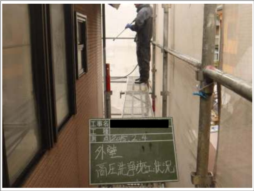
外壁高圧洗浄施工中
