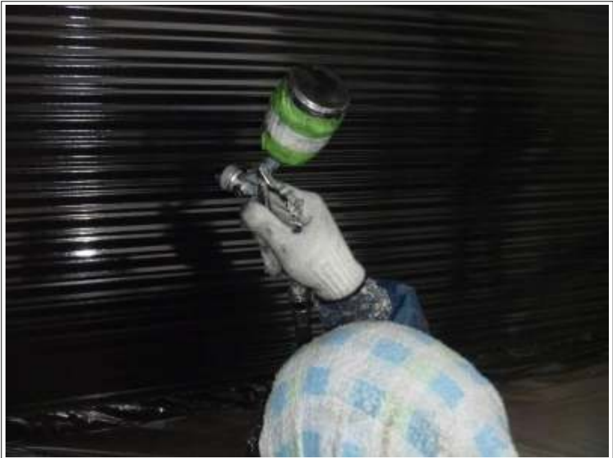
シャッター塗装 2 回目施工中
