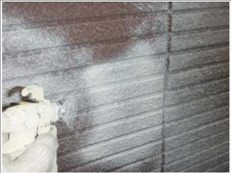
外壁塗装下塗り 1 回目施工中
