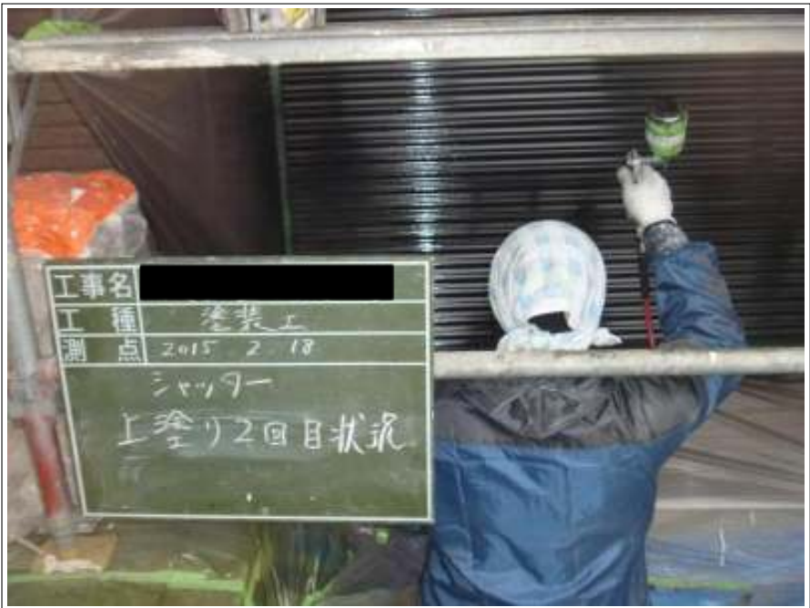
シャッター塗装 2 回目施工中
