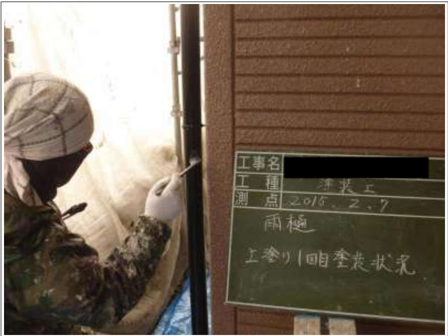
樋塗装 1 回目施工中
