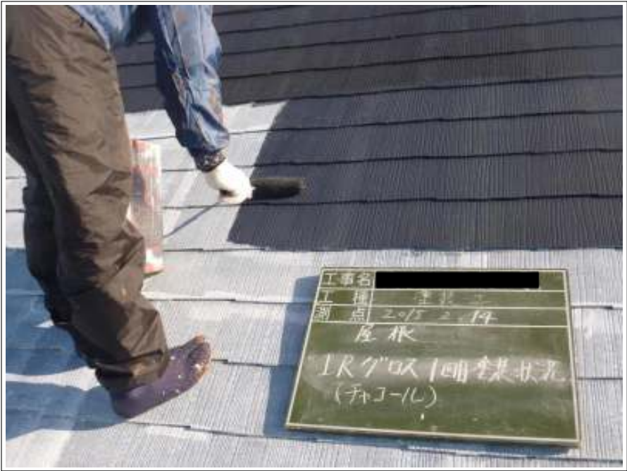
屋根塗装中塗り施工中
