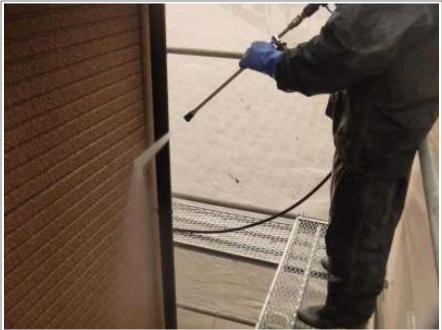
外壁高圧洗浄施工中
