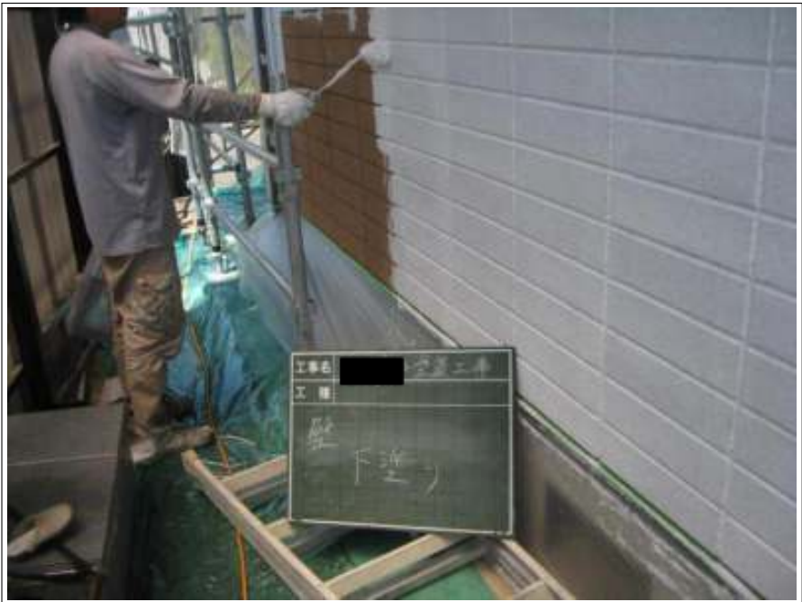
外壁 下塗り施工中
