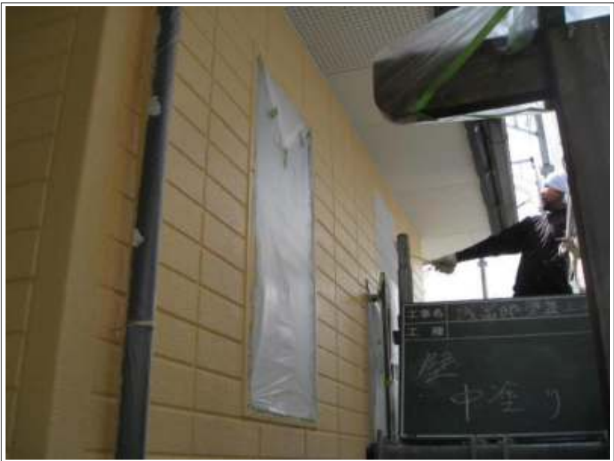
外壁 中塗り施工中
