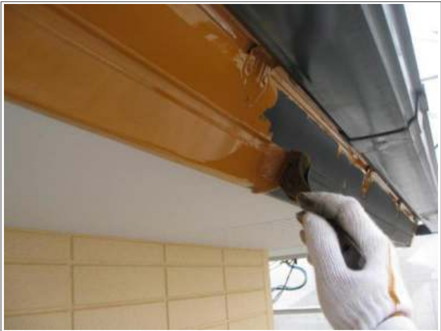
破風板 上塗り施工中
