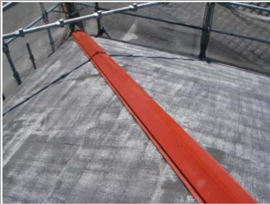
棟鉄板 サビ止め施工中
