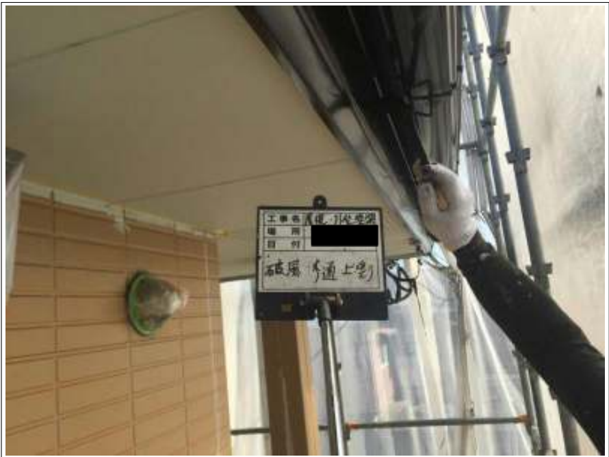
破風板・樋 上塗り施工中
