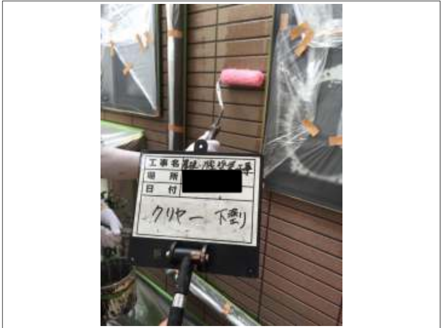
外壁 クリヤー下塗り施工中
