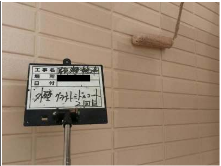
外壁 中塗り施工中 (2回目)
