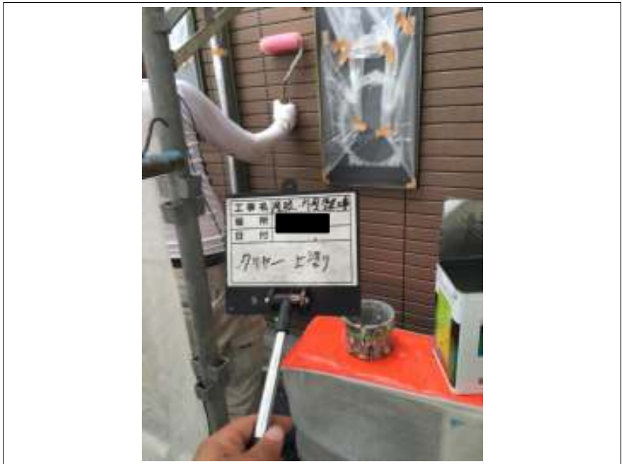
外壁 クリヤー上塗り施工中
