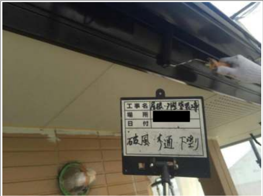
破風板・樋 下塗り施工中
