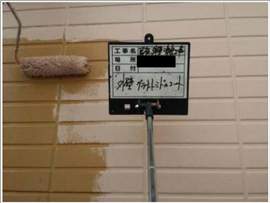
外壁 中塗り施工中 (1回目)
