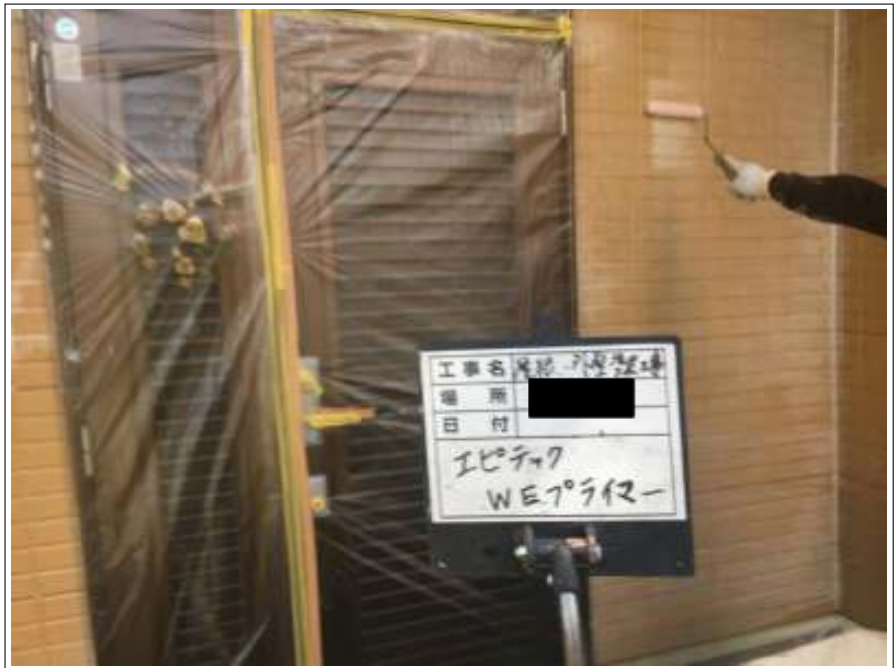
外壁 下塗り施工中
