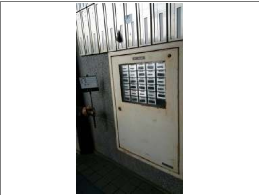
メーターBOX 施工前
