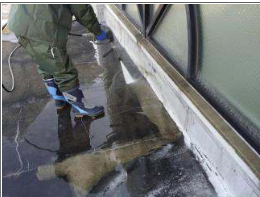
屋上防水部 高压洗净中
