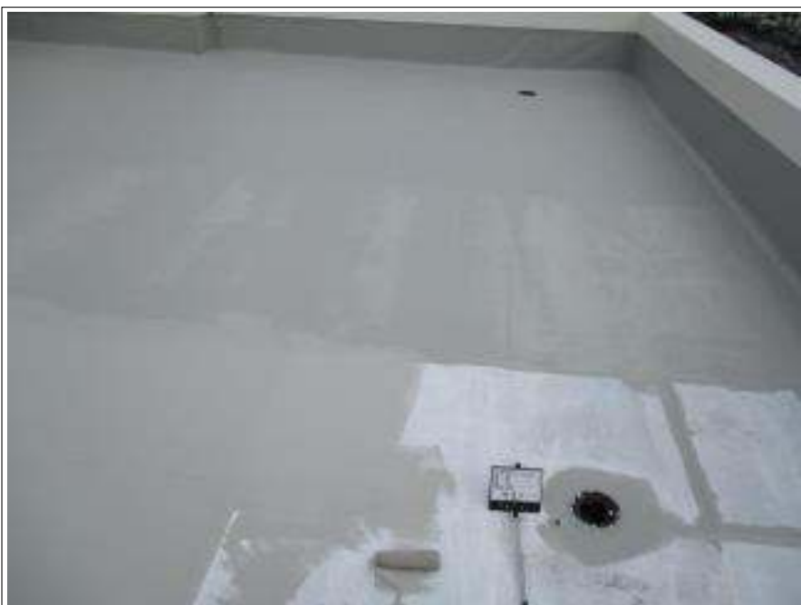
屋上防水部 中塗り施工中
