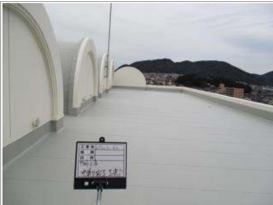
屋上防水部 中塗り施工後
