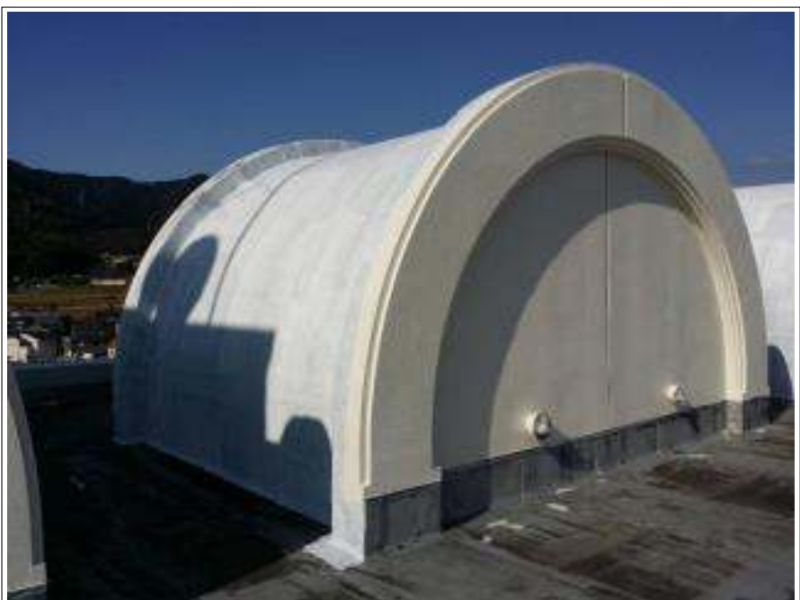
屋上モルタル部 中塗り施工後
