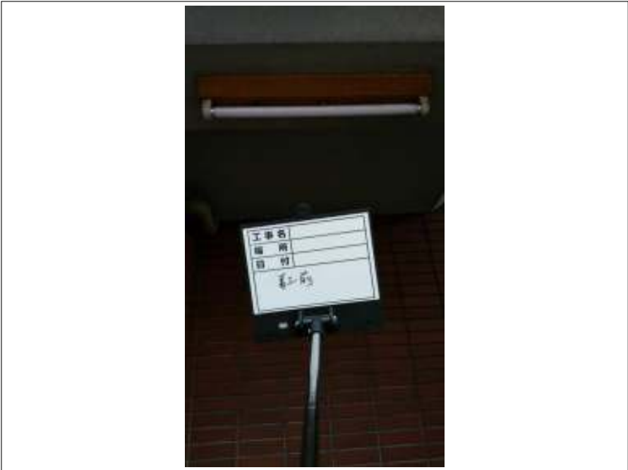
蛍光灯カバー 施工前
