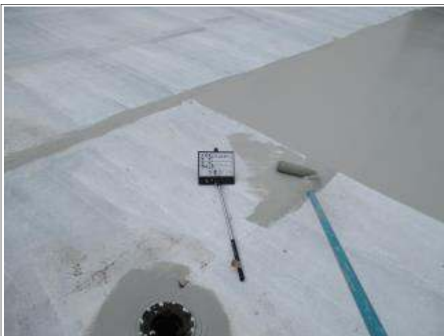
屋上防水部 中塗り施工中
