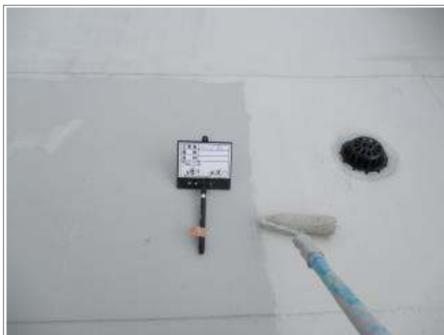
屋上防水部 上塗り施工中
