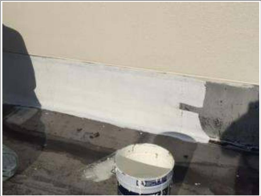
屋上防水部 下塗り施工中
