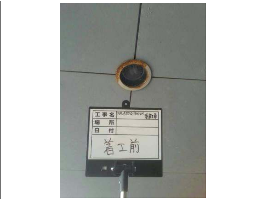
ダウンライト 施工前
