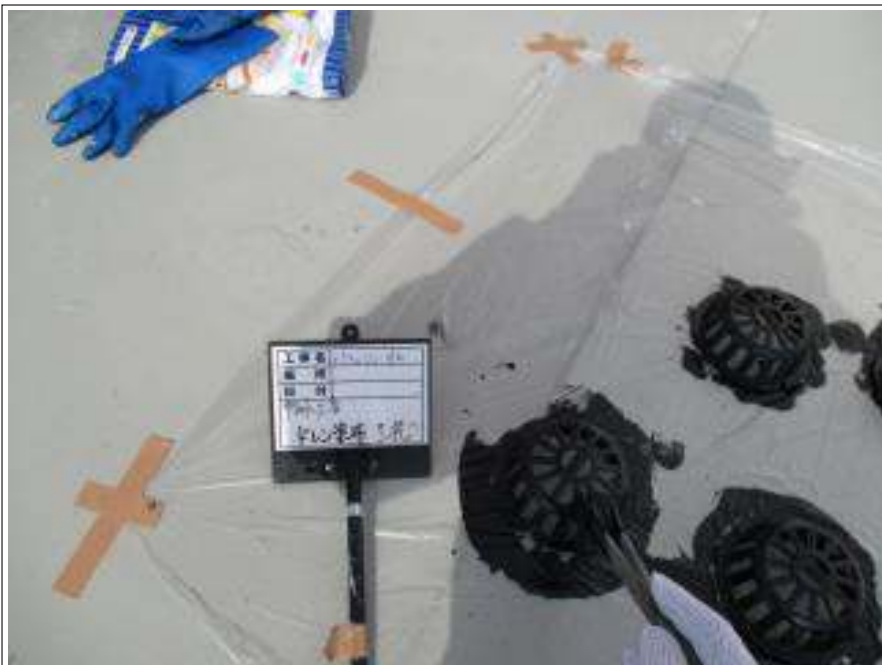
ドレン 上塗り施工中
