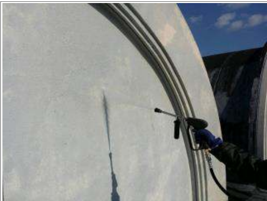
屋上防水部 高压洗净中
