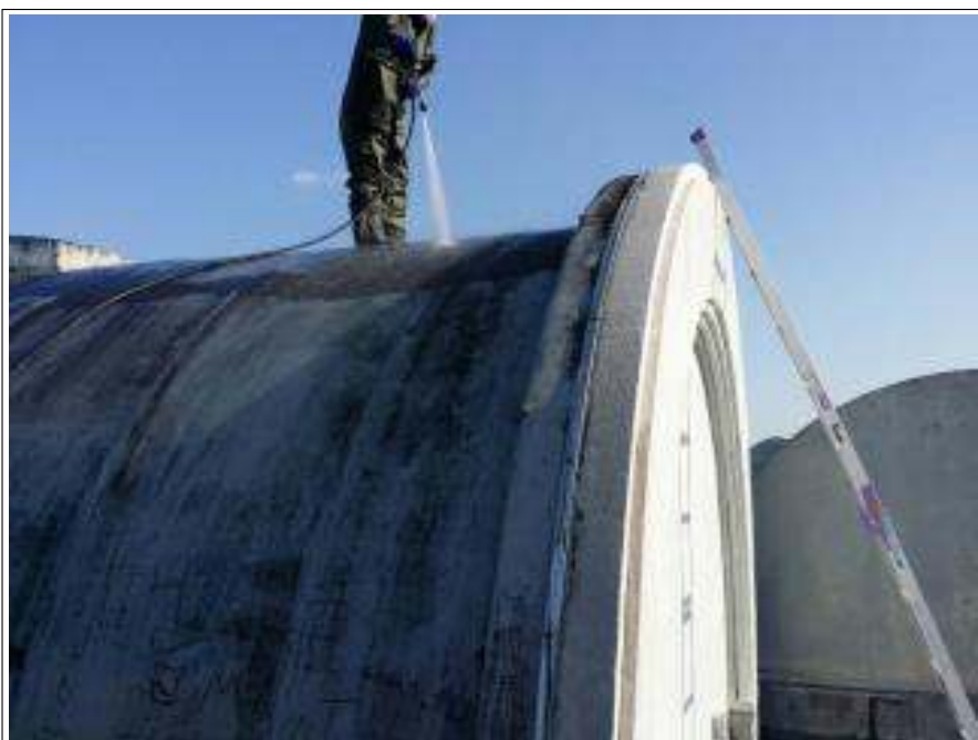
屋上防水部 高压洗净中
