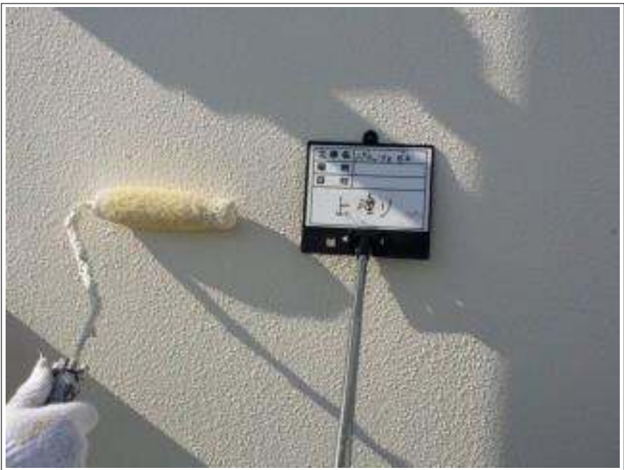
屋上モルタル部 上塗り施工後
