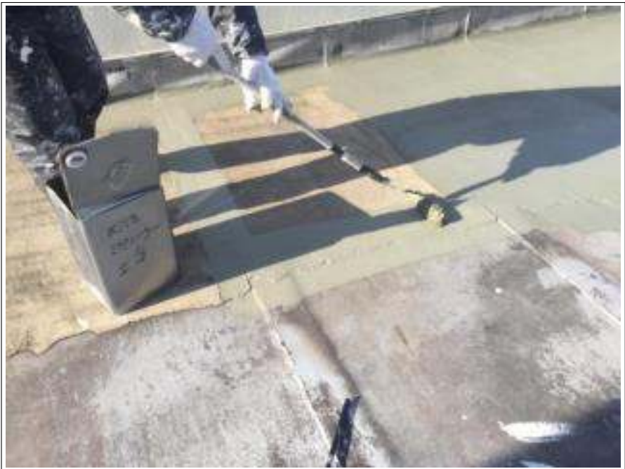
屋上防水部 樹脂モルタル補修
