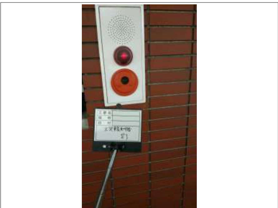
火災報知器 施工後
