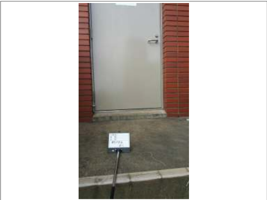
搭屋部鉄扉 施工後
