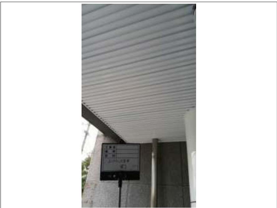
エントランス天井 施工後
