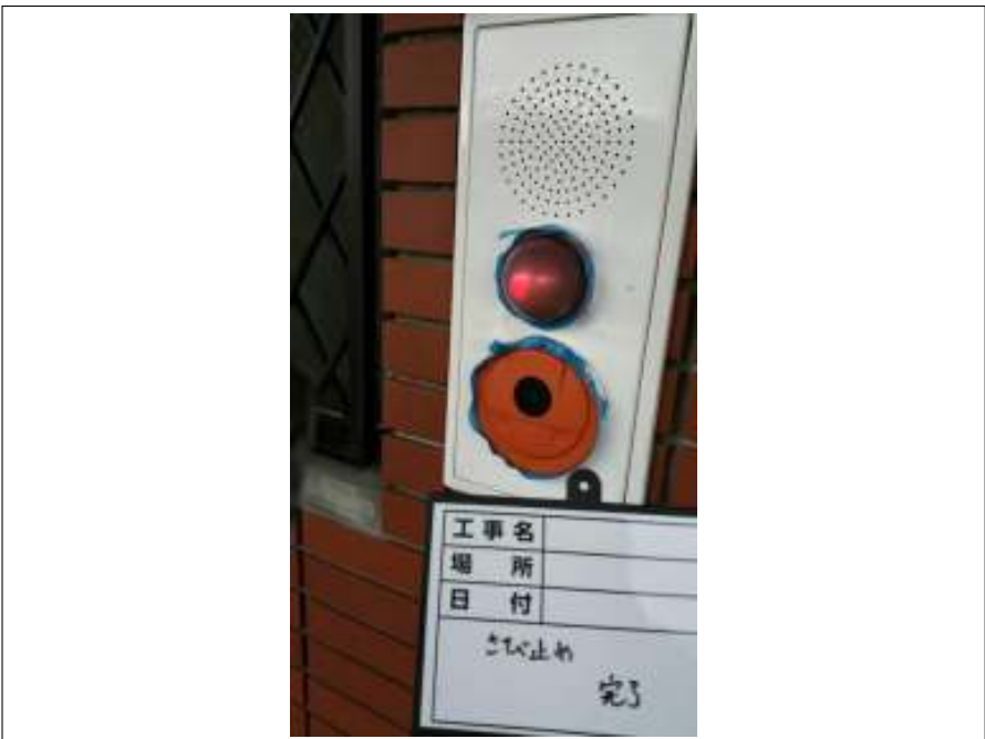
火災報知器 サビ止め塗布施工後
