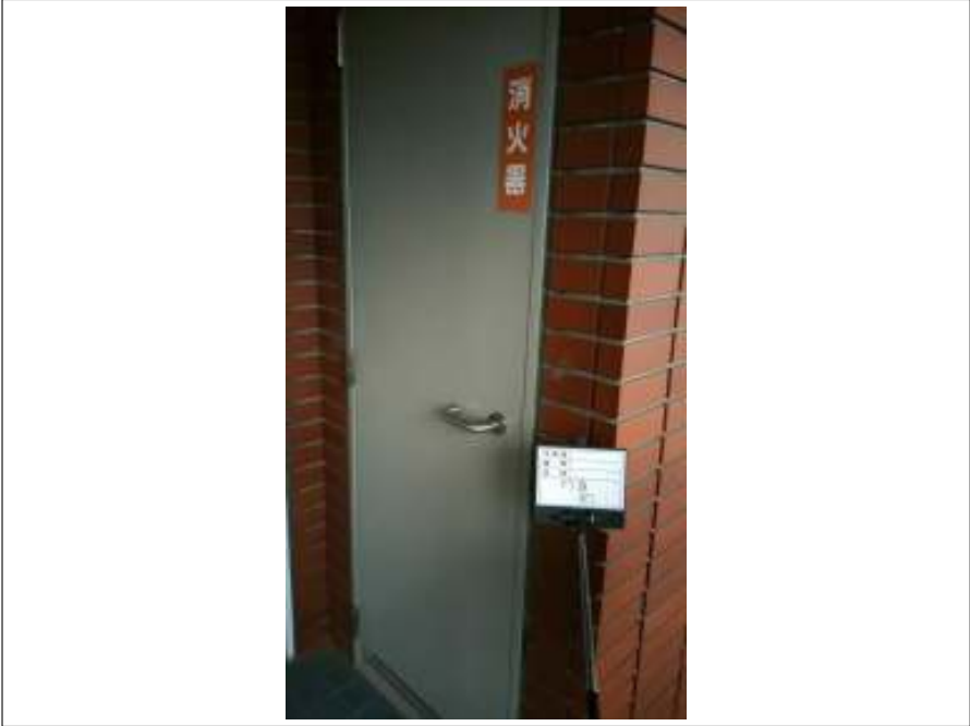
PS扉 施工後
