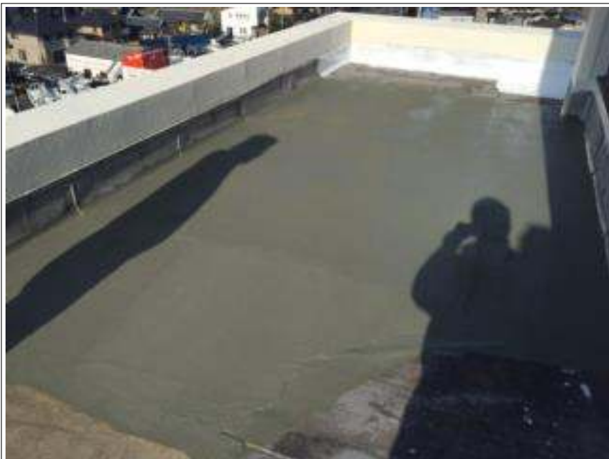
屋上防水部 樹脂モルタル補修
