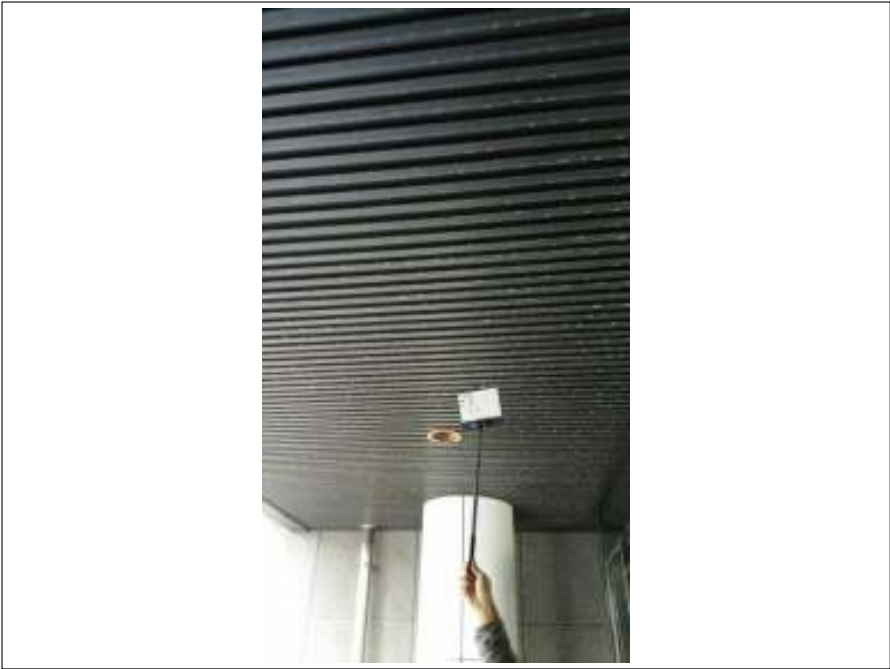
エントランス天井 施工前
