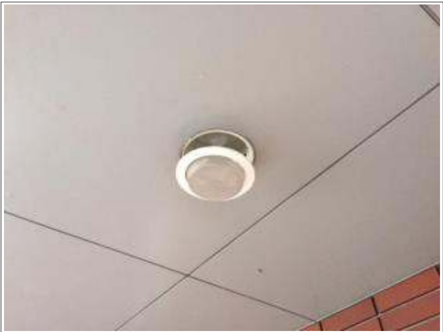
ダウンライト 施工中
