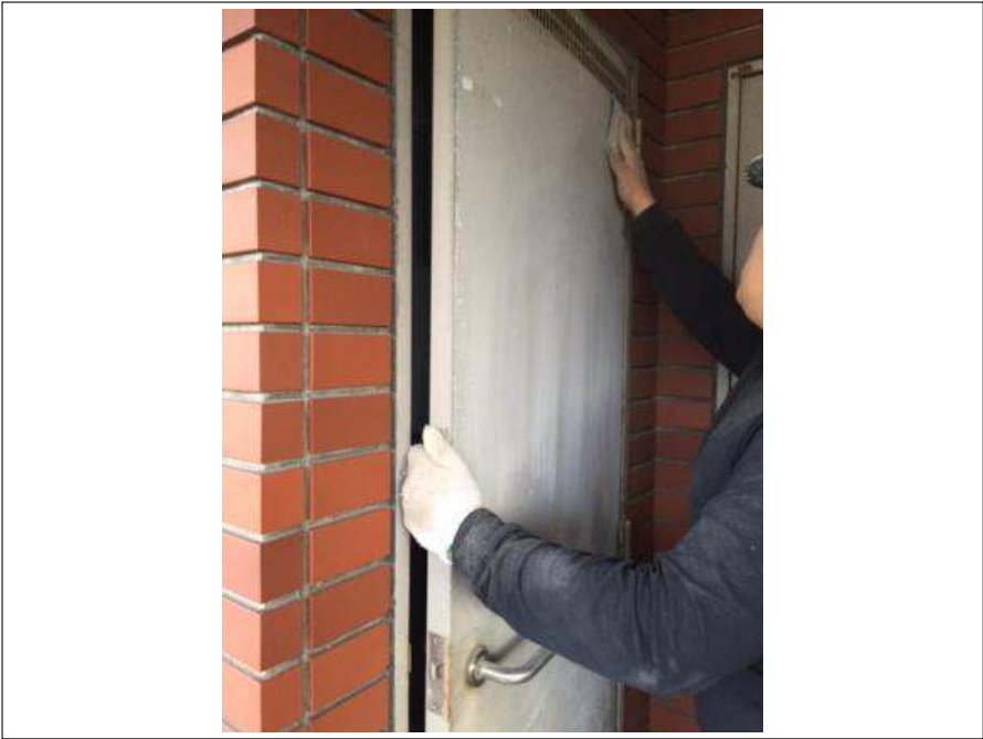
ケレン処理施工中
