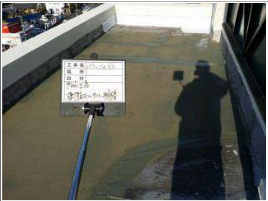
屋上防水部 樹脂モルタル補修
