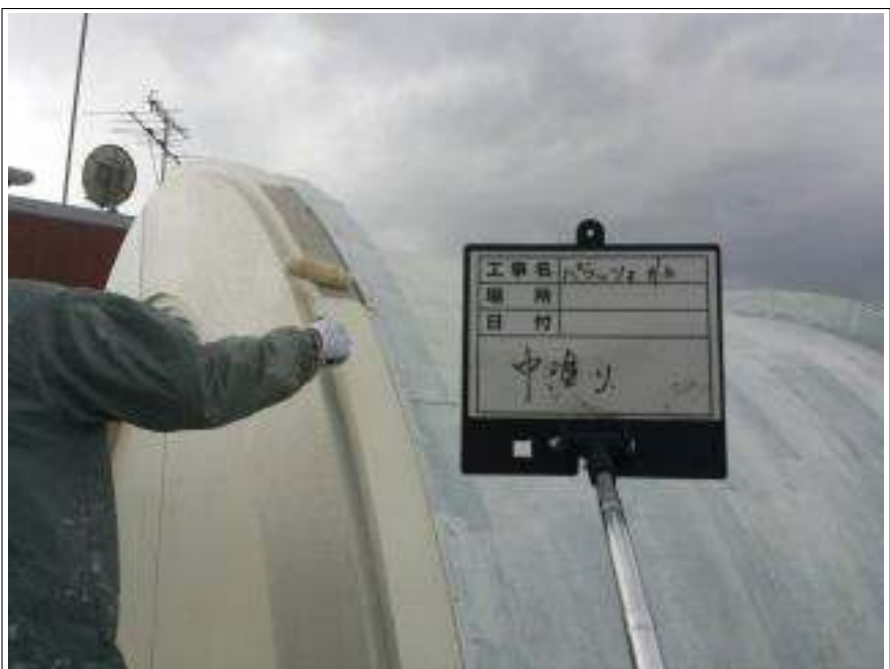
屋上モルタル部 中塗り施工中
