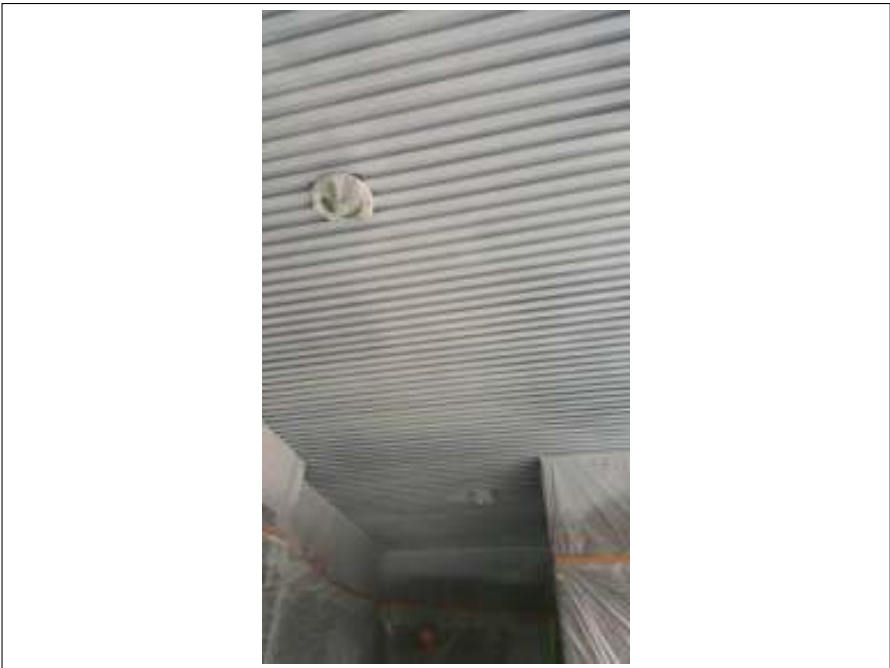
エントランス天井 下塗り施工後
