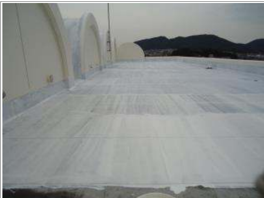
屋上防水部 下塗り施工中
