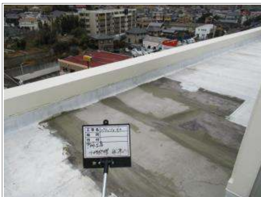
屋上防水部 下地補修
