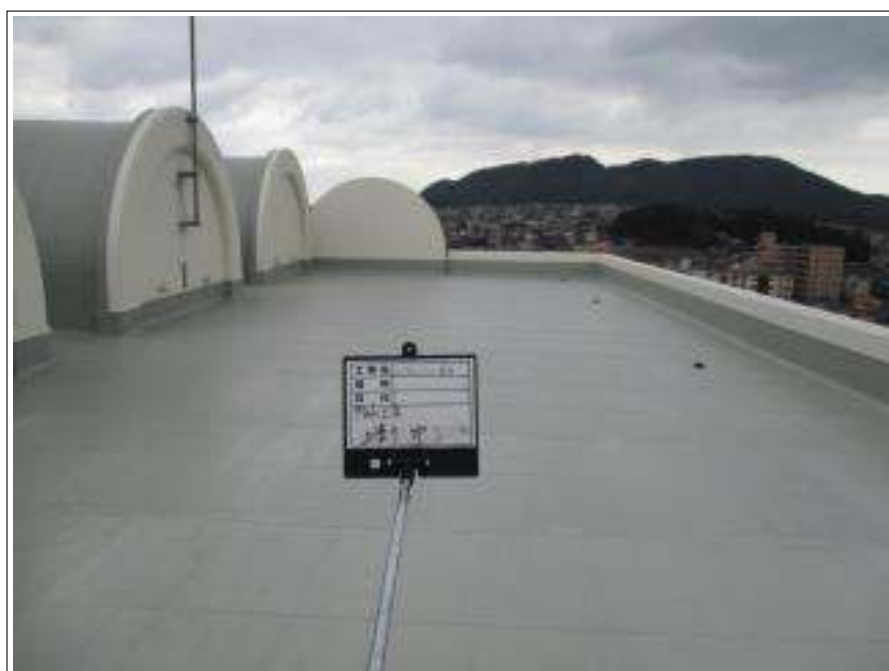
屋上防水部 上塗り施工後
