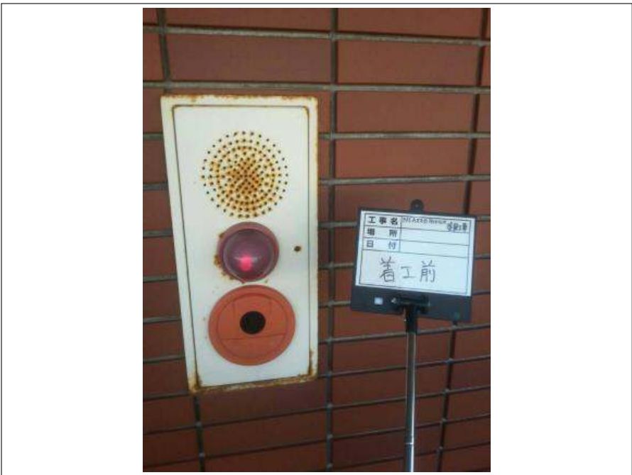
火災報知器 施工前
