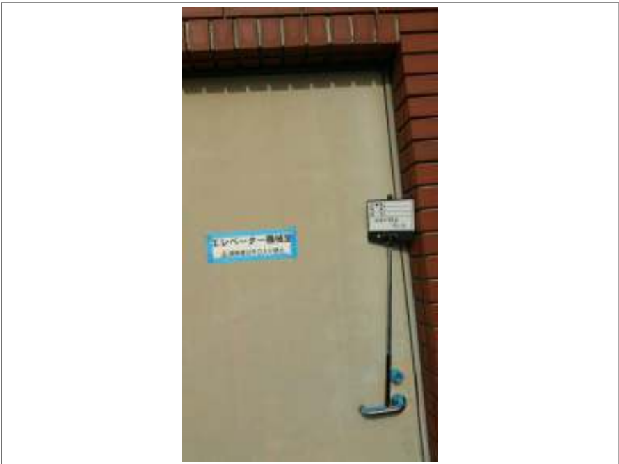
エレベーター室鉄扉 施工前
