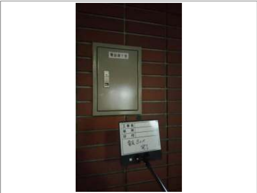
電気BOX 施工後
