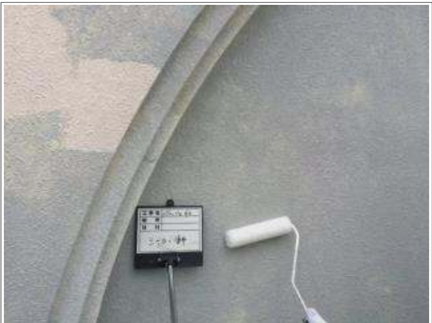
屋上モルタル部 下塗り施工中
