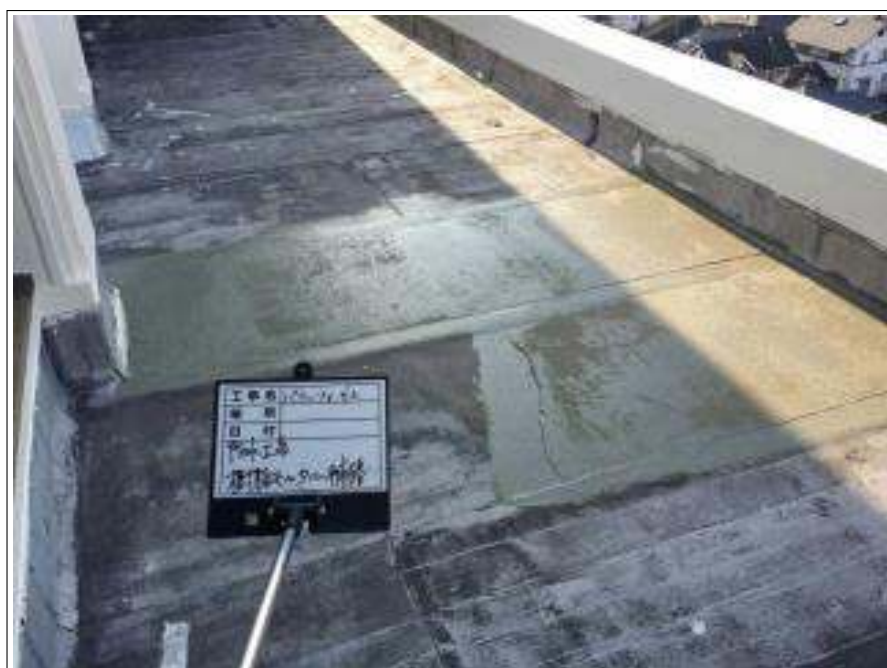
屋上防水部 樹脂モルタル補修
