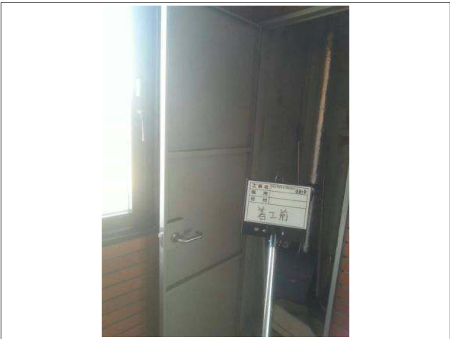
パイプシャフト 施工前
