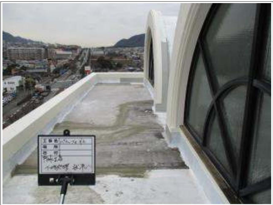
屋上防水部 下地補修
