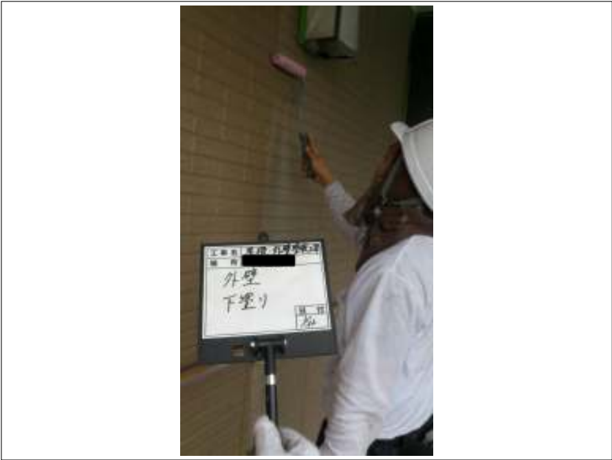
外壁 下塗り施工中
