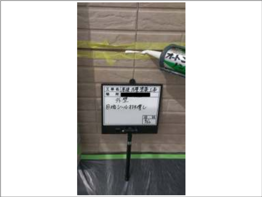
外壁 シーリング補修施工中
