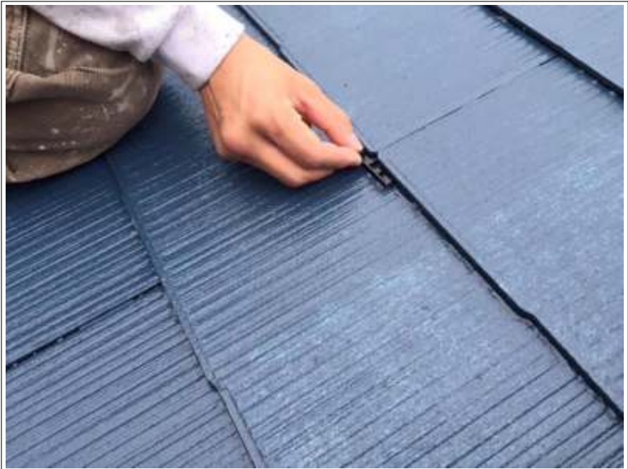
屋根 タスペーサー取付施工中
