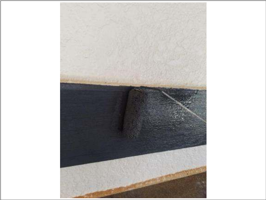
帯 上塗り（2回目）施工中
