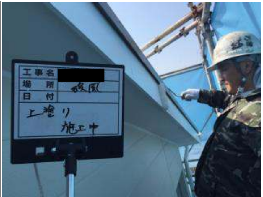
破風板 上塗り（1回目）施工中
