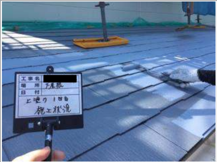
下屋根 中塗り施工中
