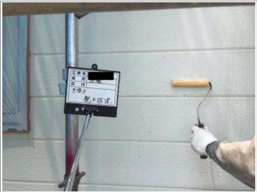
外壁(2F) 下塗り施工中
