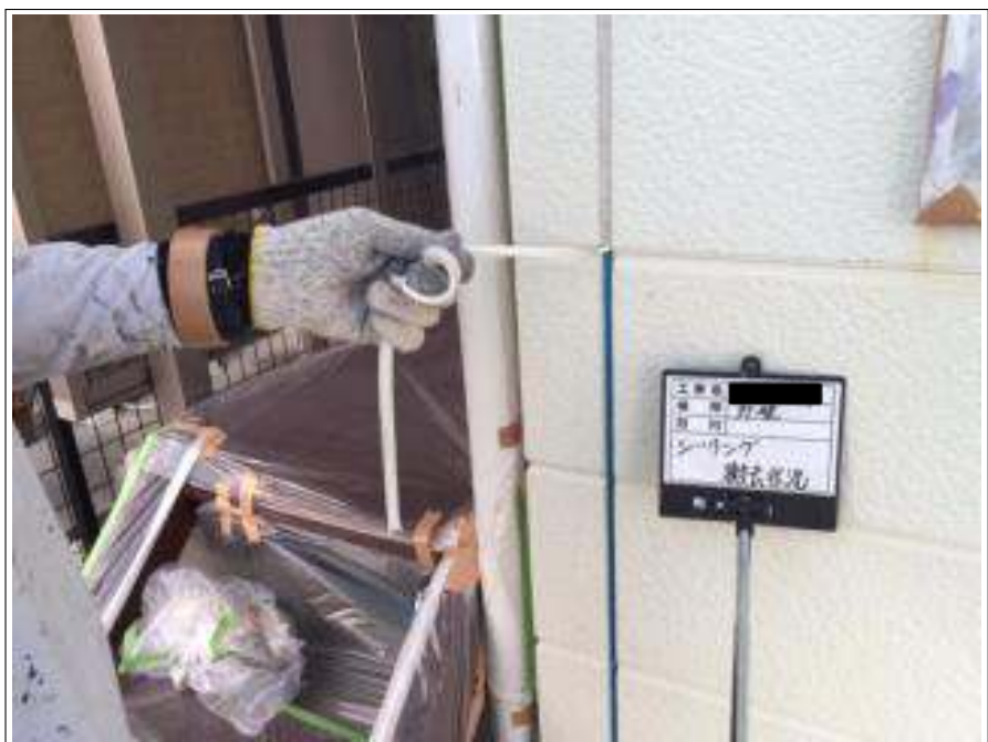
シーリング撤去 施工中
