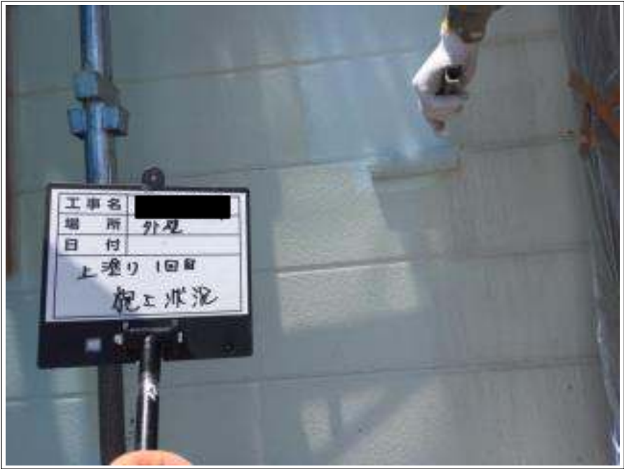
外壁(2F) 中塗り施工中
