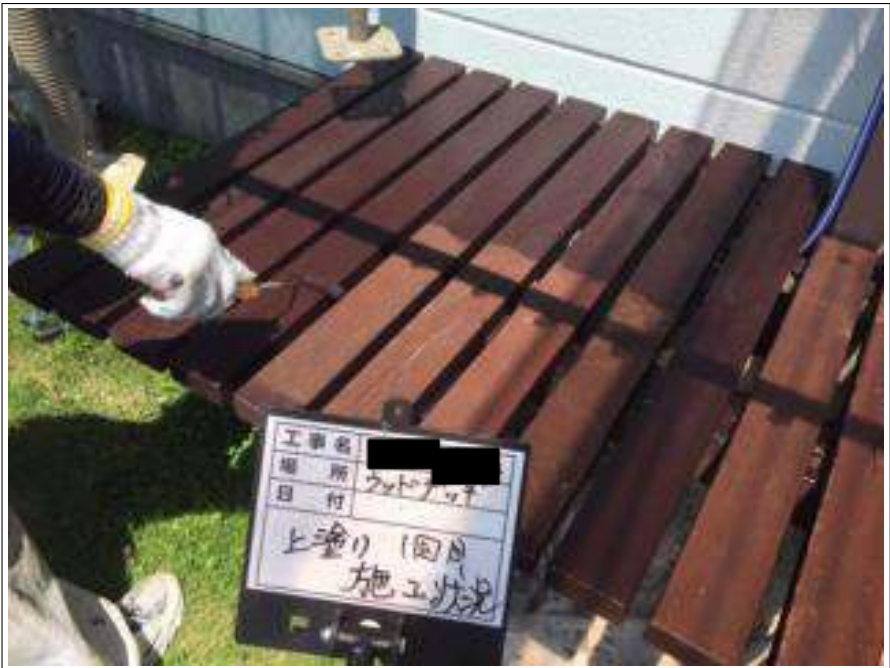
ウッドデッキ 上塗り（1回目）施工中
