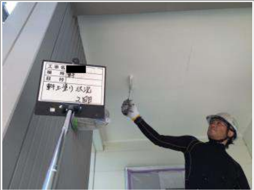
玄関軒天 上塗り（2回目）施工中
