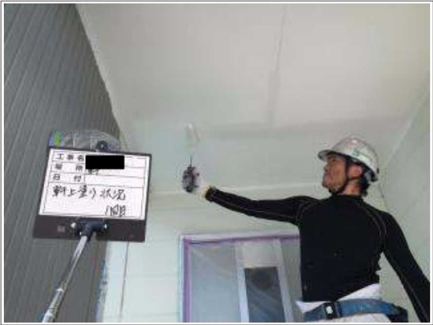
玄関軒天 上塗り（1回目）施工中
