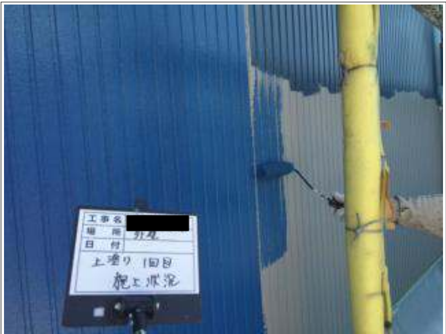
外壁(1F) 中塗り施工中
