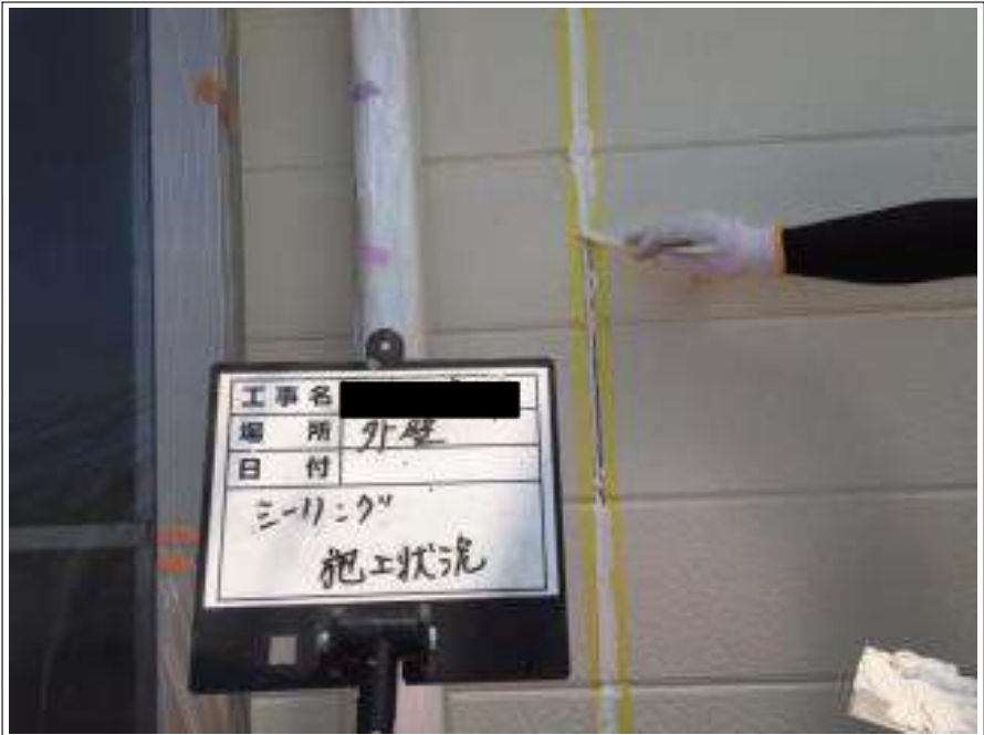
シーリング打ち替え 施工中
