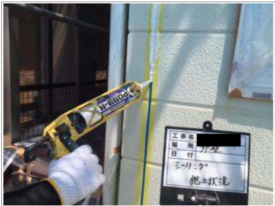
シーリング打ち替え 施工中
