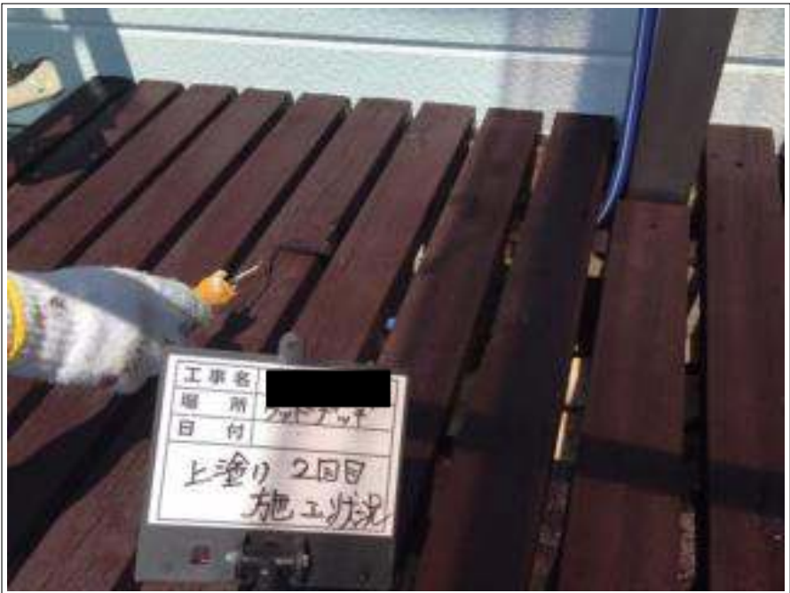
ウッドデッキ 上塗り（2回目）施工中
