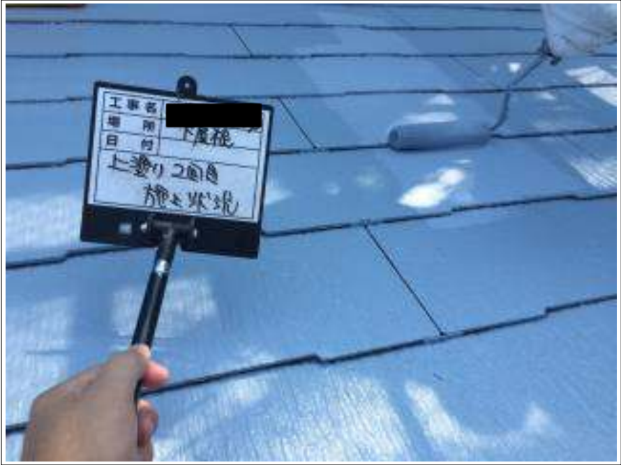
下屋根 上塗り施工中
