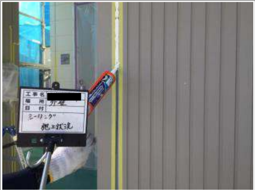
シーリング打ち替え 施工中
