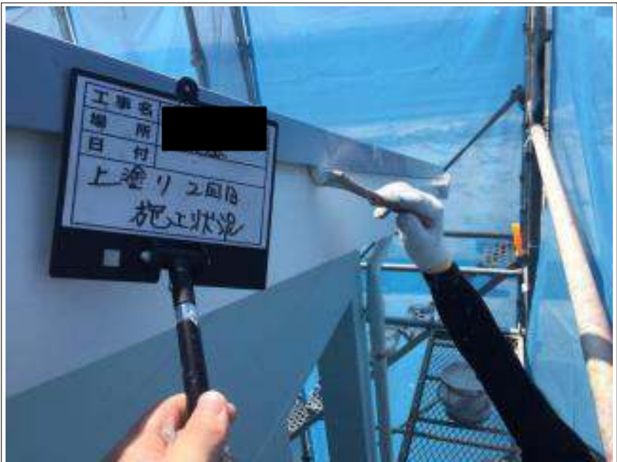
破風板 上塗り（2回目）施工中
