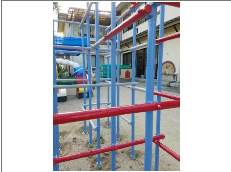
遊具 上塗り施工後（1回目）
