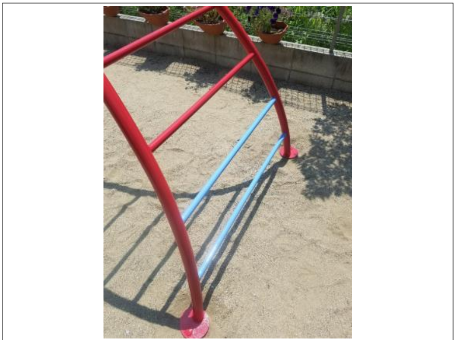
遊具 上塗り施工後（1回目）
