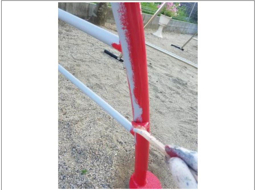
遊具 上塗り施工中（1回目）
