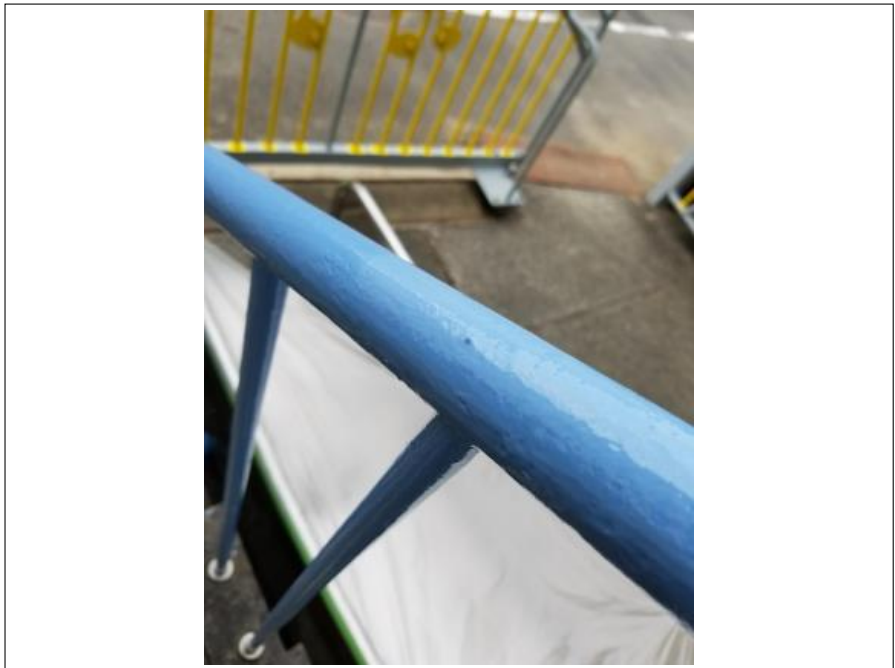
階段手摺 上塗り施工後（2回目）
