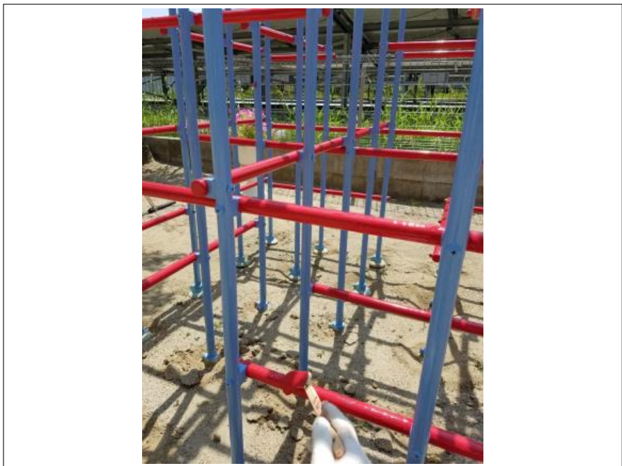
遊具 上塗り施工中（2回目）
