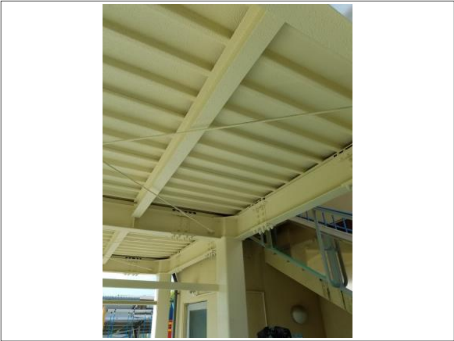
鉄骨部 上塗り 施工後
