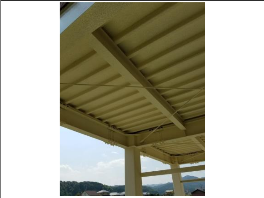
鉄骨部 上塗り 施工後
