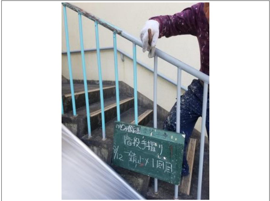
階段手摺り 錆止め塗布施工中（1回目）
