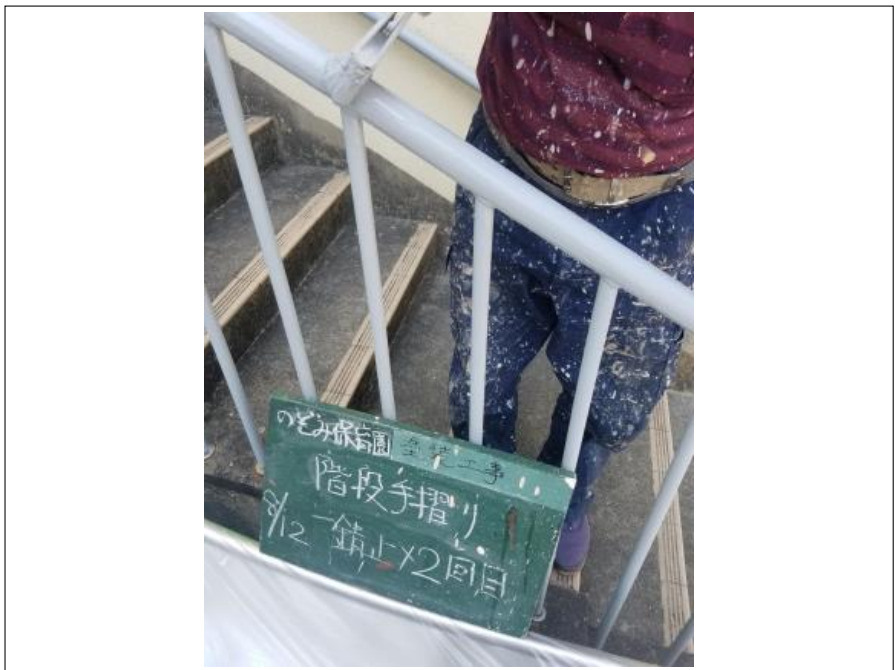
階段手摺り 錆止め塗布施工中（2回目）
