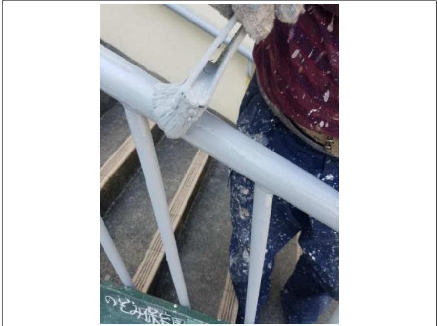
階段手摺 サビ止め塗布施工中（2回目）
