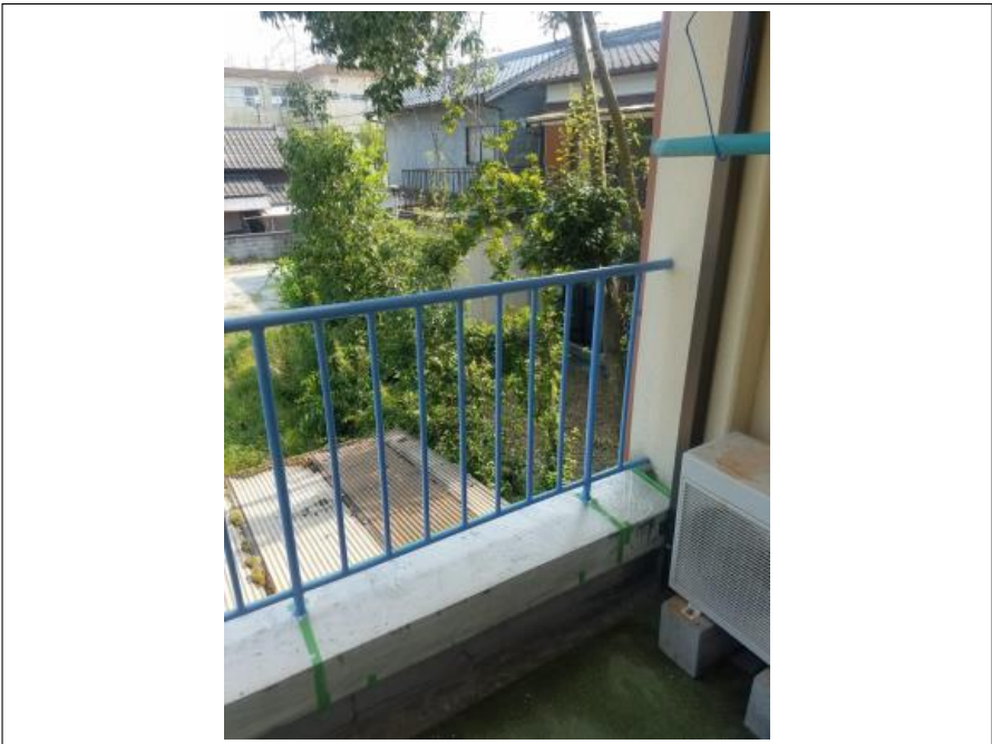
2階手摺 上塗り（2回目）施工後
