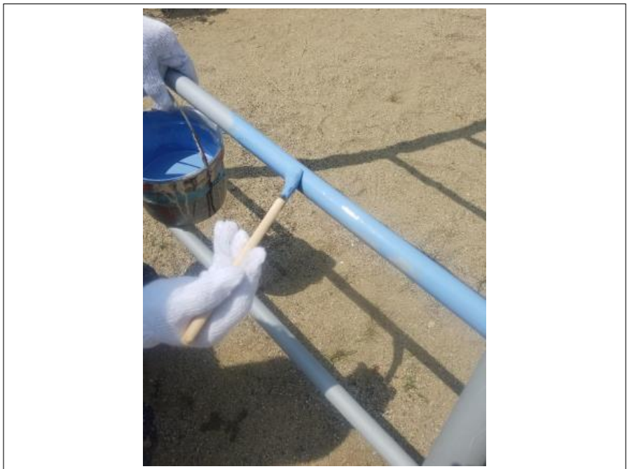
遊具 上塗り施工中（1回目）
