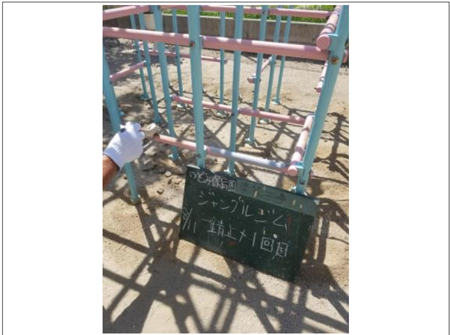
遊具 サビ止め塗布施工中（1回目）
