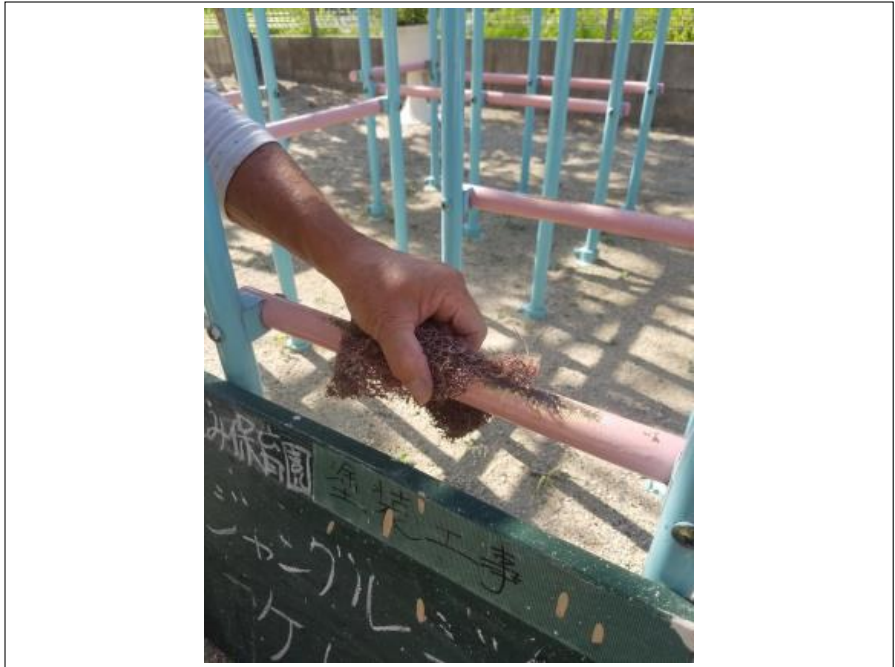
遊具 ケレン処理施工中
