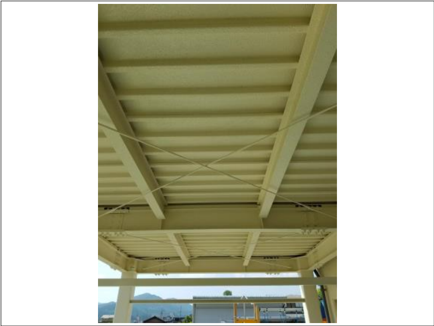
鉄骨部 上塗り 施工後
