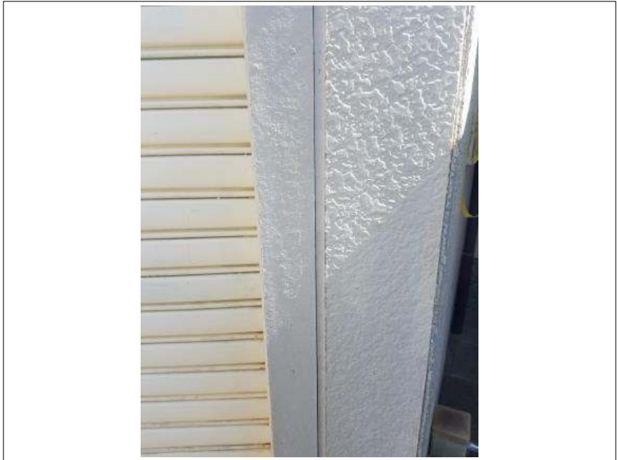
シーリング打ち替え 施工前
