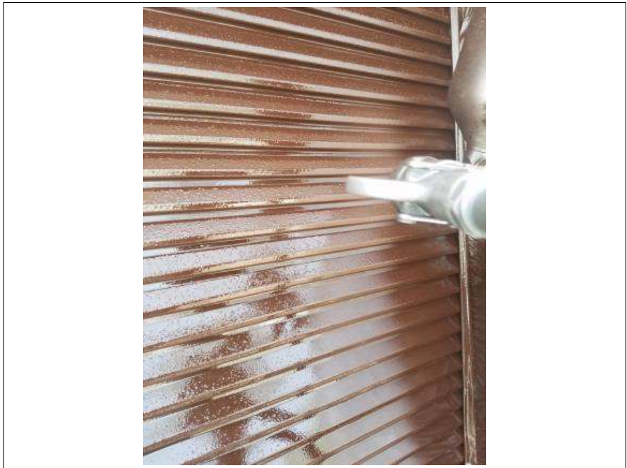
雨戸 上塗り（2回目）施工中
