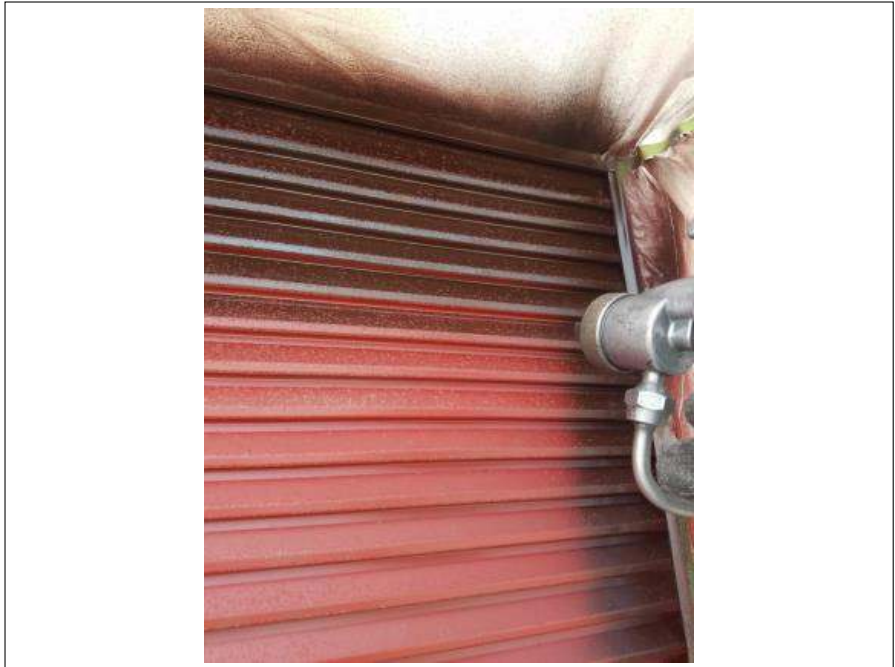
雨戸 上塗り（1回目）施工中
