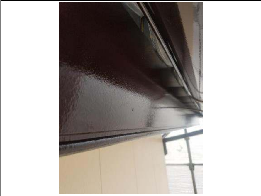
鼻隠し 施工完了
