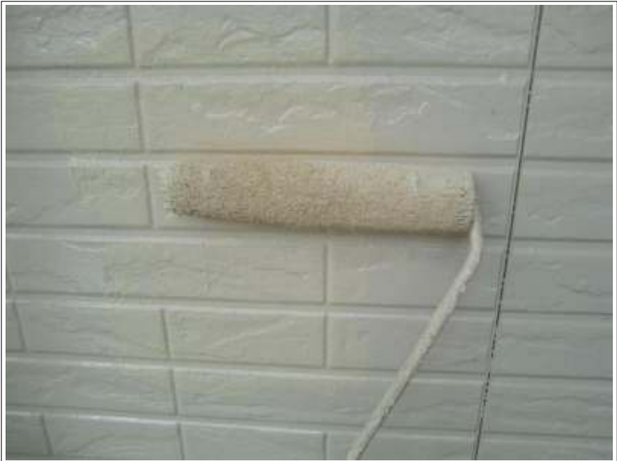
外壁 中塗り施工中
