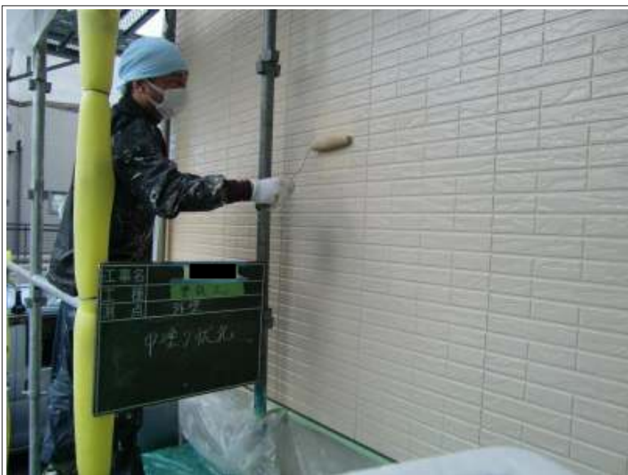
外壁 中塗り施工中
