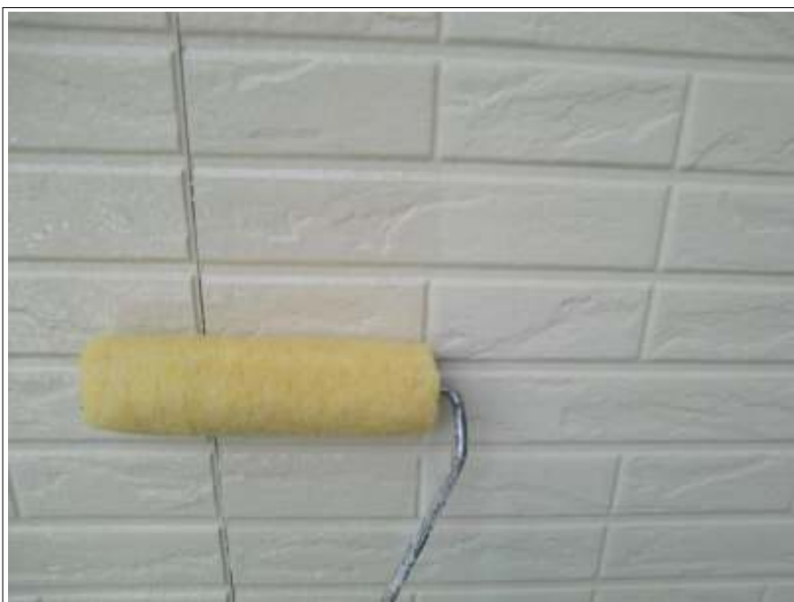
外壁 下塗り施工中
