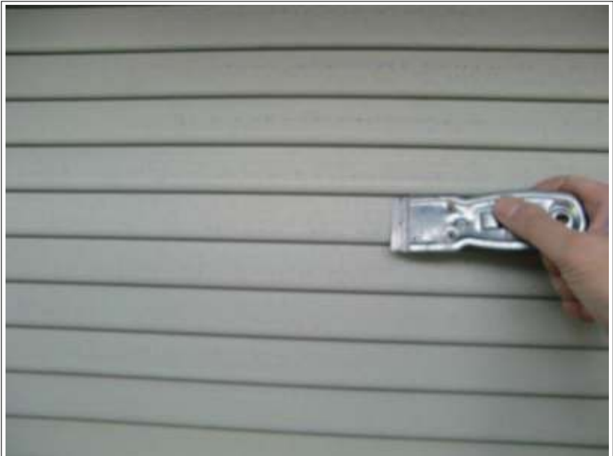
シャッター 下地処理施工中
