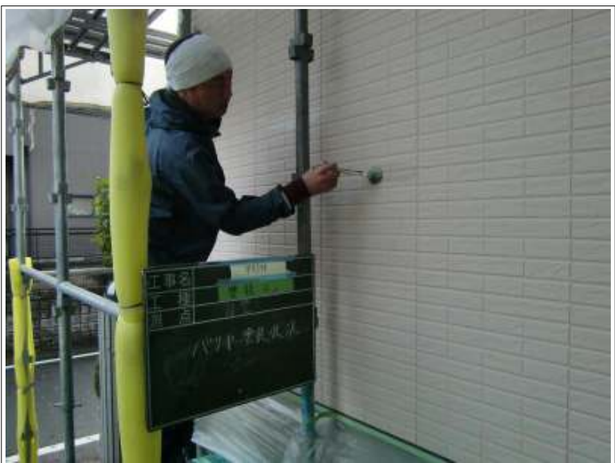
外壁 バリヤー塗布施工中
