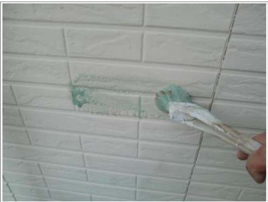
外壁 バリヤー塗布施工中
