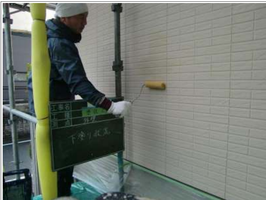
外壁 下塗り施工中
