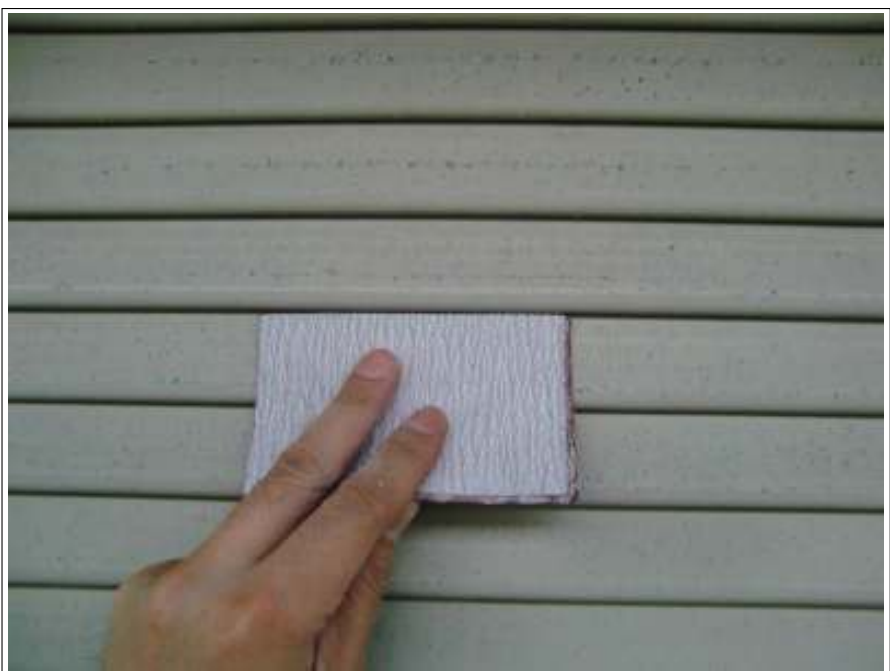
シャッター 下地処理施工中
